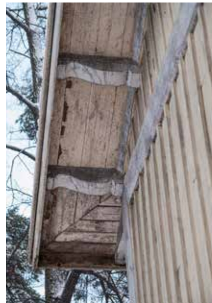
Ulkoasussa 1880-luvun detaljeja ovat muotoillut kattotuolien päät.
