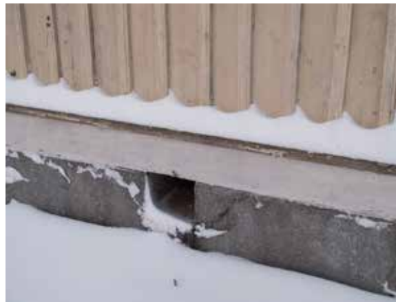
Vuokrakasarmien luonnonkiviharkoista tehtyä kivijalkaa. Seinän lautaverhous on 1950-luvulta.
