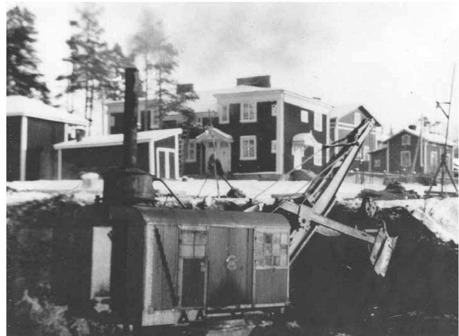
Konepajan perustuksia kaivetaan kuvan etualalla. Taustalla näkyy vuonna 1922 Naurisjärveltä Kuopioon siirretty asuinrakennus. Kuva: KKP.
