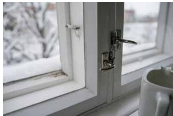
Rakennuksen ikkunat on uusittu mahdol- lisesti 1950-60-lu- vuilla.
