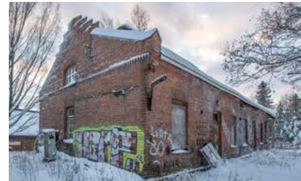
Ylinä rakennus lännestä, alla koillisesta nähtynä.
