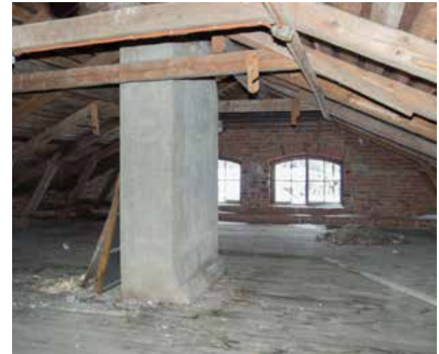
Ullakkoa rakennuksen länsipäädyssä.
