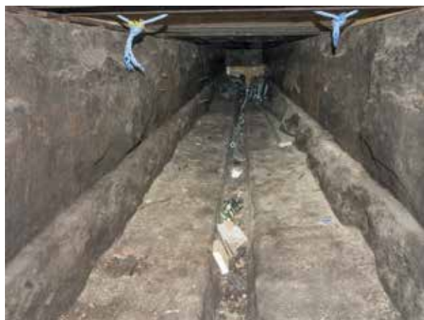
Veturipilttuun no 1 huoltomonttu - vertaa yllä oleva piirustus.
