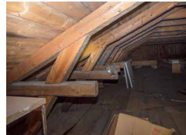
Alkuperäisiä kattotuolirakenteita ullakolla.
