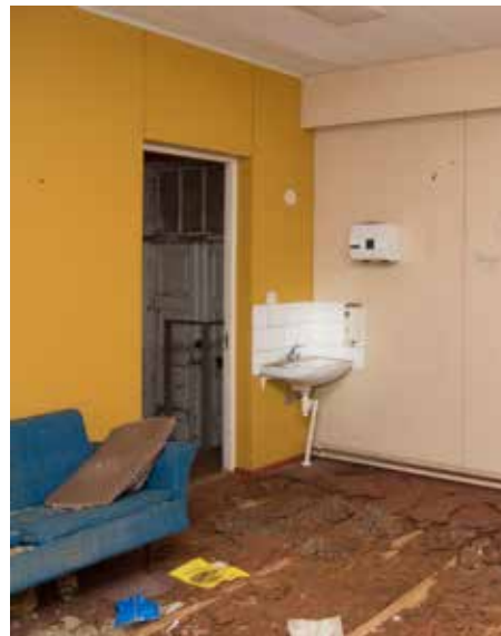
Rakennuksen sisätiloja nykyisin. Vesivuodot ovat paikoin vaurioittaneet välikatottoja ja lattiaita. Kutsumattomat vieraat ovat sotkeneet paikkoja.
