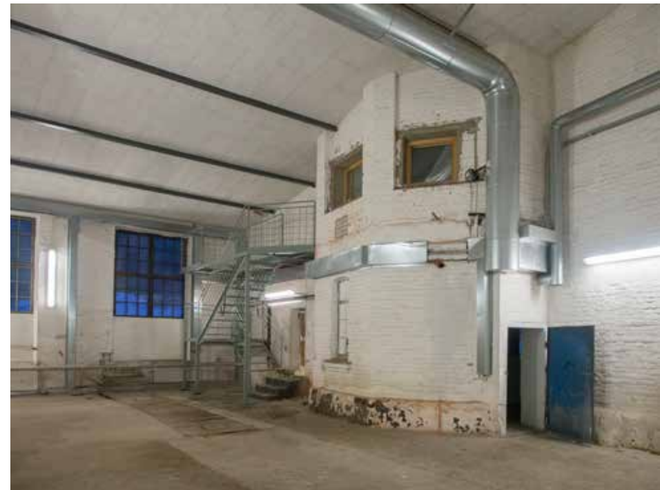
Pilttuun 11 peräosaa, jossa alaosaltaan näkyy toinen kahdeksankulmaisista vesitorneista.
