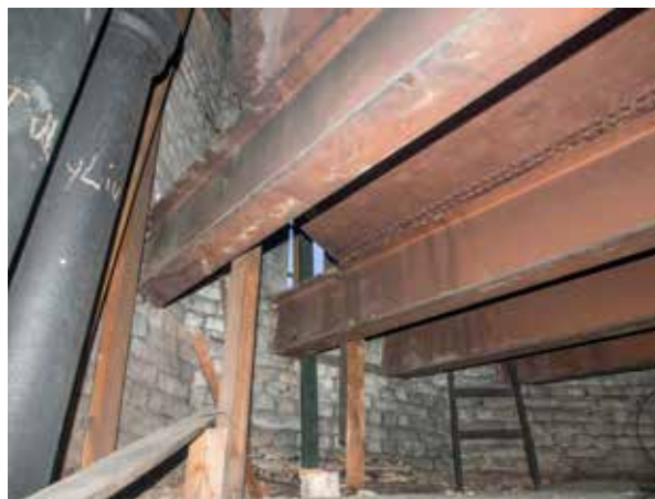
Kuva vesitornin yläosasta: tukevat I-palkit kannattavat teräslevyistä niittaamalla koottua säiliötä.
