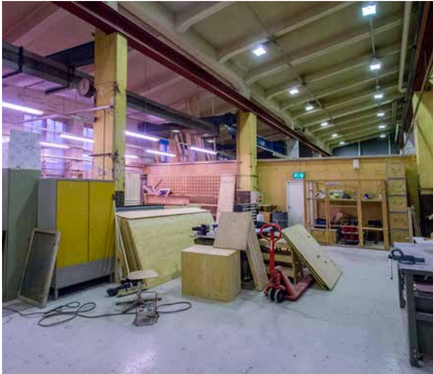
Kaarihalliin liittyvä pulpettikattoinen hallin osa 130-3. Betoniholvia kannattaa yksinkertainen palkisto. Keskellä tilaa on betonipilareihin tukeutuva pääpalkki. Pilarien varassa on teräsrakenteinen hallinosturirata; hallinosturi ei ole alkuperäinen. Alunperin yhtenäinen tila on nykyisessä käytössä jaettu osiin väliaikaisrakenteilla.
