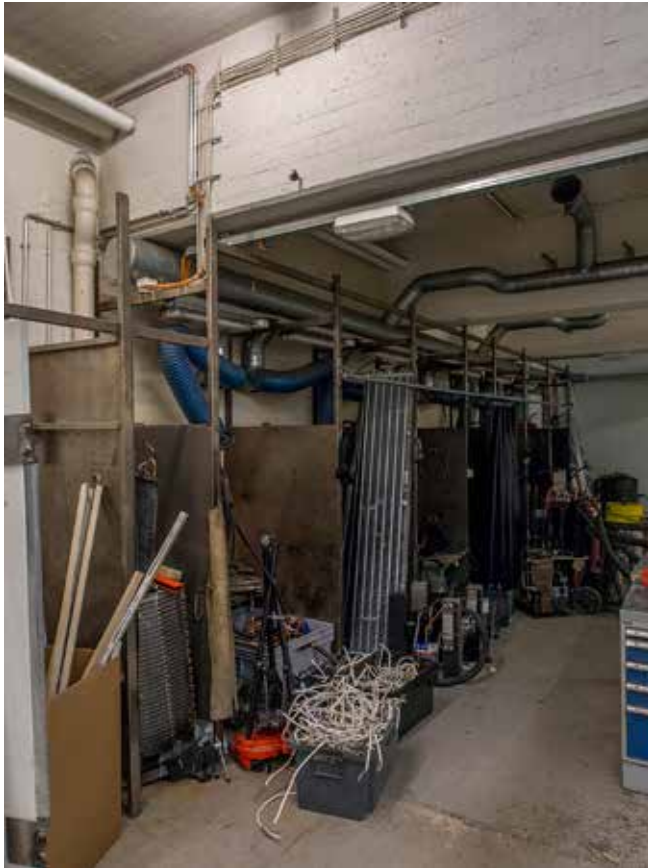
Varastotila 173. Järeä välipohjapalkisto on mitoitettu toisen kerroksen varastotilojen kuormitukselle.
