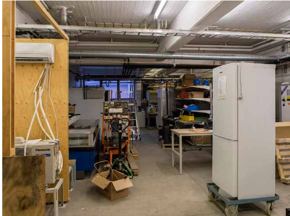
Opetustila 237, piirustuksessa vuodelta 1971 tila on osa toisen kerroksen käsittänyttä yhtenäistä varastotilaa. Kolmannen kerroksen välipohja on mitoitettu toimistokäytön mukaan. Palkisto sisäkatossa on huomattavasti kevyempi kuin kerrosta alempana.
