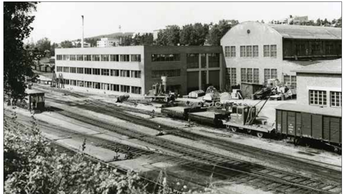
Vuonna 1968 valmistunut laajennus mahdollisti uudenlaisten veturien korjauksen Kuopiossa. Viereisellä sivulla kuva laajennuksen lounaiskulmasta. Suomen Rautatiemuseo / O. Lehtonen
