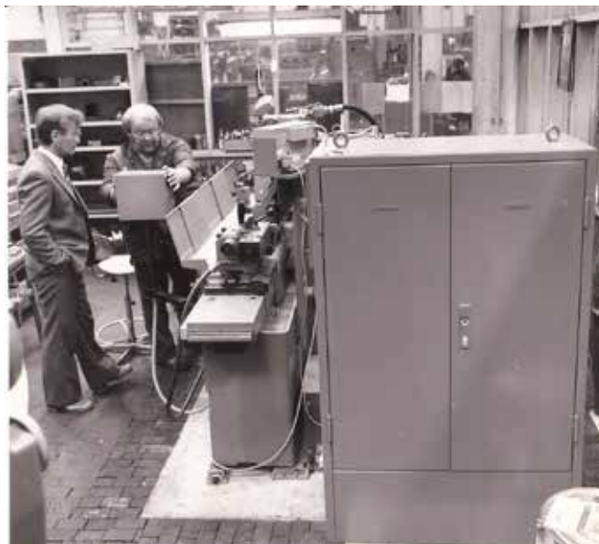
Vieressä hiomakoneen asennusta vuodelta 1981. Oikealla ylhäällä vuonna 1968 valmistuneessa osassa Raiteenvaihtokone Veera huollossa vuonna 2002 ja alhaalla oikealla kuva koneistamosta vuonna 2002. KKPY
