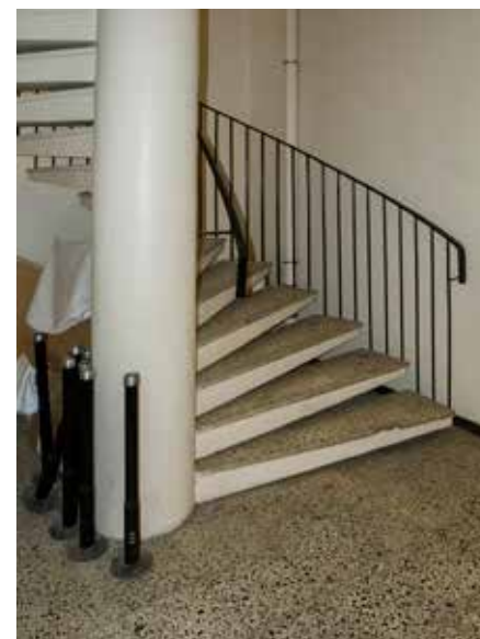
Porrashuone 124 Elementtirakentei- nen kierreporras
