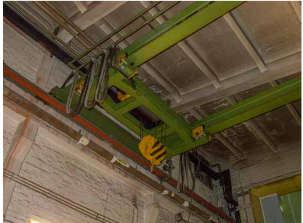
Siipirakennuksen hallin osa 111-1, vuoden 1939 piirustuksessa ”hajoitusosasto”. Yläpohjan betoniholvia kannattaa kaksinkertainen betonipalkisto. Pilareihin tukeutuviin pääpalkkeihin on yhdistetty hoikemmat sekundaaripalkit. Pilarirunkoon tukeutuva hallinosturinradan kannatus on alkuperäinen. Hallinosturi teräskiskoineen on uusittu myöhemmin.
