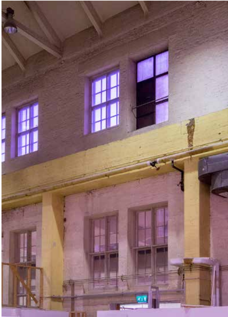
Hallin 129-3 seinä vasten hallia 133, osa alkuperäistä ulkoseinää.
