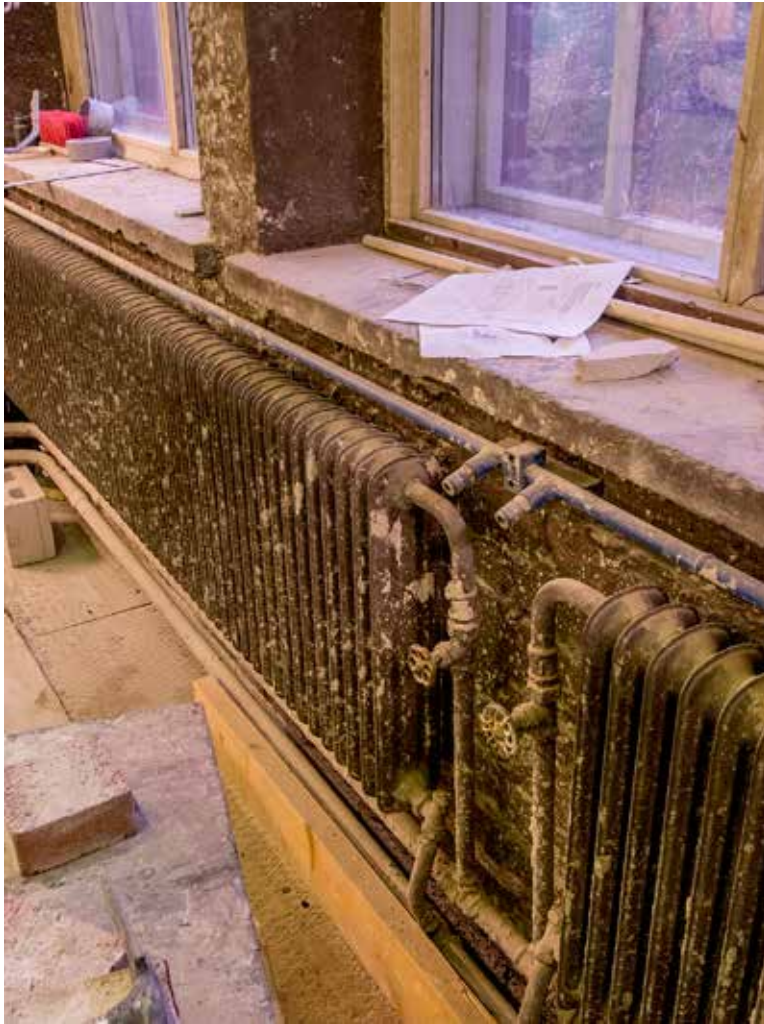
Pohjoispäädyssä, hallin osa 130-3
