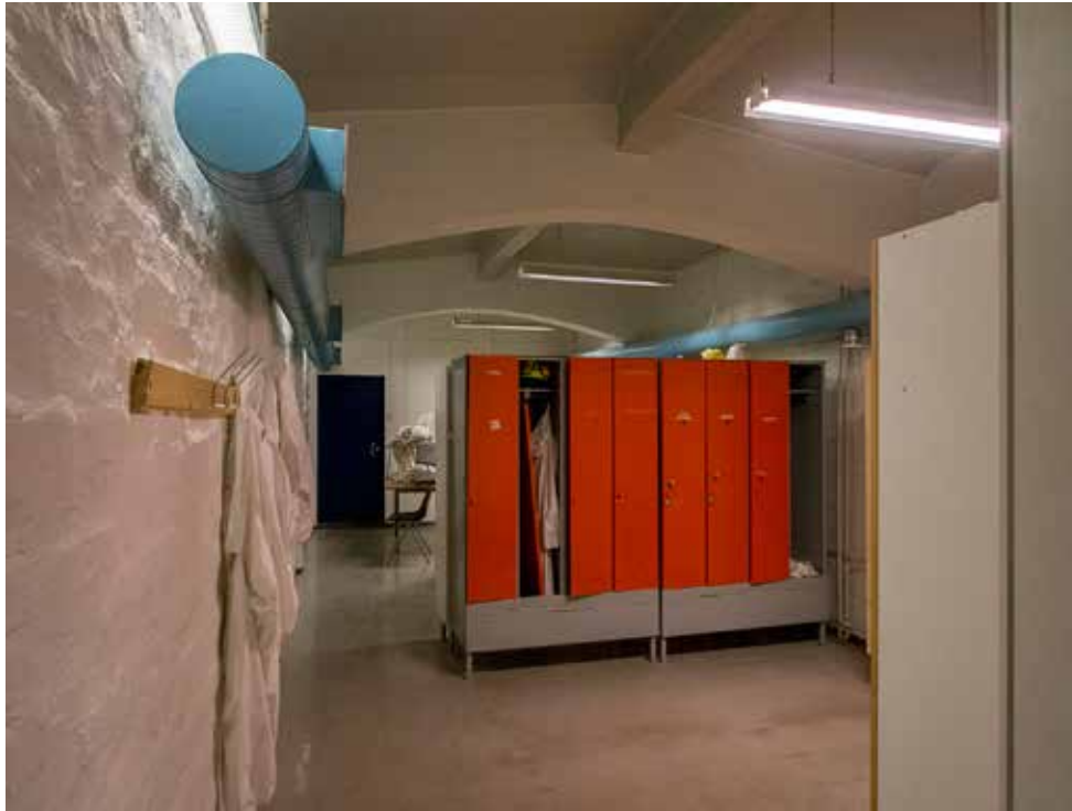
Pukuhuone 332. Alkuperäisen yläpohjan palkistoa vesikaton harjan kohdalta, jossa pääpalkit on muotoiltu kaareviksi. Harjan kohdalla olevat sekundääripalkit tukeutuvat pääpalkistoon. Vuonna 1979 tämän kerroksen päälle tehtiin yksi kerros lisää pesu- ja pukutiloja.
