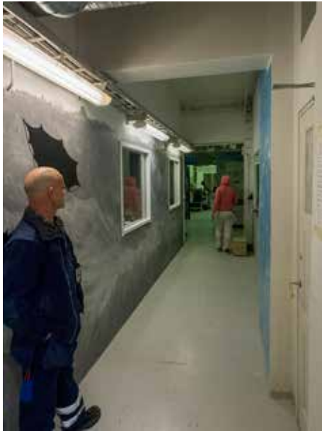
Tila 145 alkuperäisen keskikäytävän ja kirjainpitäjän tilan läpi avattu käytävä konepajahalliin 133.
