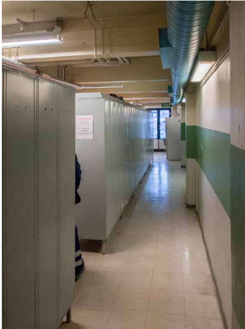
Yllä pukutila 332. Vuoden 1957 laajennukselle tyypillinen yläpohjan betonirakenne.
