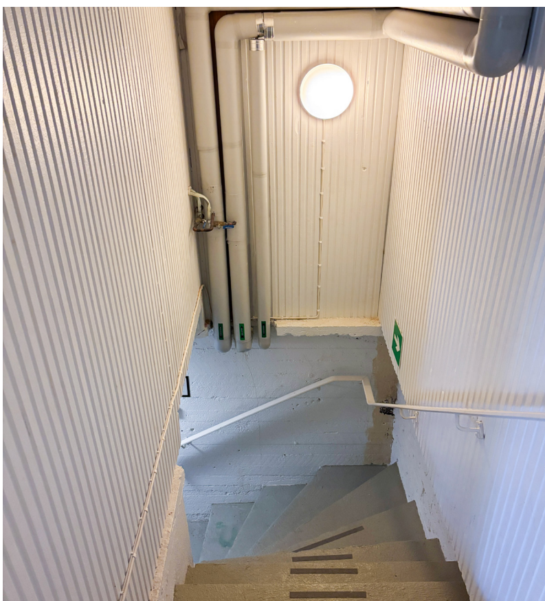
6. Valokuva kellariin johtavista portaista (ks. 1. kerroksen pohjakuva s. 28)
