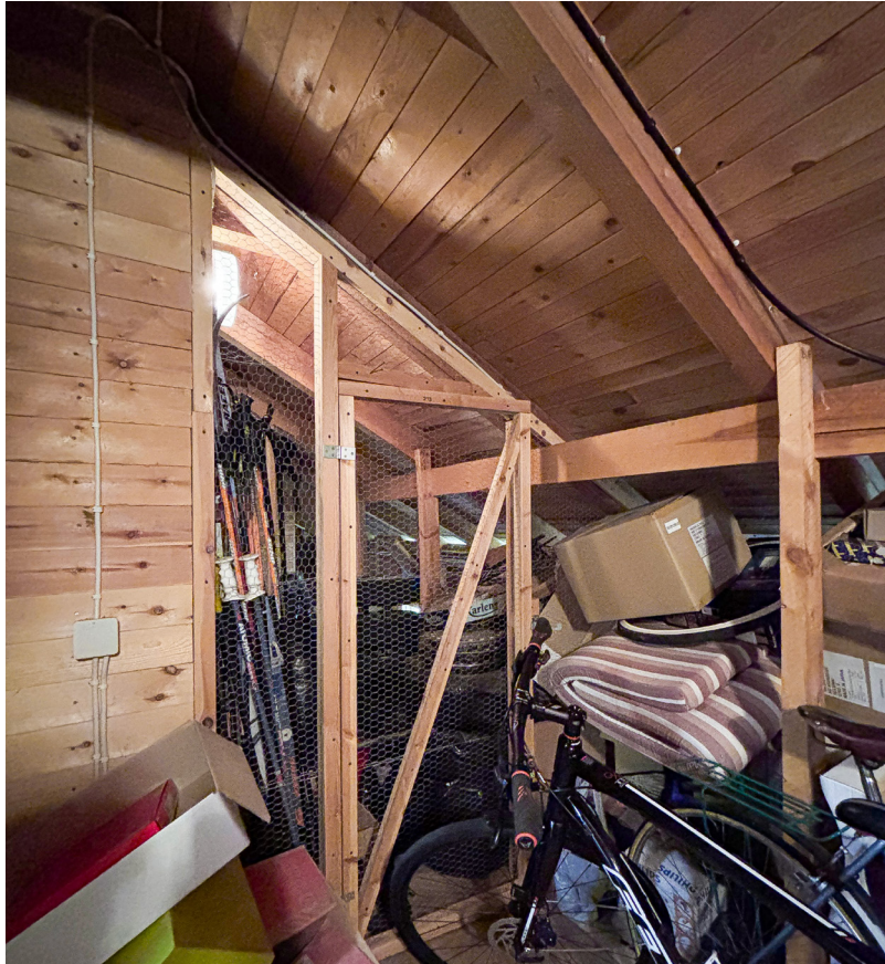
7. Valokuva 2. kerroksen ullakkotilasta (ks. 2. kerroksen pohjakuva s. 28)
