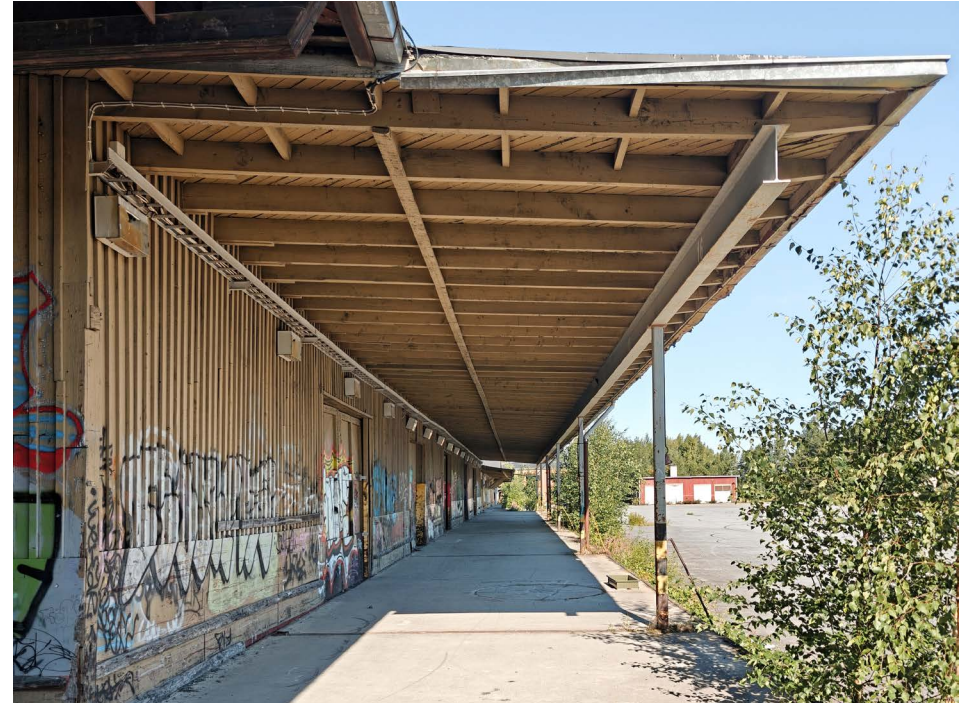
Lastauslaiturin laajennus nykytilassa. Katoksen etureunan rakenteet ovat nykyään puisten sijaan teräsrakenteita.
