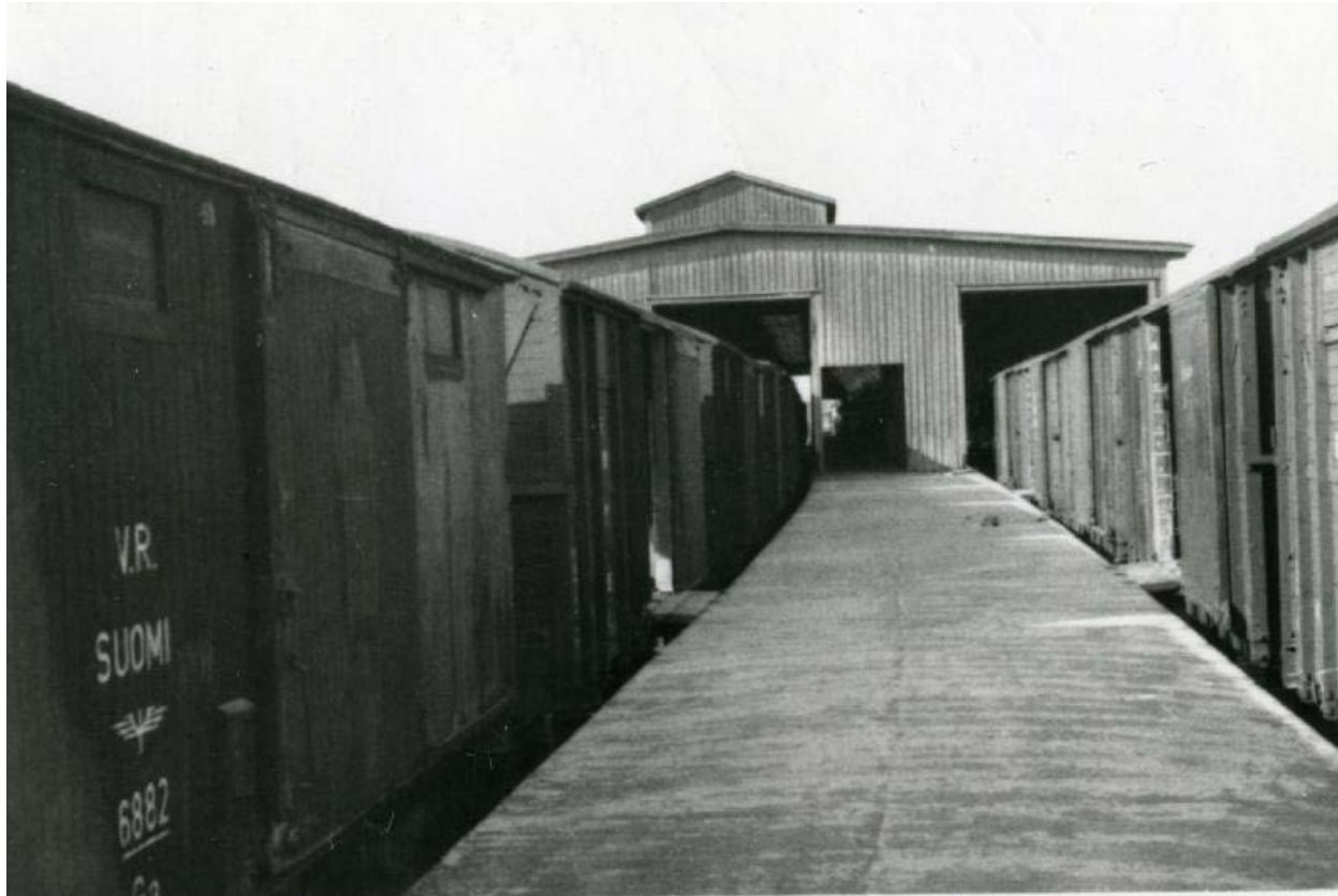
Seinäjoen tavara-aseman vaunujen kuormauslaituri. Kuva on todennäköisesti otettu kaakkoissuunnasta ennen tavara-asemarakennukseen tehtyjä laajennuksia.
