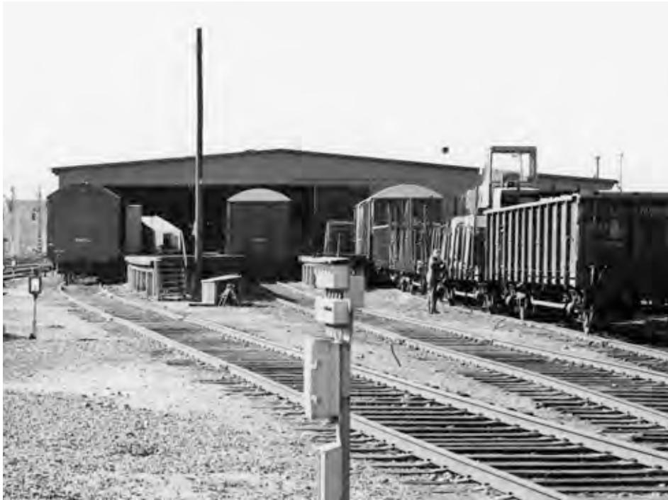
Tavara-aseman kaakkoisjulkisivu kuvattu vuonna 1980. Tavara-aseman läpi kulki vielä kaksi junaraidetta ja lastauslaituri oli nykyistä pienempi. Lähde: Kulttuuriympäristöselvitys, 2022. Seinäjoen museot.
