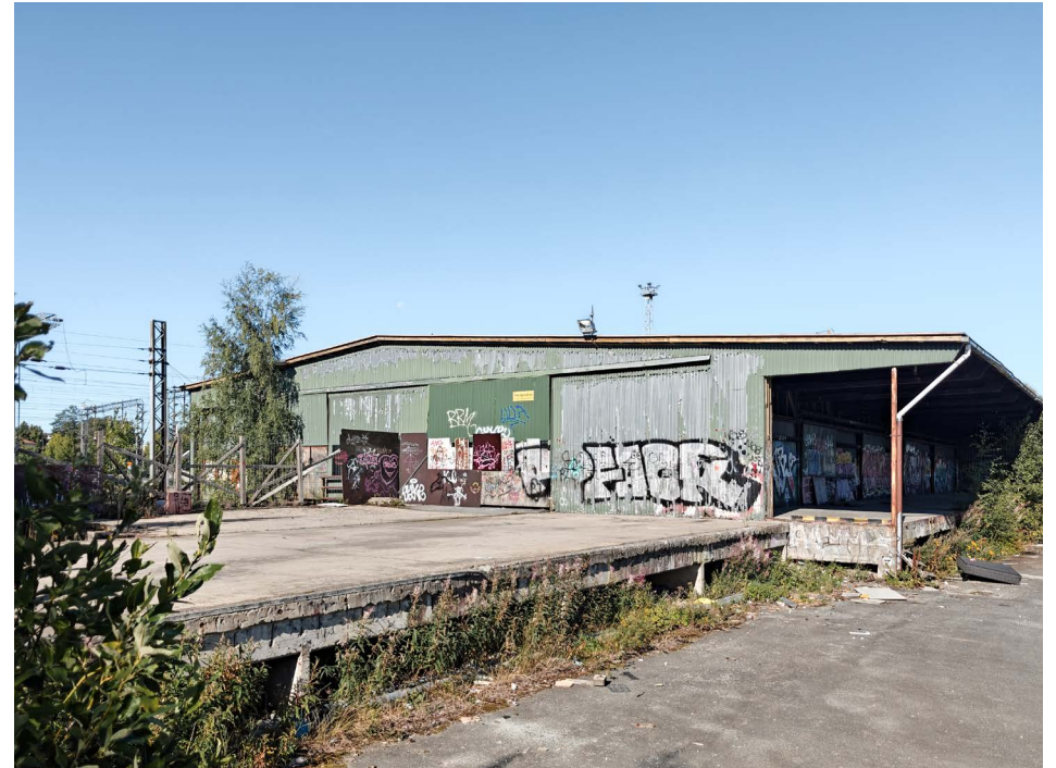
Tavara-aseman kaakkoisjulkisivu kuvattu kesällä 2026. Julkisivujen aukotus on muuttunut junaraiteiden vähentymisen myötä. Etualalla 1970-luvun lopun ja 1990-luvun alun välissä rakennettu teräsbetoninen laiturii.
