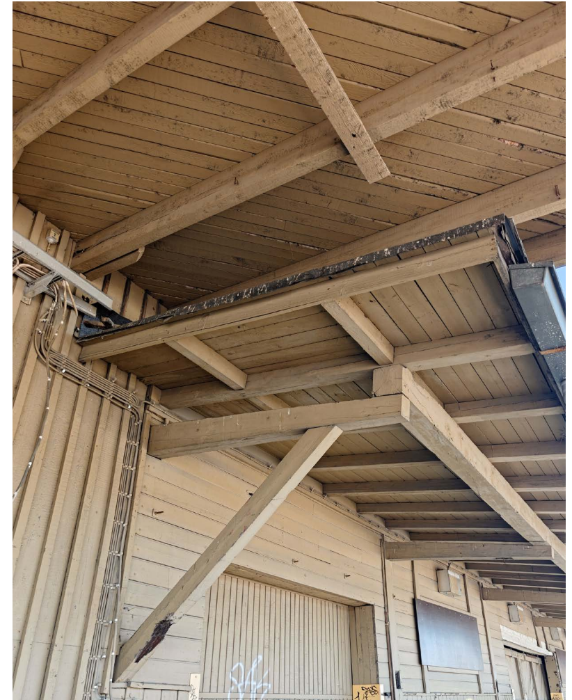
Lastauslaiturin katos on hieman korkeammalla ja edempänä kuin alkuperäisen tavaraterminaalin katos. Julkisivujen laudoitus ja katosrakenteet poikkeavat toisistaan.
