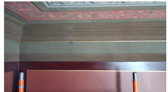
Kuva 6b. Pohjamaalin päälle maalattiin pinnat metyyliiselluloosaliisteristä valmistetulla liimamaalilla. Uuden ja vanhan maalin rajapinta häivytettiin PanPastel-liiduilla.
