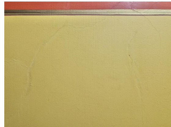
Kuva 8c. Vauriokohdat retusoitu PanPastelleilla. Pastellit tasoittivat kiillottunutta pintaa ja vaalensivat vanhoja, tummentuneita retusointeja.
