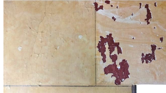
Kuva 6c. Kuvan oikealta puolelta irtoavat maalikerrokset poistettu.
