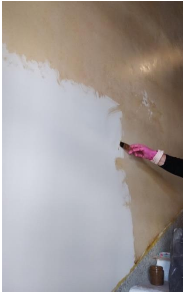
Seinän ensimmäinen laseeraus käynnissä. Laseerausnesteinä käytettiin valkaistua pellavaöljyä, joka sävytettiin öljytuubiväreillä.
