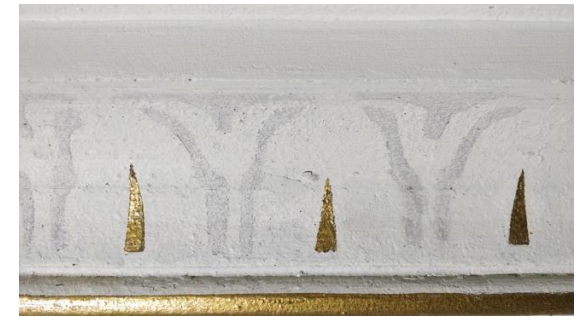
Kuva 6b. Ornamentti kiinnitetty ja retusoitu. Kiinnityksessä liimana oli MFK.
