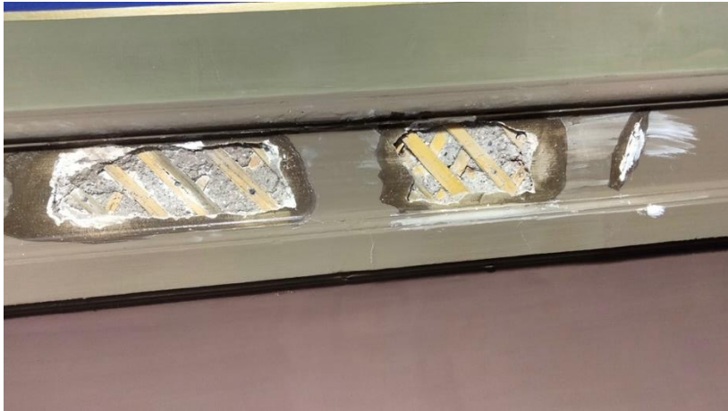
Kuva 6. Katon puoleisen profiililistan tasaiselta alueelta irtonaisen aineksen poiston yhteydessä tuli esille tikutus.
