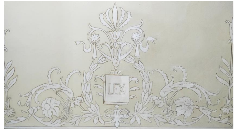
Kuva 3b. Köynnöskoristeet kuvan vasemmalla puolella on kevyesti vaalennettu vanhan pinnan mukaisesti PanPastell-liidulla (Titanium white).
