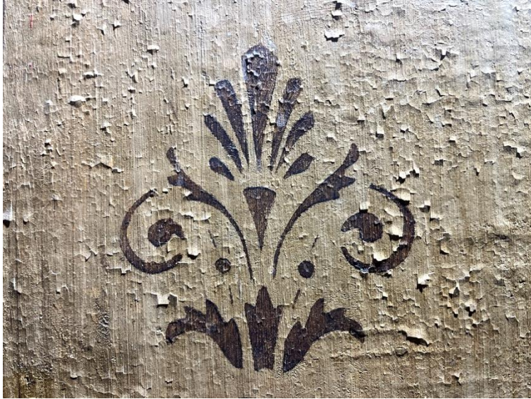
Kuva 8a. Irtoavaa maalia koristeessa ja peilissä.
