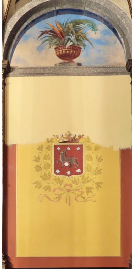
Pohjatytöet tehty ja kenttä on välimaalissa.
