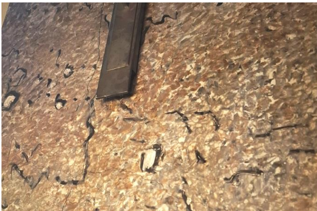
Kuva 23b. Sähköjohtojen tuloreikä kitattuna ja retusoituna.
