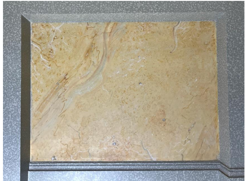
Kuva 7b. Tasanteen peilikentän puutealueet retusoitu.
