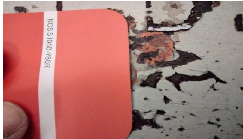
Kuva 13c. Palkin kyljestä esiin tullut koristeen kukkasen sävy, lähin sävykoodi NCS S 1060-Y80R.
