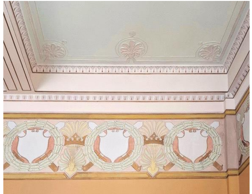
Kuva 9. Kattopinnat, palkit ja seinäfriisi valmiina.
