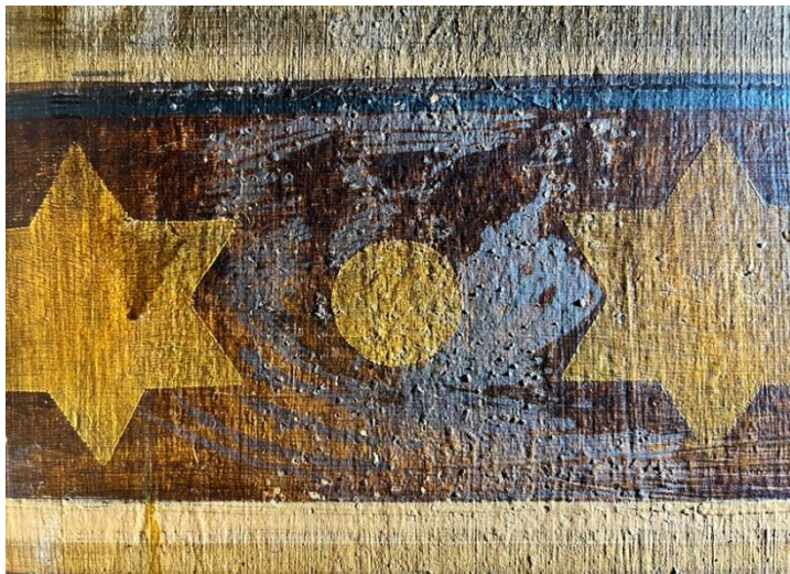
Kuva 14. Paneelin yläreunan koristeen maali- tai lakkapinnassa oli paikoitellen pientä kuplamaista irtoamaa sekä sävy muutoksia.
