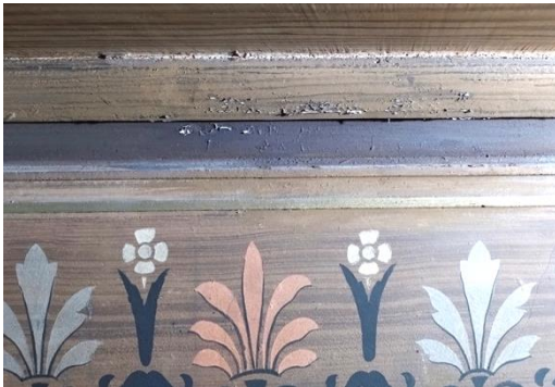
Kuva 2a. Irtoavaa maalia friisin alueella.
