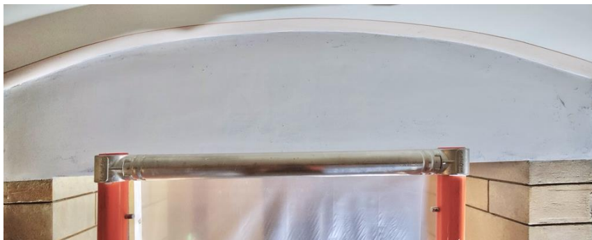
Kuvassa koko palkin sivu on tasoitettu.
