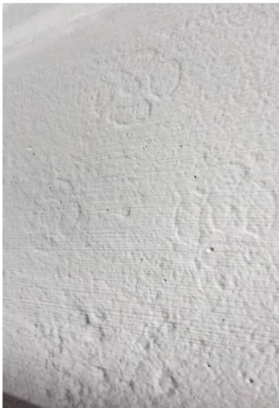
Kuva 6. Kattopalkkien kyljissä erottuu paikoitellen nykyisen maalin alta kohokuvioina alkuperäistä koristemaalausta. Aiheena pienet kukkasat.
