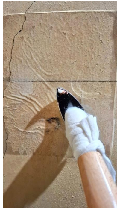
Kuva 1c. Pintaa lämmitettiin lämpöä kestävän kalvon läpi, kunnes liima on imeytynyt irtoamien alle.
