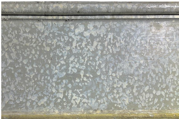
Hilseilevä maali kiinnitetty.
