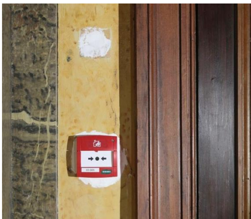
Keltaisen marmoroidun seinäpinnan vauriot tasoitettu.
