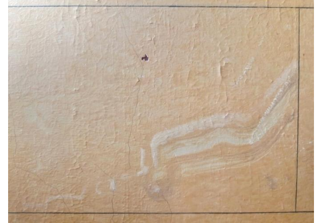
Kuva 2a. Matalaa irtoamaa, jossa kerrospaksuus on kuitenkin melko paksu. Aluetta on kiinnitetty aikaisemminkin. Seinäprojektiio 13.
