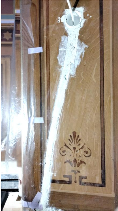
Kuva 17a. Kuvassa itäseinän pohjoisen puoleinen oviaukko. Smyygin laastitöyttö tehtiin pääurakoitsijan toimesta. Ylimääräiset laastit vanhalta pinnalta puhdistettiin (kuvassa jo roilon reunat osittain puhdistettu).
