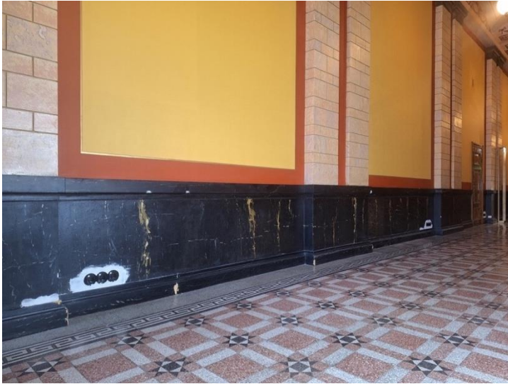
Paneelien ja jalkalistojen vauriot tasoitettu.
