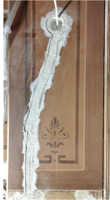
Kuva 18a. Kuvassa itäseinän eteläpuoleinen oviaukko. Laastityöt tehty.
