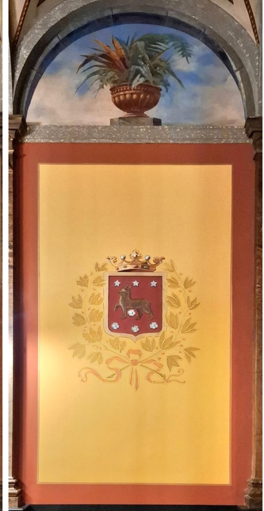
Seinäkentän maalaustyöt valmiina.
