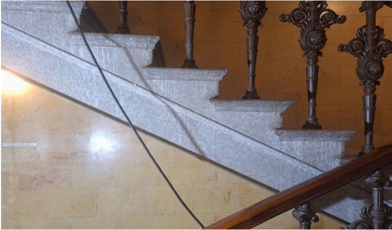
Valumajälkiä portaan kyljessä. Seinän 6 porrasaskelmien kyljet.
