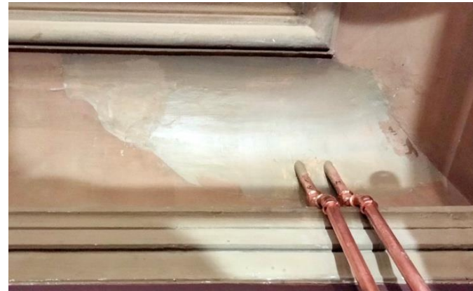
Kuva 5c. Korjausalue maalattu sävytetyllä pohjamaalilla.
