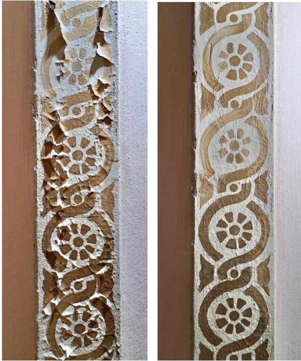
Kuva 1a. Paksua, lohcaremaista irtoamaa. Seinäprojektiio 5.
