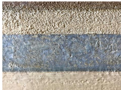
Kuva 3b. Maali-irtoamat kiinnityksen jälkeen.
