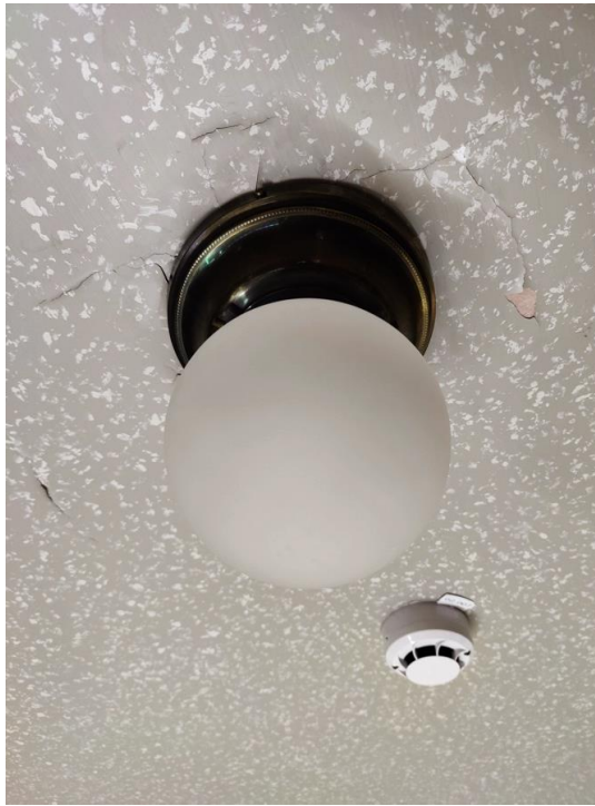
Katon maali-irtoamat sijaitsivat lampun ympäristössä. Paikoin oli ehtinyt syntyä myös maalipuutosalueita.
