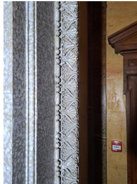
Irtoavan maalin kiinnitys ja retusoinnit toteutettiin noin 2,5 m:n korkeuteen.
