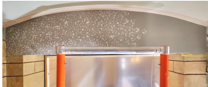
Koko alue on pintamaalattu harmaalla, vanhaan pintaan sopivalla sävyllä, maalina Futura Aqua. Töpötysmaalaus vaalean harmaalla sävyllä käynnissä.
