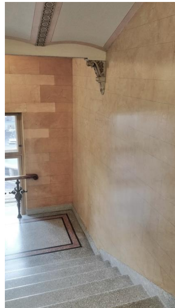
Alatasanteella näkyy vanhempaa korjausmaalausta.
