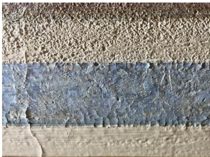
Kuva 3a. Maali-irtoamaa sinisessä koristeviivassa ennen maalinkiinnitystä.
