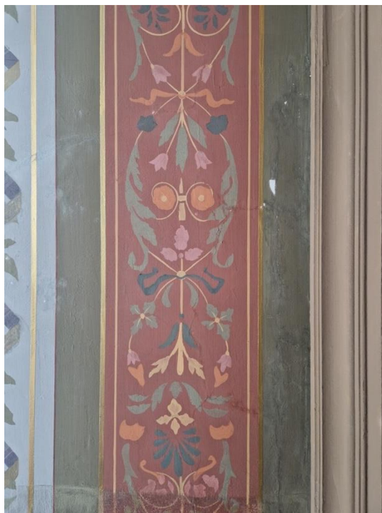
Kuva 3b. Kuvassa maali-irtoamat kiinnitetty takaisin alustansa. Liimana MFK.
