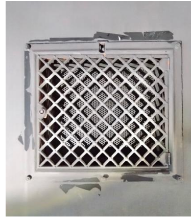
Kuva 5a. Liimamaalin pinnalla tummat jäljet ovat teipin liimajäämiä. Kuva ennen toimenpiteitä.
