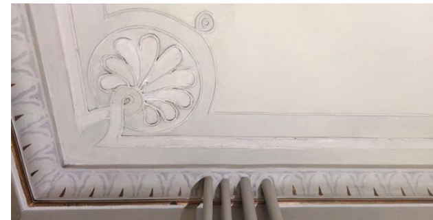
Kuva 4. Valmista kattopintaa. Uusien patteriputkien läpiviennit retusoiitiin samalla tavoin kuin muukin kattopinta.
