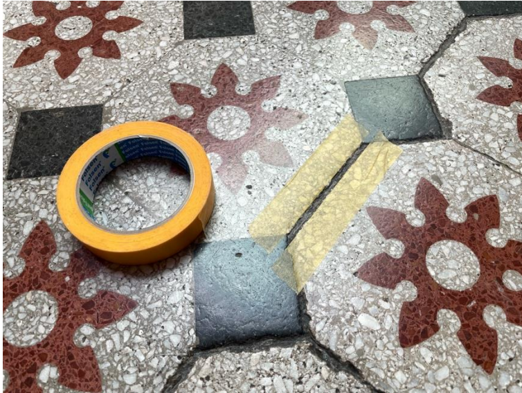
Mosaiikkibetonin reunat suojattiin teipillä ennen sauman täyttöä.
