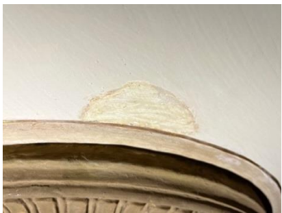
Kuva 5a. Rosetin reunassa häiritsevästi erottuva värjäymä.
