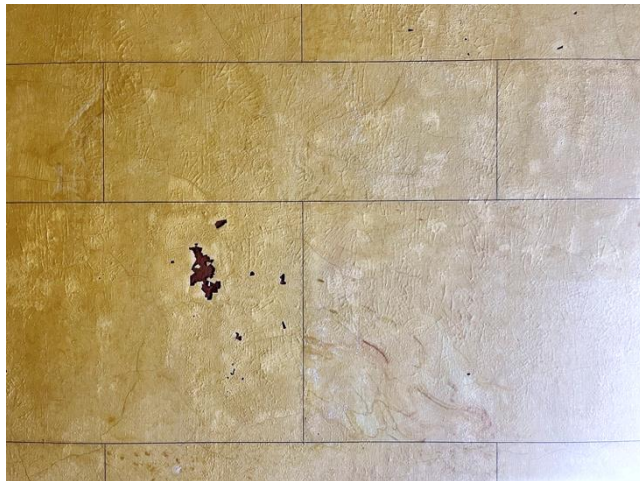
Kuva 10b. Kiinnitetyt alueet eivät olleet tarttuneet kiinni, eli maalit olivat vielä irti. Irtoamaa oli myös kiinnitettyjen alueiden ympärillä. Pinta oli tahmea, sillä liimaa poli jäänyt pintaan. Vaikutti siltä, että kiinnityksen jälkeen ei ole tehty pinnan puhdistusta ja loppulämmitystä huolella.
