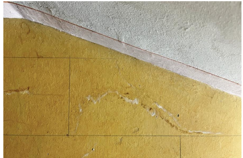
Kuva 9b. Seinän ja katon irtoamat kiinnitetty.
