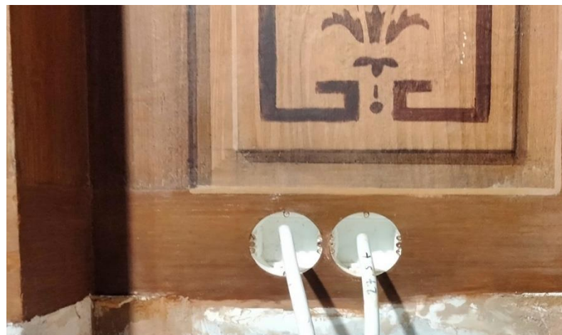
Kuva 16c. Vaurioalueen oottraus valmiina.
