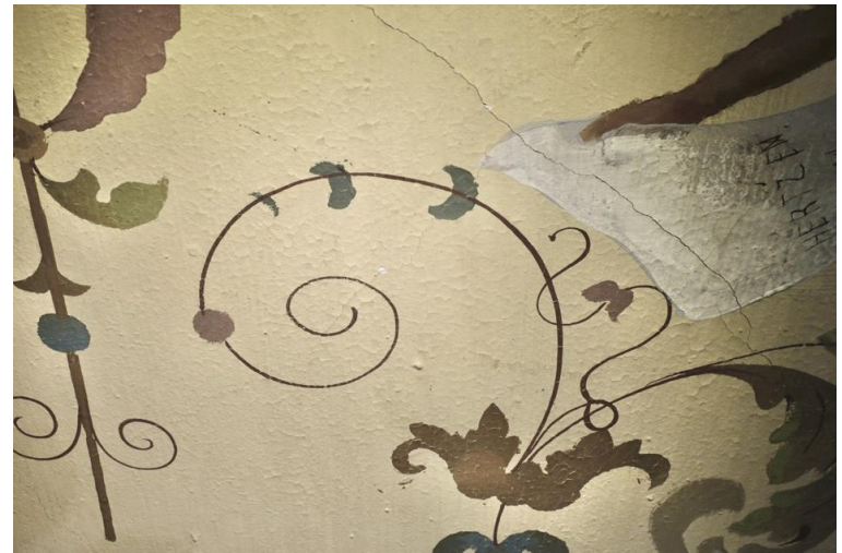
Kuva 26a. Tilassa 117 kattopinnalla oli melko laajalla alueella krakeloitunutta maalia. Liimana oli Aquazol 200 (10% IPA).
