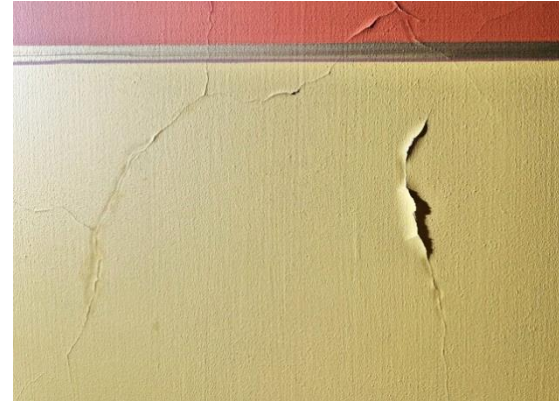
Kuva 8a. Kuvassa vasemmalla näkyy vanha kiinnitys, joka on pysynyt kiinni. Lisäksi on syntynyt uusia irtoamia.
