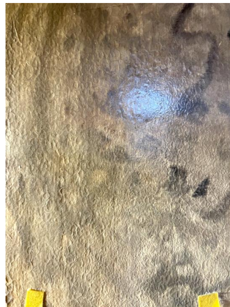
Kuva 14b. Kuva maalinkiinnityksen jälkeen. Kun irtoava maali on kiinnitetty takaisin alustaansa, pinnan kiilto tulee esille. Pilastereissa on sellakka ja ainakin paikoitellen päälle on levitetty jokin vahakerros.
