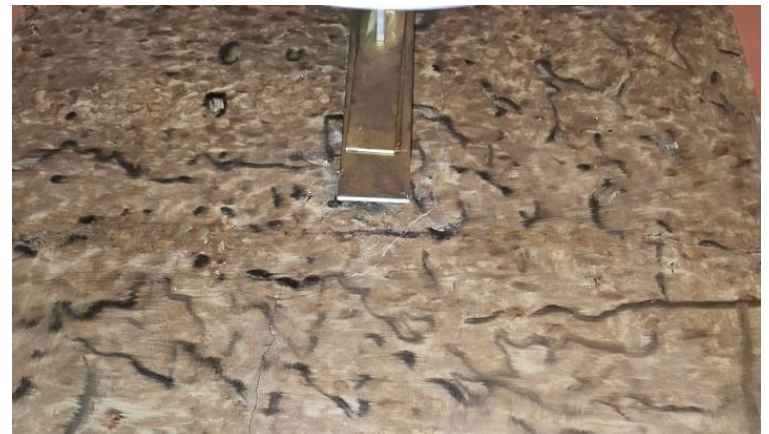
Kuva 24b. Sähköjohtojen tuloreikä kitattuna ja retusoituna.
