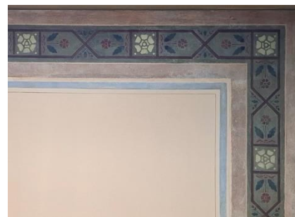
Kuva 6. Katon kulmaus valmistumisen jälkeen. Liimamaalilla maalattu koristemaalauksen elävä ja tasapainoinen kokonaisuus.
