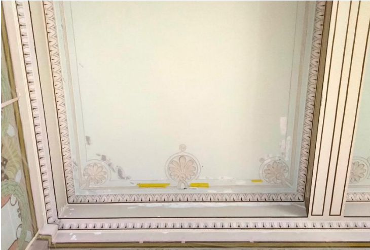
Kuva 2. Reuna-alueiden vauriot tasoitettu.
