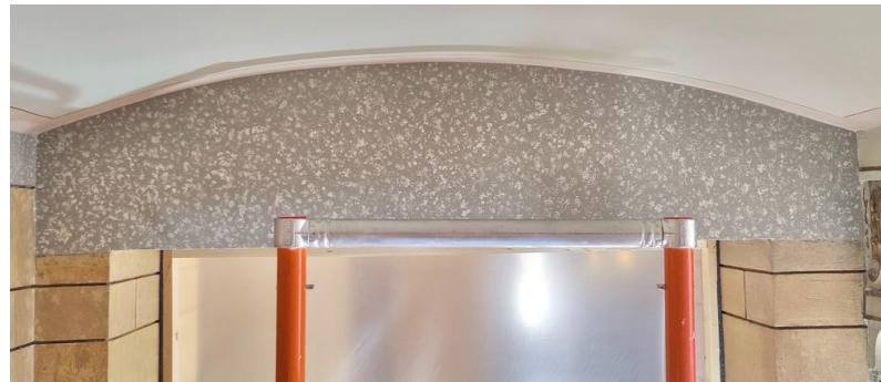
Palkin maalaustyöt valmiina.
