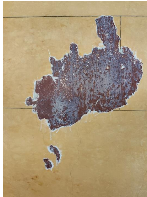
Punaisen liimamaalin päälle oli vedetty jokin eristekerros ennen pohjatöitä.
