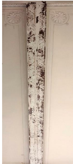
Kuva 5b. Kaikki irtoava aines poistettiin.
