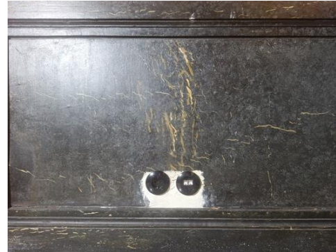
Vauriokohdan uusi rappauspinta on tasoitettu kertaalleen.
