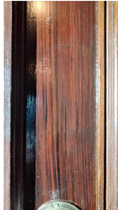
Puukorjausalue ootratu vanhaan pintaan sopivaksi.
