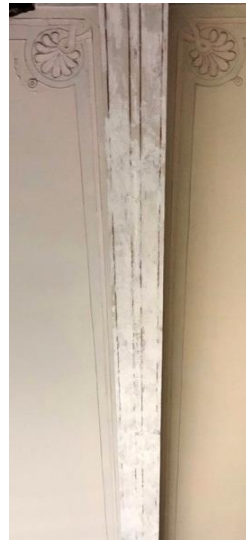
Kuva 5c. Tasoitettu kattopalkin alapinta.
