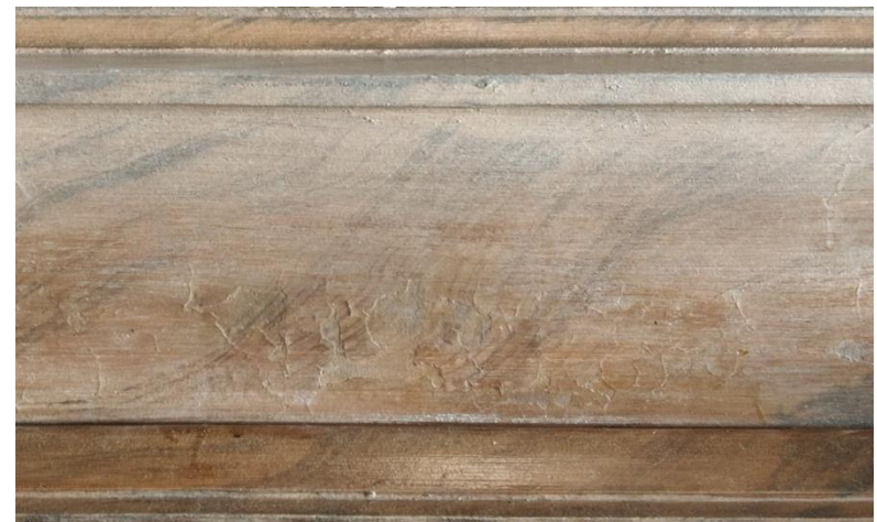
Ovi D204. Irtoavat maalit kiinnitetty ja pinta puhdistettu.
