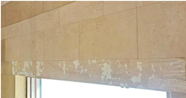
Kuva 6b. Ikkunana yläpuolisen palkin poistoalueet tasoitettu.
