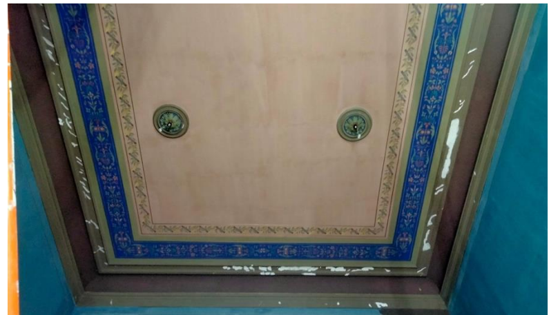
Kuva 8. Listoista poistettu heikosti kiinni oleva aines ikkunan puoleiselta alueelta. Poiston laajuus näkyy vaaleina alueina.
