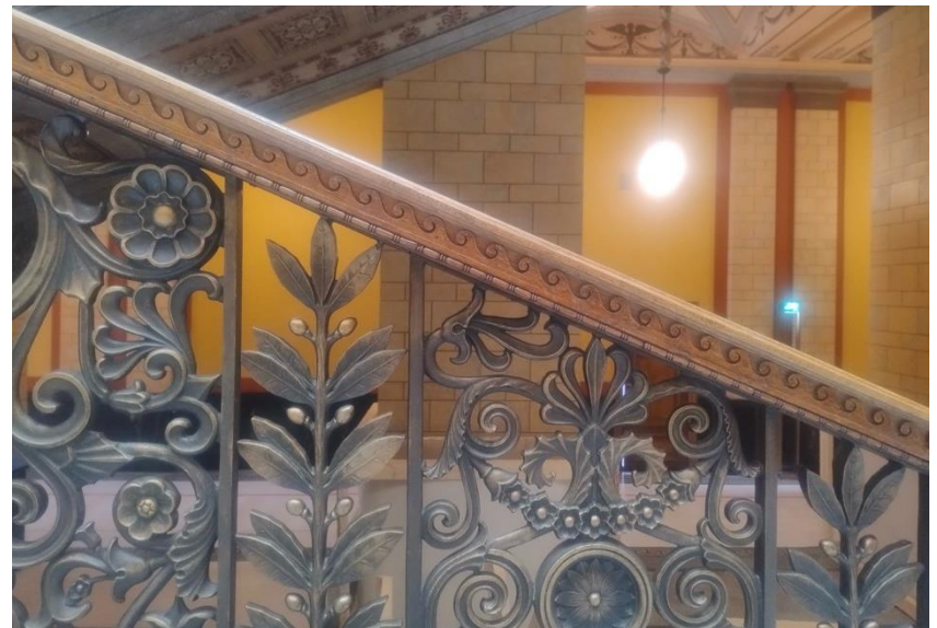
Puukorjaukset laserattu ja lakattu.
