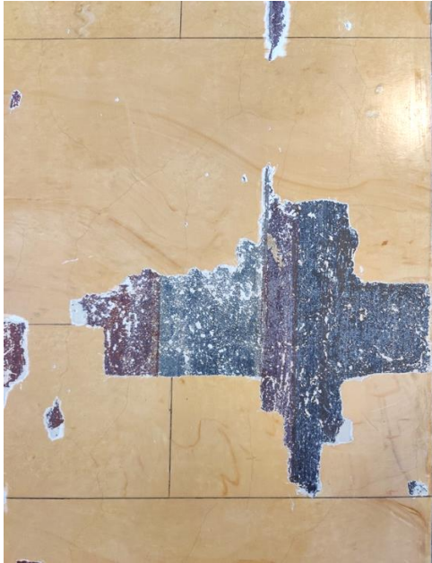
Syöksyn ylemmän tasanteen konsolin alle tehty esiinotto. Alueesta jätettiin esille suorakaiteen muotoinen alue.
