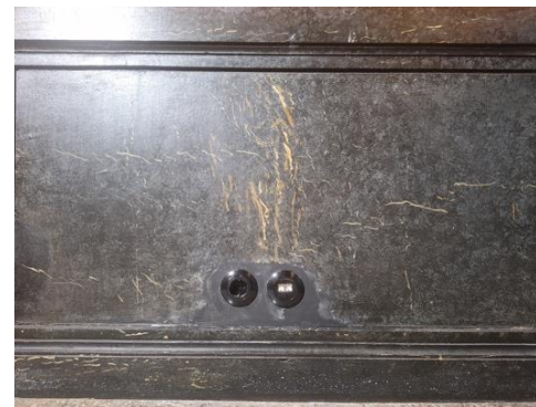
Tasointustyöt valmiit ja alue on maalattu mustalla tartuntapohjamaalilla.
