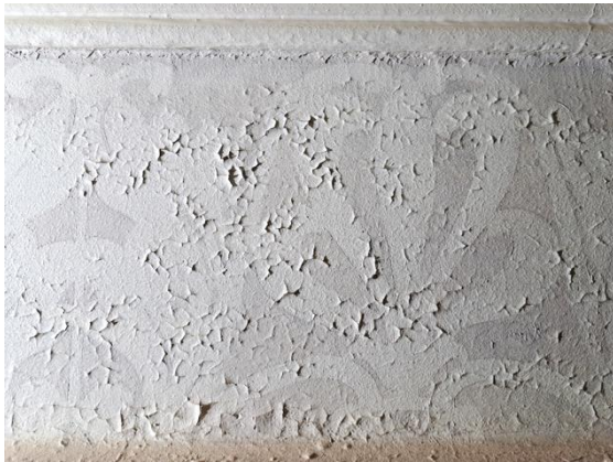
Kuva 4a. Kattopalkkien kylkien irtoavaa maalia. Yksittäiset irtoamat olivat melko pieniä, mutta niitä oli runsaasti. Lisäksi maalikerros oli kova ja irtoamat vahvasti ulospäin käyristyneitä.
