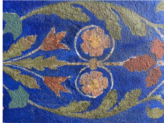
Kuva 4. Yksityiskohtakuva vanhasta koristemaalauspinnasta. Pintaa on retusoitu paljon peruskorjauksen aikana. Retusoinnit on tehty suoraan rappauksen päälle.
