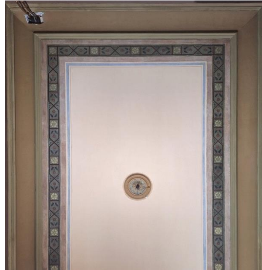
Kuva 7b. Kuvassa katto valmiina ikkunan puoleiselta katon alueelta toimenpiteiden jälkeen. Katon liimamaalatun koristefriisin maali-irtoamat on liimattu ja profiililistat kunnostettu.
