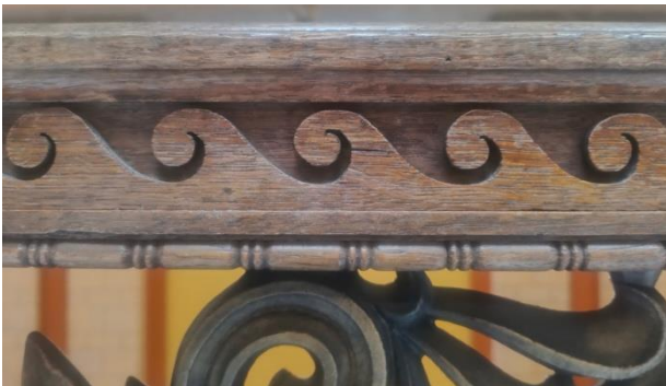
Puukorjaus laserattu vanhan pinnan sävyyn ja lakattu öljylakalla.
