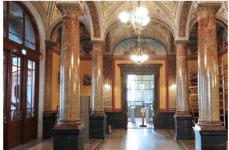
Pylväät uuden sellakkauksen jälkeen. Kuva Laura Väisänen.
