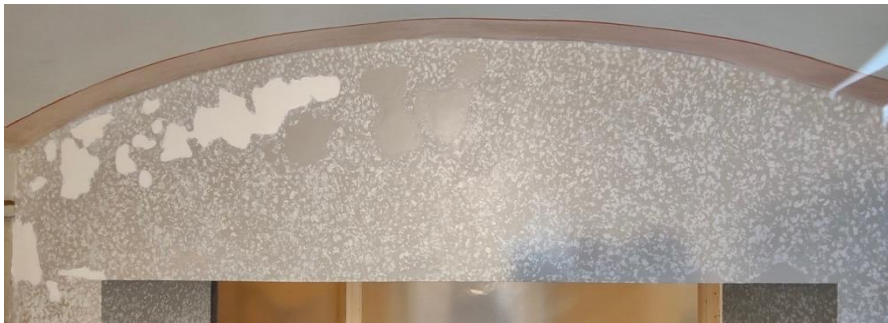
Kittipaikkojen pintamaalaus käynnissä.
