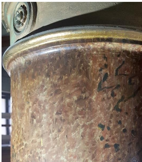
Kuva 18. Yläosan oikea puoli on puhdistettu ennen sellakan ohennusta. Kaikkien pylväiden yläosat olivat tumman lian peitossa. Pylväs 116-5hE.
