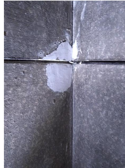
Kulman kolhu on tasoitettu.
