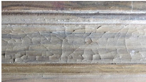
Ovi D207. Maalipinnassa paljon irtoamaa.
