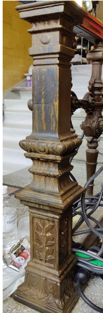
Vahanpoistosta vaurioitunut kaiteen tolppa. Kuvassa tolppa on jo pyyhitty öljyllä, joten pahimmat vaaleat valumajäljet ovat hävinneet.
