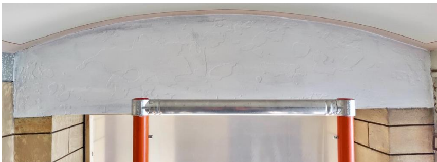
Palkin irtoavat maali- ja kittikerrokset poistettu ja pinta pohjamaalattu.
