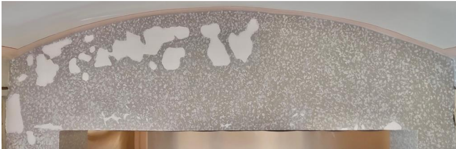
Hissin puoleisen oviaukon yläpalkin maali-irtoamat poistettu, vaurioalueet tasoitettu ja pohjamaalattu.
