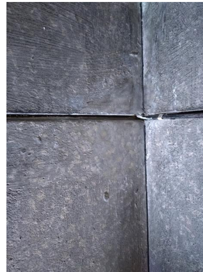
Kulman kolhu pohjamaalattu sävytettyllä tartuntapohjamaalilla ja retusoitu muuhun pintaan sulautuvaksi akryylituubiväreillä.
