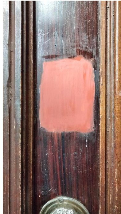
Puukorjaus pohjamaalattu kahteen kertaan oranssinsävyisellä tartuntapohjamaalilla. Vanhan ootratun pinnan alta kuultaa saman sävyinen, vanha pohjamaali.
