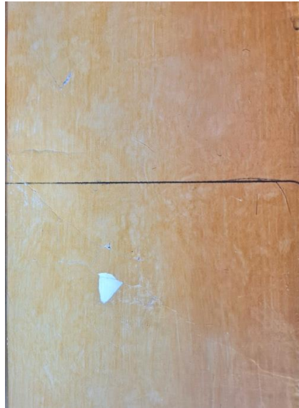
Kuva 4b. Alue kiinnitetty. Seinäprojektio 8.
