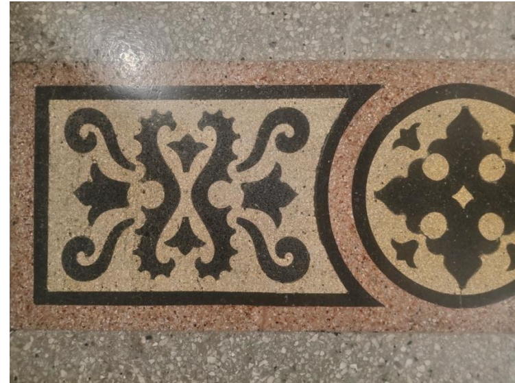
Halkeama puhdistettu ja täytetty sävytetyillä kivikiteillä.
