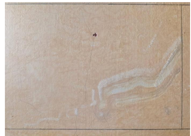
Kuva 2b. Irtoavat maalit kiinnitetty. Puutealueen kohdalta näkyy alla oleva punainen limamaali.
