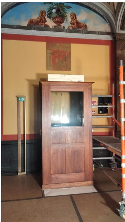
Puhelinkopin päälle rakennettu koroke ennen pintakäsittelyä.
