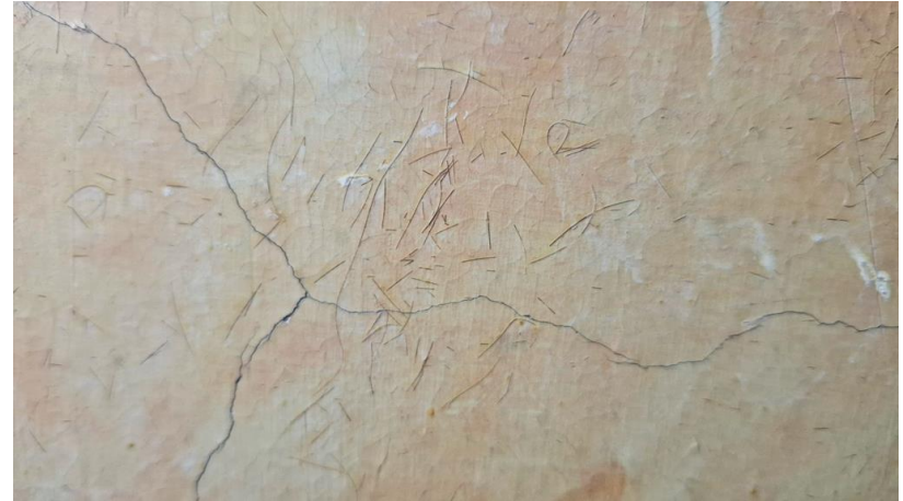
Kuva 16. Lähikuvassa erottuvat siveltimen katkenneet harjaspäät sellakkaan kiinnittyneenä. Seinä 5.
