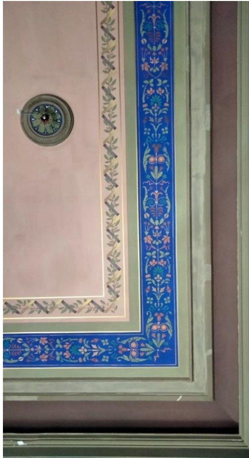
Kuva 9a. Katon puoleisen profiililistan tasainen alue on kangastettu, kitattu ja pohjamaalattu.
