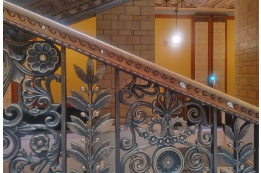
Käsijohteen puukorjauksia ennen pintakäsittelyä.
