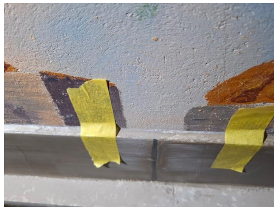
Kuva 4c. Maali-irtoamien kiinnityksen jälkeen kiinnitettiin pohjastaan irronnut lista. Lista on oletettavasti kipsilaastia ja maalattu alkydi- ja öljymaalein 1990-luvun peruskorjauksen yhteydessä. Kiinnityksessä valutettiin HV 498 liimaa kapeasta raosta ja tuettiin teipeillä kuivumisen ajaks
