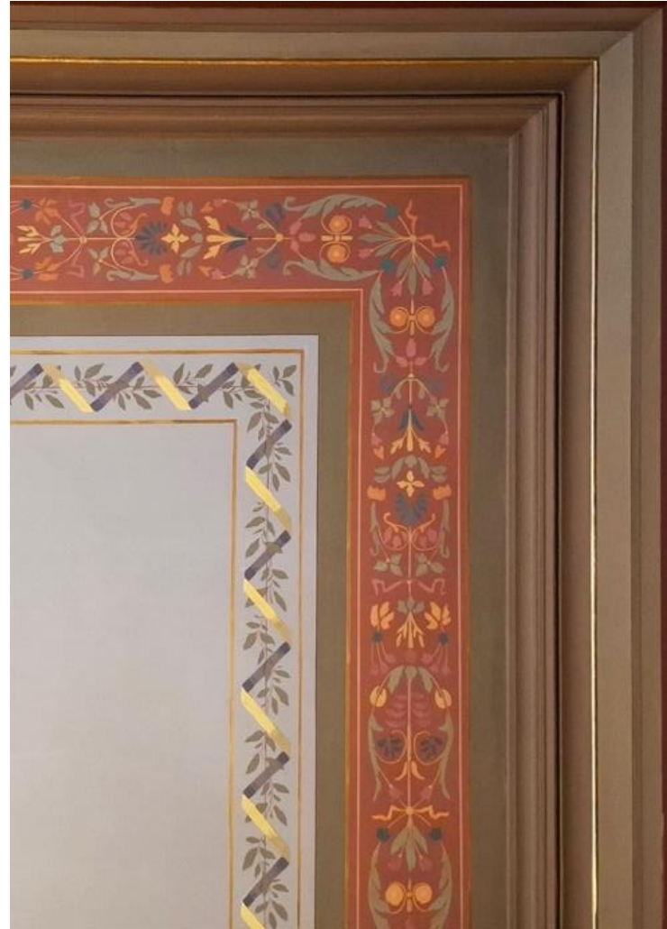
Kuva 1. Kedellisen peruskorjauksen aikaan toteutettu rekonstruktio katon koristemaalauksesta.
