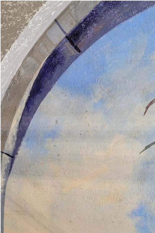
Kuva 1. Esimerkkikuva lunetin karkeasta pinnasta. Lunetti 8.
