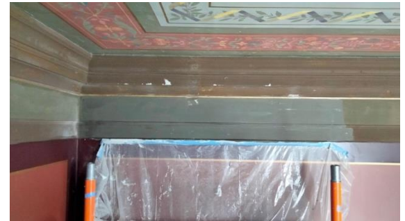
Kuva 6a. Laastipaikkausalue on kitattu muun pinnan tasoon ja pohjamaalattu sävytetyllä Otexilla.
