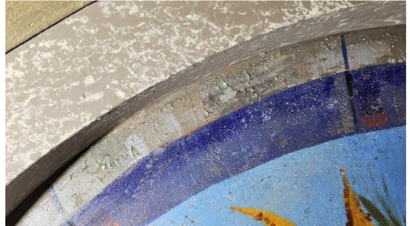
Kuva 2a. Irtoavaa maalia lunettia kiertävässä kehyslistassa. Lunetti 4.
