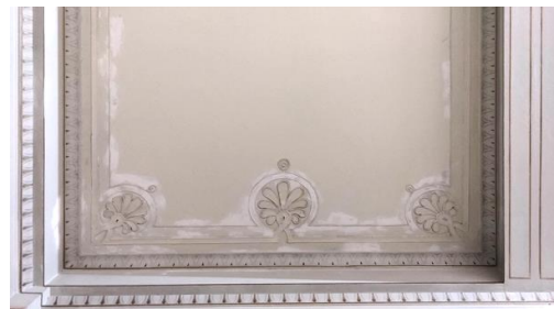
Kuva 1b. Vauriokohdat tasoitettiin Alltek LG ja LF hiekkatasoiteella.
