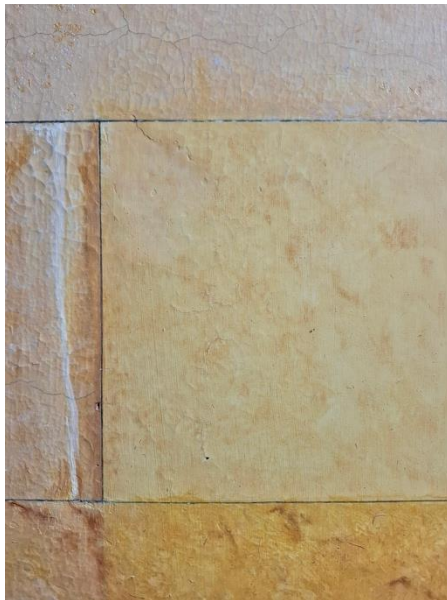
Kuva 2b. Irtoamat kiinnitetty.
