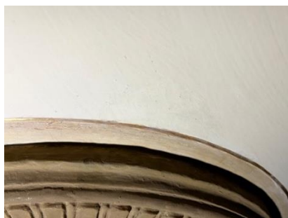
Kuva 5b. Värjäymä retusoitu PanPastel-liiduilla.
