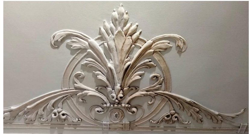
Kuva 1. Kuvassa koristeen oikea puoli on vanhempaa patinointia. Koristeiden vasen puoli on vaalennettu.
