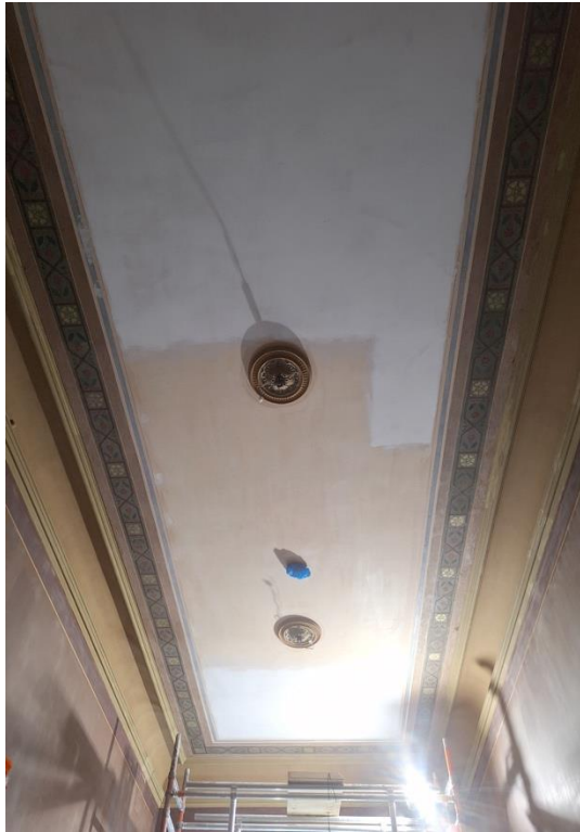
Kuva 4c. Keskikaton vaurioalueet on kangastettu ja ylitasoitettu. Tasoitetut alueet on pohjustettu Otexilla ennen koko katon pohjamaalausta.
