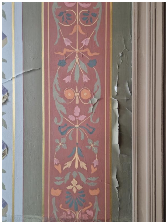
Kuva 3a. Vihreällä liimamaalipinnalla voimakkaasti ulospäin kaartunutta maali-irtoamaa. Irtoama oli paksua ja melko kovaa.
