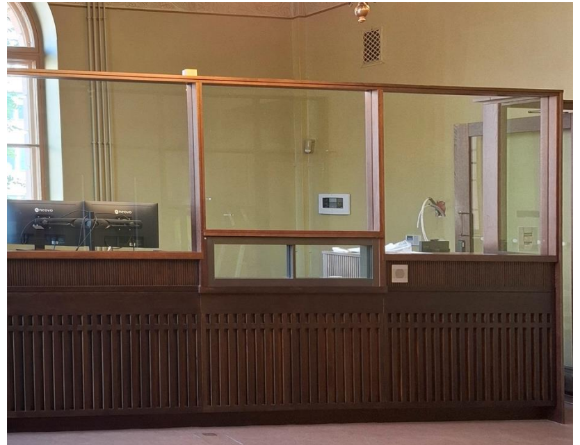
Palvelutiski kuvattu syksyllä 2025. Tiskin asennustyöt ovat kuvaushetkellä vielä käynnissä.
