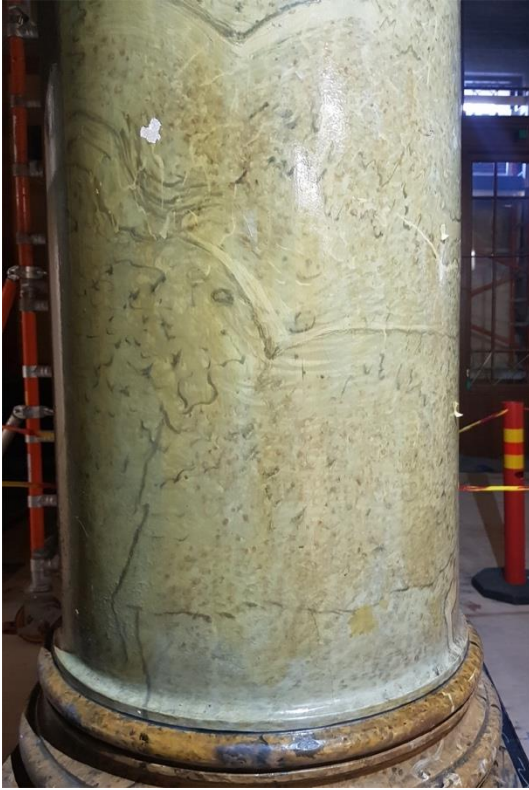
Kuva 5a. Kuva ennen sellakan ohentamista. Pylvään varressa erottuu selvästi epätasainen kellastunut sellakka. Sellakan paksuus määrää keltaisuuden asteen; mitä paksummin on sellakkaa, sitä keltaisempi alue. Pylväs 6hl.
