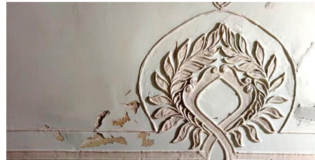
Kuva 1b. Irtonainen aines poistettu. Paikoitellen esille tuli kiiltävää tai jauhoista maali- tai kittipintaa. Nämä alueet pohjustettiin tartuntapohjamaalilla ennen tasoitusta.
