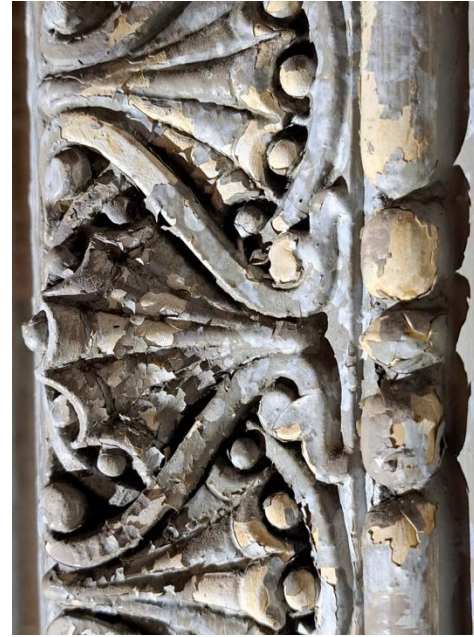
Kipsisen koristelistan irtoavaa maalia ja puutosalueita ennen toimenpiteitä.
