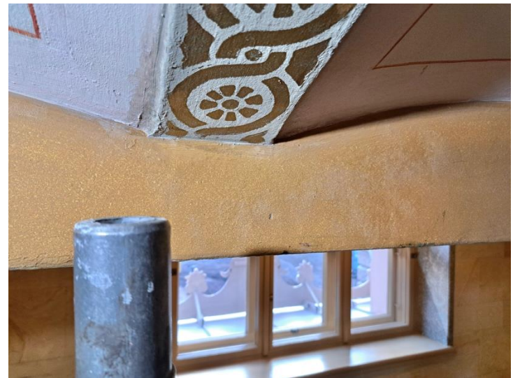
Kattopalkin sivustan irtoamat kiinnitetty.
