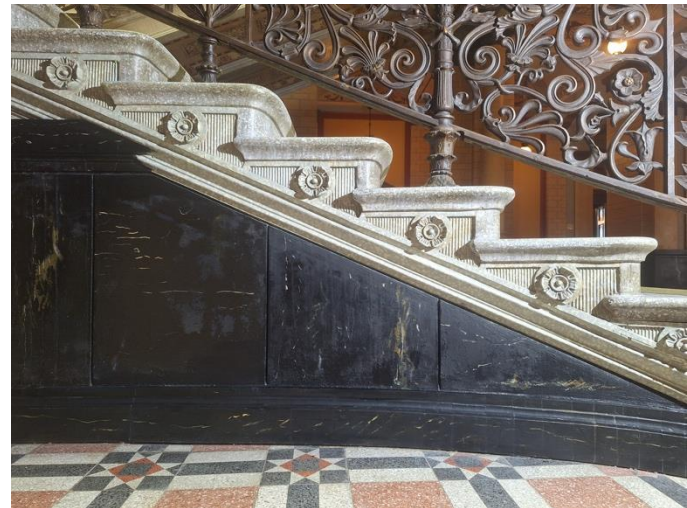
Pinta puhdistettiin ja elvytettiin Sax Hoitoöljyllä. Sama käsittely tehtiin eteläkäytävän itäpäädyn portaan sivun seinämälle.
