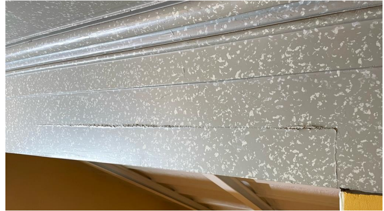
Esimerkkikuva palkin irtoamista.
