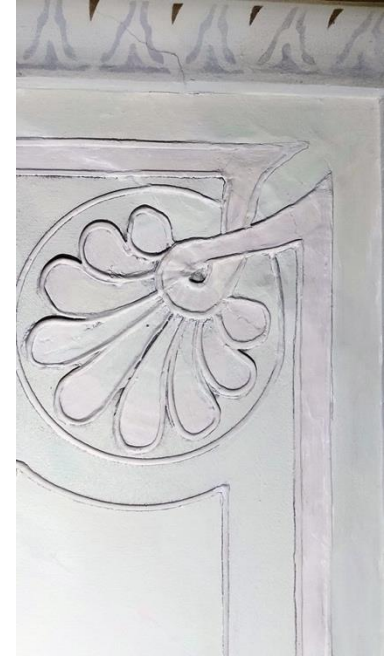
Kuva 3b. Vaurioalue injektoitu ja retusoitu.
