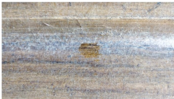
Ovi D219. Kuva pääpalkin lakasta ja sen poistosta. Kuvassa keskellä lakkaa poistettu mekaanisesti.
