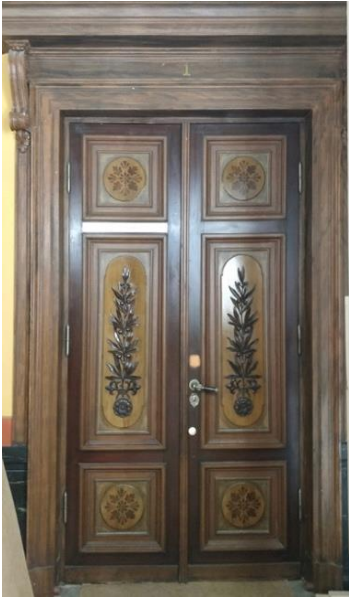
Ovi D109, kuvattu aulasta huoneeseen päin. Ovessa on puusta veistetyt kohokuviot keskipeileissä. Ovenkahvan yläpuolella on lukitusmuutoksista aiheutunut puupaikka.
