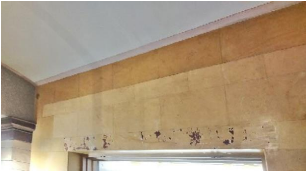
Kuva 6a. Ikkunan yläpuolisen palkin irtoava maali poistettu. Seinäprojektio 8.
