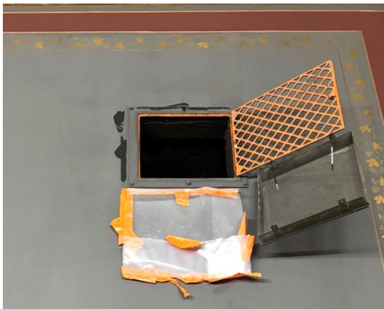
Kuva 4. Suojamuovit poistettiin asentajan toimesta.
