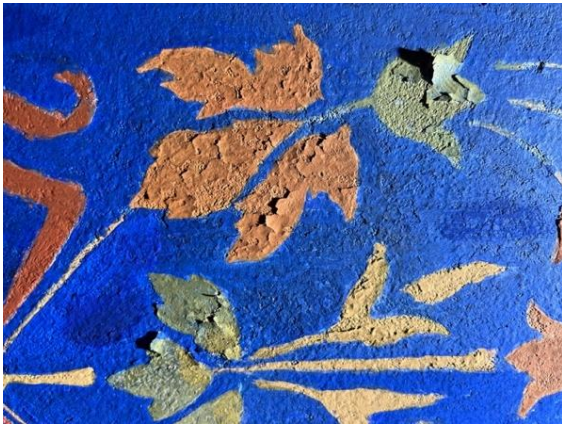
Kuva 3a. Liimamaalilla maalatussa koristeessa on maali-irtoamaa.
