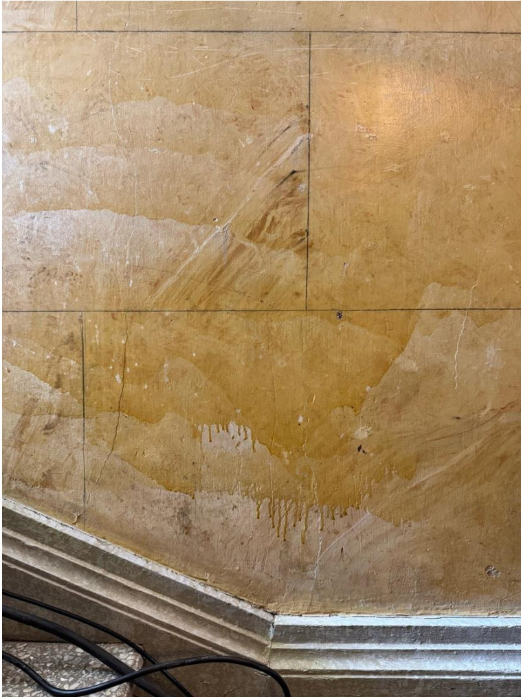
Kuva 12a. Epätasaista lakkausta ja valumia. Seinä 4.
