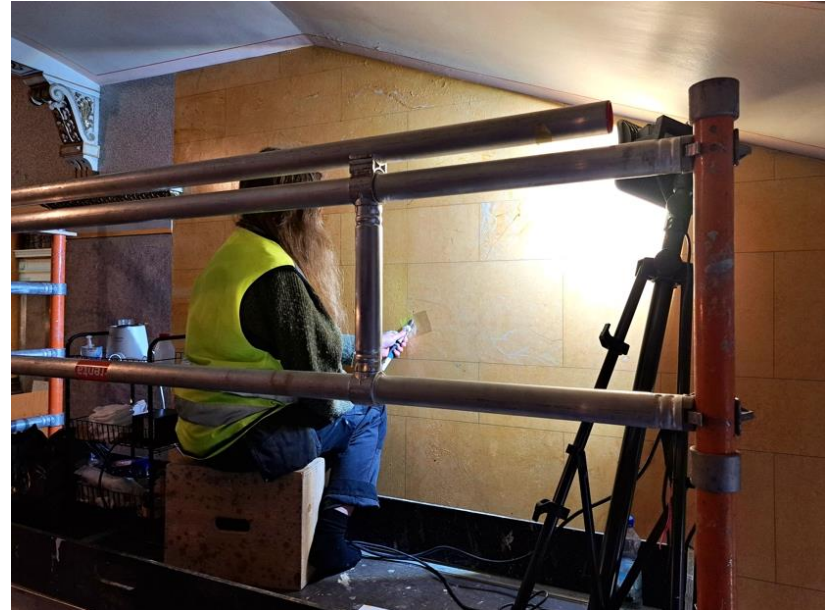
Kuvassa työvälineistöä ja sivuvalon aseointi telineellä portaikossa. Kuvassa konservaattori Emilia Bergholm. Seinä 16.
