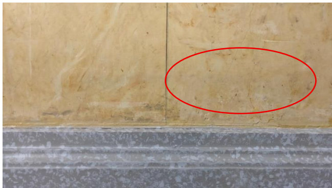
Vauriot tasoitettu ja retusoitu.
