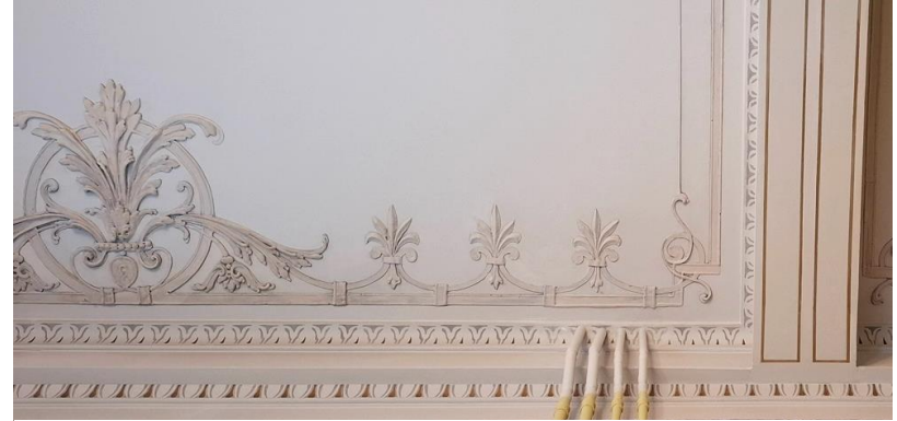
Kuva 4. Katto, koristeet, palkin pohjat ja uusien putkien läpiviennit valmiina.
