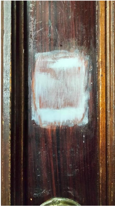
Oven vanhan lukkokohdan puukorjaus kitattu.
