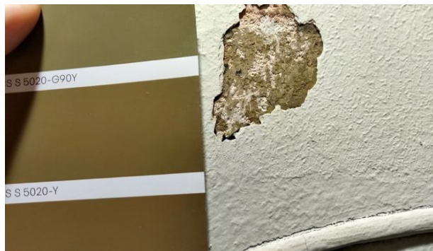
Kuva 10b. Kattopinnoalta esiin tullutta sävyä, jonka lähin sävykoodi on NCS S 5020-Y.
