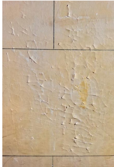
Kuva 1a. Paksua, lohcaremaista irtoamaa. Seinäprojektiio 5.
