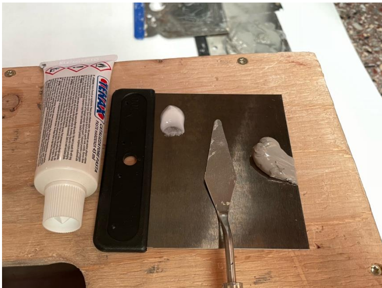
Kivikitti sävytettiin paletilla vanhaan pintaan sopivaksi.
