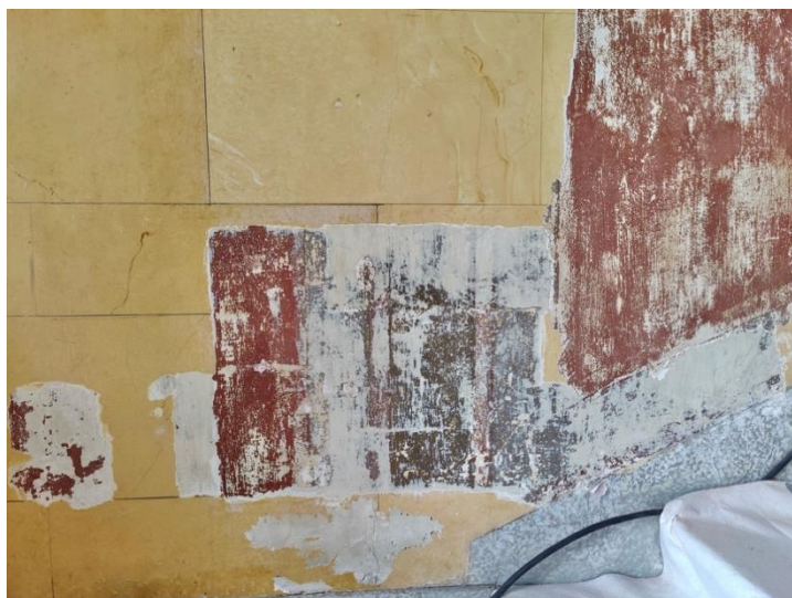
Konsolin kohdalla oleva 1890-luvun pilasterimaalaus.
