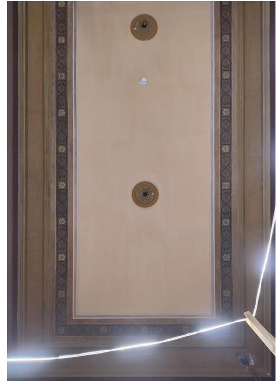
Kuva 4d. Valmis liimamaalattu katto työmaavalaistuksessa.
