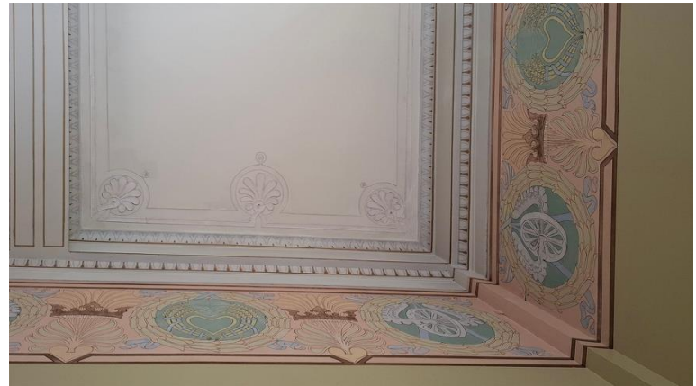
Kuva 9. Kuva valmiista friisistä ja kattopinnasta.
