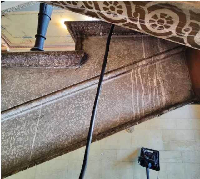
Leveitä valumia portaan kyljen yläpäässä ja katon koristeissa.
