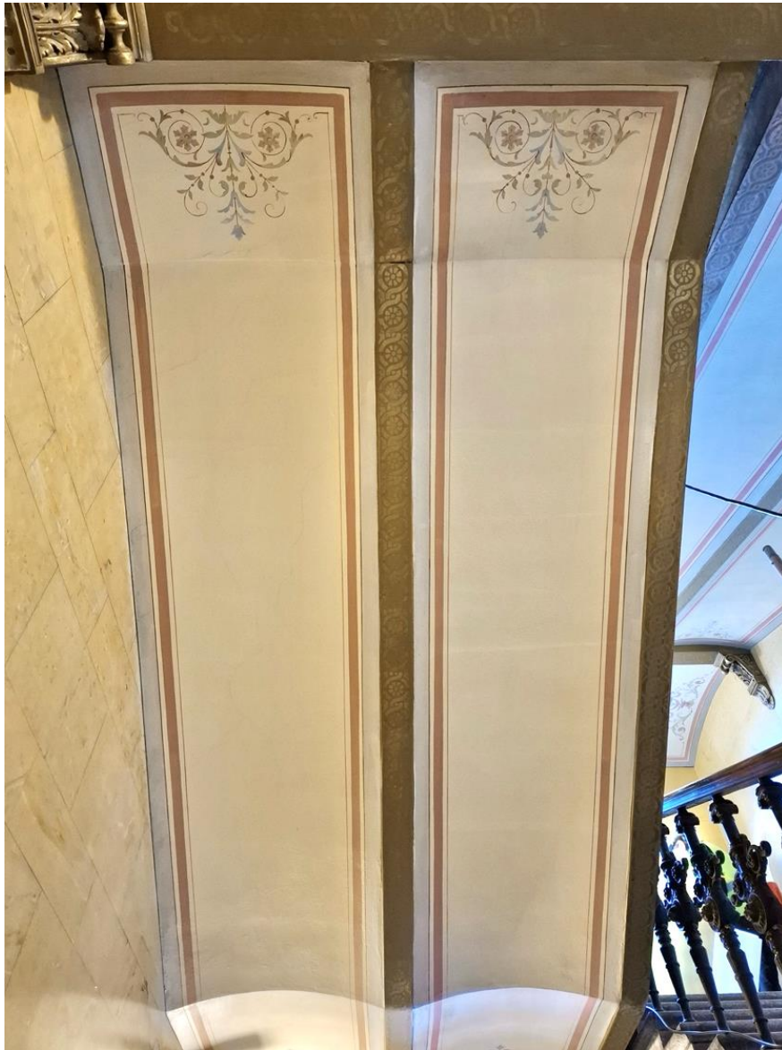
Yleiskuva syöksyn katosta. Katon keskellä ja oikeassa reunassa on rautaisen kannatuspalkin päälle kultamaalilla maalatut koristeet. Seinän 4 katto.
