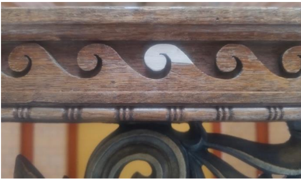
Puukorjaus ennen pintakäsittelyä.
