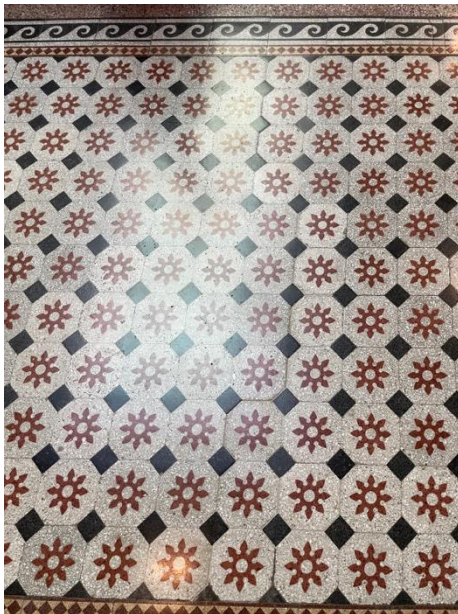
Lattian vauriot korjattu.
