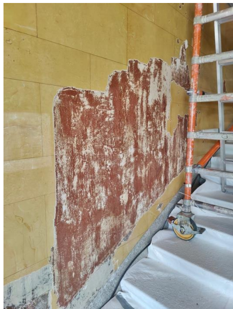
Aluksi oli tarkoitus poistaa kaikki maalikerrokset liimamaalin päältä, jotta saadaan varmasti kestävä lopputulos. Maalikerrokset olivat suurimmalta osin niin tiukasti pohjassaan kiinni, että päädyttiin poistamaan vain selkeästi irti olevat kerrokset. Kuvassa aloitettu poistamaan skrappaamalla kaikki maalikerrokset.
