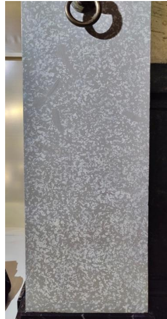
Kuva ylhäällä vasemmalla: Pilasterin kittipaikat pintamaalattu.
