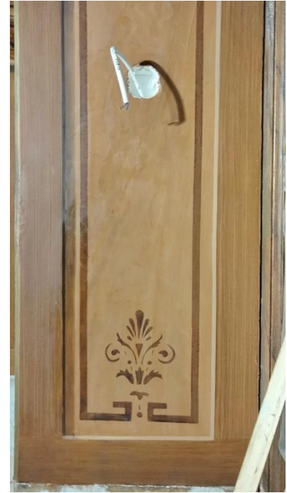
Kuva 18b. Roilon retusointi valmis.
