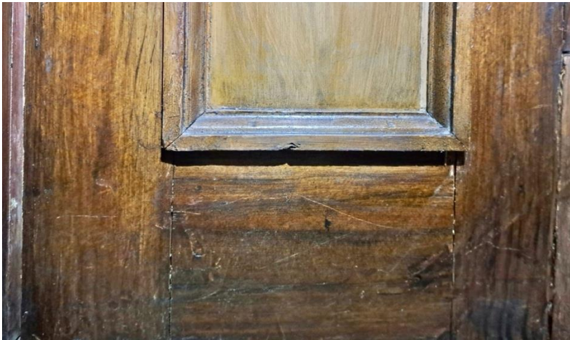
Oven D227 oven smyygin naarmut ja kolhut retusoituina.
