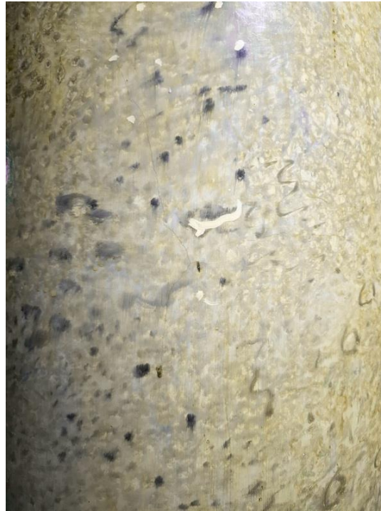
Kuva 7b. Kuva sellakan ohentamisen jälkeen. Valuma-alueilla sellakan ohentaminen aloitettiin pienellä puhdistustollolla paksuimman valumakertymän päältä, siirtyen sellakan ohentamisen edetessä ohuemmille alueille.
