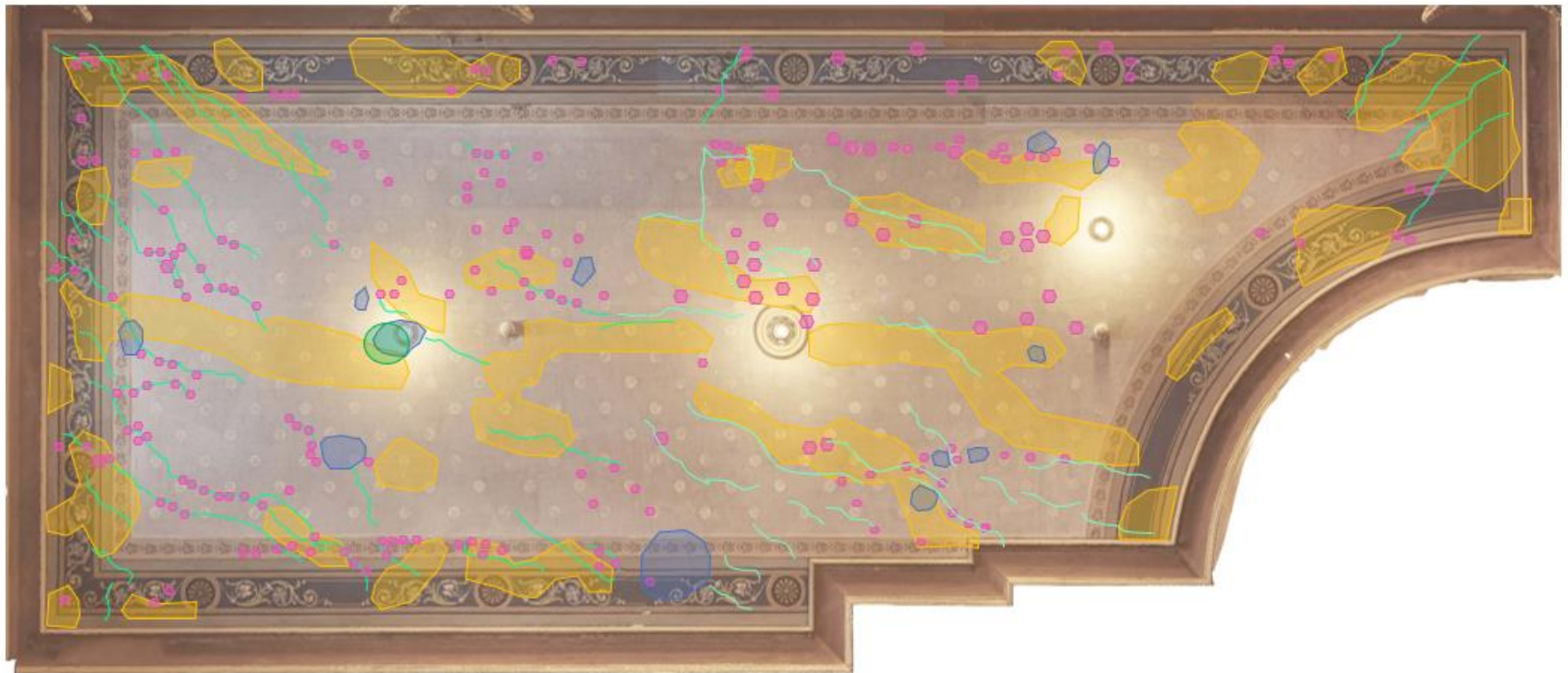
Kuva 9 Katon projektiokuvaan merkityt vaurioalueet
