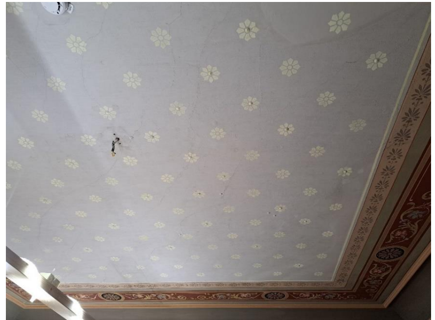
Kuva 16 Paperoidut ruuvikiinnitykset katon takaossa
