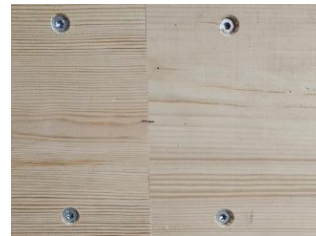
Lattioiden kiinnitsruuvit.
