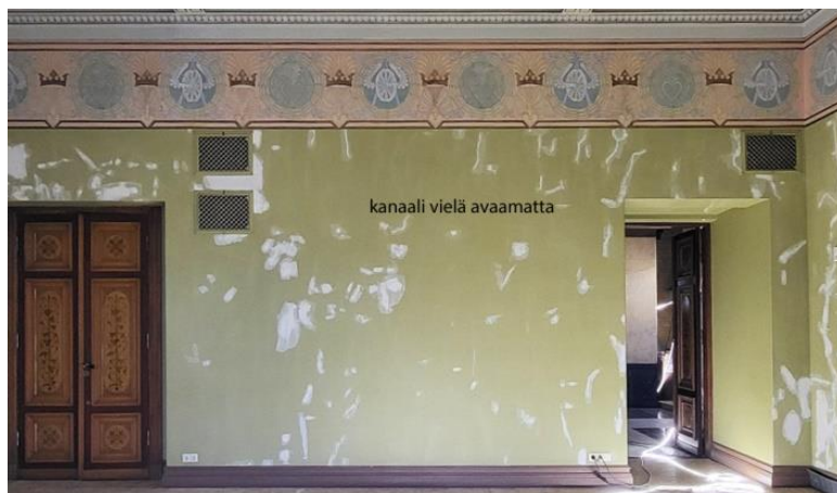
Länsiseinän paikkauksia ennen ilmastointikanaalin avausta.
