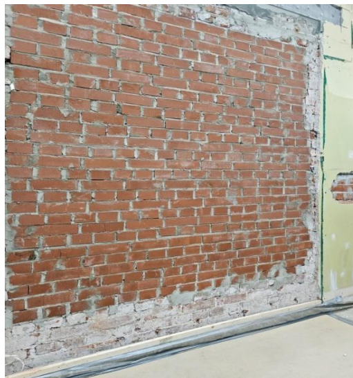
Kanaaliaukon tiilimuuraus.
