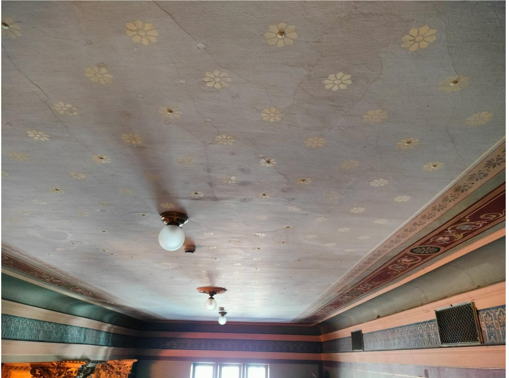
Kuva 56 Tilan 330 parvikatto kiinnitystoimenpiteiden jälkeen. Valaisimet on asennettu paikoilleen, ja oikean holkkalistan alareunassa kulkevat kaapeloinnit paperoitu. Etualan ruuvikiinnitykset ovat kirkaassa sivuvalossa helposti erotettavissa, mutta mitä kauempaa kattoa tarkastellaan, sitä huomaamattomampia kiinnitykset ovat. Kuvaaja Ilpo Heikkinen
