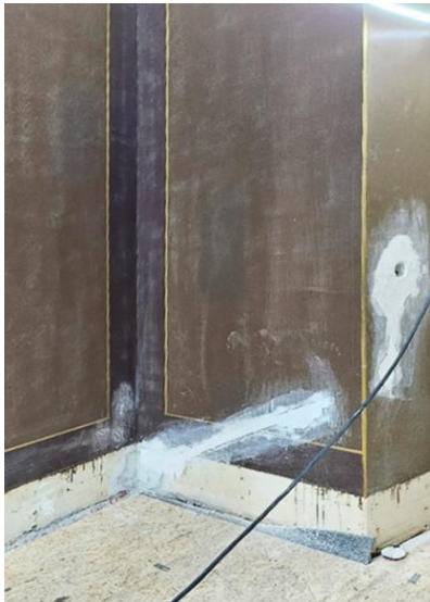
Saneerauskiipsilaastilla täytettyjä roiloja.
