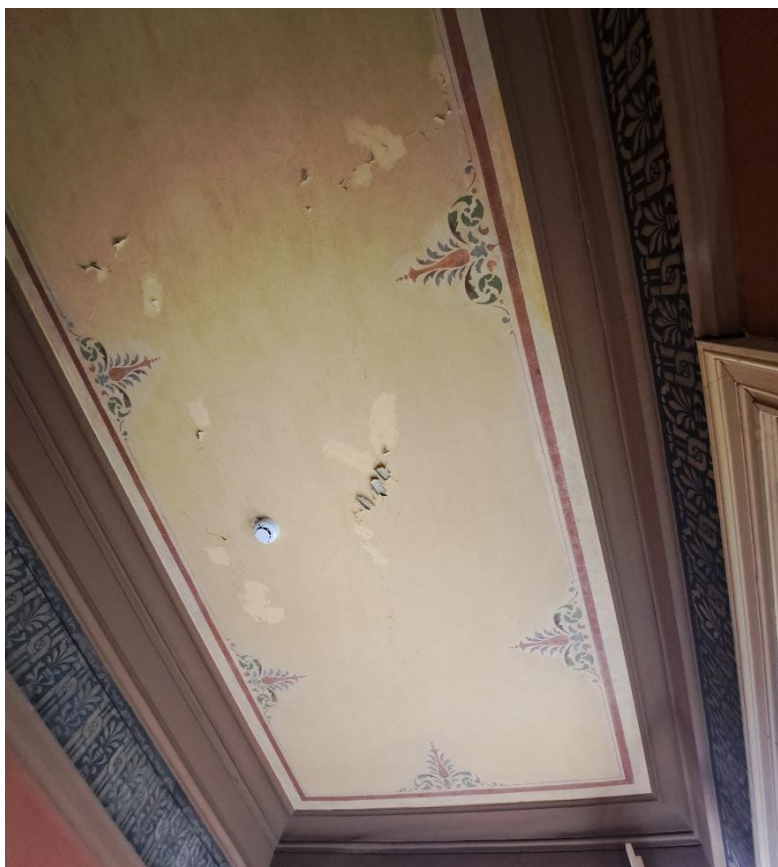
Kuva 46 Yleiskuva 323 parven katosta ennen toimenpiteitä
