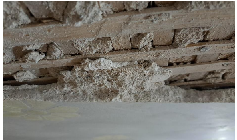
Kuva 27 Reunaan jäänyt injektointituenta
