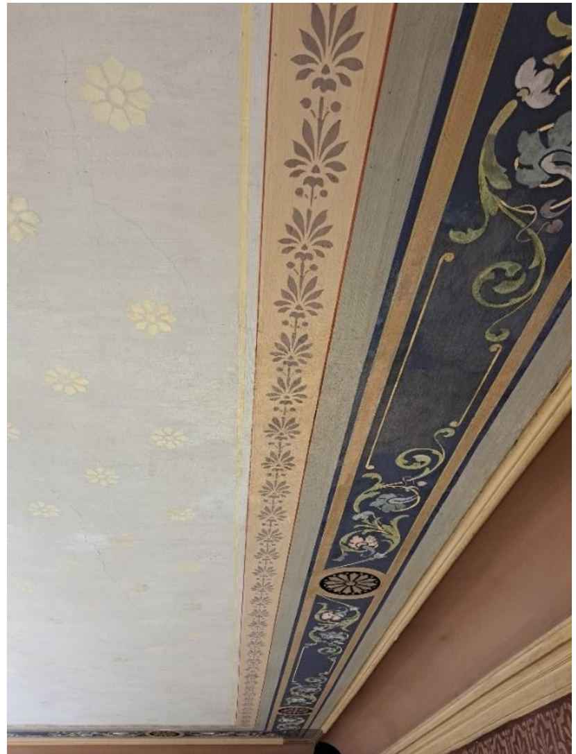
Kuva 23 Yleiskuva tilan 224 katosta
