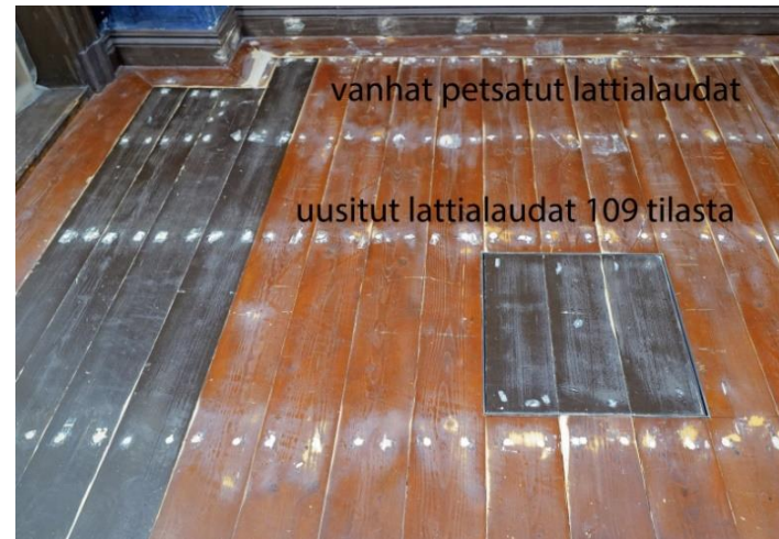
Lattiakorjauksia ennen uusinta laseerausta.
