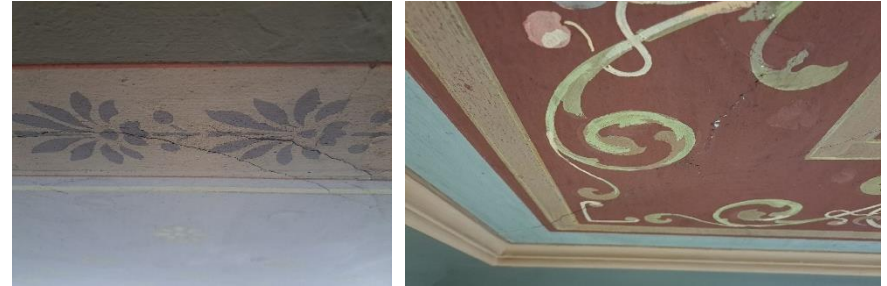
Kuva 7 halkeamakohtia reunafriisin alueella
