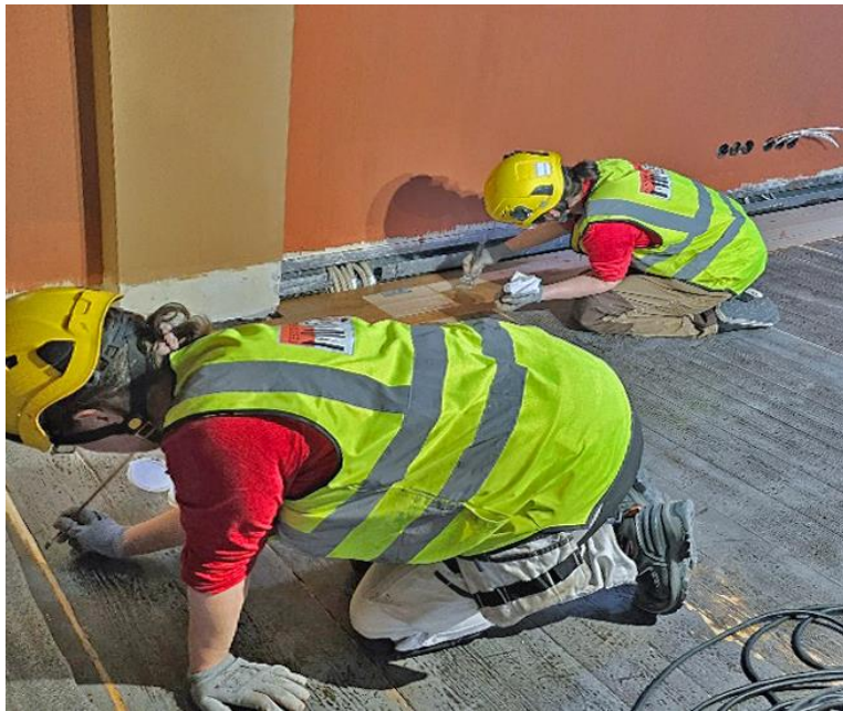
Tiedotustilan lattian paikkalaseerausta.
