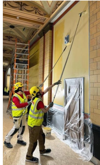
Porrashallin pohjamaalaustyöt käynnissä.
