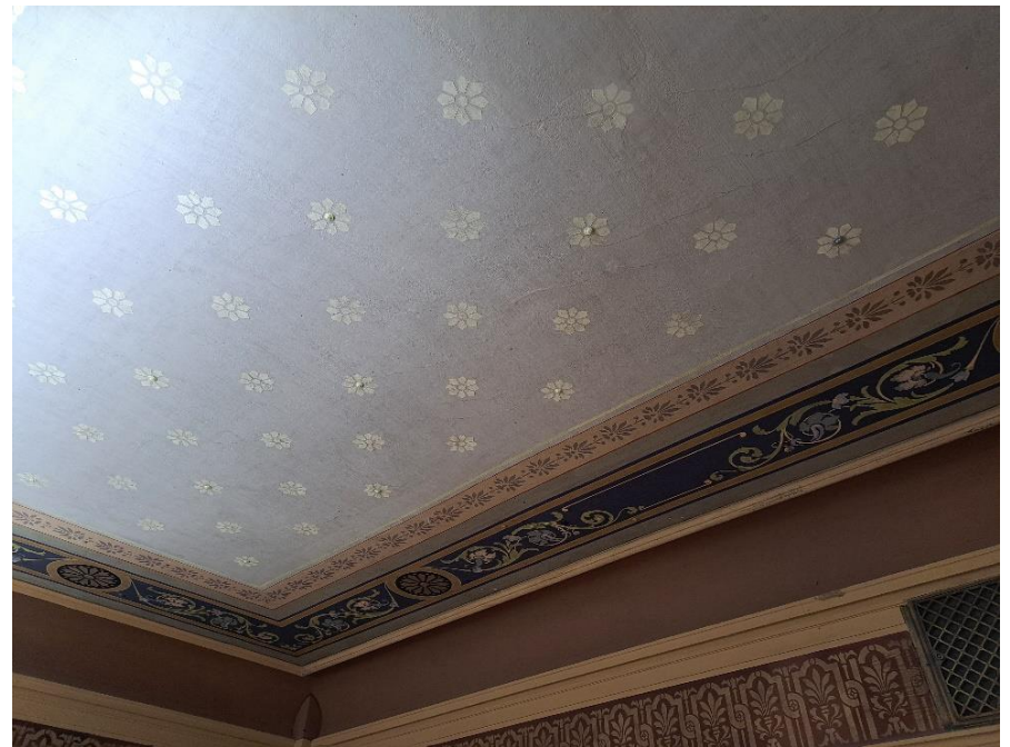
Kuva 35 Yleiskuva kiinnitysten jälkeen
