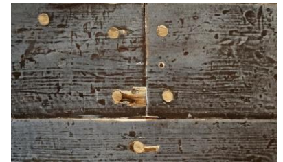
Ruuvikiinnitysten puutapitukset.
