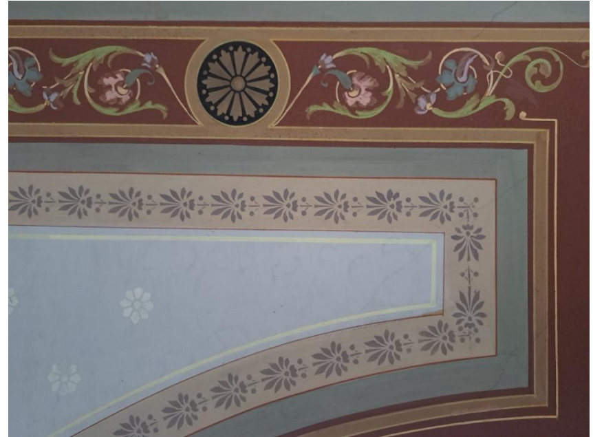
Kuva 12 Yleiskuva katosta sisäänkäynnin kohdalta
