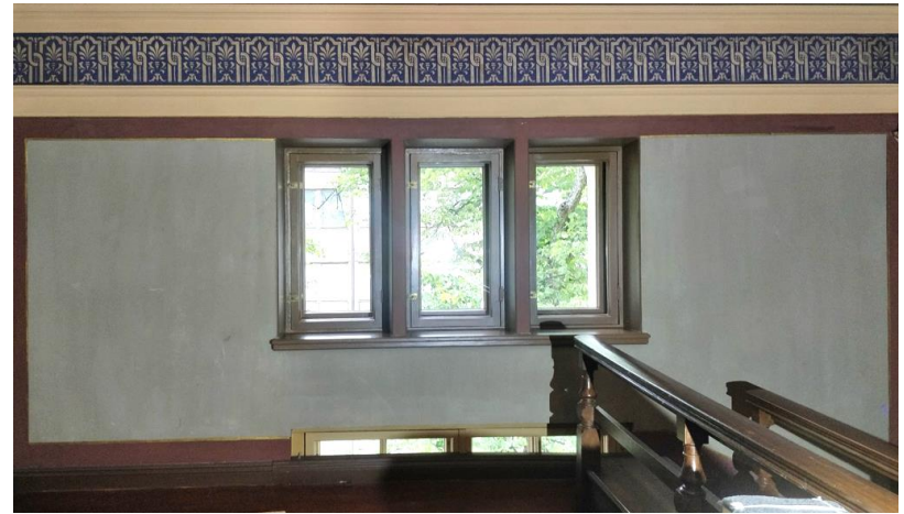
Parven ikkunat pohjoisseinällä.
