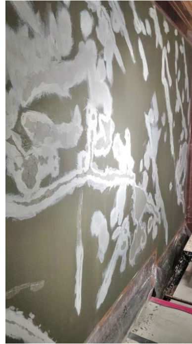
Kuva 6c. Seinästä poistettiin kaikki irtoavat kerrokset. Kuvassa nähtävissä vaurioiden laajuus. Syvät kolot ja halkeamat pohjustettiin tartuntapohjamaalilla ja täytettiin ensin kipsilaastilla ja tasoitus LG tasoitteella. Lopuksi seinä vahvistettiin pintavahvistuskankaalla.
