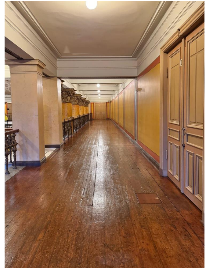
Pohjoispuolen käytävä. Kuvassa kunnostetut katot, seinäpinnat ja ovet. Lattian kunnostus Restaurointimaala us Mimos Oy, Riitta Karjalainen.
