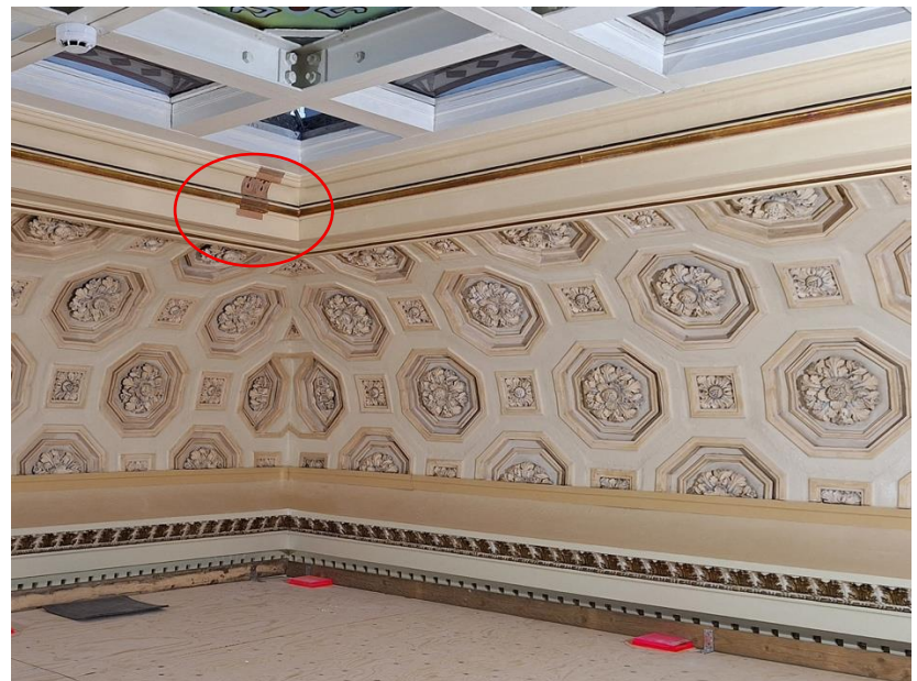
Ylälistan osuudella, maalikerrosten alla, on säilynyt alkuperäinen maalauskoristelu, jota otettiin esille lounaisnurrassa.
