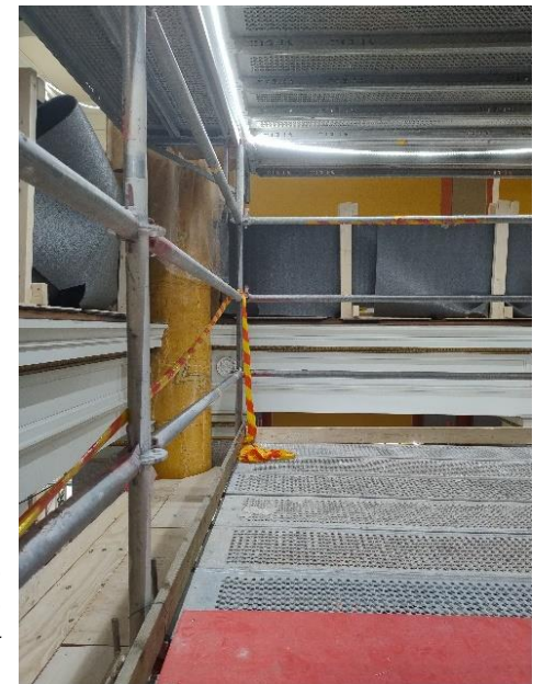
Kuvassa palkiston luoteiskulman restaurointimaalaustyöt ovat valmiit.
