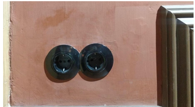
Parven 327 sähköpuruista ja asennuksista syntyneet vauriot korjattu.
