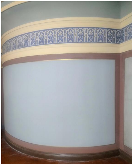
Valmis liimamaalattu seinä. Liimamaali valmistettiin työmaalla ja sen sideaineena käytettiin luuliimaa.
