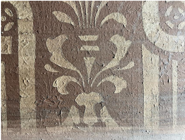
Kuva 7. Sivuvallolla kuvatussa kuvassa näkyy, kuinka nykyisen koristeen alta erottuu varhaisempi koristemaalaus kohokuviona.
