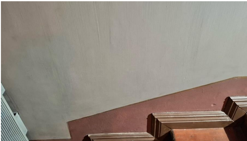
Kuva 7b. Maalipinnan nuhjaantuneisuus saatiin tasattua luonnonkumisienellä pyyhkimällä.
