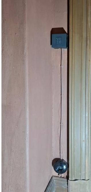
Kuva 9b. Johdon takana ollut valkoinen massa poistettiin ja alueet retusoitiin.
