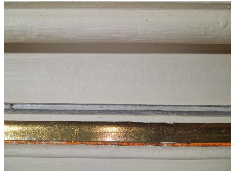
Viereisen kuvan matalat väri-irtoamat kiinnitettynä. Liimana käytettiin 10% sampiliimaa, ilman alkoholilisäystä.
