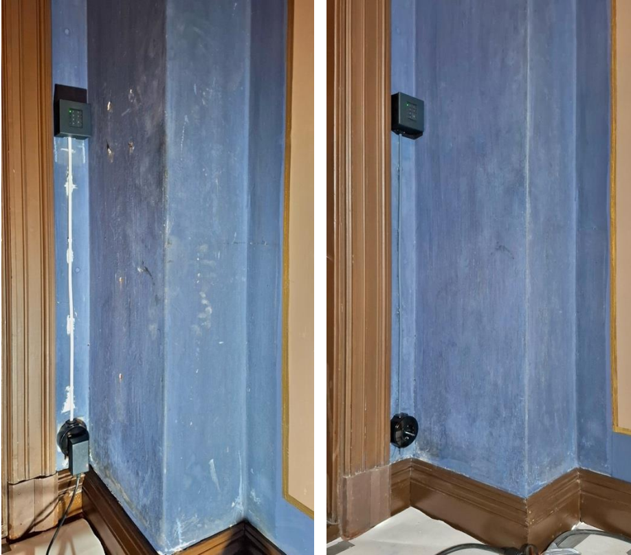
Kuva 7a ja b. Itäseinän pohjoispäädyn nurkassa vanha, sininen liimamaali oli nuhjaantunut ja osa maalista oli pyyhkiytynyt pois. Retusointi tehtiin PanPastelleilla. Kuvassa näkyvät sähkötöistä syntyneet ruuvien reiät täytettiin LG ja LF tasoitteilla. Johdon takana oleva valkoinen massa poistettiin ja alueet retusoiitiin. Johto maalattiin sävytettyllä alkydimaalilla. Kuvat ennen ja jälkeen retusointien.
