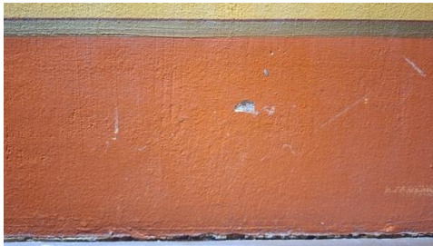
Kuva 6b. Kehyksen irtoamat kiinnityksen jälkeen.
