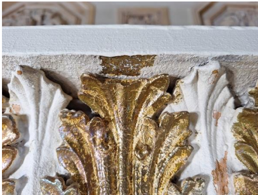
Lehden kärjen puutealue on korjattu maalaamalla.
