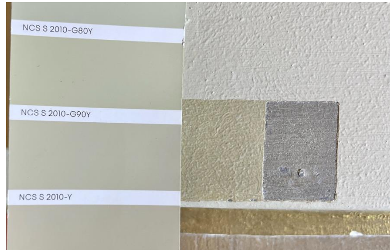
Metallisen kapiteelin toinen, eli vuoden 1904 öljymaalikerros, hakkurilla toteutettu. Lähin sävykoodi NCS S 2010-Y.
