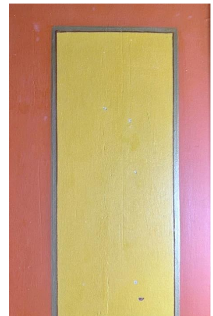
Kuva 1b. Maali-irtoamat kiinnittyivät hyvin alustaansa.
