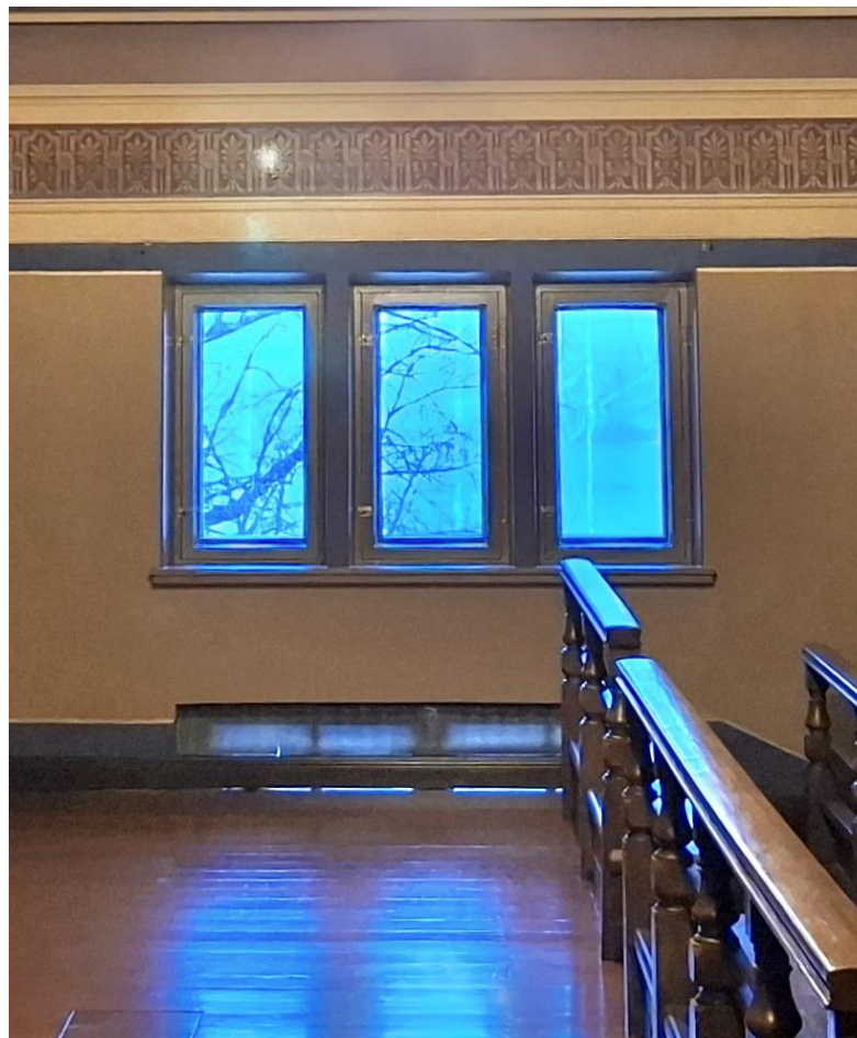
Parven 324 eteläseinällä sijaitsevat ikkunat.
