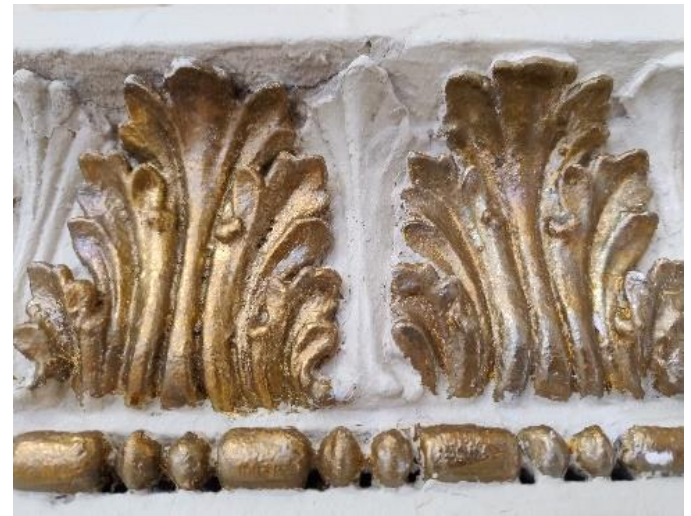
Uudet lehtien kärjet pohjustettiin ohuella pohjamaalilla. Retusointiväriä öljylakka, joka sävytettiin metallijauhe- ja kuivapigmenteillä.
