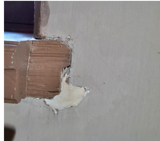
Kuva 8a. Pohjoisseinällä ikkunapenkin juuren syvä kolo täytettiin kipsilaastilla, tasoitettiin LG ja LF tasoitteilla.
