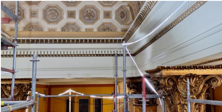
Ylempi palkisto, jonka pohjatöiden yhteydessä löytyneet alkuperäiset liimamaalipinnat dokumentoitiin.
