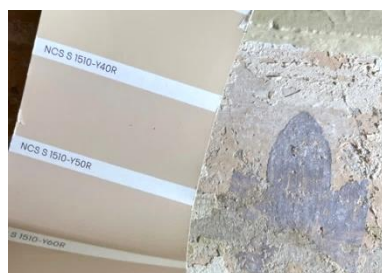
Vesivaurioalueen koristemaalauksen tausta NCS S 1510-Y50R. Oletettavasti sävyt ovat olleet samat, mutta muuttuneet joko kosteuden tai esiinoton seurauksena.
