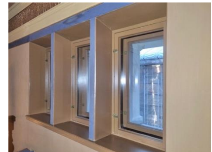
Kuvassa smyygit valmiina. Pintamaalaus tehtiin Saxotolin pellavaöljymaalilla.
