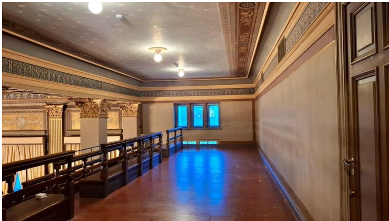
Parvi 330. Konservointityöt valmiina.
