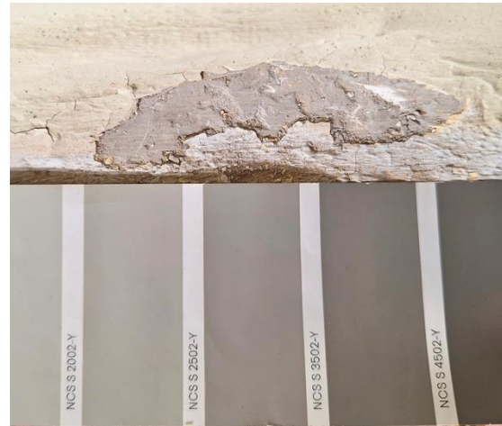
Yläpalkiston arkkitraavin 1990-luvun peruskorjauksen aikaisen öljymaalipinnan alta tuli esiin harmaa liimamaali. Lähin sävykoodi oli NCS S 2502-Y.
