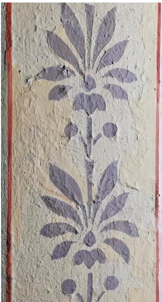
Kuva 1a. Katon palmettikuviossa oli paljon irtoamaa sekä vanhoja retusointeja.
