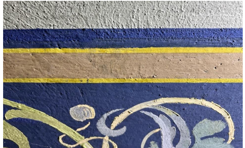
Kuva 2b. Viivoitusalueen irtoamat kiinnitetty.
