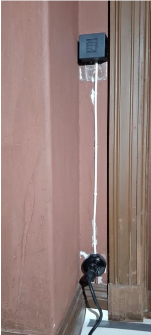
Kuva 9a. Kuvassa eteläseinällä uusi sähköasennus.
