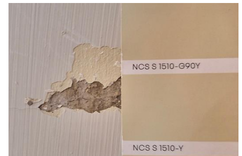
Palkiston nykyisen maalipinnan alla on vaaleankeltainen öljymaalipinta vuodelta 1904. Lähin sävykoodi oli NCS S 1510-G90Y / 1510-Y.
