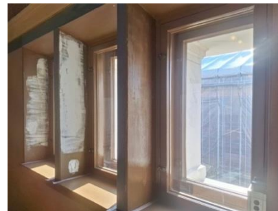
Vaurioalueet tasoitettiin, pohja- ja välimaalattiin Saxotol öljymaalilla.
