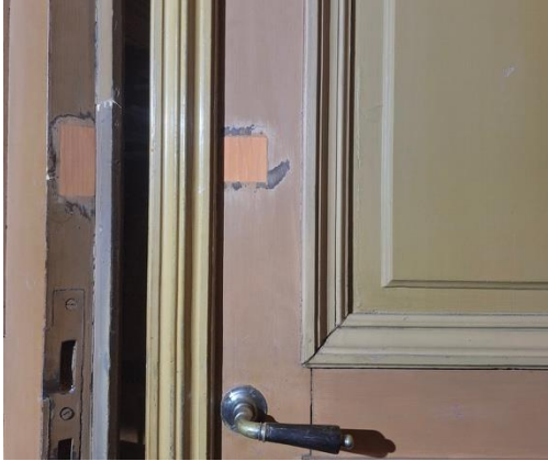
Parvelle 330, porvariston salin itäpäähän johtava ovi. Oven lukitukset on vaihdettu ja vanhaan lukkoreikään asennettu puupaikka.
