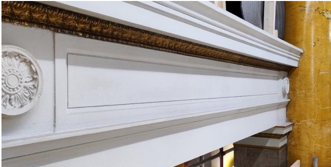
Keskipalkisto ja kapiteeli (kuvan oikeassa alareunassa), jonka pohjatöiden yhteydessä löytyneet alkuperäiset liimamaalipinnat dokumentoitiin.
