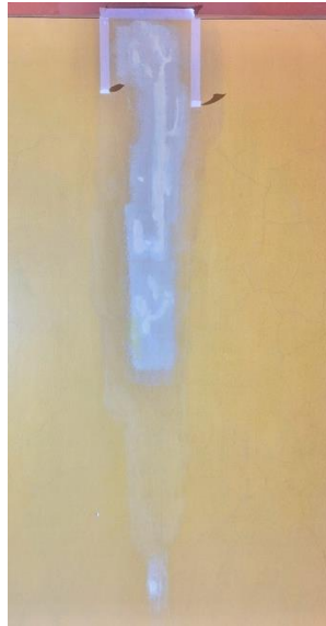
Kuva 10a ylhäällä vasemmalla: Tummunut paikkamaalaus, jossa irtoavia maali- ja tasoitekerroksia.
