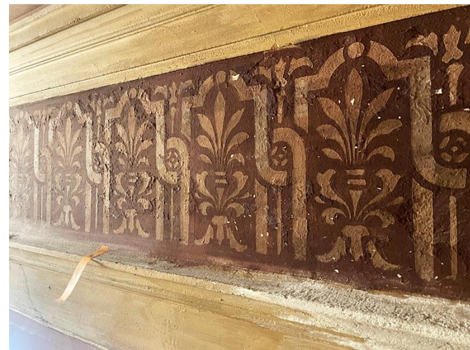
Kuva 3. Esimerkkikuva friisin irtoavasta liimamaalista.
