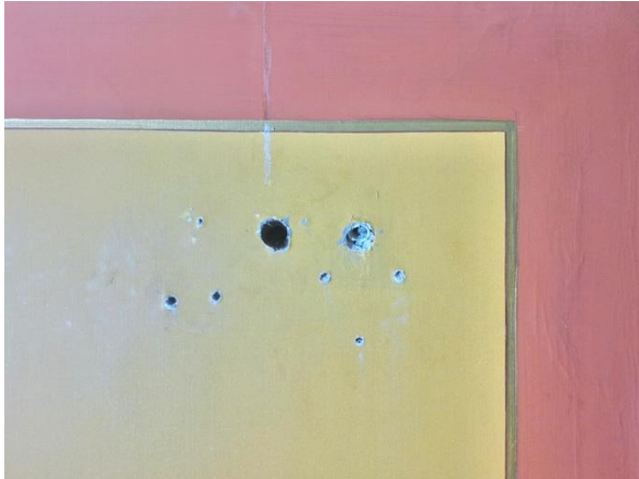
Kuva 12a. Poran reiät seinässä täytettiin ensin kipsilaastilla, tasoitettiin LF ja Snickeri A. Kuva eteläseinällä (itäpääty).
