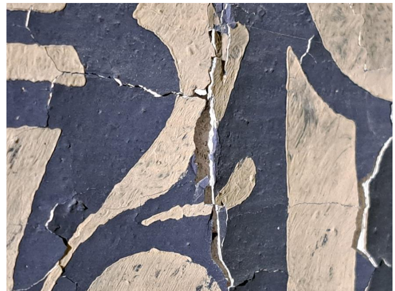
Kuva 3. Esimerkkikuva paksuista ja kovista irtoamista.
