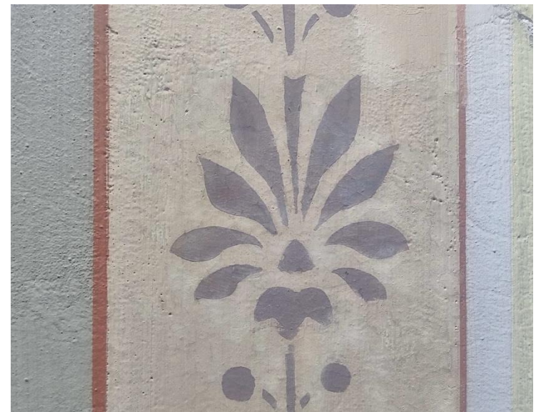
Kuva 1b. Maali-irtoamat kiinnitetty.
