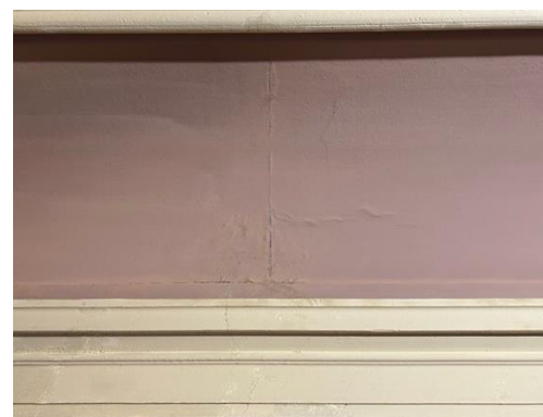
Kuva 11b. Vahvikkeen alusta imuroitiin aukeaman kohdalta ja vahvike liimattiin takaisin alustaansa.
