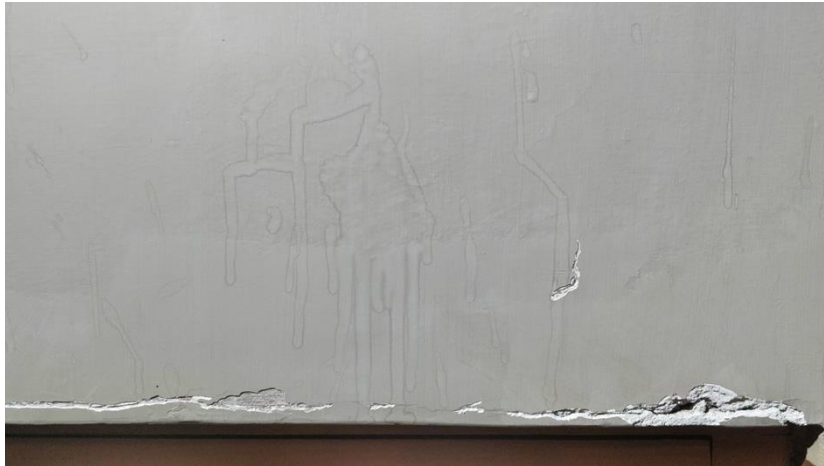
Kuva 5a. Pohjoisseinän lattian rajassa olevien ikkunoiden yläpuolella sijaitseva halkeama ja roiskejälkiä liimamaalissa. Halkeamasta poistettiin irtoava aines, täytettiin kipsilaastilla ja tasoitettiin LG ja LF tasoitteilla.
