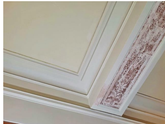
Kuva 7c. Katon ja listojen paikkamaalaus valmis.
