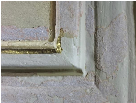
Kuva 7a. Irtoamien poiston yhteydessä esille tullutta vanhaa liimamaalipintaa, sekä pieni kultaviiva.
