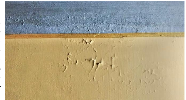
Yleiskuva itäseinän nuhjuisuudesta. Seinän liimamaali oli 1990-luvun peruskorjauksen ajalta ja maalin sideaineena oli metyyliiselluloosaliisteri.
