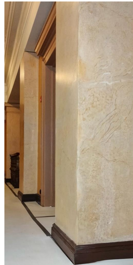
Kuva 15b. Kolhu kitattu ja retusoitu.
