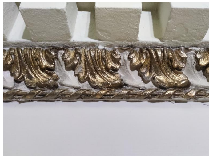
Tausta retusointiin vaalealla, keskiharmaalla sävyllä ympäröivän pinnan mukaan. Maalina öljytuubivärit.
