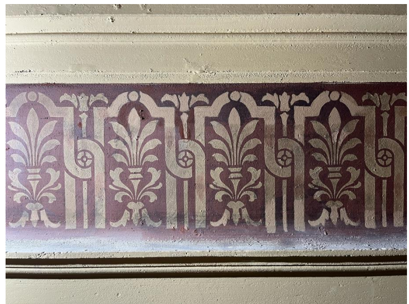
Kuva 5. Paikkamaalaukset erottuvat vaaleampina vanhasta pinnasta.
