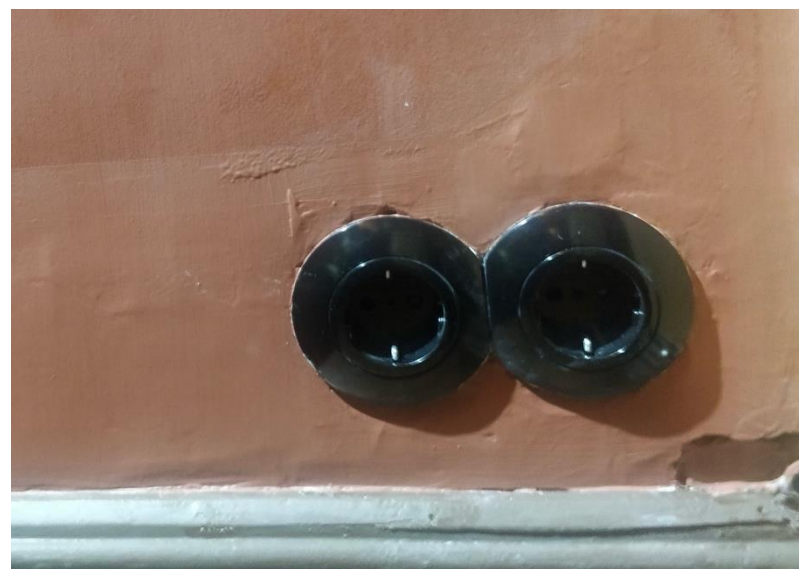
Parven 328 pistorasian ympäristön vauriot korjattu.
