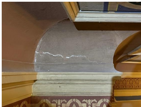
Kuva 10a. Holkkalistan halkeama tasoitettuna.
