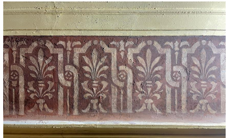
Kuva 8b. Vesivaurioalueen irtoamat olivat haasteellisia kiinnittää, samoin retusoinnit, koska pinta oli niin pahasti vaurioitunut. Kuvassa valmis pinta.
