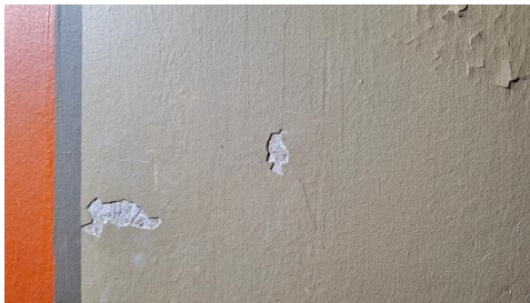
Kuva 5b. Käpristyneet maali-irtoamat kiinnityksen jälkeen.
