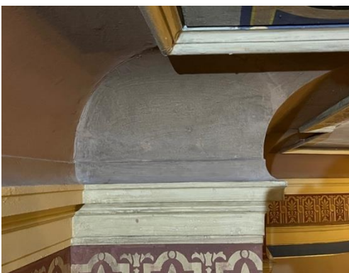
Kuva 10b. Holkkalistan halkeama retusoituna.
