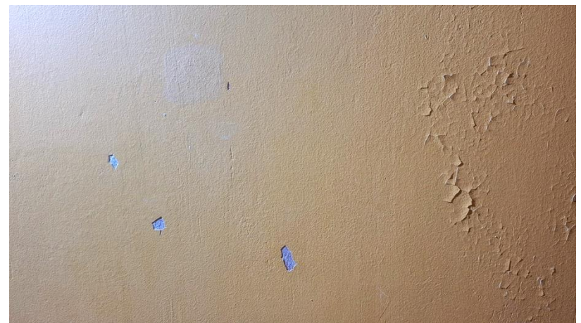
Kuva 4b. Pinta kiinnityksen jälkeen. Kuvan oikealla puolella vielä kiinnittämätöntä aluetta.
