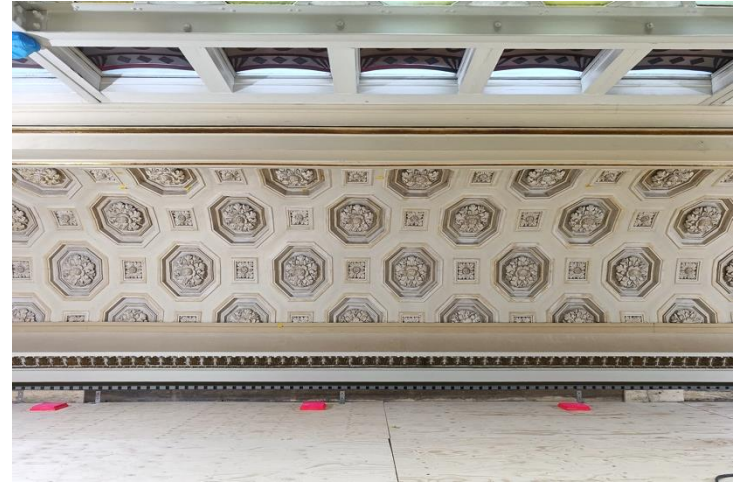
Pohjoisseinä ennen restaurointimaalaustöitä.
