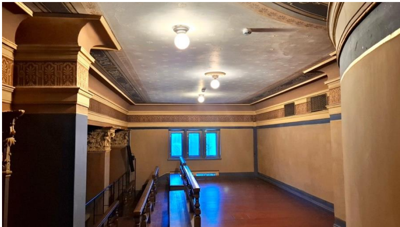
Parvi 326. Konservointityöt valmiina.
