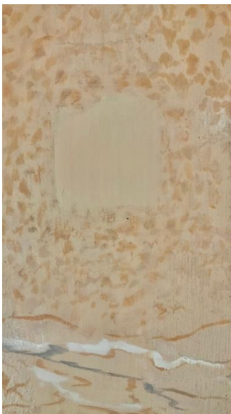
Kuva 14a vasemmalla ylhäällä: Seinän vanha sähkökytkin poistettu käytöstä ja täytetty kipsilaastilla.
