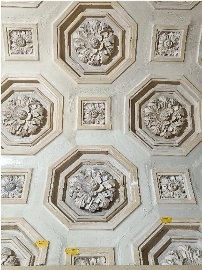
Taustapinnan pohjamaalaus käynnissä. Maalina ohennettu Ottosson pellavaöljymaali.
