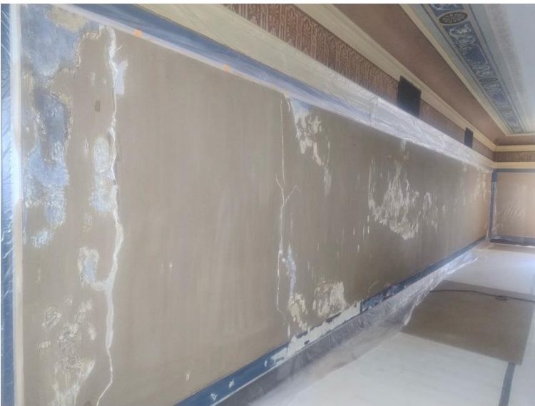
Vanha liimamaali on pesty pois ja kaikki irtoavat kerrokset poistettu.
