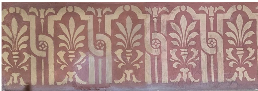
Kuva 6c. Vaurioalue paikkamaalattiin liimamaaleilla ja häivytettiin PanPastelleilla. Tasointus-, paikkamaalaus ja retusoinnit OSK Rotunda.
