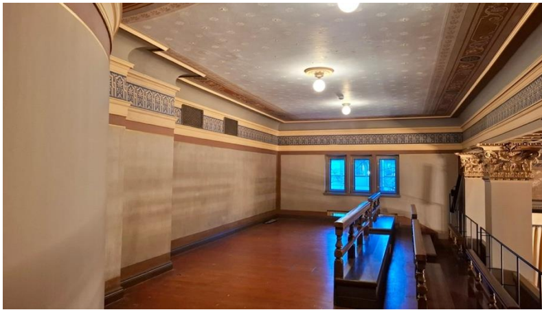
Parvi 329. Konservointityöt valmiina.
