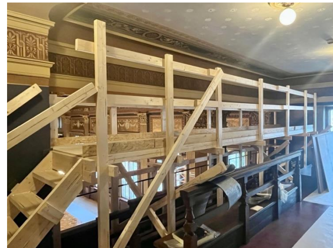
Pääurakoitsijan toimesta itäseinän puolelle, istuinpenkkien päälle, rakennettiin kiinteä, puinen teline. Teline oli myös työturvallinen, koska penkkien edessä on aukot saliin 220.
