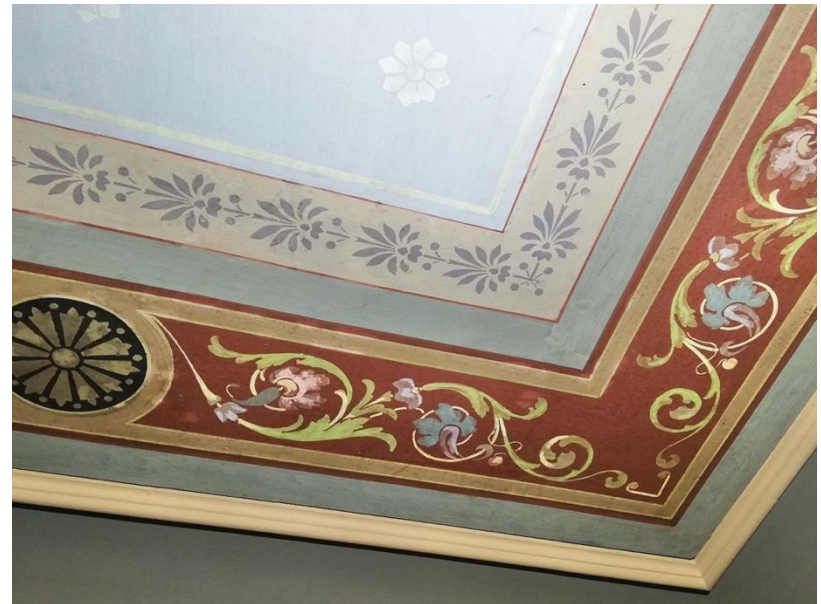
Kuva 4. Punainen koristealue kukka-aiheineen olivat katon koristealueista parhaiten säilyneet siten, että maali-irtoamaa oli vain vähäisessä määrin.
