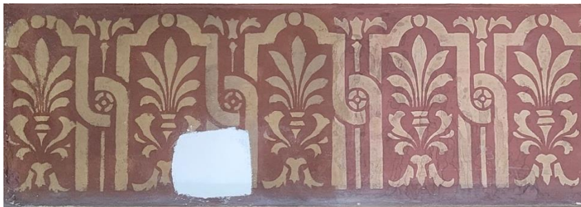
Kuva 6b. Porausreiän täytön kipsilaastilla teki pääurakoitsija. Kuvassa alue tasoitettu ja pohjamaalattu tartuntapohjamaalilla.
