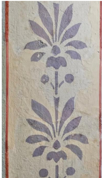
Kuva 1b. Maali-irtoamat kiinnitetty ja vanhoja retusointeja häivytetty.
