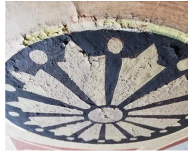
Kuva 2. Esimerkki katon irtoavasta maalista mustan koristealueella.
