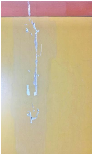
Kuva 10a ylhäällä vasemmalla: Tummunut paikkamaalaus, jossa irtoavia maali- ja tasoitekerroksia.
