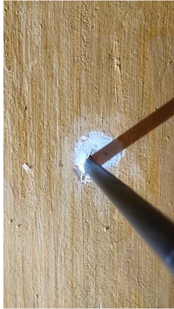
Esimerkkikuva parven 328 uusien kaiteiden kiinnityksestä. Kuvassa vaurioalue tasoitettu.
