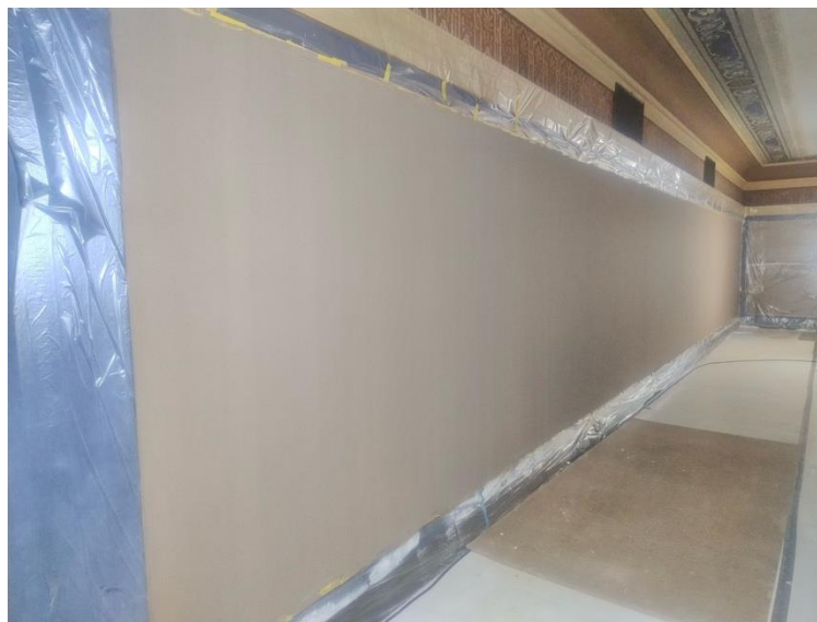
Itäseinä pohja- ja välimaalattu.
