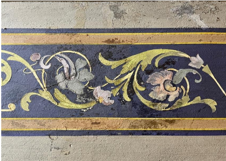
Kuva 1a. Itäseinustalla olleen vesivaurion turmelemaa kattopintaa.
