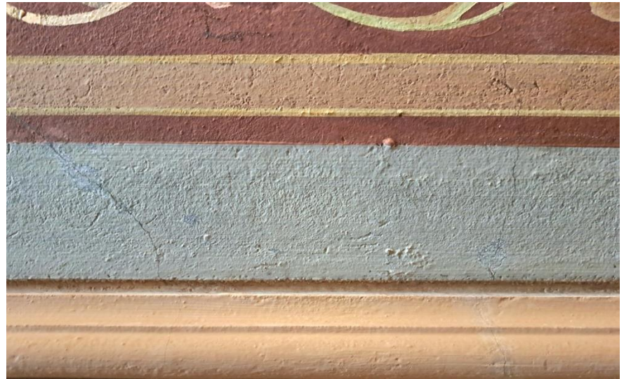
Kuva 2b. Vauriot retusoitiiin PanPastelleilla.
