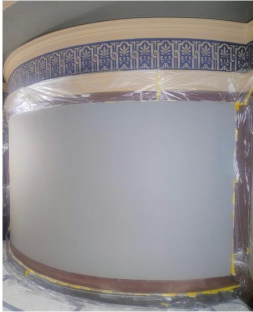
Kaareva seinä pohjamaalissa. Tartuntapohjamaali täytyi maalata kahteen kertaan, jotta tulevan liimamaalin alle saatiin yhteneväisesti imevä ja tasainen pinta.
