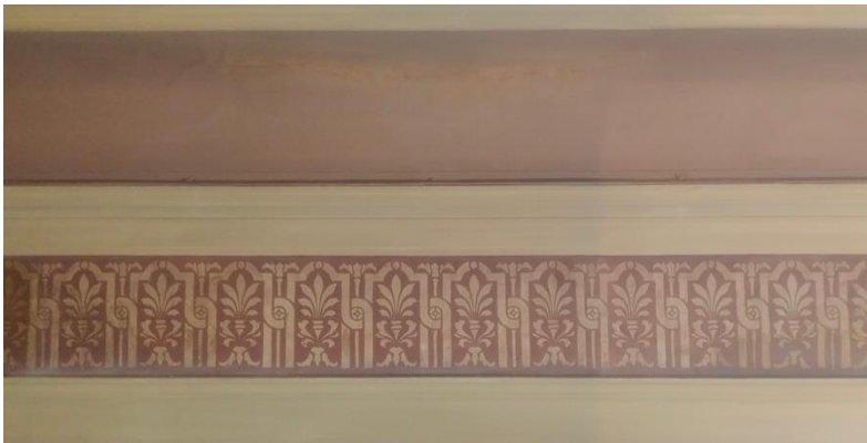
Kuva 9b. Kuvassa holkan vaurio kunnostettu.
