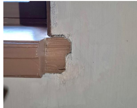
Kuva 8b. Vaurion retusointi toteutettiin eteläseinää varten tehdyllä liimamaalilla ja häivytyks PanPastelleilla.
