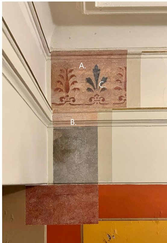
Kuva 16. Esiinottoalue länsiseinän kattolistoissa. Listojen yläpuolella holkassa ei ollut vanhoja maalikerroksia.
