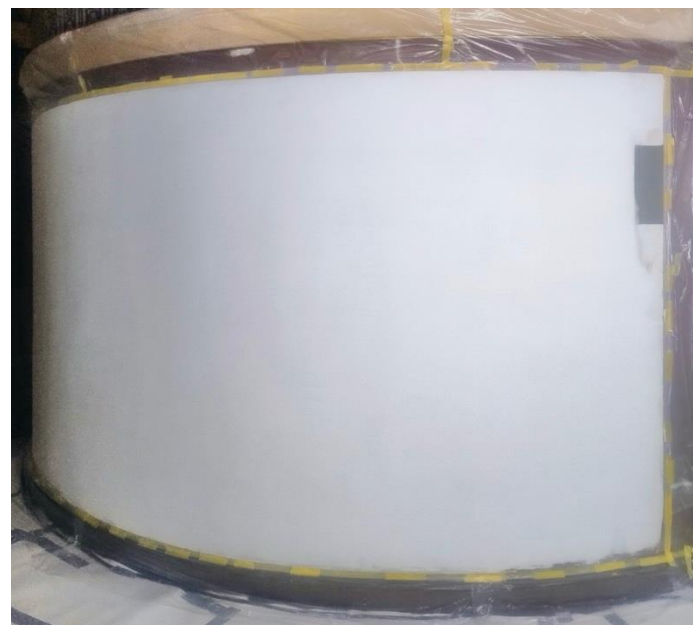
Vaurioalue kangastettu ja ylitasoitettu.
