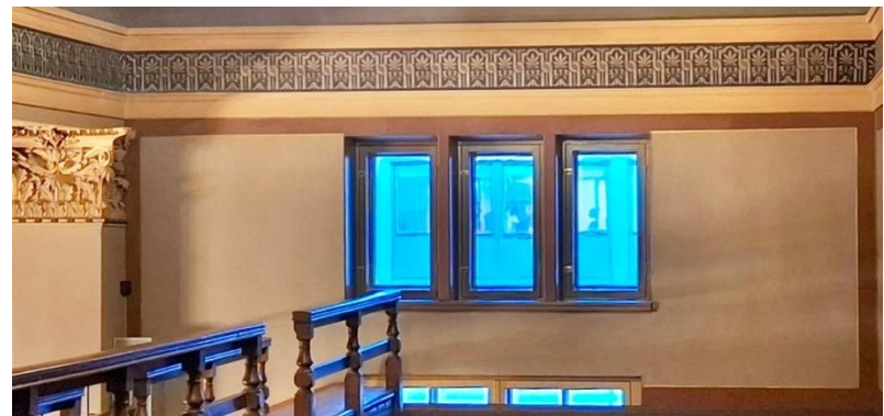
Parven pohjoisseinän ikkunat.
