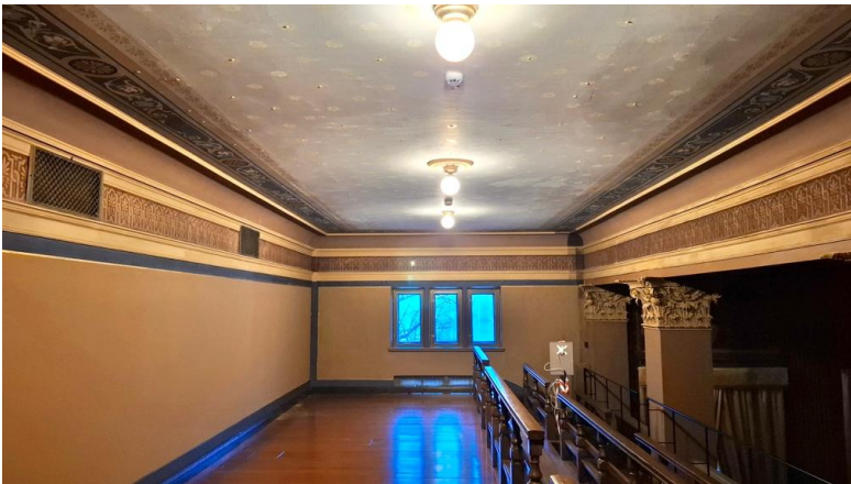
Parvi 324. Konservointityöt valmiina.
