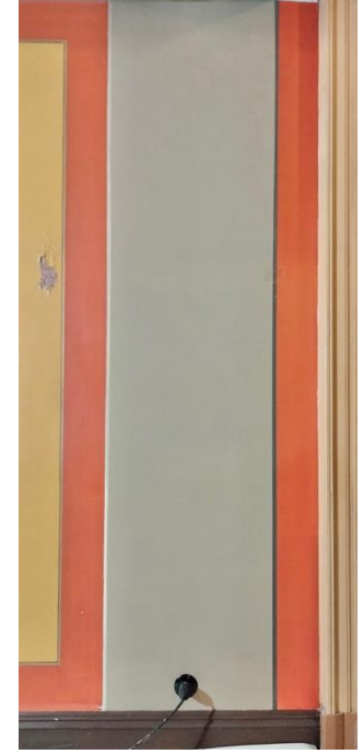
Kuva 11e. Alue valmiina. Vuoden 1904 pieni maalialue on nyt osa pintamaalausta.
