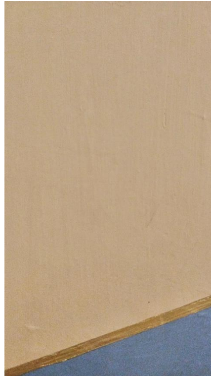
Kuva 12b. Selluloosapohjaisen liimamaalin nuhjaantuneisuutta sai häivytettyä kuivapuhdistussienellä kevyesti pyyhkien.
