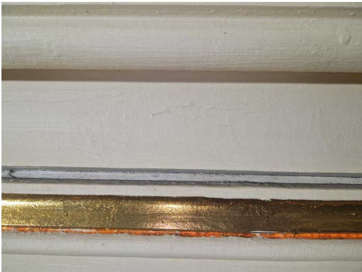
Paikoin väri-irtoamat olivat pientä ja matalaa, hiushalkeamien kaltaista irtoamaverkostoa.
