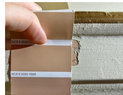
Vesivaurioalueen koristemaalauksen alistan sävyksi koodattiin sama sävy.
