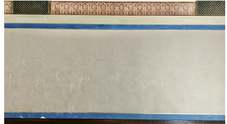
Yleiskuva itäseinän nuhjuisuudesta. Seinän liimamaali oli 1990-luvun peruskorjauksen ajalta ja maalin sideaineena oli metyyliiselluloosaliisteri.
