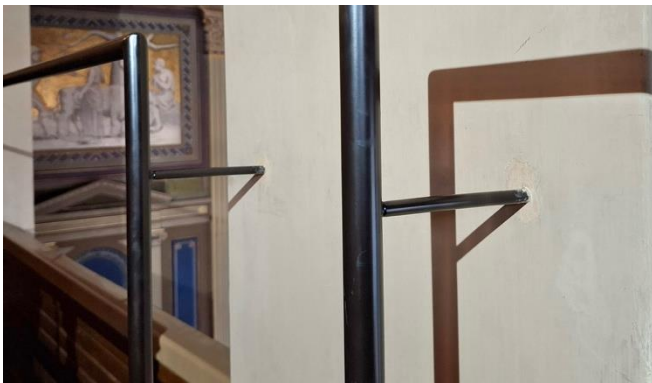
Kuva 10. Jokaiselle parvelle tehtiin salin puoleisten kaiteiden korotus. Metallisten kaiteiden kiinnityskohdat täytettiin ja retusoitiin PanPastelleilla.
