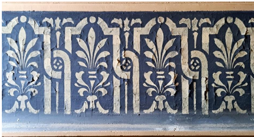
Kuva 5a. Friisin isoa irtoamaa länsiseinällä.
