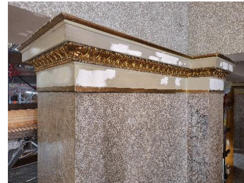
Irtoava aines poistettu ja vaurioalueet tasoitettu.
