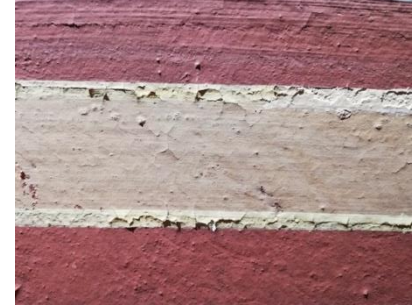
Kuva 3. Esimerkki irtoavasta maalista katon kapeissa viivoituksissa.
