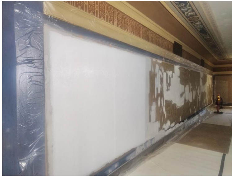
Vauriot tasoitettu ja pohjamaalattu. Seinän pohjoispääty on kangastettu.
