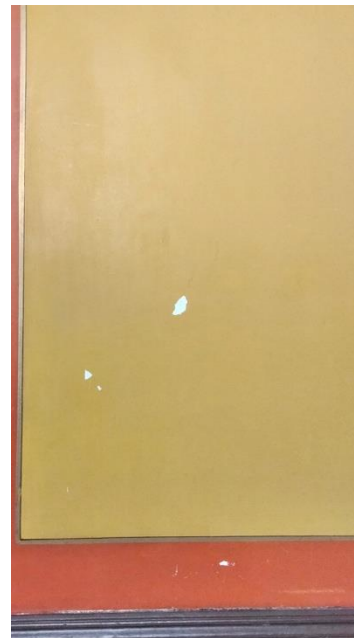
Kuva 13a vasemmalla ylhäällä: Pienet puutealueet, joista maalikerrokset ovat pudonneet.
