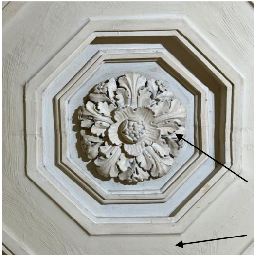
Holkkalista koostuu kipsisistä kasetoinneista ja roseteista. Rosettien tausta-alueella (nuolet osoittavat alueita) on ohuen, vuoden 1904 öljymaalin alla alkuperäinen, vuoden 1891 liimamaalikerroksen holkkalista. Ohuessa öljymaalikerroksessa on joitainkin maali-irtoamia sekä satunnaisesti paksumpia, laastikerrosta mukana olevia irtoamia.
