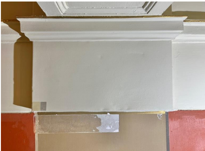
Kuvassa maalatun pilasterin yläreunaan tehty esiinotto, jossa vuoden 1904 maalin sävy oli hyvin samankaltainen 1990-luvun peruskorjauksen maalisävyyn kanssa. Pilasterin päällä on metallinen kapiteeli, johon tehtiin väriportaikko.
