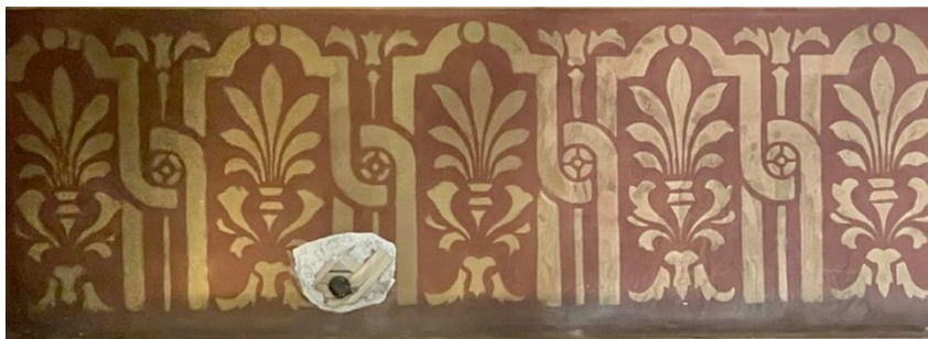
Kuva 6a. Friisin porausreikä, reiästä näkyy tikkurappausta.
