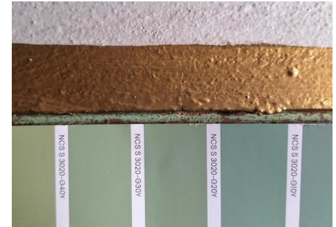
Toisen kerroksen pylväiden kapiteelin alimmassa koristeprofiilissa on säilynyt voimakkaan vihreää liimamaalia. Lähin sävykoodi oli NCS S 3020-G30Y.
