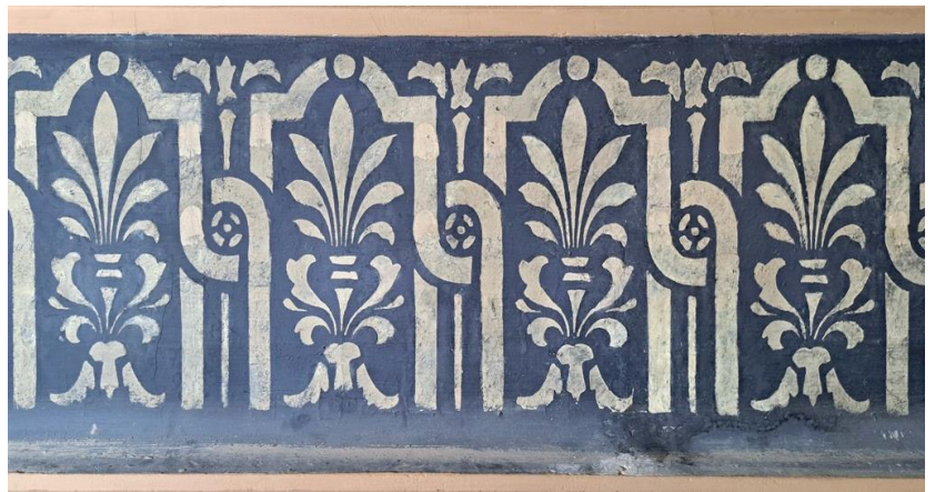
Kuva 5b. Friisin isot irtoamat kiinnitettynä.
