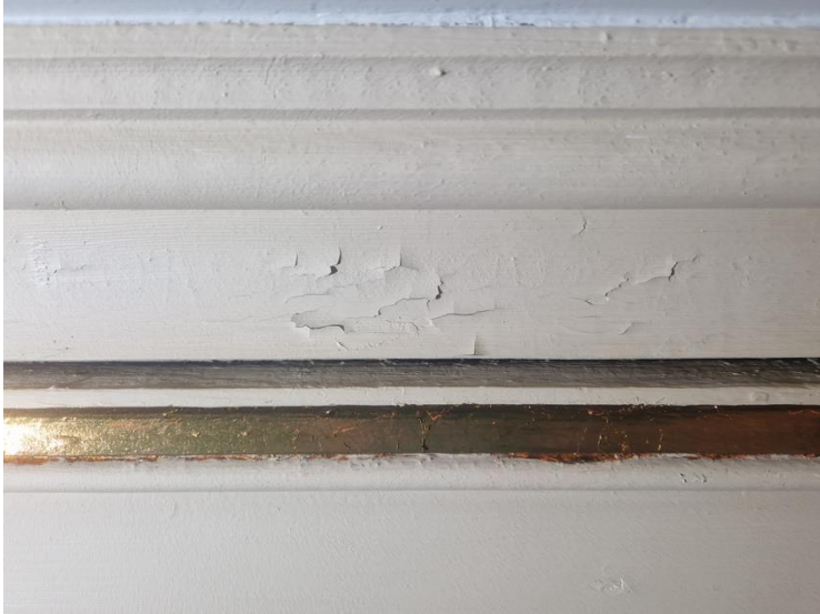
Kuvassa listan maali-irtoamaa ennen värinkiinnitystä. Paikoin väri-irtoamat olivat isompia ja vaarassa pudota.
