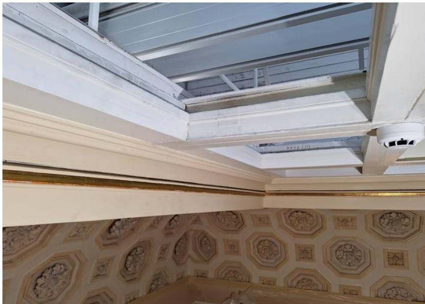
Lasikaton reuna-alueen puupalkistossa oli avattavista lasi-ikkunoita pinnoille kulkeutunutta pölyä ja likaa. Pinnat puhdistettiin veteen kostutetulla kuituliinalla.
