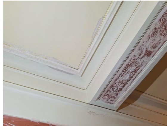
Kuva 7b. Katon ja listojen irtoava maali poistettu.
