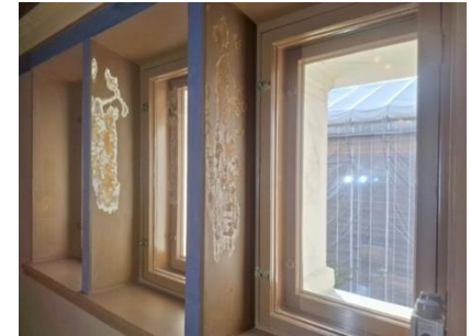
Kaikki irtoava aines poistettiin ja vaurioalueet pohjamaalattiin ennen tasoitusta.
