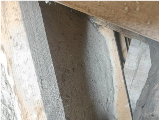
Kuvissa näkyy ulkopuolen holkkakaaren runkorakenne ja rakenteen väliin tehty rappaus.
