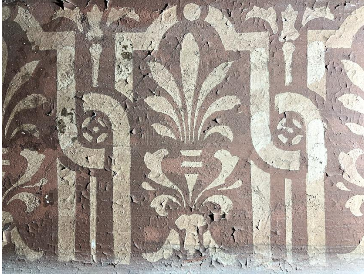
Kuva 6. Esimerkkikuva pienestä ja matalasta irtoamasta.
