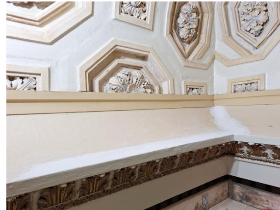
Injektoinnit tehty ja vaurioalueet vahvistettu pintavahvistuskankaalla.
