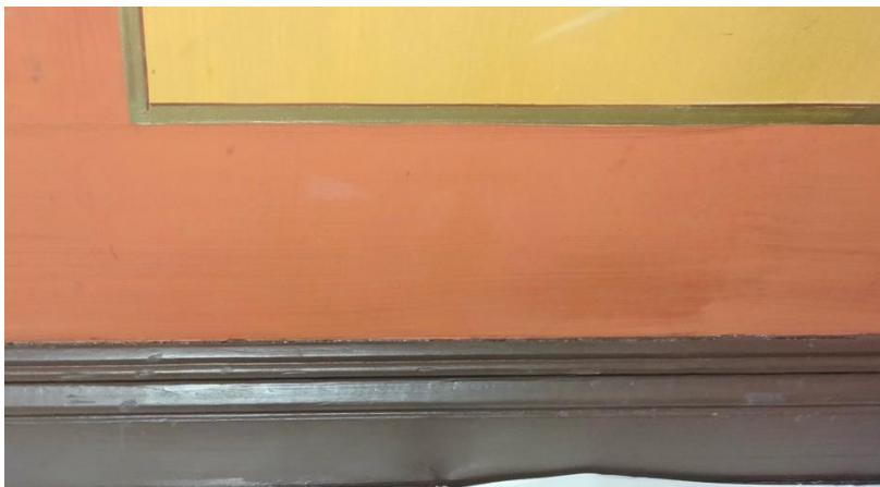
Jalkalista puhdistettu ja vauriot retusoitu.
