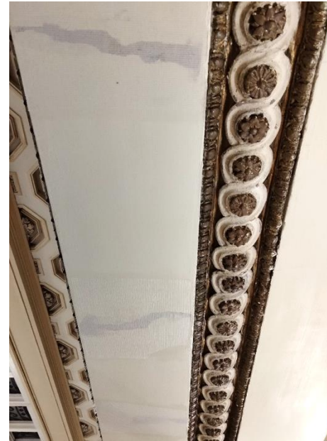
Palkiston alapinta on kangastettu aikaisemmin. Kuvassa pohjoisseinän kangasvauriot avattu, tasoitettu ja vauriokohdat kangastettu uudelleen.
