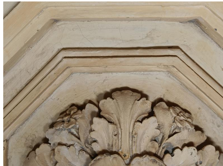
Rosettien kiinnityksen vahvistuksessa on käytetty myös ristipääruuveja.
