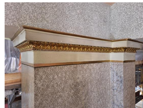
Retusointi tehtiin vesiohenteisella öljymaalilla ympäröivän pinnan mukaan. Kuvassa kapiteeli valmiina.
