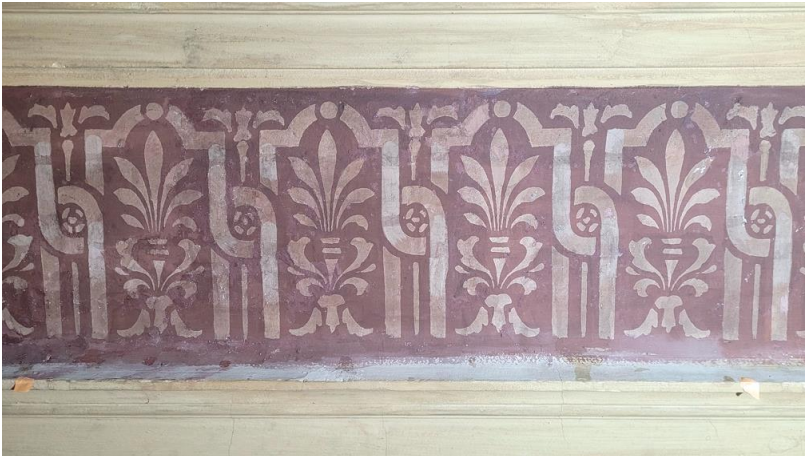
Kuva 4b. Irtoamat kiinnitetty, liimana 7% Aquazol 500.
