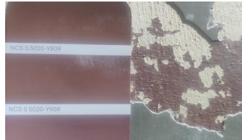
Todennäköisesti vuoden 1891 punainen liimamaali. Oletettavasti koko seinä on ensin maalattu punaisella ja sen päälle maalattu keskikentän harmahtava liimamaali. Lähin sävykoodi NCS S 5020-Y90R.
