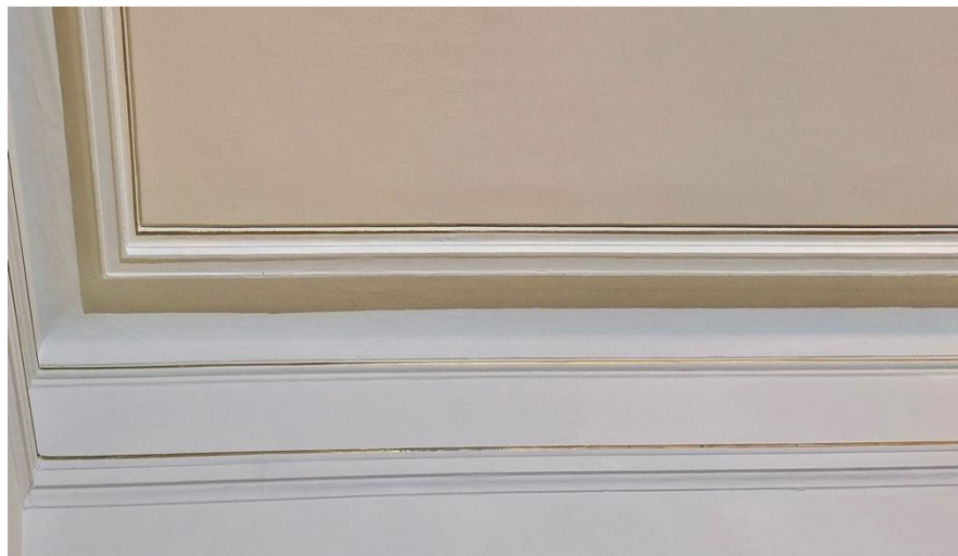
Kuva 9c. Katonrajan vesivaurioalue valmiina.
