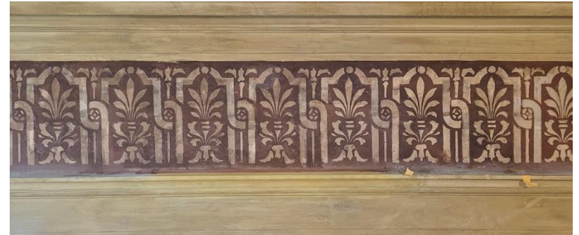
Kuva 5b. Listan reunan kolhu paikkamaalattu liimamaalilla ja häivytetty PanPastelleilla sekä friisin puutealueet retusoitu.
