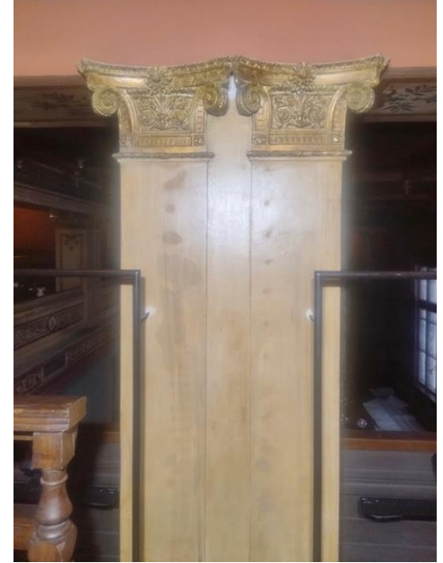
Parven 328 uudet kaiteet kiinnitetty.
