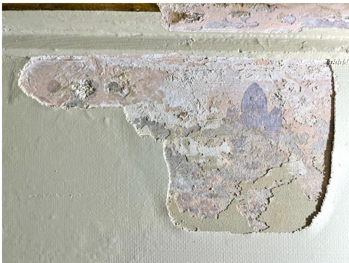
Kuva 17a. Eteläkäytävän itäpään portaikon listojen irtonaisen poistossa esiin tullut koristemaalauks. Tutkimusalueen sijainti merkitty kattoprojektiokuvaan.
