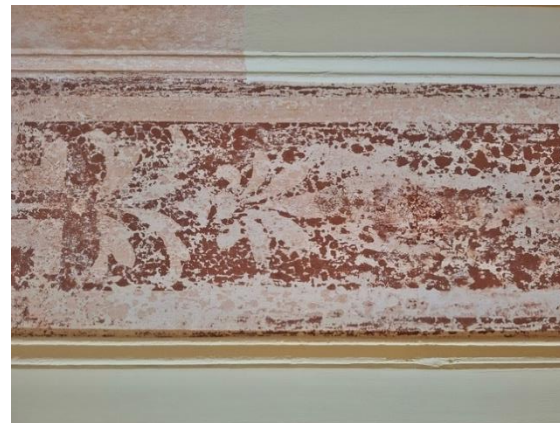
Kuva 7d. Irtoavien kerrosten poiston yhteydessä esille tullut, palkin pohjassa oleva koristemaalalaus. Koriste on alkuperäistä, vuoden 1891 pintaa ja toteutettu liimamaalilla.
