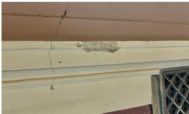
Kuva 9a. Esimerkkikuva listan likatahrasta ennen retusointia.
