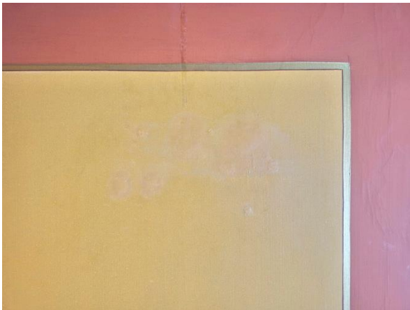
Kuva 12b. Poran reiät retusoitu.
