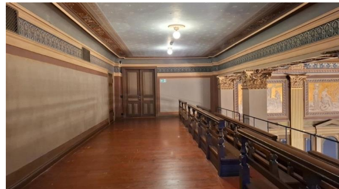
Oven vieressä oikealla uudelleen liimamaalilla maalattu seinä.
