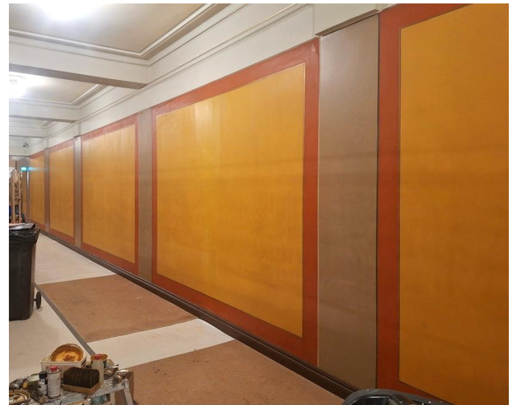
Yleiskuva eteläseinästä, jossa kaikki paikkamaalaukset ja retusoinnit ovat valmiina.
