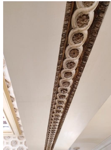
Kuvassa alapinnan vauriot on paikkamaalattu, koristelista puhdistettu ja retusoitu.
