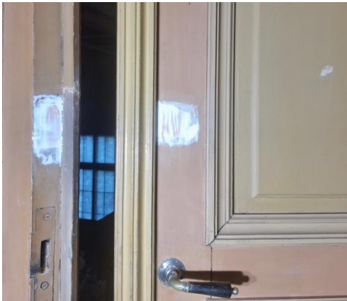
Puupaikka pohjamaalattu ja tasoitettu Snickeri A - silotteella.
