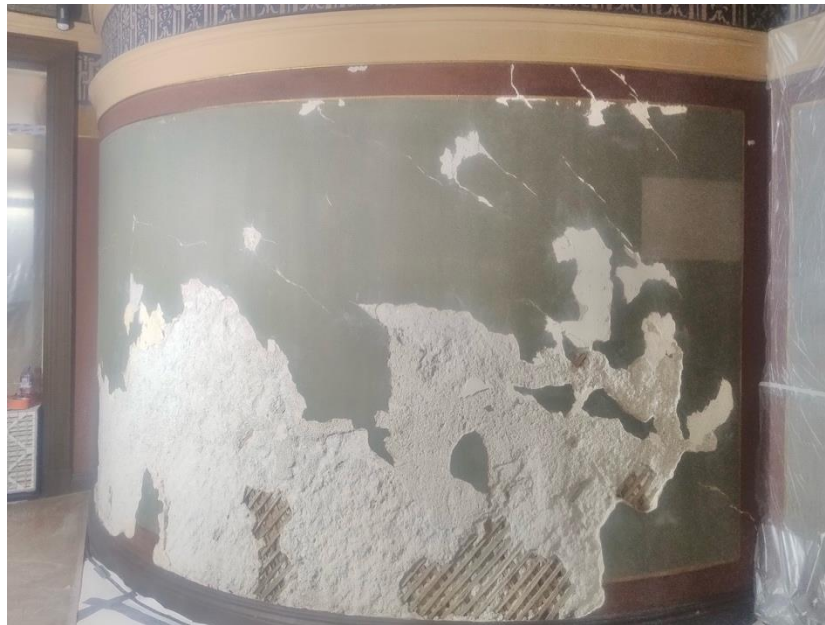
Vanhat liimamaalit on pesty pois ja kaikki irtava aines poistettu. Osa laastista irtosi tikutukseen asti.
