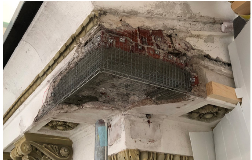
Rauditus on verkotettu huolellisesti ja alareunaan on lisätty 3mm rst-tanko tukemaan listan profiilia.
