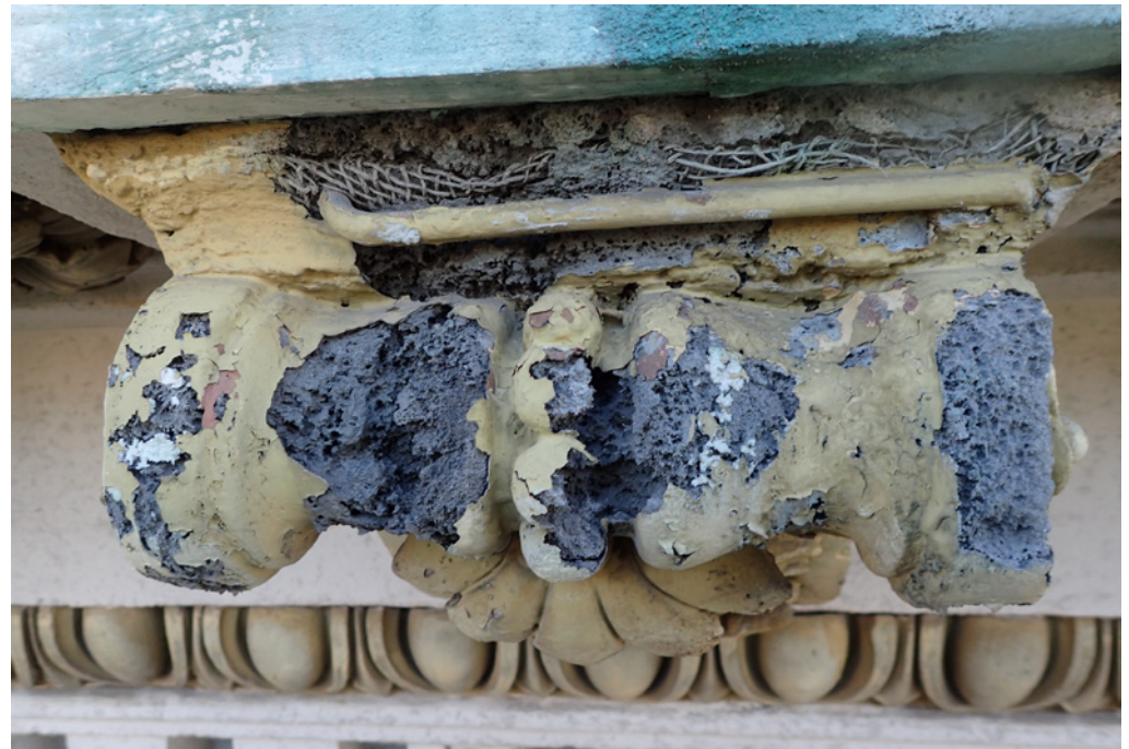
Harmaalla kipsillä valettuja koristeita, joissa on käytetty vahvikkeena juuttikangasta.
