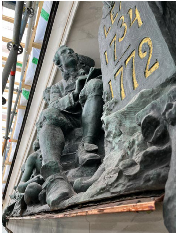
Uusi vesipelti ohjaa vettä hieman ulommaksi rakenteista.
