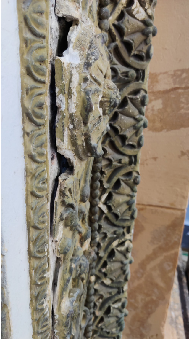
Pääoven todennäköisesti alkuperäinen kipsikoriste on hyvin ohut ja materiaaliltaan pehmeää kipsiä.
