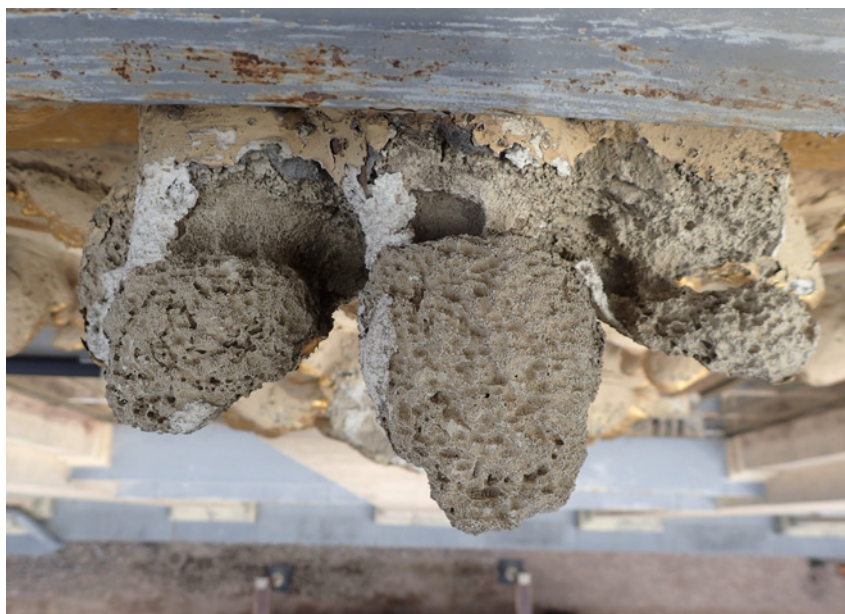
Koristeiden yläpinnat olivat kärsineet pahoin säärasituksesta ja peltien vedenohjauksesta. Lehvän yläpinnalla näkyy vanha pulupiikki.
