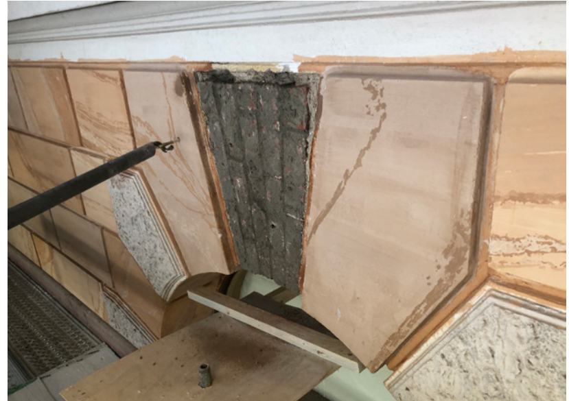
Kiilakiven alueen rappaus oli täysin vaurioitunut ja uusittiin tiilipinnalta asti. Kuvassa kynsirappaus eli tartunta.
