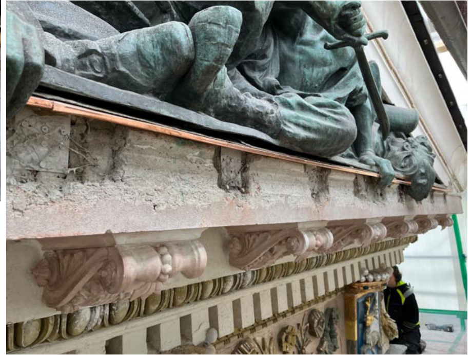
Vesipelti kiinnitettiin räystäslistan muuraukseen rst-raudoilla.
