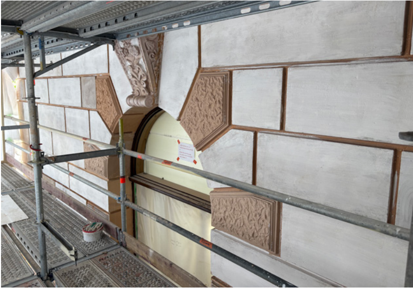
Harkotukseen on tehty kalkkimaidolla pohjustus.
