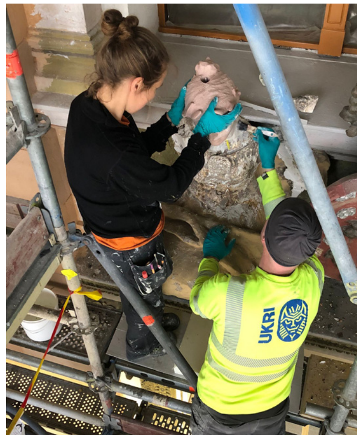
Luxille asennetaan uusi pää, joka on mitoitettu tarkasti alkuperäiseen asentoonsa. Työssä Anni Hassi ja Simo Ripatti.
