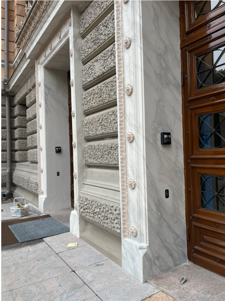
Säätytalon itäjulkisivun ovismyygien A-voimakkuuden marmorointia. Sävyt ovat vaaleat, muotokieli eloisaa ja yksityiskohtaista sillä pintaa katsotaan lähietäisyydeltä.
