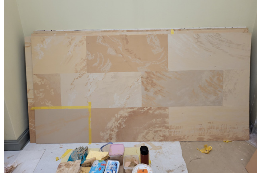
Kalkkimaalausmalli hiekkakiven imitoinnista irtolevyille
