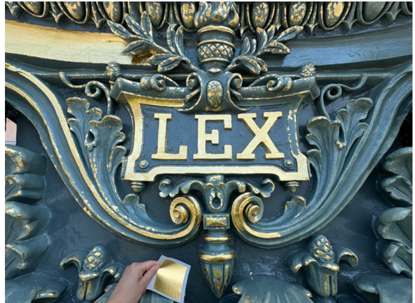
Silkkipaperiin kiinnitetty kultalehti. Sekä vaaleat, että vihreät kapiteelit kullattiin.
