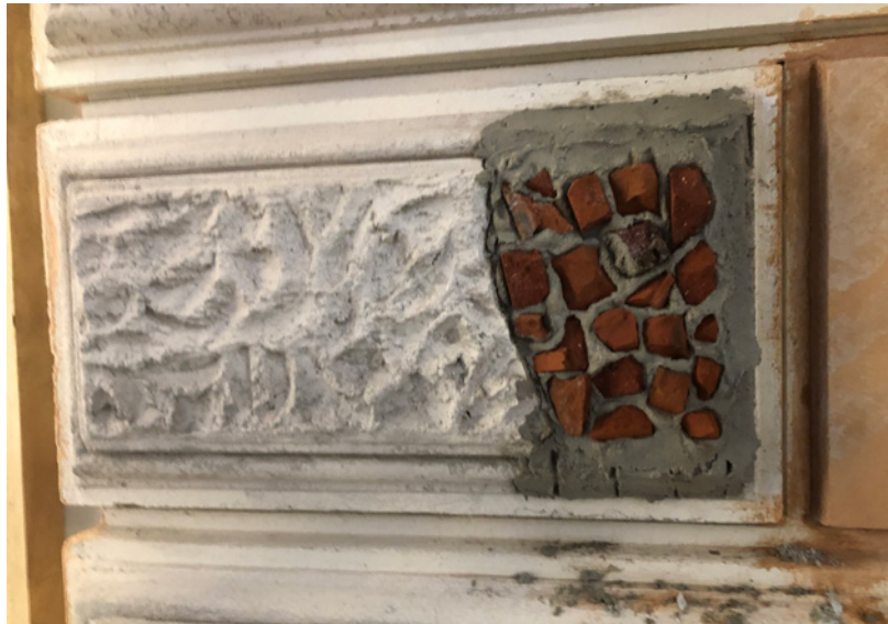
Roiskerappaus on toteutettu alunperin tiilitäytöllä. Samaa tekniikkaa käytettiin paikkauksissa. Kuvissa eri tyyliä harkkoja.
