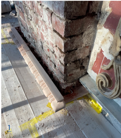
Kuva 1. Kapiteelin kiinnitys aloitetaan mitoittamalla alalista tarkasti oikeaan korkoon ja suoraksi.
