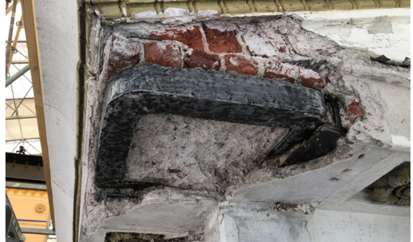
Räystään nurkan tukirauta on puhdistettu ruosteesta. Pintaan laitettiin Sto Crete korroosionsuojalaasti.
