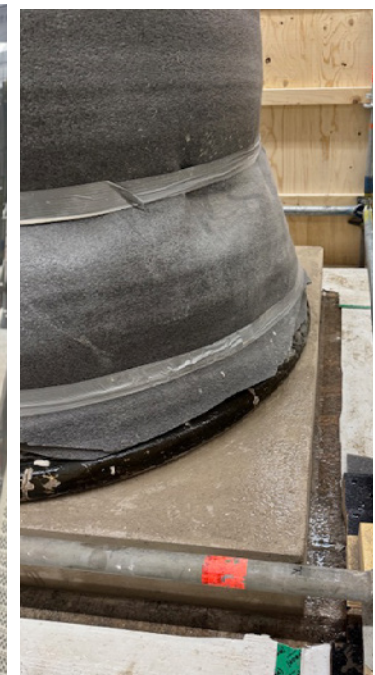
Pylvään plintin valu.
