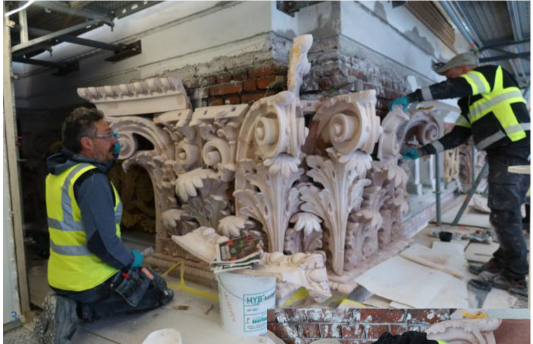
Kuva 1. Kapiteelin kiinnitys aloitetaan mitoittamalla alalista tarkasti oikeaan korkoon ja suoraksi.
