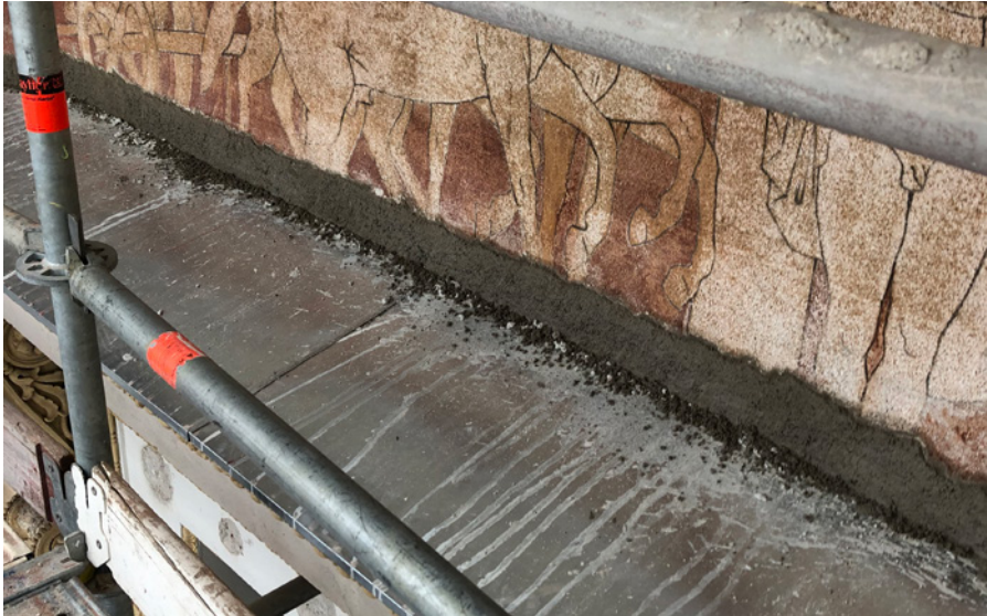
Rappauspaikkausta tehtiin kaikkien uusittujen peltien liittymissä.
