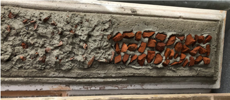
Roiskerappaus on toteutettu alunperin tiilitäytöllä. Samaa tekniikkaa käytettiin paikkauksissa. Kuvissa eri tyyliä harkkoja.
