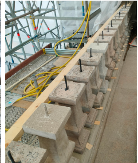
Balusterit asennettuina ennen yläpaarteiden muotitusta. Uudet keilat vaaleampia.
