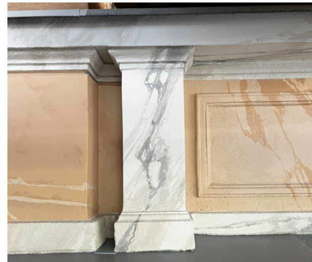
Sommittelussa on otettu huomioon ympäröivä hiekkakivi-imitaatio. Harkkojen suonistukset eivät ole samansuuntaiset, muttei myöskään riitele keskenään. Valkoinen marmorointi on sommiteltu tasaisesti pilasteriin.
