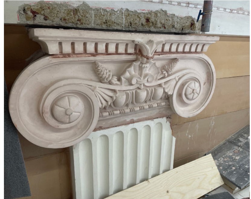
Joonialainen kapiteeli oli suurin yksittäinen koristekappale. Yläosan dentiililista valettiin omalla kappaleella.
