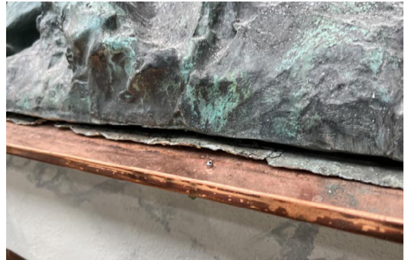
Uusi kuparipelti asennettiin mahdollisimman syväälle alkuperäisen lyijypellin alle. Sivun kaikki kuvat: Kati Winterhalter.
