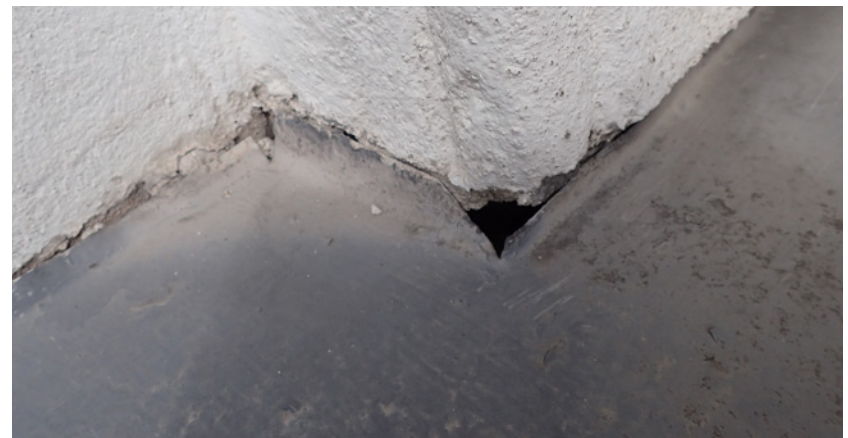
Pelti on liian pieni mitoitukseltaan ja valuttaa vettä koristeeseen.
