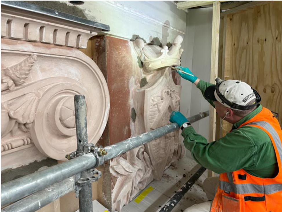
Kipsikoristeiden saumaukset viimeistellään asennuksen jälkeen. Työssä maalarimestari Osmo Tikkanen.
