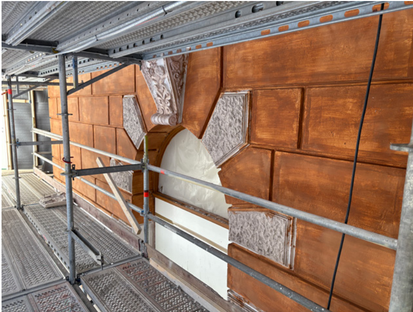
Seinäpinta on maalattu välimaaliiin sävyllä harkko 14.
