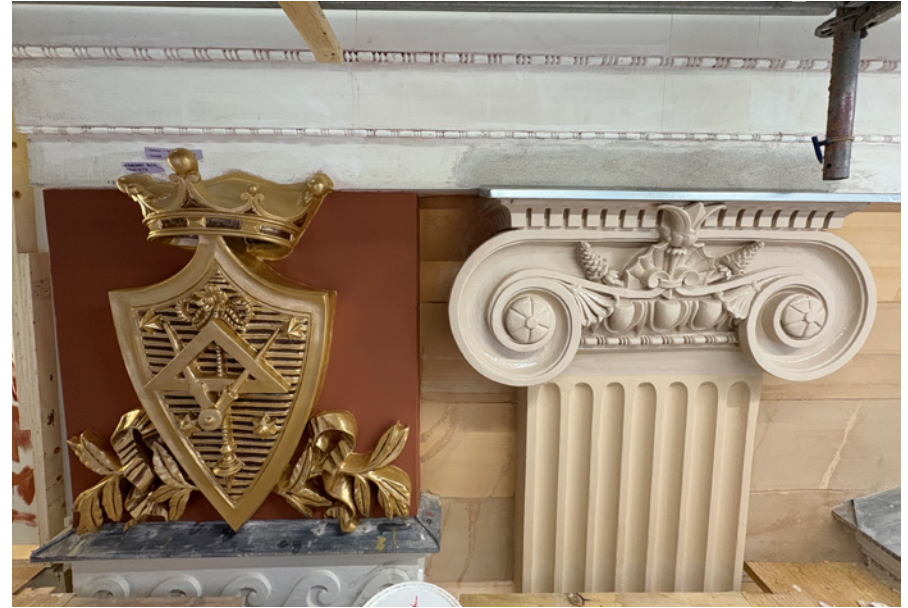
Ammattikuntavaakunan ja joonialaisen kapiteelin uudet vesipellit. Joonialaiseen kapiteeliin asennettiin myös lyijypellit ulkoreunoille.
