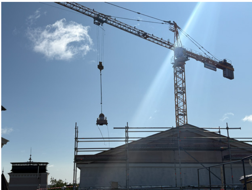
Päätykolmion akroterioni nostettiin katolta torninostimen avulla.
