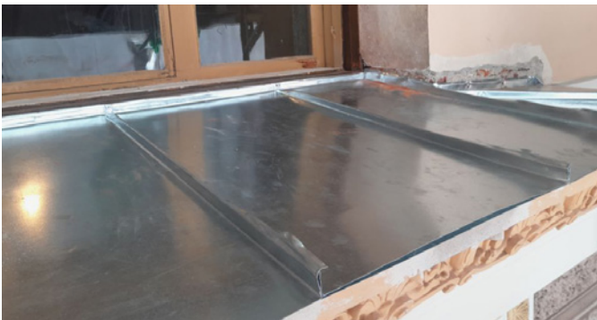
Katoksen uuden pellin alle lisättiin huopa.
