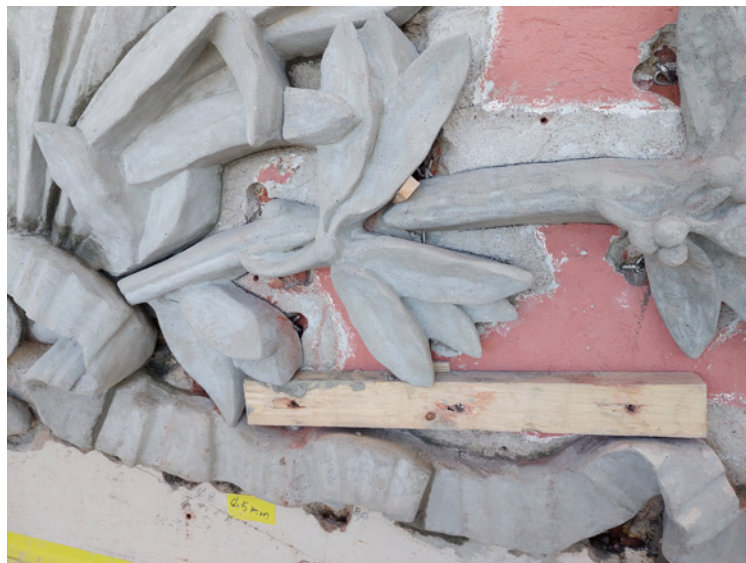
Laastikoristeiden kiinnitys pintoihin tehtiin rst-koukuilla ja laastilla. Saumaukset ja liittymät tehtiin laastilla.
