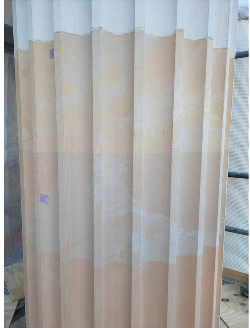
Hydrosililla maalattua urapylvästä portiikissa.
