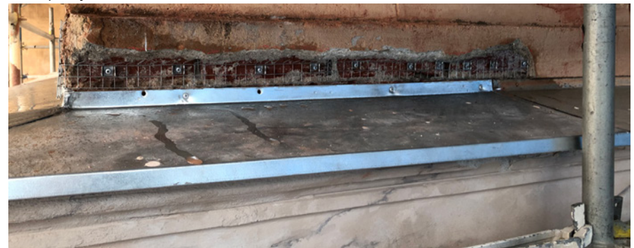
Uusia peltejä liitettiin vanhoihin.
