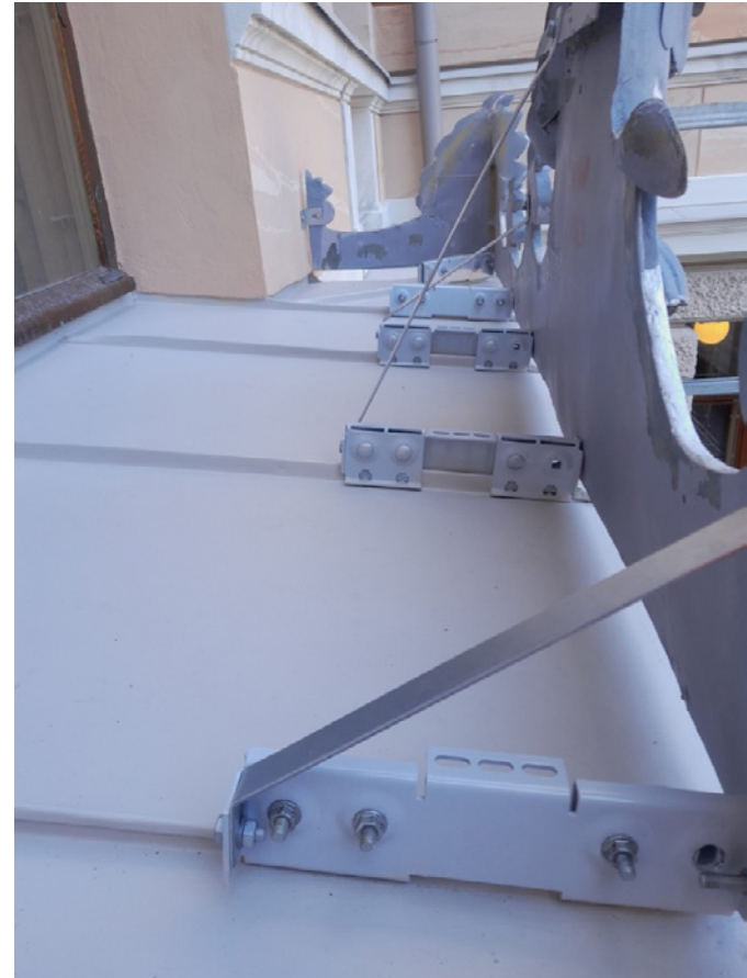
Uudet kiinnikkeet on asennettu kiinni rivisaumoihin.
