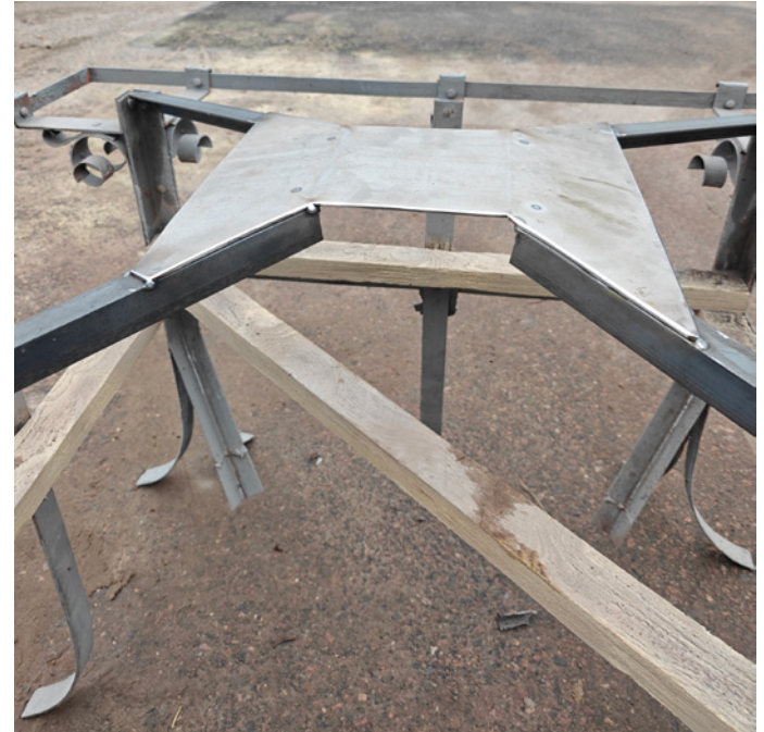
Rungon keskiosan uusi tukirakenne.
