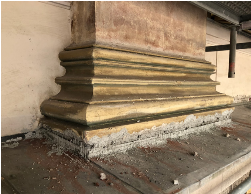
Pintaan on asennettu verkko ja sitä ennen on lyöty kynsirappaus.
