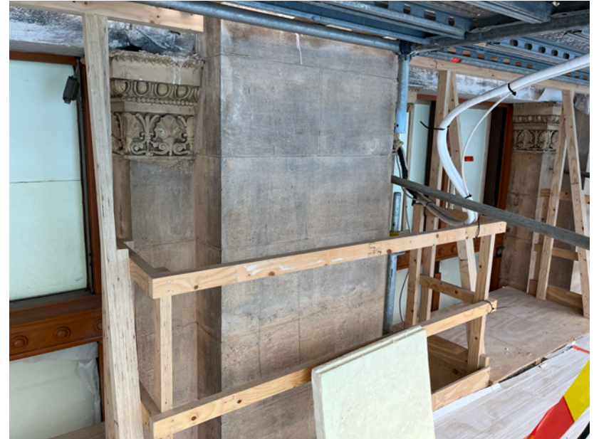
Seinäpinta on kasteltu kalkkivedellä..
