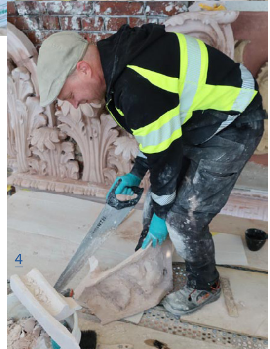
Kuva 1. Kapiteelin kiinnitys aloitetaan mitoittamalla alalista tarkasti oikeaan korkoon ja suoraksi.
