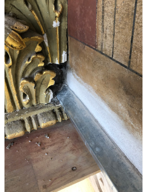
Paksu rapattu lista friisin alareunassa täytettiin muuraamalla.
