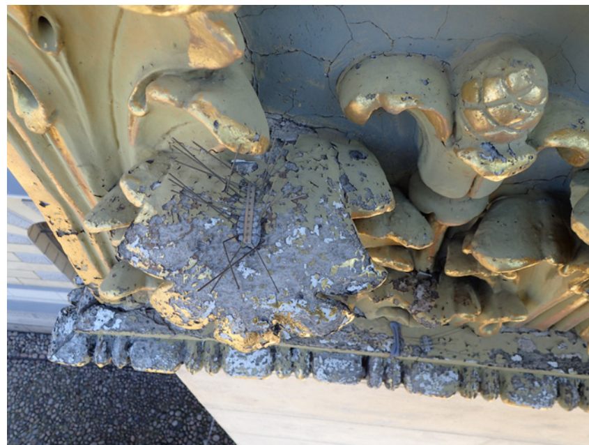
Koristeiden yläpinnat olivat kärsineet pahoin säärasituksesta ja peltien vedenohjauksesta. Lehvän yläpinnalla näkyy vanha pulupiikki.
