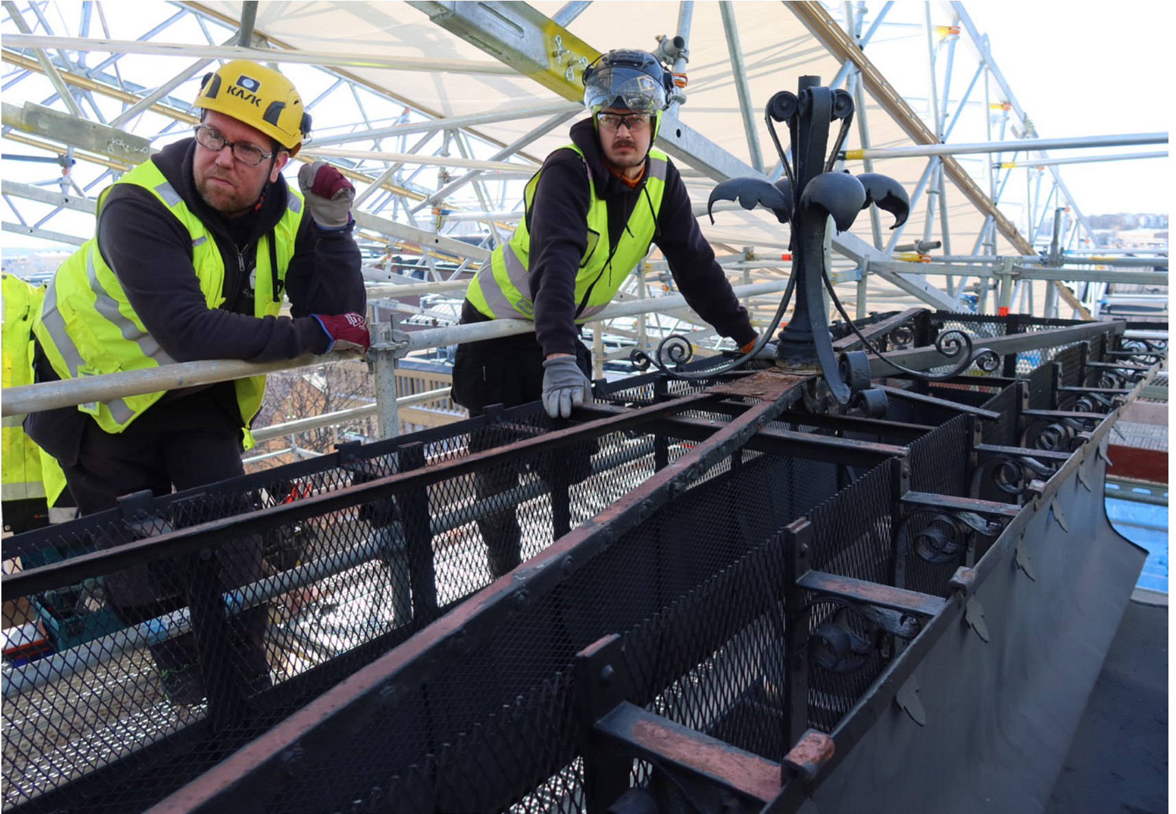
Piipunhatusta on purettu ylin pelti. Rungon rakenteita tarkastelevat Jukka Roivainen ja Ville Salminen. Kuva: Kati Winterhalter.
