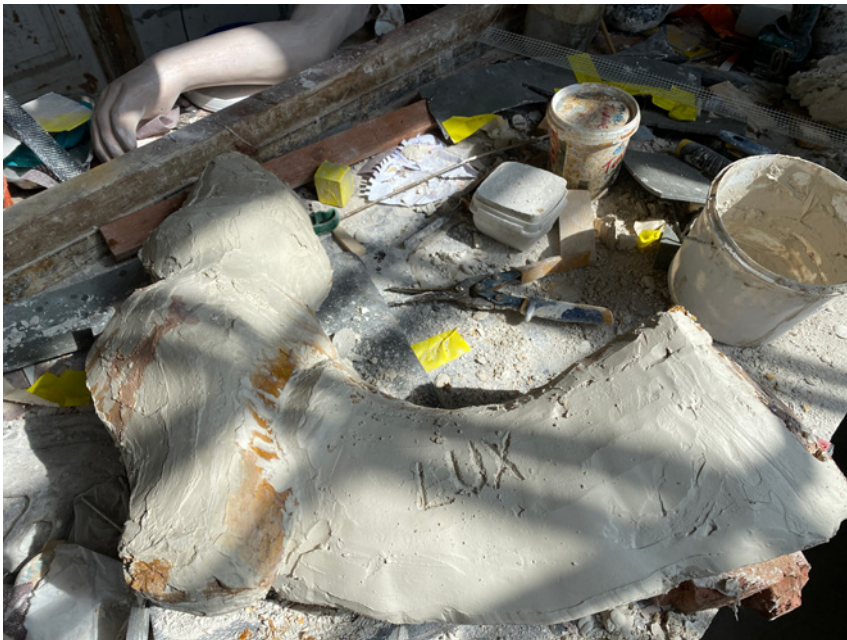
Koristeen irrotus ja mitoituksen tallennus työmaalla. Silikonin päälle on muotoiltu kipsistä tukikappa.
