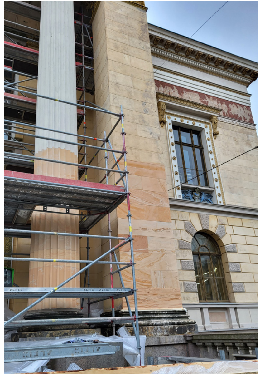
Mallialue tehtiin portiikkiin ennen rakennustöiden aloittamista, jotta väritystä ja imitoinnin vaikutelma pystyttiin arvioimaan ilman telineitä. Pylväässä hydrosil- ja pilasterissa kalkkimaali.
