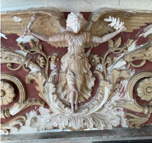
Hengettäriä korjattiin paljon. Lisäksi useimpiin uusittiin, käsiä, jalka ja pää.
