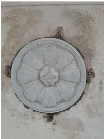
Laastikoristeiden kiinnitys pintoihin tehtiin rst-koukuilla ja laastilla. Saumaukset ja liittymät tehtiin laastilla.
