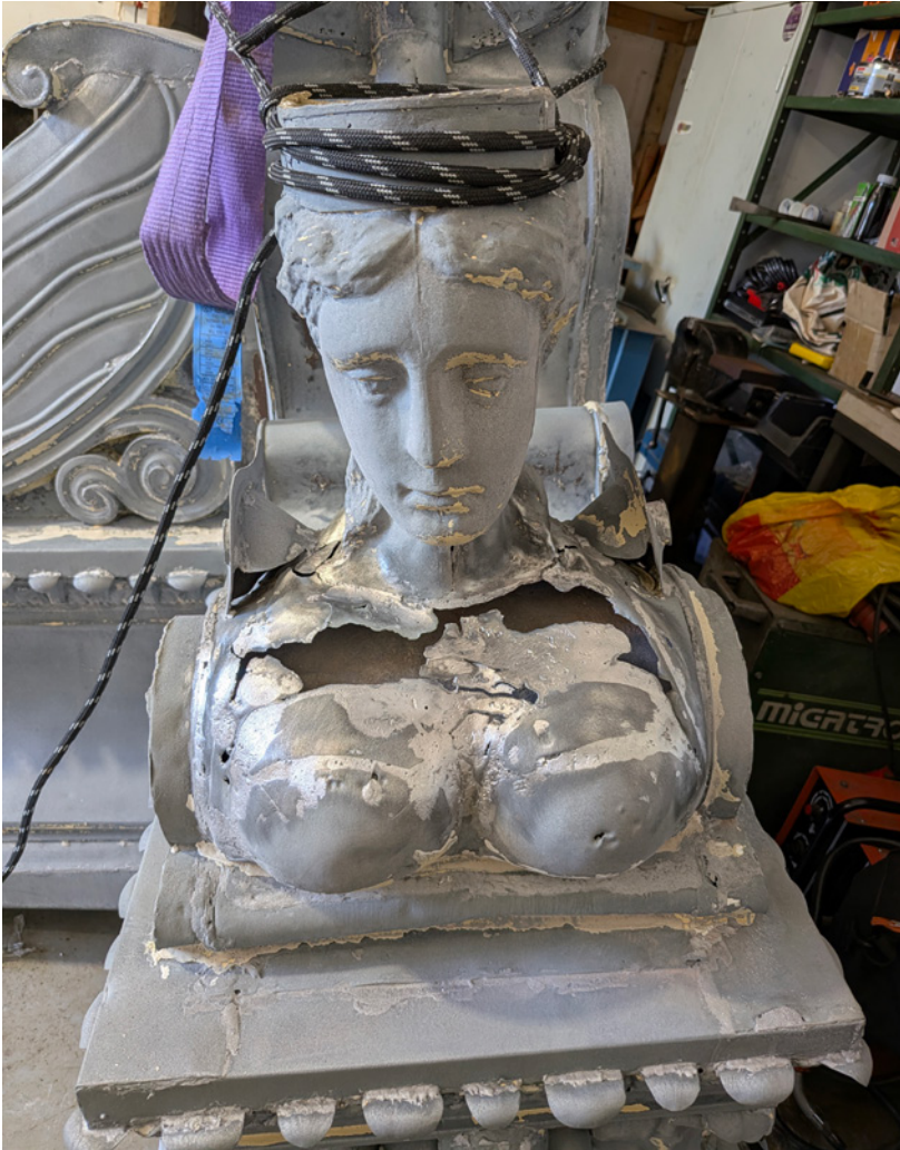
Sinkkikoristeissa oli paljon vaurioita. Reikiä juotettiin umpeen ja tähän pahiten vaurioituneeseen koristeeseen lisättiin sinkkipellistä kappale.
