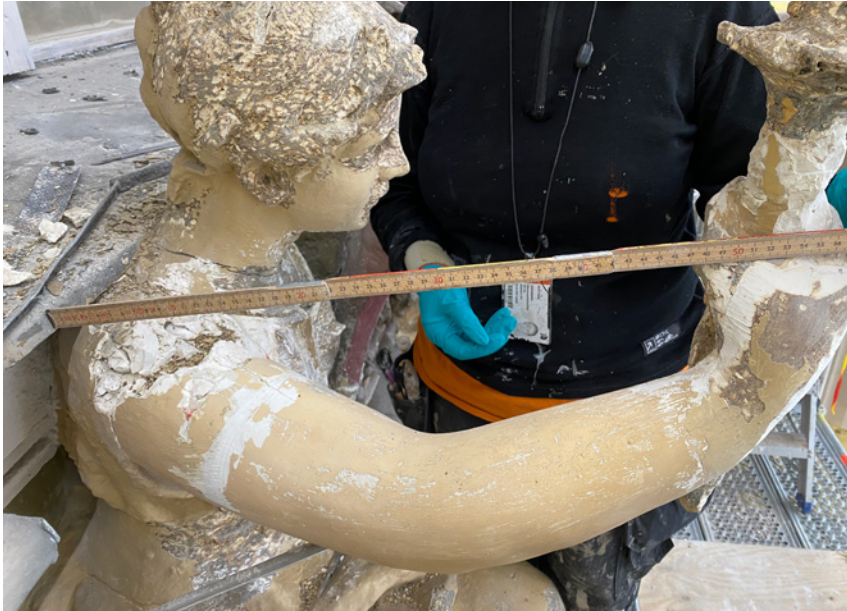
Koristeen irrotus ja mitoituksen tallennus työmaalla. Silikonin päälle on muotoiltu kipsistä tukikappa.
