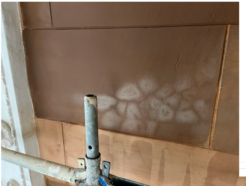
Alustasta läpi tulevia ongelmia pohjoisseinällä
