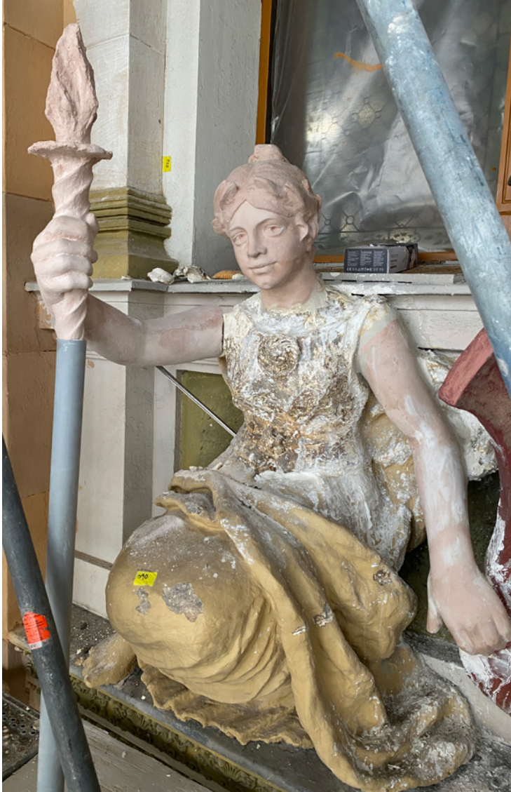
Soihtukäden asennus oli raudoituksineen haastava. Valuaukon ympärille asetettiin savesta kaulus, jotta kipsi saatiin ohjattua sisään ja valumaan oikeaan paikkaan.
