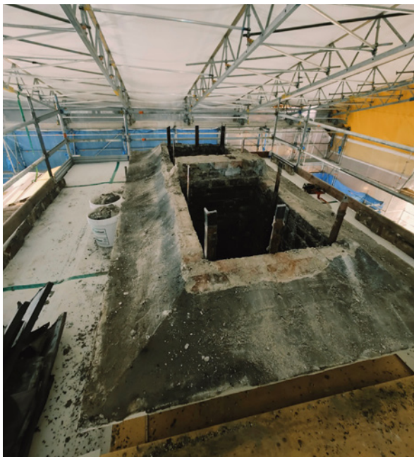
Piipunhattu ennen pellitystä, pellitettynä ja verkot asennettuna.
