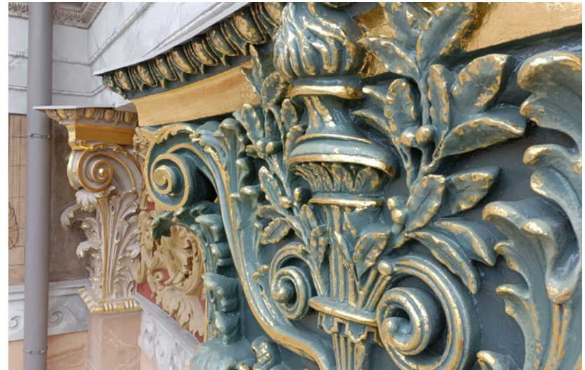
Silkkipaperiin kiinnitetty kultalehti. Sekä vaaleat, että vihreät kapiteelit kullattiin.
