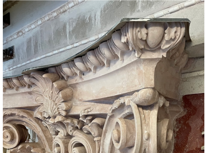
Kapiteelin uuden vesipellin keskikaarroke suojaa kipsikoristetta.
