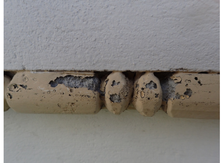
Harmaalla kipsillä valettuja koristeita, joissa on käytetty vahvikkeena juuttikangasta.
