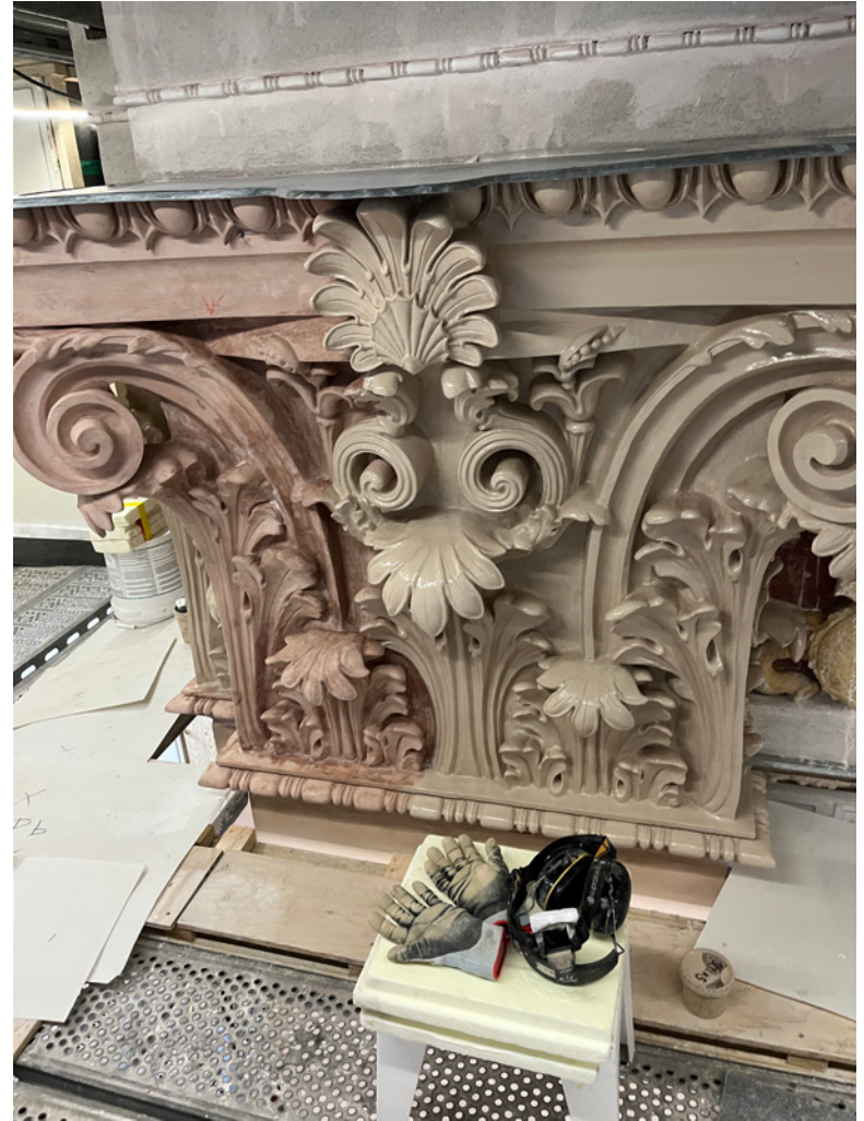
Kapiteelin vasen puoli on pohjustettu lyijyvernissalla ja vernissalla, oikealla puolella on ensimmäinen öljymaalikerros.
