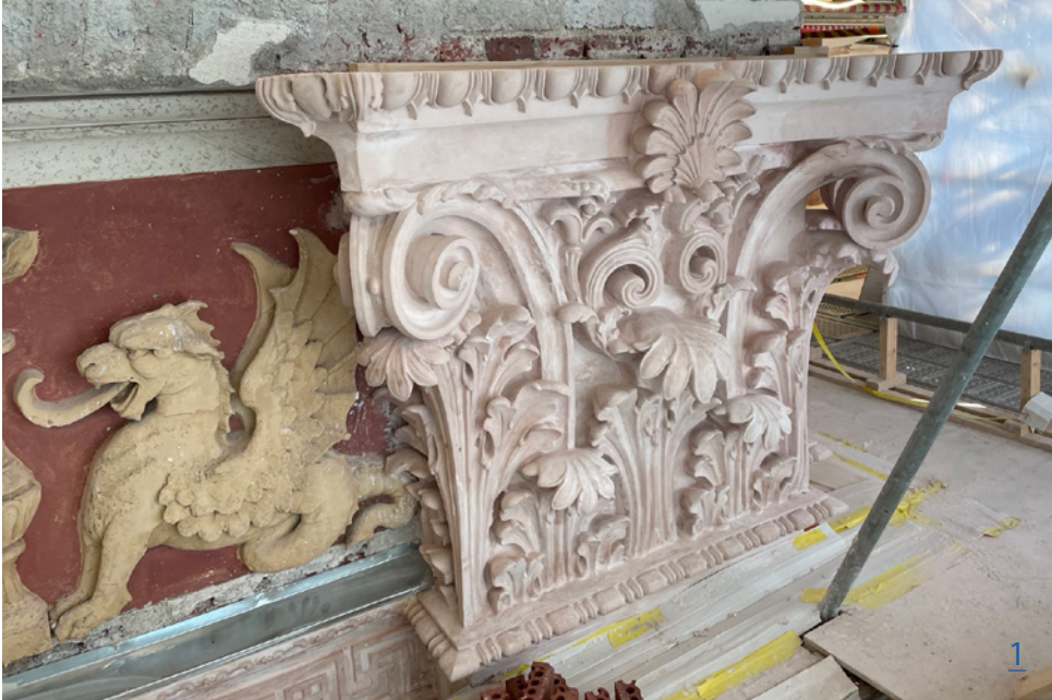
Kuva 1. Kupiteelin kaikki osat on asennettu paikoilleen.
