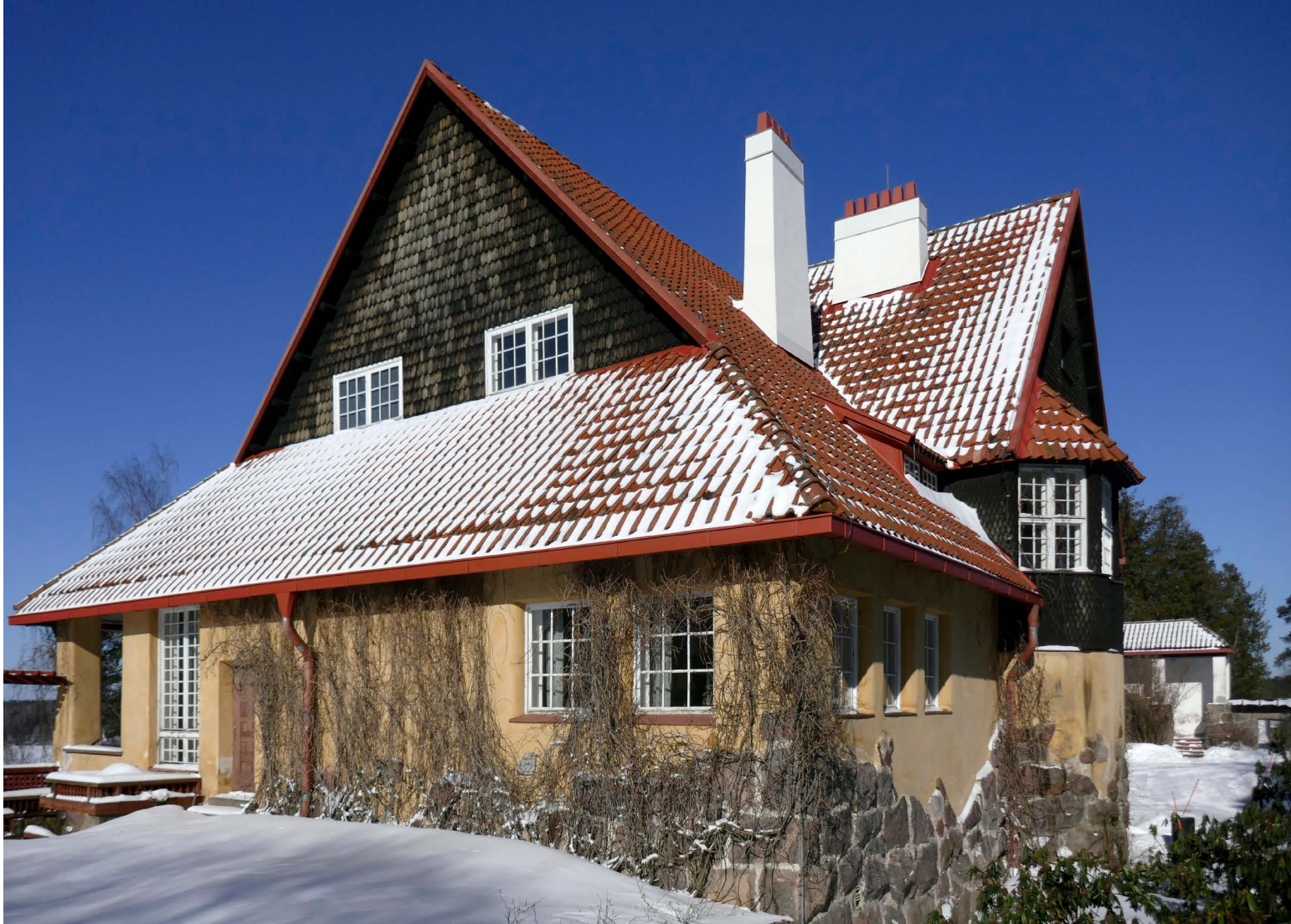
↑ Tuvan takkanurkkaus sijaitsee Eteläsiiven kaakkoiskulmassa. Kuva ennen ikkunakorjausta. amoy 2021
