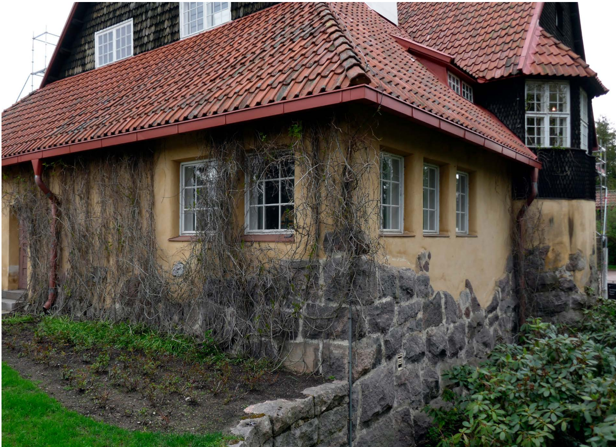
↑ Takkanurkkauksen ikkunat ennen korjausta. amoy 2021
