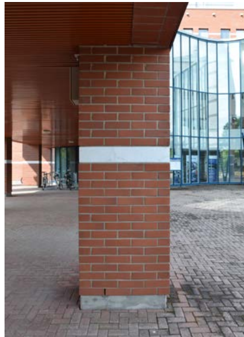
Punatiilinen pylväs, marmorilista ja betonikivijalka. Kuva on vuodelta 2022.
