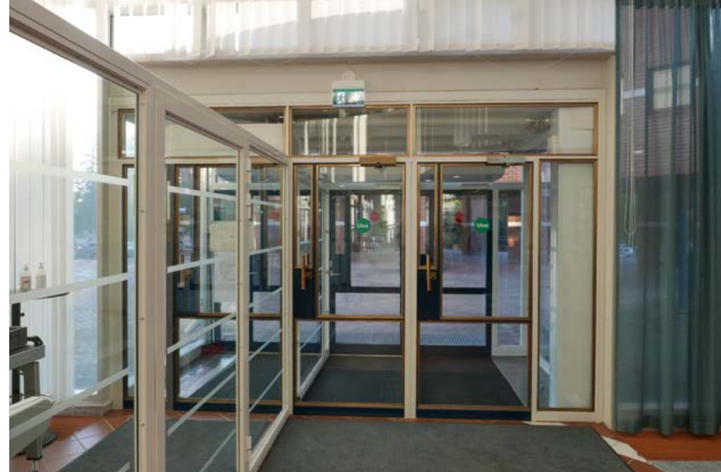
Pääsisäänkäynnin tuulikaapin teräslasiovet.
