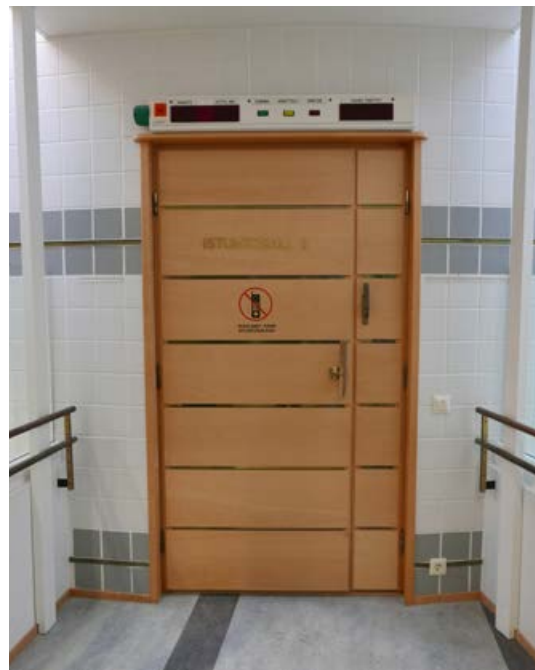
Istuntosalin pyökkipintainen laakaovi, jossa messinkilistat.
