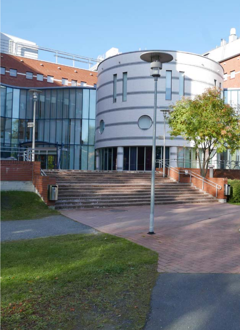
Pääsisäänkäynnille johtavat portaat.
