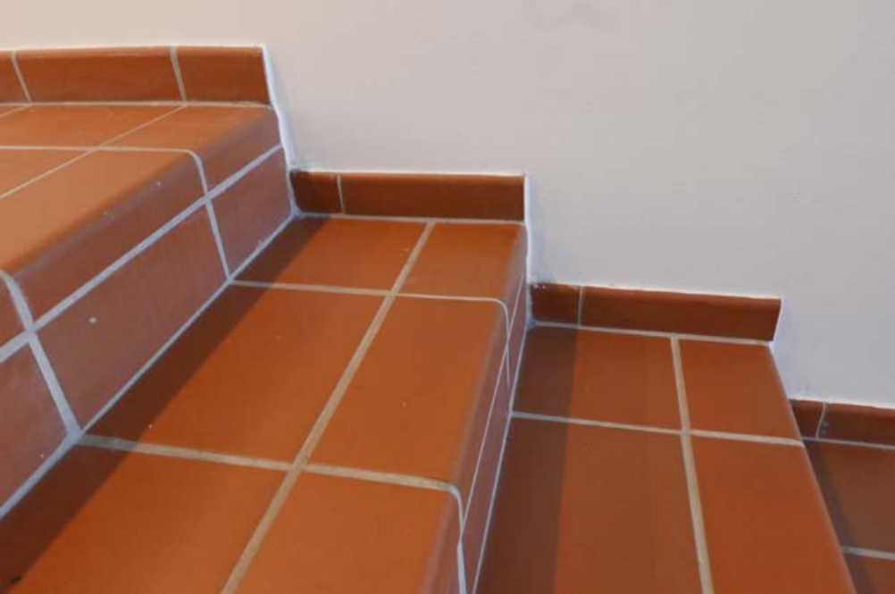
Portaan laattapintaiset askelmat.
