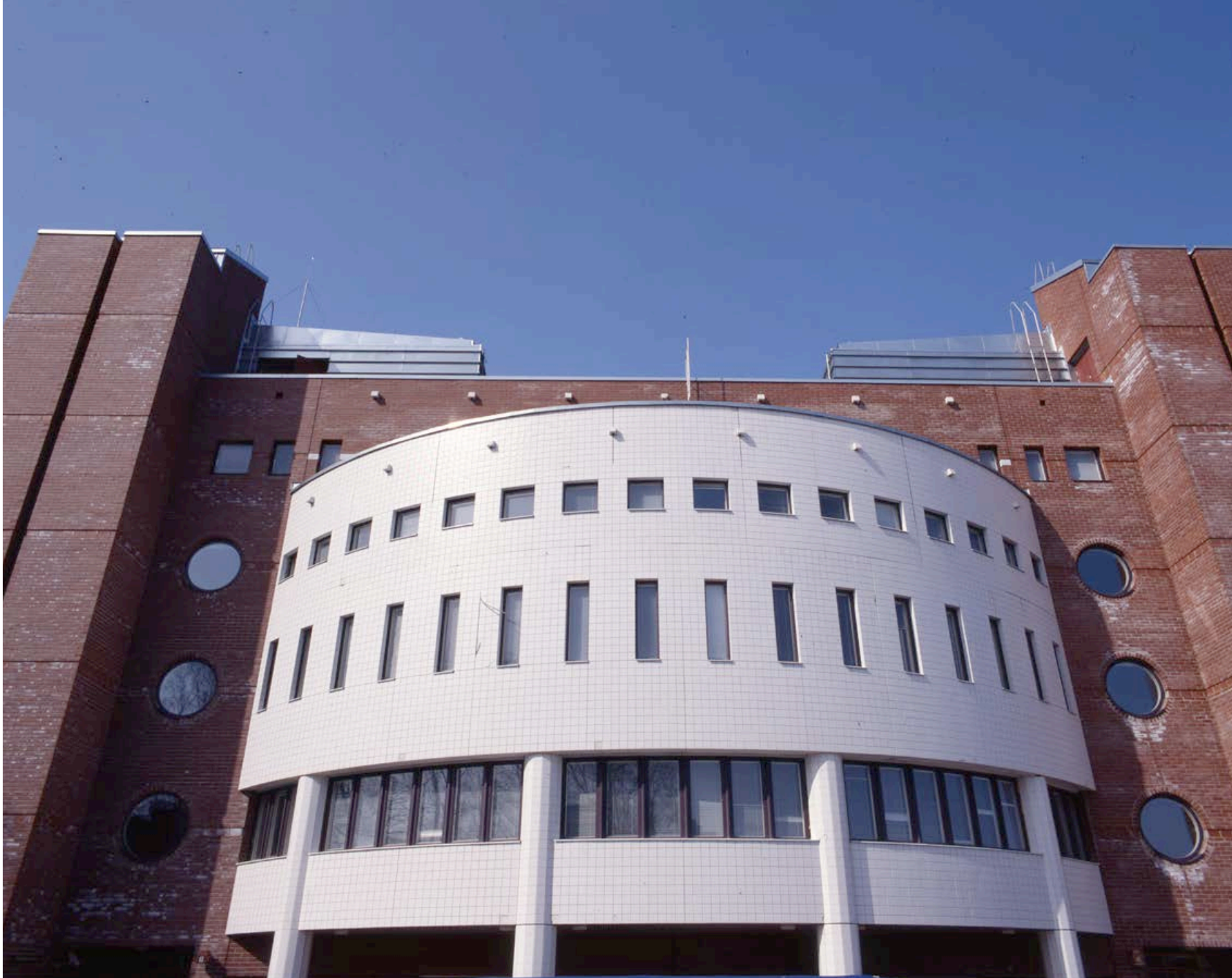
Lähikuva kaarevasta seinästä länsijulkisivulla. Kari Jämsen, 1994. KUHMU
