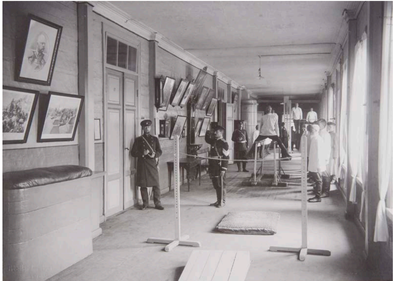
Sisäkuva yhdestä vuonna 1881 valmistuneesta miehistökasarmista todennäköisesti 1900-luvun alusta. Neljä miehistökasarmirakennusta olivat alun perin alueen suurimmat ja tärkeimmät rakennukset. Kaikki niistä on purettu 1970-80-luvuilla. Puolustusvoimat.
