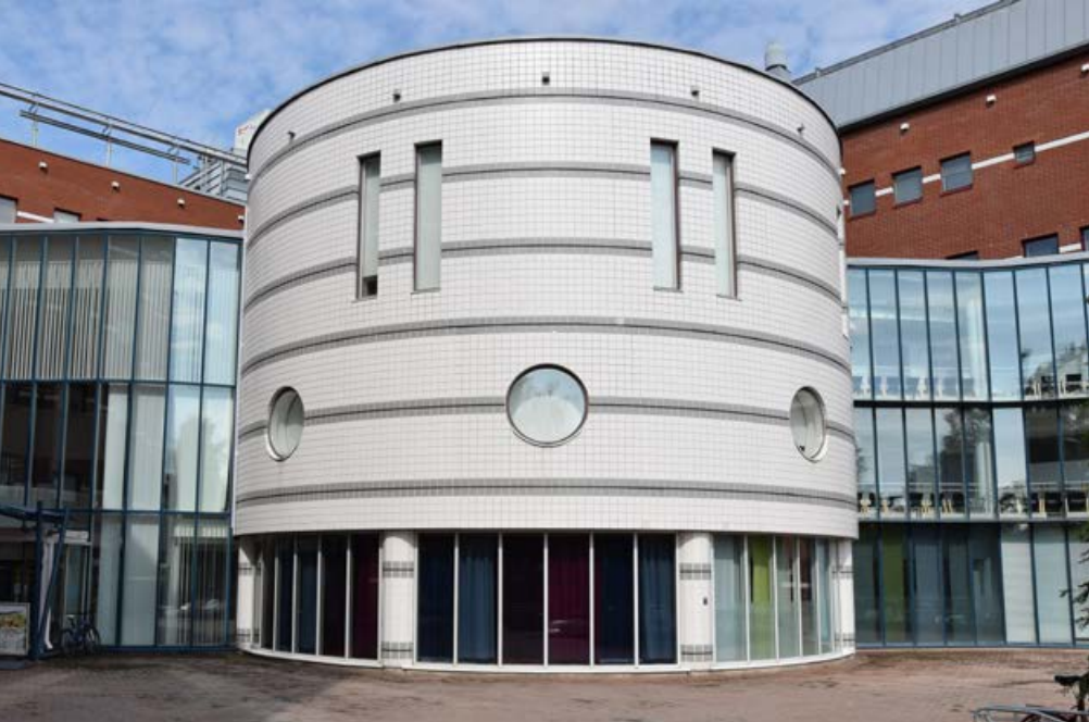
Lasiseinään liittyvä valkoinen laatoitu lieriön mallinen rakennusmassa. Kuva on vuodelta 2022.
