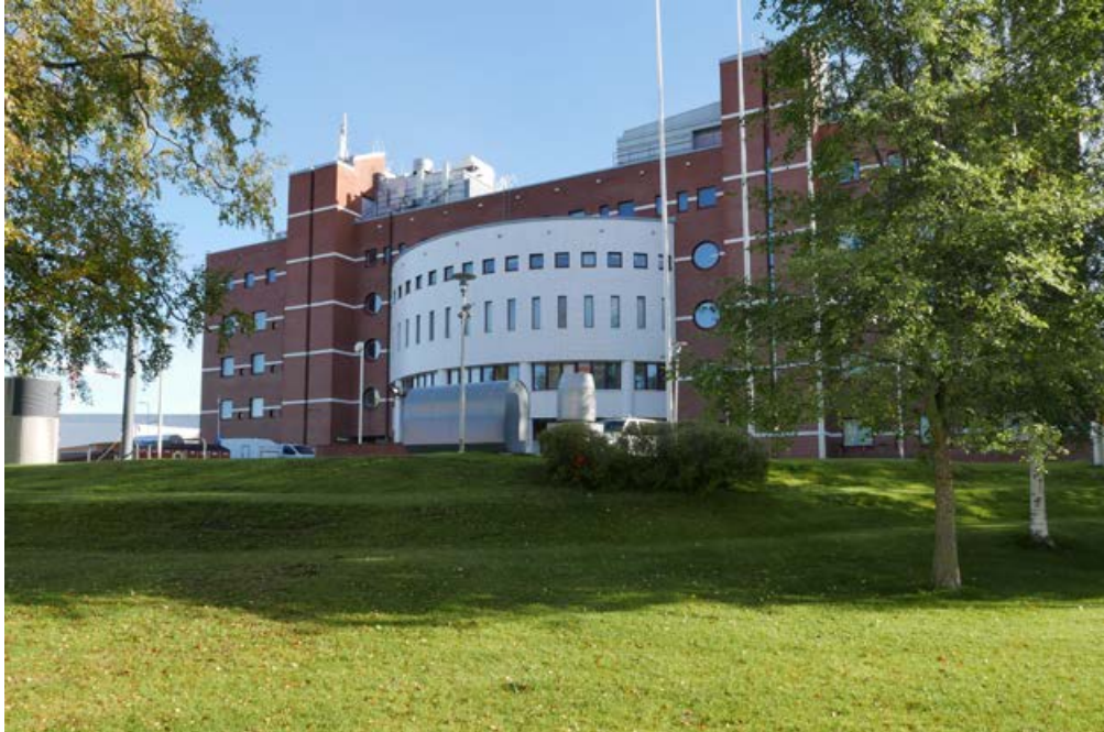
Länsijulkisivu Niiralankadulta katsottuna.
