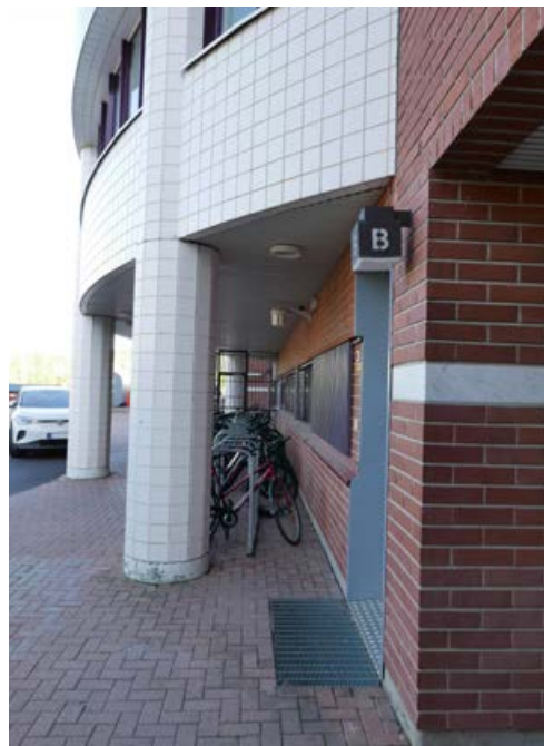
Erkkeriä kannattelevat pilarit.
