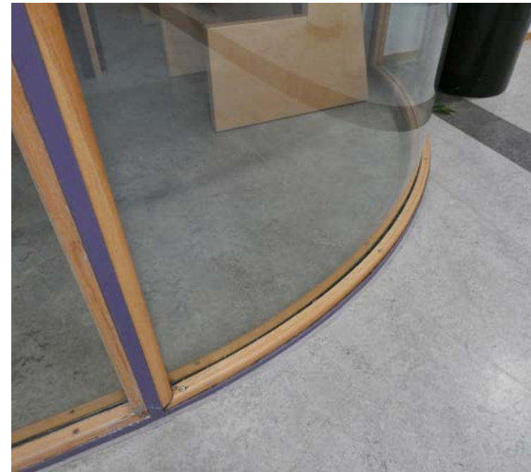
Linoleum-lattia ja kaareva pyökkilistainen lasiseinä. Listat on kiinnitetty messinkiruuvein.
