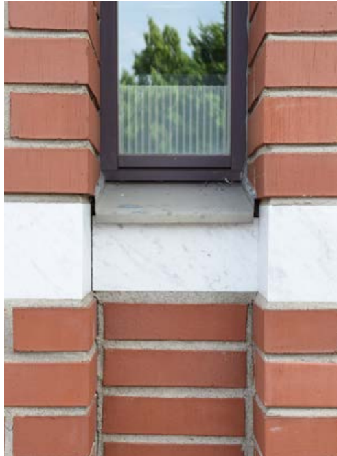
Porrashuoneen kiinteä ikkuna ja räystäspeltti. Kuva on vuodelta 2022.
