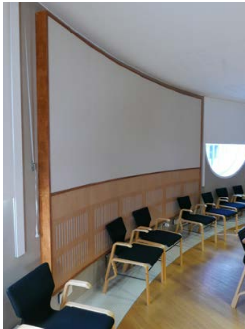
2. kerroksen istuntosalin uusittua mosaiikkilaattalattiaa ja uusi akustoseinäke.
