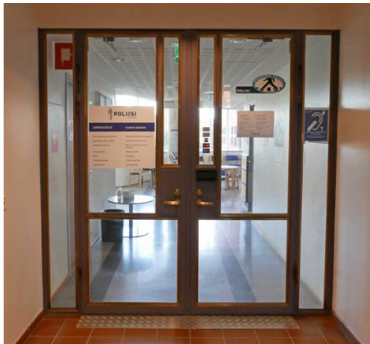
2. kerroksen palveluaulan teräslasiovi.
