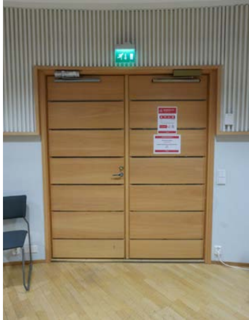
Luentosalin pyökkiviilu pariovi, jossa messinkilistat.
