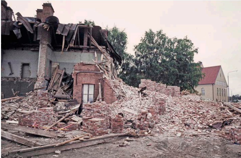
Niiralankadun varrella olleet punatiilirakennukset purettiin vuonna 1981. KUHMU / Erkki Hietanen
