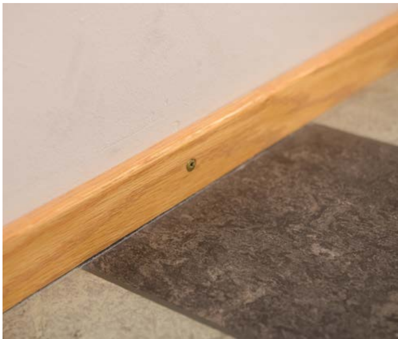
Tammilista ja messinkiruuvi sekä linoleum-lattia.
