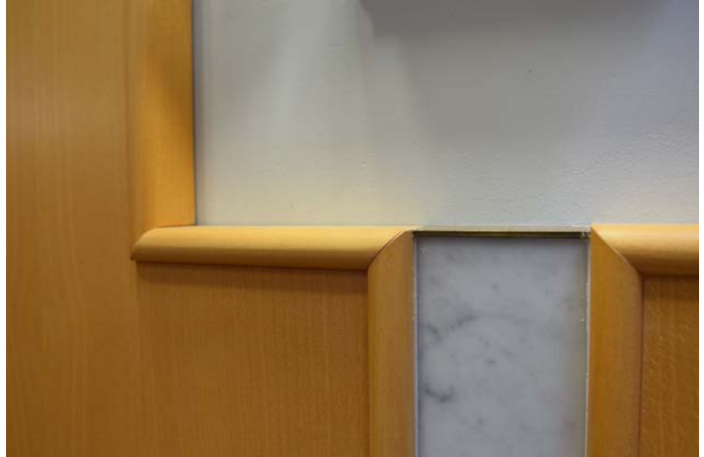
Istuntosalin seinän yksityiskohtia. Pyökkiviilua, pyökkilista, vaaleaa marmoria ja messinkilista.
