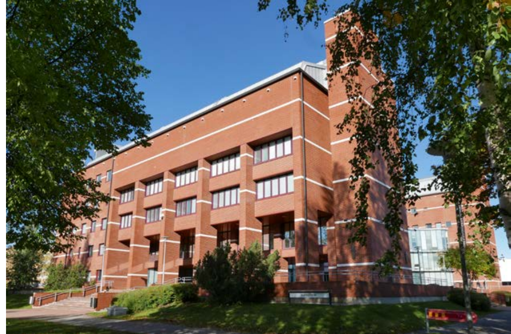
Eteläjulkisivu kaakosta katsottuna.
