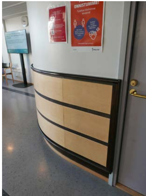
Palveluhallin seinän alaosan puuverhous.
