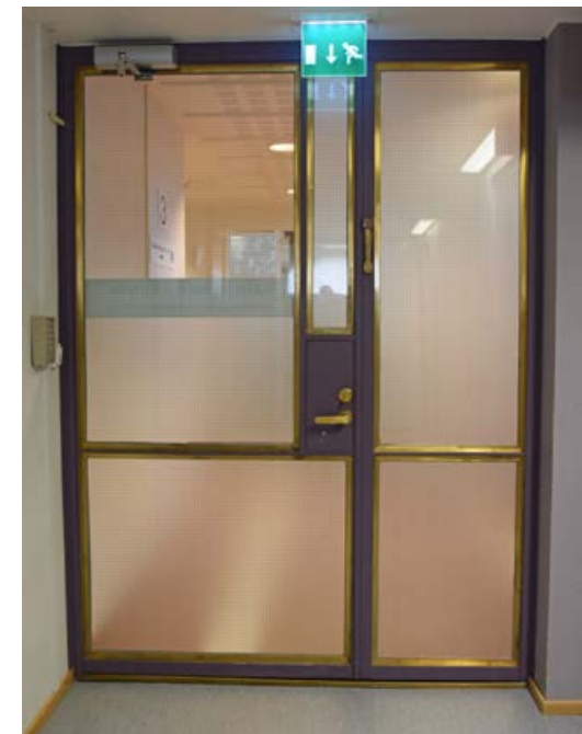
Käytävän teräslasi väliovi, jossa messinkilistat. Kuva on vuodelta 2022.
