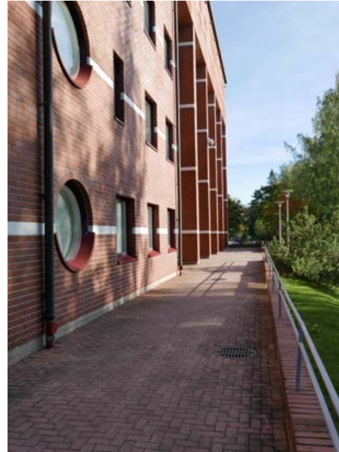
Tiilimuurilla rajattu kulkualue rakennuksen vierellä.
