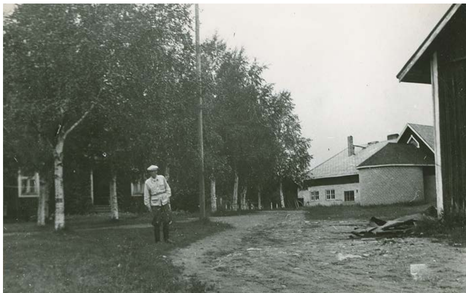
Koeaseman navetta ensimmäisten kerroksen laajojen muutostöiden jälkeen. Rakennuksen ensimmäinen kerros rakennettiin kokonaan uudestaan tiilirakenteiseksi. Kuva: Siikajoen luonnonvarakeskus.
