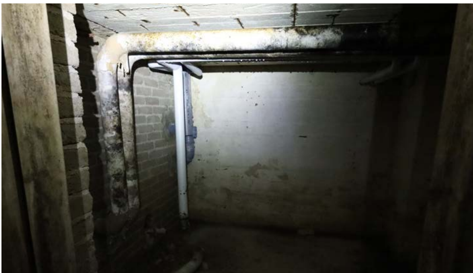
Kellarin sisätilat ovat oletettavasti 1950-luvun asussa, mutta lämmityslaitteisiin on kohdistunut myöhempiä muutoksia. Kuva: Riitta Kosonen 9/25, Arkkitehtitoimisto Jorma Teppo Oy.
