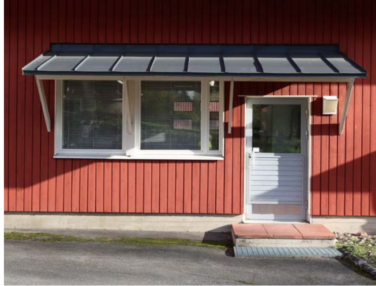
Työhalliin johtava vaakapaneloitu ja lasiaukkoinen ulko-ovi ovat rakentamisaikaiset. Kuva: Riitta Kosonen 9/25, Arkkitehtitoimisto Jorma Teppo Oy.
