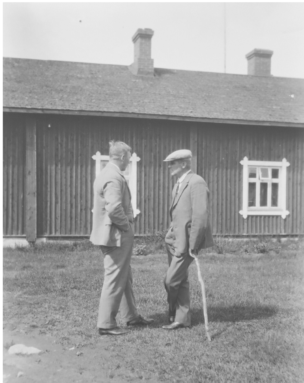
Pirttirakennuksen pihan puoleinen julkisivu arviolta 1930-luvulla. Pystyvuoratuissa julkisivuissa erottuvat hirsiseinien päiden koteloinnit sekä pärekattolla olevat kaksi tiilipiippua. Kuva: O. Antti-sen kokoelmat.
