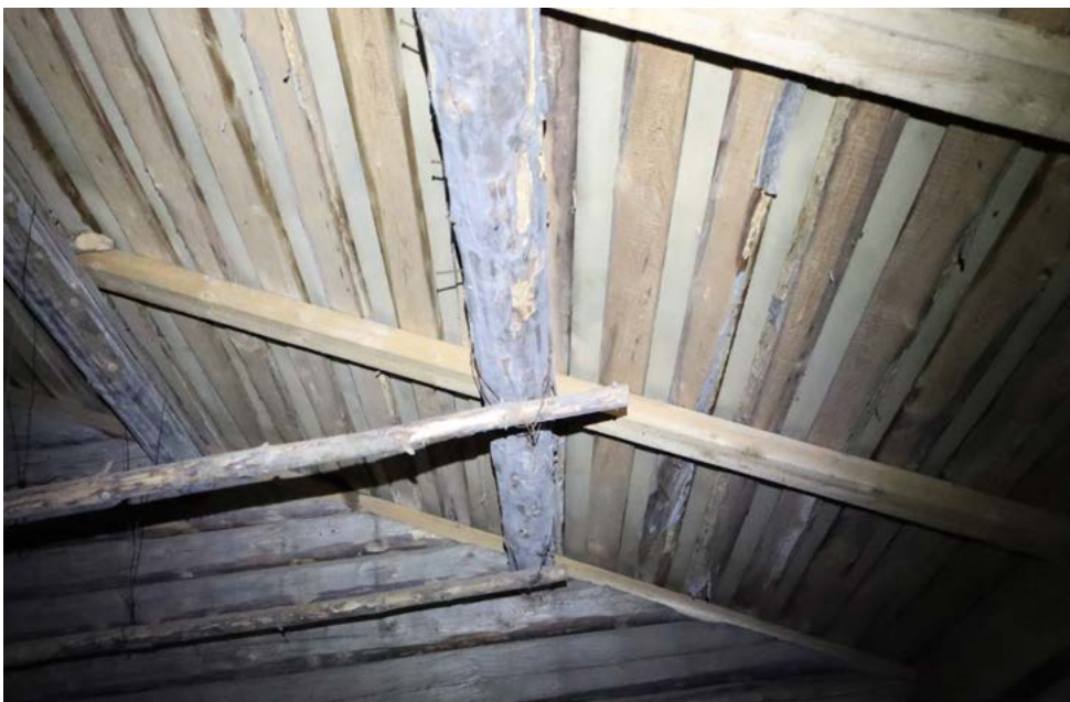
Ullakon alkuperäiset kattopalkit, joiden päällä uudet kattovasat ja vesikattorakenteet tukeutuvat. Kuva: Riitta Kosonen 9/25, Arkkitehtitoimisto Jorma Teppo Oy.
