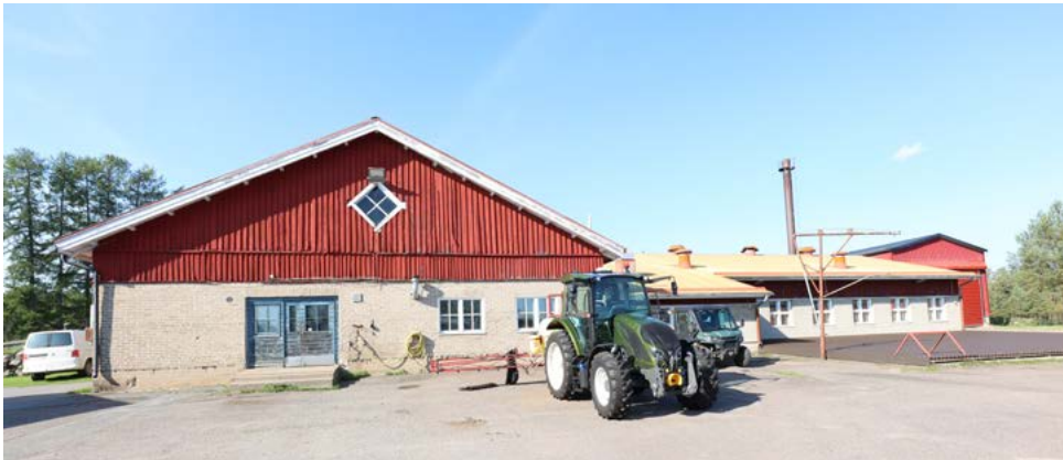
Itäjulkisivulla oleva laajennusosa. Navetan ylisillä oleva päätyikkuna on osa julkisivujen alkuperäistä kerrostumaa. Kuva: Riitta Kosonen 9/25, Arkkitehtitoimisto Jorma Teppo Oy.
