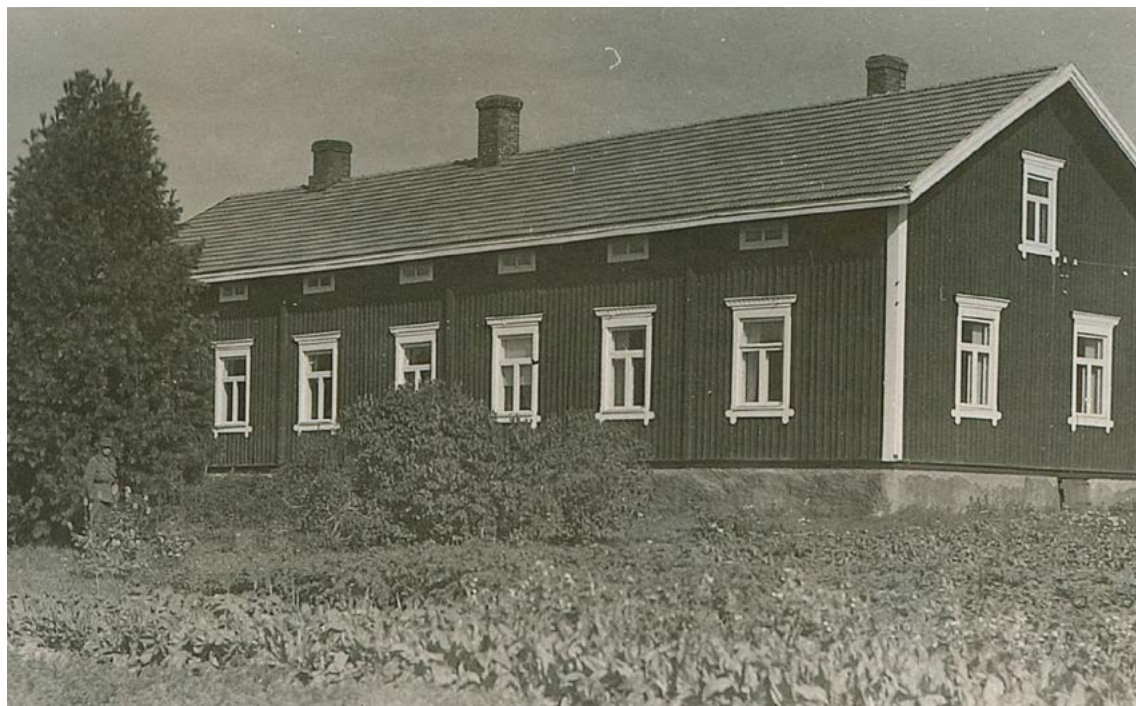
Johtajan asunto kuvattuna 1950-luvulla. Rakennuksen vesikattomateriaali on jo vaihdettu tiilikatteeseen ja korkean luonnonkiviperustuksen pinta on rapattu. Kuva: Siikajoen luonnonvarakeskus.
