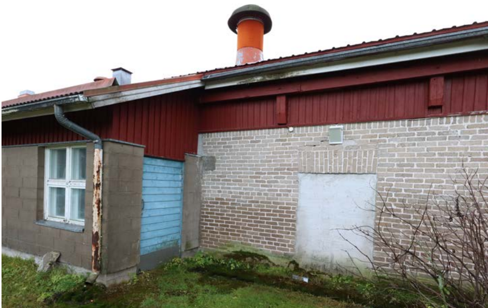
1950-luvun ja 1980-luvun seinärakenteiden liitoskohta. Oikealla on navetan ummistettu oviaukko. Kuva: Riitta Kosonen 9/25, Arkkitehtitoimisto Jorma Teppo Oy.
