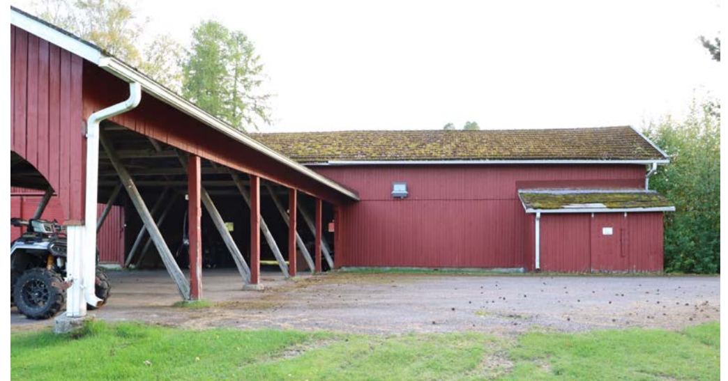
Rakennuksen pohjoisjulkisivulle on lisätty matala liukuovellinen jätekatos. Kuva: Riitta Kosonen 9/25, Arkkitehtitoimisto Jorma Teppo Oy.
