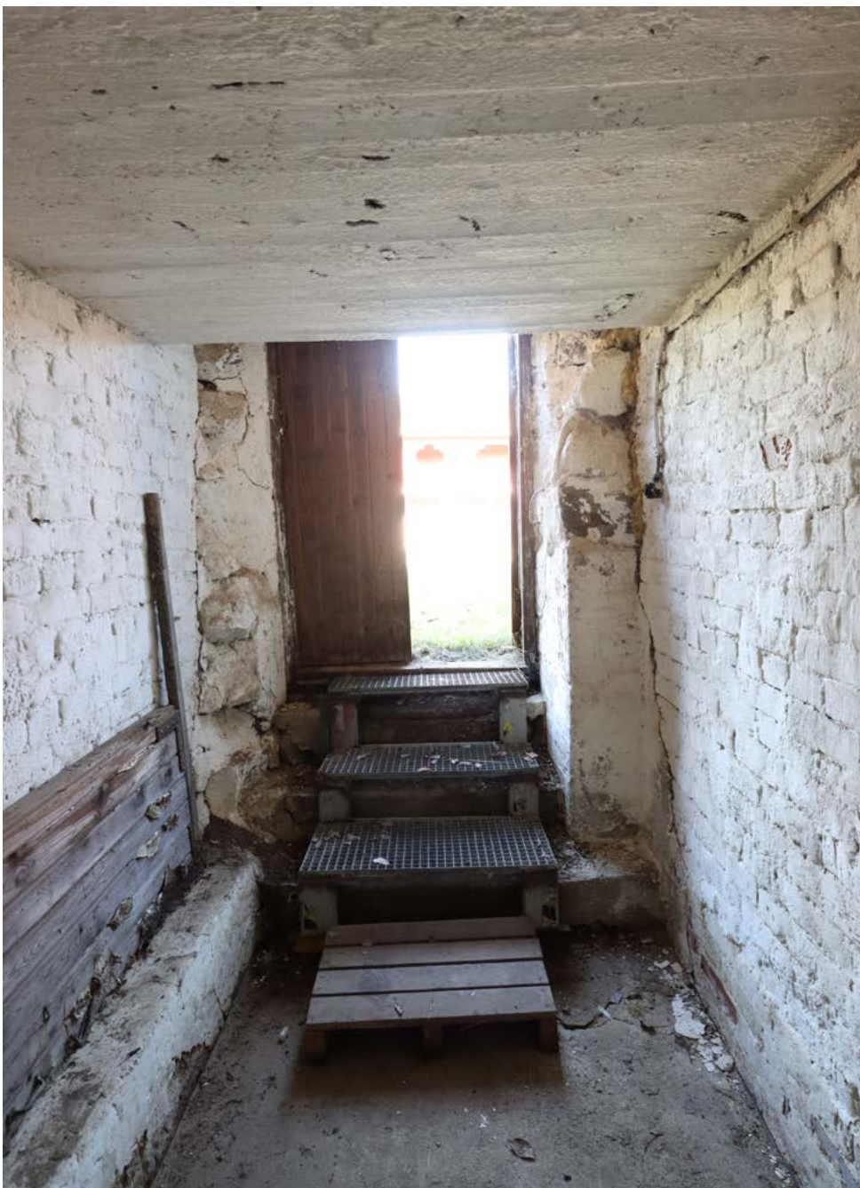
Sisäänkäynnistä alas kellariin johtavat betoniportaavat, joiden päälle on asennettu ritiläpinnaiset porrasaskelmat. Kuva: Riitta Kosonen 11/25, Arkkitehtitoimisto Jorma Teppo Oy.
