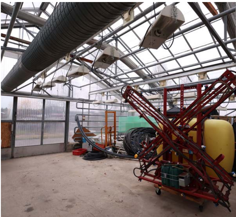
Kasvihuoneen sisätilat ovat lähes alkuperäisessä asussaan. Tila on nykyisin varastokäytössä. Kuva: Riitta Kosonen 11/25, Arkkitehtitoimisto Jorma Teppo Oy.
