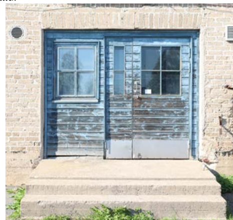
Navetan 1950-luvun ikkunoiden yläpuolella on venäläinen tiiliholvaus. Osa navetan ikkunoista on peitetty polyuretaanilevyillä.
