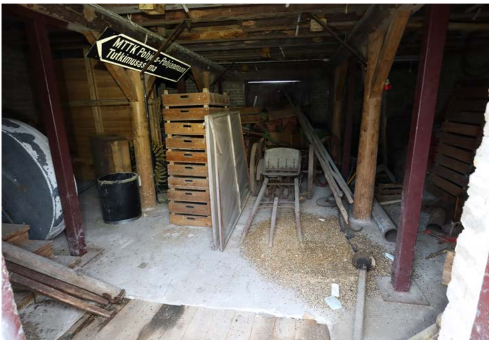
Ensimmäisen kerroksen sisätilat ovat varastokäytössä. Kuva: Riitta Kosonen 9/25, Arkkitehtitoimisto Jorma Teppo Oy.
