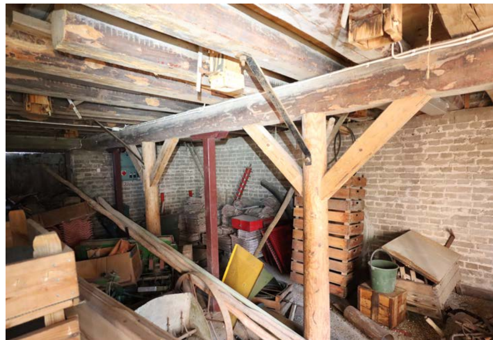
Ensimmäisen kerroksen sisätilat ovat oletettavasti lähes alkuperäisessä asussaan. Teräksiset tukirakenteet ovat 1970-luvun kerrostumaa. Kuva: Riitta Kosonen 9/25, Arkkitehtitoimisto Jorma Teppo Oy.
