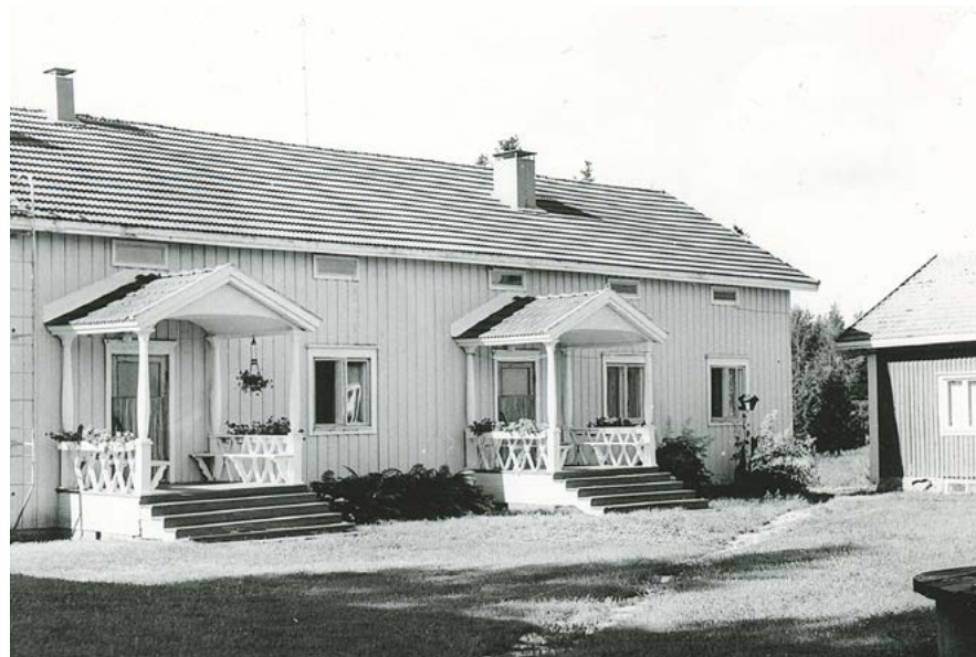
Ala-Greuksen päärakennuksen julkisivujen värit ja verhous uusittiin, ja ikkunat vaihdettiin jälleenrakennuskaudelle tyypillisiin kaksiosaisiin ikkunoihin. Kuva: Siikajoen luonnonvarakeskus.
