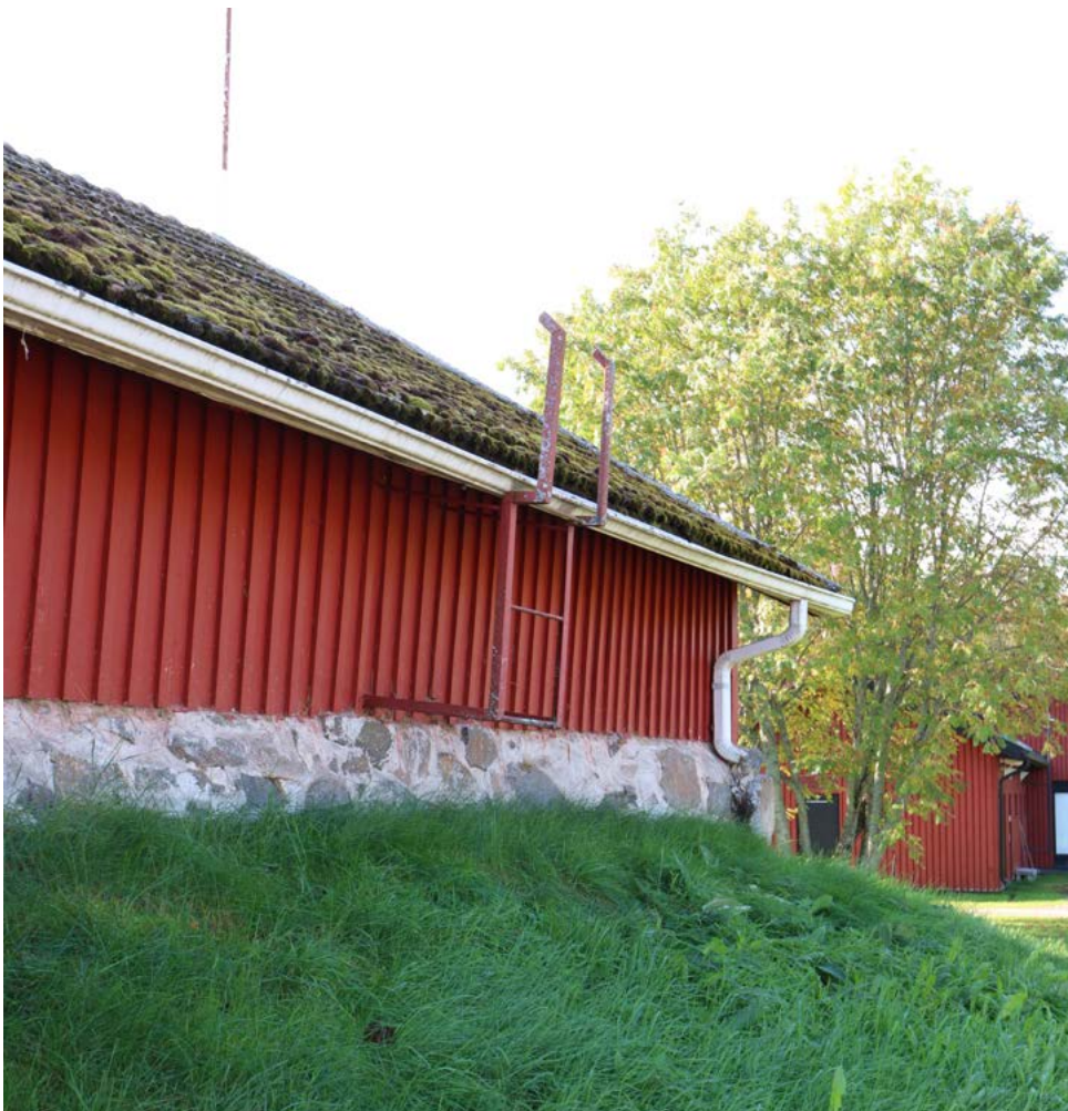
Rakennuksen pohjoisjulkisivun kulma. Kuva: Riitta Kosonen 9/25, Arkkitehtitoimisto Jorma Teppo Oy.
