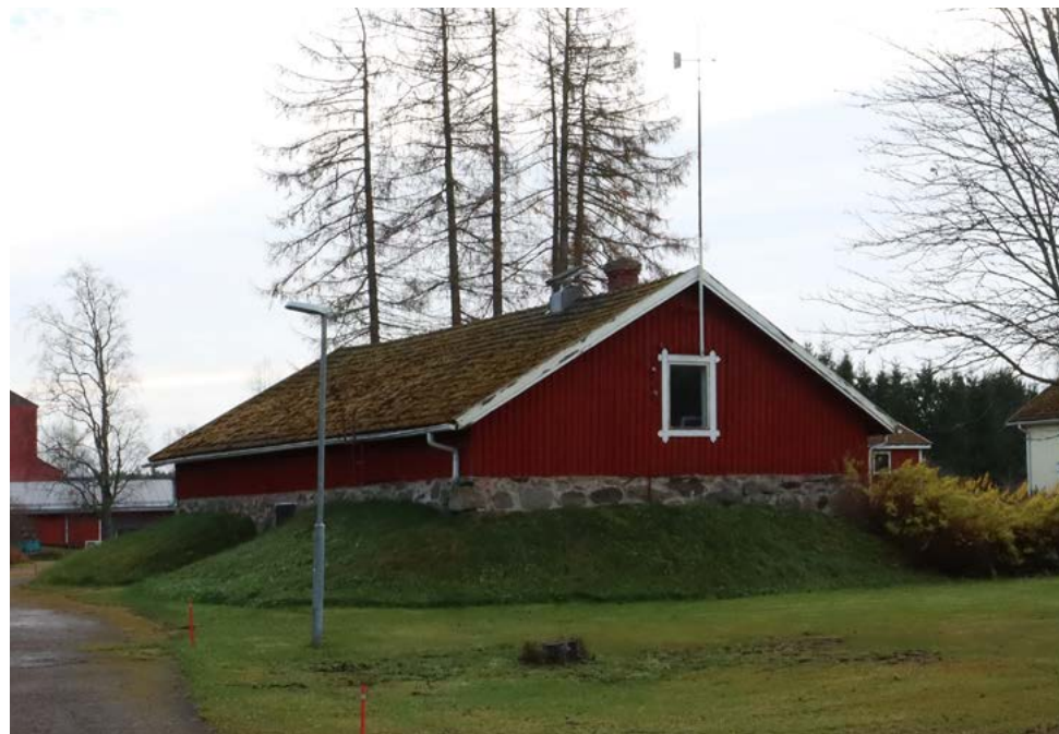
Rakennuksen päädyssä oleva ikkuna on vaihdettu pihapiiriin muita rakennuksia myöhemmin yksiruutuisen ikkunaan. Kuva: Riitta Kosonen 11/25, Arkkitehtitoimisto Jorma Teppo Oy.
