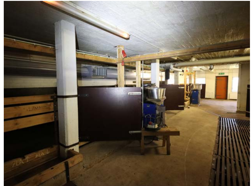
Vasikkanavetan karsinarakenne sijoittuu tilassa olevien kantavien betonipilareiden väleihin. Kuva: Riitta Kosonen 9/25, Arkkitehtitoimisto Jorma Teppo Oy.
