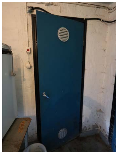
Karjakeittiön 1970-luvun laakaovi, johon on lisätty korvausilmasäleiköt.
