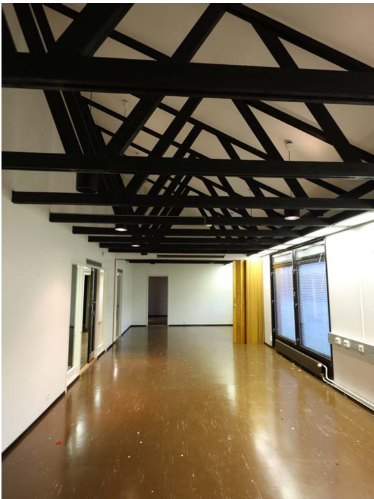
Korkeassa neuvottelutilassa olevat kattoristikot ovat tilaa hallitseva elementti. Kuva: Riitta Kosonen 11/25, Arkkitehtitoimisto Jorma Teppo Oy.
