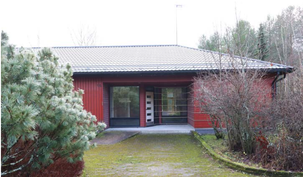
Laajennusosan sisäänkäynti, joka on alkuperäisen tavoin sisennetty. Kuva: Riitta Kosonen 11/25, Arkkitehtitoimisto Jorma Teppo Oy.
