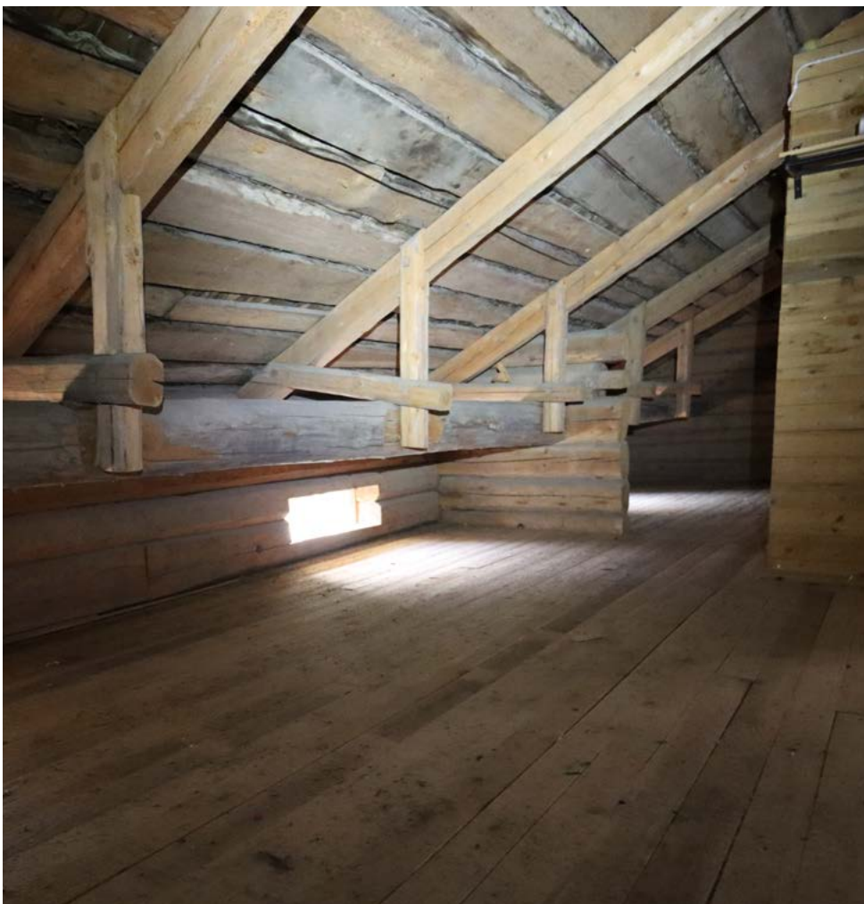
Rakennuksen ullakolla on nähtävissä sen hirsinen runkorakenne sekä puiset ruotsalaistyylliset kattotuolit. Kuva: Riitta Kosonen 9/2025, Arkkitehtitoimisto Jorma Teppo Oy.
