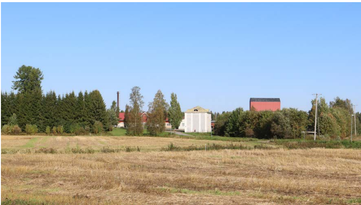
Luonnonvarakeskuksen maisemallinen arvo on muuttunut ja rakennusryhmän ympärille kasvanut kasvillisuus on katkaissut näkymiä Sammalkankaantielle. Viljasiiilo ja talousrakennuksen kuivaaja ovat edelleen maisemallisesti tärkeitä. Kuva: Riitta Kosonen 9/25, Arkkitehtitoimisto Jorma Teppo Oy.
