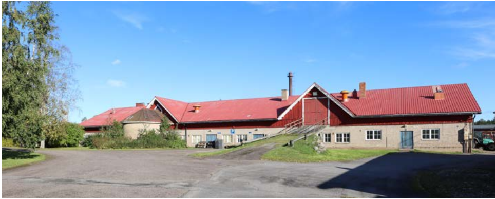
Navetan eteläjulkisivu on säilyttänyt alkuperäisen muotonsa, mutta aukotus ja materiaalit ovat muuttuneet. Kuva: Riitta Kosonen 9/25, Arkkitehtitoimisto Jorma Teppo Oy.
