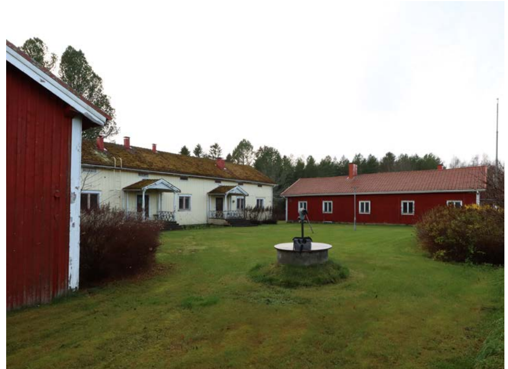
Ala-Greuksen tilan vanha pihapiiri on säilyttänyt koeaseman perustamisaikaisen muotonsa. Rakennusten julkisivujen ilmeissä näkyy jälleenrakennuskauden muutostöiden aikainen kerrostuma. Kuva: Riitta Kosonen 11/25, Arkkitehtitoimisto Jorma Teppo Oy
