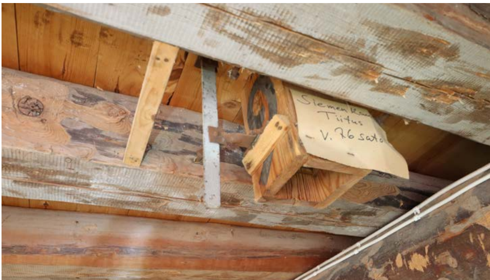
Välipohjan alapinnassa olevia viljasuppiloiden suuaukkoja. Kuva: Riitta Kosonen 9/25, Arkkitehtitoimisto Jorma Teppo Oy.
