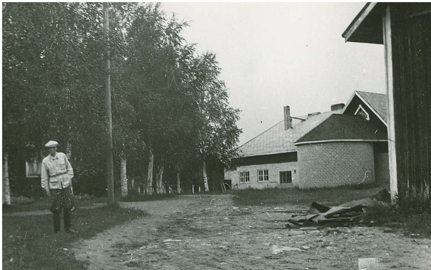
Navetan eteläjulkisivu kuvattuna vuonna 1954, jolloin ensimmäisen kerroksen muutostyöt oli saatettu valmiiksi. Julkisivun länsireunassa olleet T-ikkunat korvattiin kaksiosaisilla ruutuikkunoilla ja toinen ylisille johtaneista luukuista peittyi tuorerehusiilon kattorakenteen taakse. Kuva: Siikajoen luonnonvarakeskus.
