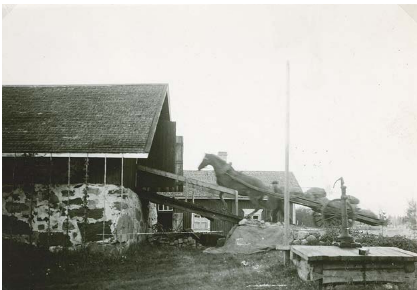
Kivinavetan päätyyn lisätty puurakenteinen luiska, jonka kautta kuljetettiin ylisille tavaraa. Etualalla oleva kaivon reunat muodostuvat hirsikehästä ja taustalla erottuu Ala-Greuksen pihapiirissä ollut vanha asuinrakennus. Kuva: Siikajoen luonnonvarakeskus.
