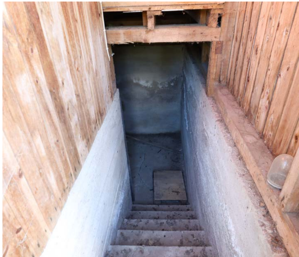
Kellariin johtavat 1950-luvulla rakennetut betoniportaat. Kuva: Riitta Kosonen 9/25, Arkkitehtitoimisto Jorma Teppo Oy.
