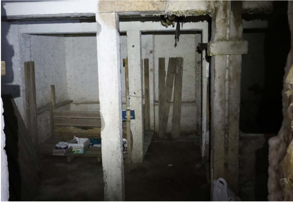
Kellarin sisätilojen betonirakenteita on tuettu puurakenteilla. Kuva: Riitta Kosonen 9/25, Arkkitehtitoimisto Jorma Teppo Oy.
