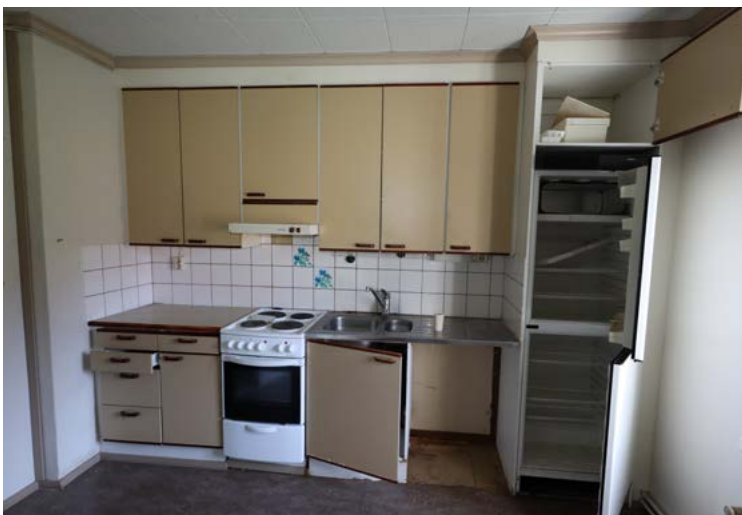
Kenttämestarin asunnon keittiökalusteiden kerrostuma on 1970-luvulta. Kuva: Riitta Kosonen 9/25, Arkkitehtitoimisto Jorma Teppo Oy.
