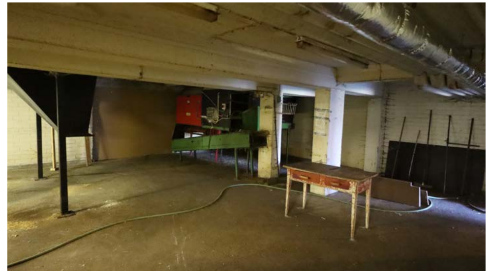
159 Navetan rehunkäsittelytila, jossa olevien siilojen täyttöluukut sijaitsevat ullakolla. Kuva: Riitta Kosonen 9/25, Arkkitehtitoimisto Jorma Teppo Oy.
