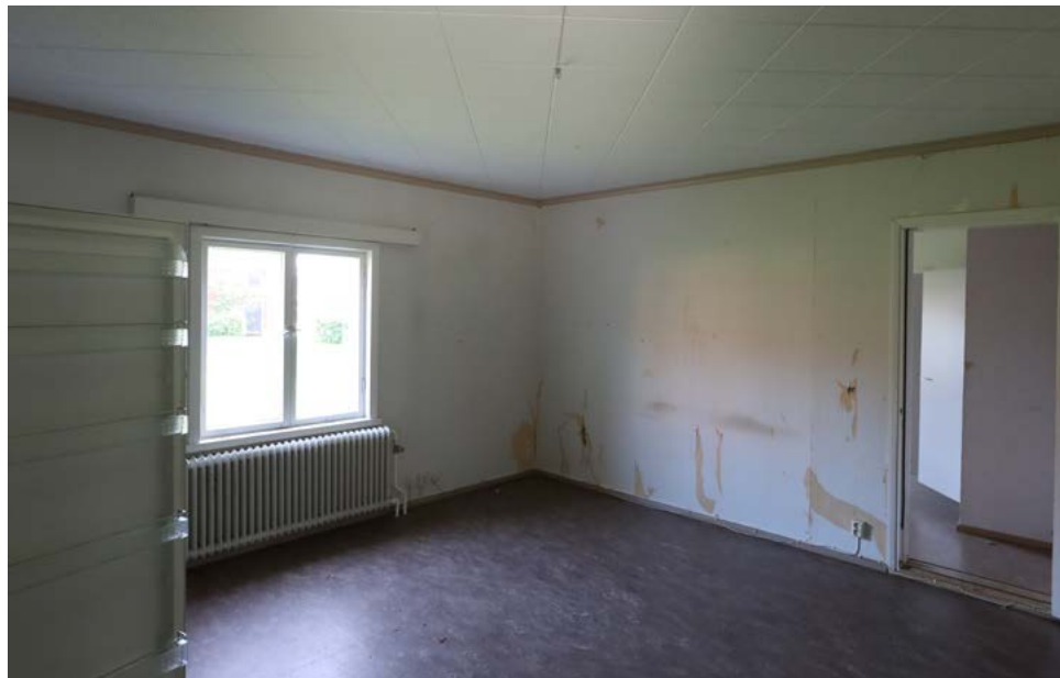
Kenttämestarin asunnon oleskelutila, jonka pintarakenteet ovat 1980-luvun kerrostumaa. Sisäkaton levypinta on asennettu diagonaalisesti seiniin nähden. Kuva: Riitta Kosonen 9/25, Arkkitehtitoimisto Jorma Teppo Oy.
