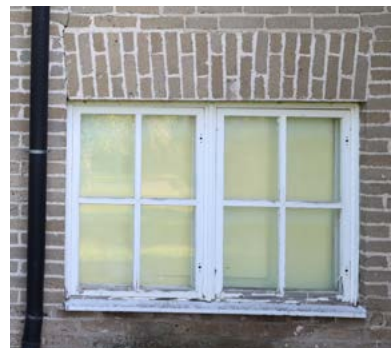
Navetan 1950-luvun ikkunoiden yläpuolella on venäläinen tiiliholvaus. Osa navetan ikkunoista on peitetty polyuretaanilevyillä.
