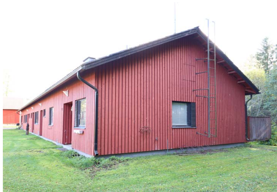
Länsipäädyn pystyverhoiltu julkisivu. Kuva: Riitta Kosonen 9/25, Arkkitehtitoimisto Jorma Teppo Oy.
