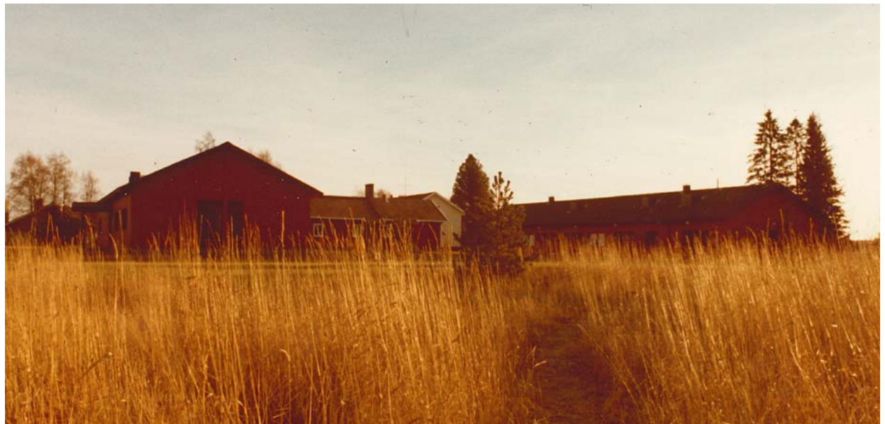
Näkymä toimistorakennuksen länsipuolella olevalta aukealta kohti rakennuksia. Ilmeiltään yhtenevät toimisto- ja asuinrakennus muodostivat uuden 1970-luvun kerrostuman koeaseman rakennuskantaan. Vasemmalla olevan toimistorakennuksen päädyssä näkyvät siinä olleet kaksi ikkunaa. Kuva: Siikajoen luonnonvarakeskus.
