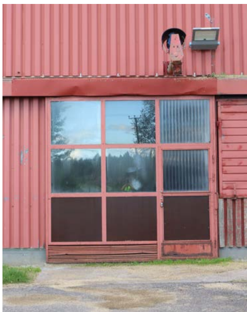
Siiloon johtavat teräsluukuovet ovat alkuperäiset. Kuva: Riitta Kosonen 9/25, Arkkitehtitoimisto Jorma Teppo Oy.
