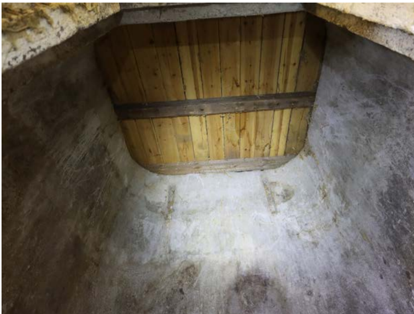
Vasemmalla: 1950-luvun muutosten aikainen pieni viljasiilo, jonka betonirakenteisten seinien sisänurkat on pyöristetty. Siilossa säilöttiin litistettyä tuoresäilöttyä viljaa.
