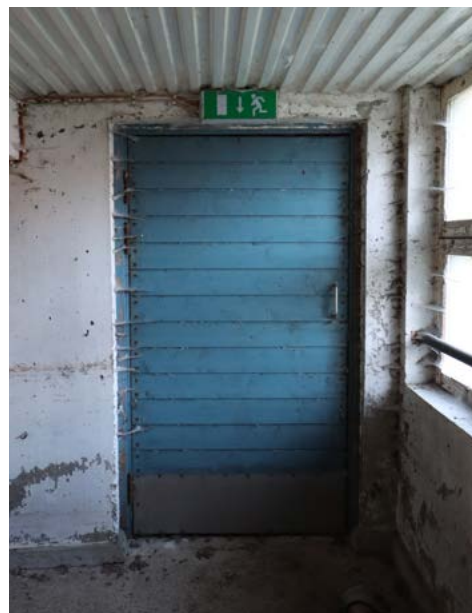
Navettalaajennuksen 1980-luvun puurakenteisen ovi.
