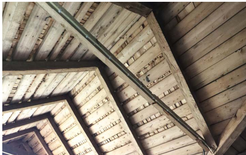
Ylisten kattopinnassa on nähtävissä alkuperäisen mukainen pärekatto. Kuva: Riitta Kosonen 9/25, Arkkitehtitoimisto Jorma Teppo Oy.
