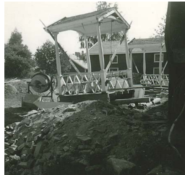
Vuonna 1972 otetussa kuvassa näkyvät, 1950-luvulla uusitut ikkunat ja ulko-ovet sekä alkuperäisenä säilyneet avokuistit. Puulämmitteisten uunien purkamisen myötä vanhat tiilipiiput purettiin. Katolla näkyvät uudet peltipintaist hormit. Kuva: Siikajoen luonnonvarakeskus.
