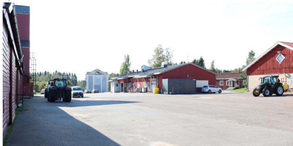
Uusi työhalli muodostaa kalustopihan yhdessä vasemmalla olevan talousrakennuksen ja oikealla erottuvan navetan kanssa. Kuva: Riitta Kosonen 9/25, Arkkitehtitoimisto Jorma Teppo Oy.
