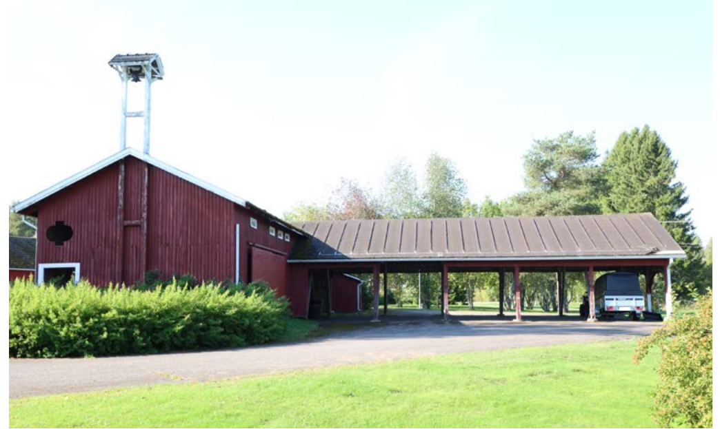
Autohallin umpinaisesta osasta työntyvä avokatos. Kuva: Riitta Kosonen 9/25, Arkkitehtitoimisto Jorma Teppo Oy.
