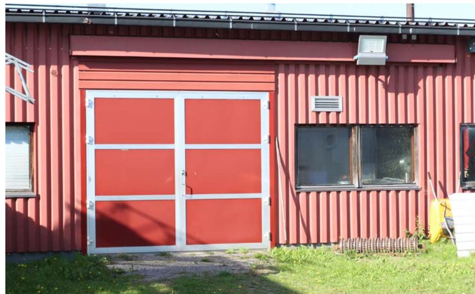
Idätystilan alumiinipariovi ja puuikkuna ovat 1980-luvun kerrostumaa. Kuva: Riitta Kosonen 9/25, Arkkitehtitoimisto Jorma Teppo Oy.
