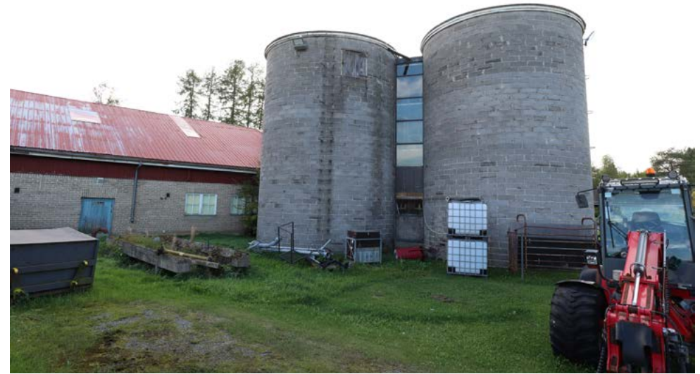
Pohjoisjulkisivulla olevat tornisiilot ovat osa 1970-luvun kerrostumaa. Kuva: Riitta Kosonen 9/25, Arkkitehtitoimisto Jorma Teppo Oy.
