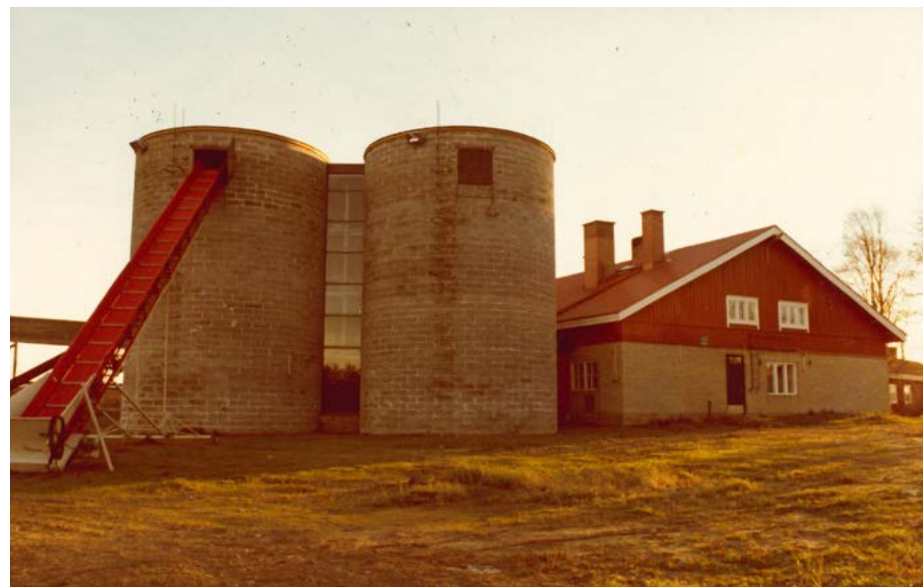
Juuri valmistuneet tornisiilot 1970-luvun lopulla. Kolmesta siilosta muodostuva rakenne liittyy toisiinsa teräsrakenteisten tasojen ja korkeiden lasiseinien avulla. Kuva: Siikajoen luonnonvarakeskus.
