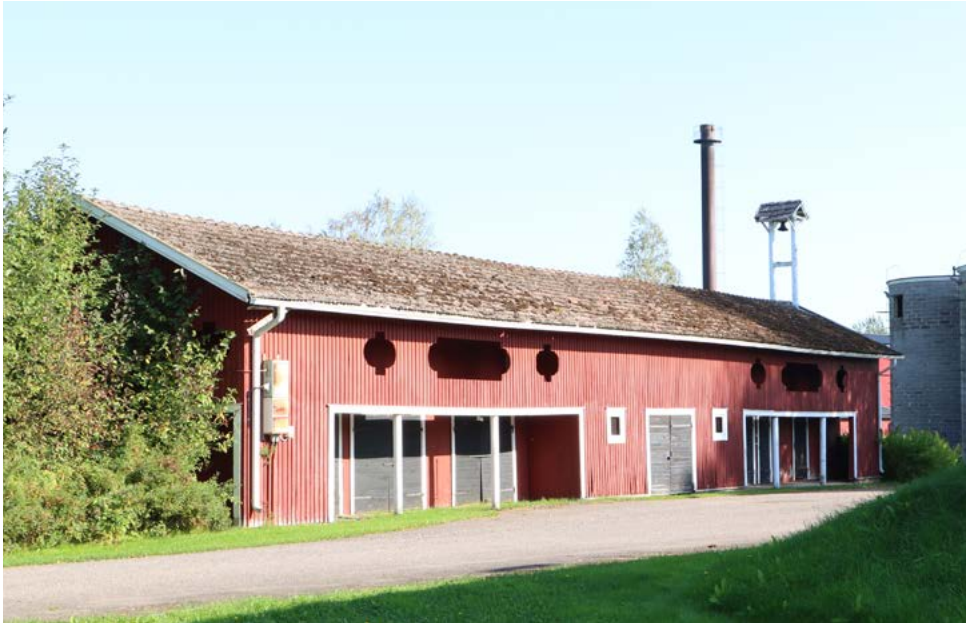
Autohallin eteläjulkisivu. Laajennusosaan on lisätty yksi puurakenteinen pariovi. Kuva: Riitta Kosonen 9/25, Arkkitehtitoimisto Jorma Teppo Oy.
