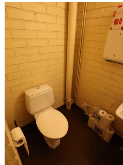
Työskentelytilan yhteydessä oleva wc. Kuva: Riitta Kosonen 9/25, Arkkitehtitoimisto Jorma Teppo Oy.
