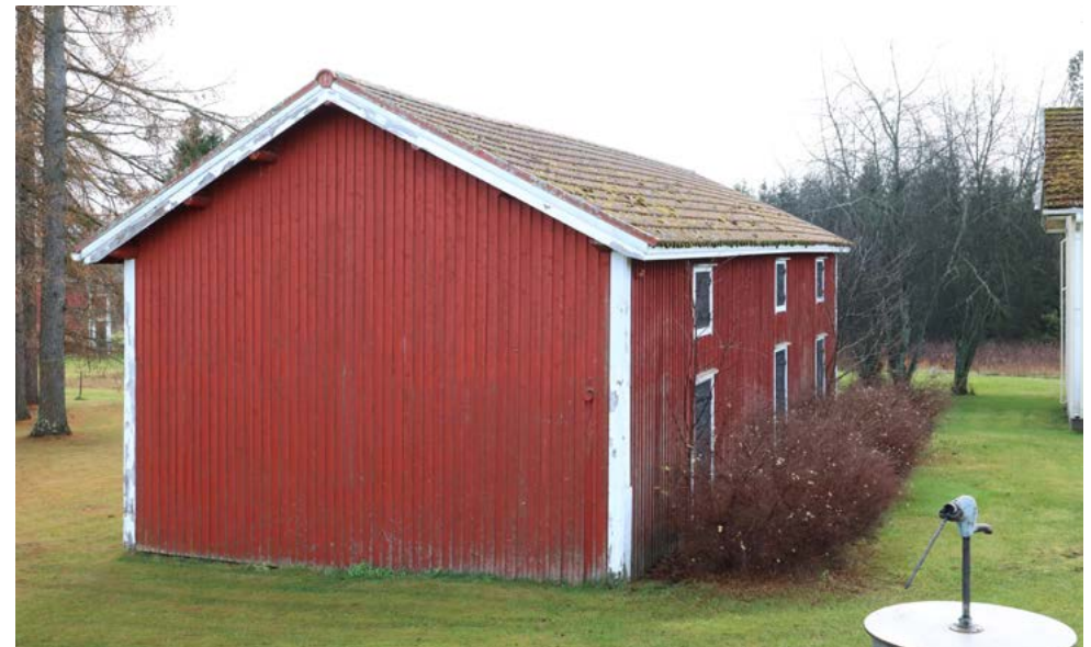
Aitan pohjoispääty, jossa aikaisemmin ollut ikkuna on peitetty pystyverhouksella. Kuva: Riitta Kosonen 11/25, Arkkitehtitoimisto Jorma Teppo Oy.
