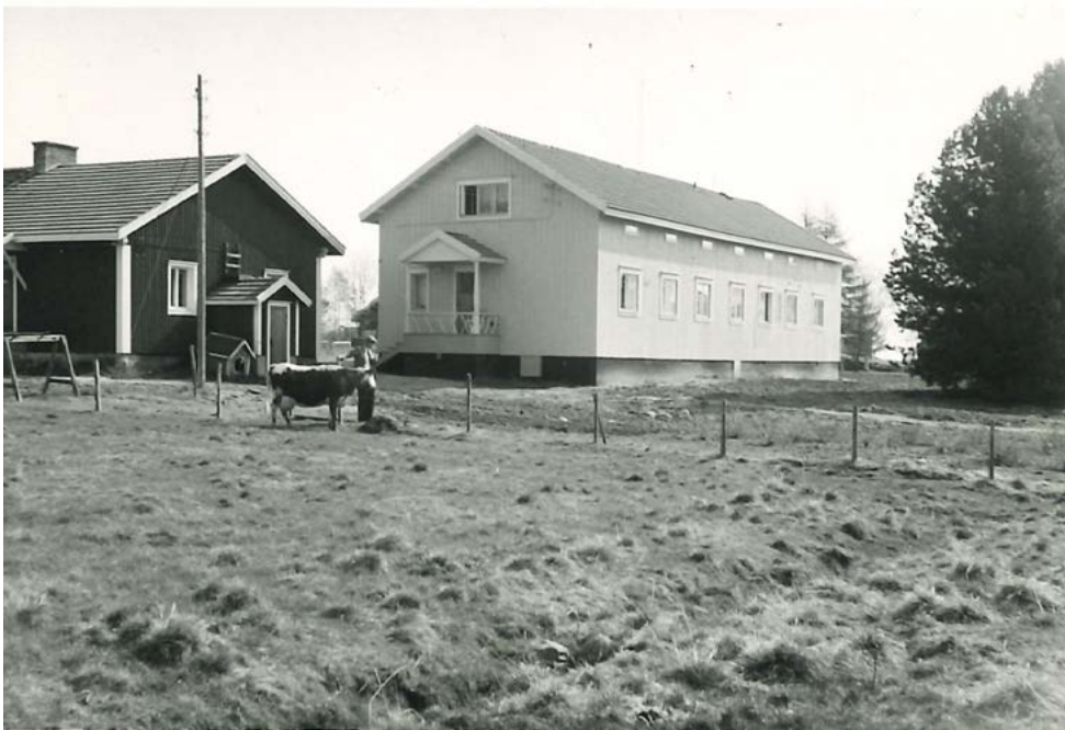
Johtajan asuntola vuoden 1956 muutostöiden jälkeen. Rakennuksen ulkovaippa koki mittavan muodonmuutoksen, ja vain julkisivuilla olevat kuistit ovat alkuperäiset. Katolla olleet alkuperäiset tiilipiiput on poistettu. Kuva: Siikajoen luonnonvarakeskus.
