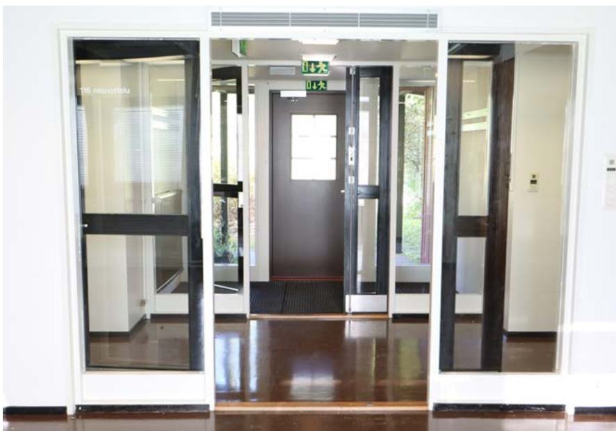
Alkuperäisen toimisto-osan sisäänkäynti, joka avautuu neuvottelutilaan. Kuva: Riitta Kosonen 9/25, Arkkitehtitoimisto Jorma Teppo Oy.
