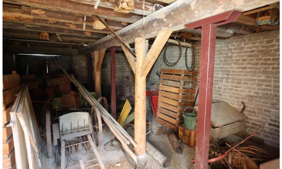
Viljasiilon ensimmäisessä kerroksen puisia välipohjarakenteita tuettiin punaruskeaksi maalatuilla teräspilarilla. Kuva: Riitta Kosonen 9/25, Arkkitehtitoimisto Jorma Teppo Oy.
