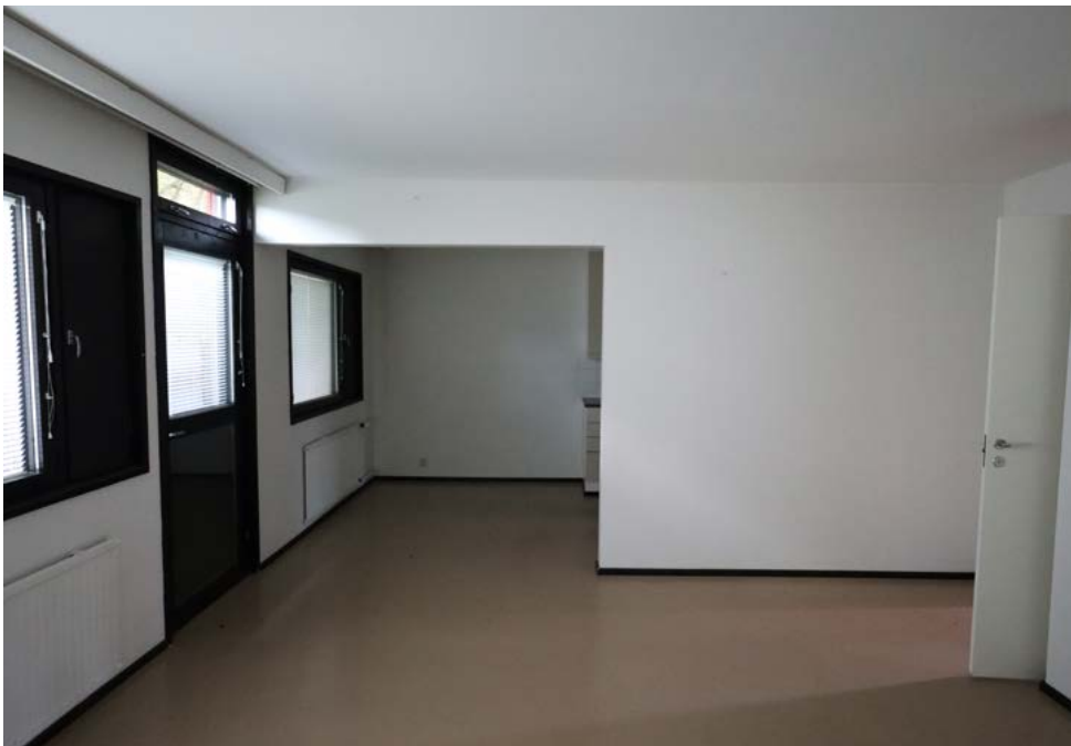
Asuntojen kipsilevyverhoillut sisäpinnat on maalattu valkoisiksi. Sisätilojen ilme ja tilajako vastaa pääosin alkuperäistä. Kuva: Riitta Kosonen 9/25, Arkkitehtitoimisto Jorma Teppo Oy.
