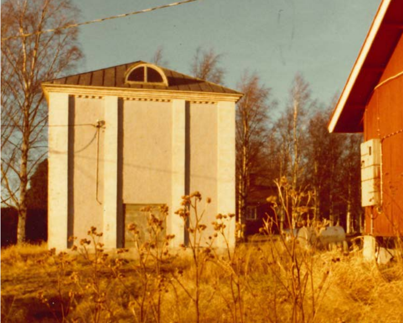
1970-luvun valokuvassa voidaan nähdä vesikaton ikkunoiden muutos kaksiosaisiksi ja keskijakoisiksi. Rakennuksen julkisivuun on myös kiinnitetty sähköjohto. Kuva: Siikajoen luonnonvarakeskus.
