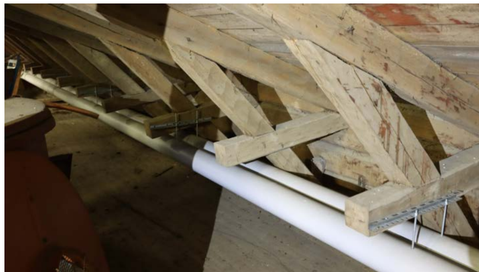
Navetan ylisillä olevat kattotuolit, jotka lepäävät alkuperäisen hirsirungon päällä. Kuva: Riitta Kosonen 9/25, Arkkitehtitoimisto Jorma Teppo Oy.
