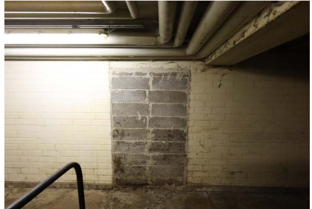
Eteläjulkisivulla olevan rehusäiliön umpeen muurattu oviaukko. Seinäpinnan muuraus on osa 1980-luvun kerrostumaa, jolloin navetan ulkoseiniä lisälämmöneristettiin. Kuva: Riitta Kosonen 9/25, Arkkitehtitoimisto Jorma Teppo Oy.
