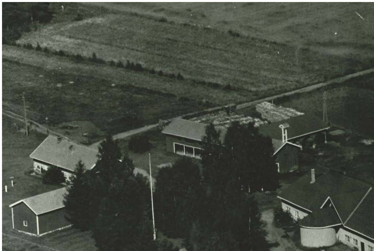
Arviolta 1950-luvulla otetussa viistoilmakuvassa erottuu autokatoksen pohjoispuolisen katoksen kaariyksityiskohdat, jotka myöhemmin tasattiin suorakulmaisiksi. Kuva: Siikajoen luonnonvarakeskus.
