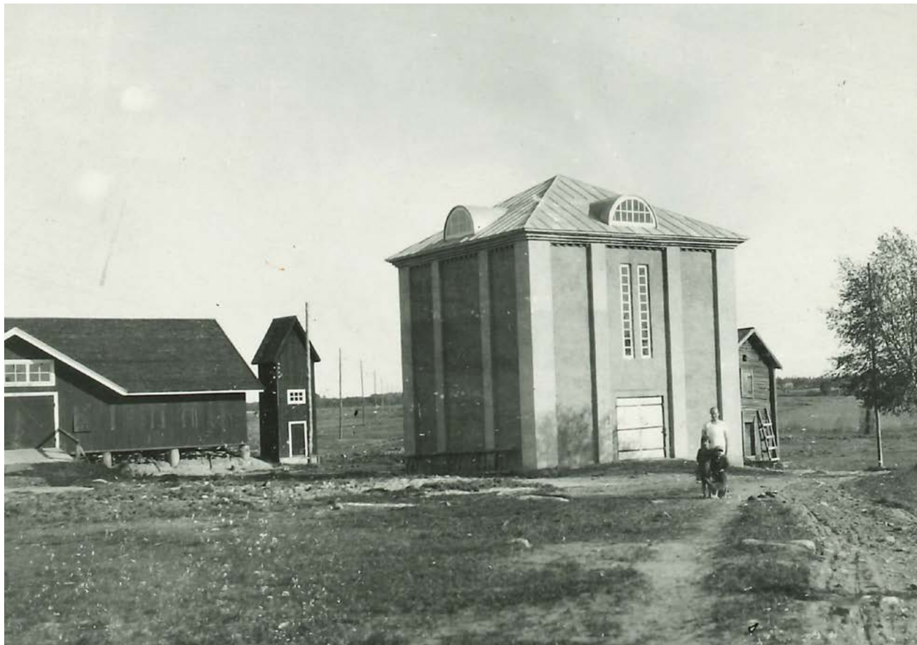
Vuoden 1930 valokuva vuosi aikaisemmin valmistuneesta viljasiilosta. Rakennus rakennettiin ilmariihen viereen, ja sen toisella puolella oli hirsirakenteinen aitta. Kuva: Siikajoen luonnonvarakeskus.
