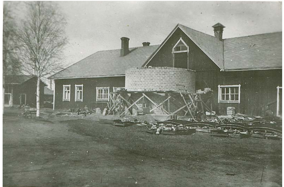
Rakenteilla oleva AIV-rehusiilo vuonna 1947. Rehusiilo rakennettiin betonitiilistä, ja samaa materiaalia käy- tettiin myös muutaman vuoden päästä navetan ensimmäisen kerroksen ulkoseinämateriaalina. Etualalla olevia kaarevia elementtirakenteita käytettiin todennäköisesti rehusiilon sisäpinnassa. Navetan katemate- riaali on kuvassa vaihdettu asbestisementtikattolevyihin. Kuva: Siikajoen luonnonvarakeskus.
