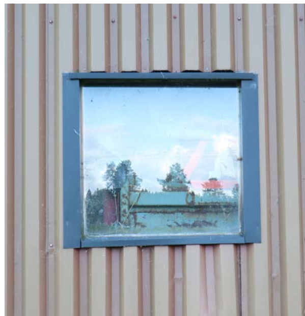
Kaakkoisjulkisivulla oleva pieni, yksilasinen alumiini-ikkuna. Kuva: Riitta Kosonen 9/25, Arkkitehtitoimisto Jorma Teppo Oy.
