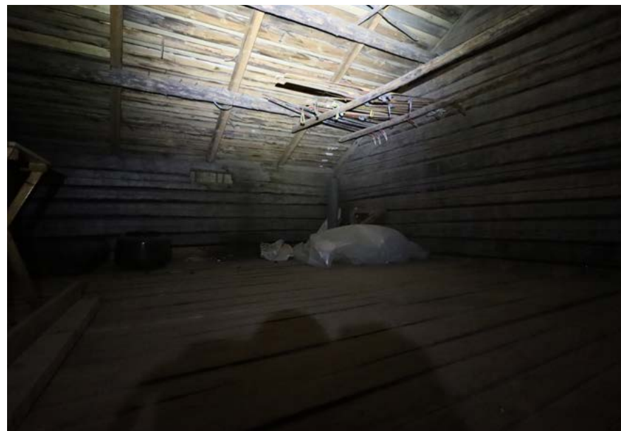
Ullakolla on nähtävissä vesikaton alapinta. Takana olevalla hirsiseinällä on haukkaikkunoiden aukkoja, jotka on peitetty julkisivuverhouksella. Kuva: Riitta Kosonen 9/25, Arkkitehtitoimisto Jorma Teppo Oy.
