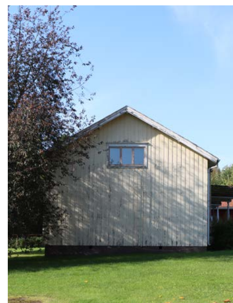
Johtajan asunnon itäpääty. Julkisivulta on ummistettu ensimmäisen kerroksen kaksi ikkunaa, ja ullakon huoneen ikkuna on vaihdettu jälleerakennuskaudelle tyypilliseen kolmiosaiseen ikkunaan. Kuva: Riitta Kosonen 9/2025, Arkkitehtitoimisto Jorma Teppo Oy.
