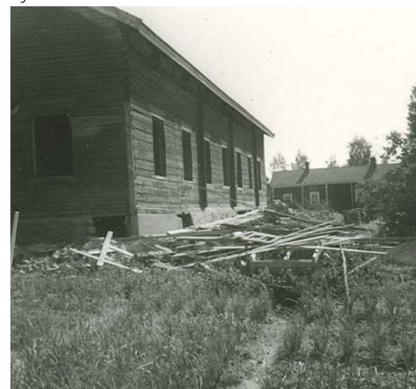
Johtajan asunto kuvattuna 1950-luvulla. Rakennuksen vesikattomateriaali on jo vaihdettu tiilikatteeseen ja korkean luonnonkiviperustuksen pinta on rapattu. Kuva: Siikajoen luonnonvarakeskus.
