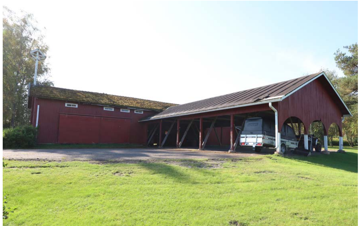
Katoksessa oleva kaariaihe on säilynyt päätyseinällä. Julkisivussa olevat korkeat liukuovet ovat myöhempää kerrostumaa, mutta niiden yläpuoliset haukkaikkunat ovat todennäköisesti alkuperäiset. Kuva: Riitta Kosonen 9/25, Arkkitehtitoimisto Jorma Teppo Oy.
