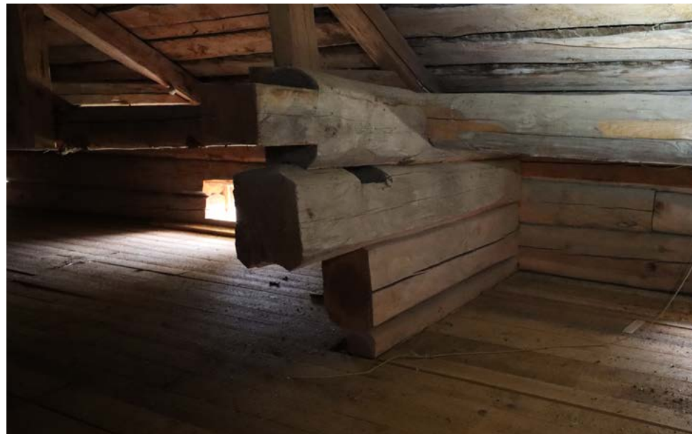
Ullakon hirsirakenteissa olevia vanhoja hirsisalvoksia, joista voidaan päätellä rakennuksen hirsien olevan kierrätys-hirsiiä. Kuva: Riitta Kosonen 9/25, Arkkitehtitoimisto Jorma Teppo Oy.
