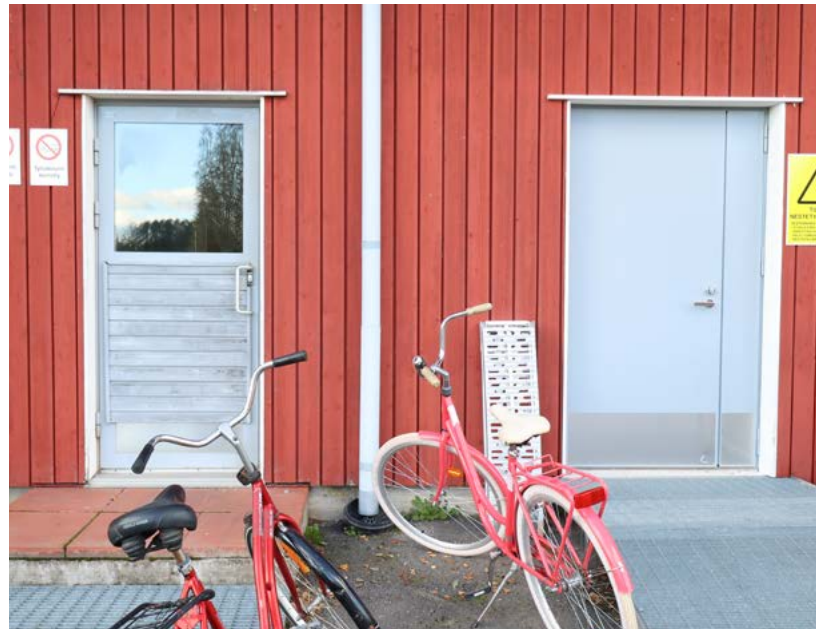
Työhalliin johtava vaakapaneloitu ja lasiaukkoinen ulko-ovi ovat rakentamisaikaiset. Kuva: Riitta Kosonen 9/25, Arkkitehtitoimisto Jorma Teppo Oy.
