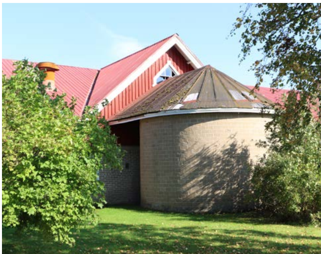
Ylhäällä: eteläjulkisivulle 1960-luvulla rakennettu rehusäiliö on rakennusaikaisessa asussaan.
