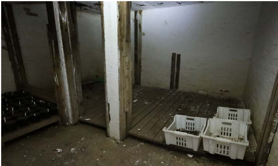
Sisätilojen lattiapinnat on osin peitetty puurakenteisilla lavoilla, ja osin lattia on betonipintainen. Kuva: Riitta Kosonen 9/25, Arkkitehtitoimisto Jorma Teppo Oy.
