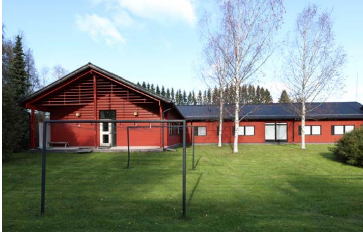
Toimistorakennuksen eteläjulkisivu ja laajennusosan etelöpääty. Kuva: Riitta Kosonen 9/25, Arkkitehtitoimisto Jorma Teppo Oy.
