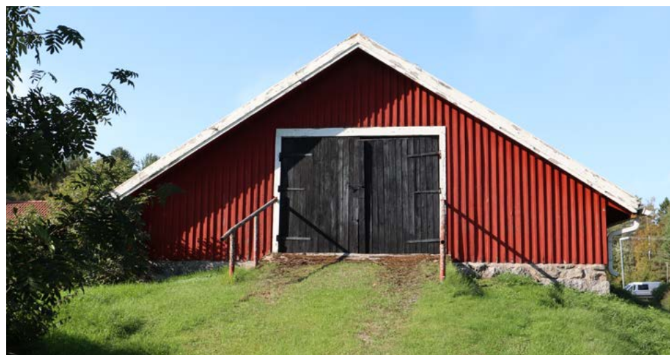
Rakennuksen itäpääty ja ylisille johtava maaluiska. Kuva: Riitta Kosonen 9/25, Arkkitehtitoimisto Jorma Teppo Oy.
