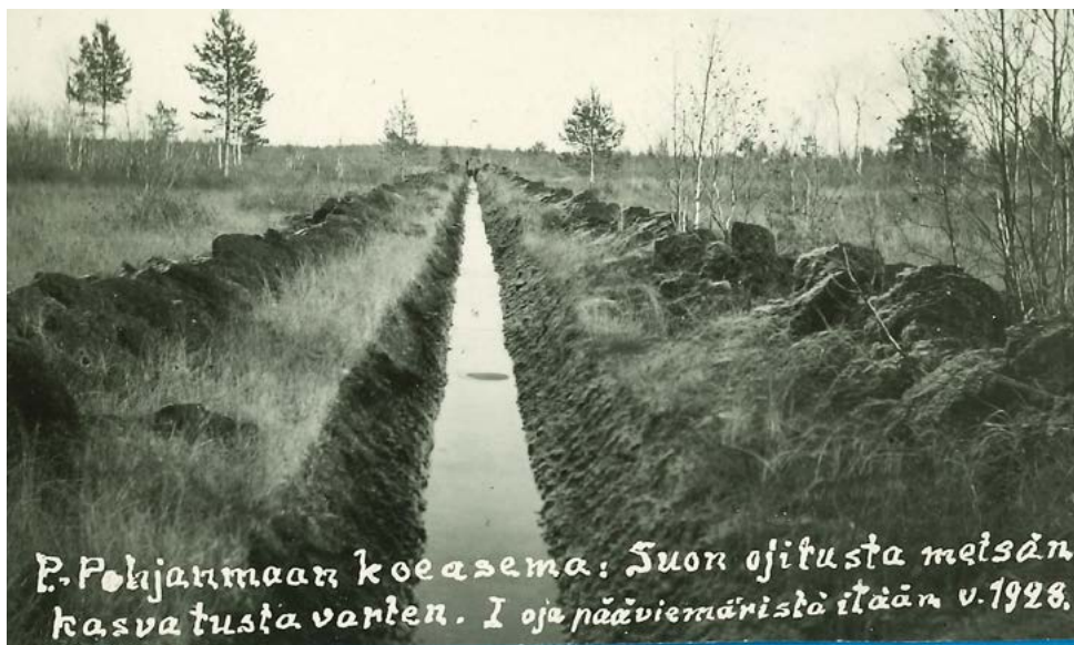
Pohjois-Pohjanmaan koeasemalla ojitettiin peltoja ja soita. Vuonna 1928 otetussa valokuvassa suota ojitetaan metsän kasvatusta varten. Kuva: Siikajoen luonnonvarakeskus.
