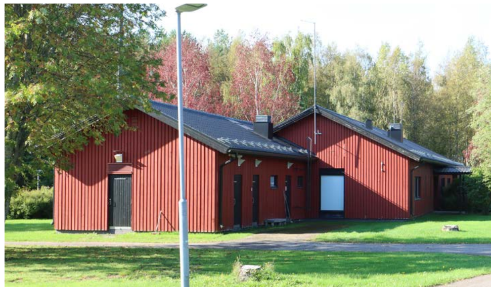
Alkuperäisen toimistorakennuksen itä- ja pohjoissivu ovat lähes alkuperäisessä asussaan. Rakennuksen katemateriaali on vaihdettu mineriittikatteesta peltikatteeseen. Kuva: Riitta Kosonen 9/25, Arkkitehtitoimisto Jorma Teppo Oy.
