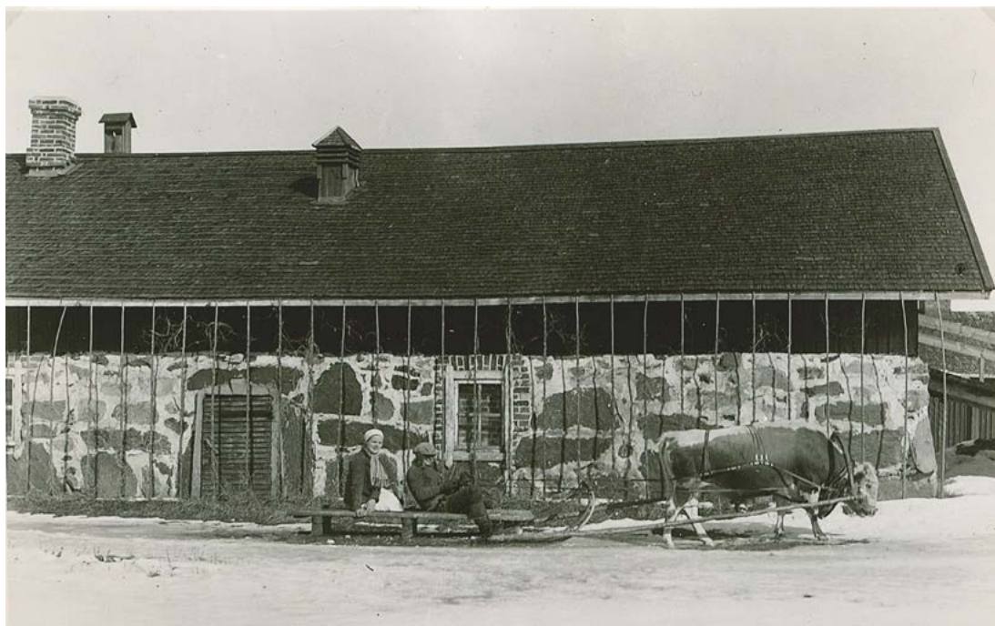
Kivinavetta kuvattuna vuonna 1938. Julkisivulla erottuu edelleen vanha ikkuna, joka on muurattu sisäpuolelta umpeen. Rakennuksen katolle on lisätty tiilipiippu ja tuuletushormi, sekä päätyyn puurakenteinen luiska. Tiilipiipusta päätellen ylisten päähän on tässä vaiheessa rakennettu lämmitetty huone. Kuva: Siikajoen luonnonvarakeskus.
