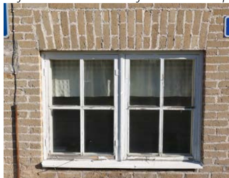
Navetan 1950-luvun ikkunoiden yläpuolella on venäläinen tiiliholvaus. Osa navetan ikkunoista on peitetty polyuretaanilevyillä.
