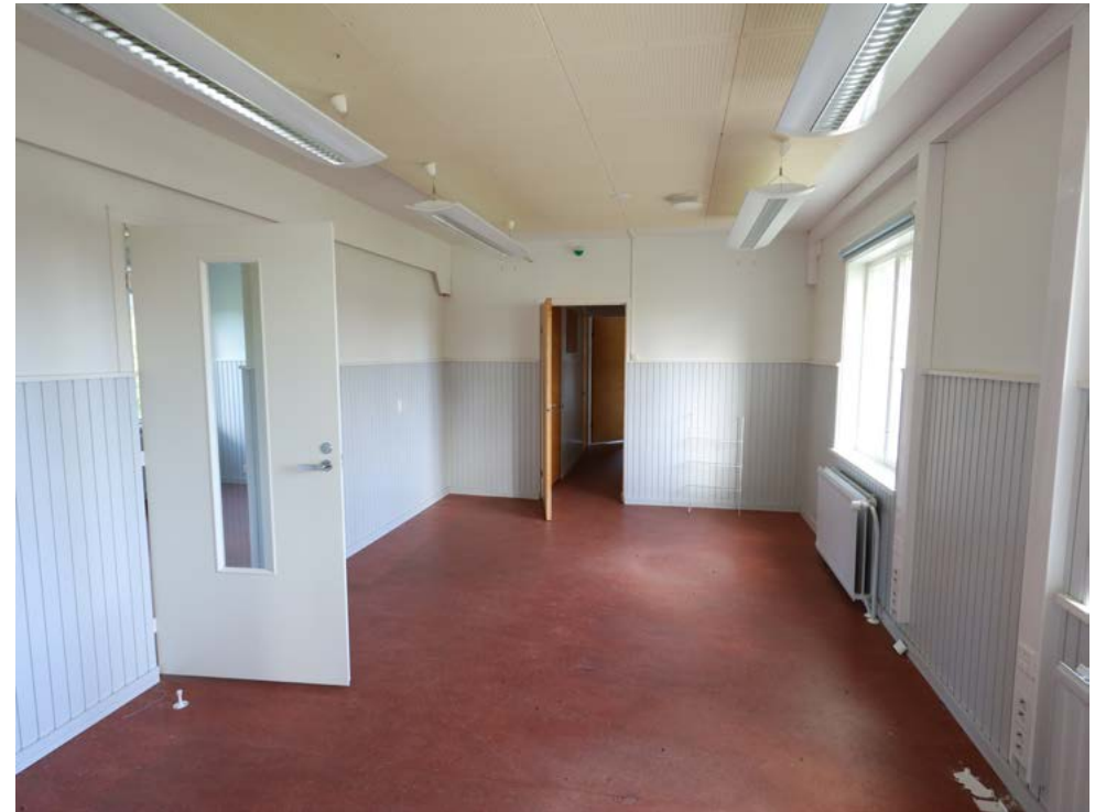
Rakennuksen sisätilat muodostuvat pääasiassa toimistohuoneista, jotka yhdistyvät toisiinsa uusien väliseinäaukotusten kautta. Sisätiloissa ei ole jäljellä sen alkuperäisiä piirteitä ja tilajärjestystä on muutettu useaan otteeseen. Kuva: Riitta Kosonen 9/25, Arkkitehtitoimisto Jorma Teppo Oy.
