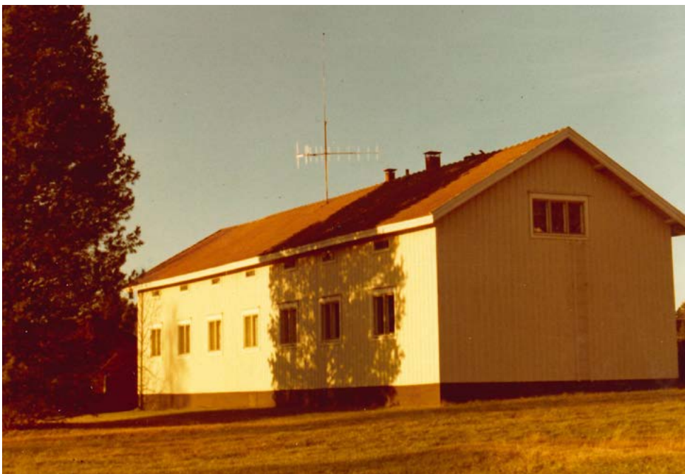
1970-luvulla otettu valokuva johtajan asuntolan itäpäädyistä. Vuoden 1954 julkisivupiirustuksista poiketen vain päädyn ullakkohuoneen ikkuna uusittiin ja sen alapuolella olleet ikkuna-aukot ummistettiin. Kuva: Siikajoen luonnonvarakeskus.
