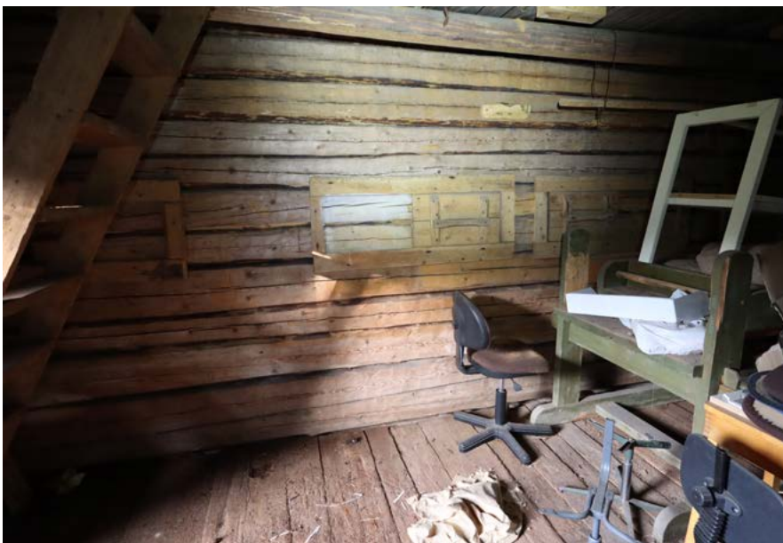
Huoneiden välisessä hirsiseinässä olevia lykkyyluukkuja. Kuva: Riitta Kosonen 9/25, Arkkitehtitoimisto Jorma Teppo Oy.
