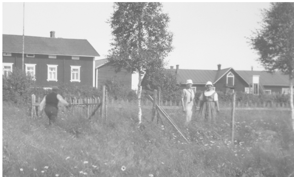
Ala-Greuksen päärakennus ja Yli-Greuksen navetta kuvattuna 1930-luvulla. Kuvassa oikealla olevan navetan katemateriaali on vaihdettu oletettavasti kolmiorimahuopakatteeseen. Ylisille johtavan oven yläpuolinen ja oletettavasti alkuperäisen ikkuna on säilynyt julkisivussa. Kuva: O. Anttisen kokoelmat.
