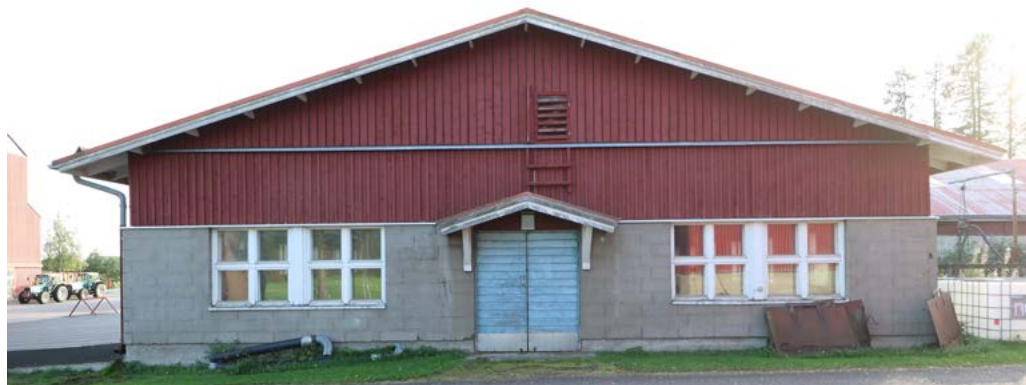
Navettalaajennuksen päädyn kaksiosaiset ruutuikkunat ja puurakenteinen sisöönköyntiovi ovat laajennuksen rakentamisajankohdalle alkuperäiset.
