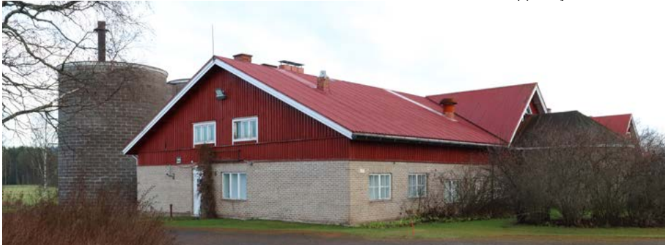
Länsijulkisivun ikkunat ovat jälleenrakennuskauden kerrostumaa. Kuva: Riitta Kosonen 9/25, Arkkitehtitoimisto Jorma Teppo Oy.
