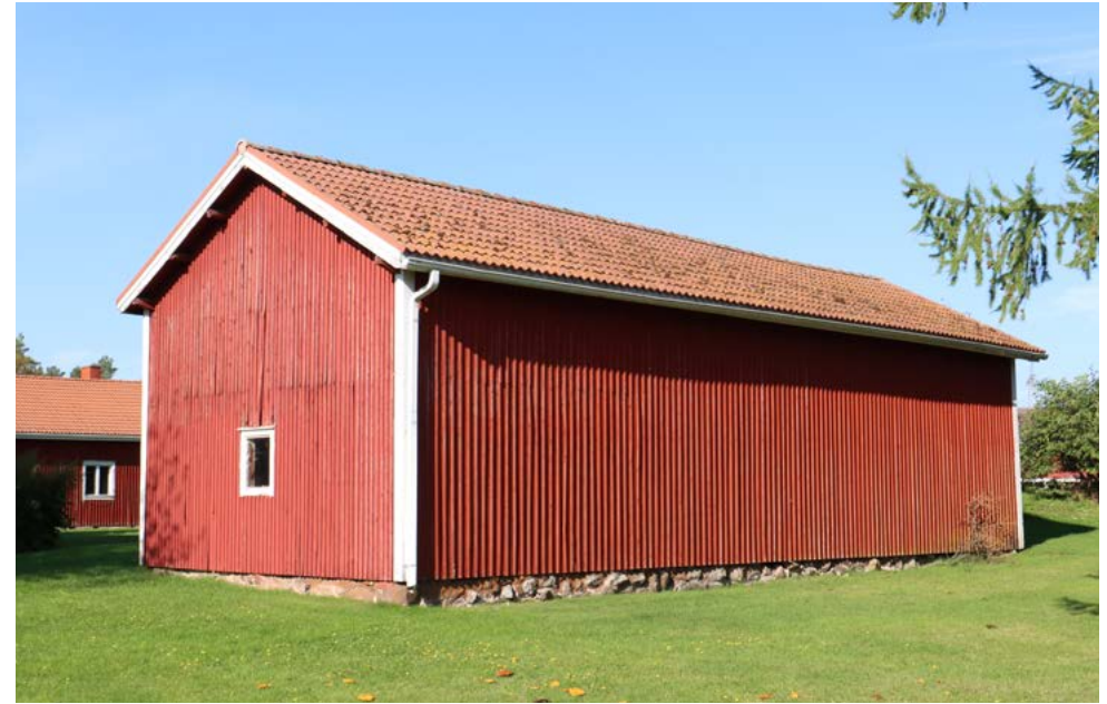
Aitan eteläpääty ja itäjulkisivu. Rakennuksen päädyssä oleva ikkuna on muutettu ruutuikkunasta yksiruutuiseksi. Kuva: Riitta Kosonen 9/25, Arkkitehtitoimisto Jorma Teppo Oy.
