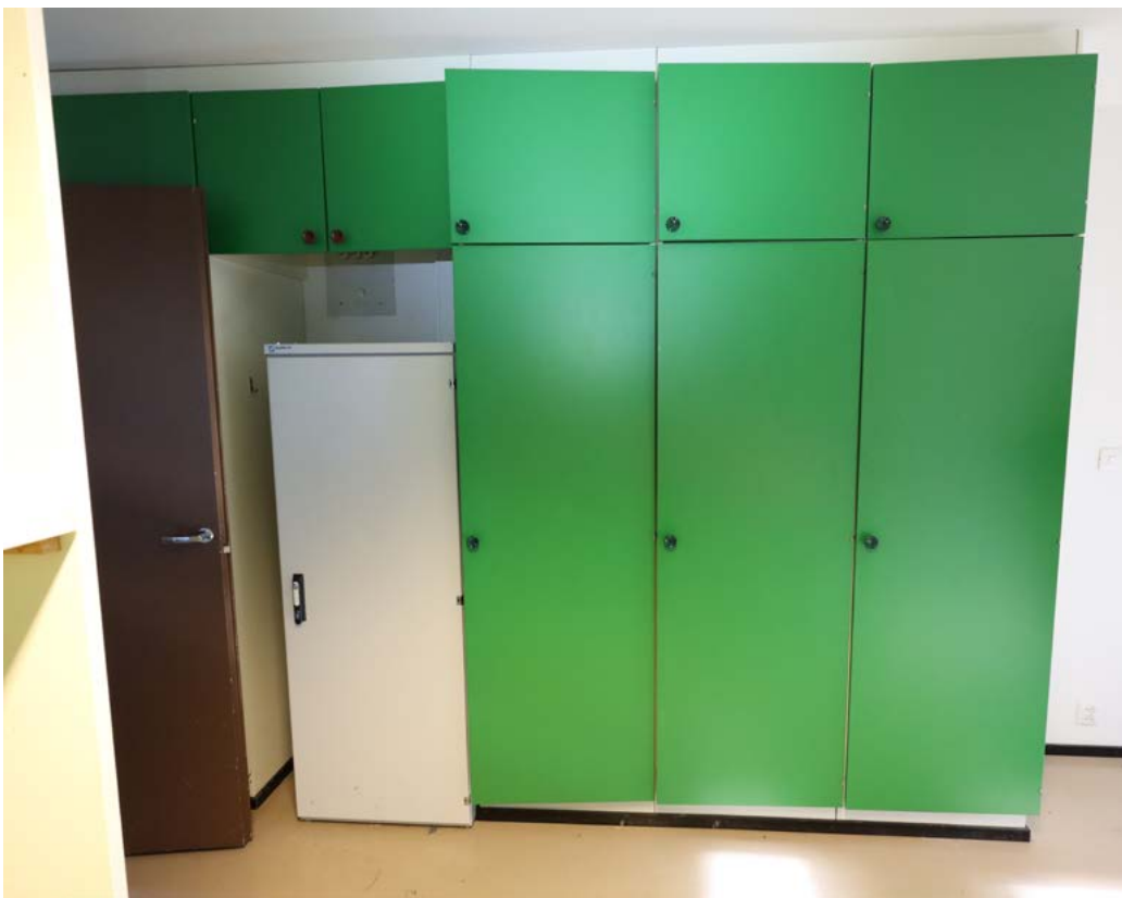
Arkkitehtitoimisto Laatio Oy:n laatiman väriyysuunnitelman mukaisesti asuinrivitalon kiintokalusteiden ovet toteutettiin vihreinä ja väliovet tummanruskeina. Samoja vihreän ja ruskean sävyjä on nähtävissä myös toimistorakennuksen ja talouspesulan väliovissa. Kuva: Riitta Kosonen 9/25, Arkkitehtitoimisto Jorma Teppo Oy.
