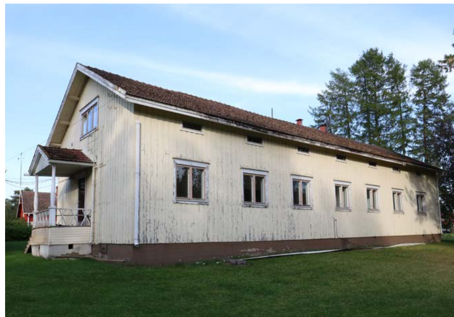
Johtajan asuntolan eteläjulkisivu. Julkisivulla olevien ikkunoiden rytmi ja määrä ovat alkuperäisen kaltaiset, mutta kaikki julkisivuilla olevat ikkunat vaihdettiin vuoden 1956 muutoksessa. Kuva: Riitta Kosonen 9/2025, Arkkitehtitoimisto Jorma Teppo Oy.
