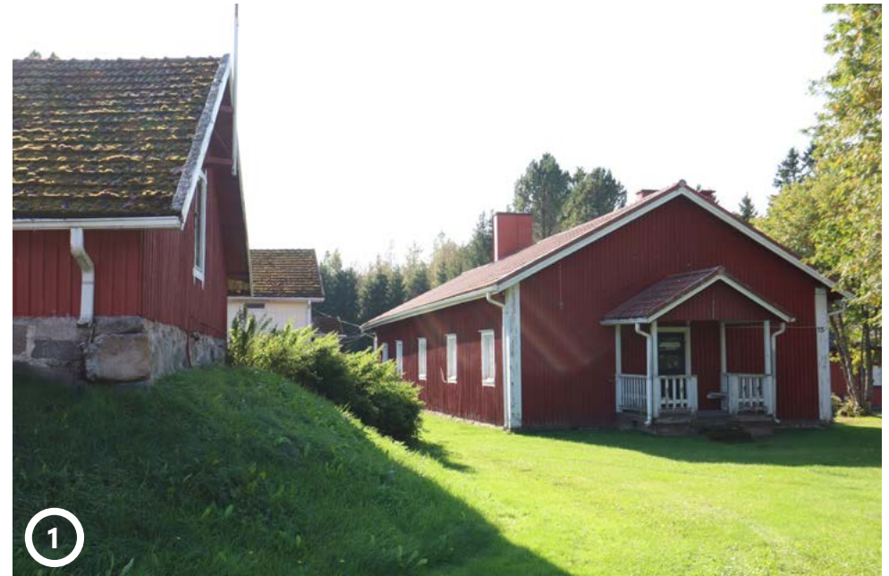
Ala-Greuksen tilan vanhan kavinavetan kulma ja pirttirakennuksen pääty. Rakennuksiin on tehty useita julkisivujen ja sisätilojen muutostöitä. Kuva: Riitta Kosonen 9/25, Arkkitehtitoimisto Jorma Teppo Oy
