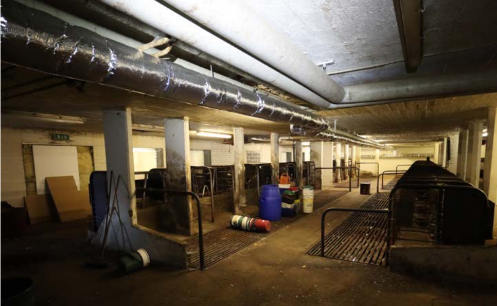
Yleiskuva vanhan navetan sisätiloista, jossa teräsrakenteiset parret sijoittuvat kantavien betonipilareiden väliin. Lattialla olevat ritiläkannet peittävät lietelantakourut. Kuva: Riitta Kosonen 9/25, Arkkitehtitoimisto Jorma Teppo Oy.
