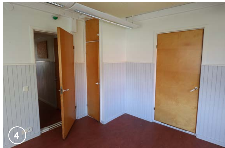
1: viilupintainen 1970-luvun väliovi. 2: 1980-luvun lasiaukollinen koivuvaneriovi. 3: toimistokäytön aikainen lasiaukollinen väliovi. 4: 1970-luvun muutoksissa asennetut väliovet sekä nurkassa oleva komero. Kuvat: Riitta Kosonen 9/25, Arkkitehtitoimisto Jorma Teppo Oy.
