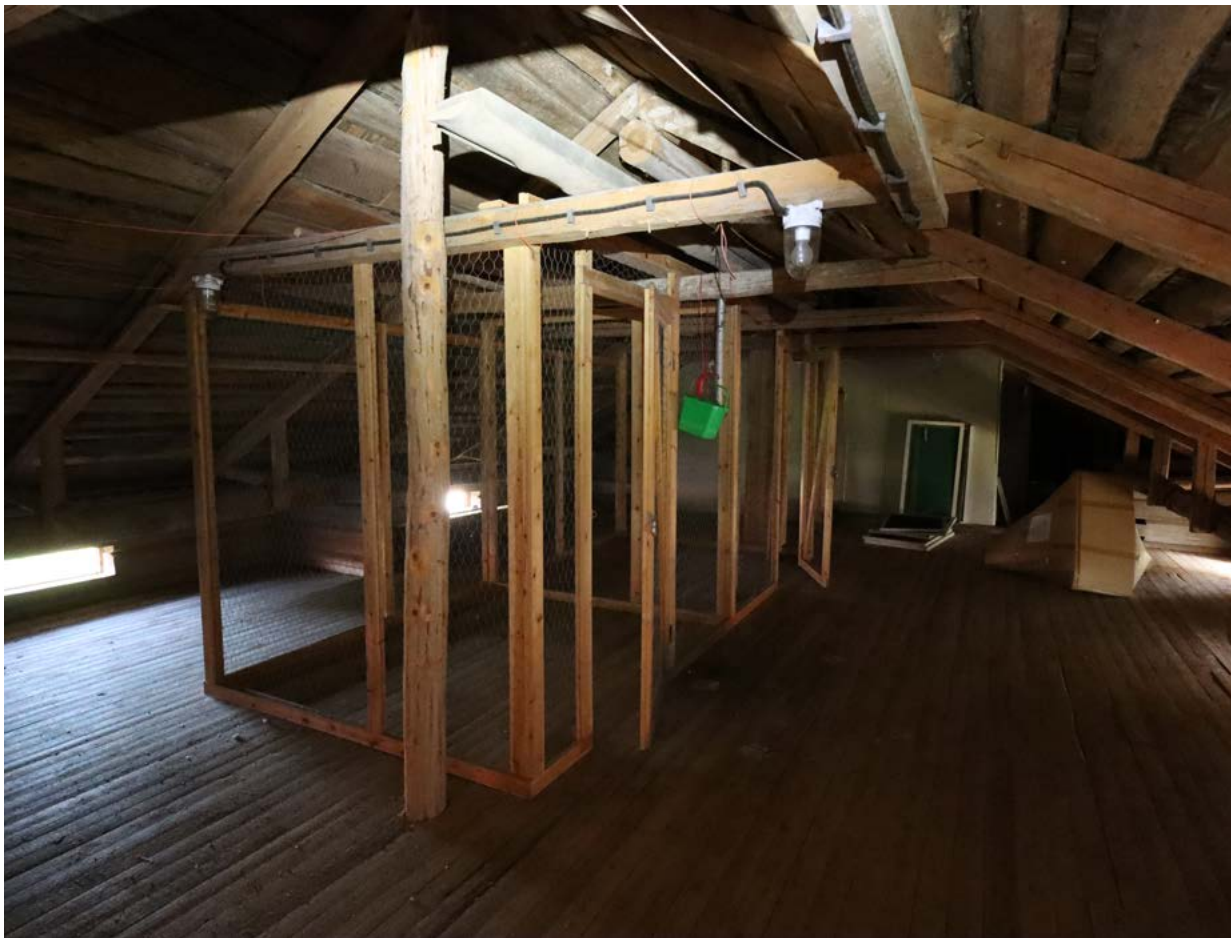
Kylmä ullakko, jonne on kulku molempien asuntojen ullakkohuoneista. Tilaan on rakennettu rivi puurakenteisia häkkivarastoja. Kuva: Riitta Kosonen 9/2025, Arkkitehtitoimisto Jorma Teppo Oy.
