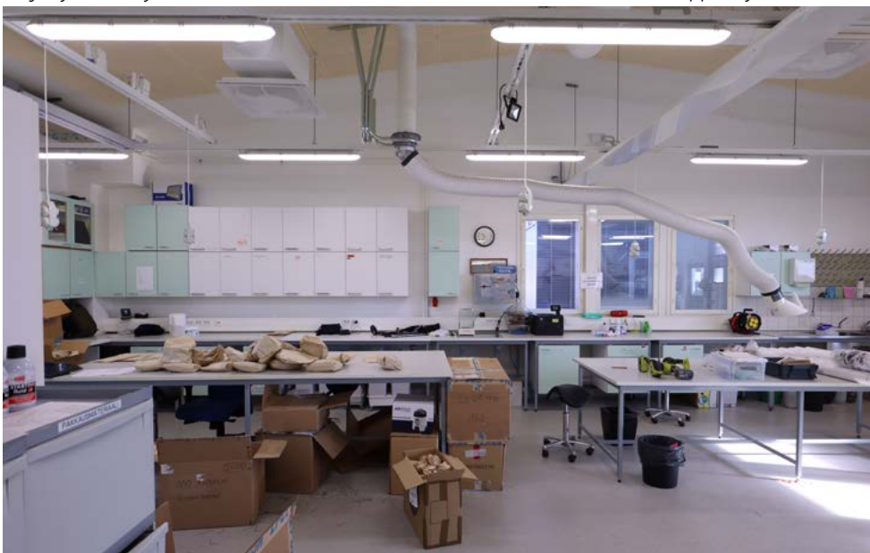
Työhallin alkuperäinen muoto ja käyttötarkoitus ovat säilyneet, ja tilaan on lisätty vasemmalla olevat valkoiset yläkaapit ummistetun ikkunan paikalle. Kuva: Riitta Kosonen 9/25, Arkkitehtitoimisto Jorma Teppo Oy.
