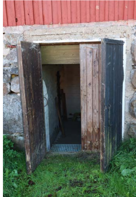
Kivinavetan pohjoisjulkisivun puurakenteinen sisäänkäyntiovi, ja jonka takana on yksilehtinen puuovi. Kuva: Riitta Kosonen 9/25, Arkkitehtitoimisto Jorma Teppo Oy.
