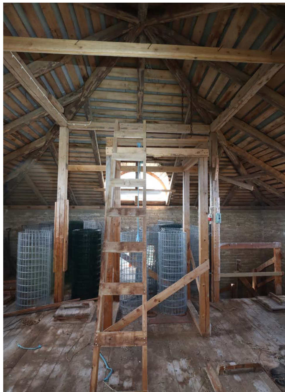
133 Ylimmällä tasolla oleva viljasäkkien nostoon käytetyn nostolaitteen tukirakenteet. Kuva: Riitta Kosonen 9/25, Arkkitehtitoimisto Jorma Teppo Oy.
