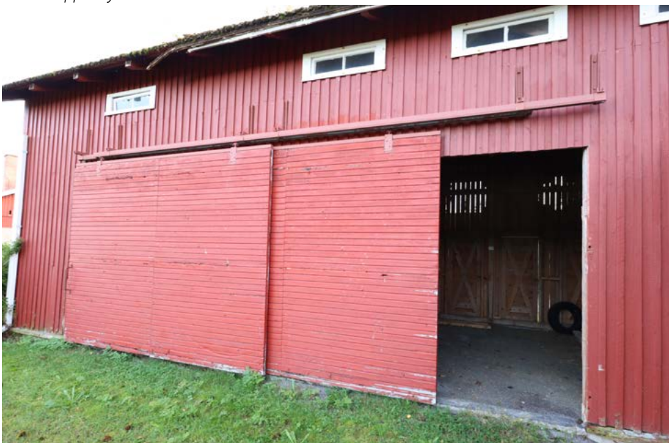
Autohallin keskiosassa oleva puurakenteinen pariovi. Kuva: Riitta Kosonen 9/25, Arkkitehtitoimisto Jorma Teppo Oy.
