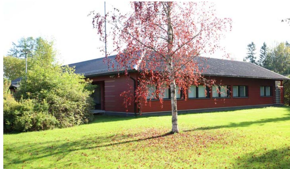
Toimistolaajennuksen länsijulkisivu on säilynyt rakentamisaikaisessa asussaan.
