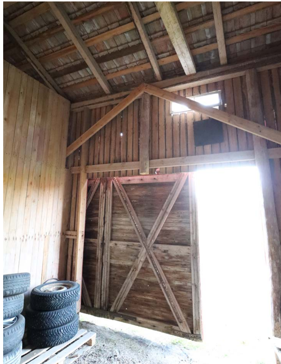
Entisen käymälän kohdalla olevat puurakenteiset liukuovet ovat myöhemmin lisätyt. Kuva: Riitta Kosonen 9/25, Arkkitehtitoimisto Jorma Teppo Oy.
