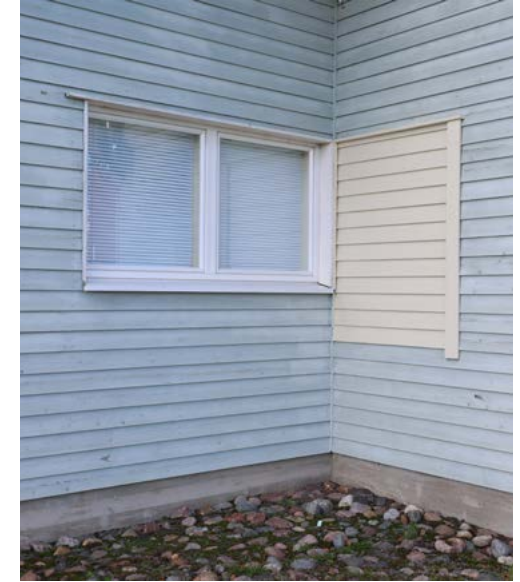
Luoteisjulkisivulla olevan eteisen ummistettu ikkuna. Kuva: Riitta Kosonen 9/25, Arkkitehtitoimisto Jorma Teppo Oy.
