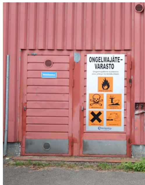
Teknisiin tiloihin johtavat teräsovet. Kuva: Riitta Kosonen 9/25, Arkkitehtitoimisto Jorma Teppo Oy.
