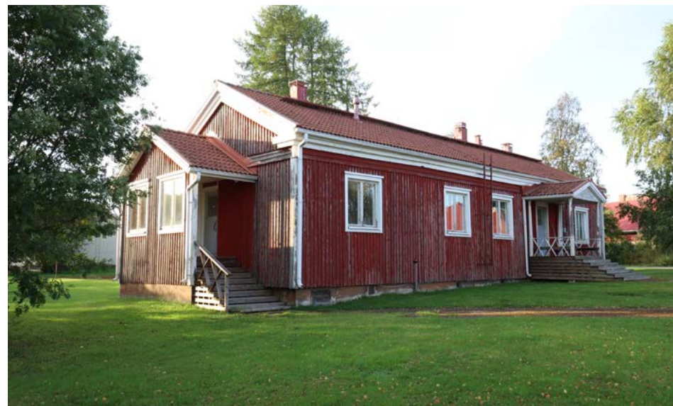
Työpaikkaruokalan itäsisä ja eteläpääty. Kuva: Riitta Kosonen 9/25, Arkkitehtitoimisto Jorma Teppo Oy.
