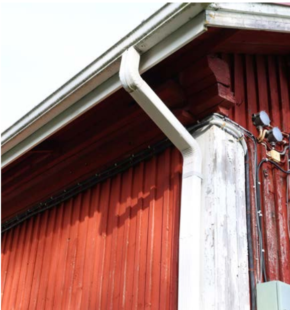
Räystäällä näkyvä hirsirungon yläosa, jonka ylimpiä hirsitä on muotoiltu. Kuva: Riitta Kosonen 9/25, Arkkitehtitoimisto Jorma Teppo Oy.
