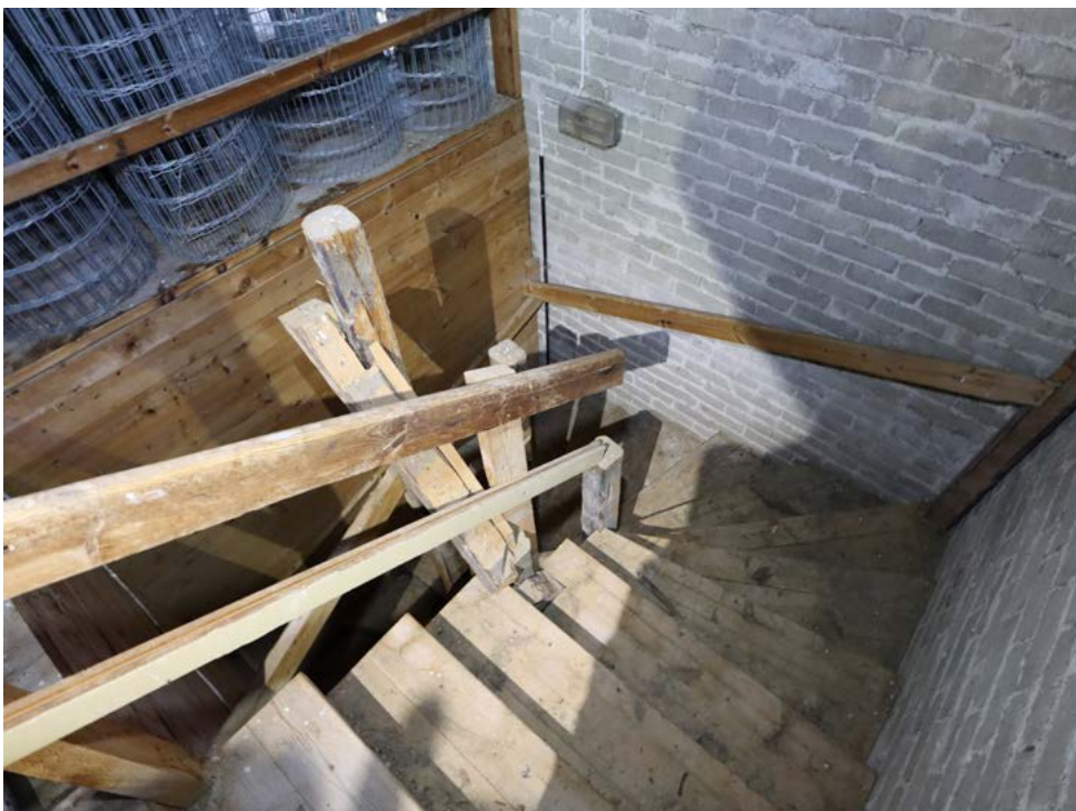
Ensimmäisestä kerroksesta ylimmälle tasolle johtavat puurakenteiset kierreportaat. Kuva: Riitta Kosonen 9/25, Arkkitehtitoimisto Jorma Teppo Oy.
