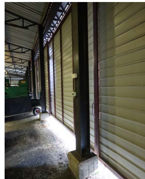
Rakennuksen teräsrunko tukeutuu betonipilareihin. Kuva: Riitta Kosonen 9/25, Arkkitehtitoimisto Jorma Teppo Oy.
