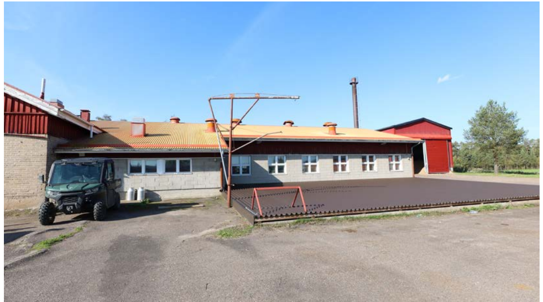
1980-luvun kevytsorabetoniharkkoseinäinen navettalaajennus on materiaaleiltaan ja rakenteiltaan tyypillinen 1980-luvun alun navettarakennus. Kuva: Riitta Kosonen 9/25, Arkkitehtitoimisto Jorma Teppo Oy.
