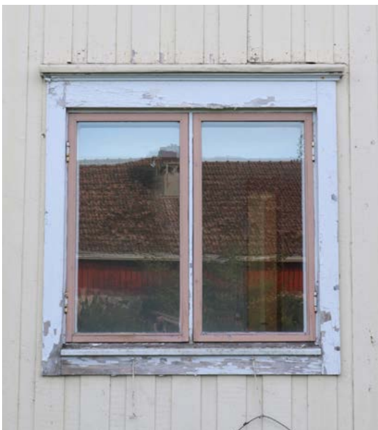
1956 muutoksessa uusitut ikkunat. Ikkunoiden muoto on alkuperäistä neliömäisempi ja muutoksessa ikkunoiden koristeelliset listoitukset pelkistettiin. Kuva: Riitta Kosonen 9/2025, Arkkitehtitoimisto Jorma Teppo Oy.
