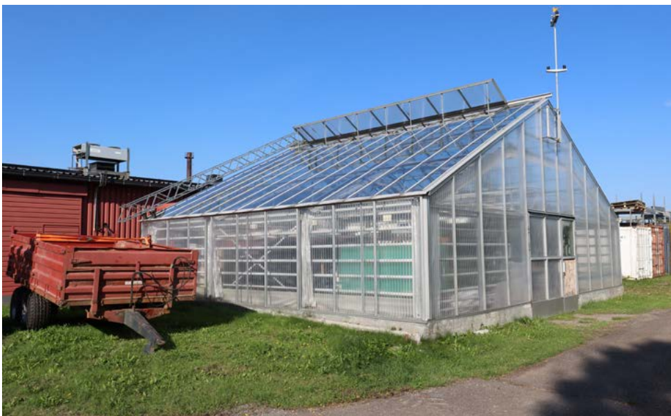
Kasvihuoneen seinien lasipinnat on vaihdettu kennolevyyn, mikä on muuttanut rakennusosan läpinäkyvää ilmettä. Kuva: Riitta Kosonen 9/25, Arkkitehtitoimisto Jorma Teppo Oy.
