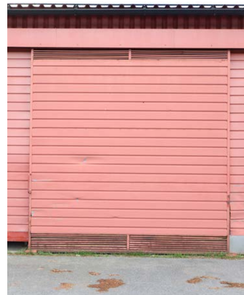
Kalustosuojan alkuperäiset luukuovet. Kuva: Riitta Kosonen 9/25, Arkkitehtitoimisto Jorma Teppo Oy.
