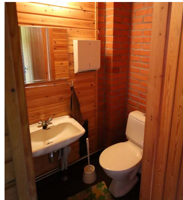
Wc-tilan takaseinällä oleva muurattu seinä liittyy saunan seinään. Kuva: Riitta Kosonen 9/25, Arkkitehtitoimisto Jorma Teppo Oy.
