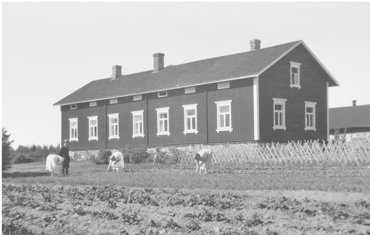
Johtajan asuntola kuvattuna vanhan keittiöpuutarhan suunnalta 1930-luvulla. Rakennuksen julkisivut ovat kuvassa oletettavasti alkuperäisessä asussaan, rakennuksessa on pärekatto ja lähellä sen harjaa kohoavat kolme alkuperäistä tiilipiippua. Kuva: O. Anttisen kokoelmat.
