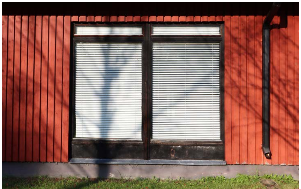
Neuvottelutilan alkuperäiset korkeat puuikkunat, joiden alaosassa on 1970-luvulle tyypilliset vanerikentät. Kuva: Riitta Kosonen 9/25, Arkkitehtitoimisto Jorma Teppo Oy.
