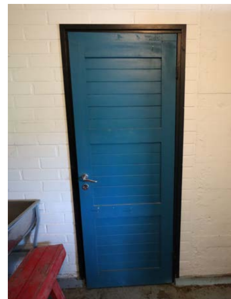
Karjakeittiön 1970-luvun lautarakenteinen peiliovi.
