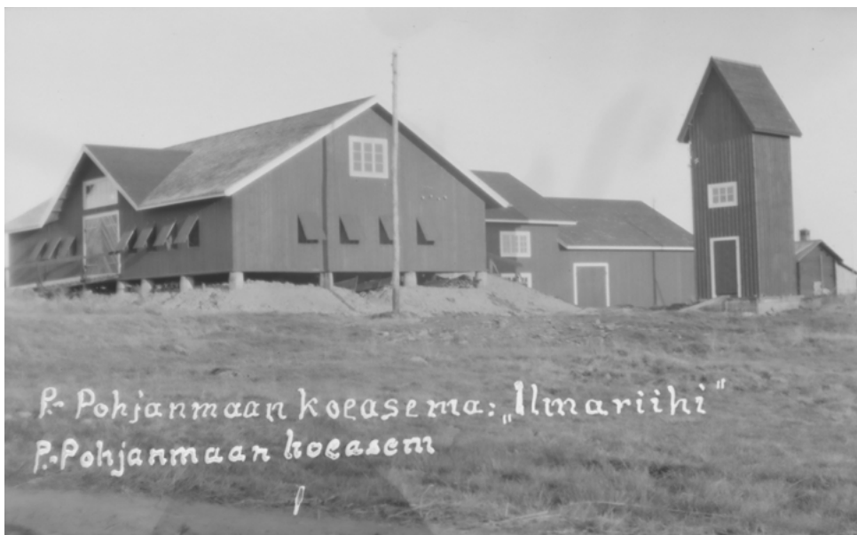
Ensimmäinen koeasematoimintaa palvelemaan rakennettu rakennus "ilmari". Rakennuksen oikealla puolella on muuntamo. Kuva arviolta vuodelta 1928-1929. Kuva: O. Anttisen kokoelmat.
