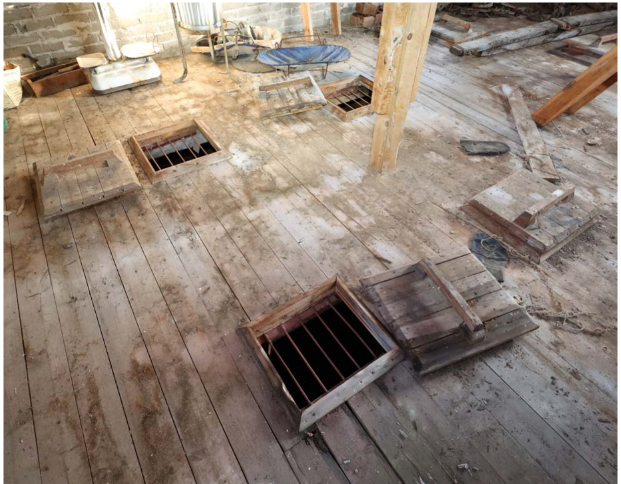
Ylimmän kerrostason lattialla olevia silojen täyttöaukkoja. Kuva: Riitta Kosonen 9/25, Arkkitehtitoimisto Jorma Teppo Oy.
