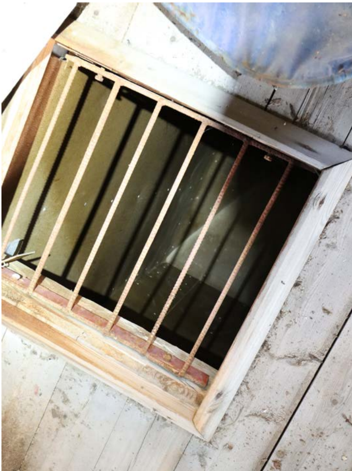
Siilon ritiläpintainen täyttöaukko. Kuva: Riitta Kosonen 9/25, Arkkitehtitoimisto Jorma Teppo Oy.
