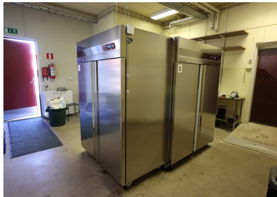
Työskentelytilaan on lisätty kylmiöitä. Oikealla on idätystilaan johtava ovi, ja sen edustalla oleva luiska. Kuva: Riitta Kosonen 9/25, Arkkitehtitoimisto Jorma Teppo Oy.
