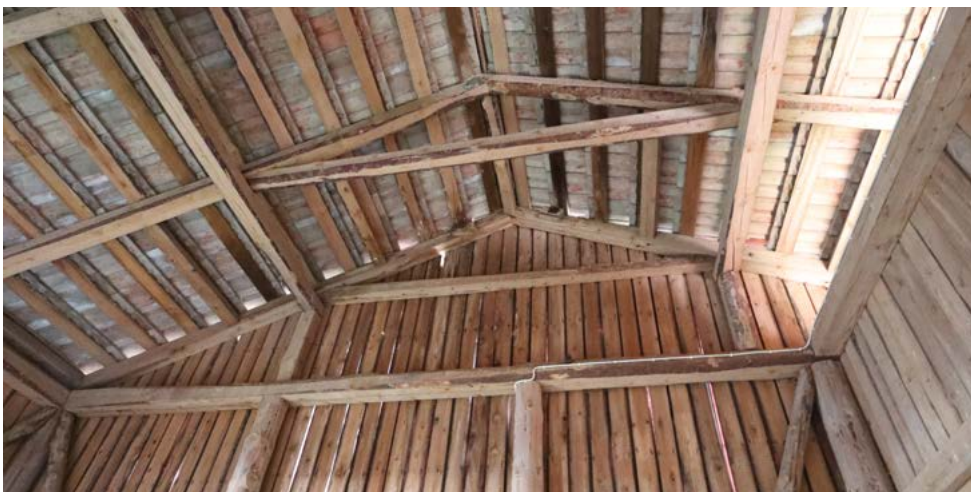
Rakennuksen seinärakenteet ovat alkuperäiset. Kuva: Riitta Kosonen 9/25, Arkkitehtitoimisto Jorma Teppo Oy.
