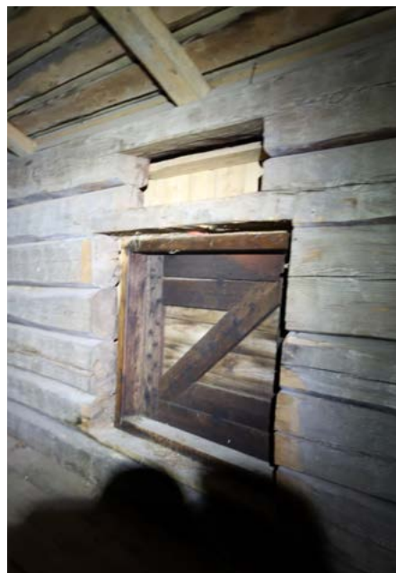
Luukkujen yläpuolella olleiden haukkaikkunoiden aukot ovat edelleen nähtävissä ullakolla. Kuva: Riitta Kosonen 11/25, Arkkitehtitoimisto Jorma Teppo Oy.
