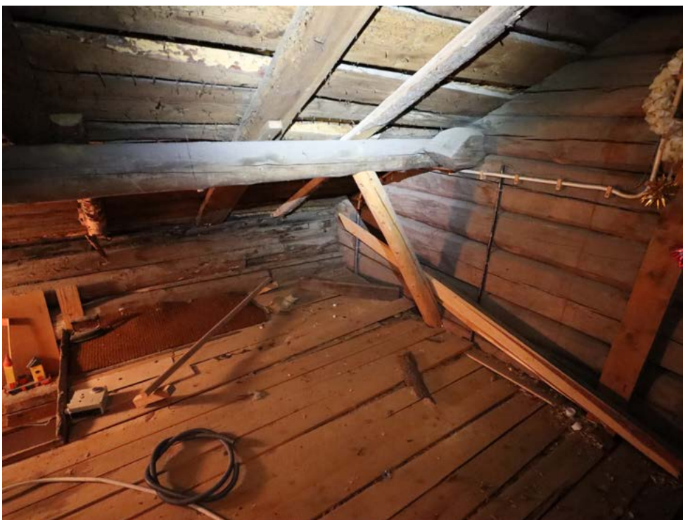
Työpaikkaruokalan ullakolla on nähtävissä rakennuksen hirsirunko ja vesikattorakenteet, joita on kattomateriaalin yhteydessä paikoin vahvistettu. Kuva: Riitta Kosonen 9/25, Arkkitehtitoimisto Jorma Teppo Oy.
