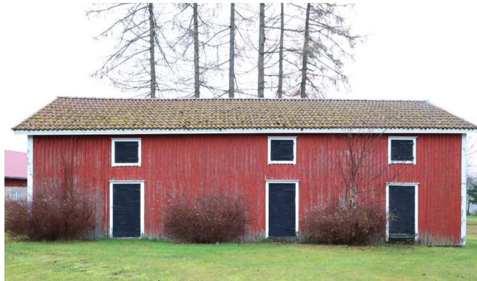
Aittarakennus kuvattuna sisäänkäyntijulkisivun suunnasta. Kuva: Riitta Kosonen 11/25, Arkkitehtitoimisto Jorma Teppo Oy.
