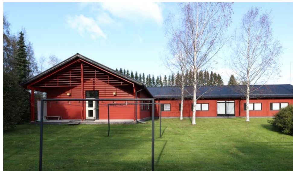
Toimistorakennuksen eteläjulkisivu, jossa laajennusosan pääty on vasemmalla. Rakennuksen muoto on laajennuksen myötä muuttunut, mutta rakennuksesta on erotettavissa sen alkuperäinen hahmo. Kuva: Riitta Kosonen 9/25, Arkkitehtitoimisto Jorma Teppo Oy.
