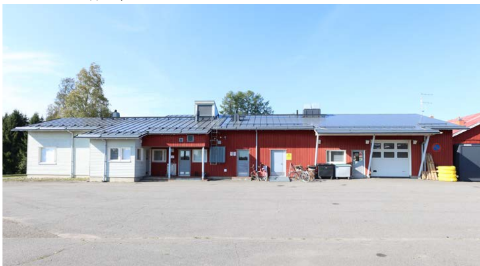
Työhallin muoto on säilynyt alkuperäisen kaltaisena. Luoteissivulle lisätty uusi ulko-ovi on väriykseltään alkuperäisten ovien mukainen. Kuva: Riitta Kosonen 9/25, Arkkitehtitoimisto Jorma Teppo Oy.
