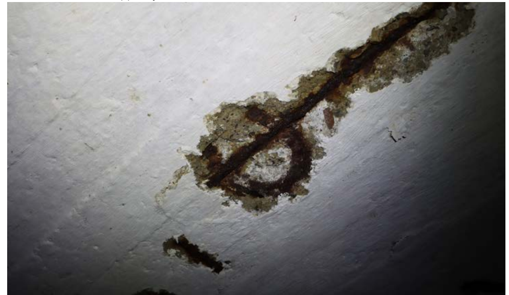
Kellarin katon betonirakenteiden raudoittamisessa on hyödynnetty muun muassa hevosenkenkiä. Kuva: Riitta Kosonen 9/25, Arkkitehtitoimisto Jorma Teppo Oy.
