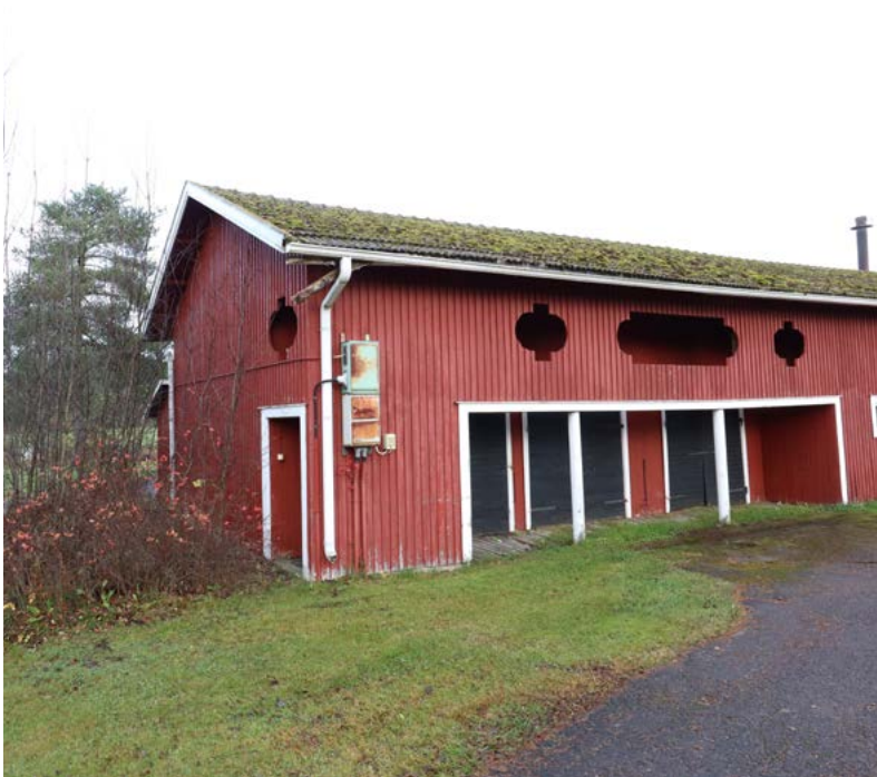
Rakennuksen länsipäädystä on purettu siinä ollut katos ja eteläseinälle on lisätty muuntaja. Kuva: Riitta Kosonen 11/25, Arkkitehtitoimisto Jorma Teppo Oy.
