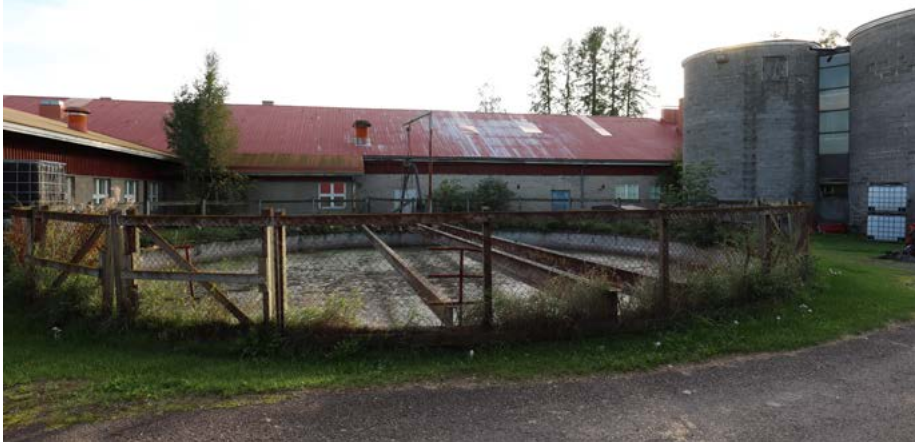
Navetan taakse rakennettu lietelantasäiliö ja oikealla erottuvat tornisiilot. Kuva: Riitta Kosonen 9/25, Arkkitehtitoimisto Jorma Teppo Oy.
