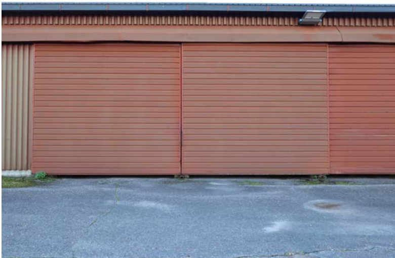
Kalustovajan alkuperäiset, teräsrakenteiset liukuovet. Kuva: Riitta Kosonen 9/25, Arkkitehtitoimisto Jorma Teppo Oy.
