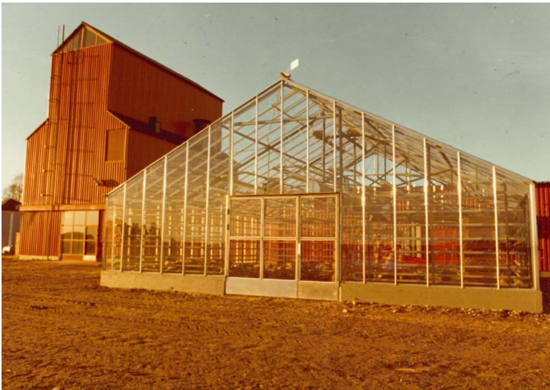
Talousrakennuksen itäisivulle sijoitettiin kasvihuone. Kuva: Siikajoen luonnonvarakeskus.
