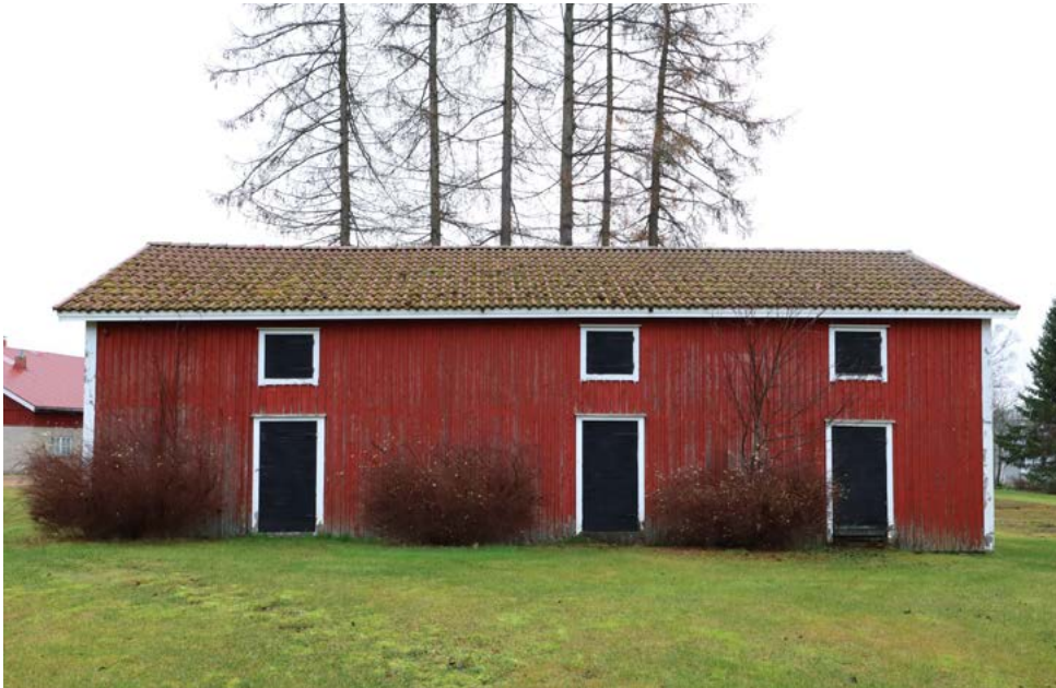
Aitan pihan puoleinen julkisivu. Julkisivun edustalla kasvaa tiheitä pensaita. Kuva: Riitta Kosonen 11/25, Arkkitehtitoimisto Jorma Teppo Oy.
