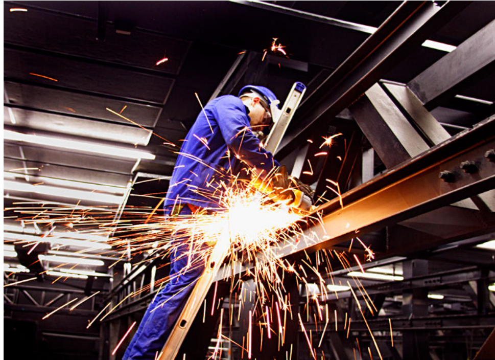
Päänäyttämön peruskorjaustyöt käynnissä näyttämötornissa kesällä 2007. Näyttämötornista purettiin vanhoja teräsrakenteita ja koko yläkoneisto. Uusista hoitosilloista tehtiin aiempaa kapeampia. Kuva: Heikki Tuuli / SKOB.
