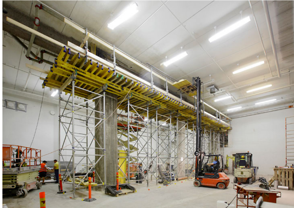
Kahta vanhaa pilaria ja katon betonipalkkia vahvistettiin vuonna 2010, kun kolmas eli keskimmäinen pilari purettiin. Kuva: Heikki Tuuli 2010 / SKOB.
