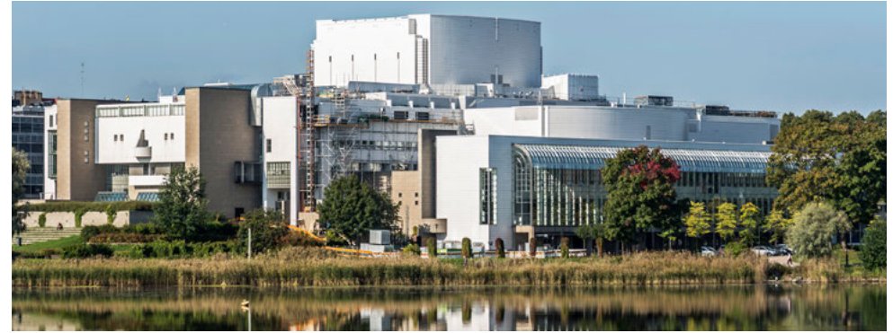
Oopperatalo vuonna 2014. Osassa Töölönlahden puoleista julkisivua ja vesikatolla on rakennustelineitä. Katolla on väliaikaine, siirrettävä ilmanvaihdon konttikone, joka verhoiltiin valkoisella metallisäleiköllä. Kuva: Sakari Kiuru / MV.
