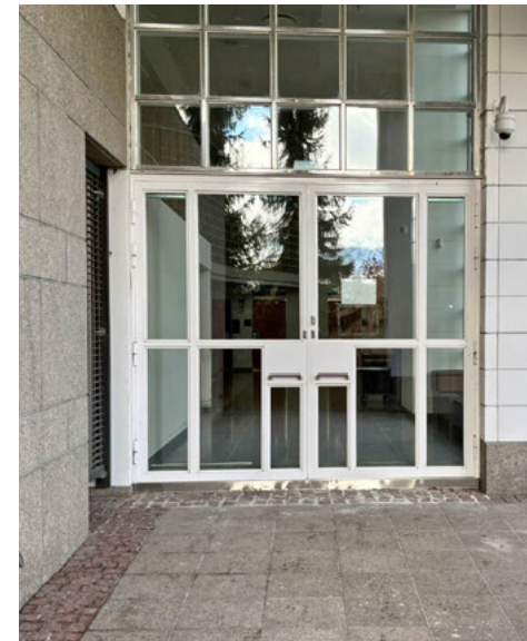
Kaakkoisjulkisivun eli Hesperianpuiston puoleisen Juha-päädyn sisäänkäynnin teräslasirakenteiset ulko-ovet uusittiin vuonna 2023. Uusia ovia voidaan käyttää huoltoreittinä päälämpöissä tarvittaville nostinlaitteille, joiden avulla voidaan esimerkiksi vaihtaa lamppuja. Ovet muistuttavat ulkonäöltään alkuperäisiä.
