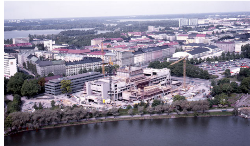
Rakennuksen runko on jo noussut. Kuva: Oy Helifoto Ab, Porvoo / SKOB.
