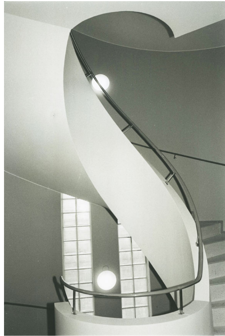
Lounaissivun betonirakenteinen kierreporras. Kuva: Mauritz Hellström 1993 / SKOB.
