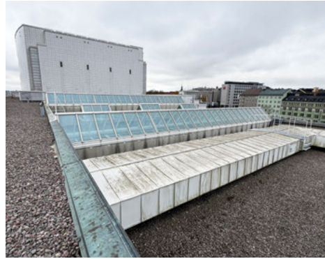
Vesikatolle rakennettiin vuosien 2012–2015 aikana uusia ilmanvaihdon kattokanavia, jotka pellitettiin.
