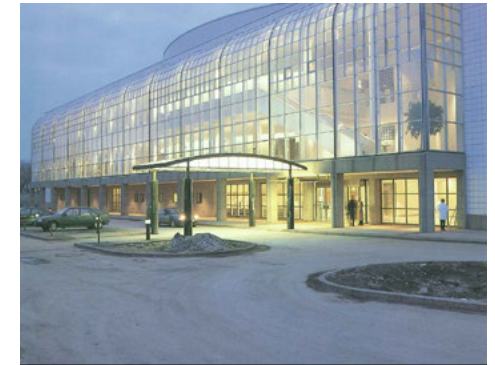
Lähtötilanne, jossa näkyy alkuperäinen katos. Kuva: Arkkitehtitoimisto HKP Oy / HKP.
