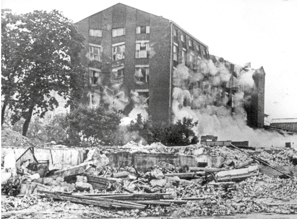
Töölön Sokeritehtaan räjäytys vuonna 1966. Kuva: Lehtikuva Oy / HKM.
