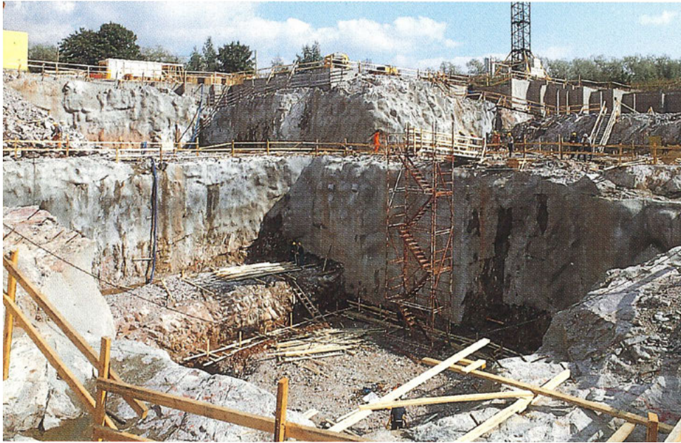
Oopperatalon louhittu monttu. Kuva on teoksesta Kempinen 1993, 120.
