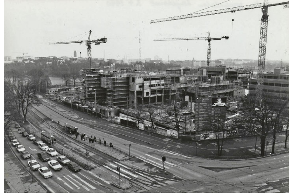
Oopperatalon rakennustyömaa harjannostajaispäivänä 3. huhtikuuta 1990. Kuva: Leo Kosonen / SKOB
