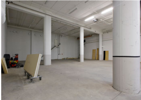
Toisen kellarikerroksen puoleinen pääty ennen muutostöitä toukokuussa 2010. Tilaan rakennettiin oopperan ja baletin käyttöön harjoitussali K2.079, varasto K2.080 sekä uusi toisesta kellarikerroksesta ensimmäiseen kellarikerrokseen johtava suora porras P77. Kuva: Heikki Tuuli 2010 / SKOB.
