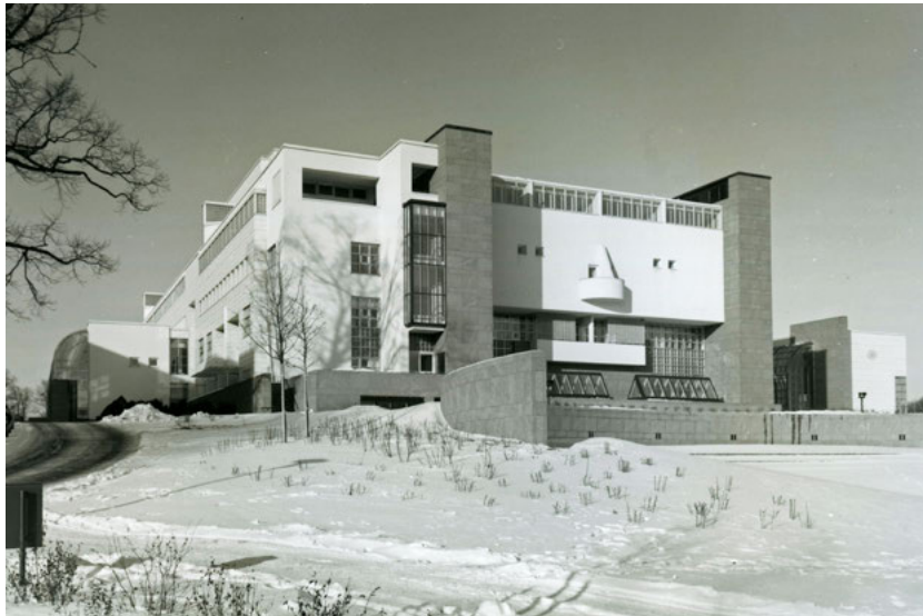
Oopperatalon puiston puoleinen kaakkoispääty ja amfiteatteri.
