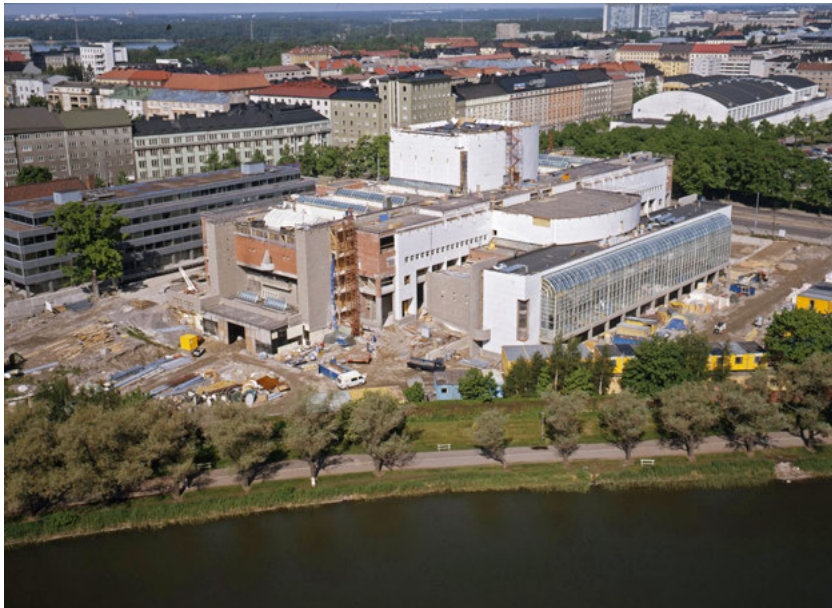
Töölönlahden puoleisen lämpiön lasiseinä on jo asennettu. Kuva: Scan-Foto, Lentokuva-ekspertit, Helsinki / Suomen Ilmakuva / SKOB.
