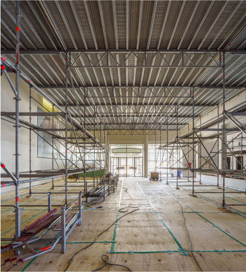
Aula- ja lämpiötiloja kunnostettiin kesällä 2023. Muun muassa valaistusta uusittiin. Kuva on pääsisäänkäynnin eteishallista 2.056.
