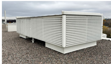
6. kerroksen yläpuolisen vesikaton uudet ilmanvaihtopiiput verhoiltiin metallisäleiköin.
