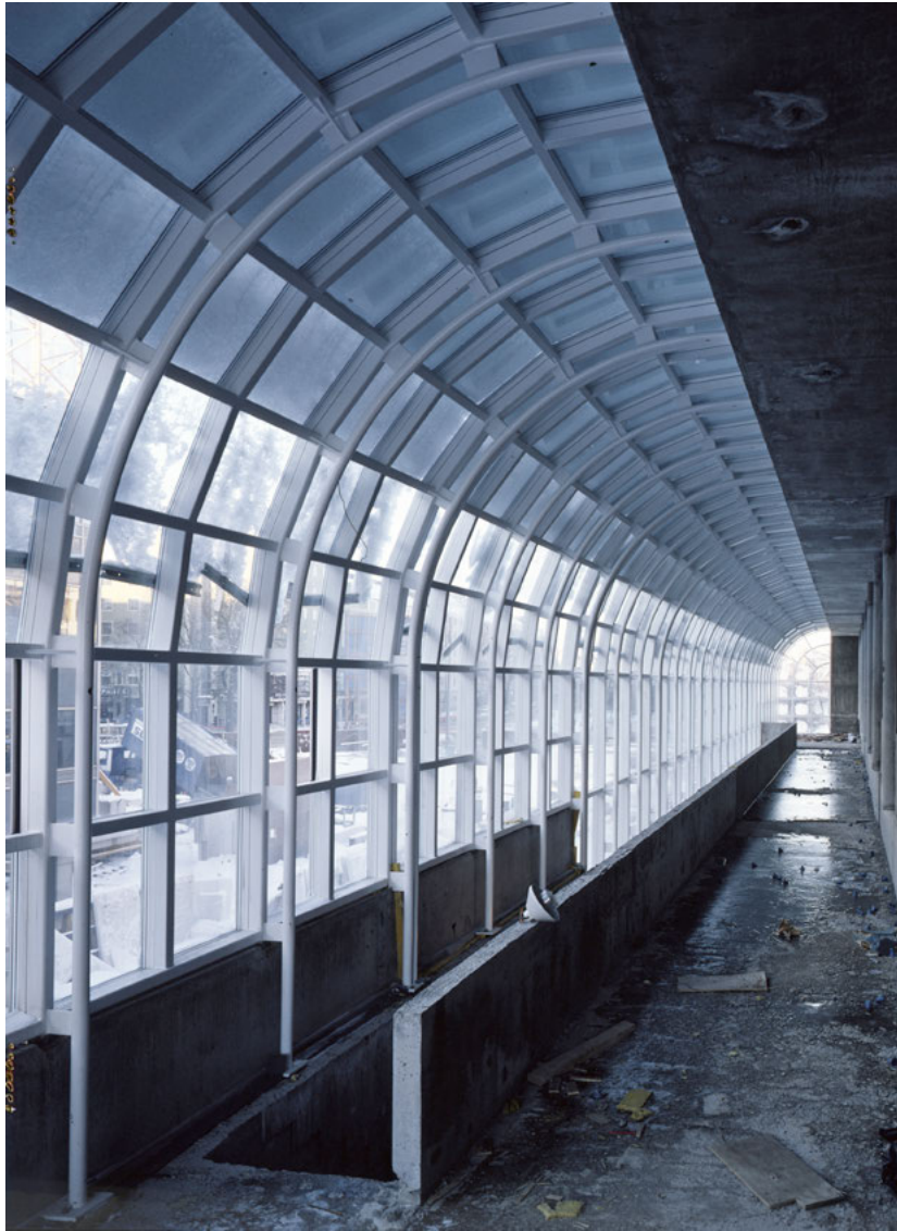
Henkilökunnan ravintolaa rakennetaan. Kuva: Kari Hakli? / SKOB.
