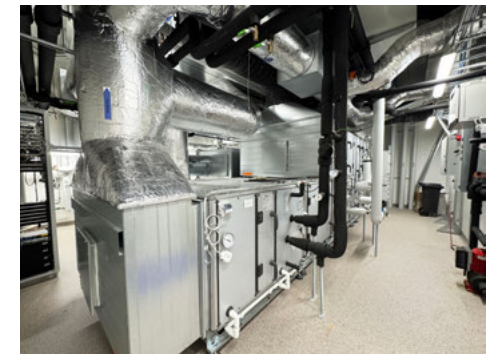
Tanssisali 3:n K1.007.c taakse rakennettiin vuonna 2021 baletin uusia tiloja palveleva uusi ilmanvaihtokonehuone K1.007e.
