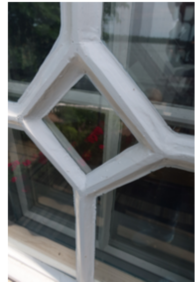
1983 tehdyissä ikkunoissa on perinteinen kittifalssilasitus, kuten talon vanhemmissa ja esikuvana toimineissa ikkunoissa.
