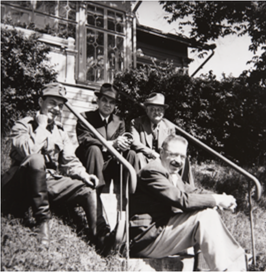
Kuva Kesärannan rannanpuolen ulkoportailta, joissa oli tuolloin metalliputkikaiteet. Kuvaaja tuntematon, 1942, MV.
