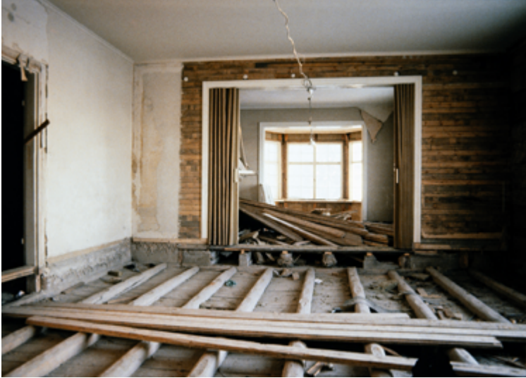
Peruskorjauksen purkuvaiheen kuva salista. 1951-1952 tehdyn salin ja ruokasalin välisen oviaukon laajennuksen yhteydessä seinälaudoitusta oli ilmeisesti uusittu ja laudoitus näkyy kuvassa paljaaltaan. Vaaleasävyisenä esiintyvillä seinäalueilla oli vanha tikkurappaus, jonka tikutusta näkyy myös lattiarakenteen korkeudella. Salin lattiasa näkyy täytteiden poistamisen jälkeen kantava puupalkisto ja täytepohjalaudoitus. Kuvasta voi myös erottaa ruokasalin puolen lattiarakenteessa olevat betonipalkit, rakenne joka oli tehty vuonna 1952. Kuva Kai Hagström 28.1.1982. JOKA.
