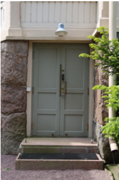
Kaikki ulko-ovet uusittiin 2003 peruskorjauksessa. Kellarikerroksen tornin ovi. 6/2025.
