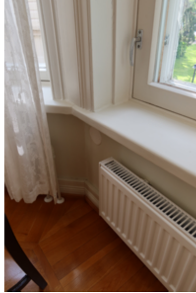
Osaan tiloista asennettiin peruskorjauksessa tyypillisiä peltisiä yksi tai kaksijakeisia viuradiaattoreita. Kuva ruokasalin erkkeristä. 6/2025.
