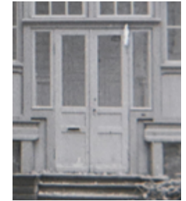
1983 peruskorjausta edeltäneessä pääovessa oli uusrenessanssityyppinen epäsymmetrinen peilijako. Kuva (ote) Liesimaa 1979. JOKA US.
