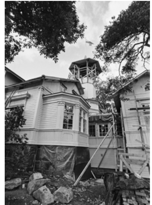
Kesärannan peruskorjaustyön harjannostajaiset 9.9.1982. Julkisivutöitä tehtiin kevyiden paikka nikkaroitujen puutelineiden varassa. Kuva Kai Hagström, Pressfoto. JOKA.
