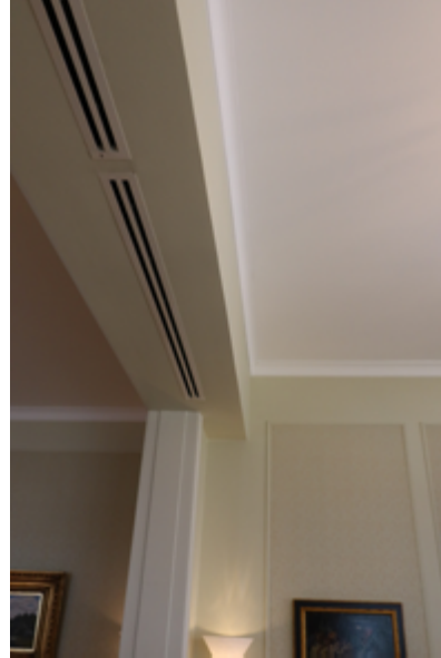
Vuoden 2003 peruskorjauksessa ruokasalin tuloilman kanava ja säleikkö uusittiin. 6/2025.
