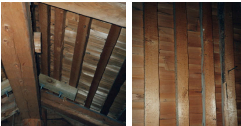
Vanhaa pärekattoa ja sen alusrimotusta ullakolla kuvattuna vuonna 2002. Kuvat Seija Linnanmäki. MV.
