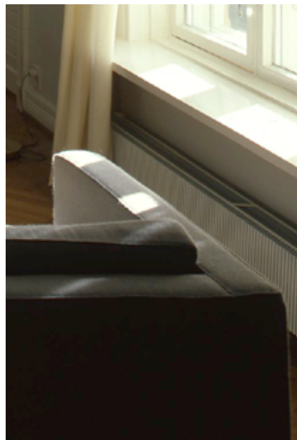
Peruskorjausvaiheen 1979–1983 peltisiä levypattereita, työselityksen mukaan Högforsin valmistamia.
