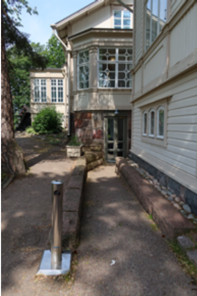
Monitoimitilaan johtava luiska ja erkkerin kivijalassa oleva kolmipeilinen lasipariovi 2003 peruskorjauksesta. 6/2025.
