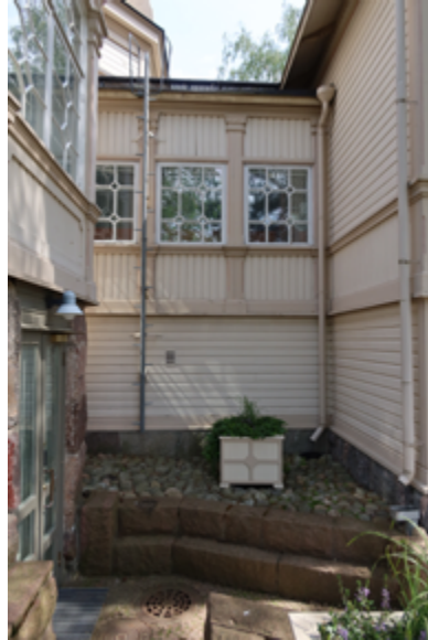
Luiskaa reunustavia luonnonkivirakenteita keittiösiiven nivelkohdassa. Liitännät rakennukseen kivettiin mukulakivillä. 6/2025.
