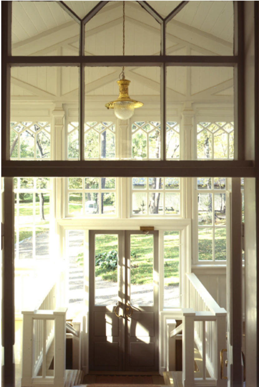
Pihapuolen kuisti 1983 valmistuneen peruskorjauksen jälkeen, vaaleassa asussa. Kuva Kari Hakli 1983. Kaisa Vepsäläisen kuvakokoelma.
