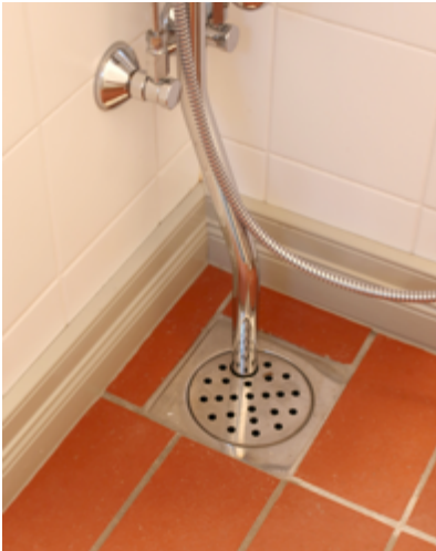
Peruskorjauksen 2003 vesi- ja viemäriäsenuksia. 6/2025.
