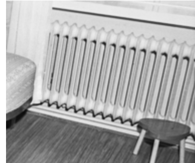
Högforsin Kesto-radiaattori, yleisin Kesärantaan 1952 asennettu malli. Kuva vuoden 1938 tuoteluettelosta. Valokuva yläkerran makuuhuoneesta, Kaisa Vepsäläisen kokoelma 1970-luvulta.
