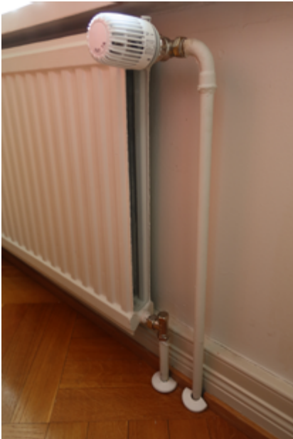
Peruskorjausvaiheen 1979–1983 peltisiä levypattereita, työselityksen mukaan Högforsin valmistamia.
