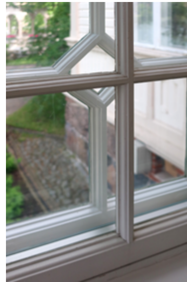
Merenpuoleisen lasikuistin ikkunat ovat edustava esimerkki Kesärantaan 1983 täydennetyistä vanhan mallin mukaan tehdyistä puuikkunoista. 6/2025.
