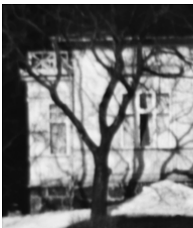
Kuva ajalta ennen tornin purkamista 1951. Erkkerissä oli ristikkokaide. Ote valokuvasta HKM, 10310.
