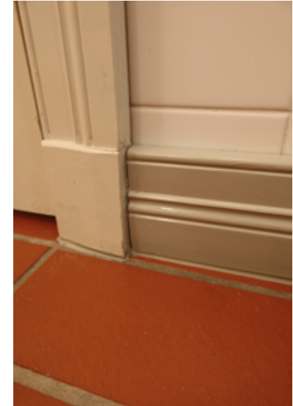
Seinissä on keraaminen valkoinen laatta, lattiasa tiililaatta, listat öljymaalattua puuta.
