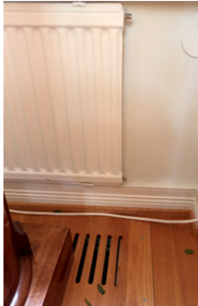
Peruskorjausvaiheen 1979–1983 peltisiä levypattereita, työselityksen mukaan Högforsin valmistamia.
