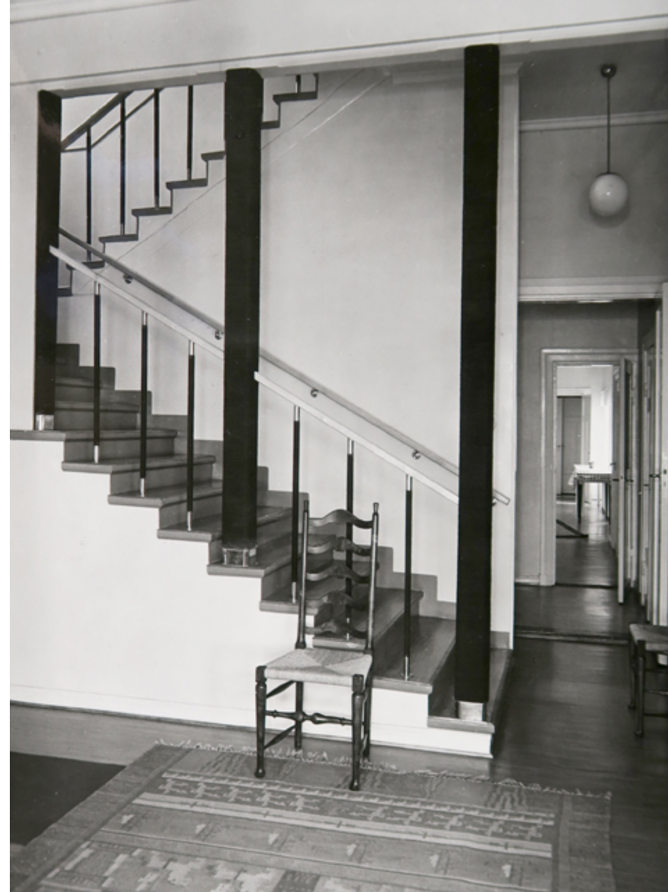
Rakennushallituksessa suunniteltu uusi ja aikakauden tyylin mukainen porras. Inventointiin 1976 kirjattuna: "Kaidetolpat messinkiheloineen ja lakattu koivupuinen kaidepuu ovat 1950-luvulta. Askelmat samoin kuin lepotoso kerrosten puolivälissä on päällystetty korkkimatolla." Kuva Grünberg 1955. HKM.
