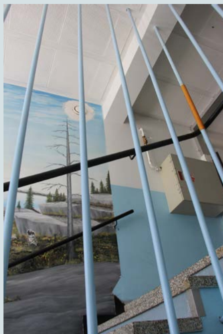
Vanhan osan portaan kaide tukeutuu kellarista ylös toiseen kerrokseen nouseviin terästankoihin.
