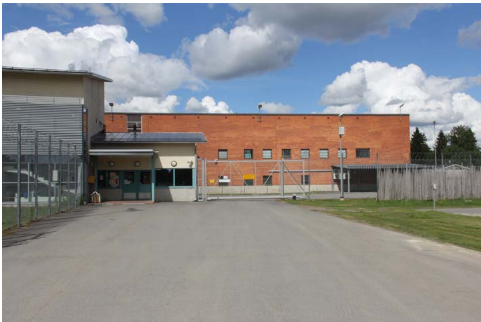
Keskusrakennuksen etujulkisivu jää nykyisin osittain hallintorakennuksen taakse. Rakennusten väliselle pihalle kuljetaan porttivalvomon tai ajoportin kautta.
