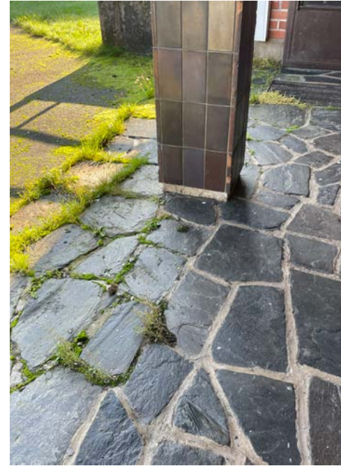
Pihalle johtava sisäänkäynti on vedetty sisään julkisivulinjasta. Syvennys on päällystetty liuskekievellä. Pilareissa on keraaminen laatta.
