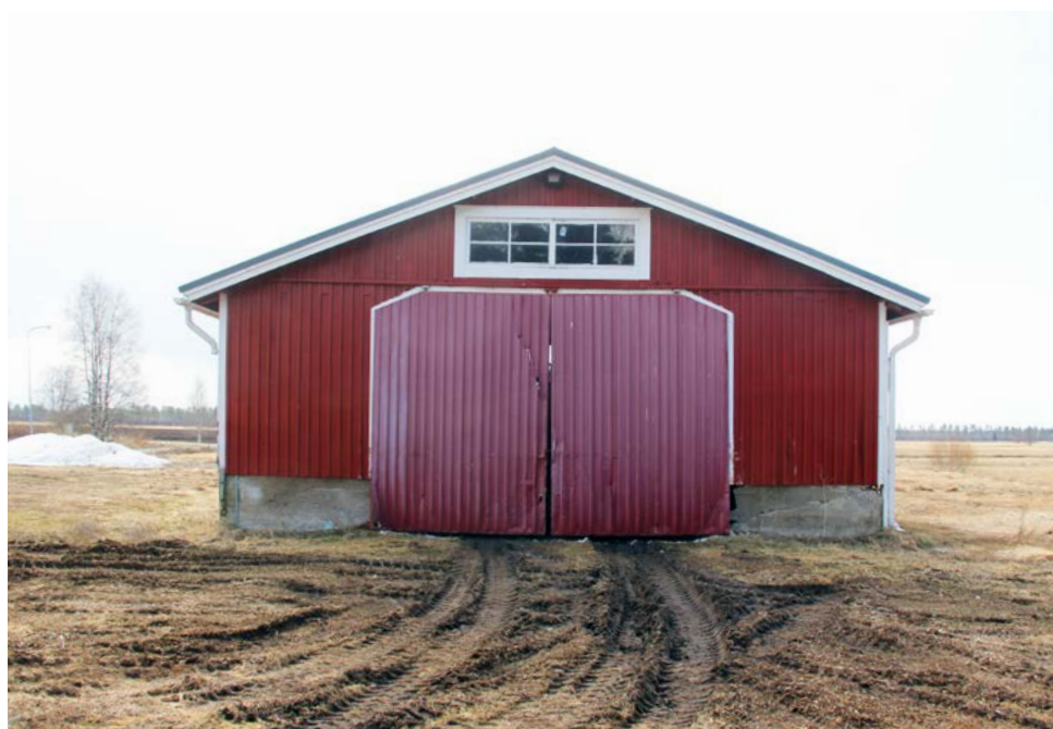
Apulantavaraston pohjoispääty. Oven muotoa on muutettu ja sivuovet on poistettu.
