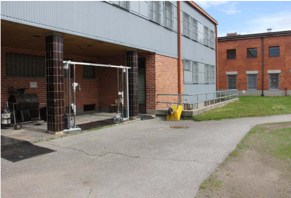
Osasto 2:n sisäänkäyntisyvennys. Kellarin seinän edustalle on kaivettu sola.
