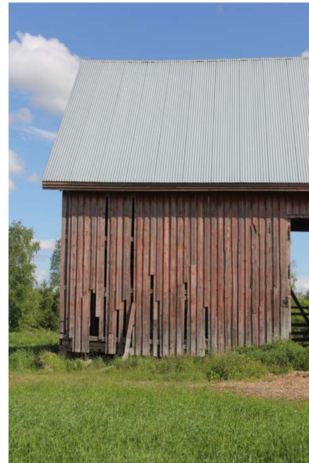
Tuulensuunaukean pohjoislaidalla olevaa sadan tonnin rehulatoa on kunnostettu viimeksi 1990-luvulla. Pelson ankarat säät ovat runnelleet ulkovuorausta.
