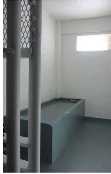
Eristysselli kalteriovelta nähtynä. Tilan kaikki pinnat, vuode mukaan lukien, ovat betonia.
