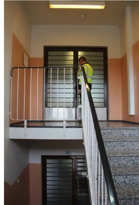
Laajennusosan portaan ylätasanne. Porras on elementtirakenteinen ja siinä on teräksinen pinnakaide.
