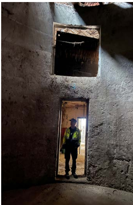
Betonista valettu rehusiilo sisäpuolelta. Siiloja on kaksi rinnakkain. Ne täytettiin yläpuolelta.
