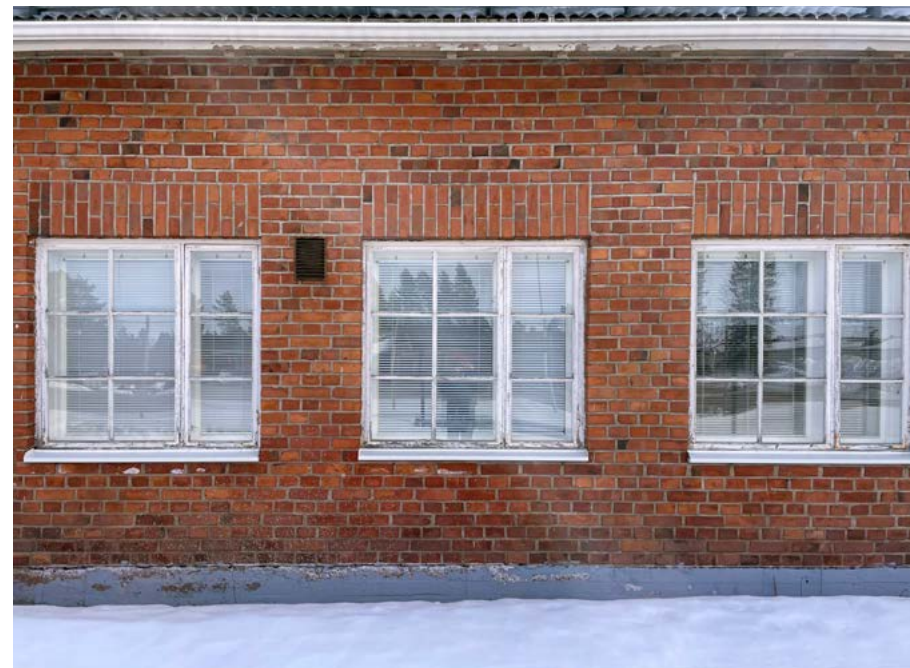
Rakennuksen tiilirunko on muurattu matalan betoniperustuksen päälle. Ikkunoiden yläpuolella on tiilipintainen holvipalkki. Puiset ruutuikkunat ovat alkuperäiset.
