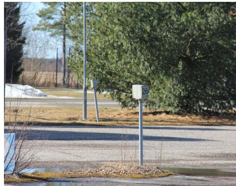
Pysäköintialue rakennettiin 2000-luvun alussa hallintorakennuksen rakennushankkeen yhteydessä. Alueelle rakennettiin kuivatus, se päällystettiin ja varustettiin lämpöpistokeilla.
