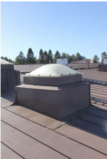
Peltikaton saumoissa on käsityön leima. Kattoa on myöhemmin tiivistetty ja maalattu.
