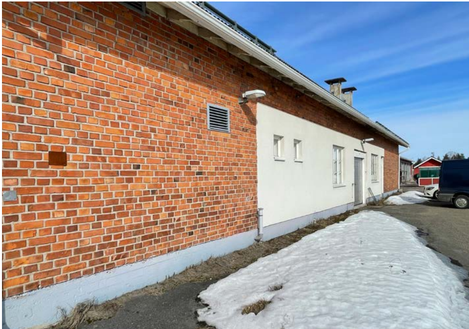
Takajulkisivun oviaukot on muurattu umpeen ja tilalle on tehty ikkunoita. Muutokohdassa on vaalea sileärappaus. Ovi johtaa vanhaan pajaan.
