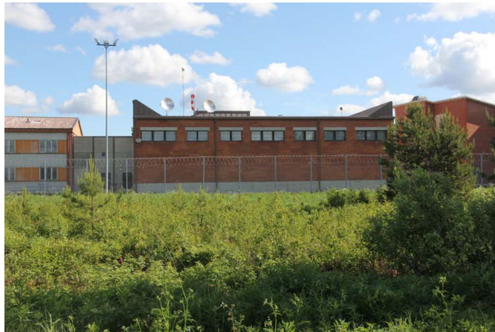
Keskusrakennuksen pääty etelään. Päädyssä on vankilan liikuntasali.
