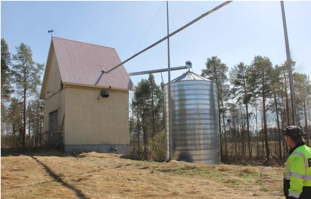
Uusi viljankuivaamo ja teräksinen viljasiilo on rakennettu harjanteen reunalle erilleen vanhasta puimalarakennuksesta. Kuivattu vilja siirretään putkea pitkin viereiseen terässiiloon tai vanhaan puimalaan.
