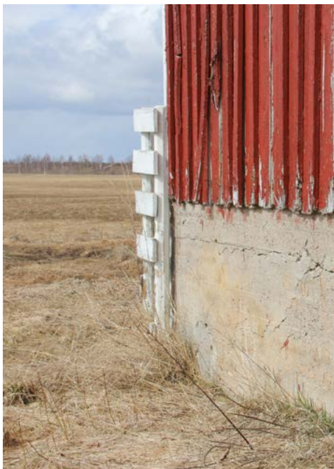
Varastossa on korkea paikalla valettu betonisokkeli. Julkisivussa on rimalaudoitus.
