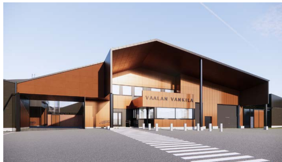
Pelson vankilan asukkaat siirtyivät uuteen satapaikkaiseen Vaalan vankilaan keväällä 2025. KUVA: Senaatti-kiinteistöt.
