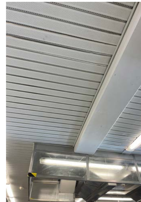
Alakatossa on perforoitu metallikasetointi.
