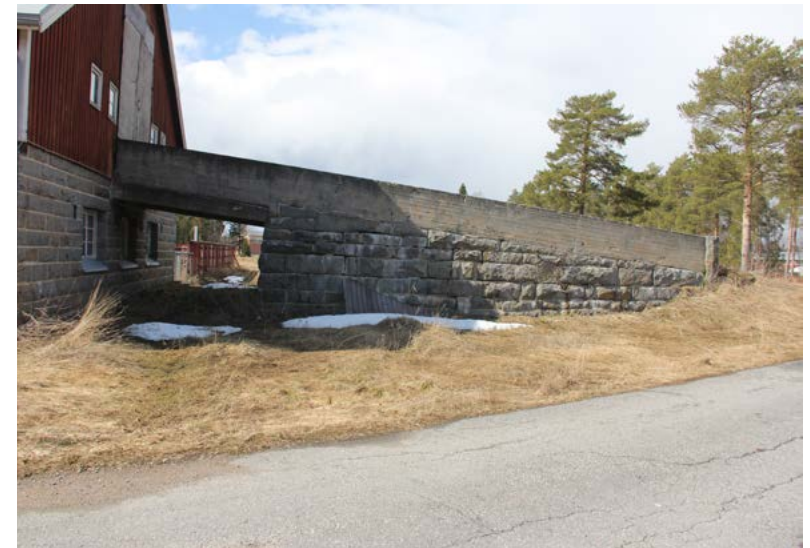
Kivistä rakennetun ajoluiskan kaide on tehty betonista.
