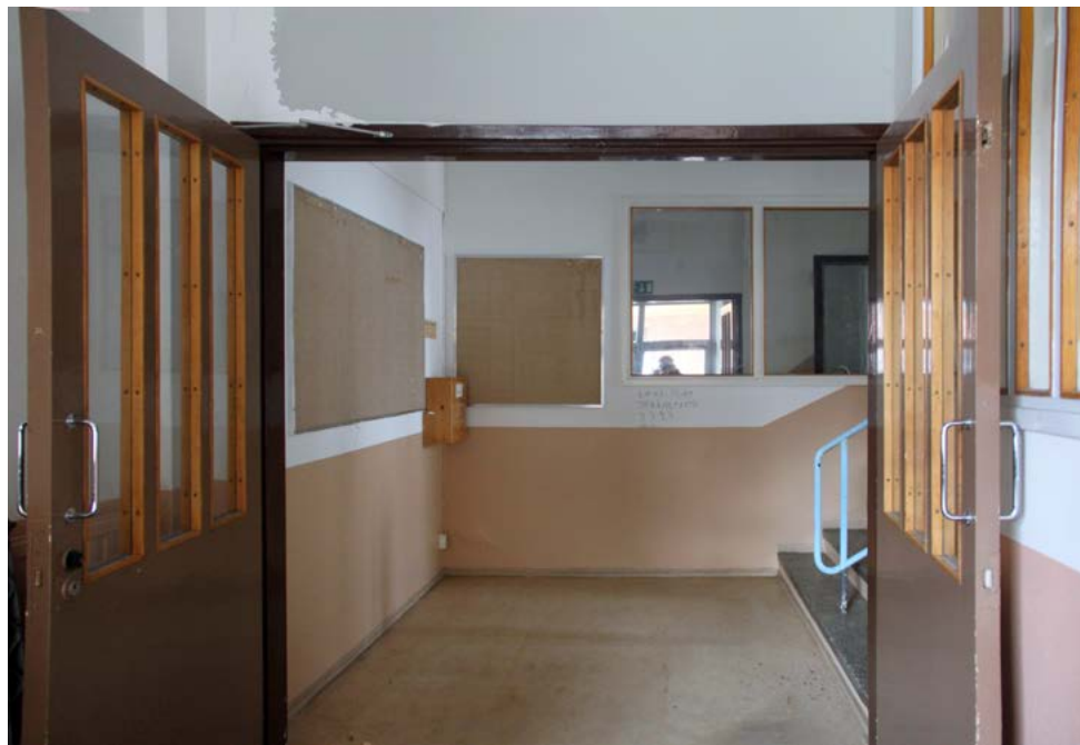
Pääovelta tullaan aulaan, josta nouseaan puoli kerrosta ensimmäiseen kerrokseen.
