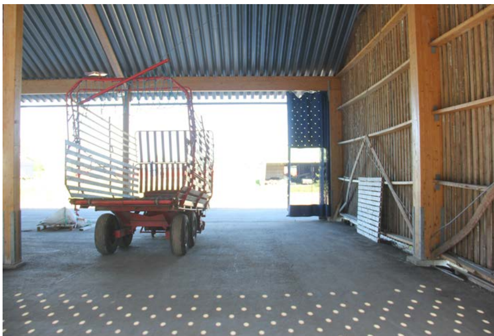
Sahatavaravarastot ovat liimapuurunkoisia. Pihan asfaltointi jatkuu hallien sisälle.
