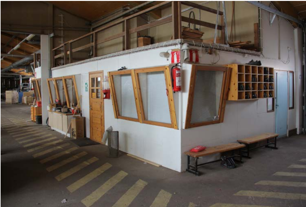
Työnjohtajan toimistossa on eteenpäin kallistetut ikkunat. Toimiston katolle on tehty säilytystilaa.
