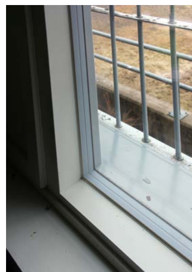
VASEMMALLA: Alkuperäinen ikkuna on kor- vattu lämpöla- sielelementillä.
