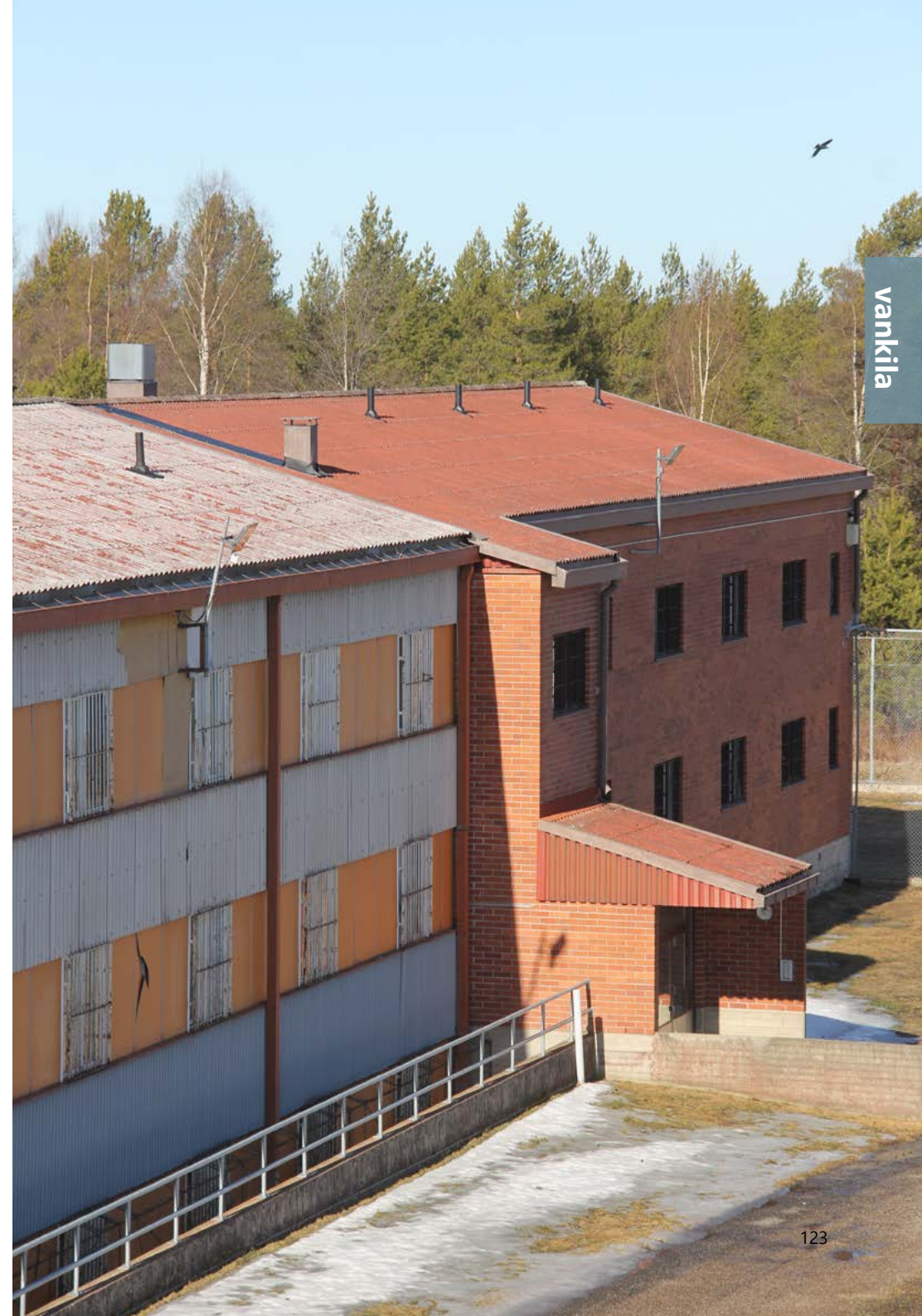
VASEMMALLA: Vankilarakennuksessa on kantikkaat ulkopuoliset vesikourut ja syöksyt.
