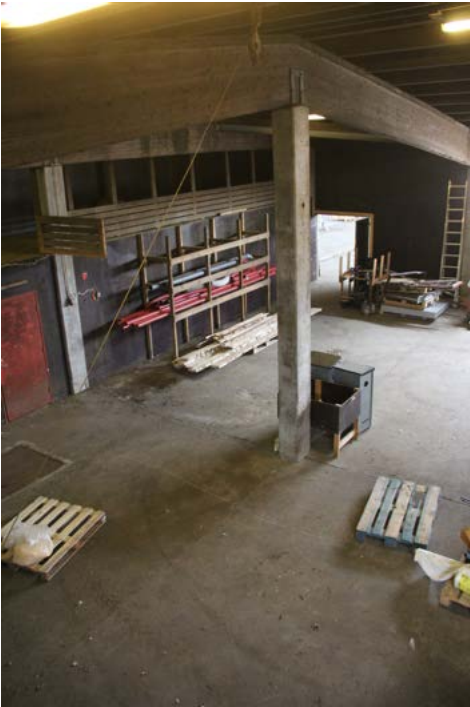
Näkymä tuorerehusiilon parvelta alas rehuvarastoon.
