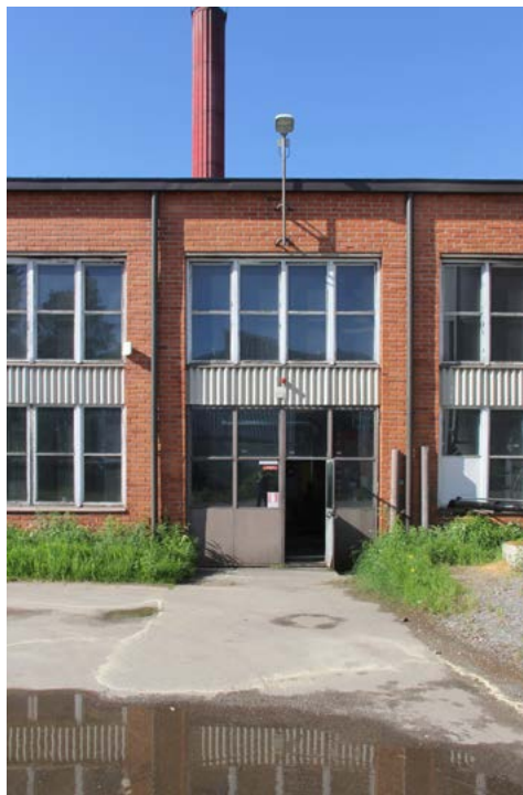
Lämpövoimalan kattilahuoneen sisäänkäynti. Etujulkisivun aukotus on symmetrinen.
