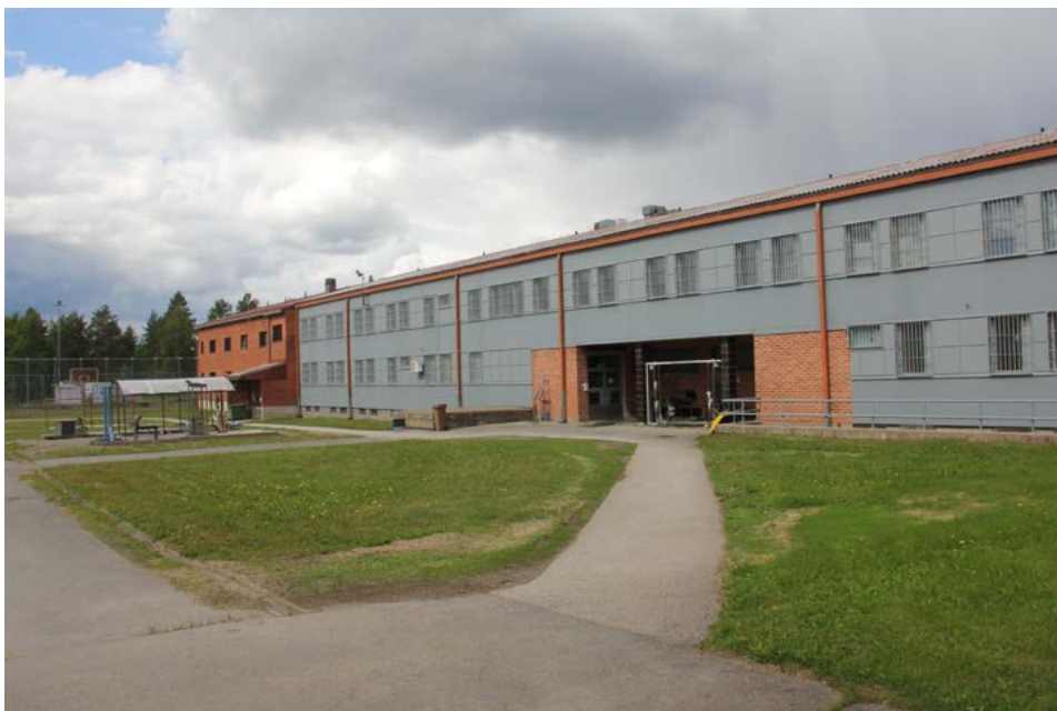
Osasto 2 sisäpihan suunnasta. Kuvan keskellä on sisäänvedetty sisäänkäynti. Punatiilinen laajennusosa jatkaa alkuperäistä julkisivulinjaa.
