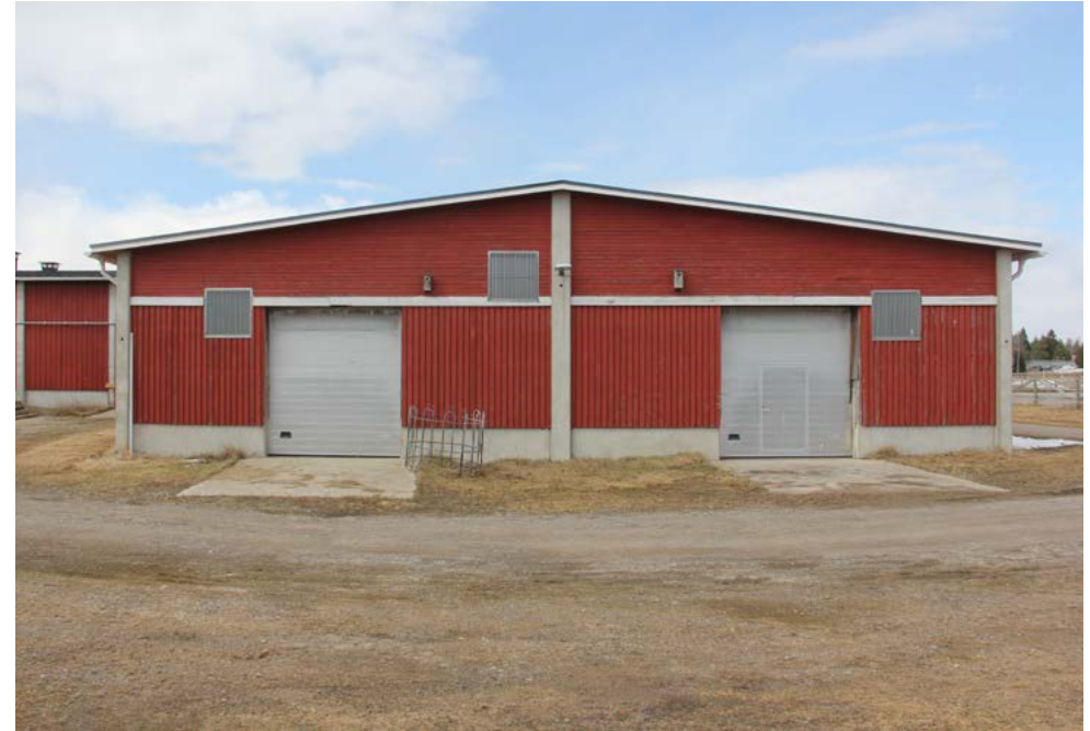
Länteen suuntautuvassa päädyssä on kaksi symmetrisesti sijoitettua nosto-ovea, joista kuljettiin kylmän lammastosaston kahdelle rinnakkaiselle käytävälle.
