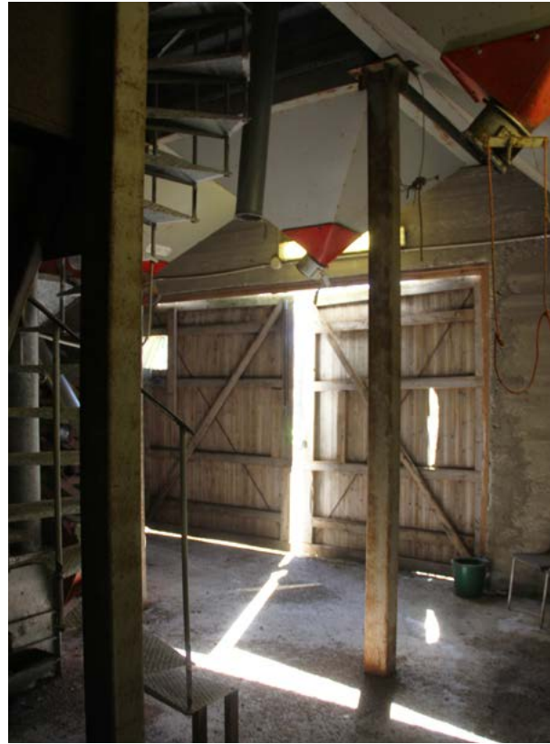
Alin kerros on betonirunkoinen. Sinne kuljetaan eteläjulkisivun puolelta.
