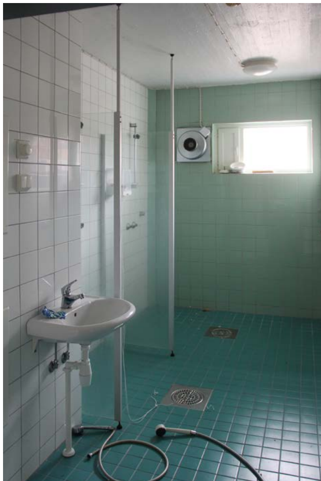
Sellin paikalle rakennettu suihkuhuone vanhassa osassa. Väritys poikkeaa vankilan alkuperäisestä värimaailmasta.
