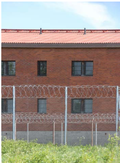
Lähikuva laajennusosan eteläjulkisivusta vankilan aidan takaa kuvattuna.
