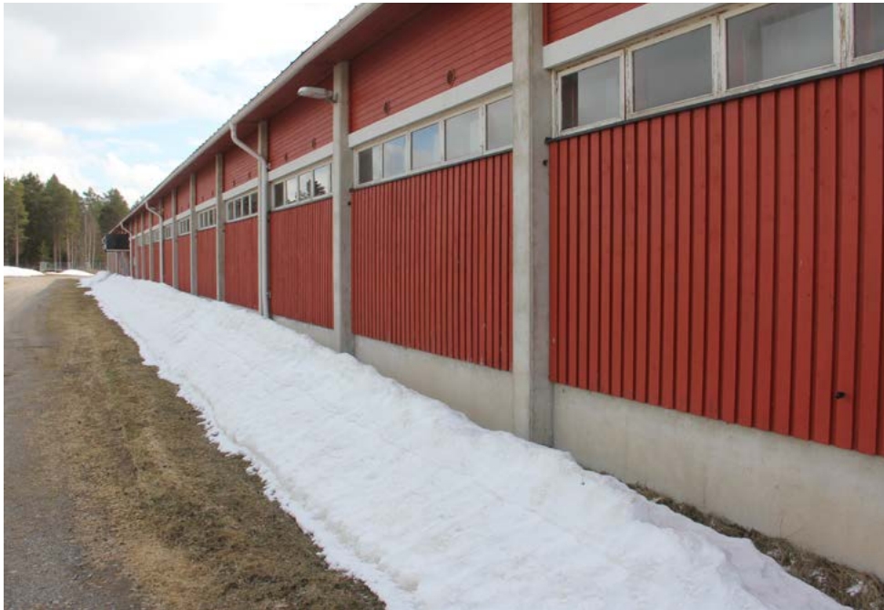
Lampolarakennuksen pitkä pohjoisjulkisivu. Betonipilareiden jäsentämä ulkoseinä toistuu aukotukseltaan ja materiaaleiltaan samanlaisena rakennuksen molemmilla pitkillä sivuilla.
