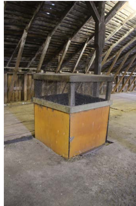
Jäteilma poistetaan katolle huippuimureilla. Aukon kautta otetaan korvausilmaa ullakolta.
