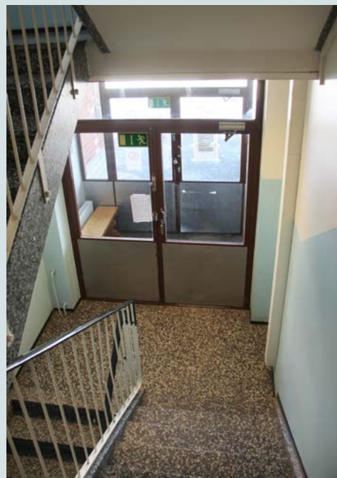
Laajennusosan porrashuone ulko-oven suuntaan.
