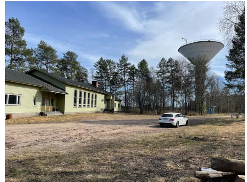
OIKEALLA: Suomaja valmistui paikallisen urheiluseuran talkootyönä vuonna 1954. Sen vieressä toimi uimala sekä urheilukenttä. Taustalla näkyy vankilan vuonna 1964 rakentama vesitorni.
