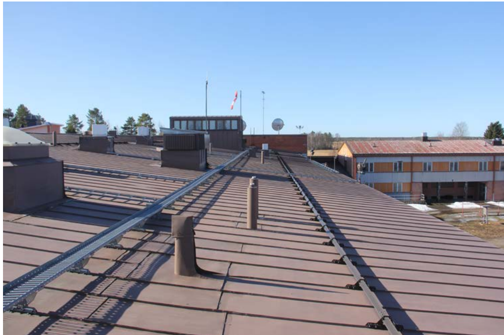
Yleisnäkymä päärakennuksen vesikatolta. Katolle on myöhemmin lisätty lumiesteitä ja kulkusilloja.
