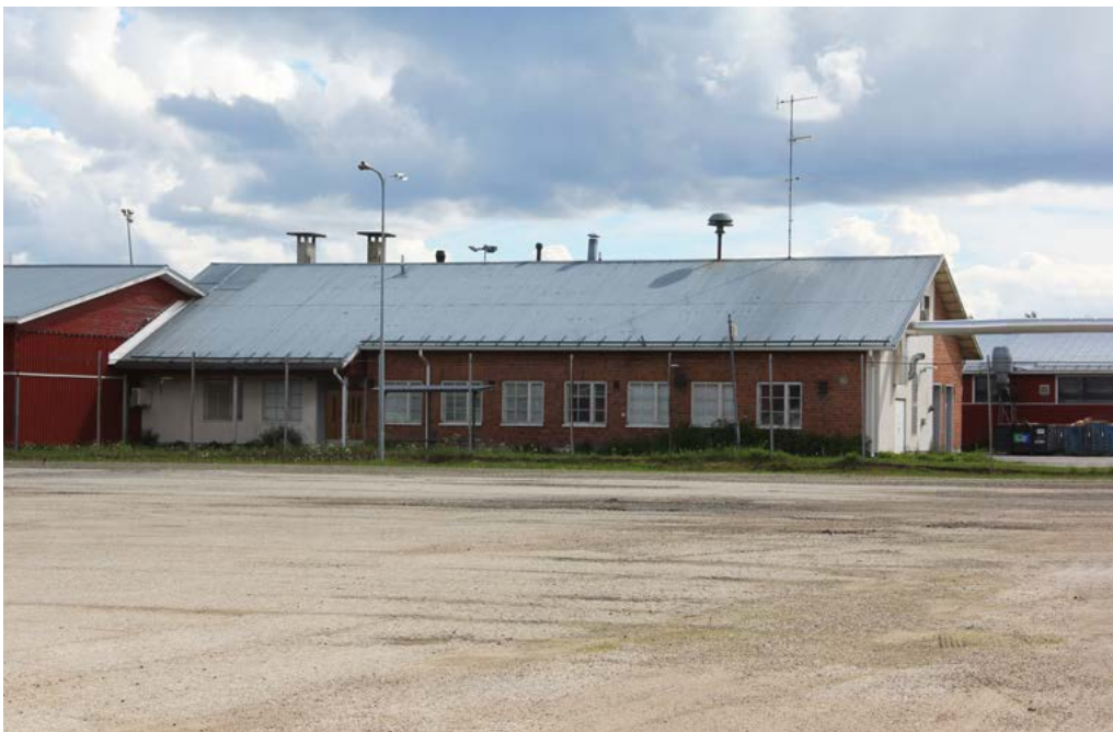
Korjaamorakennuksen eteläpäätyyn kytkeytyvä konetoimisto Linnantien yli nähtynä. Muutoskohdissa on vaalea rappauspinta.
