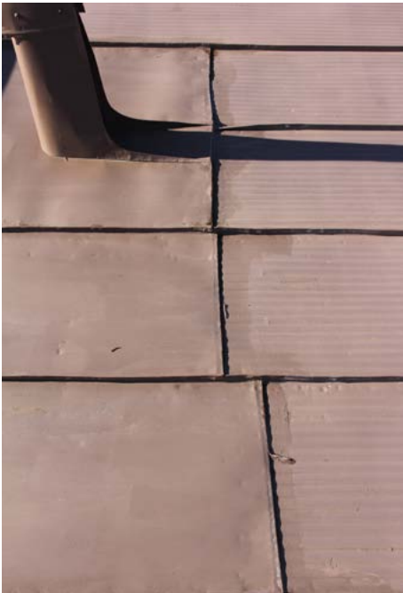
Peltikaton saumoissa on käsityön leima. Kattoa on myöhemmin tiivistetty ja maalattu.
