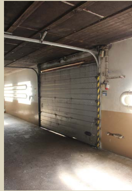
Sähkötoiminen nosto-ovi.
