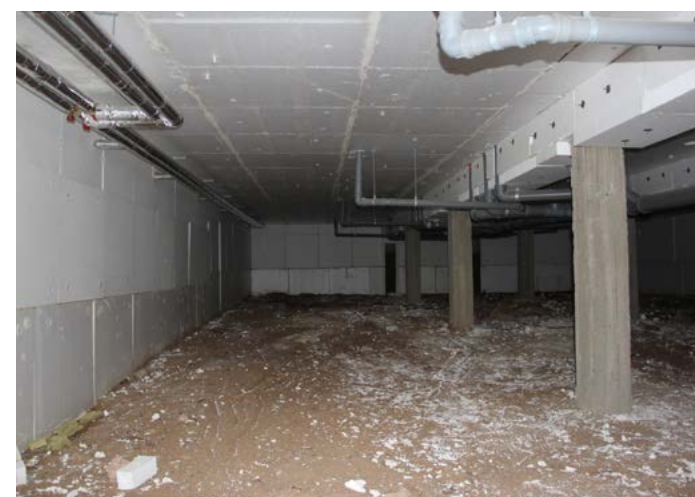
Näkymä huoltoluukusta kaivamattomaan kellaritilaan osasto 1:n laajennusosan päädyssä.
