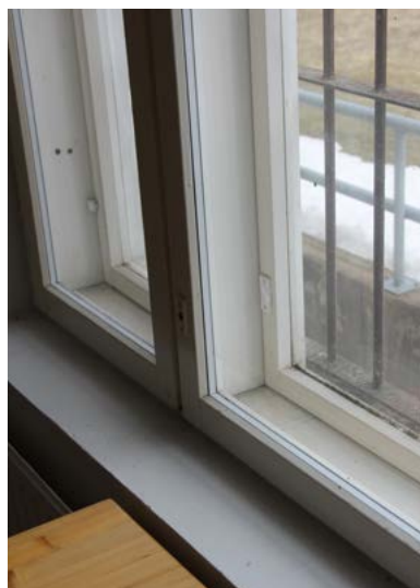
VASEMMALLA: Uusittu ikkuna, jonka sisä- puutteessa on lämpölasi.
