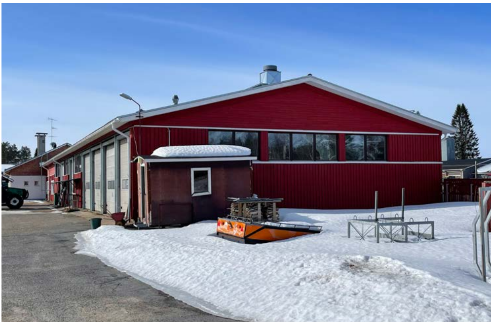
Korjaamohallin pohjoispääty. Viereisten puuteollisuushallien tavoin myös korjaamo on saanut 2000-luvulla punaisen julkisivupaneloinnin.
