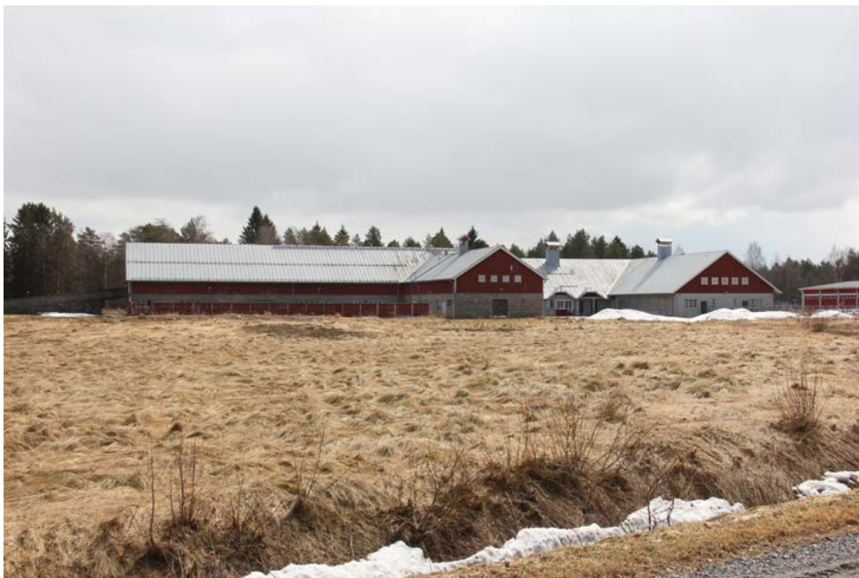
Kahdesta rakennusvaiheesta muodostuva navettarakennus Linnantien tienhaarasta kuvattuna.
