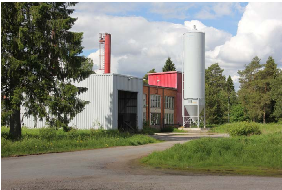
Lämpökeskus Linnantien suunnasta lähestyttäessä. Edessä on harmaa hakevarasto, takana on punainen öljysäiliö ja sen oikealla puolella korkea pellettisiilo.
