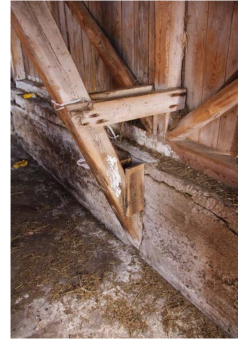
Betonisokkeli on karkeatekoinen. Myös runkorakenteissa on vankien käsityön leima.
