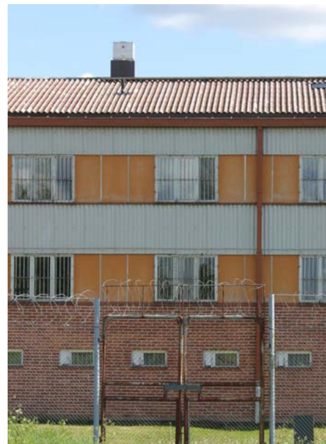
Ensimmäisen rakennusvaiheen kellarikerroksen maanpäällinen osa on tiiliverhoilu.
