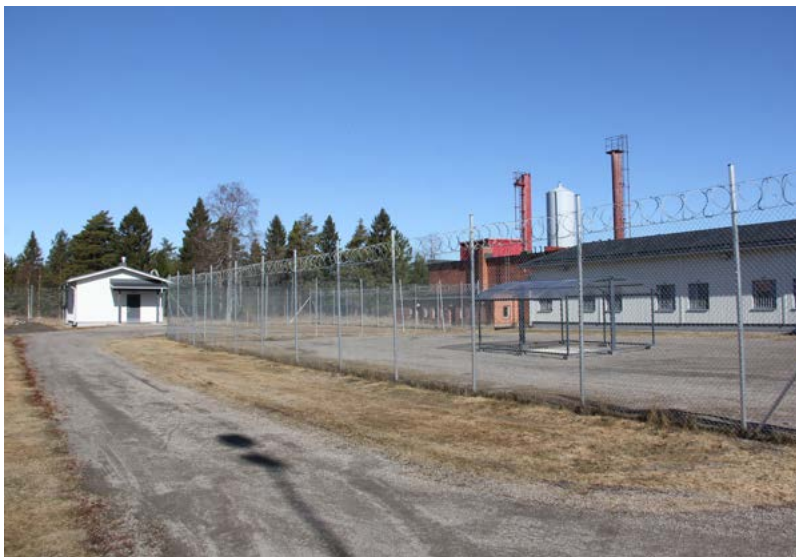
Osasto 3:n piha on rajattu teräsverkkoaidalla. Vasemmalla on erillinen saunarakennus. Taustalla näkyy lämpölaitos.
