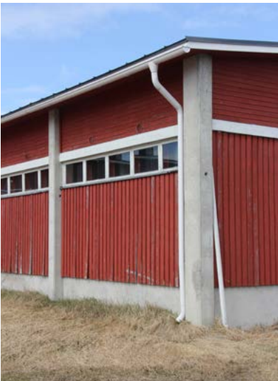
Tehdasvalmisteiset betonipilarit on sijoitettu rakennuksen julkisivun ulkopintaan.
