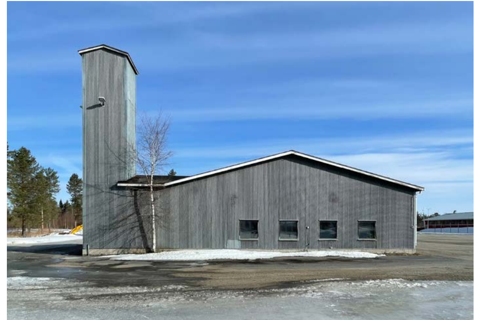
Autotallirakennuksen eteläpääty, jossa on paloaseman letkunkuivatustorni.
