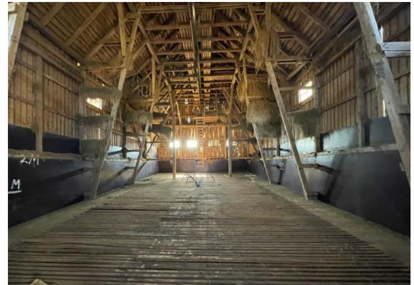
VASEMMALLA: Puimalaan varastoitua viljaa ja heinää voitiin käsitellä etualalla näkyvällä kahmarilla. Siilo tuulettuu alapuolelta korotetun lattian kautta.
