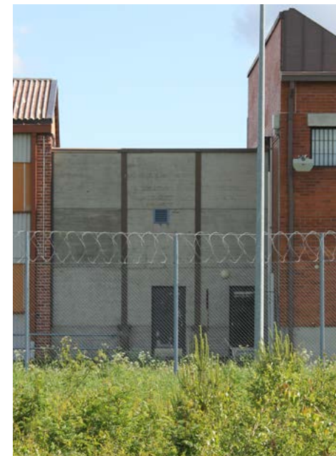
Osasto 1:n liittyminen keskusrakennukseen. Korkean betonimuurin takana on rakennusten välinen yhdysosa.
