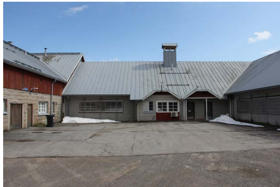
Kahden siipiosan välisellä sisäpihalla on navetan toimistot ja pääsisäänkäynti. Vasemmalla näkyy laajennusosan liittyminen vanhaan kivinavettaan.
