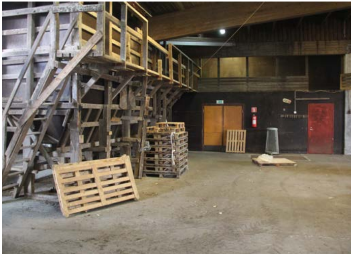
Rehuvaraston runko on rakennettu betoni-pilareista ja liimapuupalkeista. Vesikatto on eristämätön.
