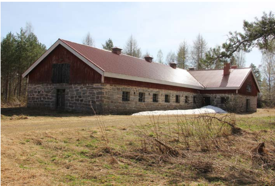
Betonitiilikatto on uusittu ja korvattu tiilikuviosella peltikatolla 2010-luvulla.
