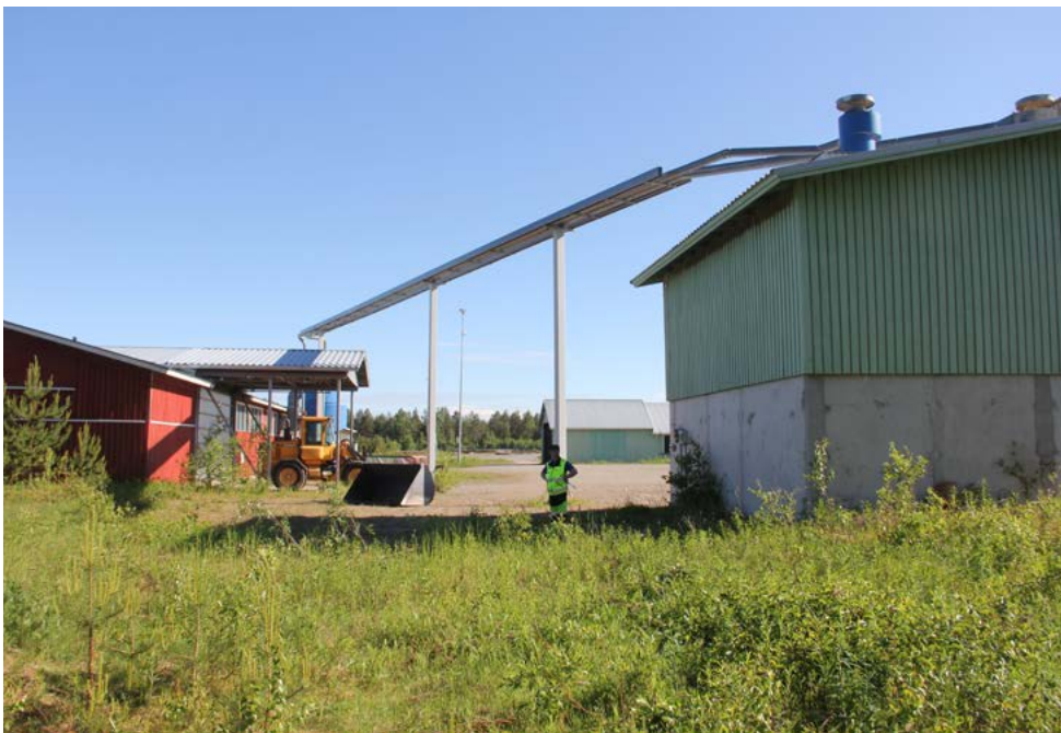
Puruvarasto rakennuksen takaa nähtynä. Putki siirtää purua puutyöhallin purusiilosta varastoon.
