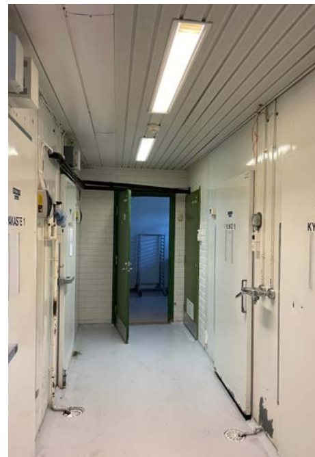
Sivukäytävällä on kylmäsäilytystiloja.
