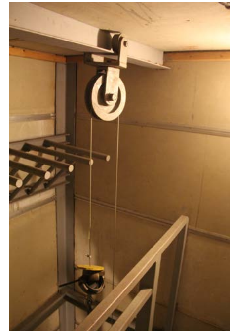
Tornin huipulla on vinssi, jolla letkut nostettiin vasemmalla näkyvään telineeseen kuivumaan.
