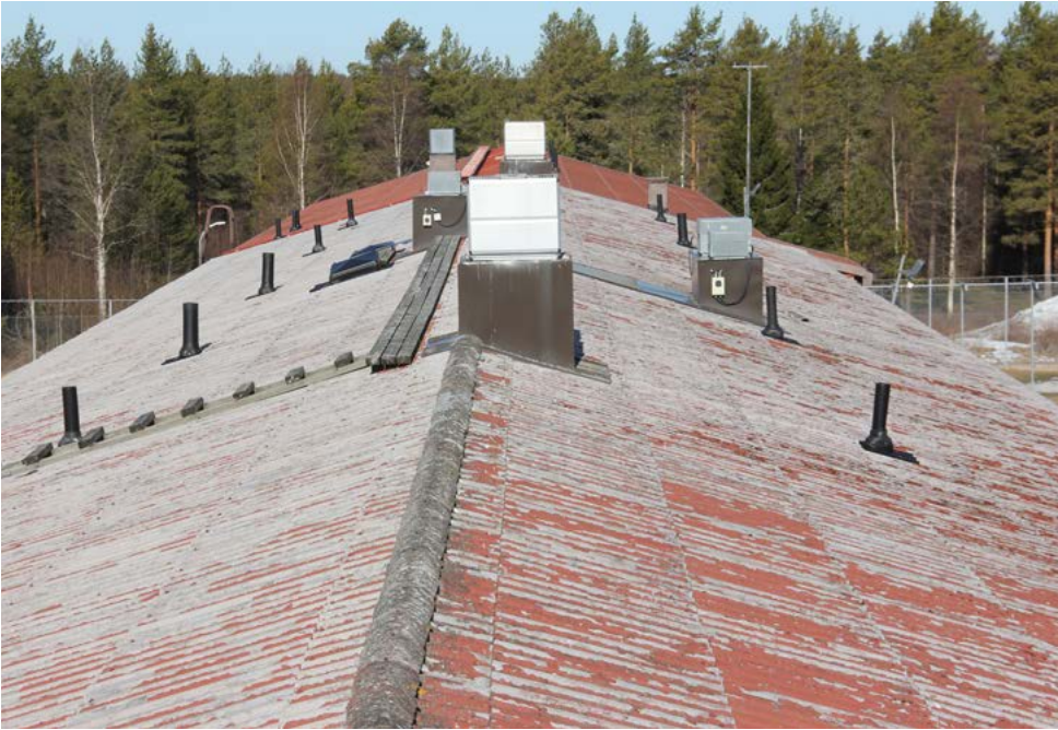
YLLÄ: Osasto 1:n vesikatolla on alkuperäinen varttikate. Katon maali on kulunut ja puiset kulkutiet ravistuneet.
