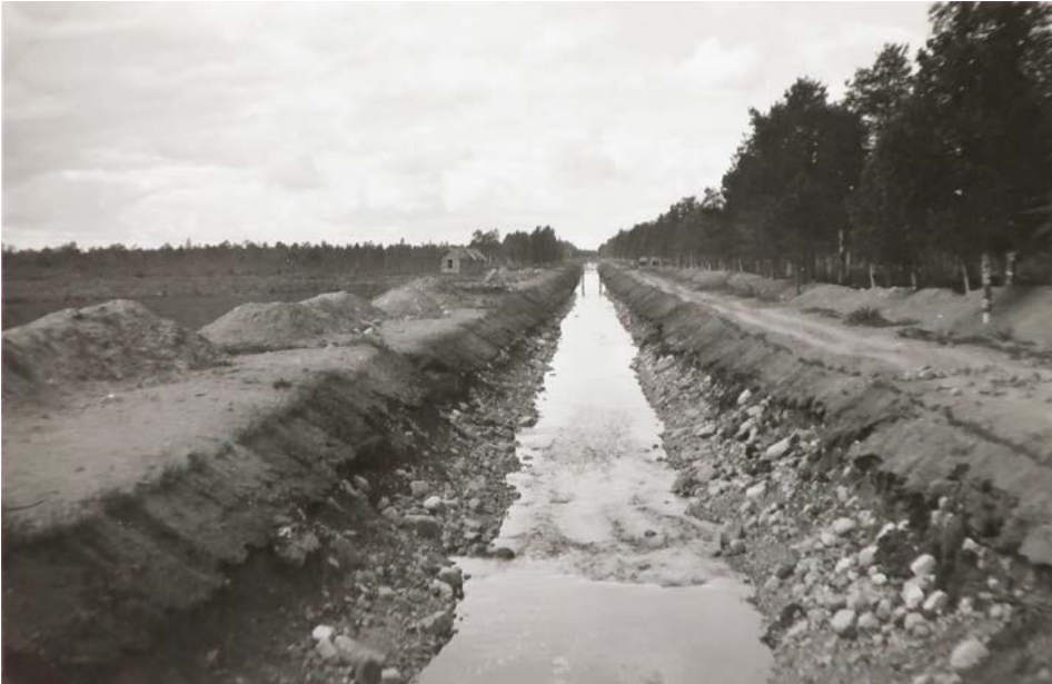
Tämä viemärikanava on perattu kaivinkoneella. KUVA: Kansallisarkisto Ude 1.1 VAHO
