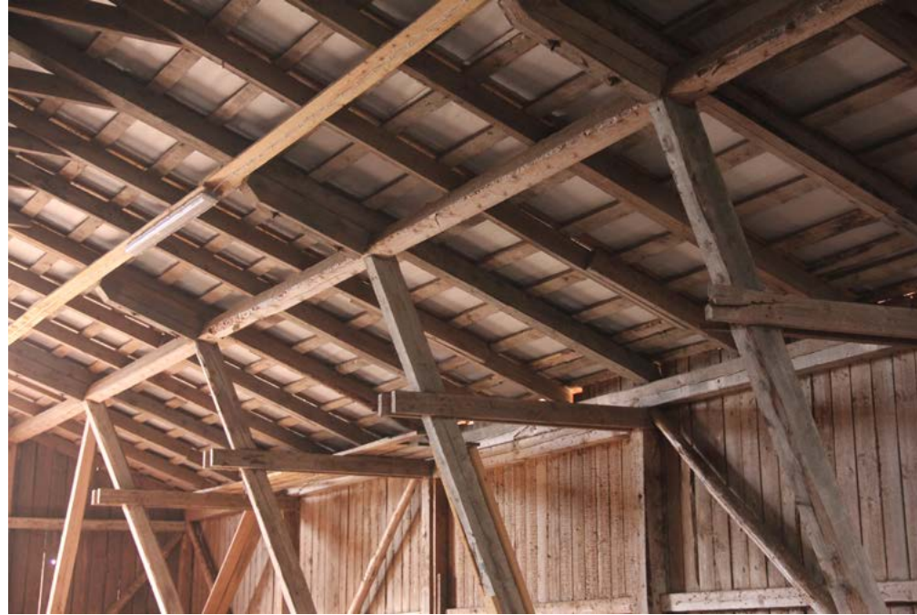
Rakennuksessa on sahatavarasta tehty ansarakenne. Vesikatteena on muovipintainen kattopelti, joka on asennettu harvalaudoituksen päälle.
