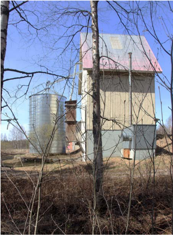
Viljankuivaamo itään. Eteläsivulla on ovi alimpaan kerrokseen. Oikealla on öljykattila, joka tuottaa lämpöä kuivausprosessiin. Maanpäällinen öljysäiliö jää kuvan ulkopuolelle.
