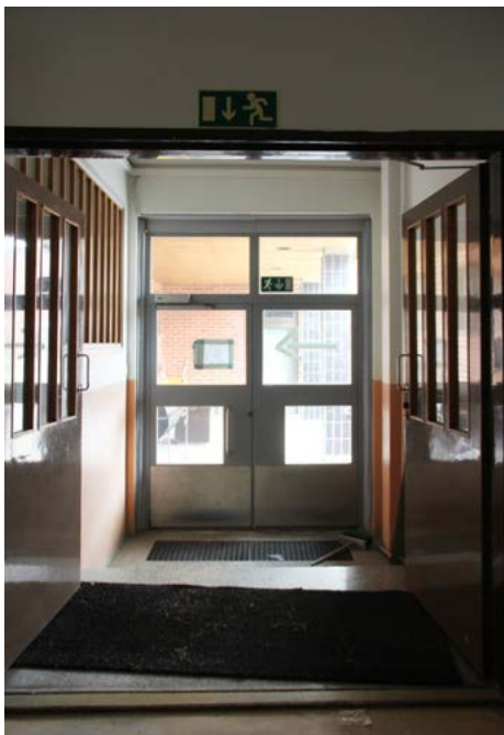
Vankipihalle johtava pääovi on sijoitettu sisäänkäyntisivennyksen sivuseinälle.
