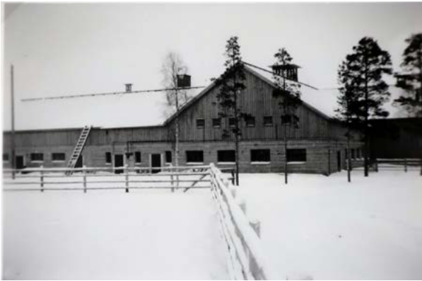
Rakenteilla olevan kivinavetan eteläpääty talvella 1948. Työ aloitettiin vankilan omin voimin ja omalla luvalla. KUVA: Kansallisarkisto Ude 1.1 VAHO
