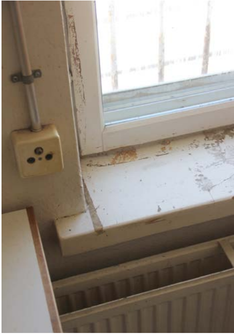
Yksityiskohta sellin ikkunaympäristöstä. Ikkunan alkuperäinen kaksilasinen ja sisään avautuva.
