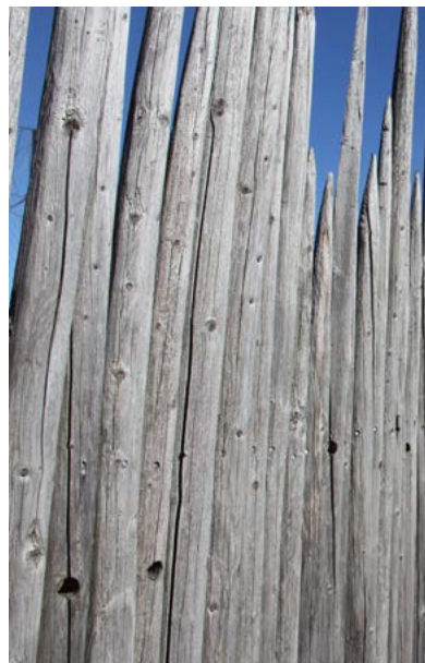
Heinäseipäistä tehty näkösuoja vankilan ja pysäköintialueen välillä.
