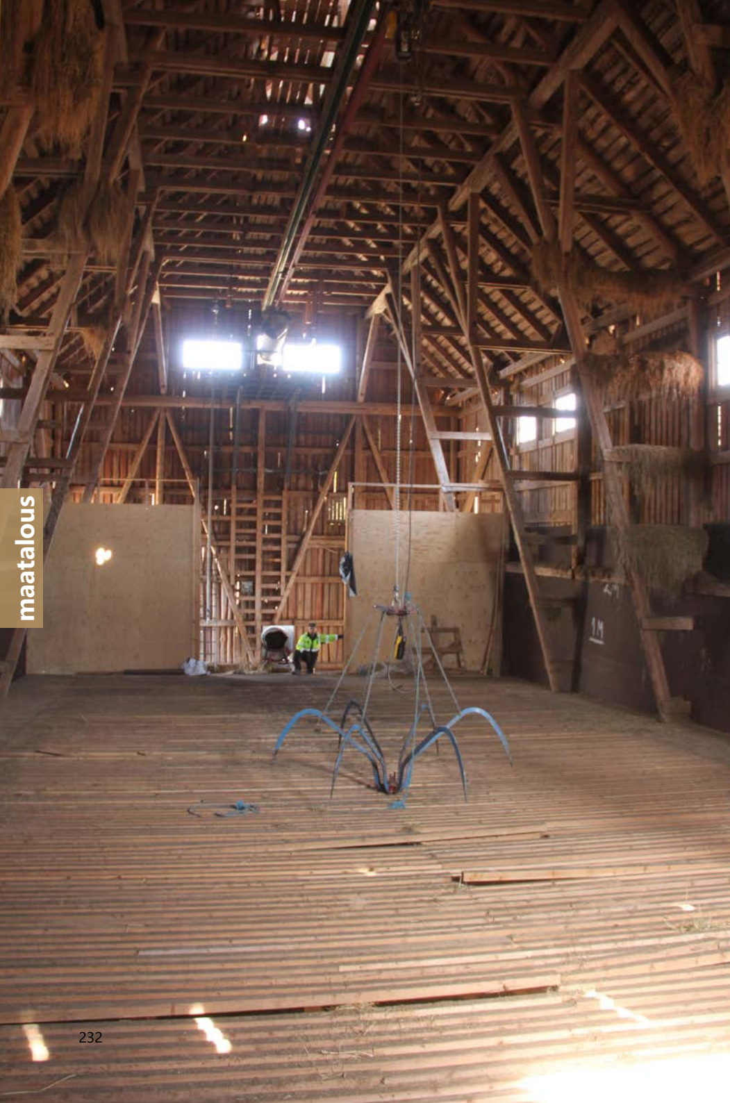
Puimalan itäpäässä on kuivaamo. Se voidaan täyttää kuvassa näkyvän putken kautta.
