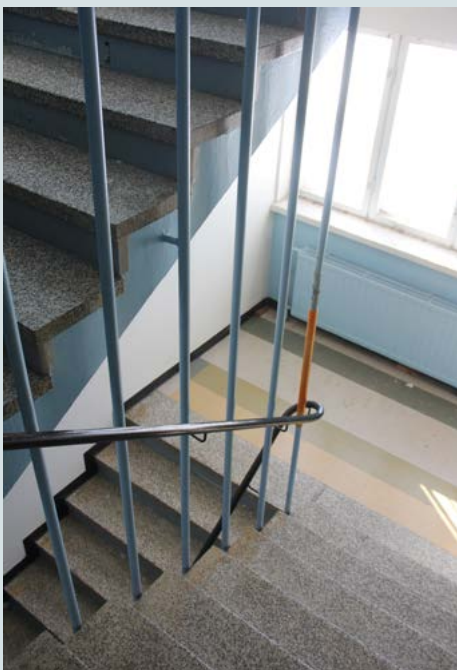
Vanhan osan kaksivartinen betoniporras nousee toiseen kerrokseen ja laskeutuu kellariin.
