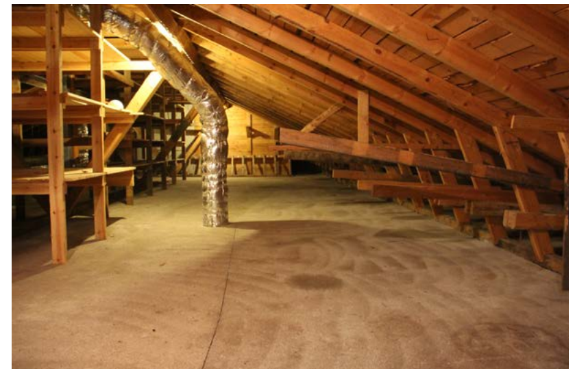
OIKEALLA: Näkymä käyttö-ullakolta, joka on toiminut sähkötarvikkeiden varastona. Ullakolla on betoninen palopermanto ja ruotsalaismalliset kattotuolit.
