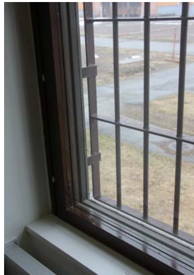
VASEMMALLA: Uusittu ikkuna, jonka sisä- puutteessa on lämpölasi.
