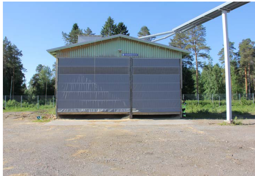
Puruvarasto edestä. Etuseinässä on vinyylistä tehty laskosovi.
