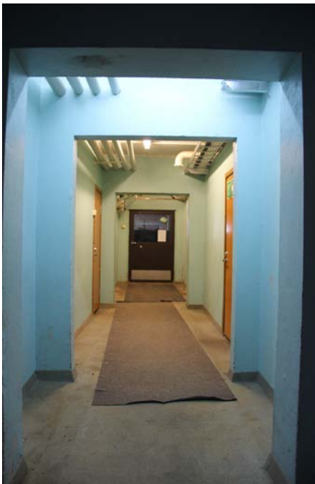
Navetan vanhan osan toimistokäytävä.
