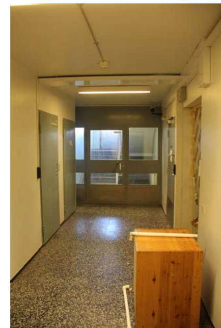
Laajennusosan kellarikäytävä, jonka oikealla puolella on tekniikkatiloja ja varastoja.
