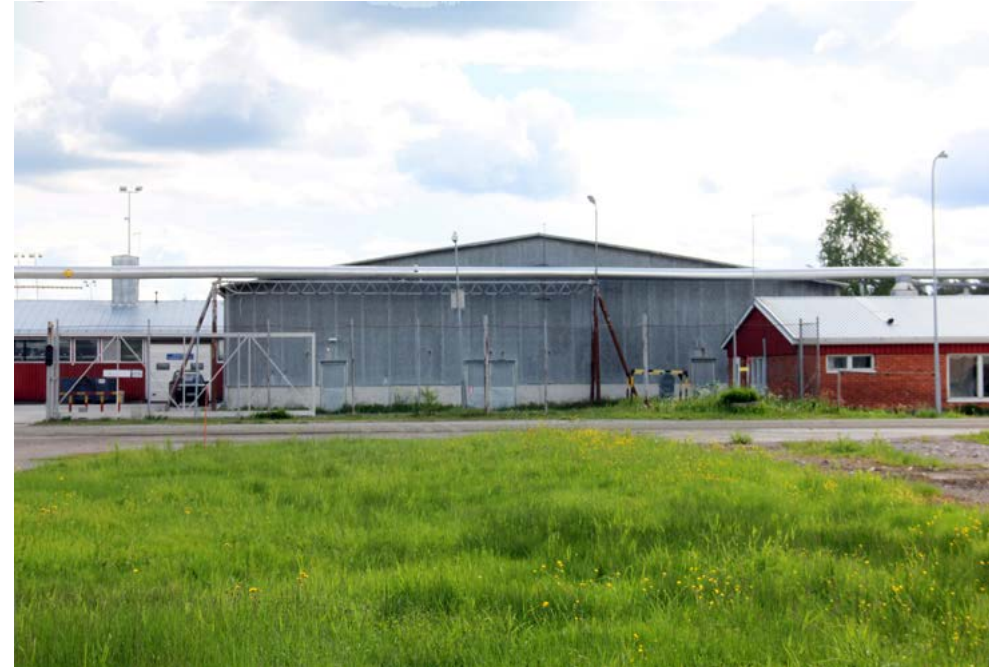
Keskusvaraston päätyjulkisivu Linnantielle. Vasemmalla on korjaamo ja oikealla vankilan työliike.
