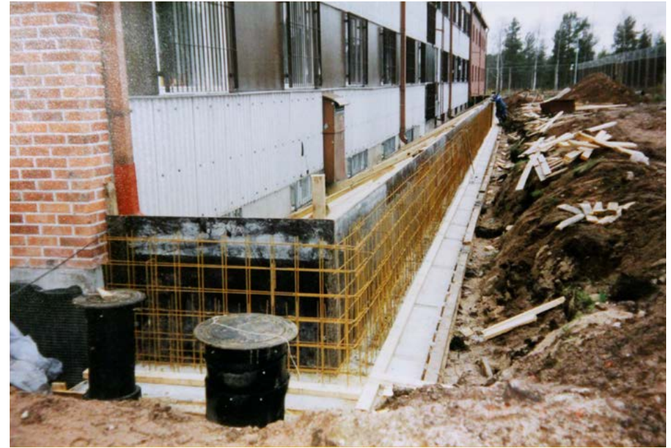
Salaojituksen korjauksessa kellarikerroksen seinät kaivettiin esiin ja kaivannon ulkopuolelle valettiin uusi rintamuuri. KUVA: Pelson vankilan arkisto
