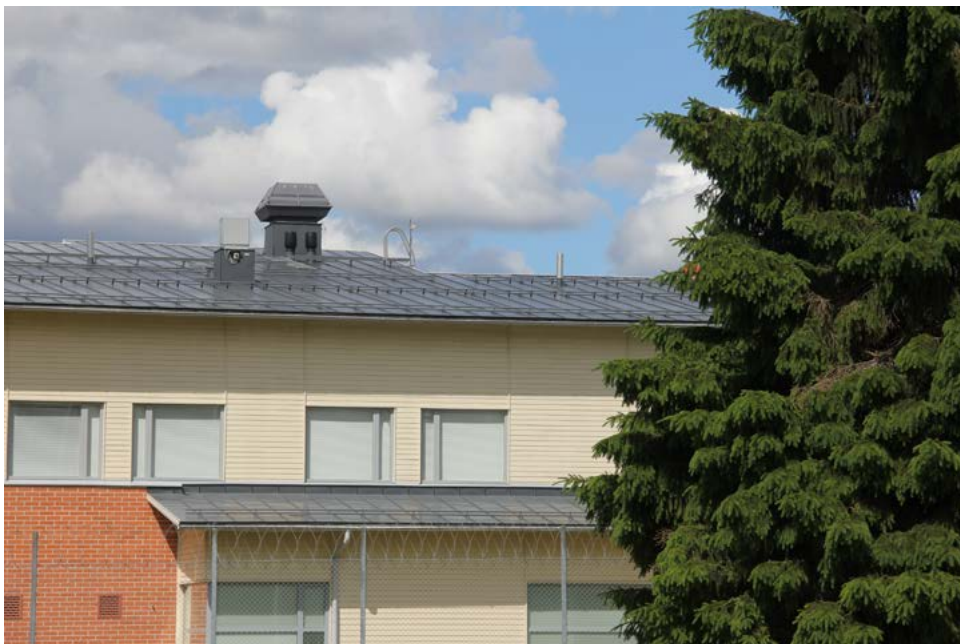
Tiilijulkisivun yläpuolella on vaakalaudoituksella vuorattu puurunkoinen osa.
