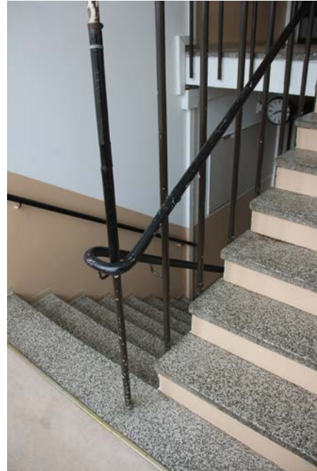
Vanhan osan käsijohde on tehty mustaksi maalatusta pyöreästä puusta. Kaiteen pystyosa nousee kellarista toiseen kerrokseen.
