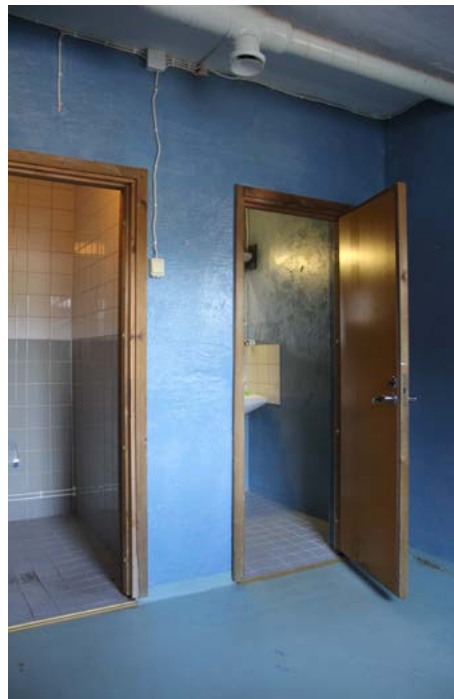
Navetan sosiaalitiloihin kuuluvat saniteettitilat on uusittu. Tilojen väritys on sinisävyinen.
