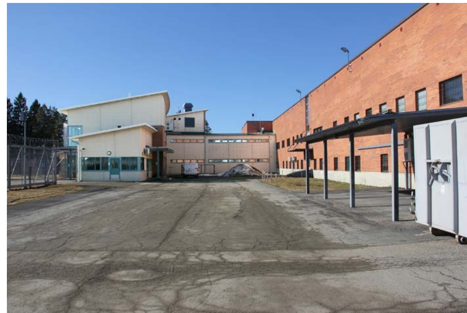
Hallintotalon pohjoispääty ja päärakennuksen välinen yhdyskäytävä, jonka korkeimmassa osassa on ilmanvaihtokonehuone. Oikealla on keskusrakennuksen sivulle vuonna 2004 lisätty katos.
