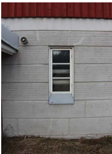
Pihatton ensimmäinen kerros on tehty kevytbetonielementeistä.
