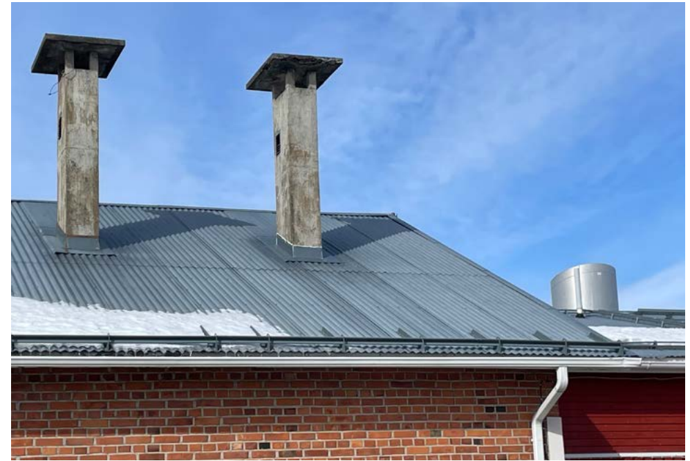
Korkealle vesikaton yläpuolelle nousevat betonihormit ovat fragmentteja vanhan konepajan ajalta. Alkuperäinen tiilikate on vaihdettu keveämpään aaltopeltiin.
