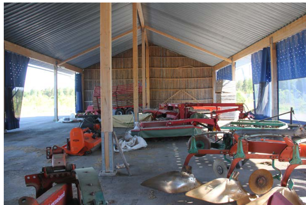
Varastojen pitkällä julkisivuilla on verhot. Ne mahdollistavat tuulettumisen ja torjuvat paistetta..
