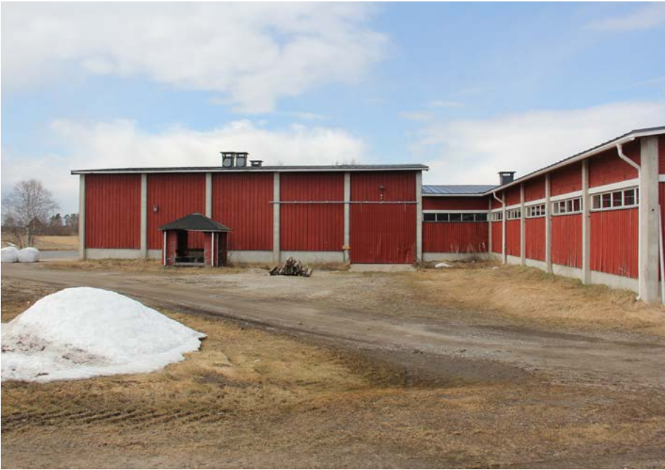
Näkymä Lampolan nurkalta kohti rehuvaraston itäjulkisivua.
