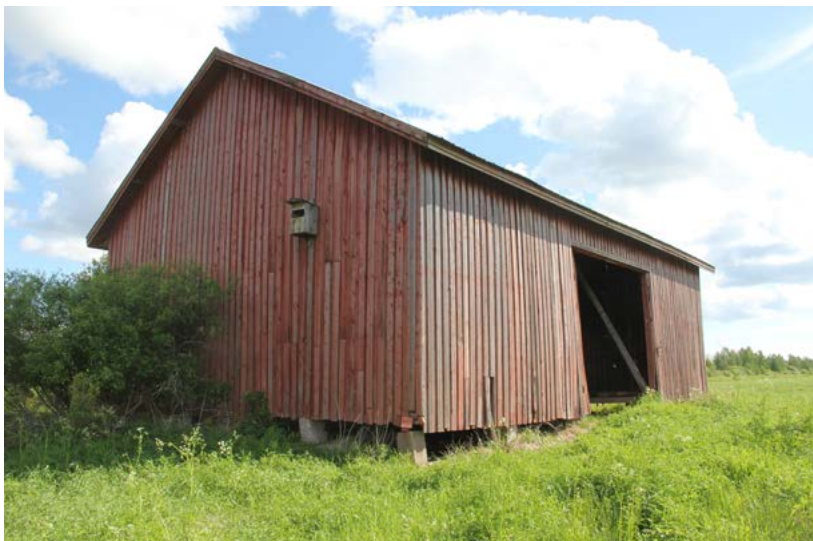
60 tonnin lato sivulta. Rakennus on perustettu luonnonkivi- ja betonilohkareiden päälle.
