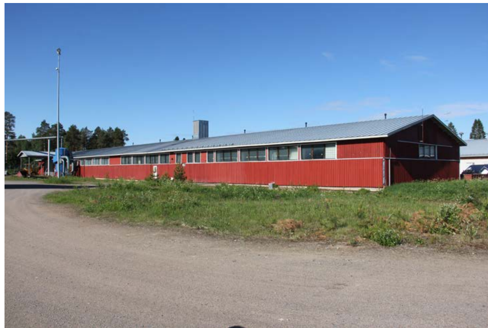
Takajulkisivu koillisesta. Rakennus sai punaisen lautavuorauksen 2000-luvulla vankityönä tehdyssä julkisivukorjauksessa.
