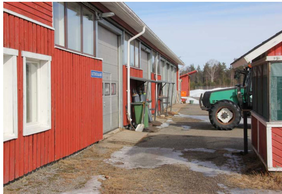
Korjaamohallin takajulkisivulla on kuusi korkeaa nosto-ovea.
