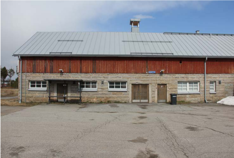
Navetan siipiosan julkisivu etelään.
