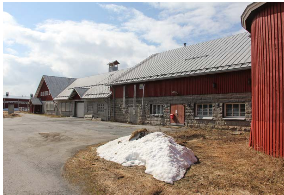
Kivinavetan takajulkisivu. Oikeassa reunassa on navetan rehusiilo. Vasemmalla on pihattonavetta ja sen takana lampola.
