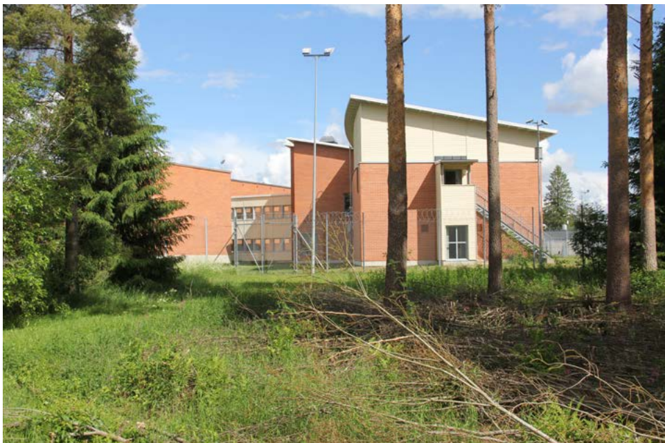
Hallintorakennuksen pääty etelästä nähtyä. Päädyssä on porrashuone. Vasemmalla näkyy Hallintolan ja kekusrakennuksen välinen yhdysosa.
