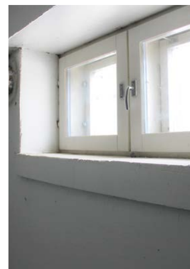
VASEMMALLA: Alkuperäinen ikkuna on kor- vattu lämpöla- sielelementillä.
