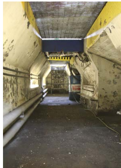
VASEMMALLA: Ajoneuvojen alapuolelta tapahtuvaan huoltoon varten tehty "rasvamonttu".
