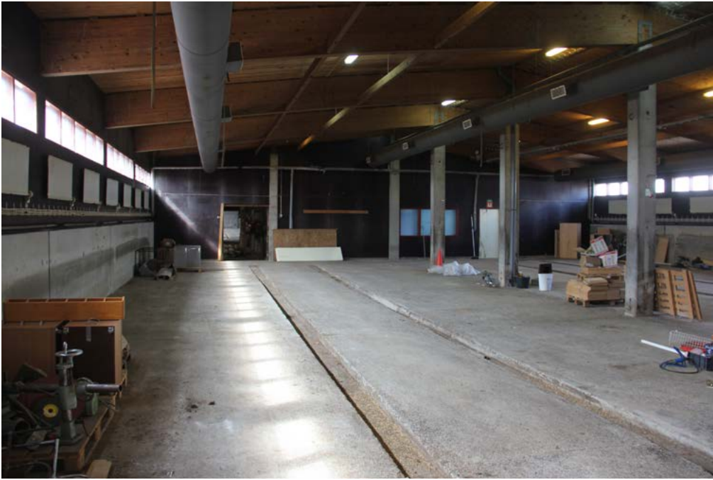
Lampolan puolilämmin "pikkupuoli". Keskellä näkyvän pilarilinjan kohdalla ollut väliseinä on poistettu. Lattian kourut johtavat virtsan lattian alapuoliseen säiliöön.
