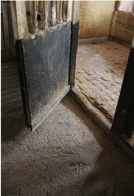
Käytävällä on betonilattia. Hevoskarsinassa on puinen "pölkynpäälattia".
