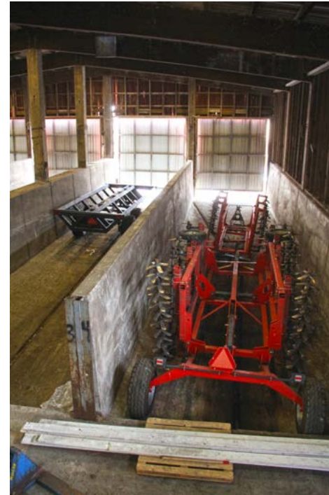
Kolme betoniseinällä toisistaan erotettua laakasiiloa.
