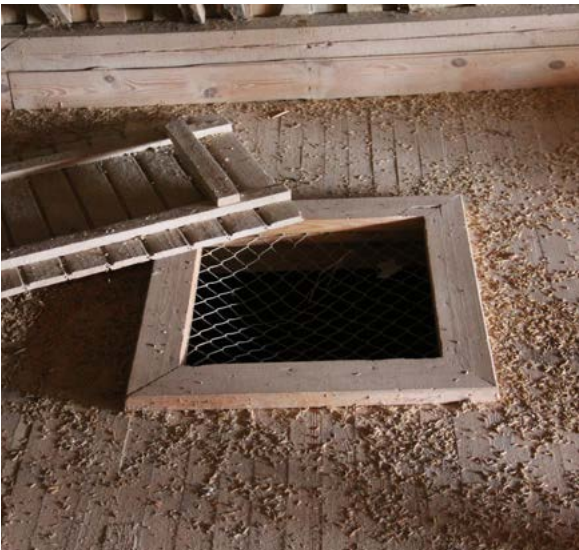
VASEMMALLA: Siilon täyt- töaukko on suojattu verkolla ja puukannella.
