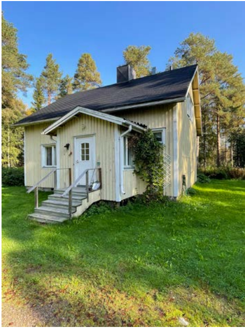
Rakennukseen nouseaan portaiden ja kylmän kuistin kautta.
