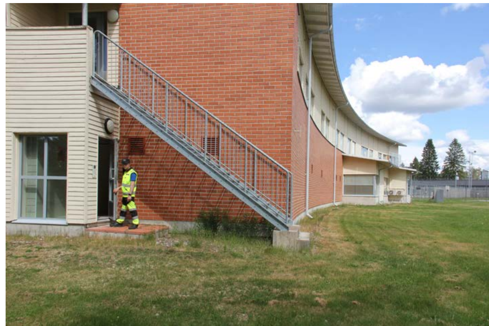
Kaareva etujulkisivu etelästä nähtynä. Metalliporras nousee toisen kerroksen parvekkeelle. Alaovi johtaa ensimmäisen kerroksen käytävälle.
