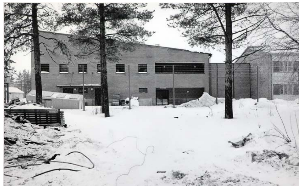
Keskusrakennuksen pohjoispääty, johon rakennettiin vankiosasto 2:een yhdistyvä korkea muuri. Sisäyhteys rakennettiin vasta myöhemmin. KUVA: Kansallisarkisto Ude 1.2 kuvaaja Riku Virtanen
