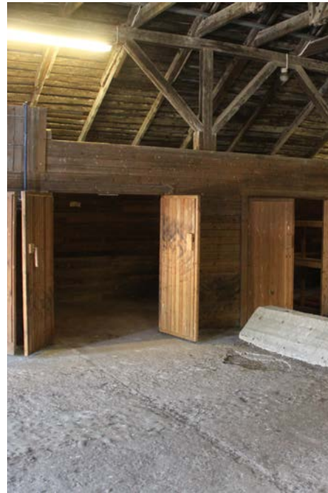
Vanhan osan ullakolla on varastoja. Lattia on valettu betonista
