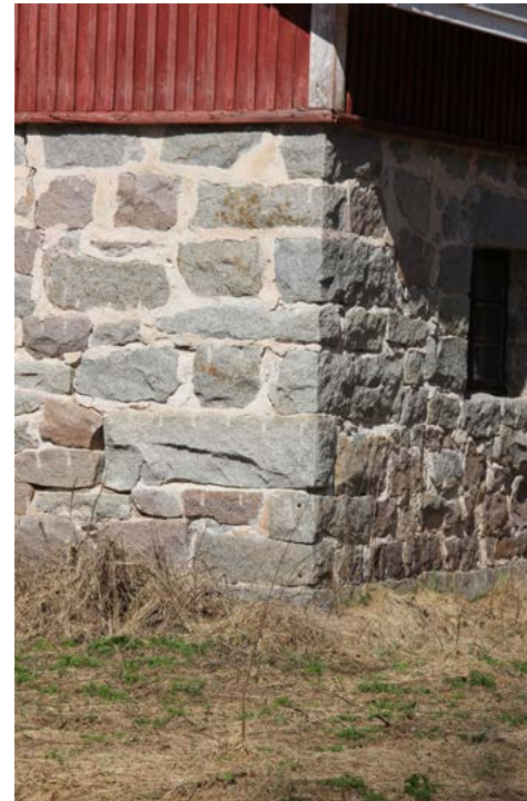
Lähikuva tallin kiviseinän ulkonurkasta.
