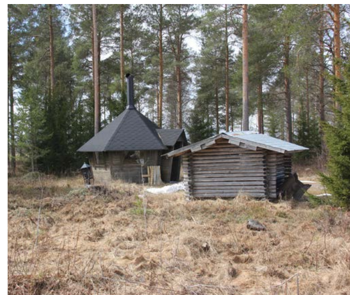
Henkilökunnan käyttöön rakennettu kota tarjosi myös vankiryhmille tilaisuuden irtautua karusta vankilamiljööstä. Kota ja liiteri sijoitettiin helposti saavutettavaan ja valvottavaan paikkaan vankilan etupihalle.
