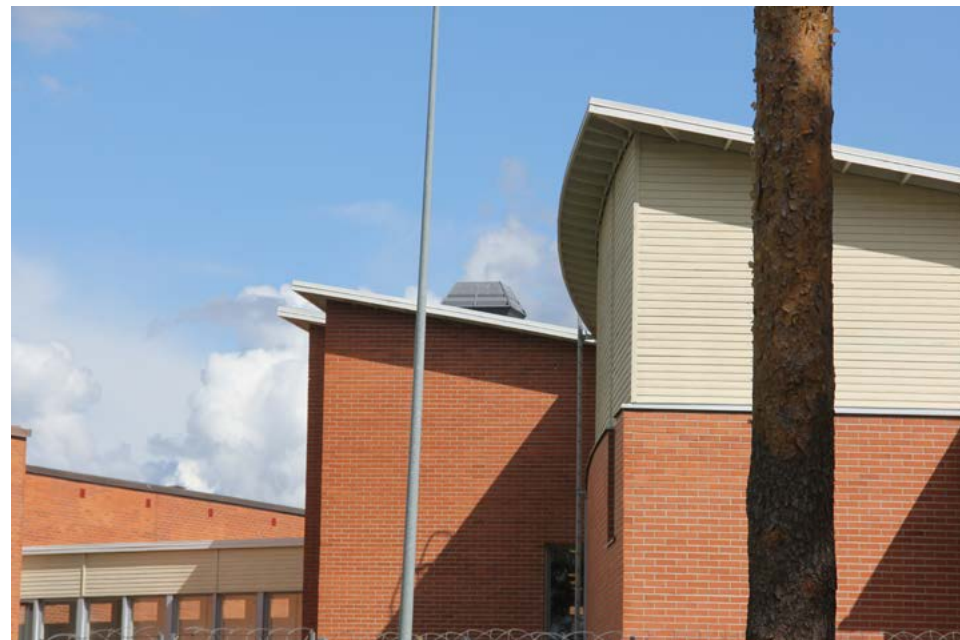
Pulpettikaton avoräystä hallintotalon eteläpäädyssä.
