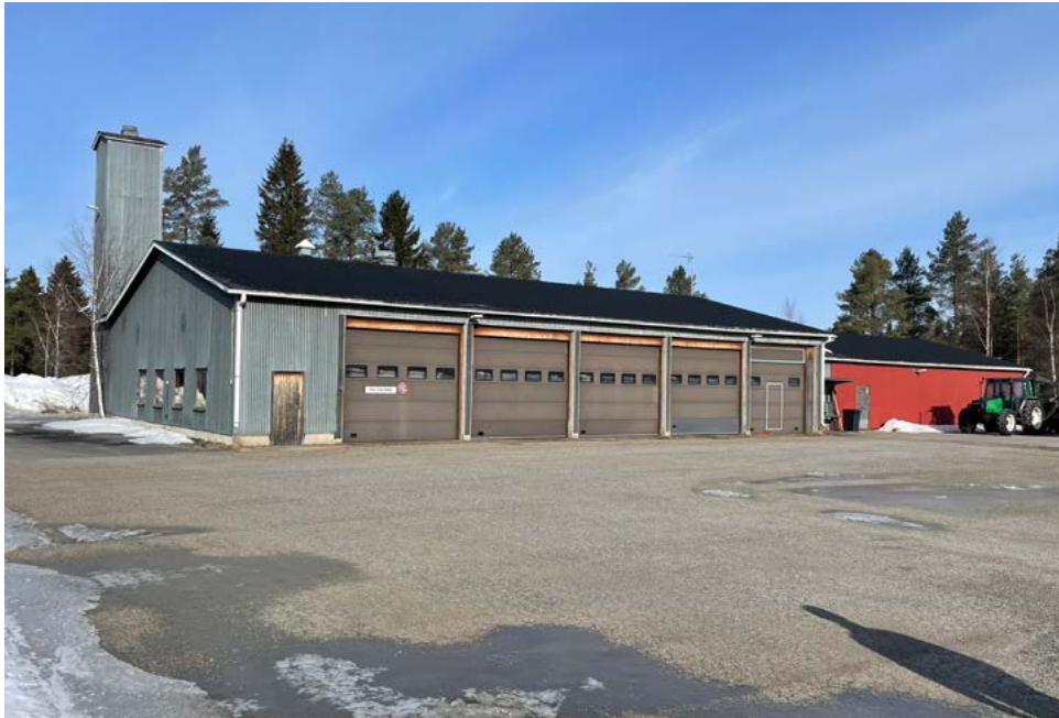
Autotallirakennus edestä Linnantien yli nähtynä. Autotallin etujulkisivussa on viisi nosto-ovea. Oikealla näkyvän punaisen traktoritallin etujulkisivussa on vain käyntiovi.
