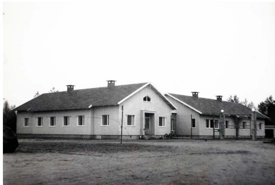
Näkymä vankilan pihalta kohti vuonna 1958 valmistunutta hallintorakennusta. Rakennus sijaitsi puolittain aidan sisäpuolella. KUVA: Kansallisarkisto Ude 1.1 VAHO
