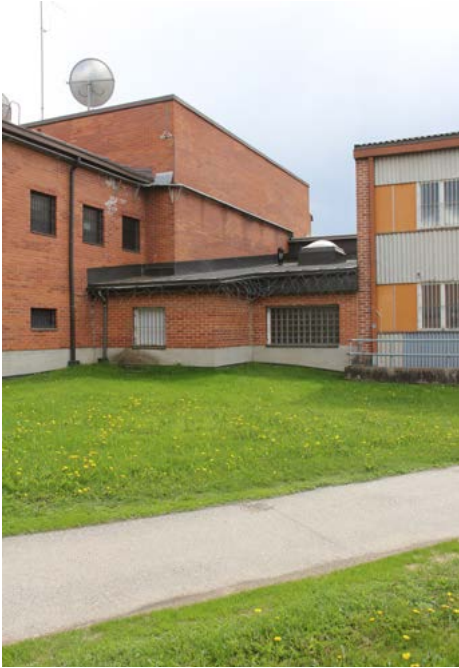
Vankiosasto 1:n yksikerroksinen yhdyskäytävä liittyy keskusrakennuksen eteläosaan.
