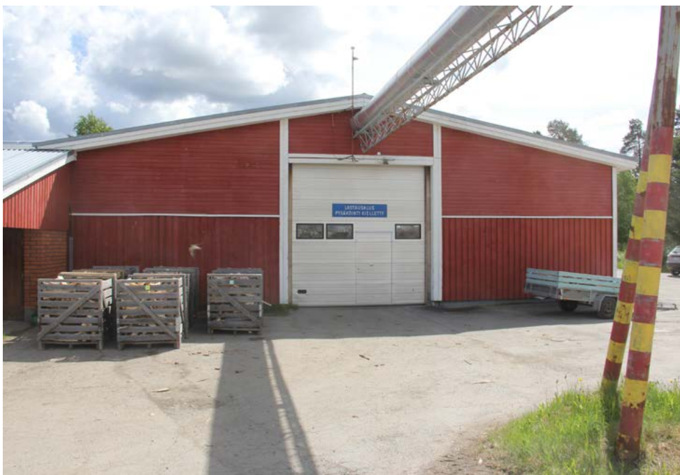
Puutyöhallin itäpääty Linnantieltä nähtynä. Valmiit tuotteet toimitettiin ulos suuresta nosto-ovesta. Etualalla on aluelämpökeskuksesta tuleva lämpökanava.
