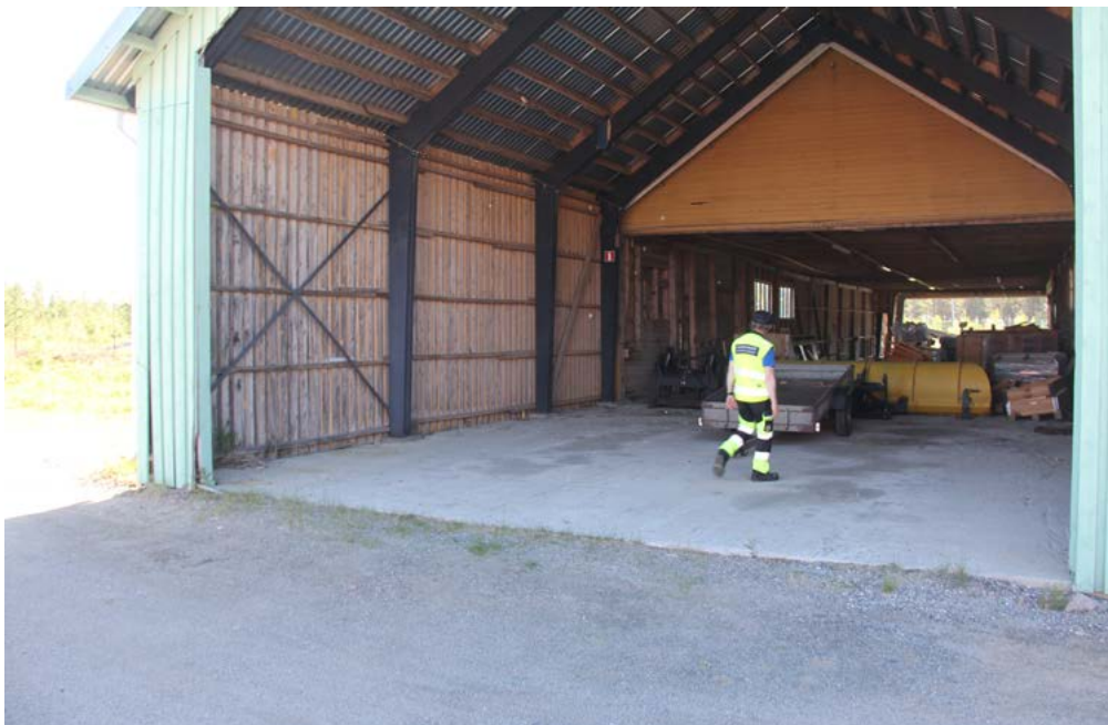
Saharakennuksen länsipäädyn paketointihalli on 1980-luvulla tehty laajennusosa. Hallin runko muodostuu korkeista teräskehistä. Hallin perällä näkyy alkuperäisen saharakennuksen keltainen pääty.
