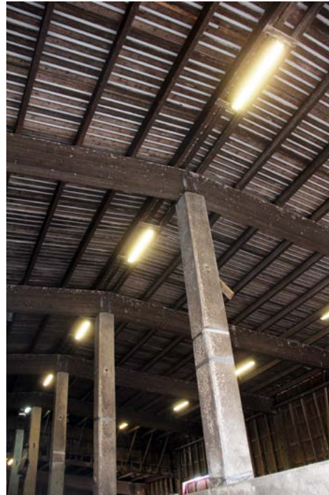
Rehuvaraston runko on rakennettu betoni-pilareista ja liimapuupalkeista. Vesikatto on eristämätön.
