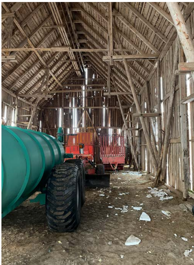
Ladon sisäpuolen lattiarakenteet on purettu, kun ladosta on tehty konesuoja. Harjalinjan vinssirakenteet ovat säilyneet.
