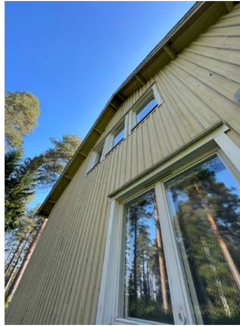
Ikkunat on uusittu alkuperäistä puitejakoa mu- kaillen. Vesikatossa on avoräystäät.
