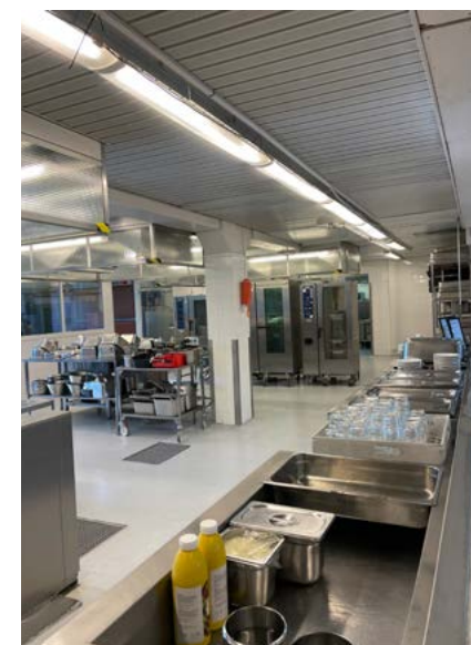
Alakatossa on perforoitu metallikasetointi.
