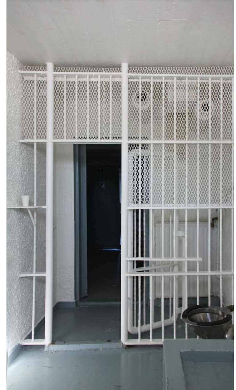
Vankat kalterit erottavat vangin tilan eristyssellin ovesta. Juoma ja ateriat tarjotaan vasemmalla näkyvälle tasolle.
