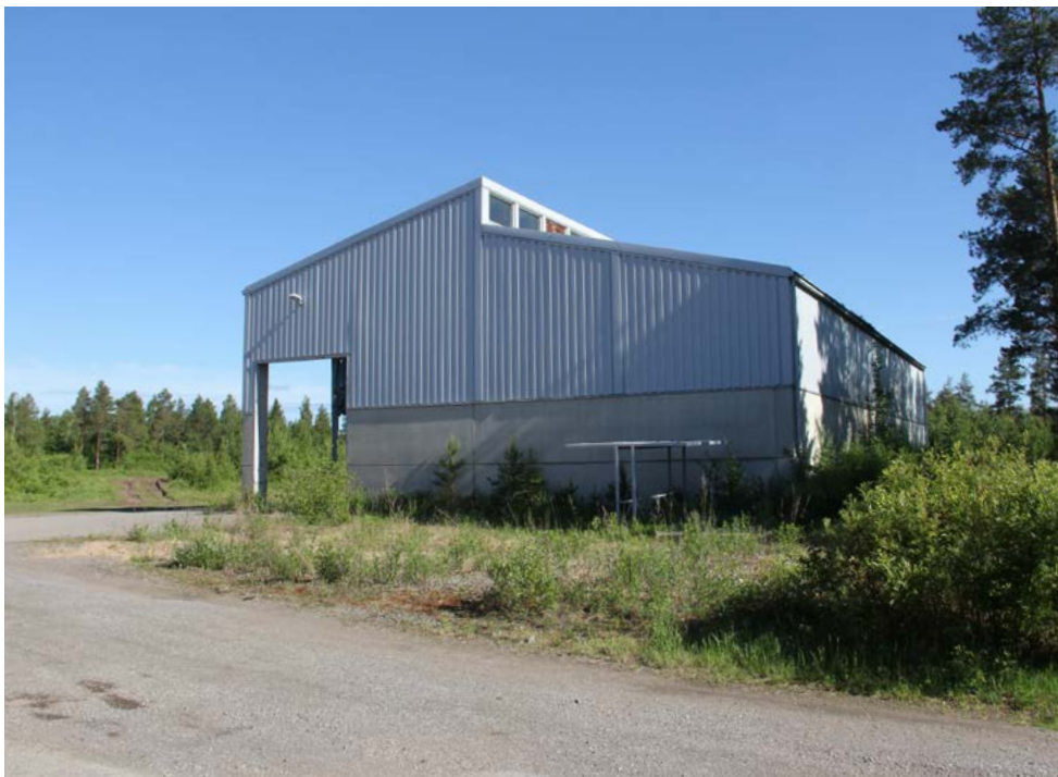
Hakevaraston eteläpääty lämpökeskuksen suuntaan. Rakennuksessa on korkea betonisokkeli ja katkaistu hajakatto, josta varasto syvärunkoinen varasto saa luonnonvaloa.
