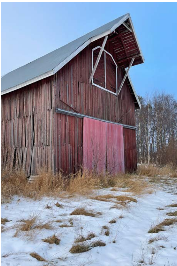
Sadan tonnin ladon pääty Pirunsaaresta. Ylhäälle sijoitetun täyttöoven alle on lisätty uudet peltiset liukuovet.
