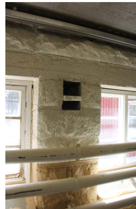
Navetan kiviseinää sisäpuolelta. Ikkunan edessä on putkipatterit.
