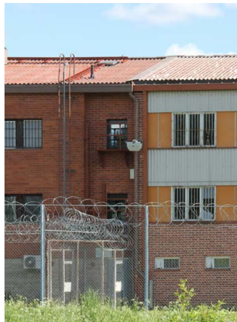
Kahden rakennusvaiheen liittymäkohta eteläjulkisivulla.
