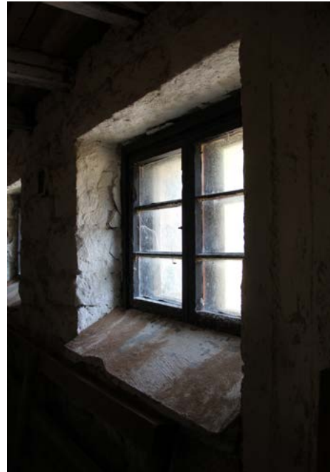
Alkuperäinen ikkuna kivimuurissa. Kuva on otettu tallin sisäpuolelta.
