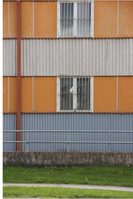
Vanhan osan julkisivu on verhoiltu nauhamaisesti kahdella erivärisellä kuitusementtilevyllä. Ikkunat on sijoitettu tasavälein.
