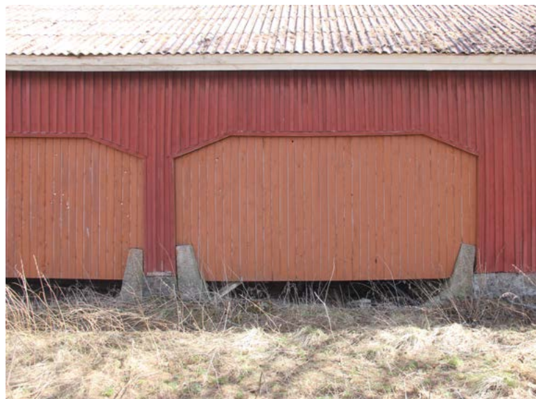
Takajulkisivun oviaukot on laudoitettu umpeen.
