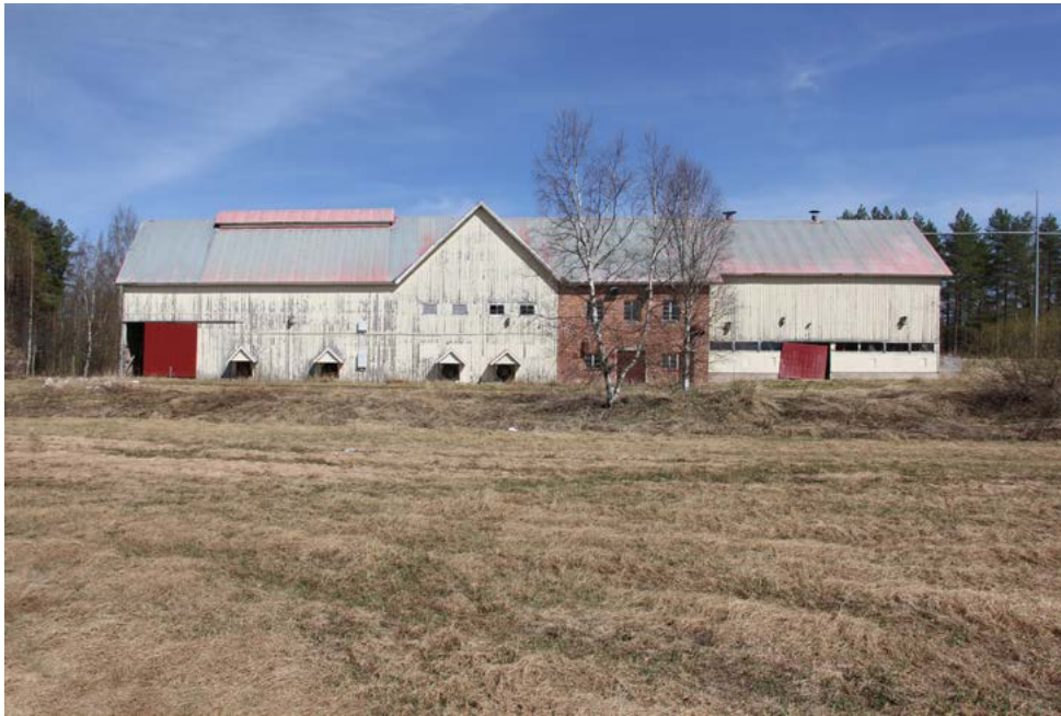
Vaiheittain rakennetun puimalan jukisivu etelään. Katolla näkyvä kohouma on latokuivaamon ilmanpoistoaukko. Keskirisaliitin oikealla puolella on tiilirunkoinen mylly.
