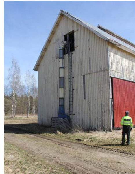
Puimalan itäpäässä on kuivaamo. Se voidaan täyttää kuvassa näkyvän putken kautta.
