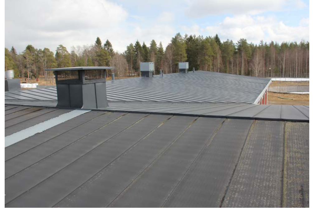
Lampolassa on loivaharjainen satulakatto, joka on katettu uritetulla peltikasetilla. Itäsiiven peltikattoa on osin uusittu 2000-luvulla.
