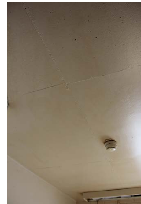
Sileävalettu betonikatto. Jokaisessa sellissä on paloilmaisin.
