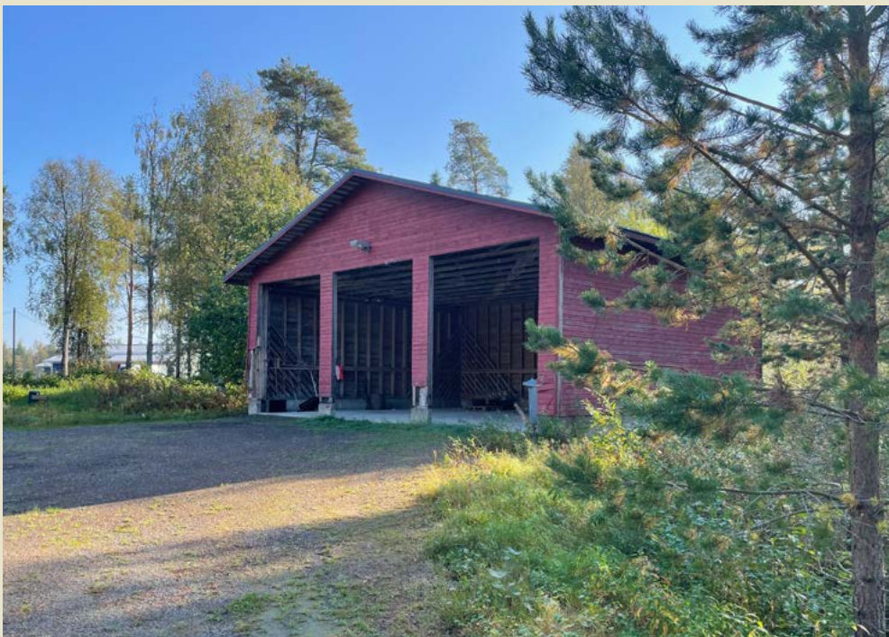
Jätekeskus Linnantien suunnasta saavuttaessa. Oviaukkojen edessä on suurelle ajoneuvolle mitoitettu kääntöpaikka.
