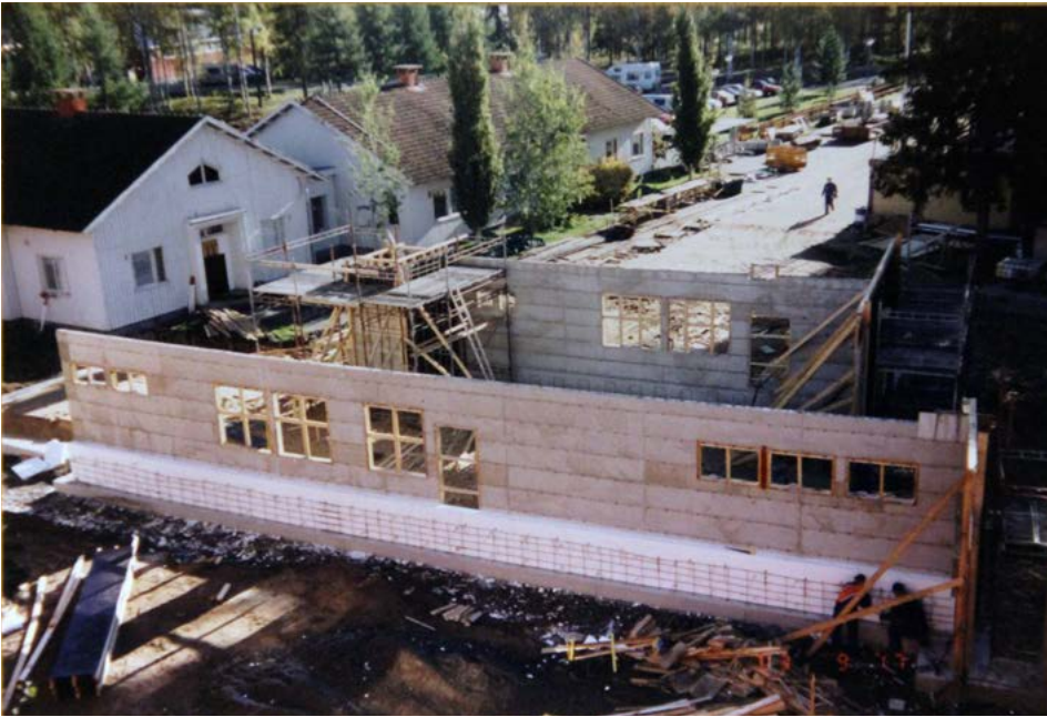
Hallintotalon rakennustyömaa 17.9.2003 keskusrakennuksen katolta kuvattuna. Rakennuksen pohjoispääty koottiin keveistä seinäelementeistä. KUVA: Pelson vankilan arkisto
