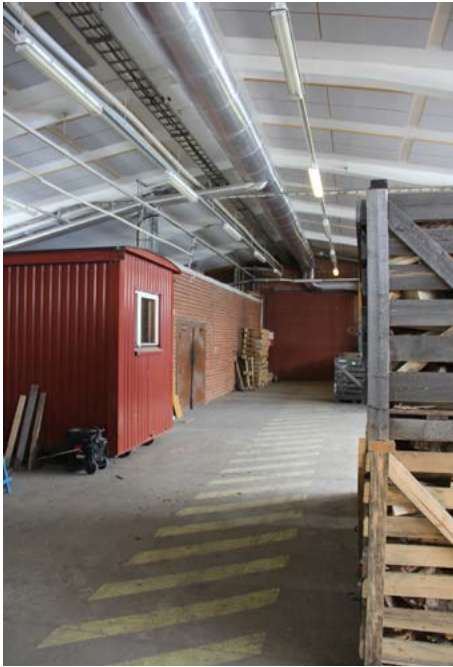
Hallin itäpäädyssä on tiilirakenteinen maalaa-mo. Vasemmalla on työmaakoppi.
