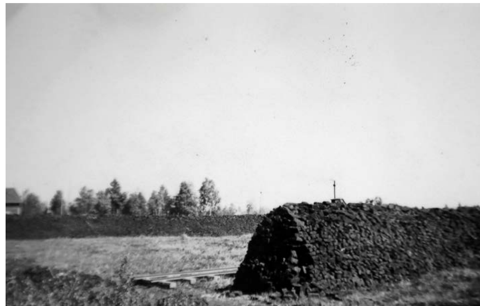
Turve kuivattiin nostokentällä. Se koottiin ensin kasoihin ja sitten kuvassa näkyviin aumoihin, joista se kuljetettiin talvella käyttöpaikoille KUVA: Kansallisarkisto Ude 1.1 VAHO
