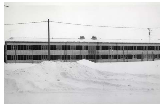
Osasto 2:n julkisivu pohjoiseen. Rakennukseen tehtiin yhden hengen sellejä, joita Pelsossa ei aiemmin ollut. KUVA: Kansallisarkisto Ude 1.2 kuvaaja Riku Virtanen
