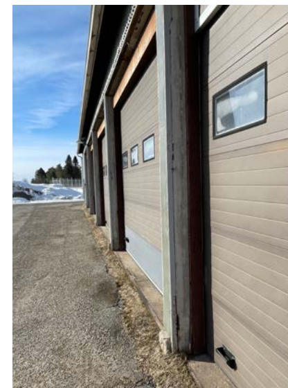
OIKEALLA: Autohallin etujulkisivun nosto-ovet.
