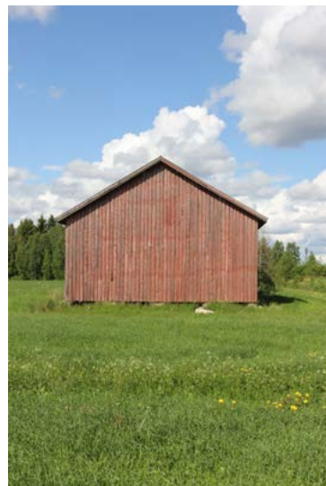
60 tonnin lato päädystä.
