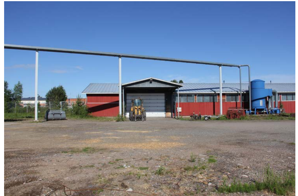
Puuteollisuushallin laajennus yhdisti tilat viereiseen puutyöhalliin. Hallin takajulkisivulla on katoksella suojattu korkea nosto-ovi. Oikealla on purumuri, josta lähtee kuljetin viereiseen purusiilon.
