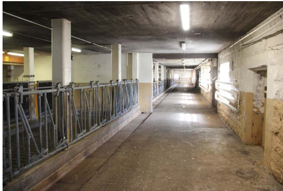
Navetan ruokintakäytävä. Kivipintaisilla ulkoseinillä on pitkät vesikiertoiset putkipatterit.
