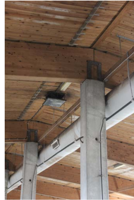
Lampolan keskelle sijoitetut betonipilarit kannattelevat poikittaasia liimapuupalkkeja.
