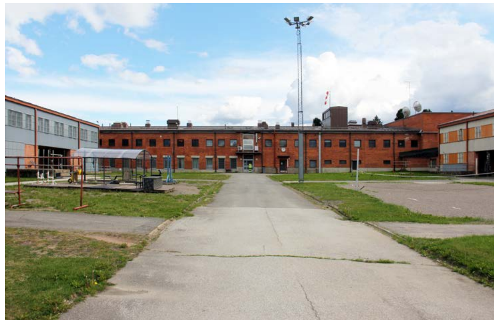
Näkymä vankien ulkoilupihalta kohti keskusrakennuksen länsijulkisivua. Keskusrakennuksella yhdistettiin kaksi erillistä 1960-luvun vankilasiipeä.
