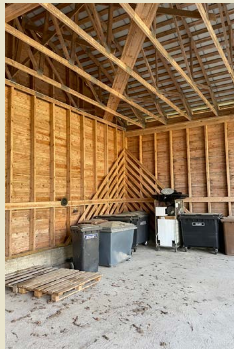
Jätekatos on korkea ja ylös asti avoin tila. Lattiana on betonilaatta.
