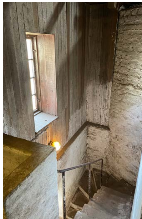
Siilon kupeessa on betonista valettu porras-huone. Kuva on otettu ylätasanteelta.
