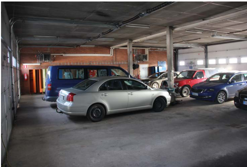
Autotalli on läpiajettava puolilämmin tila, jossa on betonirunko. Rakennuksen osat on osastoitu tiilimuureilla.
