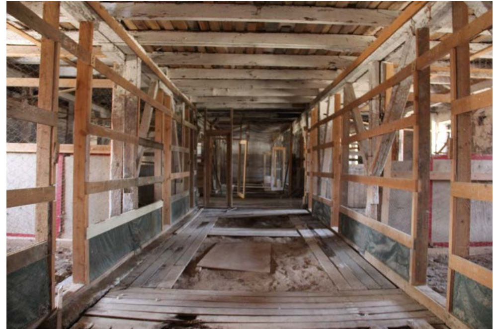
Tallin eteläpääty on toiminut ensin sonninaavettana ja myöhemmin siipikarjan kasvattamona. Betonilattiat on purettu ja käytävälle on tehty sivuseinäärakenteita.
