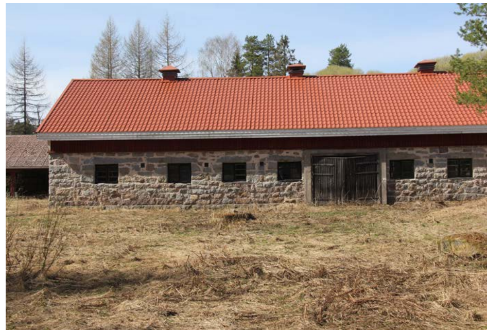
Hevostallin takajulkisivu itään.
