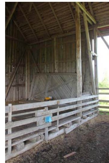
Ladon päädyissä on tuulettuvat lattiarakenteet.
