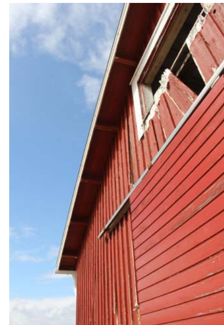
Rakennuksen julkisivu ja räystääs.
