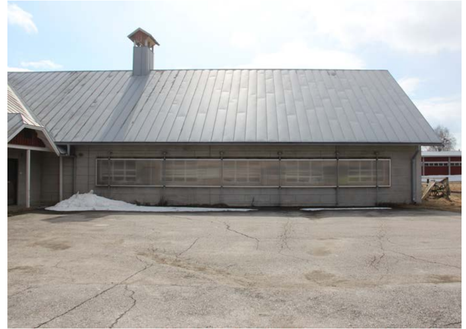
Pihatön julkisivu pohjoiseen.
