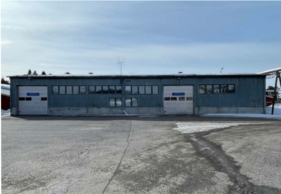
Keskusvaraston etujulkisivu pohjoiseen. Rakennuksessa on vankilan teollisuusrakennusten alkuperäinen peltijulkisivu, jota ei ole lautaverhoiltu muiden hallien tavoin.
