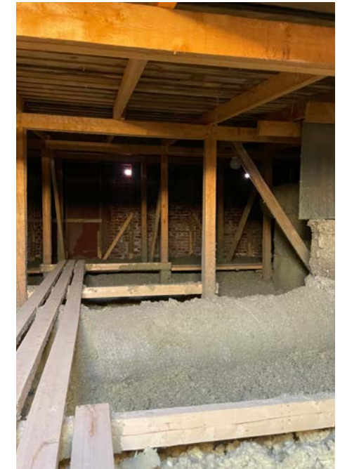
Tuulettuvalle ullakolle on lisätty puhallettavaa eristettä. Kulkutiet on tehty lankuista.
