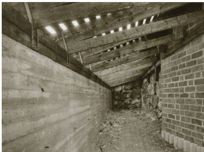
Suojamuurin ja -katoksen väliin jäi tyhjä tila. Kuvassa oikealla on danskeritornin tiilirakenteinen suojamuri. Kuva vuodelta 1984, MVA RHOHL8867.
