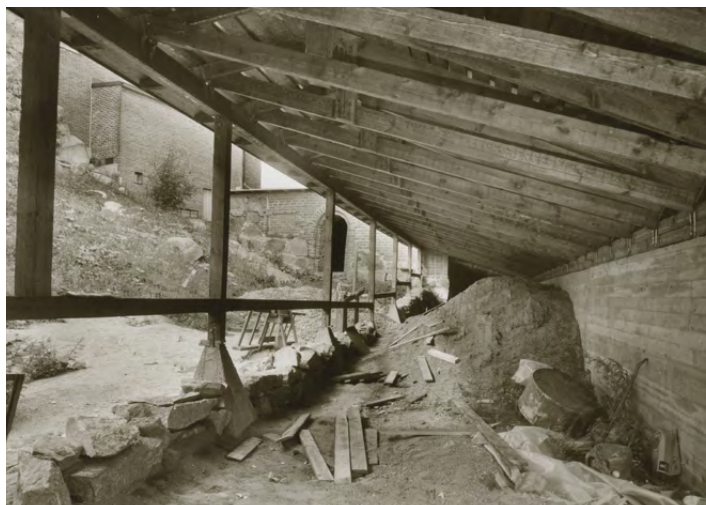
Kehämuurin suojakatteen puurakenteet tehtiin esilinnan pihan puolella betoniperustusten varaan. Suojarakenteen sisätilaa käytetään tiilivarastona. Valokuva vuodelta 1984, MVA RHOHL8866.
