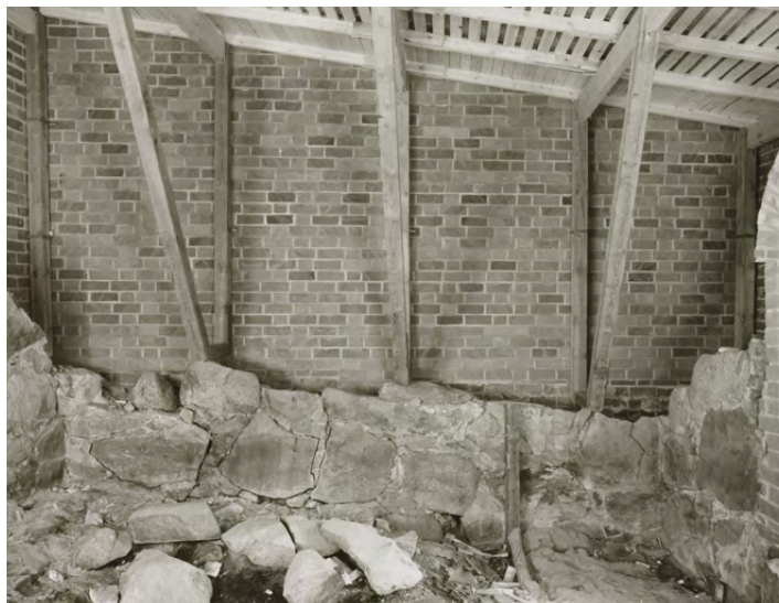
Kehämuuritornin puiset kattorakenteet on tuettu kivimuuriin. Sen taustalla on keskiaikaista kehämuuria jäljittelevä tiilimuuri. Valokuva vuodelta 1984, MVA RHOHL8856.
