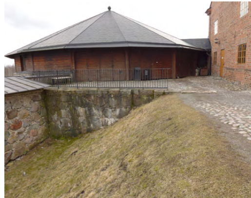
Kehämuuritornin luoteisseinää täydennettiin kivimuurauksella. Torni täytettiin maalla ja sen päälle tehtiin pihakiveys. Sen seinämuurien paikat merkittiin pihakiveykseen lohkoilla kivillä.
