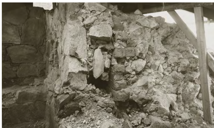
Luoteisseinän ampuma-aukon kohdalta näkyy valumuurirakenne. Vasemmalla kehämuuritornin seinän kuorikivien ja kehämuurin tiilimuurauksen välissä on laastista sekä kivistä ja tiilen paloista valettu osa. Kehämuurin kuoriosan tiilimuuraus jatkuu paksuna valumuurina kuvan oikeassa laidassa. Kuva vuodelta 1982, MVA RHOHL8051.
