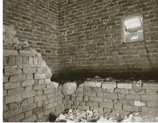
Danskeritornin suojamuuri kätkee sisäänsä alkuperäiset tiilimuurit. Valokuva vuodelta 1984. MVA RHOHL8862.
