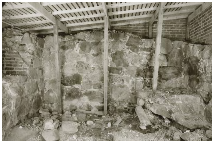
Kehämuuritornin länsikulmassa oli säilynyt tulisijan jäännökset. Kuvan vasemmassa laidassa on tiilipielinen ikkuna-aukko. Valokuva vuodelta 1962, MVA RHOHL8858.
