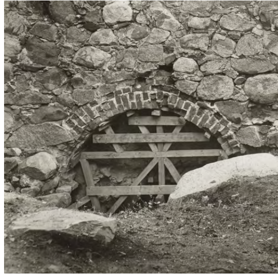
Kehämuuriin oli tehty tiilestä holvattu aukko, jonka kautta esilinnan pihan pintavedet johdettiin rantaan. P. O. Welin 1980, MVA RHOHL7584.
