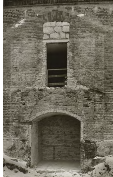
Huoneen 149 alla on 1840-luvulla rakennettu pieni tiilikellari. Kellarin edustalta purettiin porrashuone ja kellarin lounaisseinä muurattiin umpeen tiilillä. Kuva vuodelta 1978, MVA RHOHL8294.
