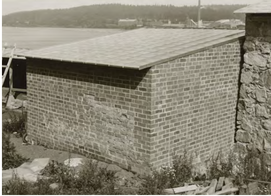
Danskeritornin konservointi valmistui vuonna 1984. Säilyneiden muurien ympärille tehtiin tiilinen suojamuuraus ja torni sai pulpettikaton. MVA RHOHL8861.
