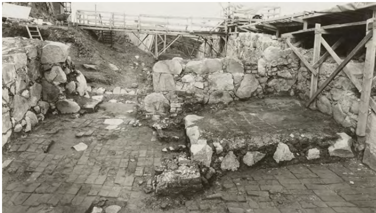
Itäinen kehämuuritorni sijaitsee keskiaikaisen kehämuurin ja 1550-luvulla rakennetun tykkitornin välissä. Esilinnan pihalta, tornin edustalta, löytyi kivikoulu, jonka kautta vedet on ohjattu pois. Tornihuoneessa oviaukon vieressä on suuri, nelikulmainen tulisija, jonka eteläkulmassa on huoneen keskellä tiilipilari. Valokuvat vuodelta 1980, MVA RHOHL7653 ja RHOHL7654.
