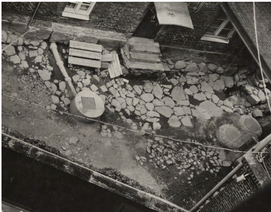
Porttitornirakennuksen edustalta paljastui vuonna 1969 laattamaisista kivistä tehtyä pihakiveystä, joka oli tehty ennen 1700-lukua. Laattakiveystä nuorempaa mukulakiveystä on esillä kuvan etualalla. Portin kohdalla tuli esiin keskiaikaisen kehämuurin kiviperustuksia. MVA RHOHL3293.
