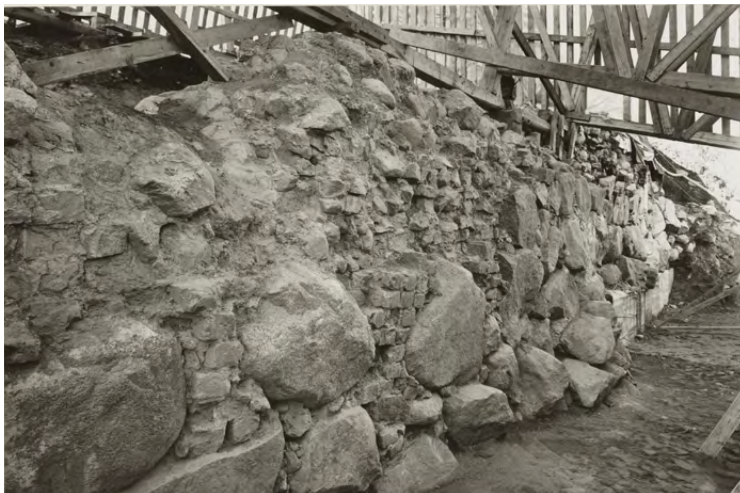
Kehämuuriin oli tehty tiilestä holvattu aukko, jonka kautta esilinnan pihan pintavedet johdettiin rantaan. P. O. Welin 1980, MVA RHOHL7584.
