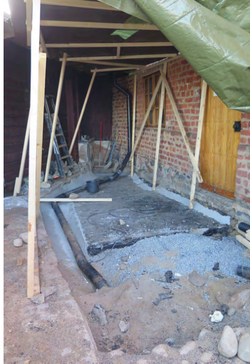
Tykkitornin edustan sadevedet johdettiin vuonna 2019 eteistilan betonikannen ja kiveyksen välistä vanhaan sadevesikaivoon. Kiveys palautettiin entiselleen.
