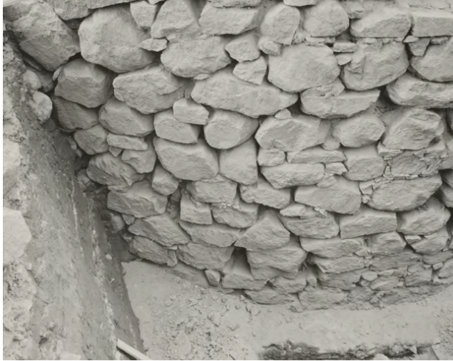
Alkuperäistä tykkitornin muuria on säilynyt puolibastionin maavallin takana. Muurin suuret kivet oli ladottu riveihin ja niiden välit oli kiilattu pienillä kivillä. Kuva vuodelta 1960. MVA RHOHL1587.
