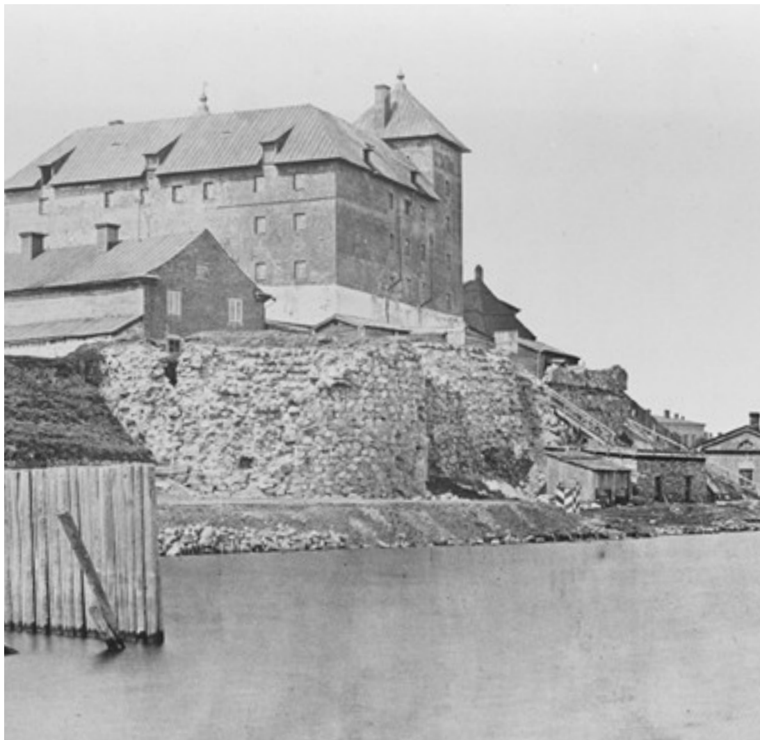
Vasemmanpuoleisessa vuoden 1869 kuvassa näkyy huonokuntoisen tykkitornin sortunutta ja halkeillutta muuria. 1800-luvun lopulla muurit tuettiin tiilirakenteisilla kontreforeilla ja alaosan muurit kivillä, jotka peitettiin vielä hiekalla. Nämä rakenteet purettiin vasta 1950-luvun lopulla. MVA 1869, RHOHL124733 ja MVA 1957, RHOHL853.
