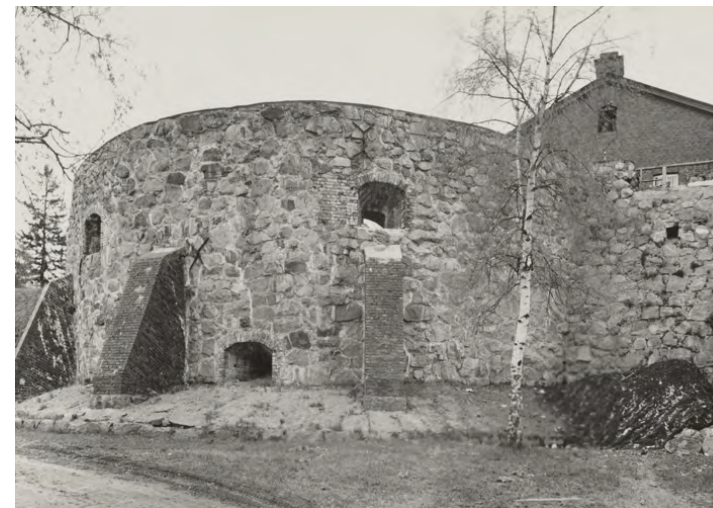
Vasemmanpuoleisessa vuoden 1869 kuvassa näkyy huonokuntoisen tykkitornin sortunutta ja halkeillutta muuria. 1800-luvun lopulla muurit tuettiin tiilirakenteisilla kontreforeilla ja alaosan muurit kivillä, jotka peitettiin vielä hiekalla. Nämä rakenteet purettiin vasta 1950-luvun lopulla. MVA 1869, RHOHL124733 ja MVA 1957, RHOHL853.
