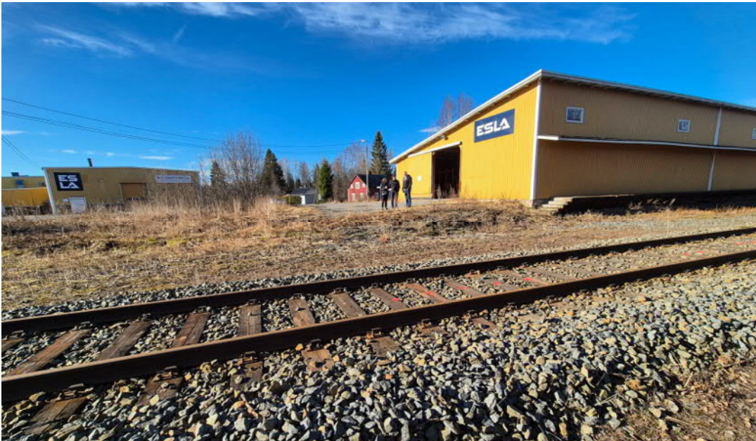
Kuva 9. Kylmävarasto raiteen pohjoispuolelta kuvattuna.
