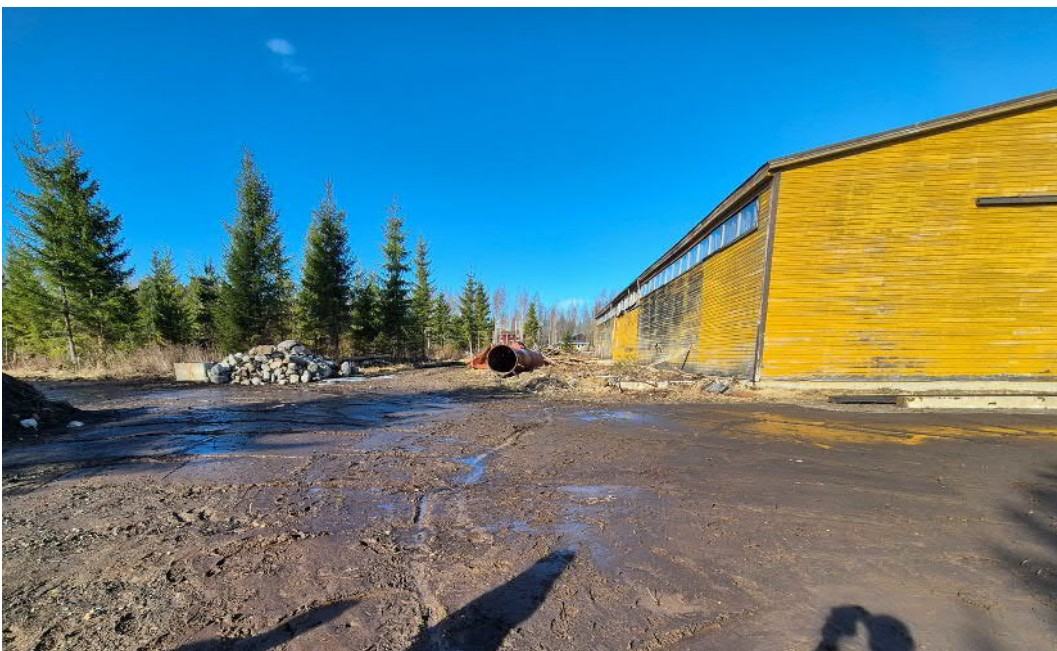
Kuva 10. Entinen saha-alue. Sahan alueen nykyinen omistaja on tehnyt alueella maanrakennustöitä, mm. kaivanut ojia ja tehnyt tiepohjia.
