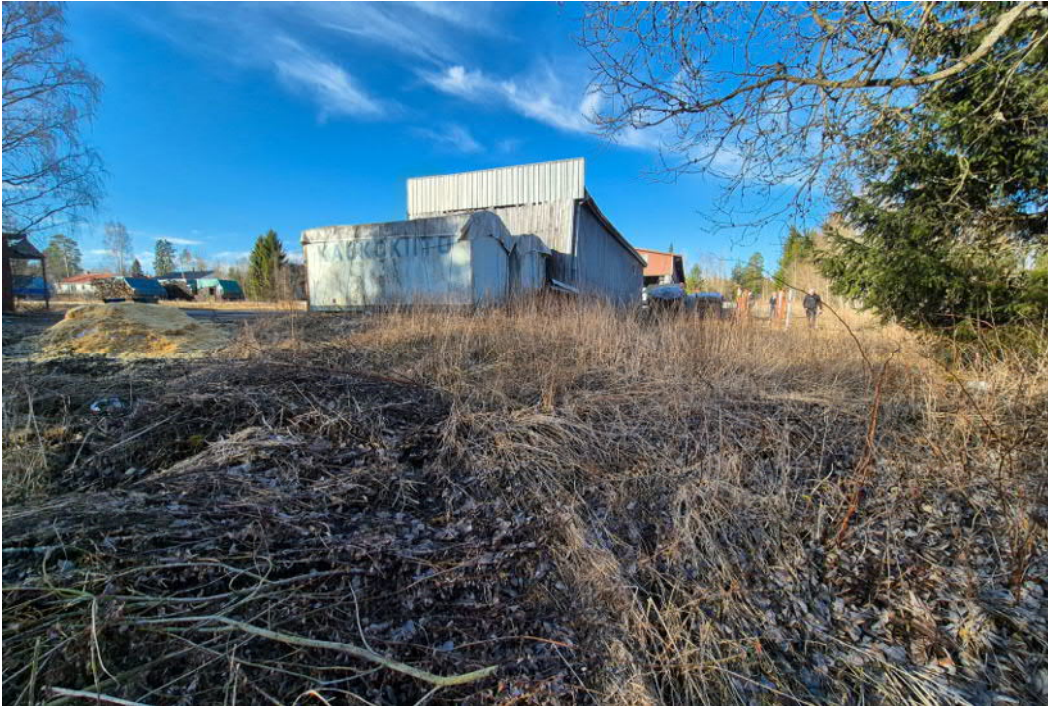
Kuva 5. Varastorakennus idän suunnasta kuvattuna. Ympäristössä ei havaittu romua tai muuta erityistä. Kaikki tilat ja varastot olivat siistejä ja hyvässä järjestyksessä.
