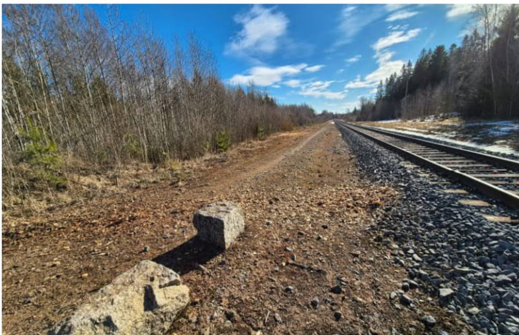
Kuva 14. Kuva itään päin. Radan varressa ei havaittu maanpinnalla jätteisyyttä.
