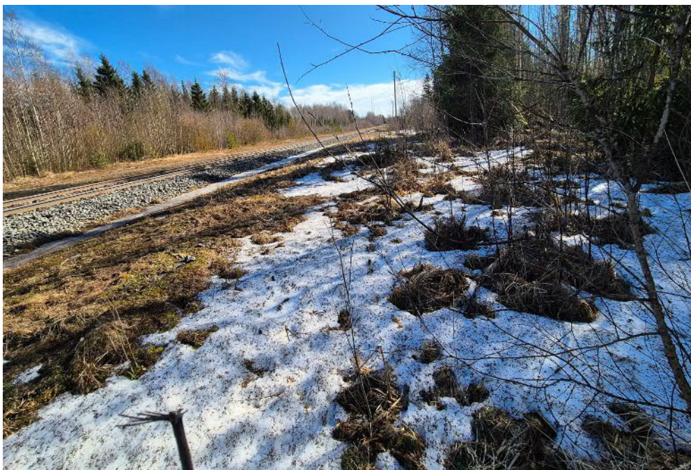
Kuva 24. Radan eteläpuoli kuvattuna itään päin.
