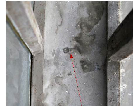
Etenkin porrashuoneiden ikkunoiden alla on nähtävissä peltisiä luukkuja, jotka liittyvät ikkunavälien hikivesijärjestelmään. Ikkunavälin alapinnassa on pieni reikä, josta kondensoitunut vesi kulkee astiaan. Yllä Nyströmin ikkunasuunnitelma nro 139, johon on piirretty vedenkeruujärjestelyn periaate. Piirustus (sinikopio) sijaitseevee kokoelmassa Kansallisarkiston arkistorakennuspiirustukset Ia, "Kalteripiirustuksia Valtionarkiston vanhasta tutkijasalista" (virheellisesti luetteloituna).
