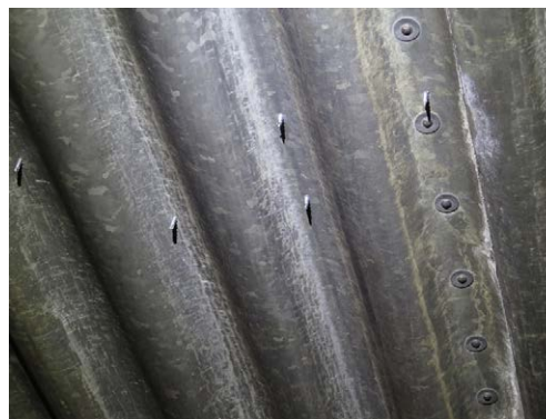
Uusien teräsrankojen poraruuvit näkyvät paikoin ullakon puolella ja lävistävät (luonnollisesti) vanhan 1890 aaltopeltikatteen.
