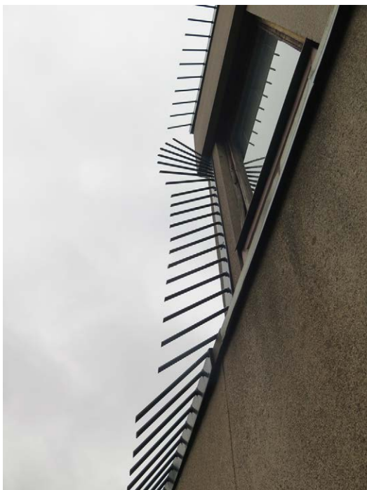
Luvattomalta rakennukseen tunketumiselta suojaamista on tehty myös Hanssonin 1994 suunnitelman jälkeen. Toimisto-osan länsijulkisivu on saanut silmäripset.
