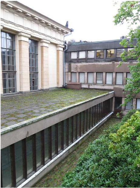
Hanssonin yksikerroksinen laajennus tutkijasalin edessä. Katolla on tiivis betonilaatoitus, mutta katolle ei ole pääsyä (kuin ikkunasta).
