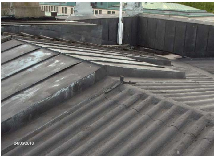
Aktimakasiinin lasikatteiset alueet käyvät selvästi ilmi Nyströmin suunnitelman heittovarjostuksesta. Kattoikkunat näkyvät myös vanhoissa ilmalokuvissa 1940-luvulle saakka. Alla kuva vuodelta 2010, ennen vesikaton kunnostustyötä. Konesaumattu peltikate on tehty kattoikkunan kohdalle 1950-luvulla. Kuva Keijo Kekoni, ISS Suunnittelupalvelut Oy, R574-01-04 SA.
