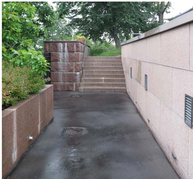
Laajennusosan graniittipinnat: istutusaltaassa ja portaassa puolihienoksi hakattua paksua sahattua harkkoa; tukimuurissa paksuhkoa lohkopintaista harkkoa; ulkoseinässä graniittilevyä.
