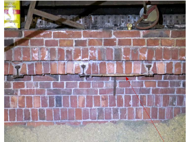
Nykytilakuva aktimaksiinin ullakolta, seinän räystäösosan muurauksesta, missä näkyvät ratakiskokannattajat ja niiden väliset 8 kiven kappaholvit. Yhteen holveista on jäänyt työaikainen (1888-89) puinen muuraustuiki.
