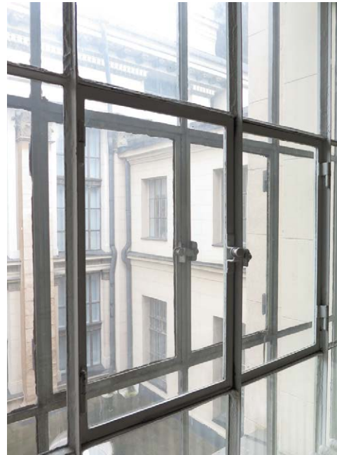
Laajennusosan tuuletusikkunat ovat parittaiset, kun Nyströmin osassa ne ovat yksittäiset.
