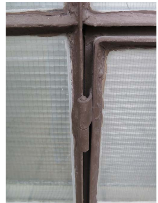
Laajennusosan profiilit ja helat ovat huomattavan ohuita, peltimäisiä, suhteessa Nyströmin valurautaisiin rakenteisiin.
