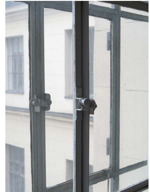
Laajennusosan profiilit ja helat ovat huomattavan ohuita, peltimäisiä, suhteessa Nyströmin valurautaisiin rakenteisiin.
