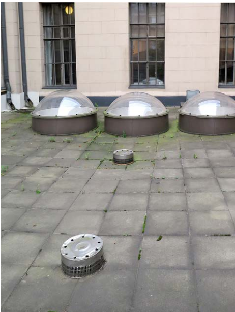
Hanssonin laajennusosa, luentosali, Nyströmin aktimaksiinin ja Schjerfbeckin makasiinin välissä. Katolle on kulku vain huoltoa varten, ulkotikasta pitkin. Edessä sadevesikaivo.
