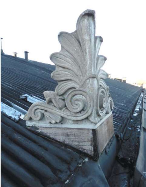
Pohjoispään akroterion, betonia
