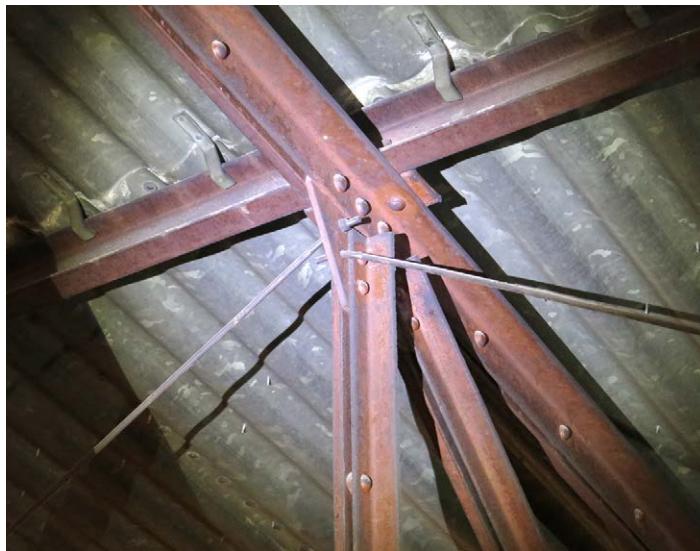
Nykytilakuvat aktimakasiinin ullakolta. Ullakon lämmöneristys on uusittu 2011, mutta muutoin rakenteet ovat alkuperäiset 1888-1890 ja mitä ilmeisimmin alkuperäisessä pintakäsittelyssä.
