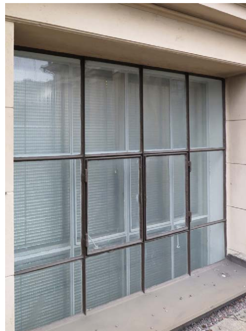
Laajennusosan tuuletusikkunat ovat parittaiset, kun Nyströmin osassa ne ovat yksittäiset.
