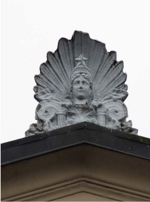
Pohjoispään akroterion, betonia
