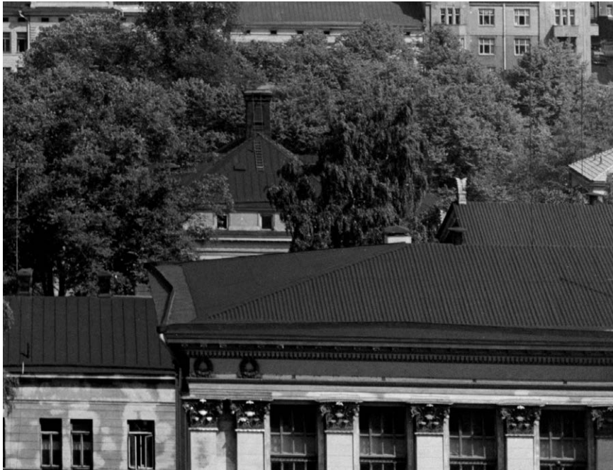
Volker von Boninin heinäkuussa 1960 ottamassa kuvassa vesikate esiintyy vasta kunnostettuna (HKM N509). Alla olevista ortokuvista voi havaita, että aktimakasiin keskialueella 1950 vaaleina täplinä erottuvat kattoikkunat ovat poissa vuoden 1964 kuvasta.
