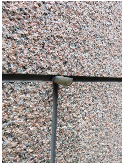
Kivilevyrakenteen tyypillinen yksityiskohta: muovinen tuuletusputki saumassa.
