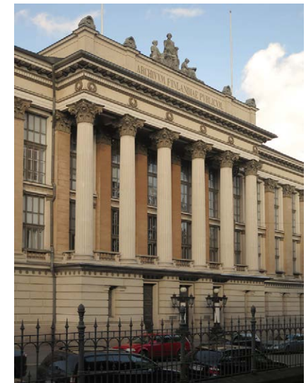
Nykytilanne, joka perustuu 1981 tehtyyn maalaus-kunnostukseen. Keskisaliin syöksytorven ylähaara poistettiin tiettävästi 1968-1972 laajennustyön yhteydessä, samalla kun pääsisäänkäynnin edustalle ennallistettiin valaisinylvät.
