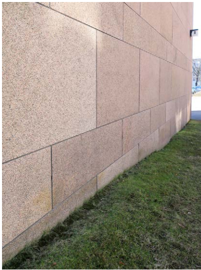
Graniittilevytykseen alkaa vailla sokkelia maan alta
