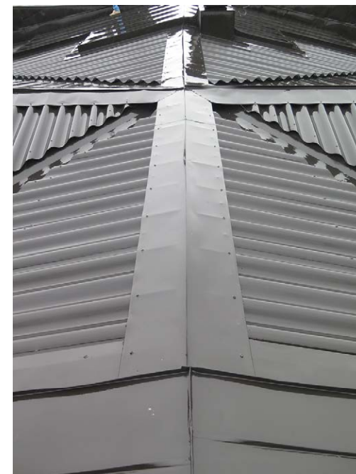
Uusien teräsrankojen poraruuvit näkyvät paikoin ullakon puolella ja lävistävät (luonnollisesti) vanhan 1890 aaltopeltikatteen.
