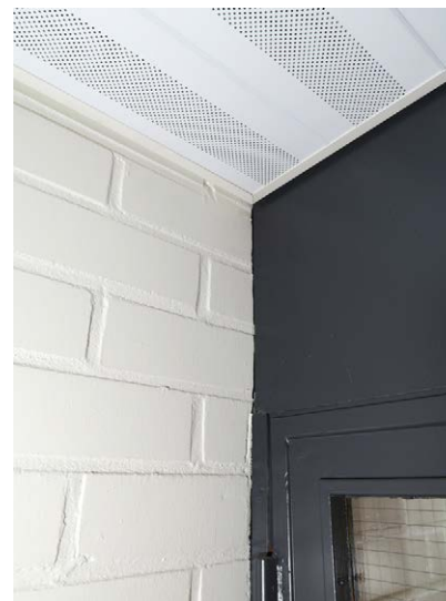
Käytävän materiaalipaletti: puhtaaksi muurattu maalattu tiili, Lautex-alakatto, osastoivat teräslasiovet.
