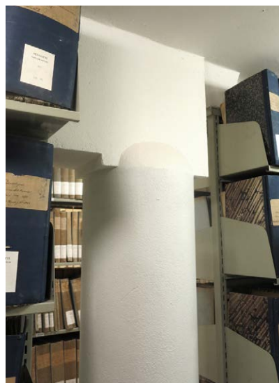
Vanhat yläpohjan rautapalkit ja niitä kannattelevat rautapylväät on oletettavasti valettu betoniin.
