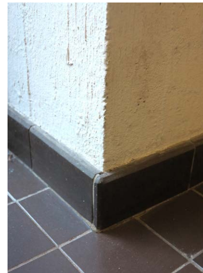
Seinän betonimuottipintainen tekstuuri on harkittu vaikkakin yleisilmeeltään epäsiisti.
