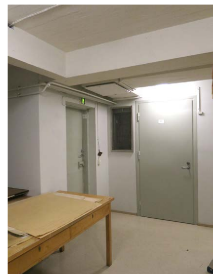
B-portaan ja jakokeskuksen harmaaksi maalatut peltiovet ovat oletettavasti pääsääntöisesti 1950-luvulta.
