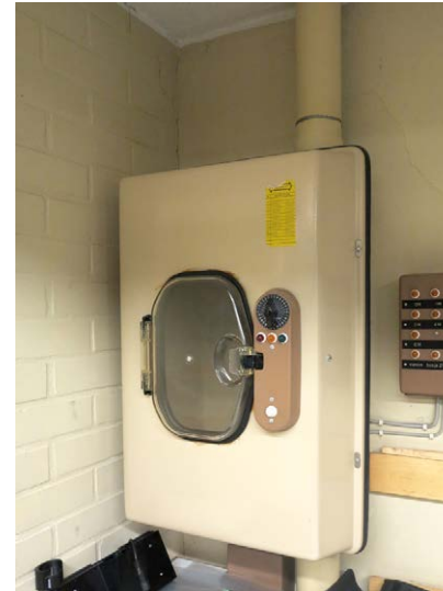
Putkipostijärjestelmä.
