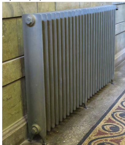
Vestibyylin valurautaradiaattori, ei alkuperäinen. Alkuperäinen vaihdettu tähän vasta Hanssonin peruskorjauksen yhteydessä 1970-luvulla.
