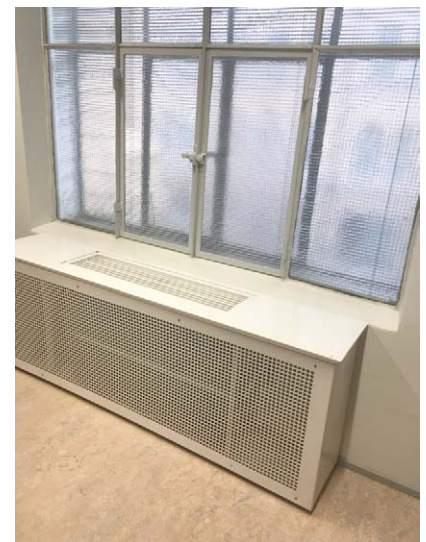
Kirjaston vanhoihin, rautakehyksisiin ikkunoihin ei ole asennettu alumiinikehyksisiä sisäikkunoita toisin kuin yläpuolella olevissa makasiineissa. Ikkunan edessä konvektorikotelo.
