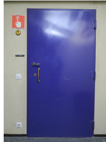
Porrashuoneiden makasiiniovat on maalattu tunnisteväreihin; 2.kerroksen violetiksi maalattu palo-ovi.
