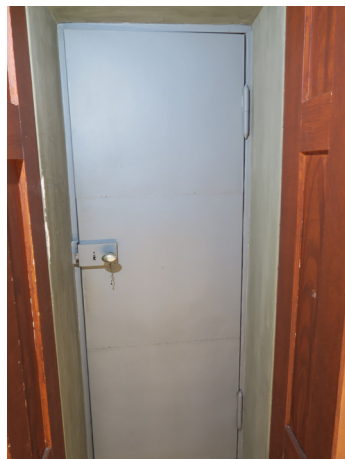
Ylälehterin virkailijakäytävän ylemmän kerrokseen johtava kapea peltiovi.
