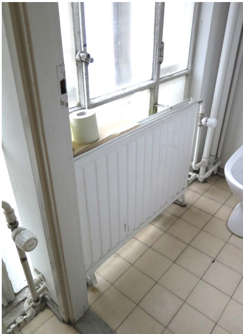
WC-tila. Ilmeisesti 1950-luvun levyradiaattori, joita on säilynyt vain satunnaisesti.
