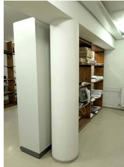
Vanha valurautapylväs on oletettavasti valettu betoniin.
