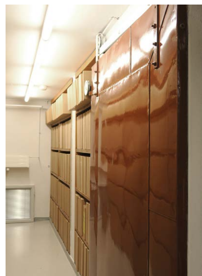
Uuden peltipalo-oven lisäksi makasiinissa on vuoden 1927 liukukiskoilla kulkeva palo-ovi.
