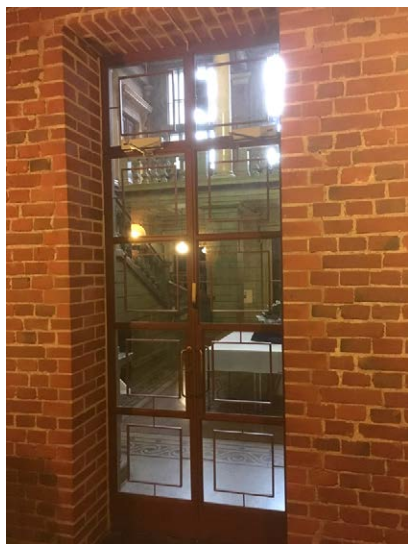
Vestibyyliin johtava ovi, puhkaistu Hanssonin vaiheessa.
