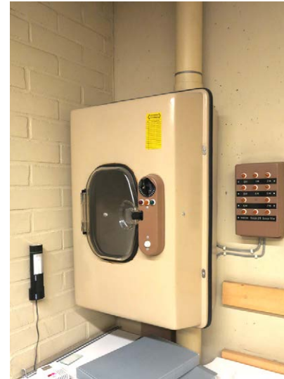
Putkipostijärjestelmä.
