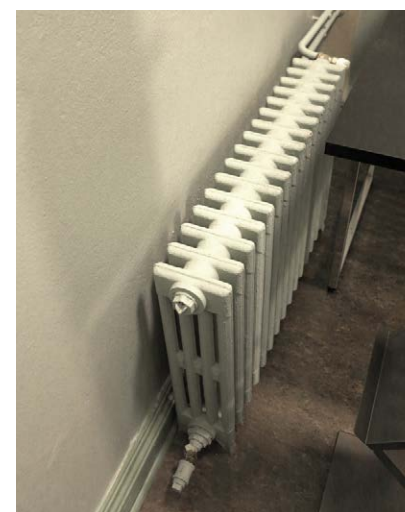
Tilassa on vanha, vaalean vihertäväksi maalattu valurautaradiaattori. Lattiassa linoleum; jalkalistana puuprofiili, edessä kapeampi puulista.
