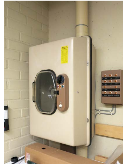
Putkipostijärjestelmä.
