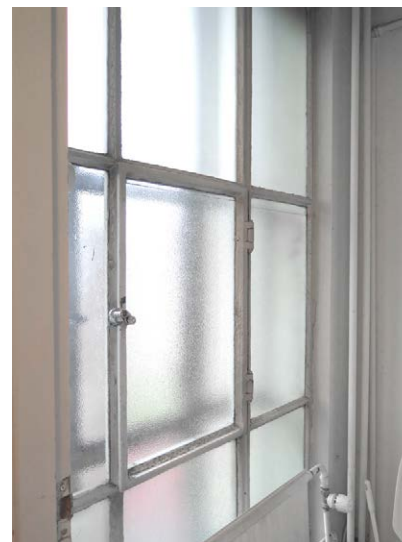
WC:n ikkunassa on kaksi erillistä rautakehystä. Sisäpuolen lasissa on himmennys.
