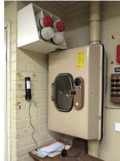
Putkipostijärjestelmä.
