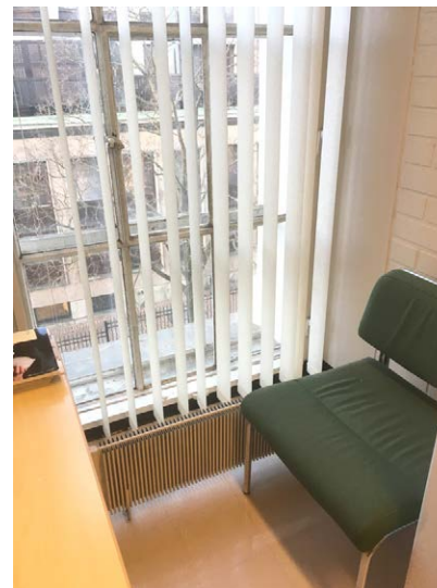
Käytävän päässä rautaikkunat; ikkunan edessä matala peltisäleradiaattori.
