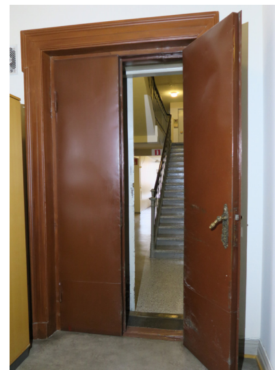
Työhuoneesta on käynti C-portaaseen kaksinkertaisen peltioven kautta. Makasiinin puoleinen on oletettavasti alkuperäinen, työhuoneen puoleinen viimeistään 1957-58; tai vanha ovi pellitetty. Vanha painike ja laakapeltiovi on erikoinen yhdistelmä.
