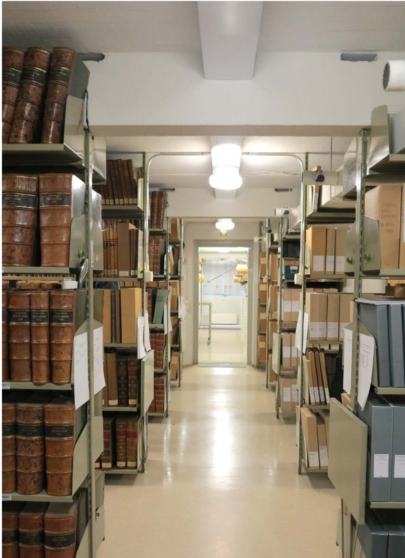
Nyströmin alkuperäinen makasiinitila on edelleen samassa käytössä, mutta avoimet rautarakenteet on muokattu paloturvallisiksi rautabetoni- ja teräsbetonirakenteiksi vuosien 1951-1957 välillä.
