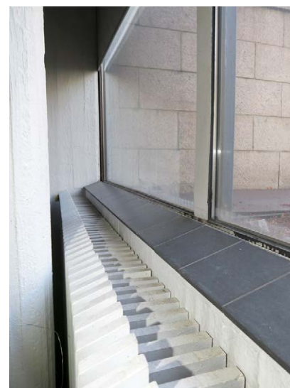
Ikkunapenkissä keraaminen laatta ja radiaattorin suojana maalattu puuritiä.
