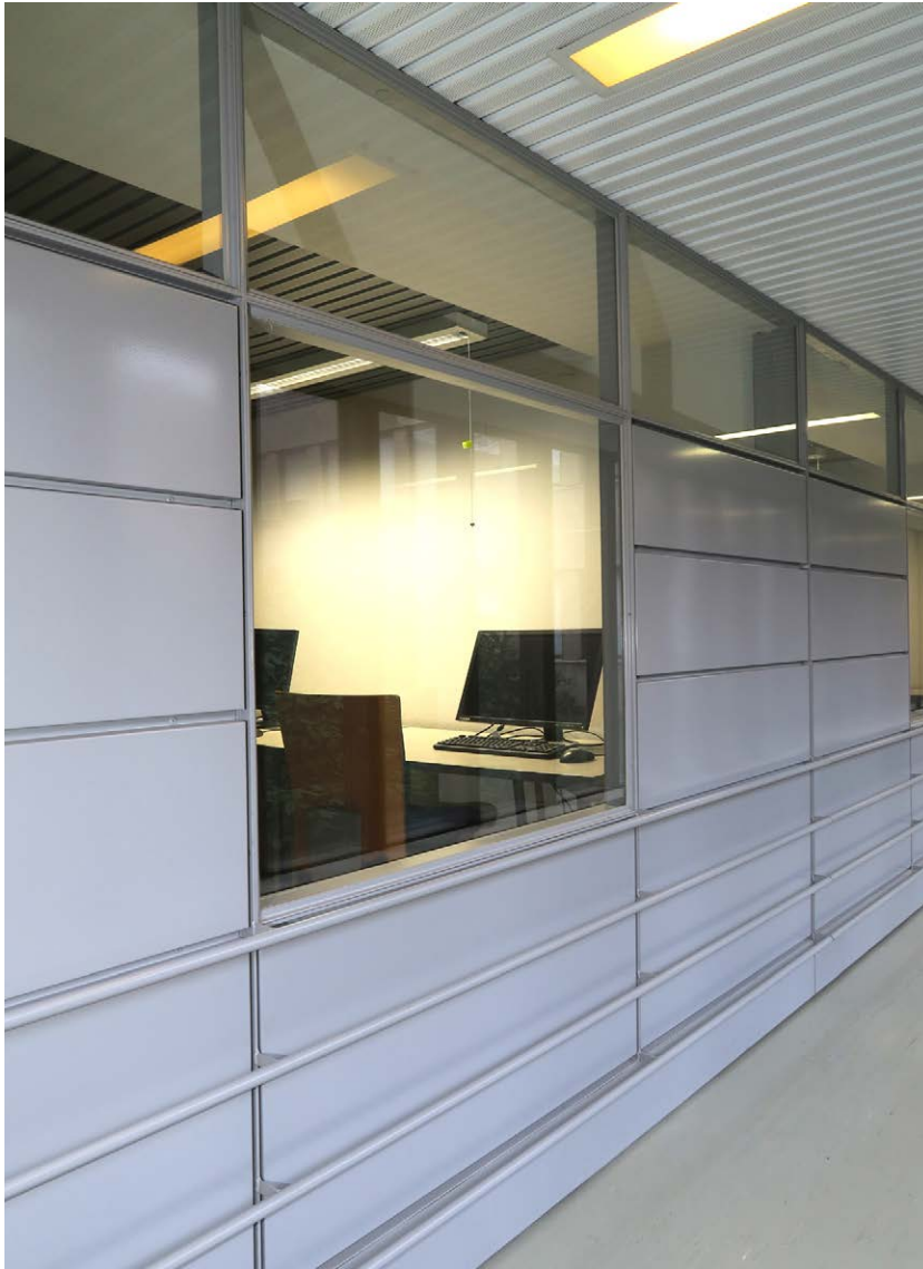
Tutkijahuoneiden uudempi metallikasettijulkisivu käytävän 6.247 puolelta katsottuna.
