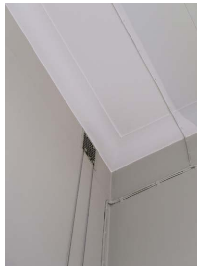
Katonrajassa vanha poistoräppänä.
