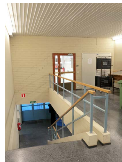
Porraskäytävän 3. kerroksessa on lastauslaituri; ylemmässä kerroksessa konservointitilat.
