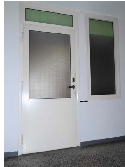
Sisäänkäynti D-portaasta; valkoinen laakaovi, yläosassa lankalasi.
