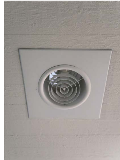
Kulkusillan katto on lautamuottipintaista betonivalua. Valaisin on oletettavasti 1991 muutostyöstä. 1968 Sähkösuunnitelmissa SLOY 2030/20 -valaisimet.
