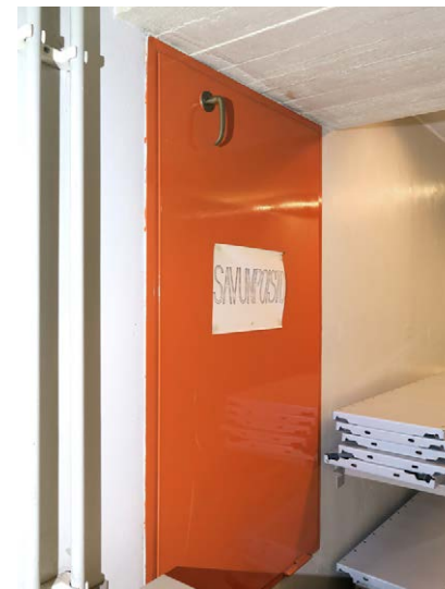
Savunpoistoluukku ulkoseinällä.
