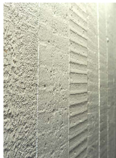
Makasiinin seinissä lautamuottipintainen betonivalu; maalattu vaalean kellertäväksi.
