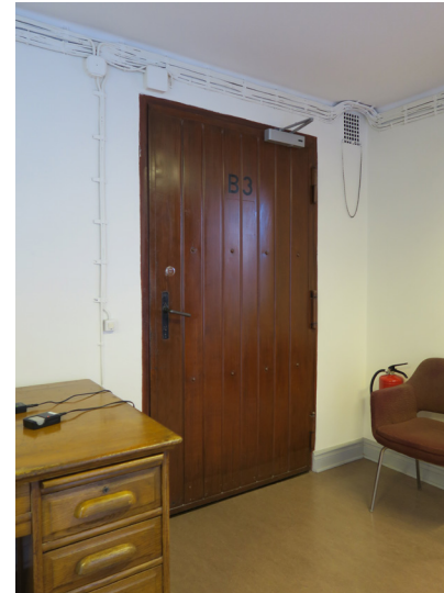
Käytävästä käynti B-makasiiniin; ruskeaksi maalattu palo-ovi.
