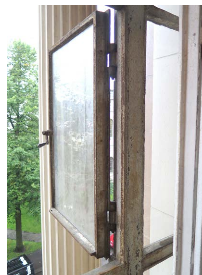
Tuuletusikkunan ulkokehän ikkuna avautuu ulos.
