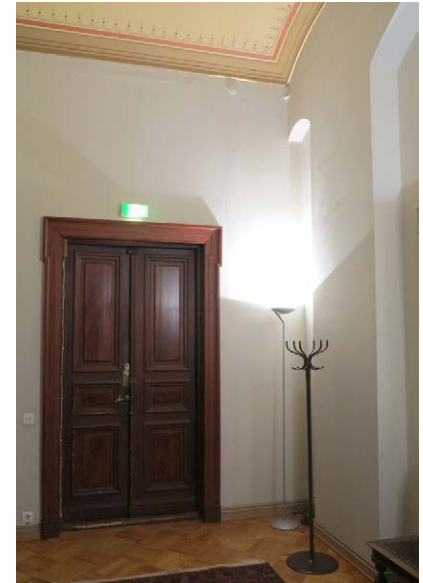
Etuhuoneen lattiassa on vinoruutuladottu tammi-parketti. Oletettavasti lattiassa on ollut aikaisemmin kuviollinen linoleum.
