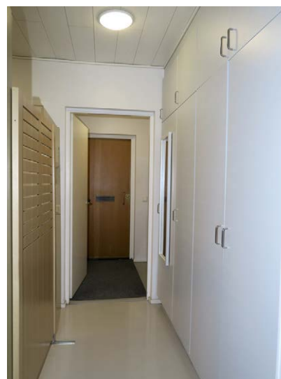
Sisäkäytävään johtavat ovet ovat tammipintaiset laaka-ovet.
