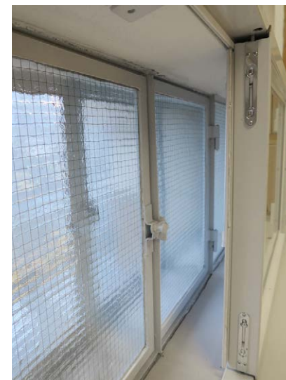
Makasiinissa 9303 on matalat, lattianrajassa kulkevat ikkunat. Ulkopuolella on alkuperäiset, lankalaiset rautaikkunat. Vuoden 2001 muutostöissä makasiinin sisäpuolelle asennettiin uusi alumiini-ikkuna.
