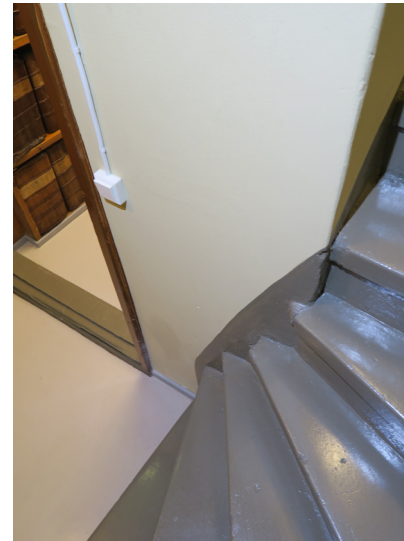
Betoniportaait on maalattu vuoden 2002 kunnostuksen yhteydessä sävyllä Monicolor Nova L161; jalkalista maalattu seinään sävyllä Monicolor Nova K159 / L157.
