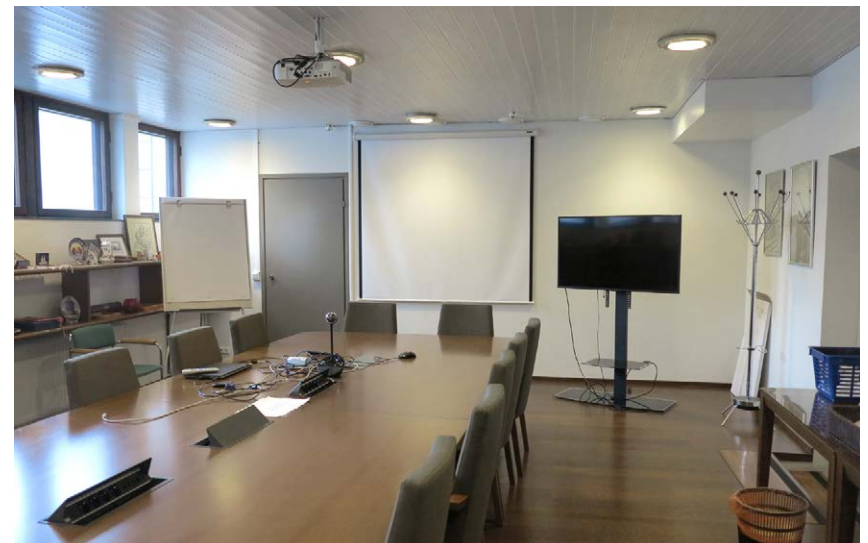
IV-konehuoneen sisäänkäynti neuvotteluhuoneen pohjoisseinällä.
