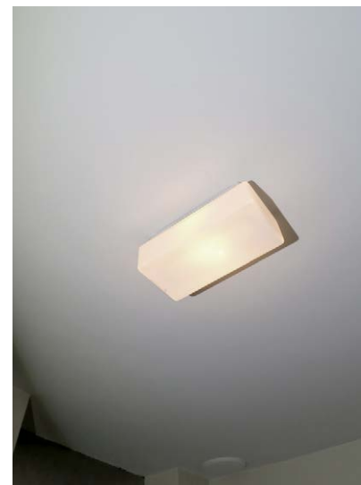
Porraskäytävässä on suorakaiteen muotoiset kattovalaisimet.
