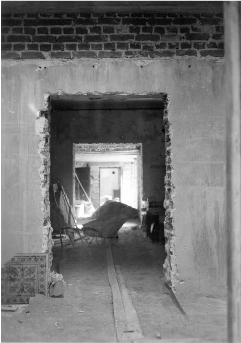
~1927, Schjerfbeckin laajennustyö, käytävä 8.310 Virkailijakäytävästä katsottuna, wikimedia/KA.
