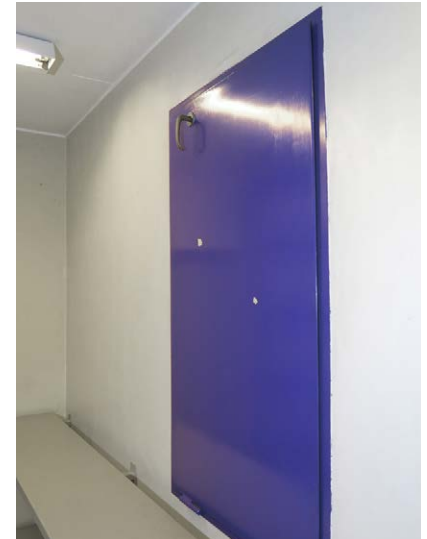
Savunpoistoluukku ulkoseinällä.
