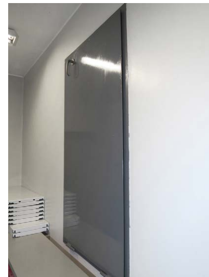
Savunpoistoluukku ulkoseinällä.
