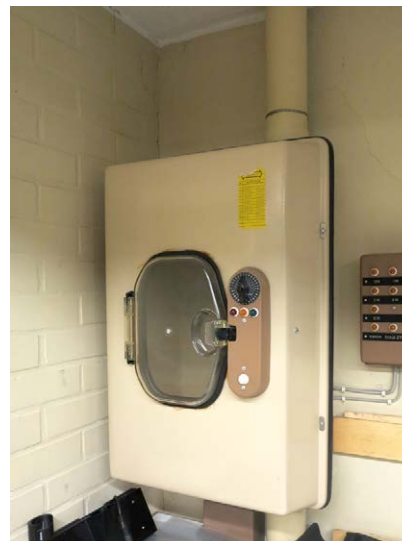
Putkipostijärjestelmä.
