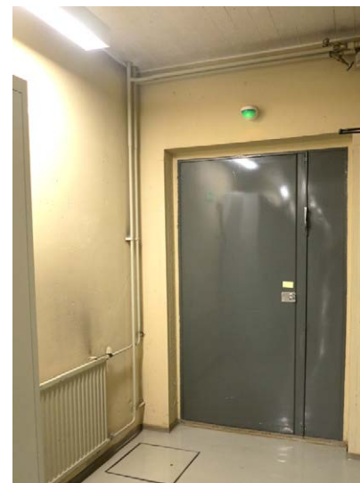
I-portaaseen johtava palo-ovi PO90+30.
