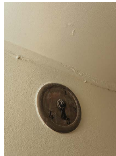
Hissioven yläpuolella olevasta taulusta on voinut seurata hissin kulkua.
