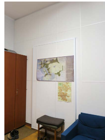
Työhuoneiden 8308 ja 8309a välille on Hanssonin työvaiheen aikana lisätty ovi; kulkuyhteys suljettu työhuoneen 8308 pohjoisseinään asennetuilla akustoivilla seinäpaneelilla.
