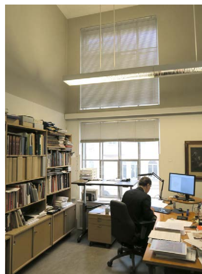
Työhuoneen itäseinällä kaksi iso rautakehyksistä ikkunaa; kirkkaat lasit.
