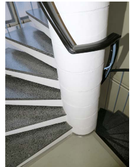
L-portaikossa kulkee elementtikierreporras; askelmat ovat mosaiikkibetonia.
