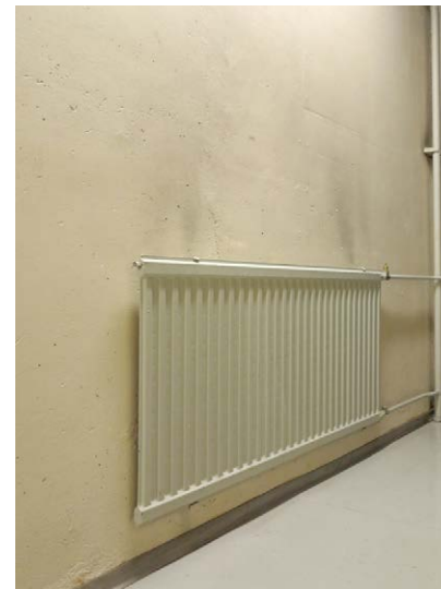
"Pyykkilautaradiaattori" ja muovinen jalkalista.
