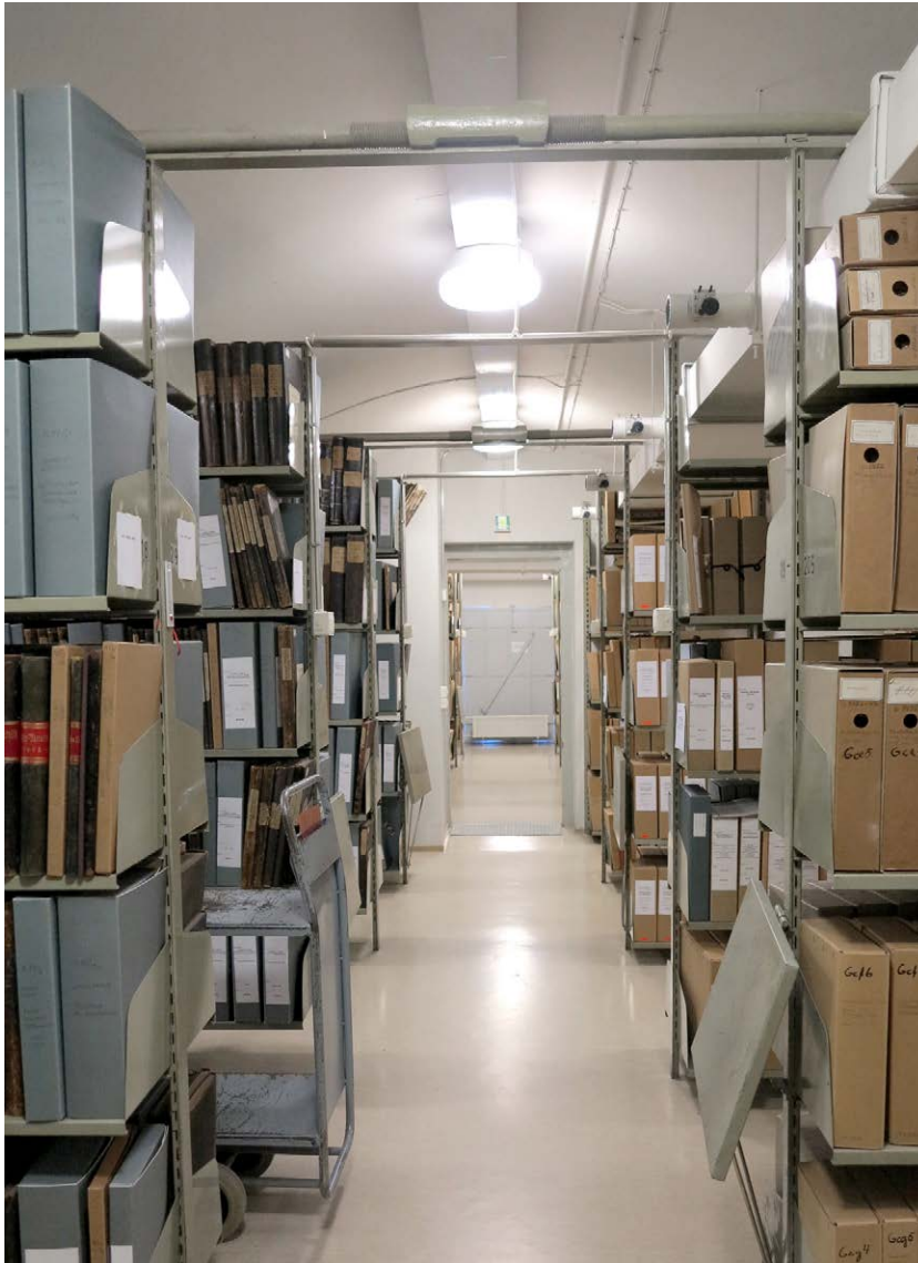
Makasiini D7 ja D8 . Katon laakea holvaus paljastaa, että kyseessä on ylin kerros. Rautapalkkien varaan tehdyt holvit ovat osa alkuperäistä Nyströmin 1880-luvun rakennetta.
