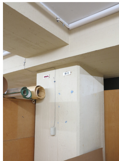
Lautamuottipintainen betonipylväs, maalattu vaalea.
