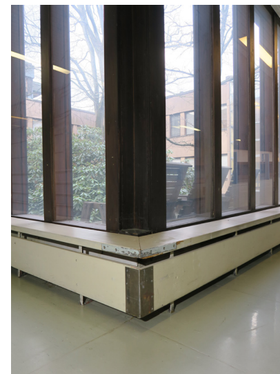
Ikkunaseinä sisäpihan suuntaan.
