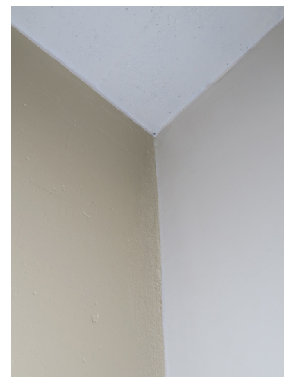
Ulkoseinän (vasemmalla) ja väliseinän värikyset poikkeavat harkitulla tavalla toisistaan. Katto on valkoinen.
