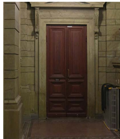
Tilan 5.408 puinen peilipariovi; oven yläpuolella konsolit ja tympanum.
