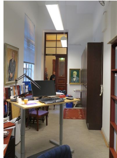
Työhuoneen sisäänkäynti on tehty virkailijakäytävän entisen ikkunan paikalle.
