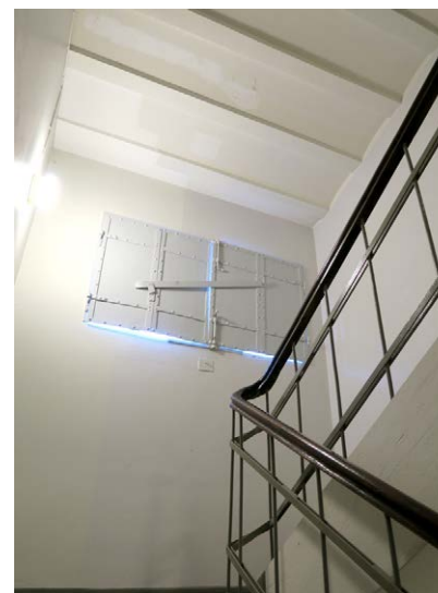
D-portaan katossa kappaholvaus; ikkunoissa rautaluukut.
