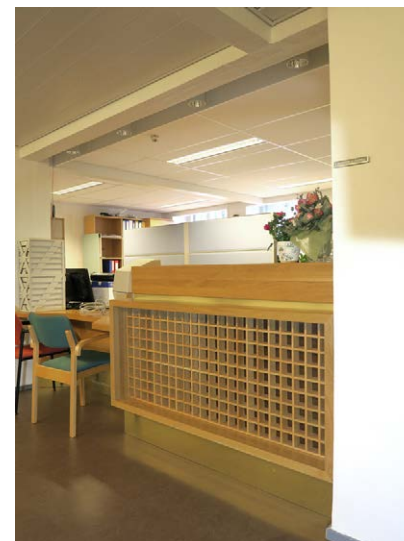
Käytävän alakatossa on perforoitu peltipaneli, toimistoissa akustoivat kasetit.
