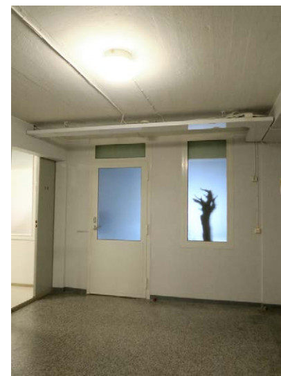
Sisäikkuna ja lasiovi D-portaaseen; lasi mattahiottu lankalasi.
