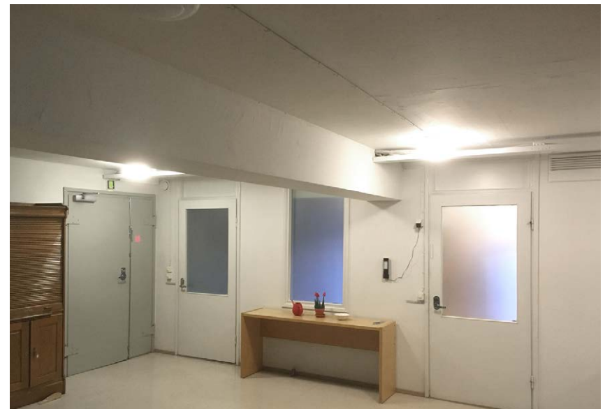
C-portaan harmaa palo-ovi; toimistoissa valkoiset lasiovet, lasi mattahiottu.
