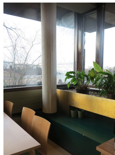
Paikalla valetut pylväät jättävät ikkunarakenteen vapaaksi.
