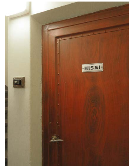
F-portaan alkuperäinen hissi.
