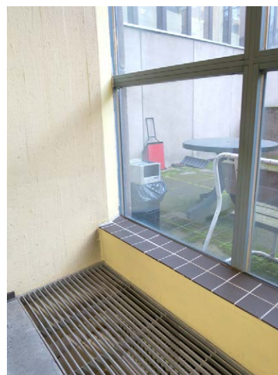
Porraskäytävässä kohoaa korkea teräskehysinen ikkunaseinä; ikkunapenkissä tumma klinkkeri.
