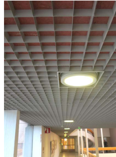
Kattojen alapintojen akustoiva ja estetisoiva ratkaisu.
