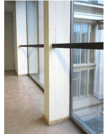
Sisääntulohallin ikkunat ovat mahdollisimman immateriaaliset, kiinteästi lasitetut lämpölasiseinät.
