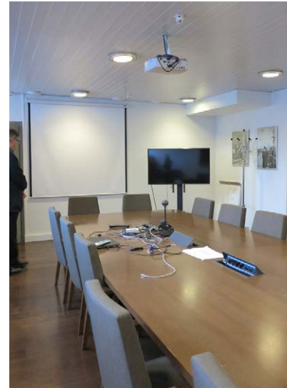
Katon perforoitu peltipanelointi ja kattovalaisimet on uusittu Hanssonin työvaiheen jälkeen. Nykyinen panelointi on ikkunaseinän suuntainen, Hanssonin taas sitä vasten kohtisuora.
