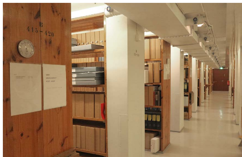
Makasiinin kirjahyllyt ovat liimapuusta; numerointi on maalattu hyllyjen etureunoihin. Pylväissä näkyvä numerointi on maalattu v. 2002 kunnostuksen yhteydessä, kirjahyllyjen numerointia mukaillen.
