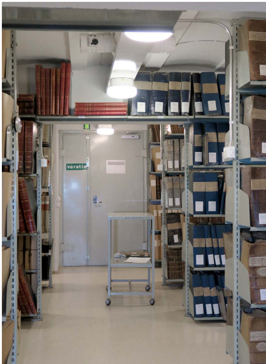
Aktimakasiinin keskiosassa ylin makasiinikerros sijaitsee 10. kerroksessa, päädyissä samalla tasolla on vain kylmät ullakot.
