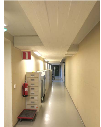
Betonista valettu koneellisen ilmanvaihdon kanava-kotelo.
