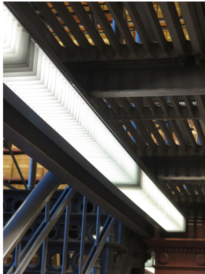
Loisteputkivalaisimien häikäisysojaritilat takaavat sen, että valaisimen alla kulkiessa valo ei loista silmään häiritsevän kirkkaana.
