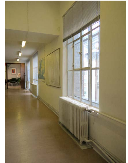
Käytävässä on vanhat, valurautaradiaattorit vuodelta 1927.
