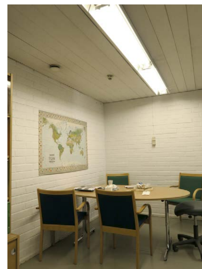
5.214 entinen varasto, nykyinen taukotila. Katossa lautex-alaslasku tunnisteella LXS/m.
