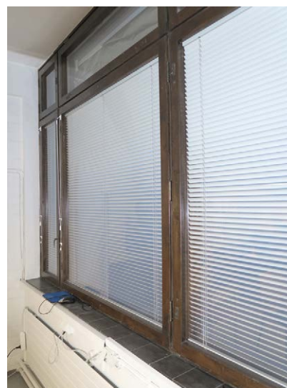
Toimistoissa tummaksi petsatut puuikkunat; ikkunalaudassa tumma 15x15 klinkkerilaatta.
