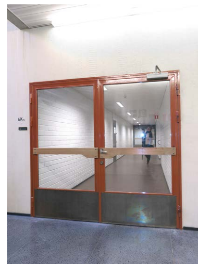
K-portaasta käytävään 6.215 johtava ovi POI 100+100 on porrashuoneen puolelta punainen ja käytävän puolelta sininen.
