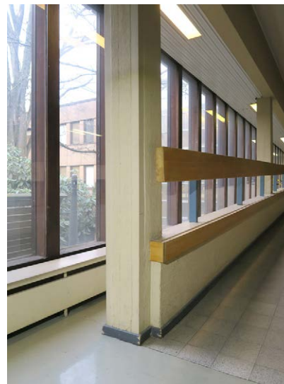
Hanssonin suunnitelmassa on erikseen mainittu, että rampin betonivalulautoitus tehdään rampin suuntaisena, eikä pystysuuntaisena kuten tavallisesti (esim. kuvassa näkyvät pilarit).
