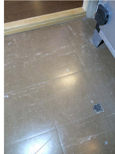
Lattiassa on ruskea kvartsivinyylilaatta.
