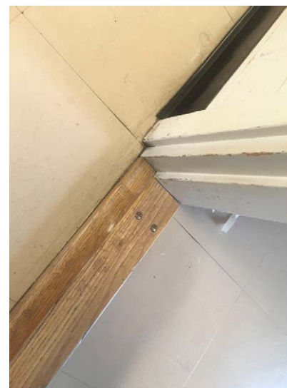
Lattiassa on kvartsivinyylilaatta; seiiniä kiertää musta muovinen jalkalista.
