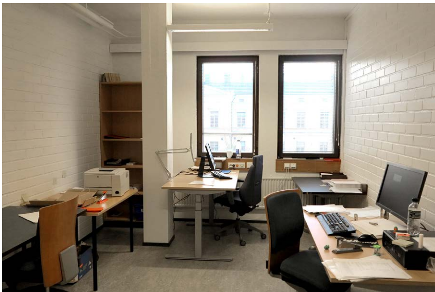
Tyypillinen ulkokaarteen työhuone 6.229; tiilestä muuratut väliseinät, kantava vapaasti seisova betonipilari, ikkunoiden alaosissa sähköpielit. Pinnat uusittu 2013.
