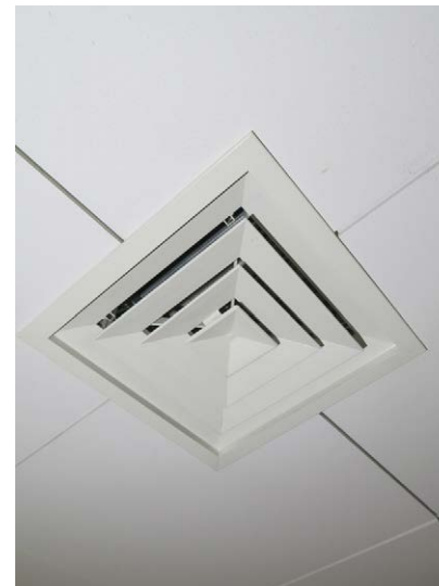
IV-elin lienee alkuperäinen 1968, mutta alakattomateriaali on uusittu 2012.
