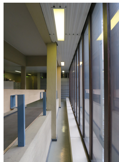
Luiskan ja ulkoseinän väliin muodostuu kapea, mutta kuljettavissa oleva tila.
