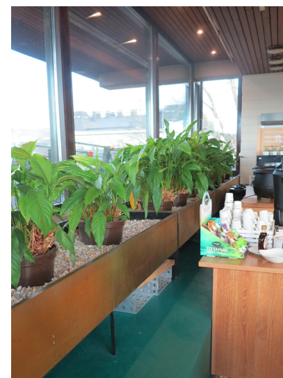
Kukka-altaat ovat ap. suunnitelmasta: "ikkunapenkit varustetaan kukkalaatikoilla, 0,7 mm messinkipelistä joka reunataitetaan, jalusta L-kehysinen putkijalat, c/c 50 cm."
