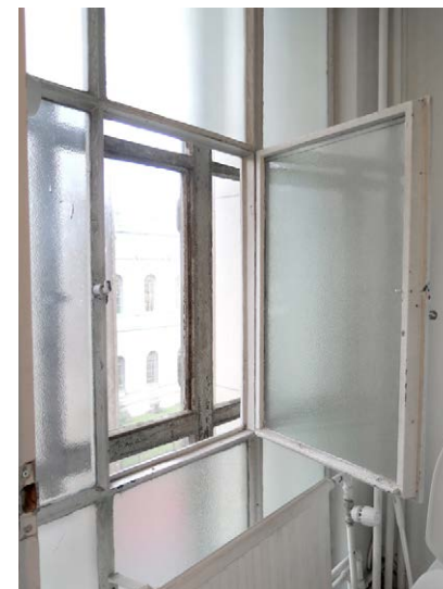
Ikkunakehässä on tuuletusikkuna, jossa sisäkehän ikkuna avautuu sisään.
