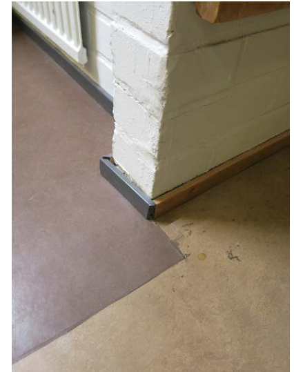
Tumman ruskea matto ja maalatut harmaat jalkalissat ovat 2013 peruskorjauksesta. Alun perin lattiassa on ollut vinyylimatto.
