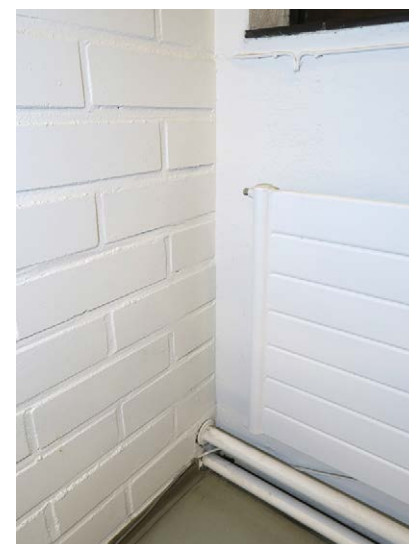
Uudet, tilan jakavat seinät ovat tiilimuuratut ja valkoiseksi maalatut.
