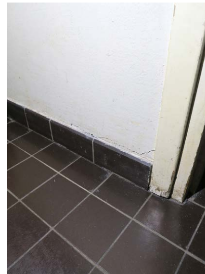
Lattian sintrattu laatta ja sintrattu jalkalista.
