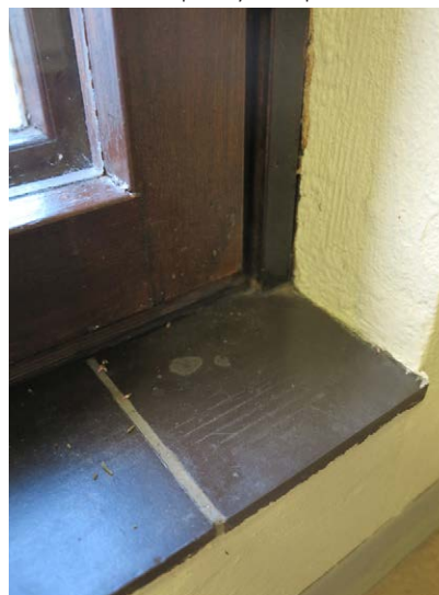
8. kerroksessa on tyypillinen puuikkuna ja keraamisilla laatoilla peitetty ikkunapenkki.
