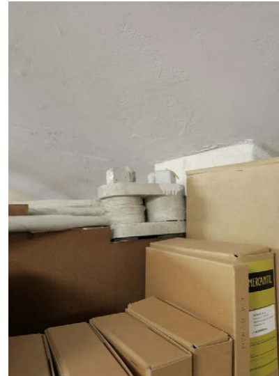
Vetotanko haarautuu kolmeksi ohuemmaksi tangoksi nivellukon kohdalla.
