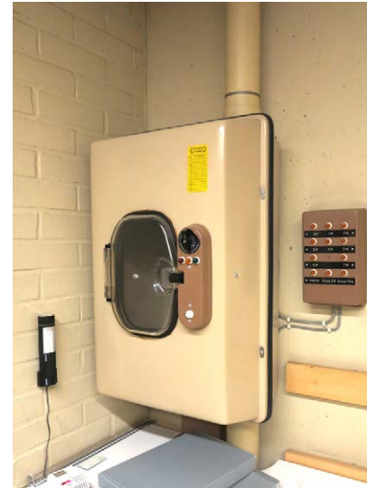
Putkipostijärjestelmä.
