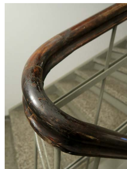
Portaissa oletettavasti alkuperäinen rautainen porraskaide puisella käsijohteella.
