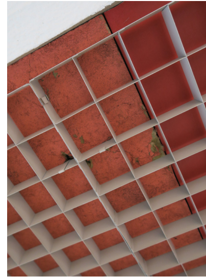
Kattojen alapintojen akustoiva ja estetisoiva ratkaisu.
