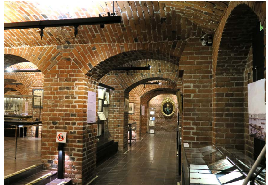
Kellarikerroksen tynnyriholvit tukeutuvat pilarilta toiselle kulkeviin tiilikaaripalkkeihin.
