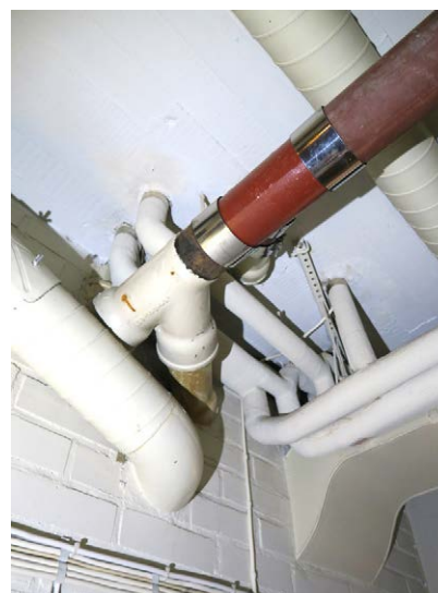
Talotekniikan asennukset käytävän 5.223 katossa
