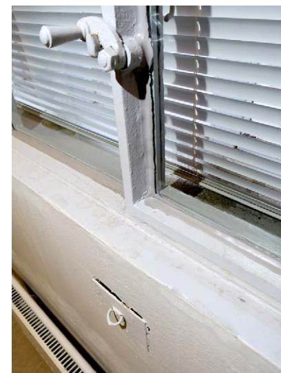
Ikkunoiden sisäkehällä on kaartuvat rautaiset sulki- met. Ikkunoiden alla alkuperäiset hikivesien kerää- mistä varten tehdyt peltirasiat ovat monin paikoin säilyneet.
