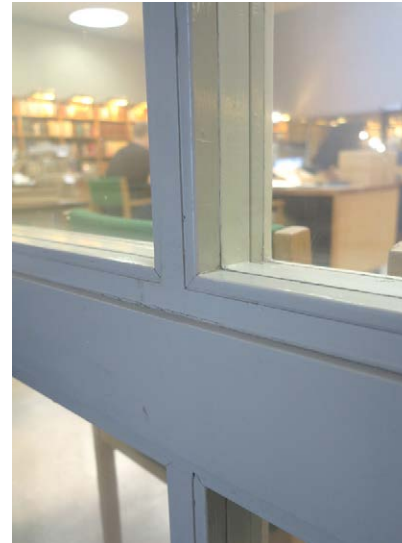
Lasiseinärakenne tutkijasalin suuntaan on puinen, kaksinkertainen lasitus.
