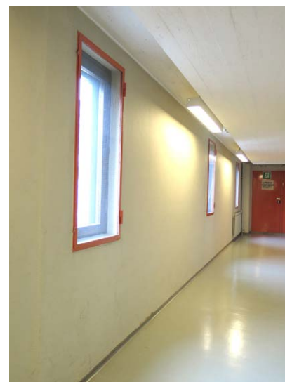
Käytävän ikkunallinen länsiseinä: seinän pinnasta saattaa erottaa levymuotin rytmin, katossa muottilaudan jäljet.
