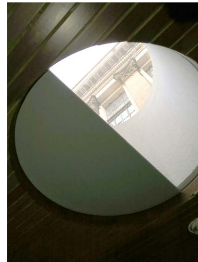
Kattokuvut (3 kpl) on pimennettävissä Hanssonin suunnitelman mukaisella moottoroidulla sulkulevyllä.
