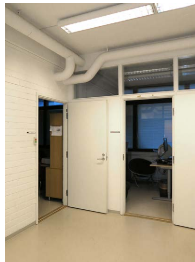
Erikoismakasiinitila jaettiin kahdeksi toimistohuoneeksi, atk-laitehuoneeksi ja eteiseksi vuonna 1995; uudet väliseinät ja -ovet.
