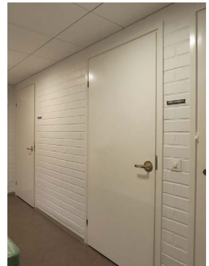
Tyypillinen WC-tilojen yms. ovi on paikalla maalattu laakaovi, tyyppiä Ov 85.
