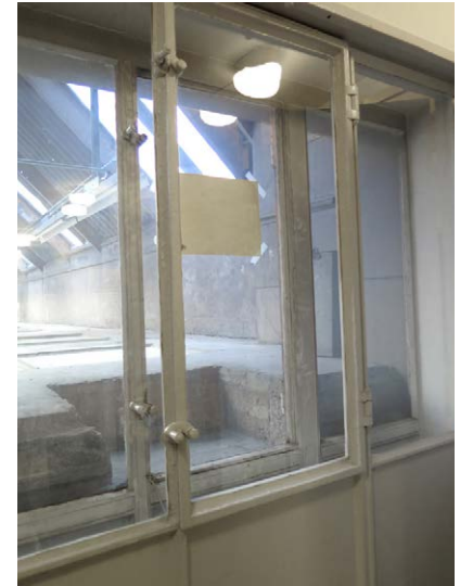
Aulasta on näkymä virkailijakäytävän yläpohjaan ovimaisen ikkunarakenteen läpi.
