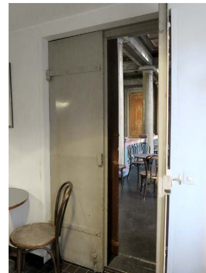
Vestibyyliin johtava Nyströmin aikainen palo-ovi.
