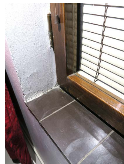
Tummaksi petsatut puuikkunat, ikkunalaista tumma 15x15 klinkkerilaatta.
