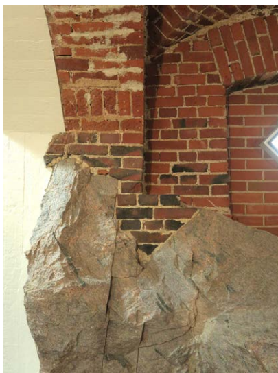
Nyströmin osan muurausta
