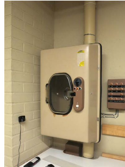
Putkipostijärjestelmä.
