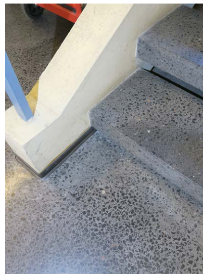
Porrasaskelmat ja porrastasanteiden lattiat ovat mosaiikkibetonia.
