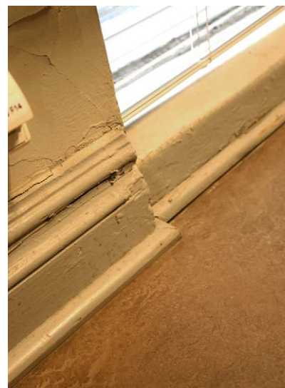
Lattiasa linoleum; puiset, harmaaksi maalatut jalkalistat.
