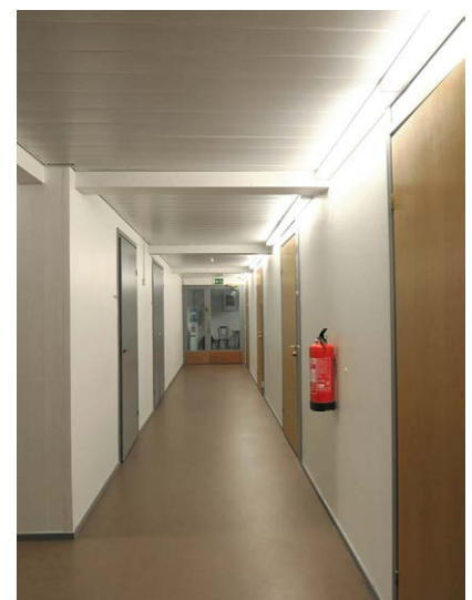
D-portaaseen johtava käytävä; oik. toimistojen tammiuovet, vas. peltipintaiset laakaovet.
