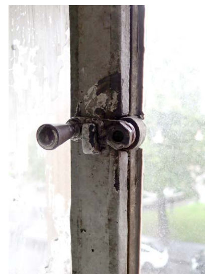
Ulkokehän ja sisäkehän ikkunoiden sulkimet ovat toisistaan poikkeavat. Ulkokehän ikkunan suljin on suoravartinen. Sisäkehällä suljin on kaareva.
