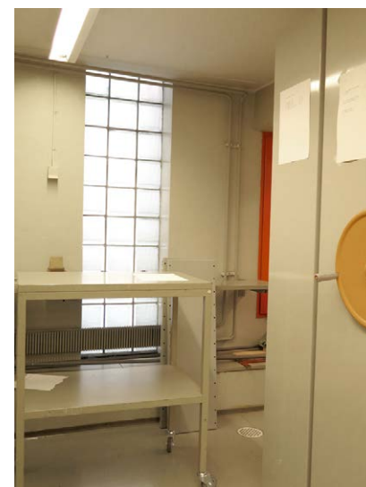
Lasitili-ikkuna; edessä matala peltiritiläradiaattori.
