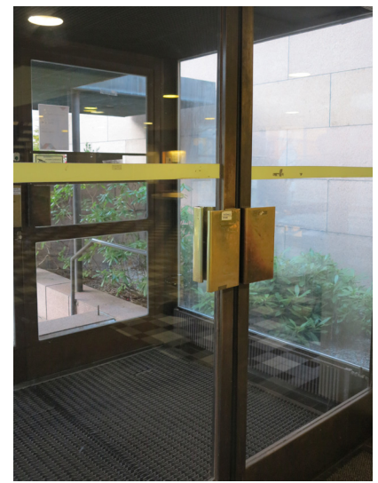
Sisäntulohallin tuuli-kaapin lasipariovissa on Hanssonin suunnittelemat messinkivetimet.
