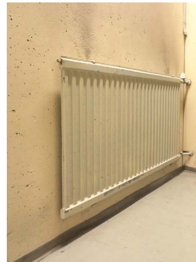
"Pyykkilautaradiaattori" ja muovinen jalkalista.
