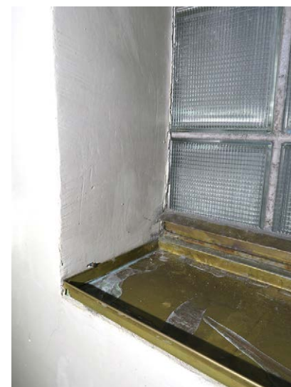
Makasiinin ikkunoina kapeat lasitiilikaistat; ikkunapenkissä messinkinen hikiastia.
