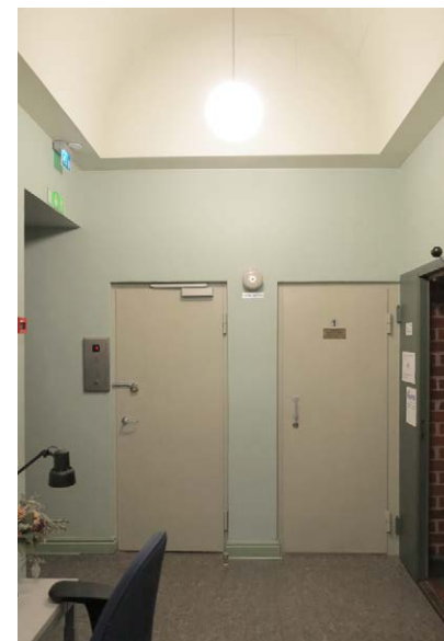
Hissi ja konehuone 5.416
