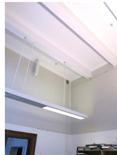
Työhuoneen katosta roikkuvat uudet loisteputkilaisimet.
