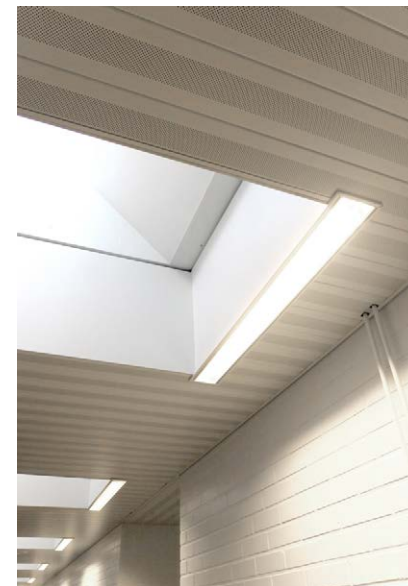
Kattoikkunat ja lautex-alakatot.
