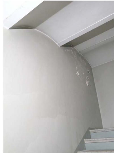
Portaikossa rautarakenteinen kappaholvaus.
