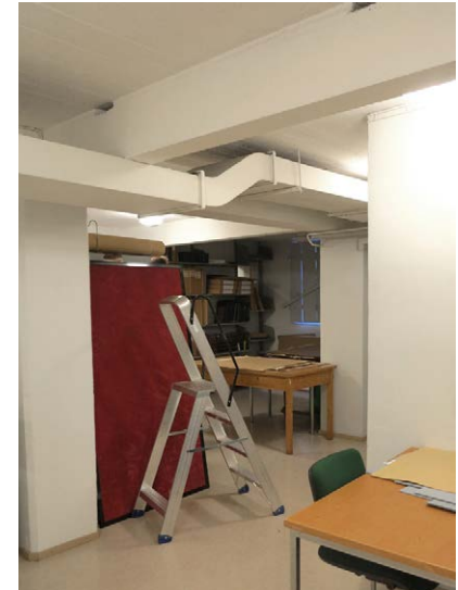
Katossa kulkevat ilmanvaihtokanavat 1996.
