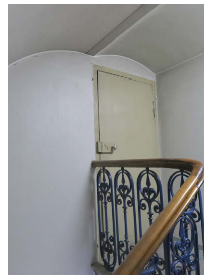
Portaan ylimmältä tasolta on käynti ullakolle; pelti-pintainen laakaovi.
