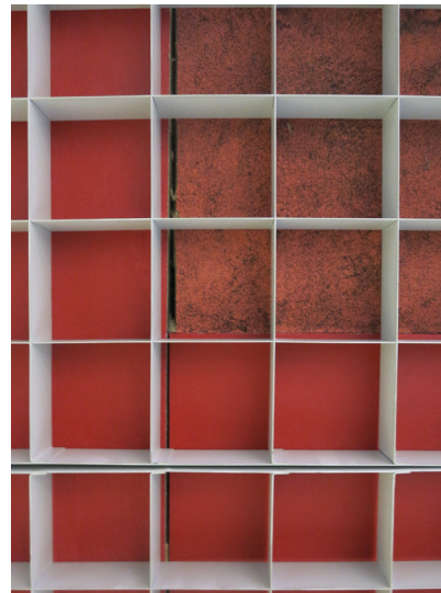
Punaiseksi maalattu mineraalivilla ja peltiritiläkatto.
