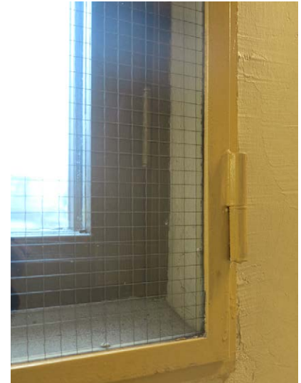
Ulkoikkuna puupuitteinen, lasina lämpölaselementti, sisäpinnassa rautalankalasi ja teräsikkuna.
