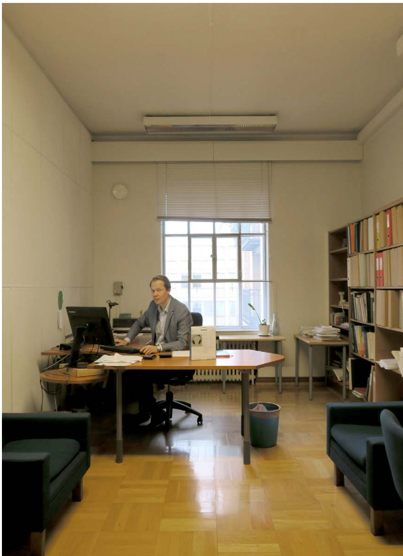
Työhuone "numero 3" on säilyttänyt 1920-luvun alkuperäisen muodon, mutta pintamateriaaleja on uusittu. Ikkunan alla on säilynyt myös alkuperäinen valurautaradiaattori. Hanssonin vaiheessa tilan lounaisnurkasta purettiin pois vuoden 1927-28 keskuslämmityshormi.
