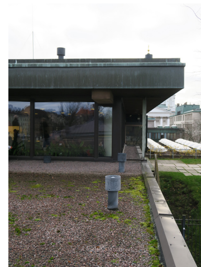
Cafe Hausen on paviljonkimainen rakennusosa 7. kerroksen katon päällä.
