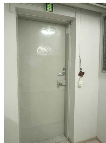
Harmaaksi maalattu peltipintainen laakaovi, B-por- ras, saattaa olla Nyströmin alkuperäisiä, palapellistä tehtyjä palo-ovia. Havaitun perusteella voi olettaa, että uudemmat ovet on tehty yhtenäisestä pellistä.
