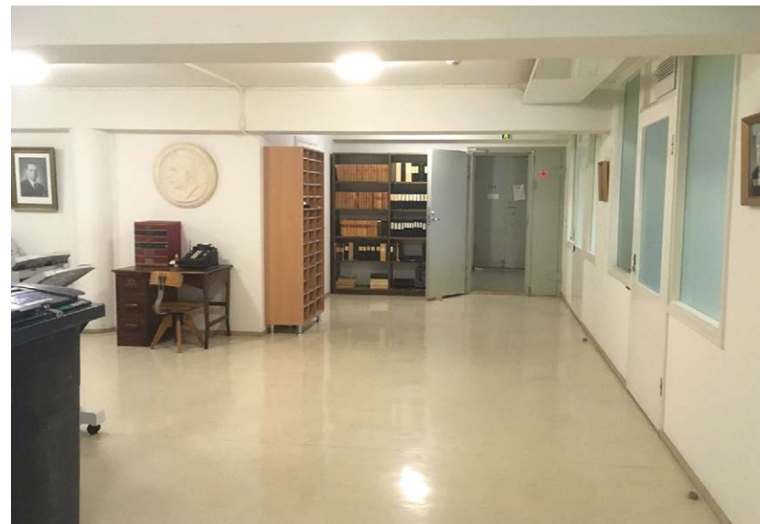
Kulkuyhteys C-portaaseen ja makasiiniin D5-D6; ovet peltipintaisia palo-ovia
