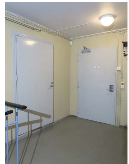
Porrastasanteilta kulku makasiineihin sekä iv-kone-huoneisiin; harmaaksi maalatut palo-ovet.
