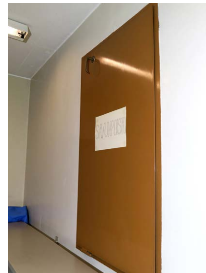
Savunpoistoluukku ulkoseinällä.
