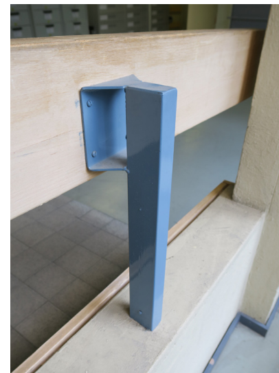
Tammipuiset käsijohteet ja suojalaudat.
