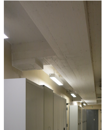
Betonista valetun koneellisen ilmanvaihdon kotelo-rakenne.
