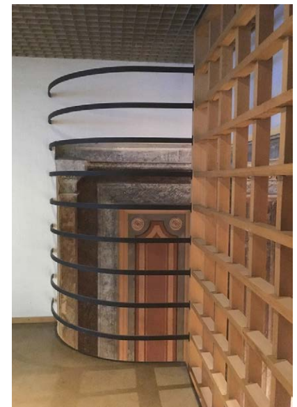
Parven liitos Nyströmin virkailijakäytävään johti kalterimaiseen ritiläkkörakenteeseen, jolla moderni ja uusrenessanssi rajattiin toisistaan irrallseen.
