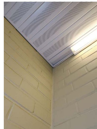
Katossa perforoitu peltipaneeli; seinät tiili-muuratut ja keltaiseksi maalatut.
