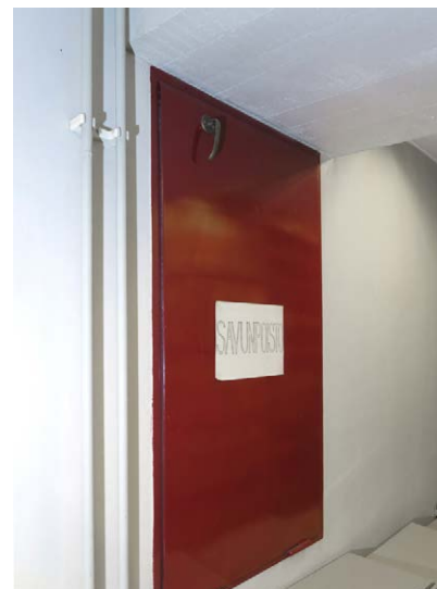
7.kerroksen tunnusteväri on burgundinpunainen; savunpoistoluukku ulkoseinällä.
