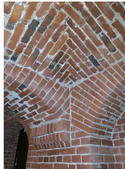
Pitkien tynnyriholvien päät on muurattu aumaan.
