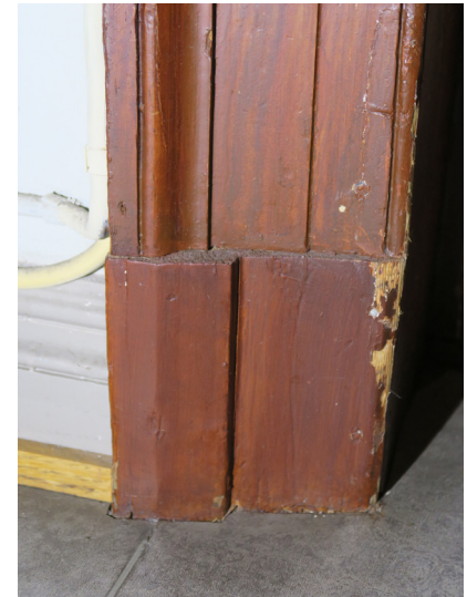
Lattiassa linoleum, jalkalistana vanha puuprofiili, jonka edessä on uudempi tammilista. Oven kehyslistat oletettavasti edelleen alkuperäiset 1890.
