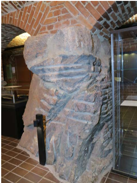
Poraamalla tehty pilarin syventäminen
