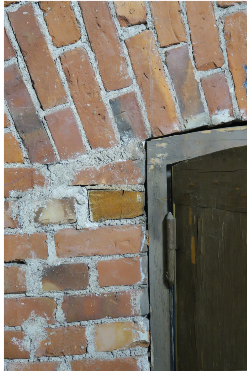
Perusmuurin muurauksen yksityiskohdat ovat pääsääntöisesti rappaus- ja maalauskerrosten takana, vain kellarissa ja ullakolla muurauksen työtavat ovat nähtävillä. Läntisellä ullakolla muurauksessa näkyy kauniisti toteutettu, kiilan muotoinen "puutiili", johon oven karmi on kiinnitetty.
