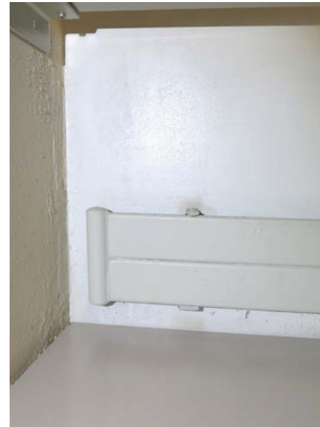
Tuloilman suojarakenteeseen on liitetty radiaattoriverkoston asennukset, kuva 4.107
