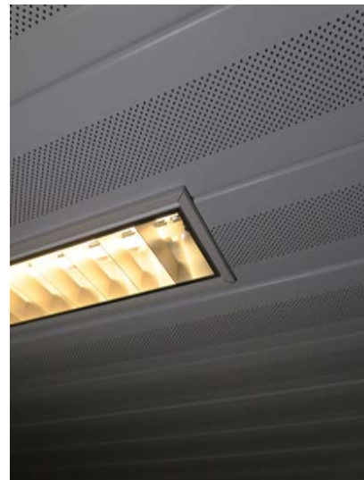
7. kerroksen 2012 uusittu metallikasettikatto.
