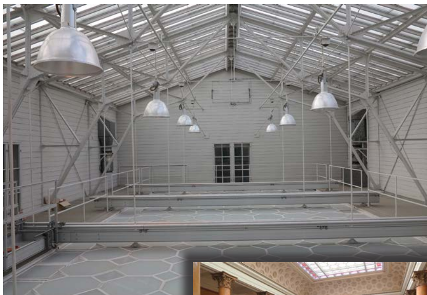
Säätytalon suuri porrashalli näyttäytyy perinteisenä kivirakenteisena tilana, vaikkakin kattoikkunan suuren jännevälin keveät rakenteet on toteutettu rautarakentein. Kuvat Okulus 2016.
