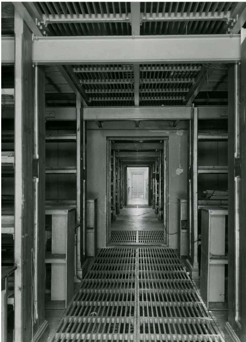
Aktimakasiinin paljaat rautarakenteet ennen muutostöitä. Kuva on otettu idästä kohti länttä, sillä näkymän päättäneenä oleva läntinen osio on tässä vaiheessa jo kunnostettu. Noin 1954, Wikimedia, KA.
