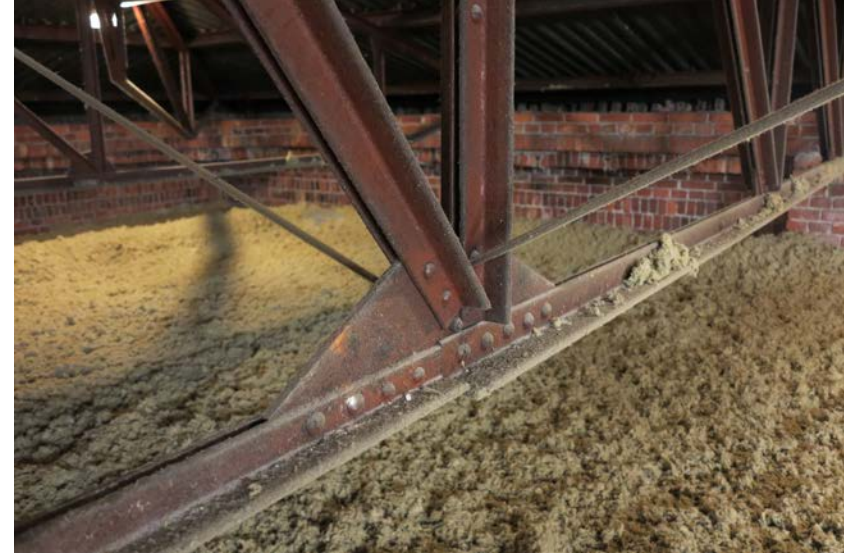
Kattotuolien sauvat on liitetty toisiinsa solmukohdissa oleviin nurkkalevyihin niittaamalla. Alapaarteen sauvat on koottu erikokoisista L-profiileista.
