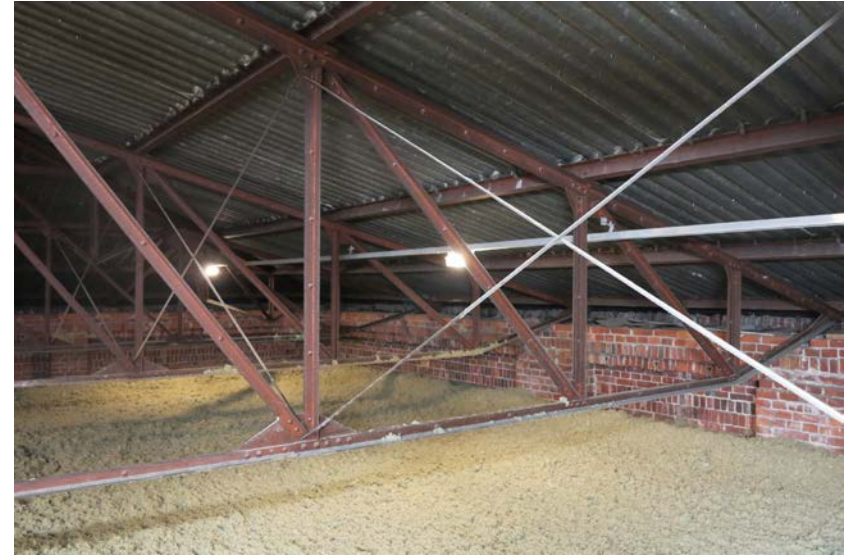
Kattotuolien välillä kulkevat tuuliseiteet.
