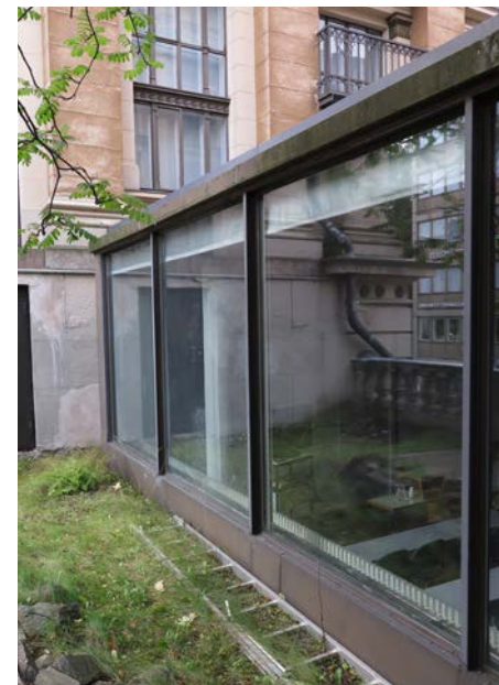
Luentosali on puolittain maanpinnan alapuolella.
