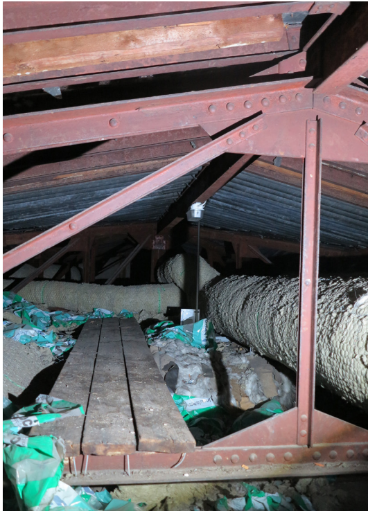
Päätykolmion alla on kevytrakenteisempi yksittäinen kattotuoli.
