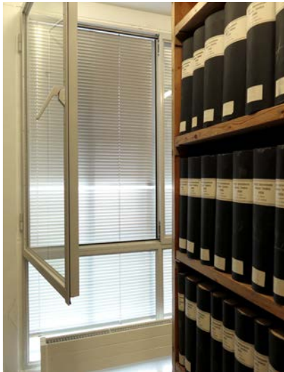
B-makasiiniin asennettiin kerroksiin 7.-9. sisäpuoliset uudet ikkunat ja radiaattorit. 6. kerrokseen asennettiin puhallinkonvektorit. Rakennukseen tehtiin koneellinen ilmanvaihto.
