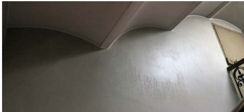
1957 ehjiksi porrashuoneiksi toteutettu C- ja D-porras on katettu kappaholvein. Tila madaltuu päädyissä, koska holvaus väistää yläpuolisia kattorakenteita.
