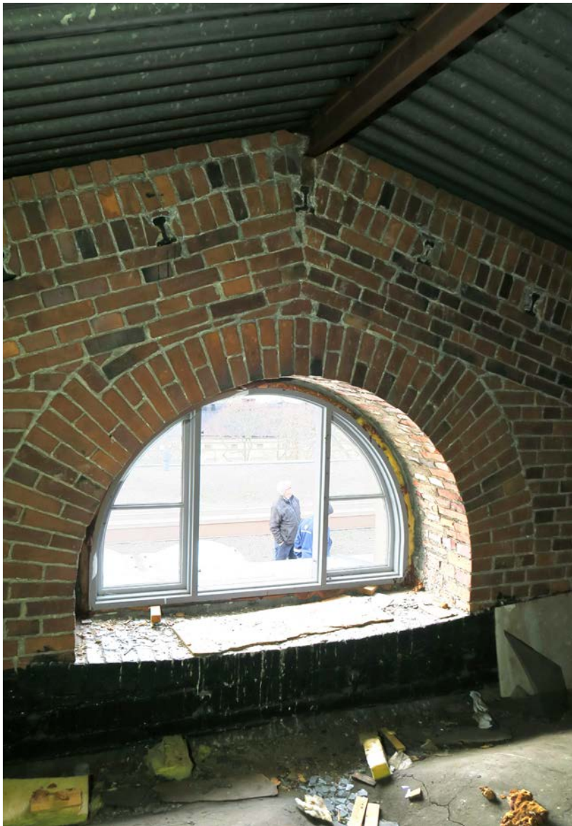
Puhtaaksi muurattuja tiilipintoja näkyy vain kellarissa ja ullakoilla. Muuraustyön jälki on erinomaisen selkeää ja tarkoituksenmukaista, laastin käsittely siistiä. Räystästä kantavien ratakiskojen sovittaminen muuraukseen on tehty tarkasti ja ilman suuria laastitäyttöjä.
