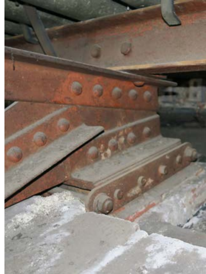
Kattotuolit on asetettu rullalaakerien päälle.
