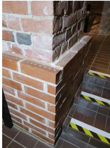
Tiiliverhoitu pilarin tyvi, oletettavasti sisällä ARK-suunnitelman periaatteen mukainen valu
