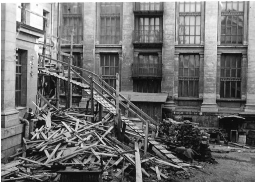
Rakennustelineiden tai betonimuottien purkulautoja Valtionarkiston sisäpihalla 1927-1928.
