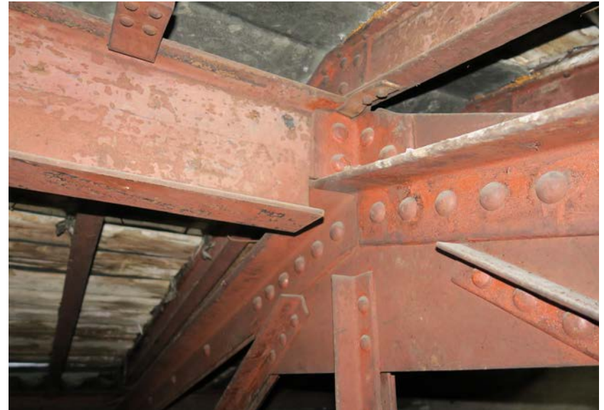
Kattotuolit vaikuttavat säilyneen koskemattomina. Rakenteiden huolellinen käsittely rakennusaikana on osaltaan varmistanut rakenteiden säilymisen. Työmaalla tehty maalauskäsittely on ollut jonkinlainen lyijymönjä/rautaoksidimaali, mikä ilmeisesti on edelleen ristikoiden näkyvä pintakäsittely.
