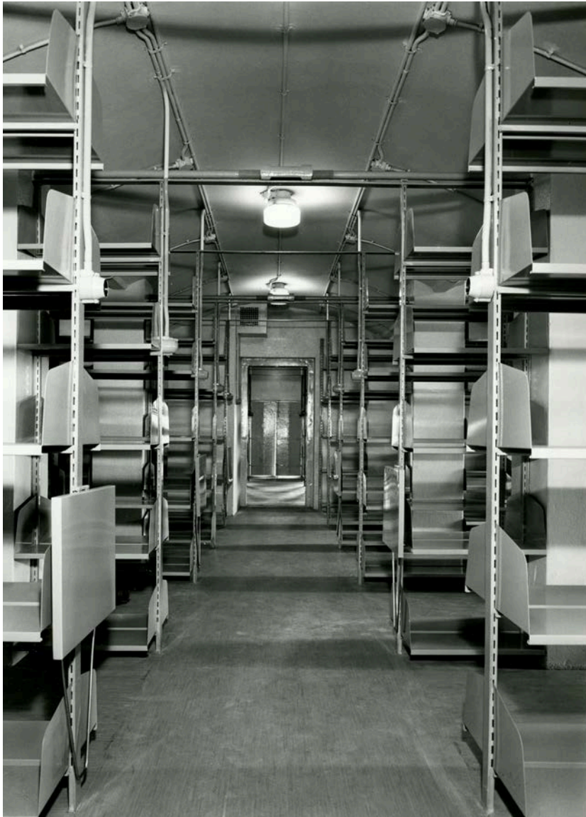
Aktimakasiinin länsipää, jossa uudet rakenteet ja teräksiset kirjahyllyjärjestelmät olivat valmiit vuonna 1954. Kuvassa näkyy länsipään puolittava seinämuuri. Samalla asennettiin limppumaiset valaisimet ja pistorasia jokaisen hyllyn päähän. Noin 1954, Wikimedia, KA.
