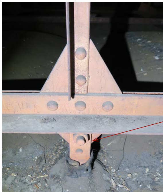
Tutkijasalin kappaholveja kannattelevat ripustimet on muodostettu kahdesta vastakkain asetetusta lattarau- dasta. Piirustuksen mukaan mitta alapaarteesta palkiston alareunaan on 760mm. KA, Hea 6.
