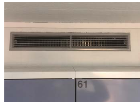
E: Tuloilma sisäntulohallin lokerikon päällä
