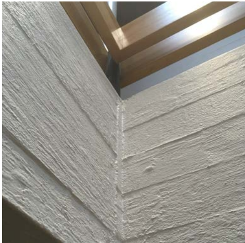
Raakalaudasta tehty muotti ja siitä saatu karkea betonivalu oli 60- ja 70-luvun arkkitehtien unelma, pinta joka sopi niin painotaloon, kirkkoon kuin alikulkutunneliin, siinä missä Valtionarkiston aulaan.
