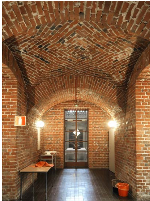
Vanhan vesibyylin suuntaan puhkaistiin ovi
