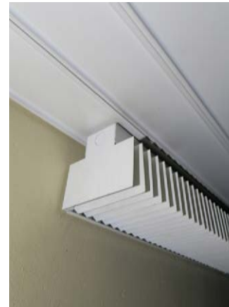
LxO/m eli sileä Lautex, K-portaan 3. kerroksen katto
