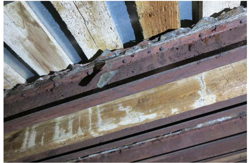
Keskiosan ullakolla on tallella vanhaa valokatetta kantaneet I-profiilit. Rautapalkeissa on jäänteitä kattoikkunoiden rautalankasista.
