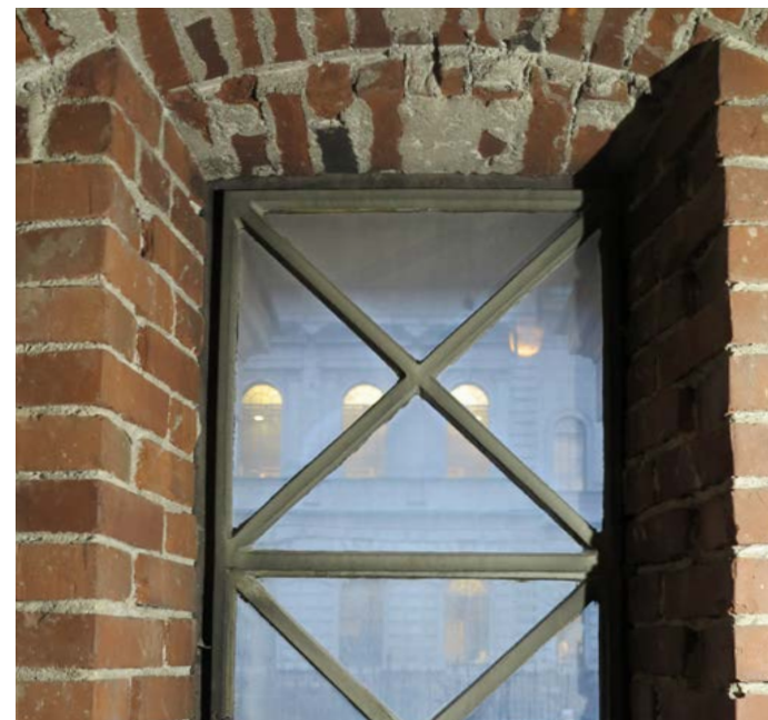
Puhtaaksi muurattuja tiilipintoja näkyy vain kellarissa ja ullakoilla. Muuraustyön jälki on erinomaisen selkeää ja tarkoituksenmukaista, laastin käsittely siistiä. Räystästä kantavien ratakiskojen sovittaminen muuraukseen on tehty tarkasti ja ilman suuria laastitäyttöjä.
