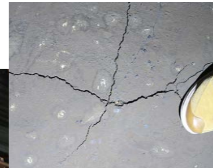
Tutkijasalin komea kasettikatto perustuu rautaisista kattotuoleista kannatettuun rautapalkistoon ja sen varaan muurattuihin pieniin kaukaloholveihin. Rakennevahvuus on Nyströmin rakenneselostuksen perusteella noin 40 cm. Yläpuolisessa tiivistyslaastissa on satunnaisesti vähäistä halkeilua.
