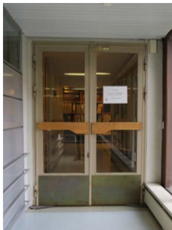
POI 80+80 lasipariovi ja tammipuinen työntölevy yhdyskäytävässä 6.247.
