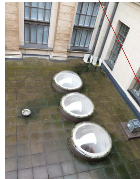
Luentosalin kattoikkunat Valtionarkistonhoitajan (johtajan) huone
