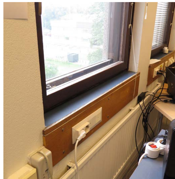
Sähköasennuksille varattu ikkunapenkkirakenne. Hansson, Olof. ARK392, 12.8.1968. SENA.
