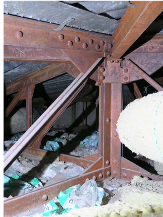
Aktimakasiinin keskiosassa, vesikattorakenteiden keskiosaa kannattelee nelihaarainen kattotuoli.
