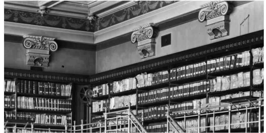
Tutkijasalin eteläseinän yläosassa on ollut poistoilmasäleiköt, lyhyellä seinällä (kuvassa kapiteelin alapuolella) esilämmitetyn ilman nousukanavan säleikkö.
