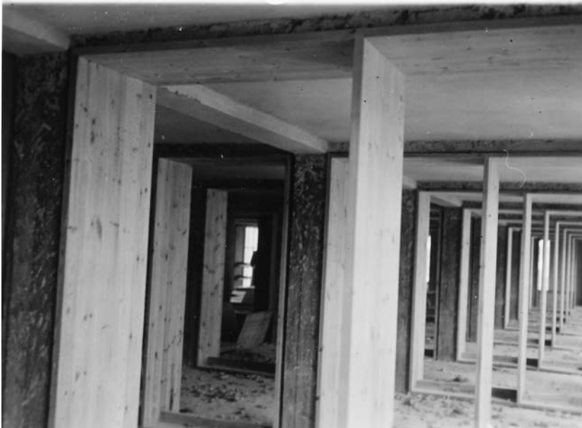
Yllä rakennusaikainen kuva uudesta B-makasiinista. Välipohjarakenne perustuu huomattavan mataliin palkkeihin, ja toisaalta kirjahyllyt on sovitettu hyvin tarkasti vapaaseen väliin. 1927, Wikimedia, KA.
