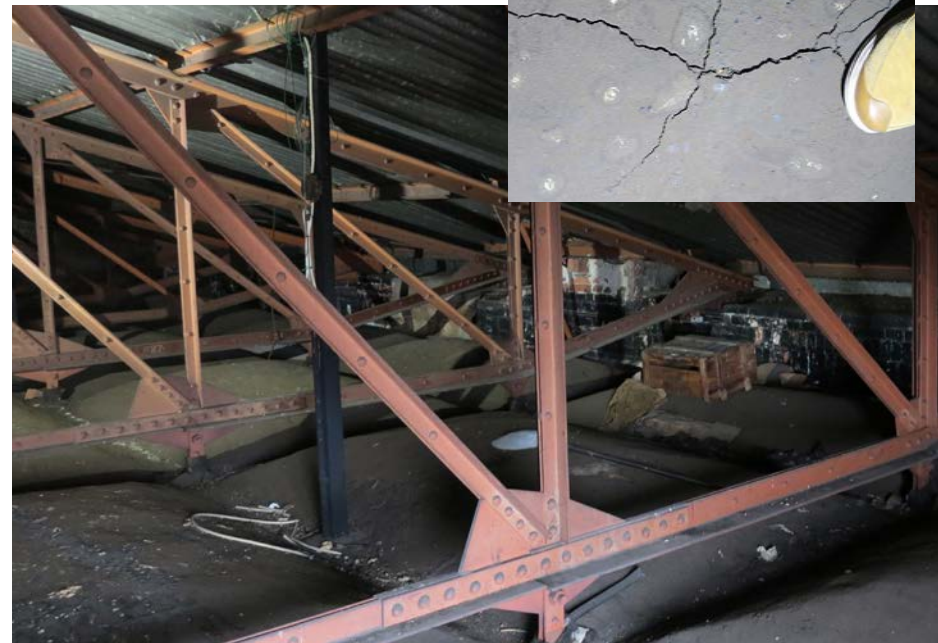
Tutkijasalin komea kasettikatto perustuu rautaisista kattotuoleista kannatettuun rautapalkistoon ja sen varaan muurattuihin pieniin kaukaloholveihin. Rakennevahvuus on Nyströmin rakenneselostuksen perusteella noin 40 cm. Yläpuolisessa tiivistyslaastissa on satunnaisesti vähäistä halkeilua.
