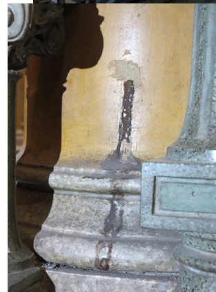
Vestibyylin pylvään kulunut maalipinta paljastaa altaan valurautapinnan. Korkean tilan raskasta rautapalkistoa kannattelee neljä valurautapylvästä.
