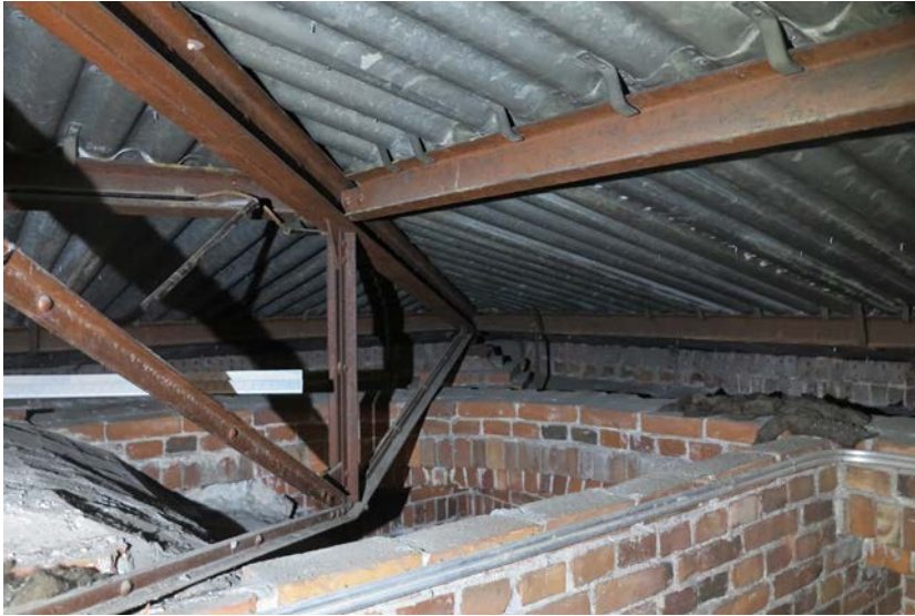
Auman diagonaalisen, kahdesta U-rautaprofiilista yhteen niitatun harjapalkin alapinnassa on pienemmät, jäykistävät ristikot. Kattotuolien sauvat on koottu yhteen niitatuista L-raudoista, joiden dimensiot on määriteltty laskennallisen kuormituksen mukaan.
