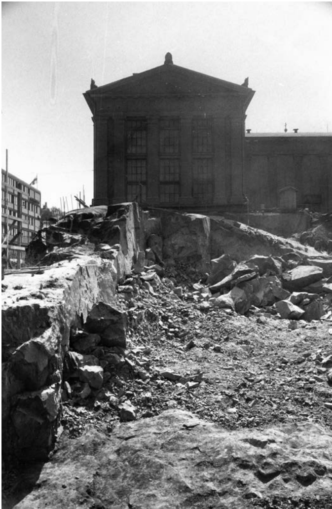
Louhintatyöt etenivät varovaiseen tahtiin. Kuva tietävästi 26.5.1969, 7 kuukautta pääurakan aloittamisen jälkeen. Snellmaninkadun kallion säilyttäminen katukuvassa oli osa Hanssonin arkkitehtuuriideaa. Kuva KA wiki.
