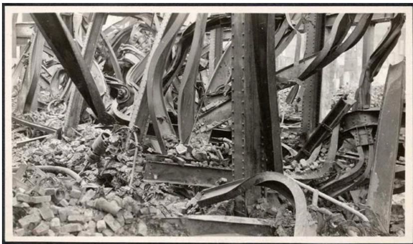
Rautaa pidettiin paloturvallisena materiaalina vielä Kansallisarkiston suunnittelun aikaan. Kuvassa San Franciscon tulipalossa 1906 pahasti muotonsa menettäneitä rautarakenteita. Kuva Online archive of California, http://oac.cdlib.org/ark
