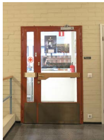
POI 90+30 lasipariovi ja tammipuinen työntölevy K-portaan 5. kerroksessa
