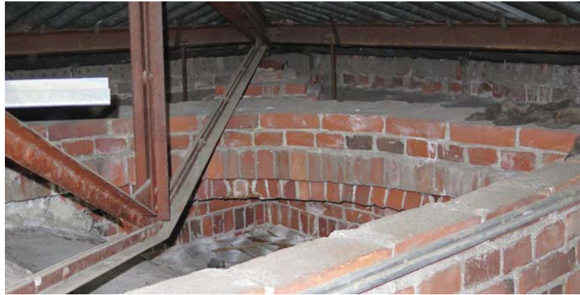
Aktimakasiinin nurkkaporrashuoneen kappaholvaus laskeutuu porrasjuoksun mukaisesti.
