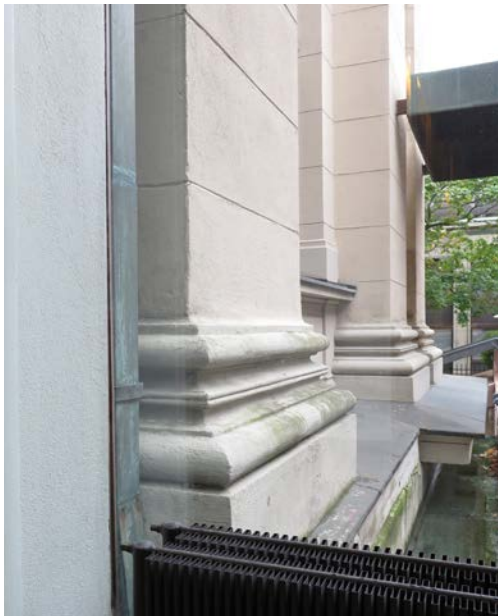
Sisääntulohallin ikkunan liitos on tehty vailla näkyviin jäävää karmia, mahdollisimman läpivirtaavan vaikutelman aikaansaamiseksi.
