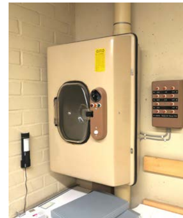
Putkipostin asema M-makasiinin käytävällä.
