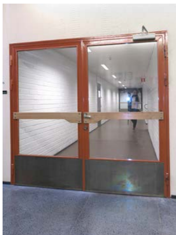
POI 100+100 lasipariovi ja tammipuinen työntölevy K-portaassa.
