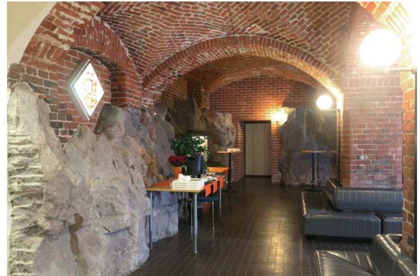
Yllä entisen kattilahuoneen pohjoisen seinämän louhittu kallioseinä.
