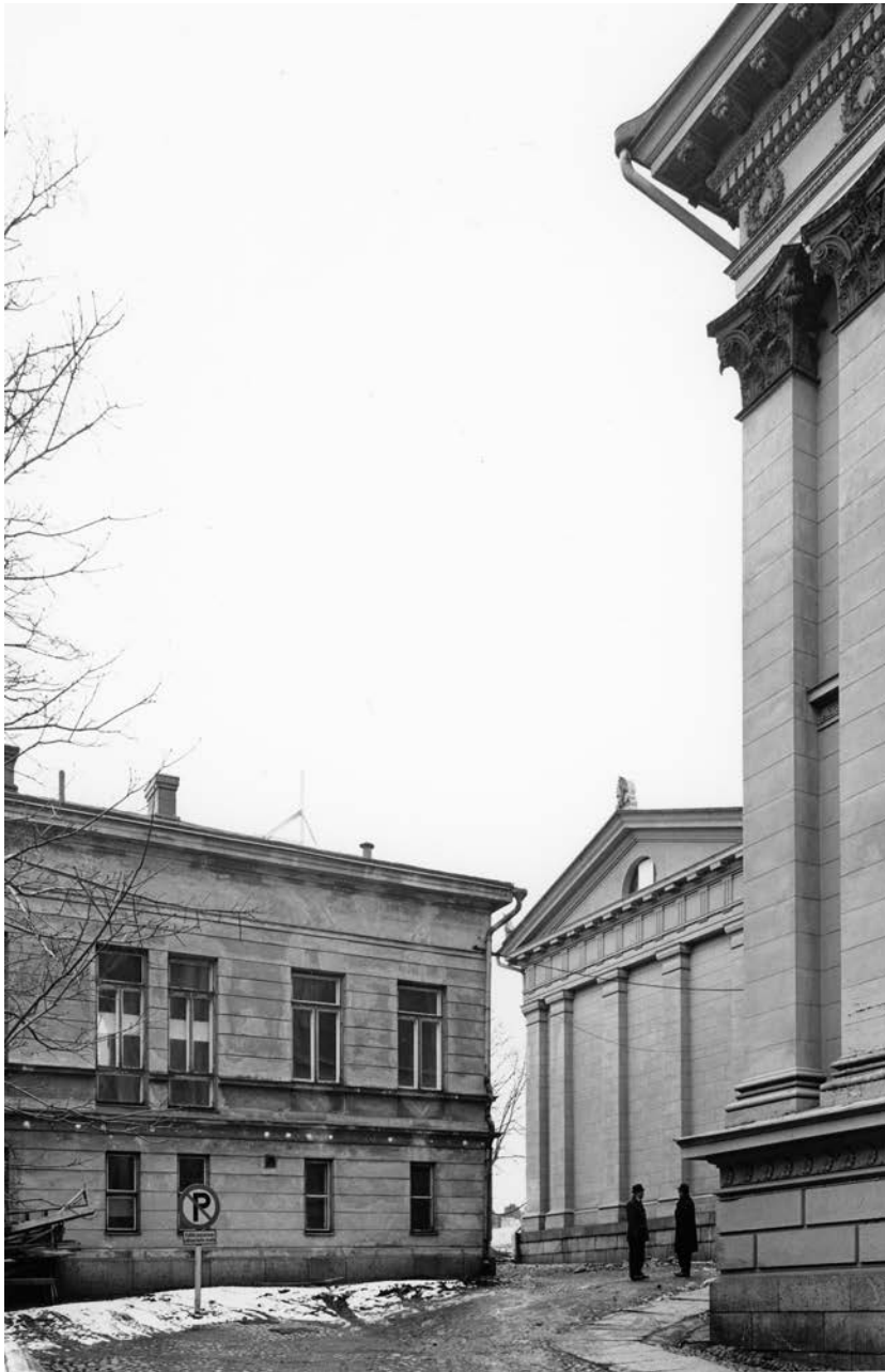
Vahtimestarien rakennus hiukan ennen purkutöiden käynnistymistä vuonna 1968.
