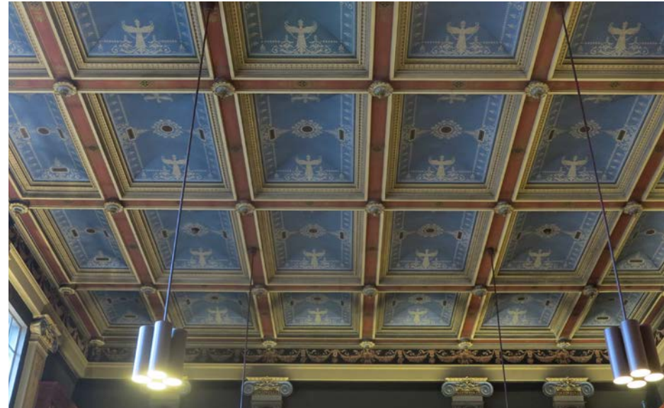
Tutkijasalin komea kasettikatto perustuu rautaisista kattotuoleista kannatettuun rautapalkistoon ja sen varaan muurattuihin pieniin kaukaloholveihin. Rakennevahvuus on Nyströmin rakenneselostuksen perusteella noin 40 cm. Yläpuolisessa tiivistyslaastissa on satunnaisesti vähäistä halkeilua.
