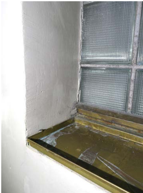
Maan päällä olevissa makasiineissa on lasitiili-ikkunat joiden ikkunapenkeissä on hikiastiat.
