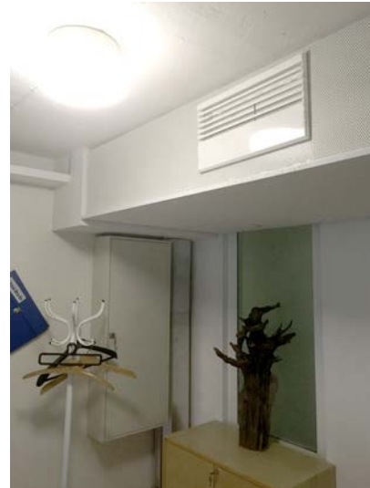
Aktimakasiinin koneellinen ilmanvaihto 1996, esimerkki toimistohuoneen 9.408 käytävään tavanomaisesta kanavoinnista.
