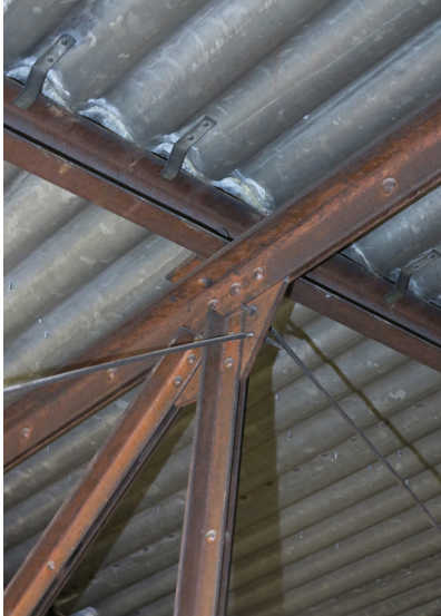
Kattotuolien päällä kulkevat U-profiiliset orret. Orret on kiinnitetty kattotuoleihin kulmaraudoin. Vesikaton aaltopelti on kiinnitetty orsiin sinkityin klammelein.
