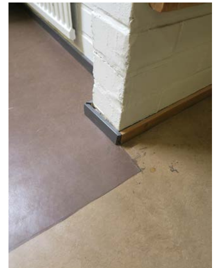
7. kerroksen käytävässä oli Hanssonin suunnitelman mukaan kvartsiivinyyliilaatta. 2012 asennettiin ruskea linoleum ja harmaaksi maalatut jalkalistat. Luettelohuoneen vanha linoleum on vaaleasävyisempi.
