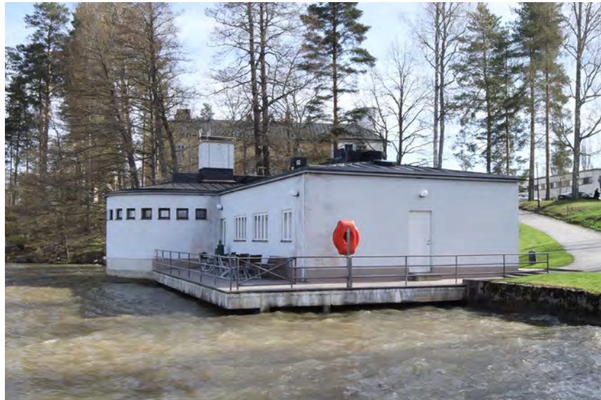
← Rantasauna on valmistunut vuonna 1938. Järven puolella saunan yhteydessä on terassi.
