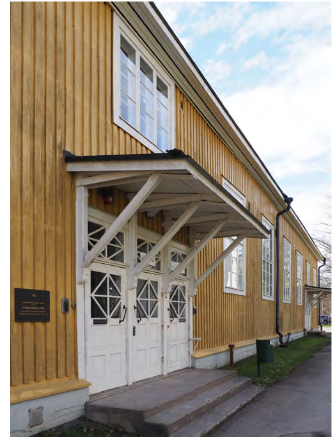
↑ Rakennuksen länsipuolella on kaksi sisäänkäyntikatosta. Sisäänkäyntien ovet ovat alkuperäiset, mutta niiden ikkunoihin on lisätty osittain alkuperäisen kaltaisia, uusia puitteita.
