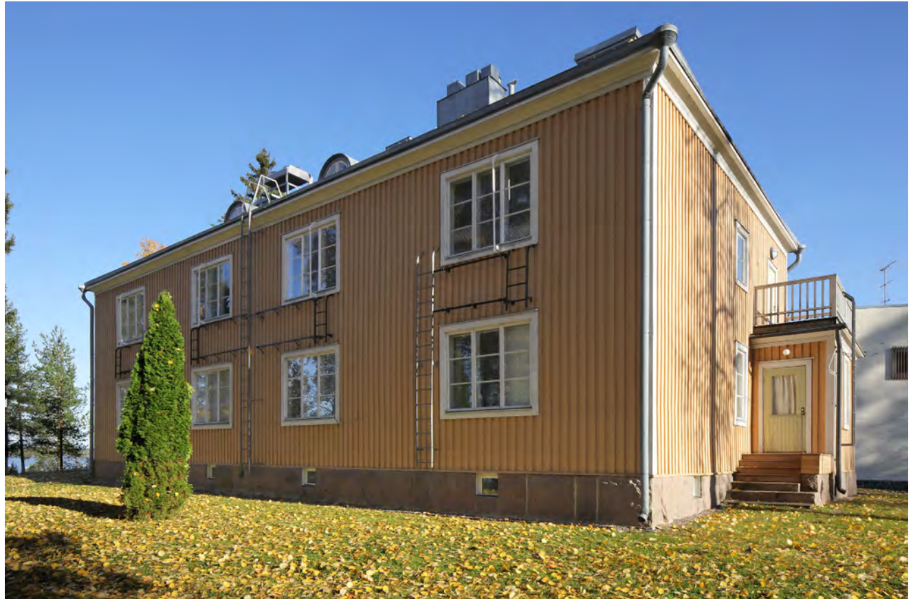
↑ Vihmala kuvattuna etelästä takapihan ja järven suunnalta. Rakennuksen ilme on säilynyt alkuperäisenä.
