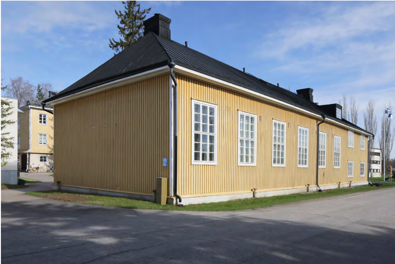
↑ Levälässä on korkea aumakatto ja sen liikuntasaliosassa korkeat ruutuikkunat.
