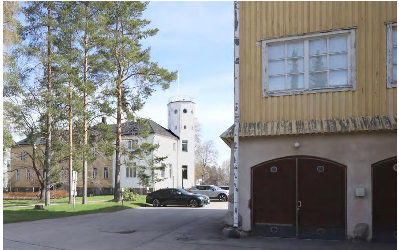
↑ Puolustusvoimien kurssikeskuksen pihapiiriä keväällä 2025. Vasemmalla entinen upseerikerhon rakennus, oikealla opintorakennus Hersala.
