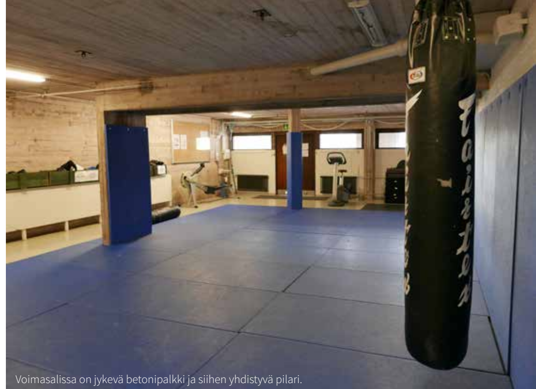
Voimailusalin katossa on näkyvillä betonipalkki ja siihen yhdistyvä pilari.
