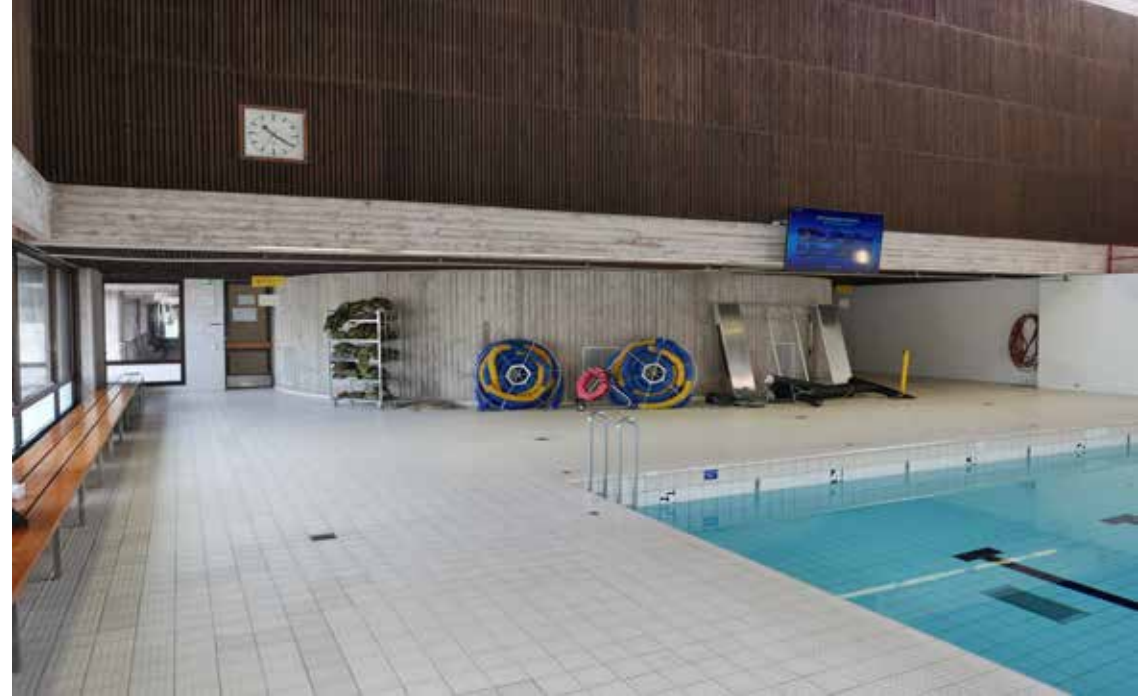
Uimahallin allasosaston sisäänäntuloa rajaa kaareva saunan betoniseinä.
