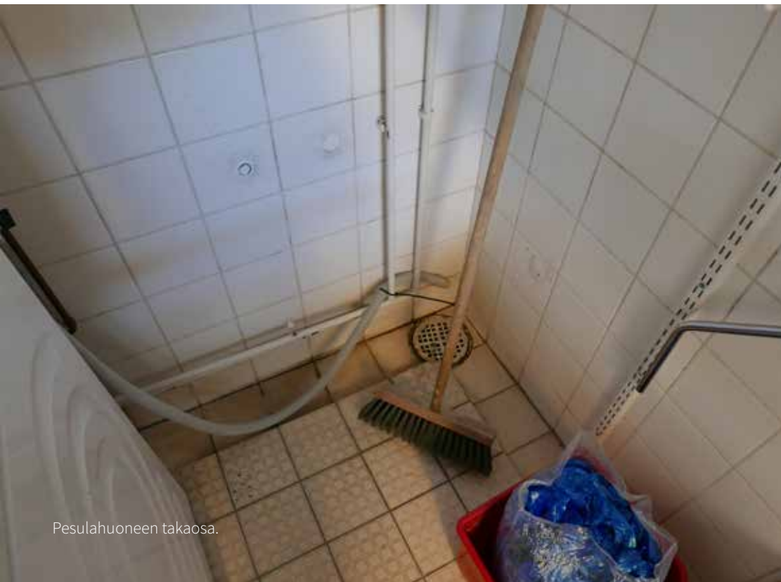
Pesulassa on edelleen suihkuja varten tehty laattapintainen lattiakouru seinän vierustalla.
