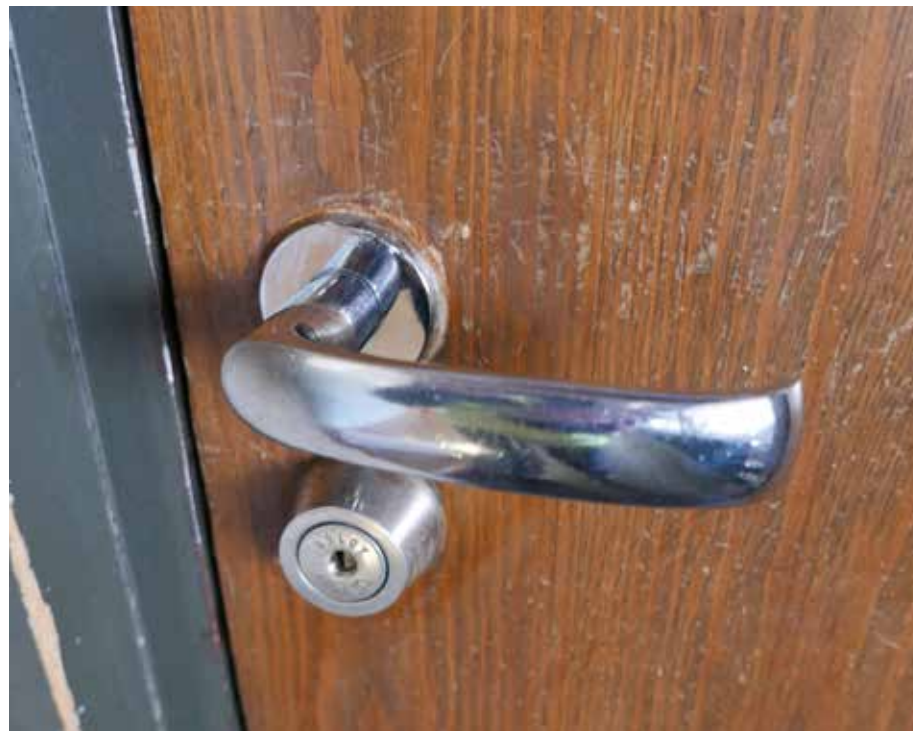
Aulassa sijaitseva puinen laakaovi ja sen alkuperäinen painike.
