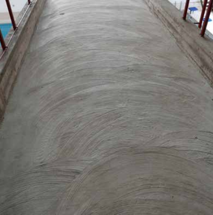
Hyppytasanteen valettu ja karhennettu betonipinta.
