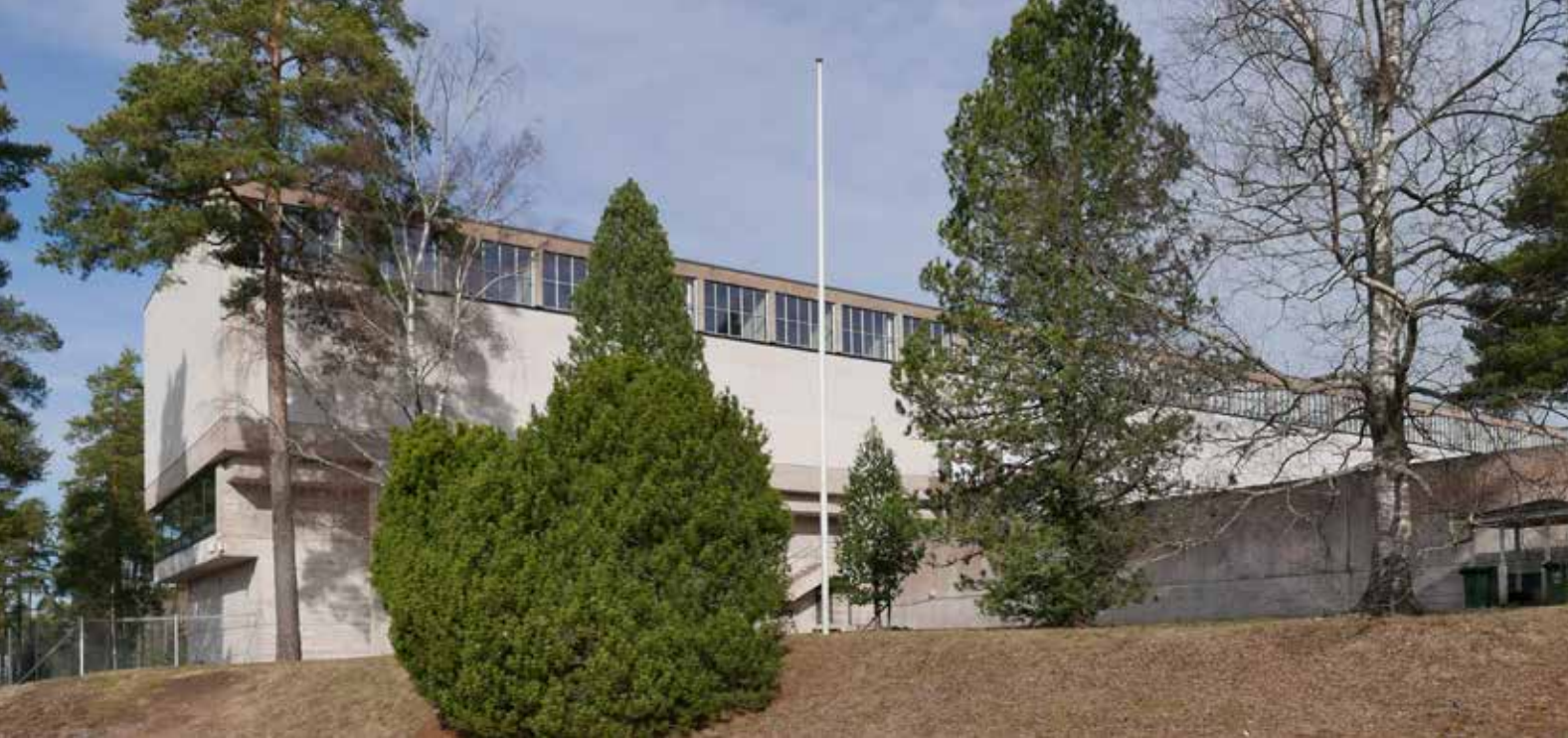
Eteläjulkisivu urheilukentältä lounaasta.
