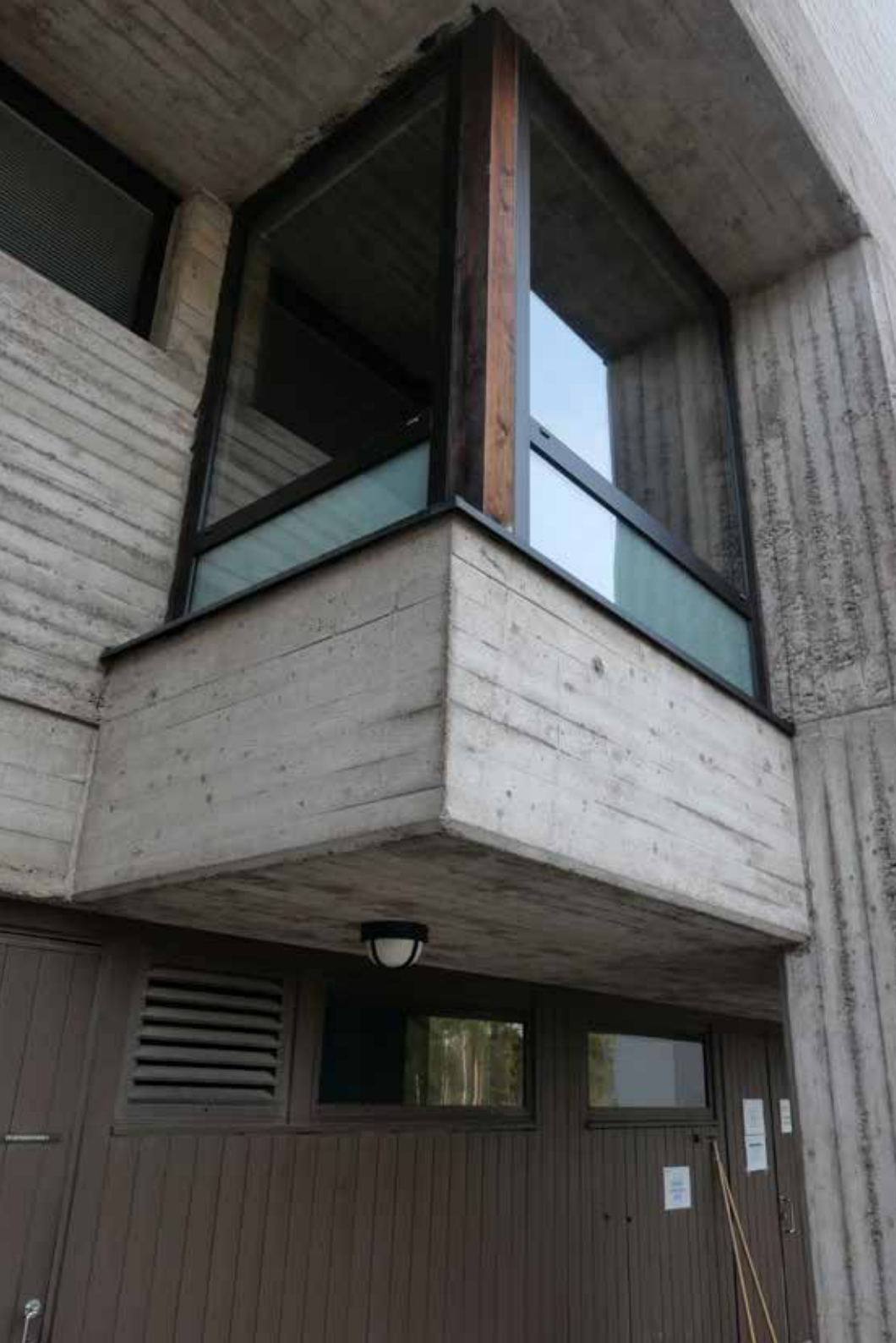
1.kerroksen puuikkunat ja puinen nurkkatolppa
