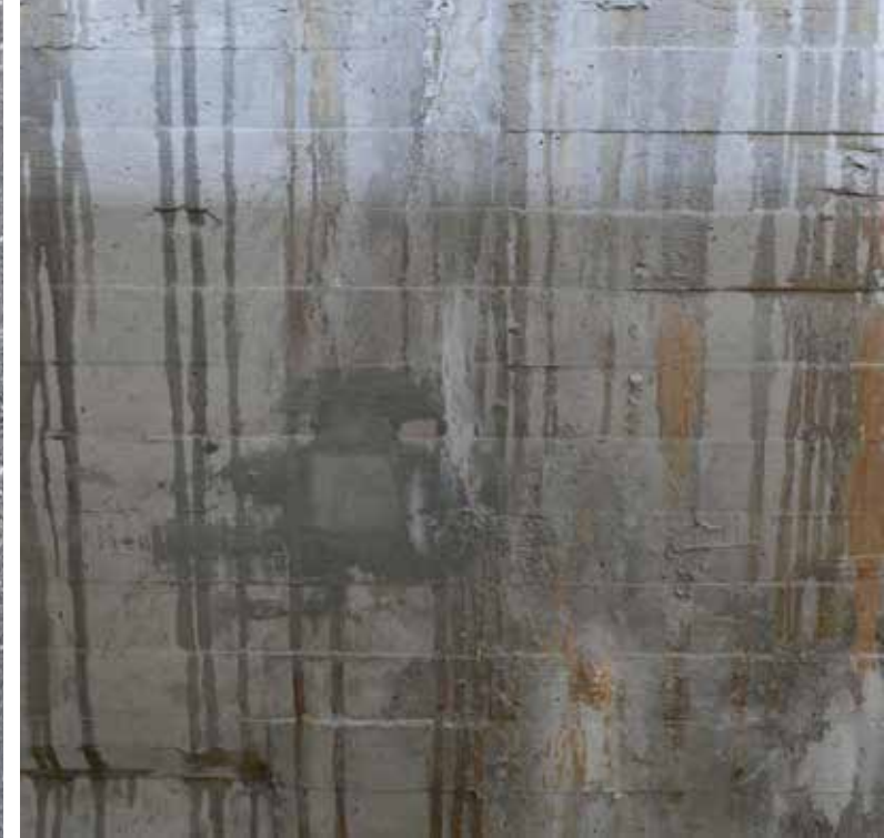
Altaan valettu betonipinta kellarin puolelta.
