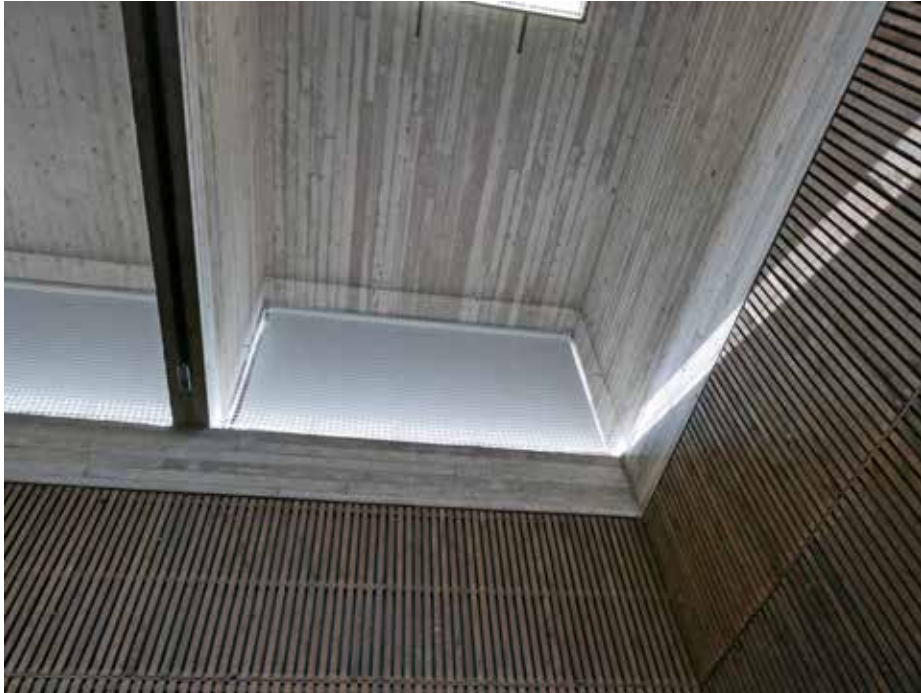
Salin lautamuottivalettu käsittelemätön betonipinta, palkit ja rimaverhous.
