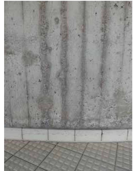
Lautamuottivalettu käsittelemätön betonipinta ja laatan seinänosto.
