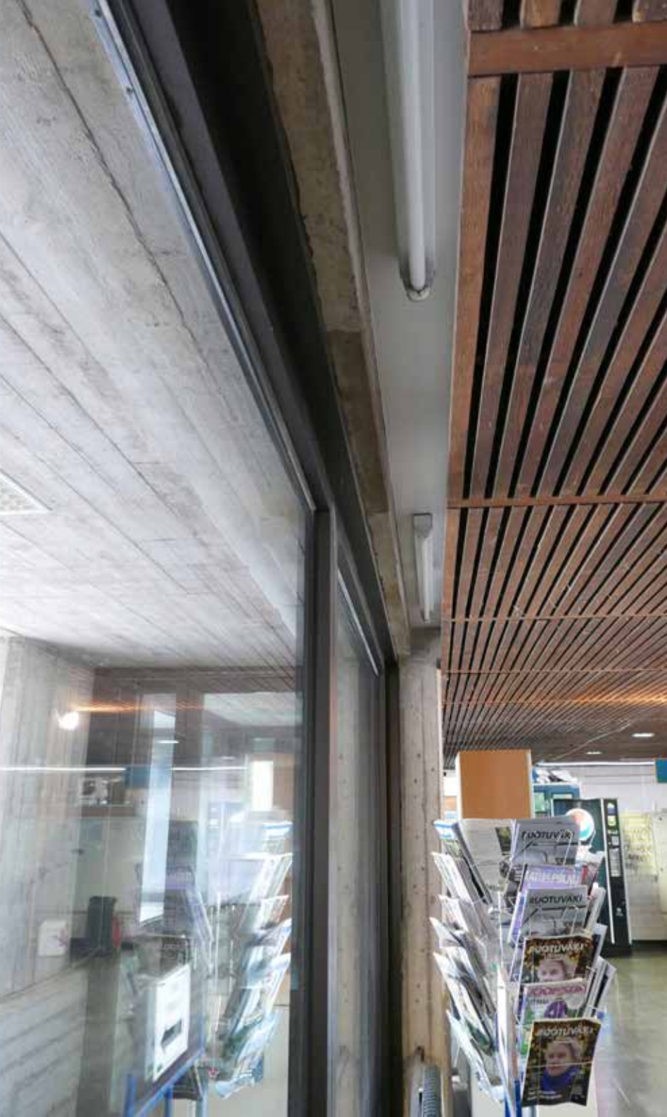
Lähikuva ritilän taakse piilotetusta loisteputkivalaisimesta.
