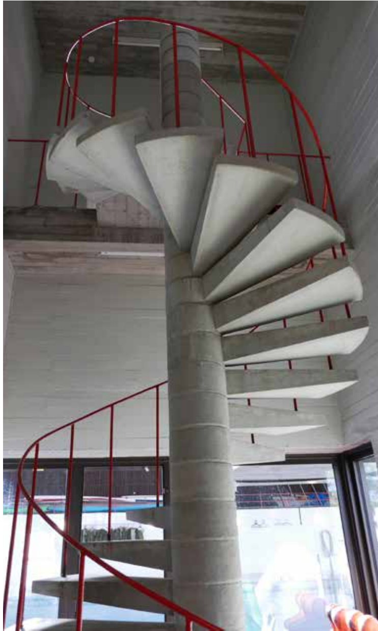
Ote kierreportaan piirustuksesta. Sisäportaavat ovat pääasiassa lautamuottiin valettua teräsbetonia, Arkkitehtuuritoimisto Osmo Lappo, 1964. PHA.
