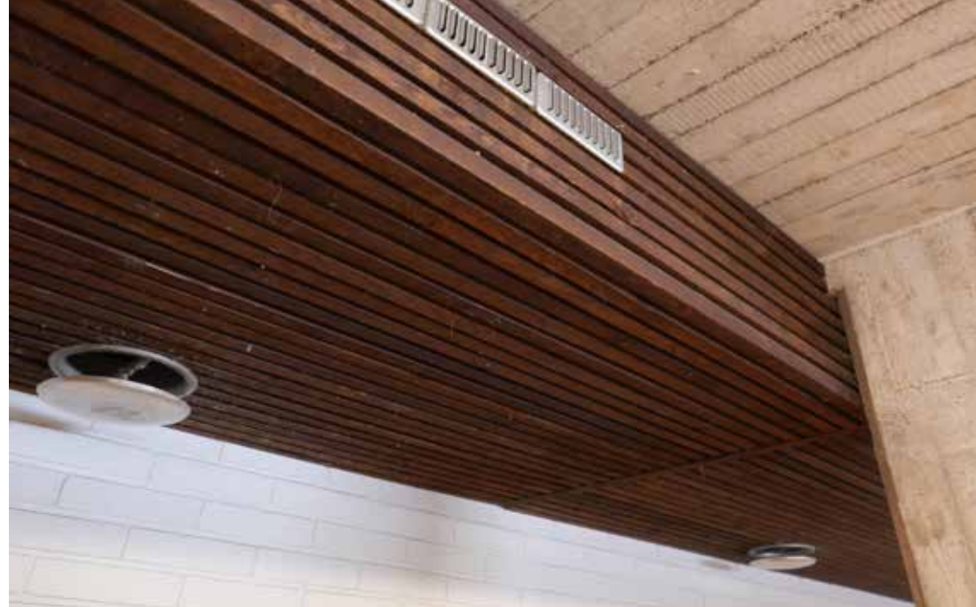
Näkymiä miesten pukuhuoneesta. Pukuhuoneiden välissä sijaitsee tekniikka- ja aputilavyöhyke. Sen katossa on rimaverhoiltu alaslasku.
