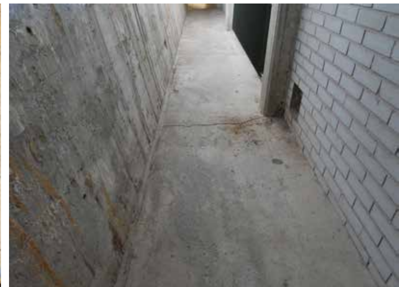
Altaan viereisen kuilun valettu betonilattiapinta kellarin puolelta.
