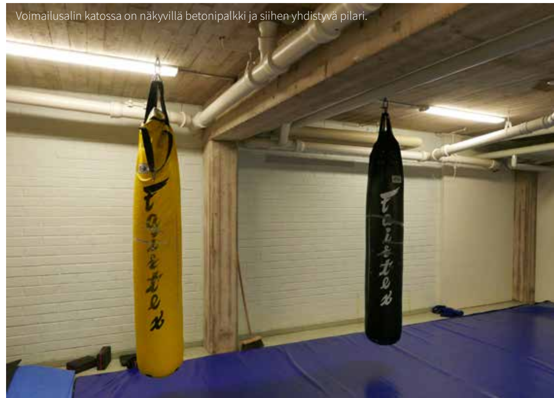
Voimasalissa on jyrkää betonipalkki ja siihen yhdistyvä pilari.
