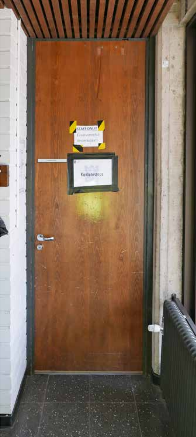
Aulassa sijaitseva puinen laakaovi.
