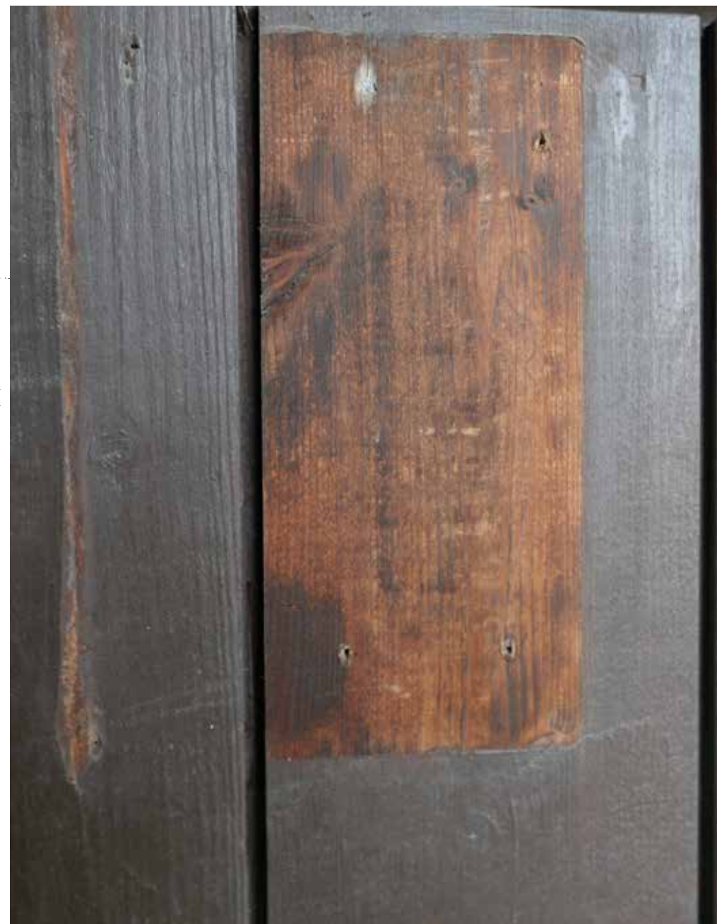
Lähikuva paljastuneesta kuultokäsittelystä ulko-oven puupinnasta.
