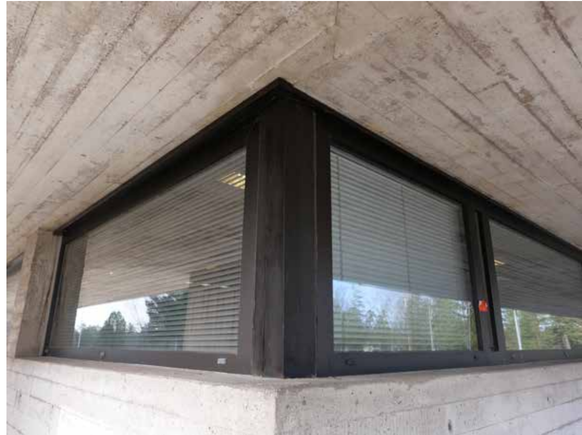
1.kerroksen puuikkunat ja puinen nurkkatolppa
