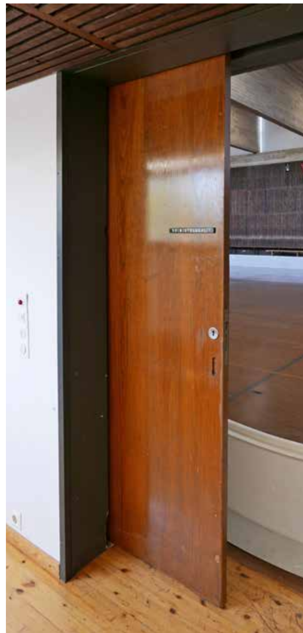
Liikuntasalin puinen liukuovi joka liukuu seinän sisään.
