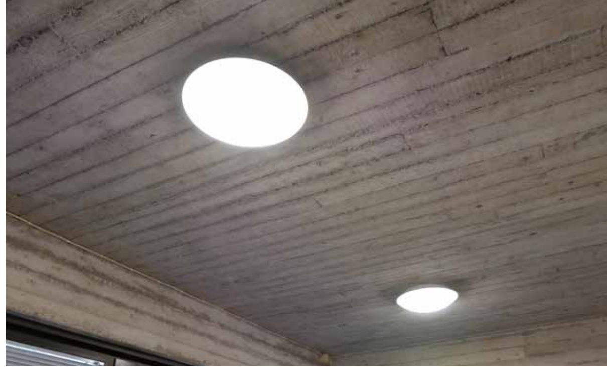
Lautamuottivalettu käsittelemätön betonipinta.
