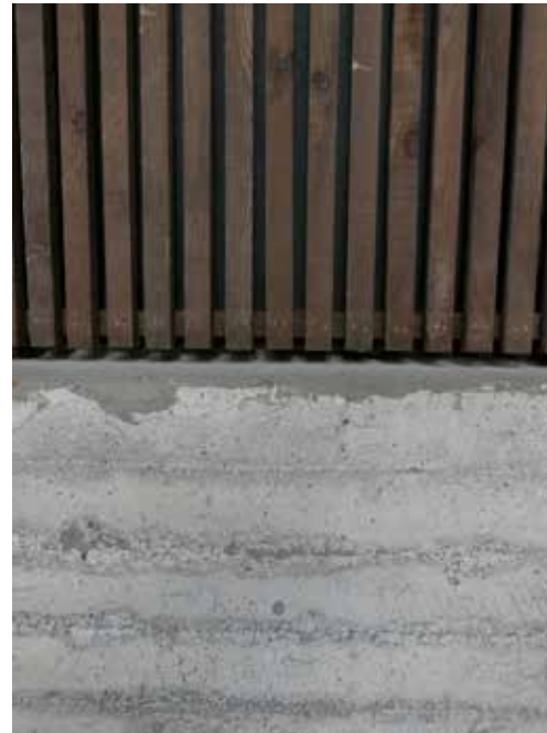
Lautamuottivalettu käsittelemätön betonipinta ja rimaverhous.
