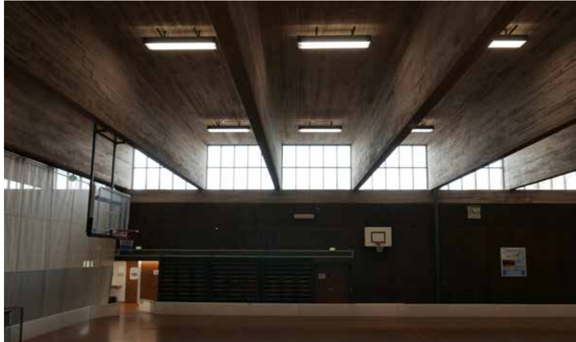
Liikuntasalin katon betonipalkisto ja niiden väleissä olevat ikkunat.
