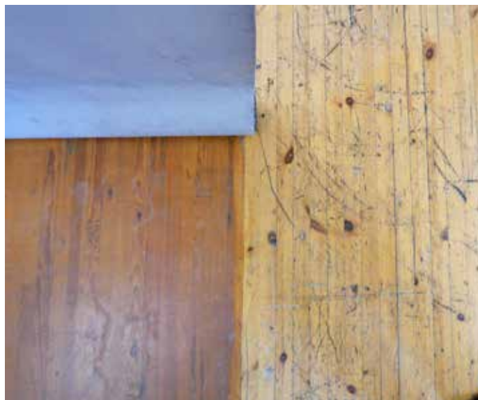
Liikuntasalin ja viereisen käytävän mäntylattiapintaa.
