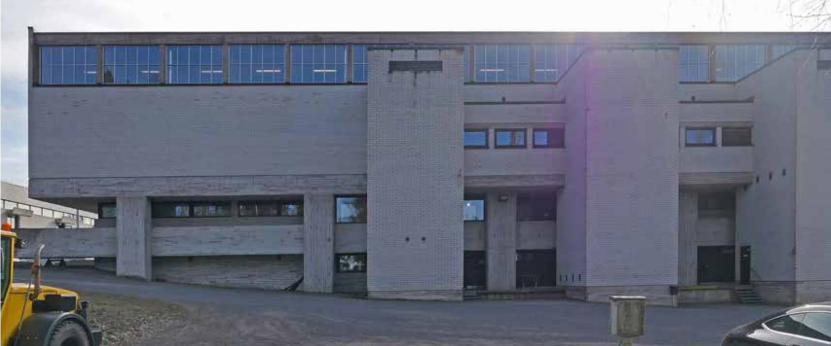
Tornit rakennuksen itäpäädyistä. Pohjoisjulkisivu.
