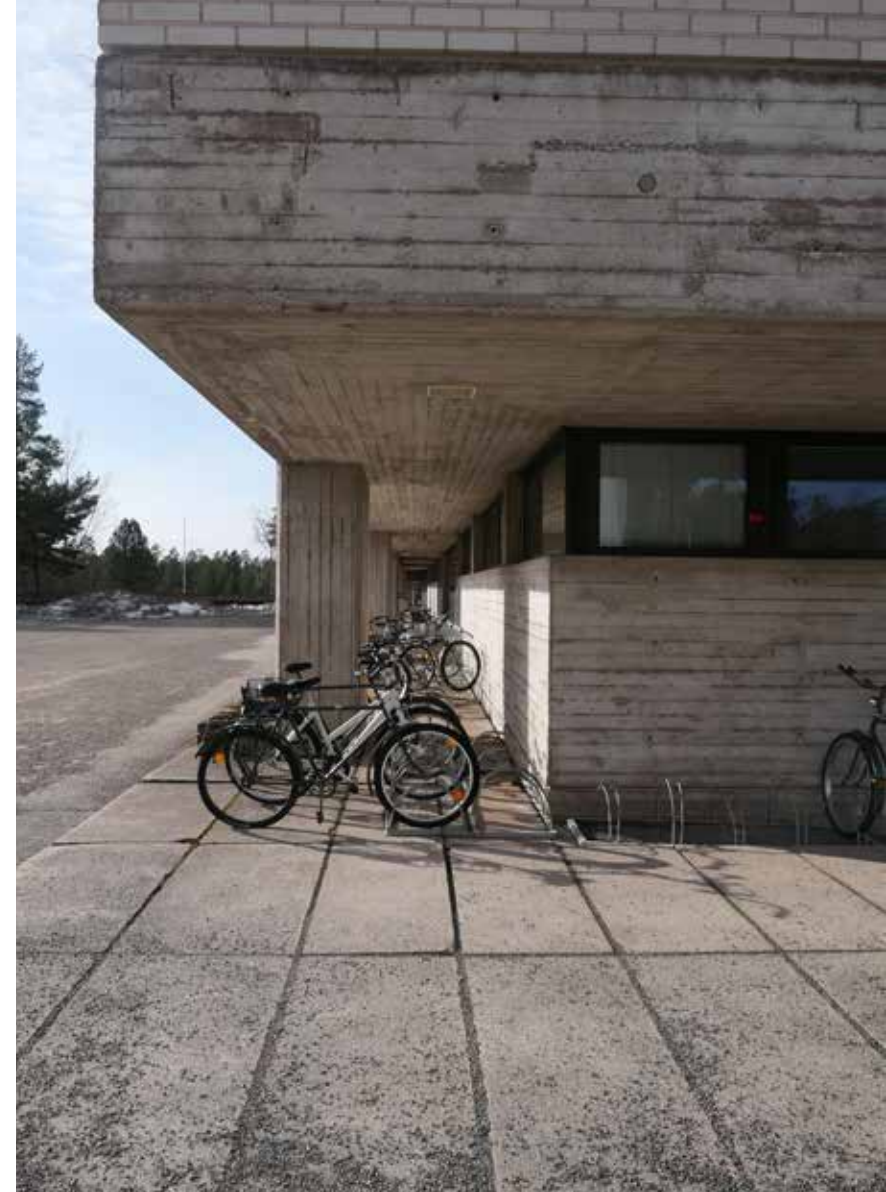
Sisäänvedetty pylväskäytävä itäpäädyssä.
