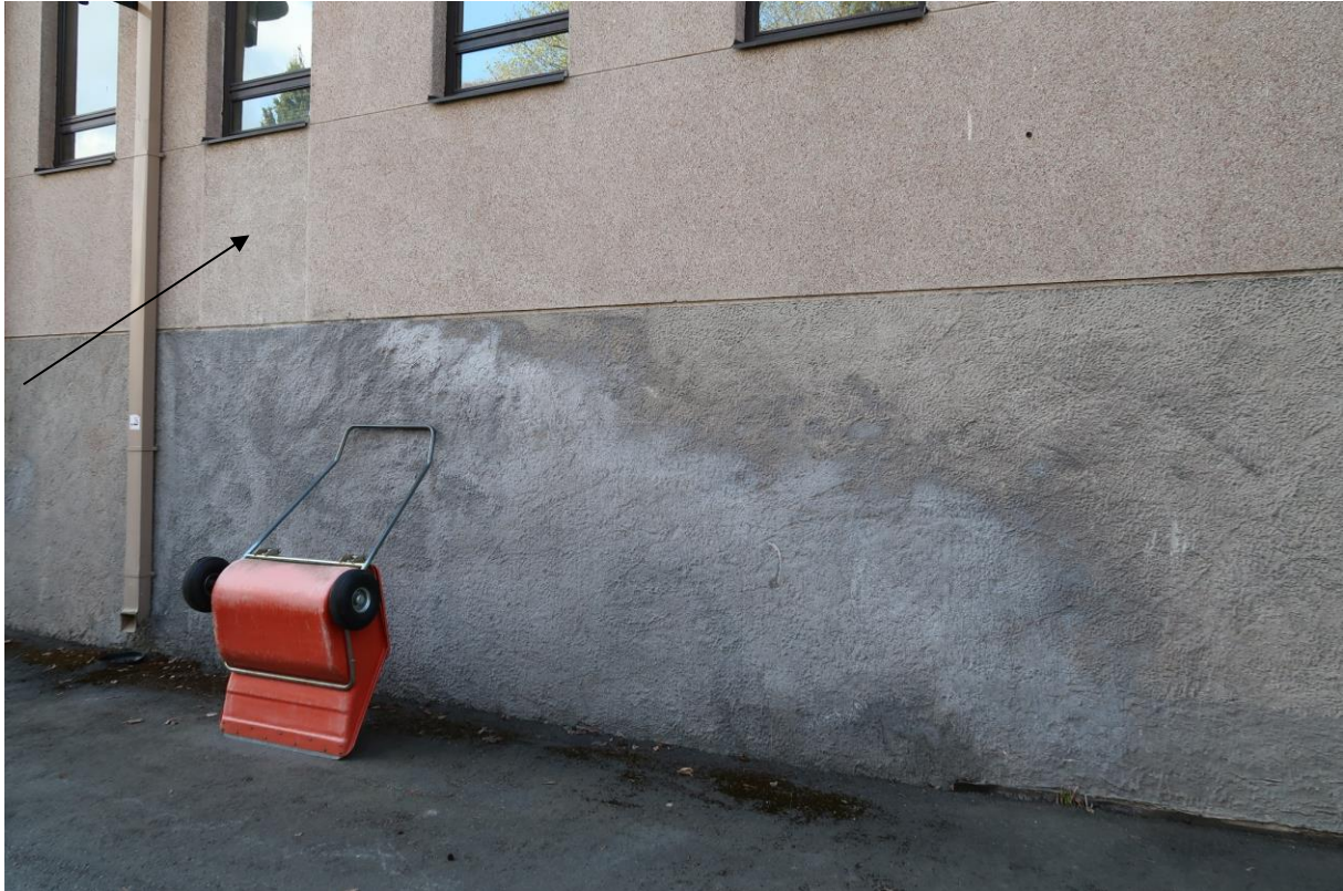
Julkisivussa oli nähtävissä ikkunaksi muutetun oven paikka (nuoli) sekä ovelle johtaneiden portaiden sijainti paikkarappauksena sokkelissa.
