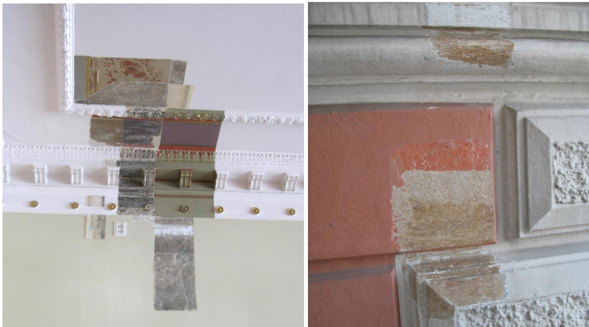
Väritutkimuksia. Vasemmalla esiinottoja ja niiden vierelle rekonstruoituja tulkintoja koristemaalauksista. Oikealla julkisivupinnan värikerrosten esiinotto.
