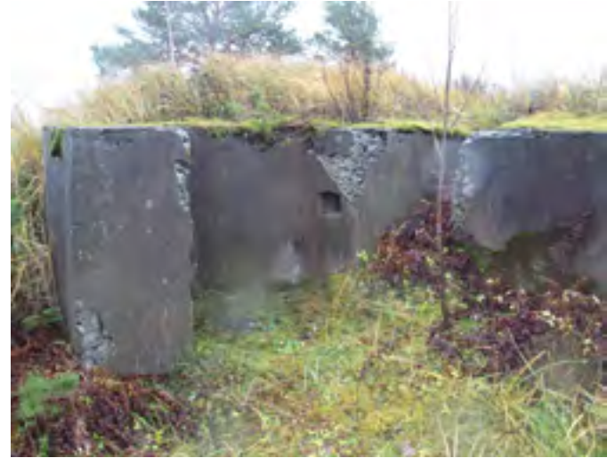
Yllä: Patterin no 1 itäpäähän vuonna 1907 rakennettu betoninen tulenjohtoaesema.
