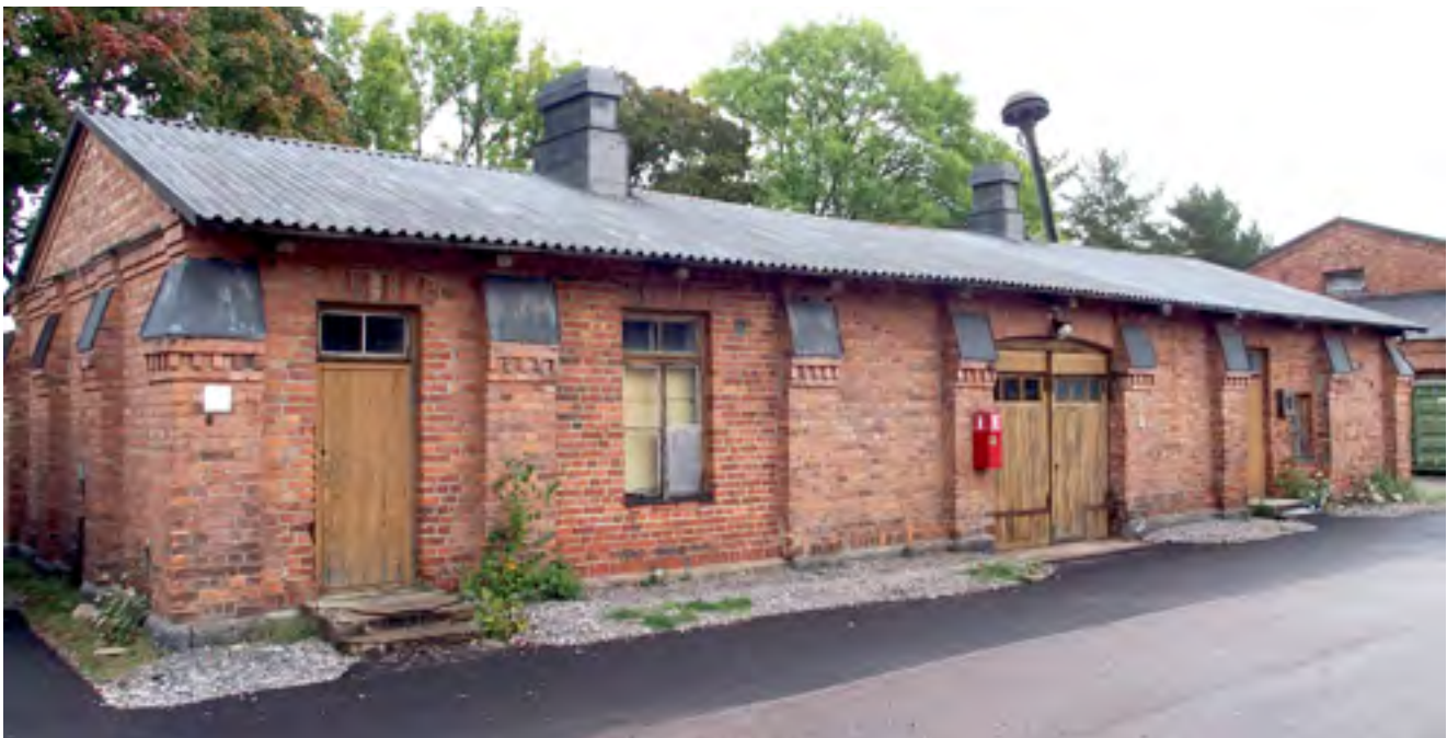
Alla: Kun entinen korppuvarasto muutettiin paloasemaksi, muurattiin julkisivun kolmesta pariovesta kaksi umpeen.
