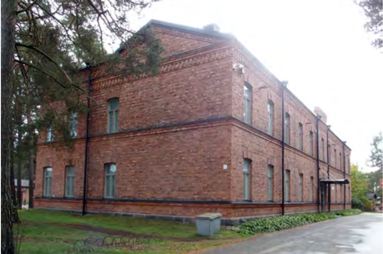
Yllä: Tiilinen sairaalarakennus.
