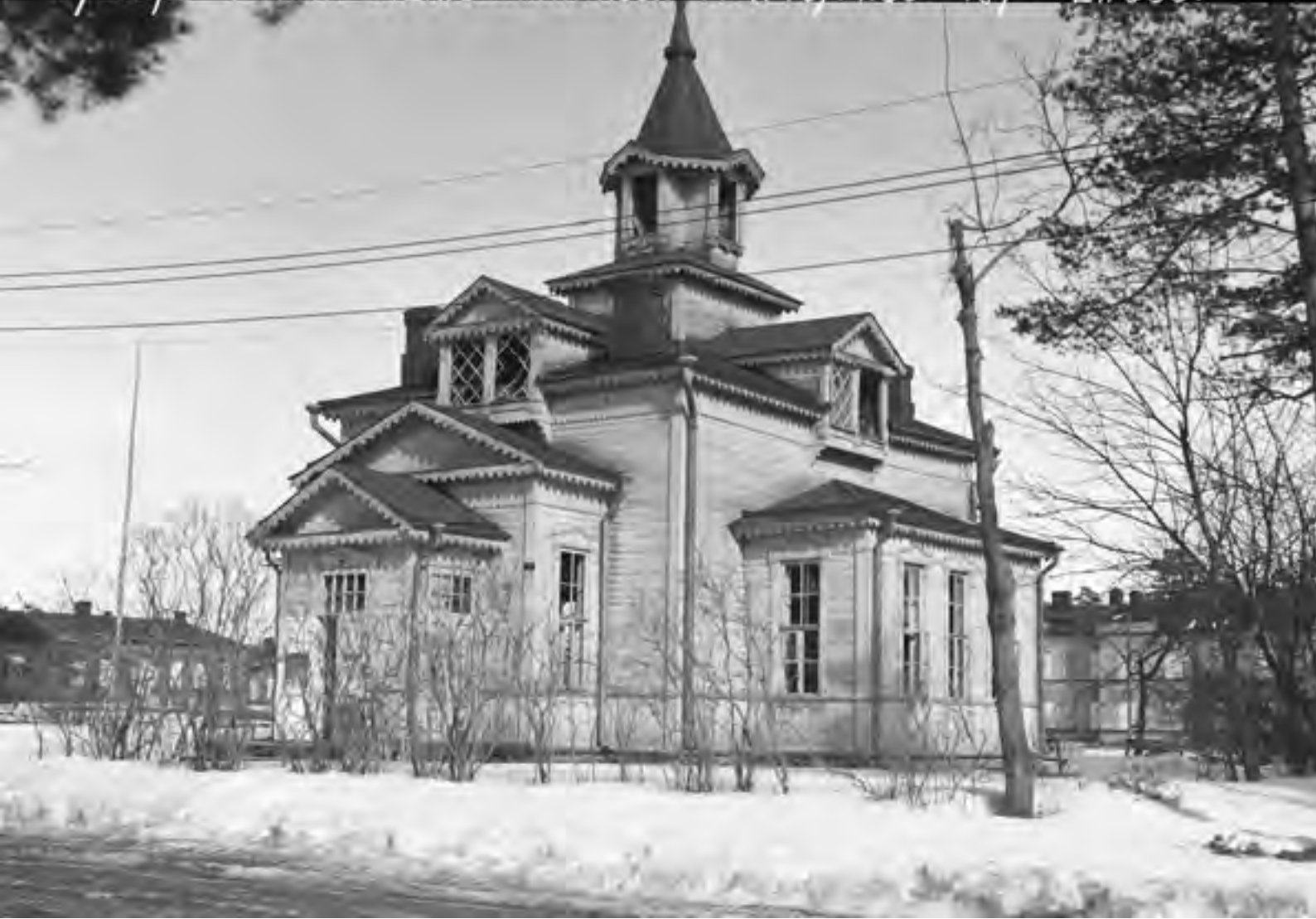
Yllä: Talvisodan ilmapommituksissa vaurioitunut kirkko. IVKK.
