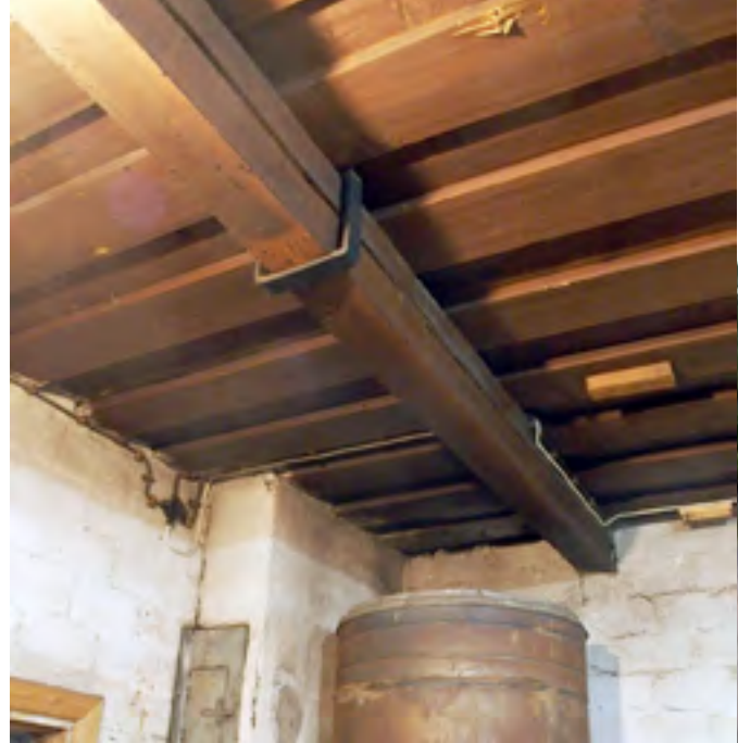
Yllä:: Kuormastovaraston puisia sisäkattorakenteita.
