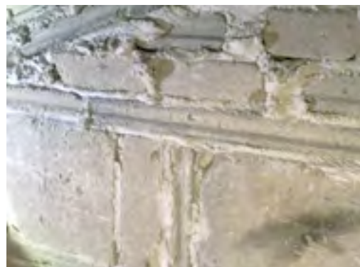
Yllä: Jääbetonitiilimuurausta upseeritalon ullakolla.
