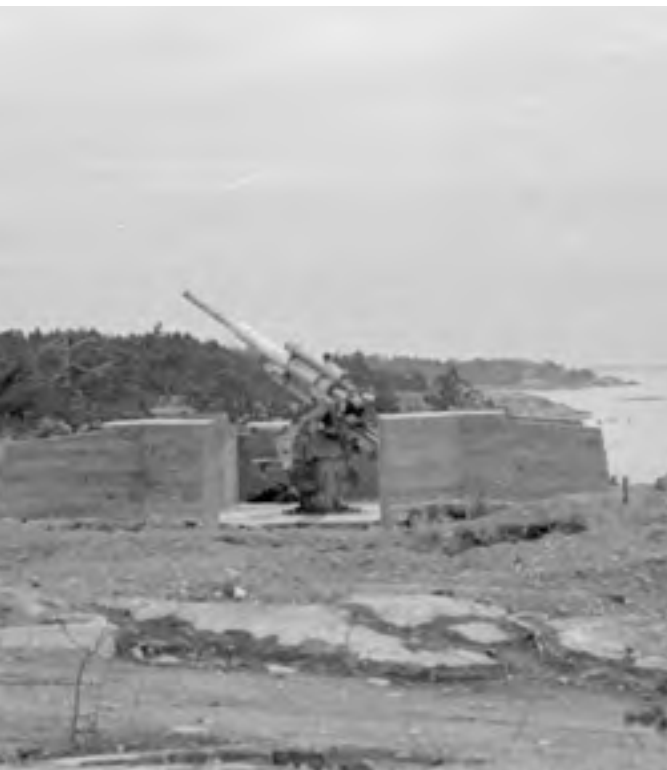
Alla: Patterin no 1 itäosan luokse rakennettu RMB-tykin asema syksyllä 1944. SA-kuva.
