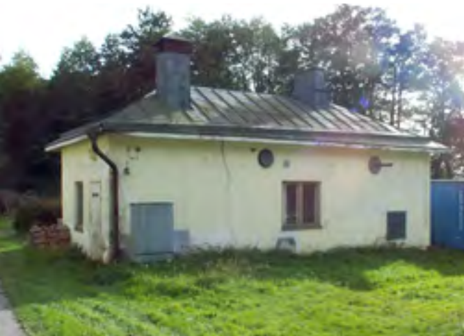
Alla: Radioaseman luokse vuonna 1950 rakennettu harkkorakenteinen, rapattu konehuone.
