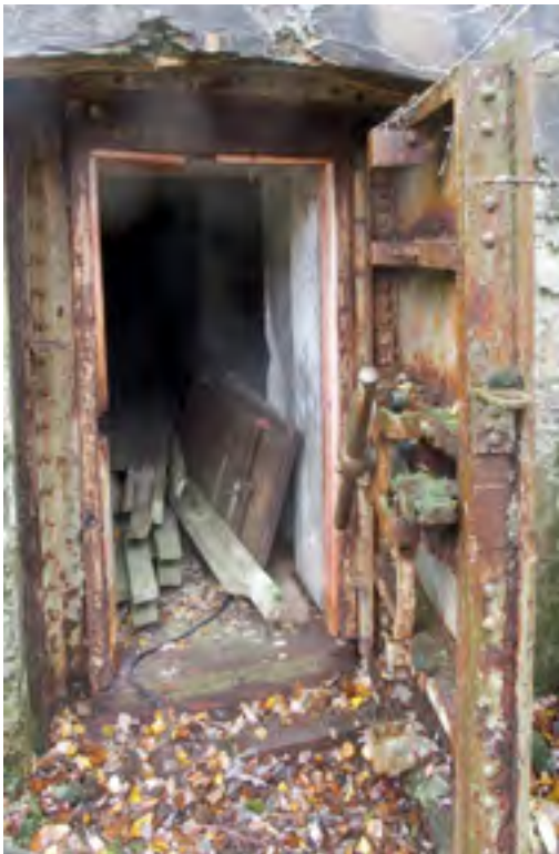
Alla: Panssariovi betonipatterin no 3 traverssin päädyssä.
