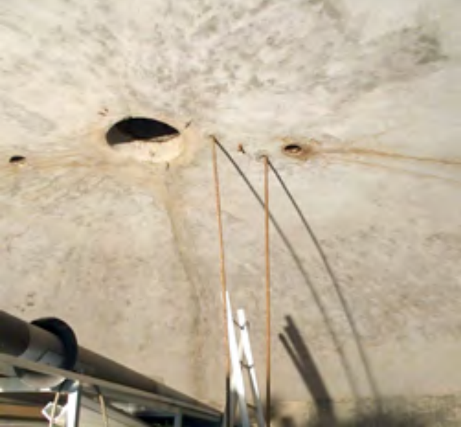
Yllä: Vedenpuhdistuslaitoksen edessä olevan betonisen säiliön kupolikatto.
