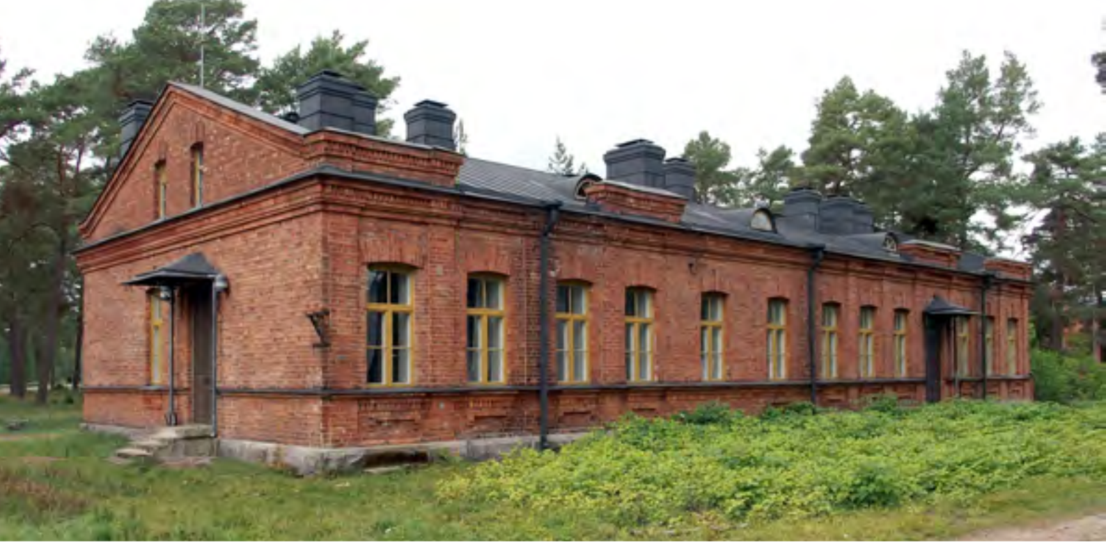
Yllä: Tiilinen upseeritalo. Kulmassa ollut ulkovi on muurattu umpeen ja uusi avattu päätyyn 1920-luvulla.
