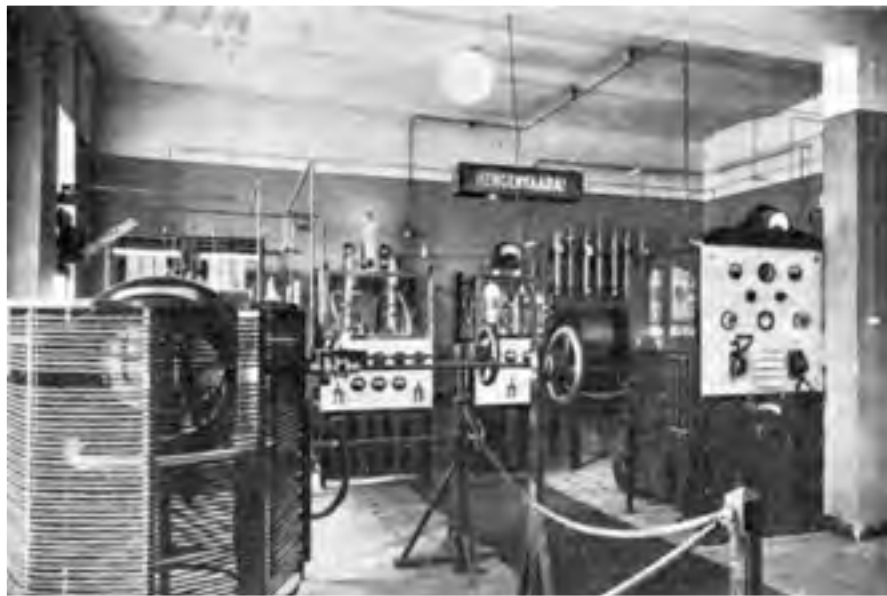
Yllä: Radioaseman sähkötyshuone, jossa vasemmal- la 15 kW:n putkilähetin ja oikealla vastaanotin. Julkaistu: US 7.2.1926.
