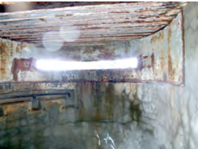
Yllä: Patterin no 4 länsipään komentopaikan panssarilevyllä vahvistettu tähtystysaukko. Sen alapuolella näkyy puhelinlaitteiden liityntäjohtoja, joille on valettu omat syvennyksensä. Katto on tuettu rautakiskoilla.
