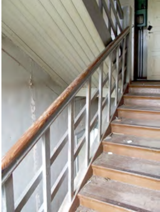
Yllä: Asuinrakennuksen porrashuone.
