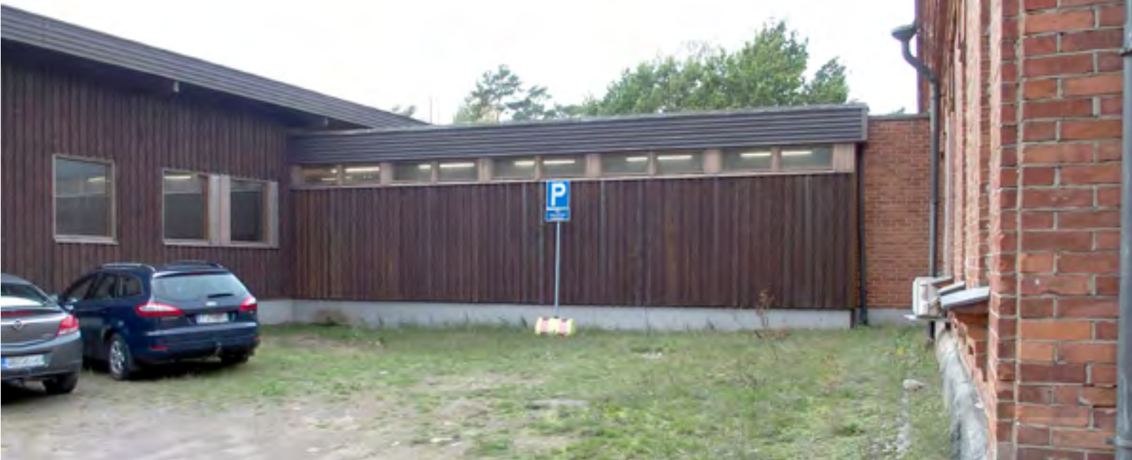
Yllä: Tiilisen entisen tykistöruokalan ja puuverhoilun huoltohallin välinen yhdyskäytävä.
