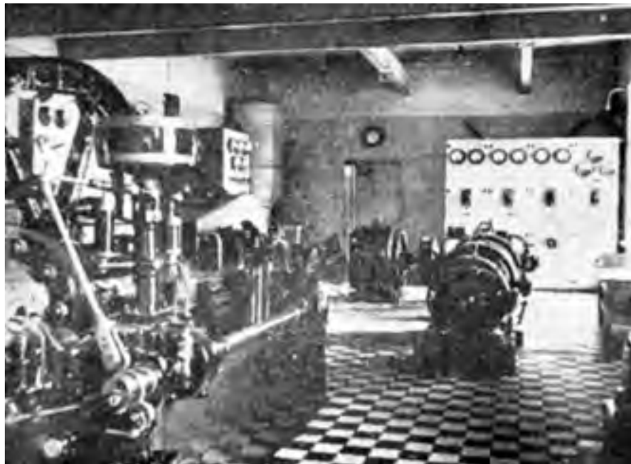
Oik. yllä: Radioaseman laitteistoja. Valaistun "Hengenvaara!" -kyltilin alla olivat mm. 12 000 voltin muuntaja, tasasuuntaaja, virityskäämit ja kondensaattorit. Julkaistu: Laivastolehti 2/1932.
