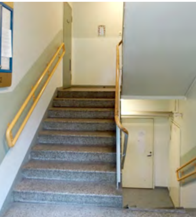
Alla: Asuinkeuhustalon porrashuone.
