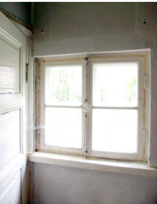
Alla: Eteisen ikkuna.
