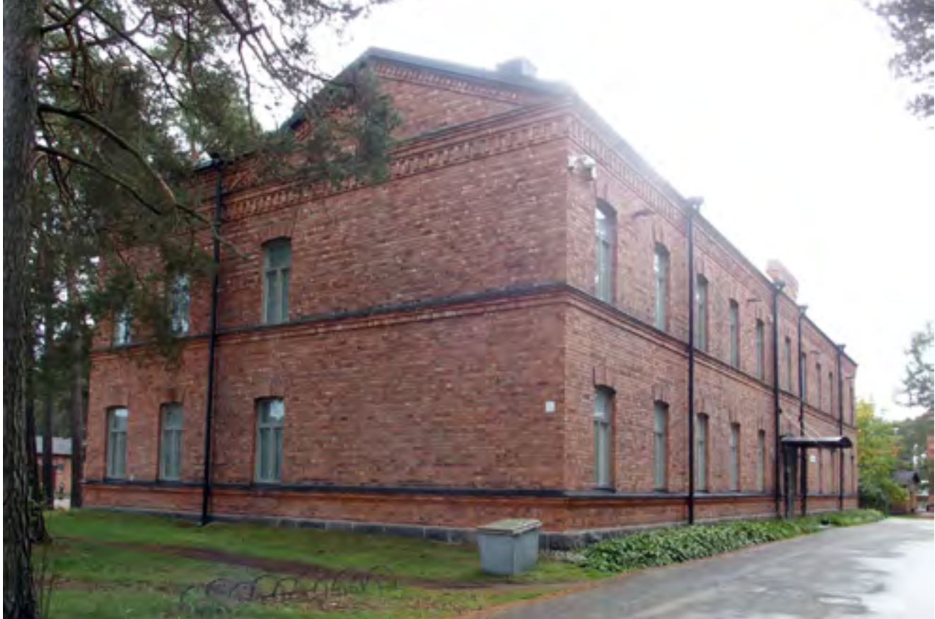
Yllä: Tiilinen sairaalarakennus.
