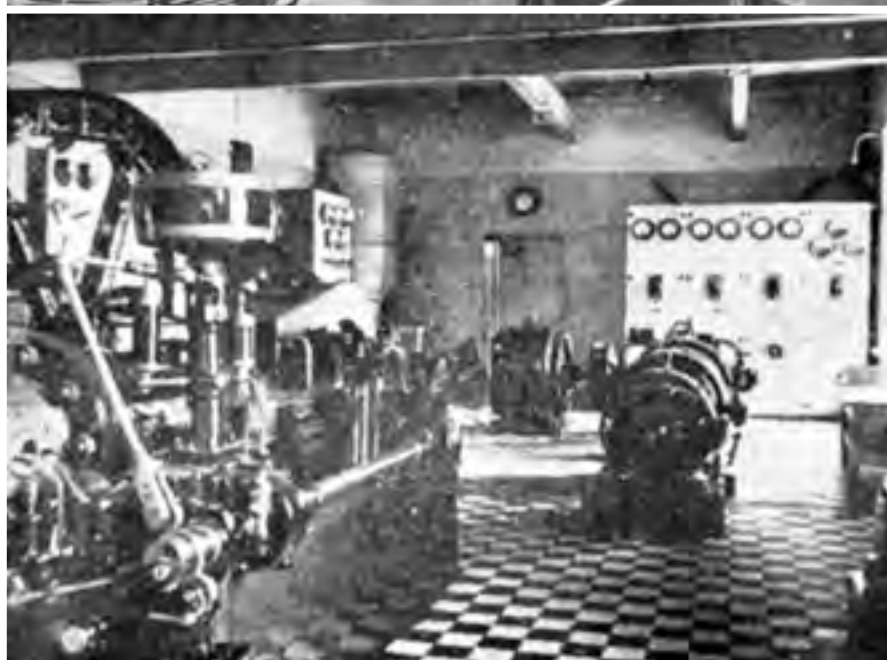
Oik. yllä: Radioaseman laitteistoja. Valaistun "Hen- genvaara!" -kyltin alla olivat mm. 12 000 voltin muuntaja, tasasuuntaaja, virityskäämit ja konden- saattorit. Julkaistu: Laivastolehti 2/1932.
