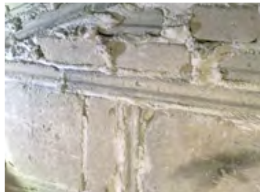
Yllä: Jääbetonitiiliimuurausta upseeritalon ullakolla.
