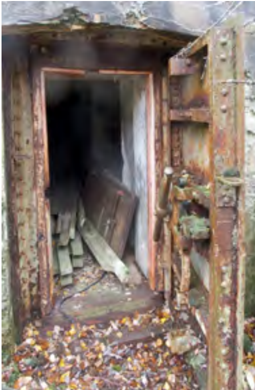
Alla: Panssarioivi betonipatterin no 3 traverssin päädyssä.
