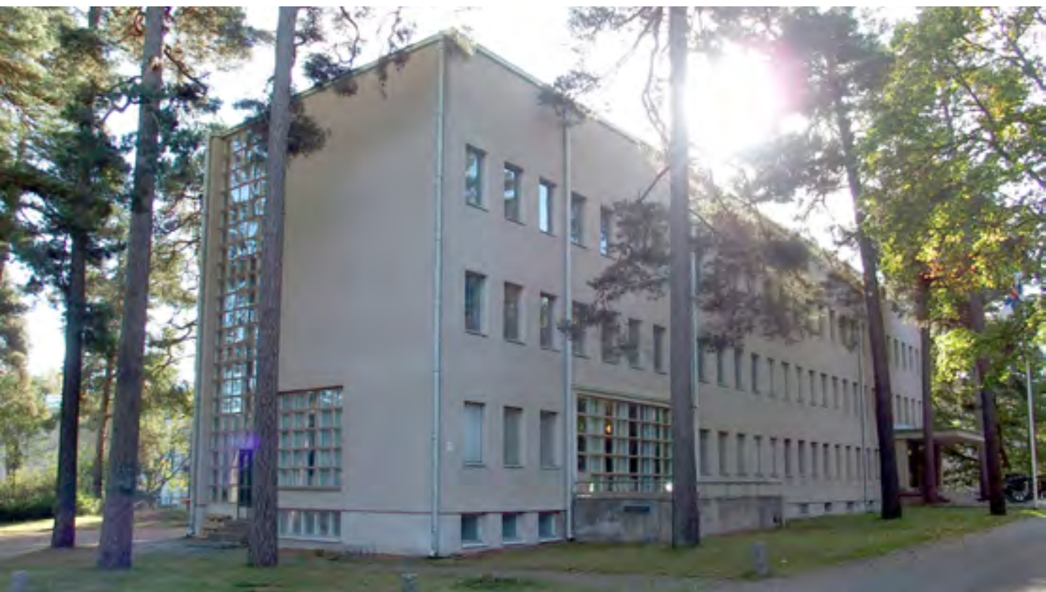
Alla: Päärakennuksen pohjoispääty.
