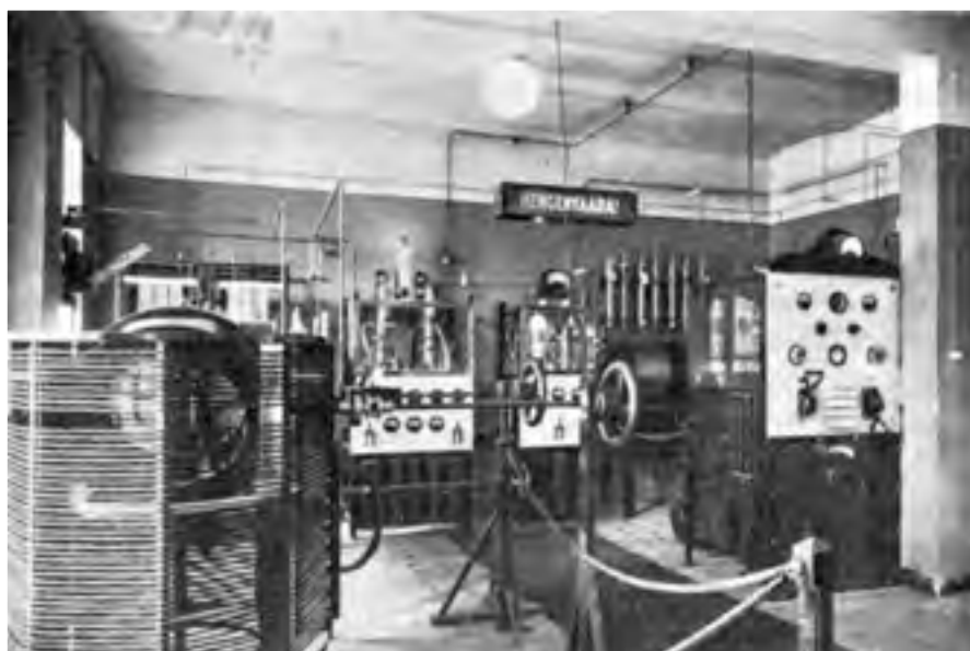
Yllä: Radioaseman sähkötyshuone, jossa vasemmal- la 15 kW:n putkilähetäjä ja oikealla vastaanotin. Julkaistu: US 7.2.1926.
