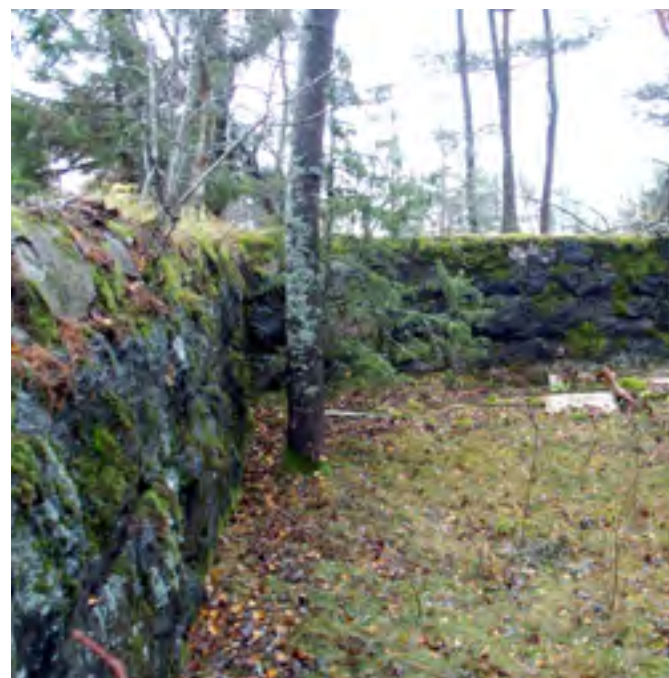
Yllä: Patterin no 6 betonilla vahvistettu kivinen rintasuoja.
