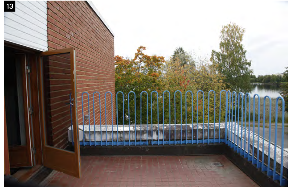
↑ Toisen kerroksen hallista on käynti terassille. Näkymät avautuvat Kalavedelle. Terassin kaide muodostuu U-muotoisista pinnakaiteista, joiden sininen väri on tiettävästi alkuperäinen. Lattia on laatoitettu terrakotan värisillä laatoilla.
