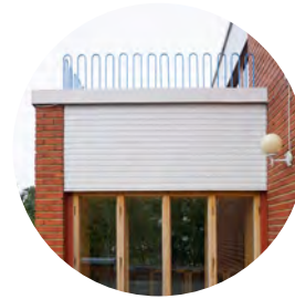
parvekkeen taivutettu metallikaide
