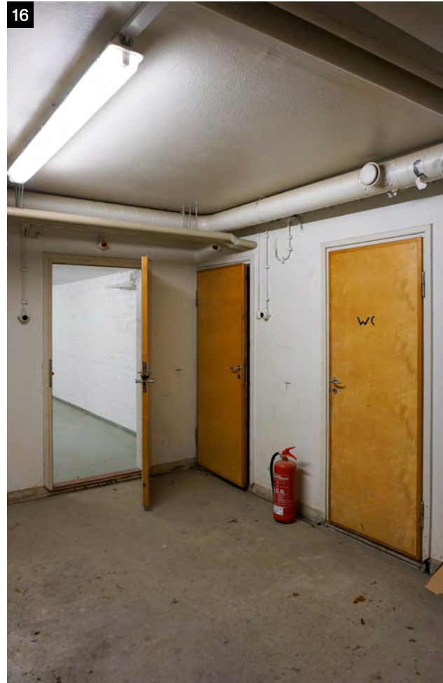
↑ Kellarin lattiat ovat pääosin maalattuja betonilattioita, seinät maalattuja betoniseiniä ja katot maalattuja betonikattoja. Kellarin ovet ovat pääosin alkuperäisiä lakattuja vaneriovia.
