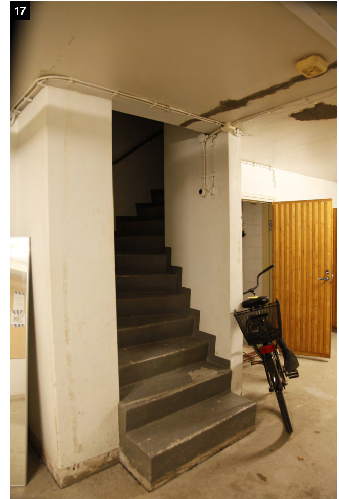
↑ Kellarista ensimmäiseen kerrokseen johtava kaareva porrashuone yhtyy ensimmäisessä kerroksessa pohjoisjulkisivun sisäänkäyntiin. Porras on betonirakenteinen.
