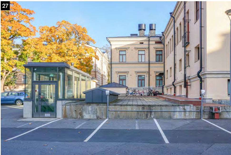
← Kellariin johtava teräslasirakenteinen palokunnan hyökkäystien maanpäällinen osa on uusittu vuoden 2008 jälkeen.
