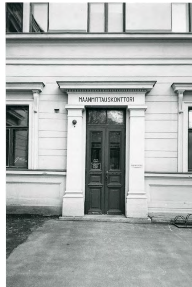
↑ Maanmittauskonttorin pääsisäänkäynti sijaitsee vuoden 1896 laajennusosassa, ja sisäänkäyntialuetta muokattiin korottamisen yhteydessä vuonna 1911. Kuva Helena Riekkä, 1985. KKM.
