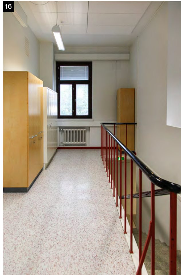
↑ Laajennusosan porrashuone yhdistää kerrokset eri tasoissa olevaan vanhaan osaan. Porras ja ylätasanteen kaide ovat oletettavasti alkuperäisiä 1930-luvulta.
