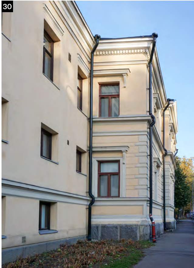
↑ Vanhan osan ja laajennuksen liittymäkohta Sepänskadulla. Osa julkisivulistoista ja ylimmän kerroksen ikkunat on sovitettu samaan kokoon, mutta muuten laajennusosan linjat eivät noudata vanhan osan sommitelmaa.
