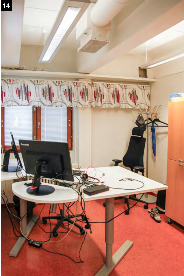
↑ Laajennusosan alemmissa kerroksissa on näkyvissä betonirakenteinen välipohjapalkisto.
