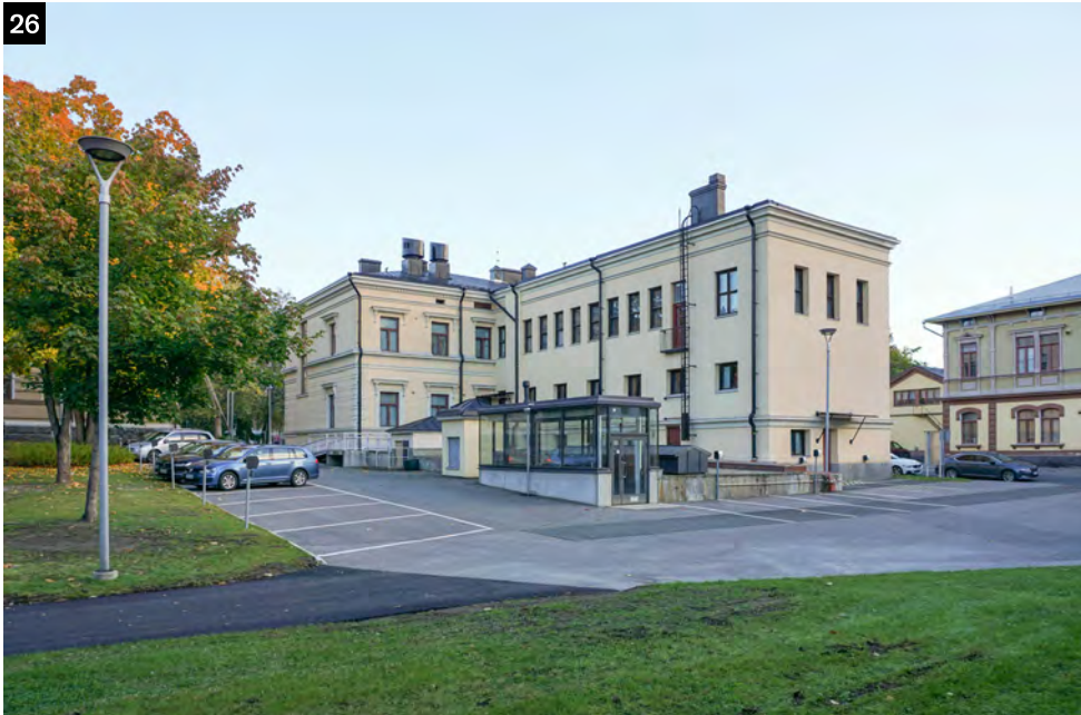
← 1930-luvun laajennusosan pihan puolella on korotetun kellarin katto. Kellarin nykyiset maanpäälliset rakenteet ovat pääosin 1990-luvulla uusittuja.
