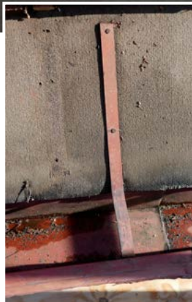
↑ Vanhat tukiraudat olivat ohuempia ja kapeampia ja ne oli kiinnitetty nauloin. amoy 8.4.2020
