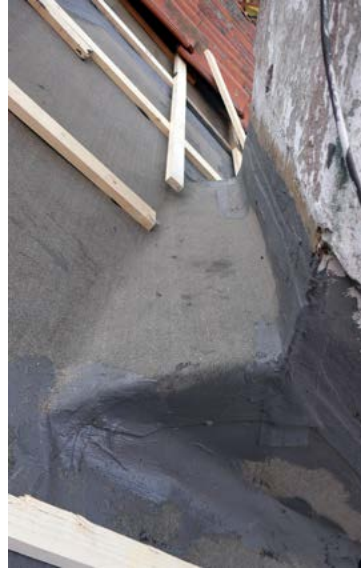
Kuvat yllä: Piipun yläpuolinen poikkilape Ukri Oy 3.4.2020, amoy 8.4.2020 ja amoy 21.4.2020
