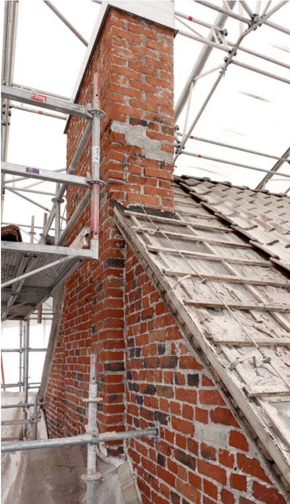
← Eteläpääty ja savupiippu märkälasi puhalluksen jälkeen. amoy 17.05.2022
