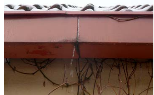
↑ ↑↑ Vesivuotoja Ateljeen itälappeen kourussa. Ylempää kuvassa vuodon alle talven ajaksi tehty väliaikainen veden ohjaus rappausvaurioiden vähentämiseksi. amoy 1.12.2020
