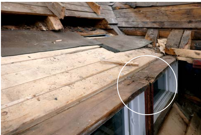
↑ Kattoikkuna i.215 kattolapteen tiiliruoteiden ja aluskatteen poistamisen jälkeen. amoy 4.6.2020
