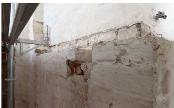
↓ ↓↓ Luoteiskulmalla, missä muuraus oli pahiten vaurioitunut, päällimmäinen tiilirivi muurattiin uudestaan. Samalla tiilen yläpinnan korkoa saatiin laskettua hieman alemmaksi, jolloin pellityksen kaadot saatiin kuntoon. Ikkunan alakarmi sijaitsi aiemmin huomattavan matalalla suhteessa muurin ja pellityksen yläpintaan. amoy 20.9.2022
