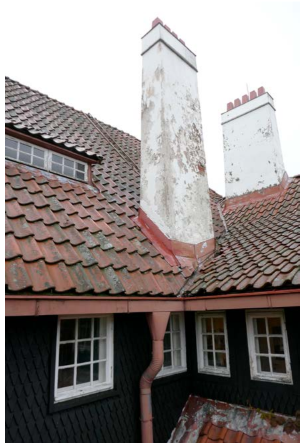
↑ ↓ Valokuvat syksyllä 2018 nostimella tehdystä vesikattokatselmuksesta. amoy 9.10.2018.
