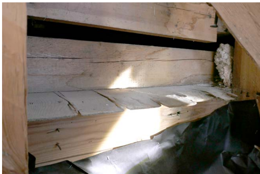
↑ Kylpyhuoneen ikkunan yläpuolista koteloa jakava hirsiseinä. Hirsiseinän oikealla puolella kotelo oli eristetty mineraalivillalla. Vasemmalla puolella eristeenä on olkipohku. amoy 3.12.2018
