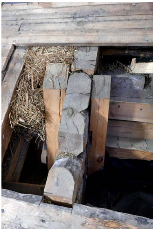
↑ Kylpyhuoneen ikkunan yläpuolista koteloa jakava hirsiseinä. Hirsiseinän oikealla puolella kotelo oli eristetty mineraalivillalla. Vasemmalla puolella eristeenä on olkipohku. amoy 3.12.2018
