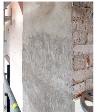
↘ Pohjoissiiven piipun eri rappauserrokset. Oikealla sivulla tartuntarappaus, etupinnassa alhaalla täyttörappaus ja etupinnassa ylhäällä hierretty pintarappaus. amoy 11.10.2022
