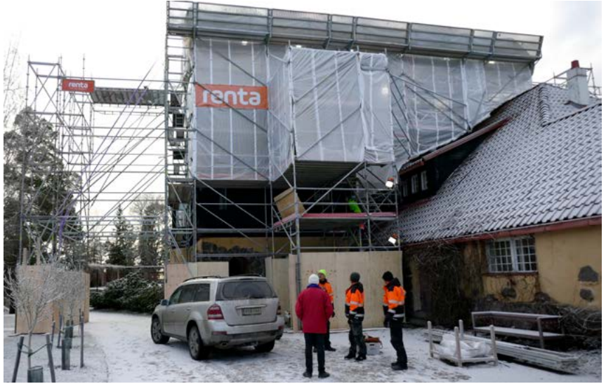
↑ Telineiden vesikatoon kohdistama kuorma poistettiin telineiden toisessa päässä olevalla vastapainolla. amoy 26.11.2018
