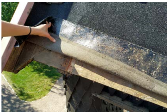
↑ Räystästä pitkin otetussa kuvassa näkyy räystäslinjan kuperaus. amoy 23.6.2021
