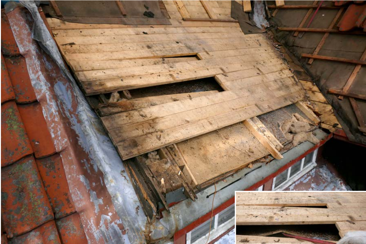
↑ Kattoikkuna i.215 kattolapteen tiiliruoteiden ja aluskatteen poistamisen jälkeen. amoy 4.6.2020
