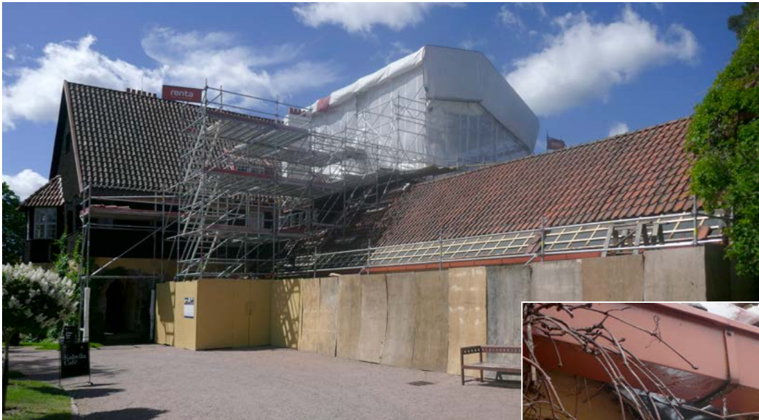
↑ Työmaa-alue. Korjaustyö tehtiin saman aikaisesti Eteläsiiven länsilape / 2:n korjaustyön kanssa. amoy 15.6.2021
