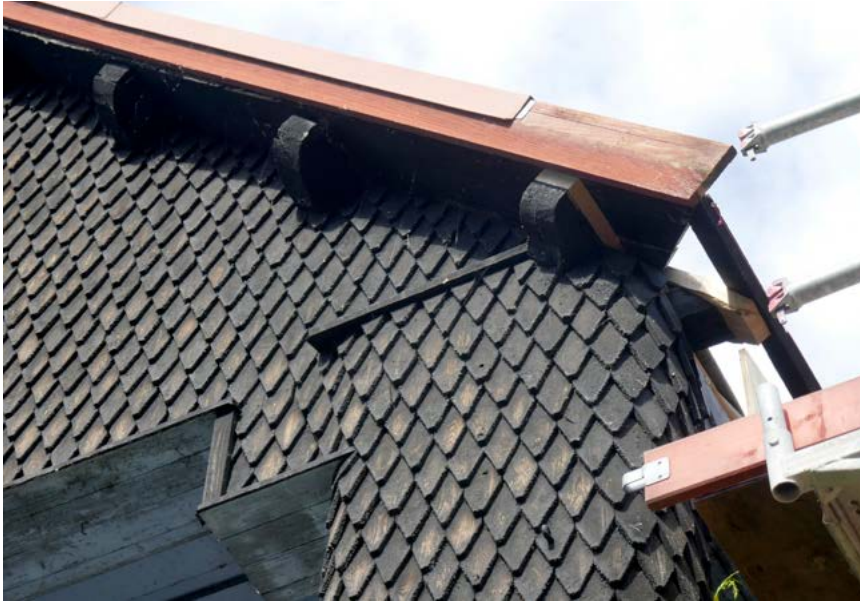
← Kulman molemmin puolin vasojen päälle tehtiin korokpalikat, joilla räystä oikaistiin. Kuvassa oikealla tukipalikka, jolla on haettu räystäään oikeaa korkoa. amoy 2.7.2021
