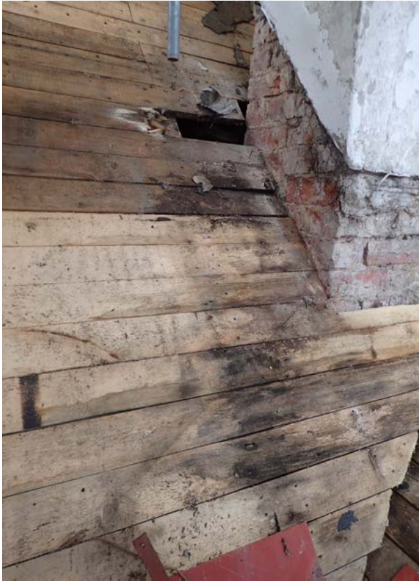
↑ ↗ Piipun 308A itäpuolinen ja pohjoispuolinen lahovaurio ennen aluslaudoituksen purkamista. Ukri Oy 23.11.2018
