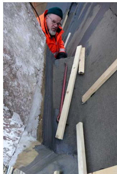
↑ Piipun takaisen lappeen alusri- moituksen ja sen päälle tulevan pelli- tysratkaisun pohdintaa. amoy 8.4.2020.
