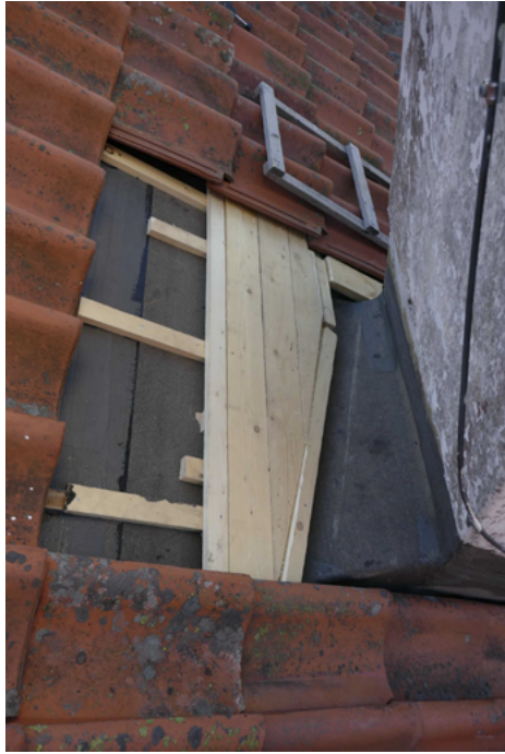
Kallistuksen pohja tehdään piirustuksen 1261 013-2c tapaan. Kuvassa Eteläsiiven länsilapteen piipunjuuri.
