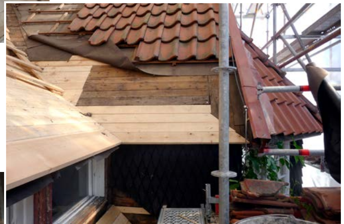
↑ Kattoikkunan i.215 vasemman sivun kantavien rakenteiden lahovaurioituneet kohdat uusittiin puupaikoin. Kattoikkunan keskeltä nykähtänyt rakenne oikaistiin ja ikkunan alle tehtiin uusi pitkitäinen kannatinpalkki, joka tukeutuu ikkunan sivuilla kulkeviin kattovasoihin. amoy 18.6.2020
