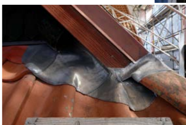
↘ → Veden valuminen eteläpäädyn pellitystä pitkin harjatiilien alle estettiin lyijypellityksellä. amoy 18.8.2020
