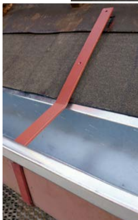
↑ Uusi yläpuolinen tukirauta, kourun kannatinkoukku on vanha. amoy 27.3.2020
