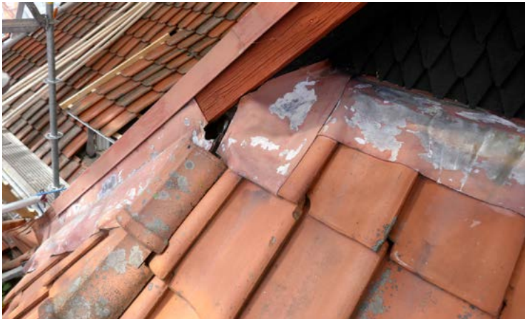
ERKKERIN LYIJYPELLITYKSEN ONGELMIA kuvat amoy 6. - 30.7.2020
