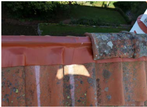
↑ Harjatiilien asennus lyijypellityksen päälle. amoy 22.09.2023
