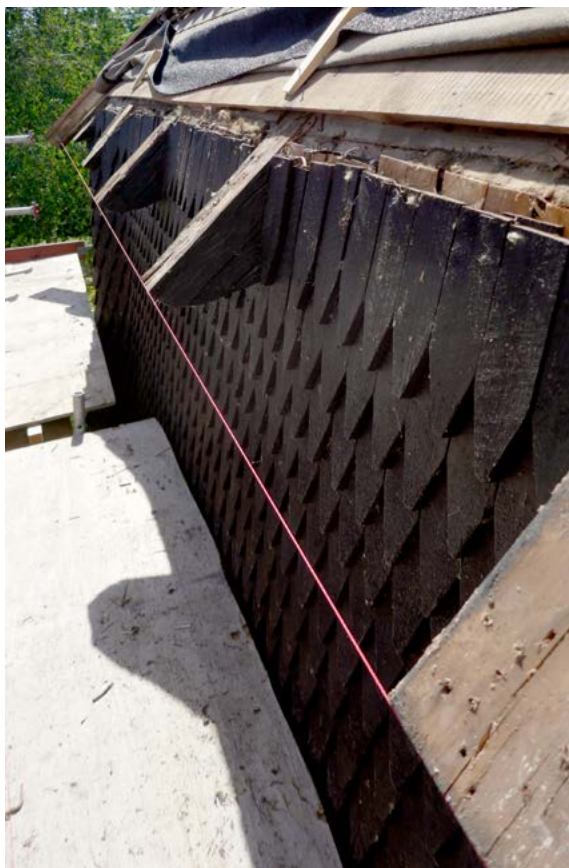
← Linjalanka osoittaa viimeisten vasanpäiden olevan sisempänä. amoy 29.6.2021
