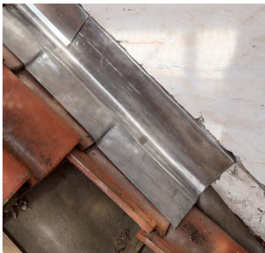
ETELÄJULKISIVUN SEINÄLIITTYMÄ
