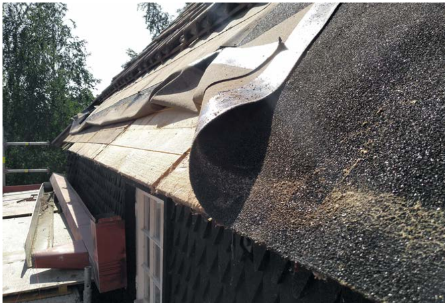
↑ Räystästä pitkin otetussa kuvassa näkyy räystäslinjan kuperaus. amoy 23.6.2021
