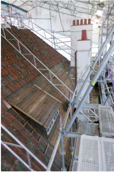
↑ Työalue telineiden sisäpuolella. amoy 26.11.2018
