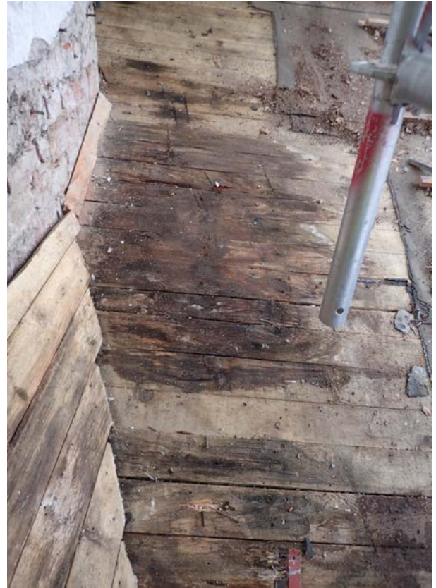
↑ ↗ Piipun 308A itäpuolinen ja pohjoispuolinen lahovaurio ennen aluslaudoituksen purkamista. Ukri Oy 23.11.2018
