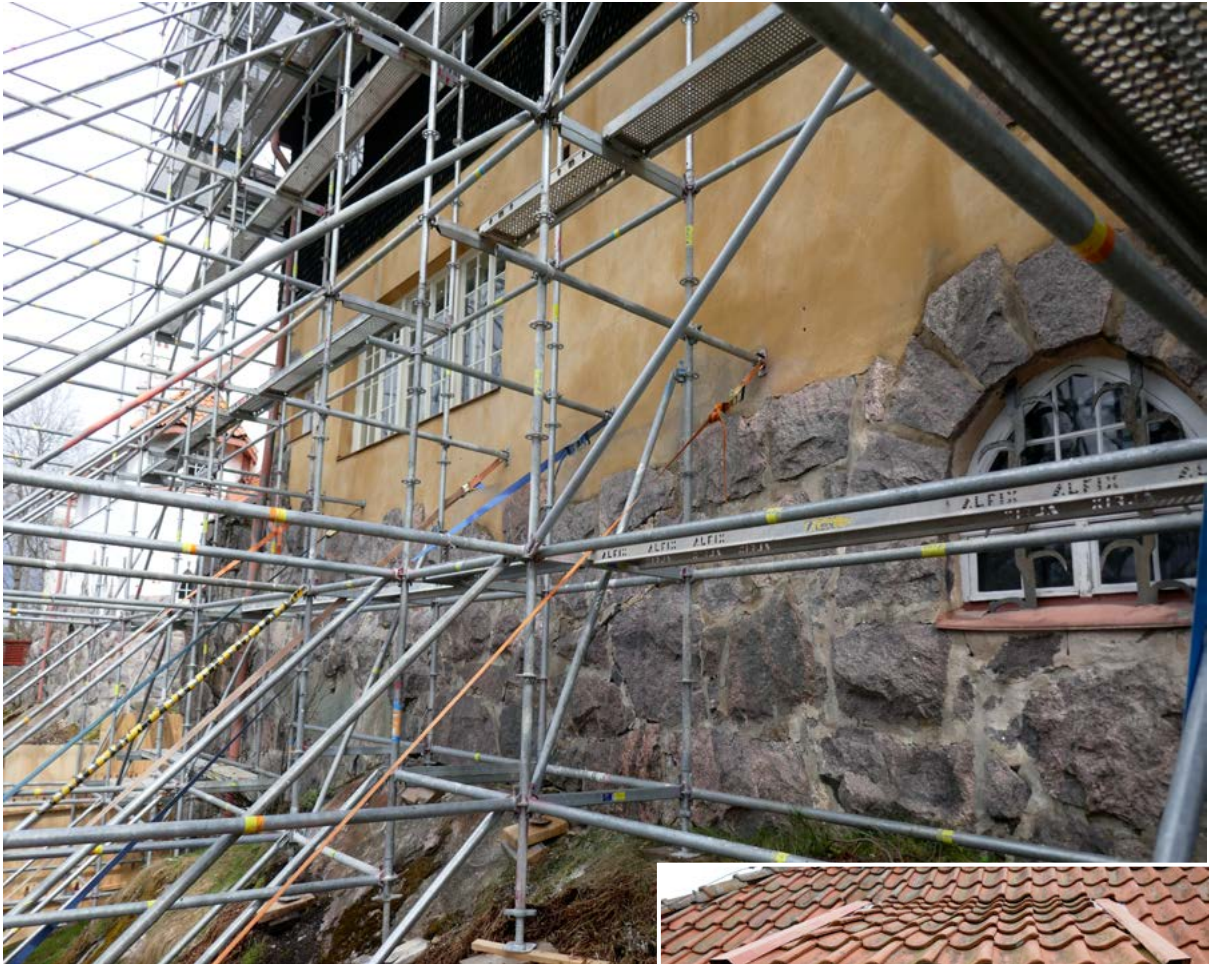
↑ Teline rakenteita Alaterassin puolelta. amoy 6.5.2021
