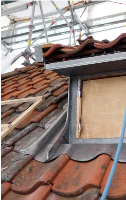
↑ Eteläsiiven länsilapteen kattoikkunan detail- jointia. amoy 1.12.2021
