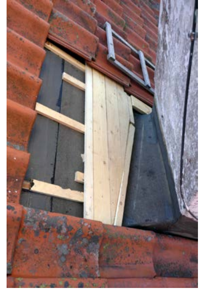
Kuvat yllä: Piipun yläpuolinen poikkilape Ukri Oy 3.4.2020, amoy 8.4.2020 ja amoy 21.4.2020
