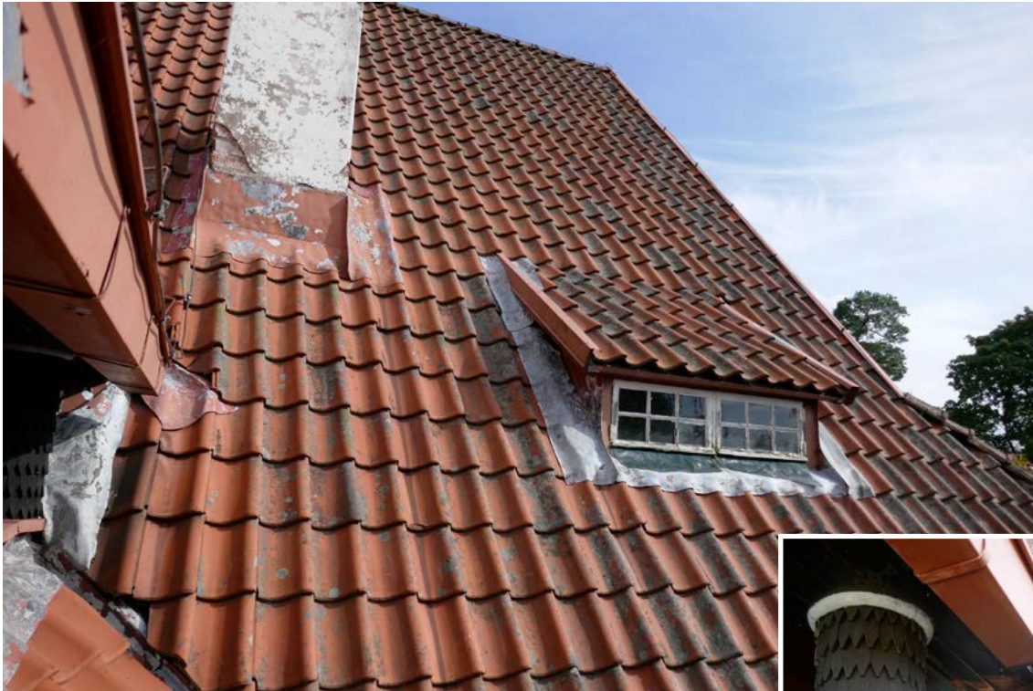
↑ Eteläsiiven länsilape terassiparvekkeelta katsottuna ennen korjausta. amoy 3.9.2019
