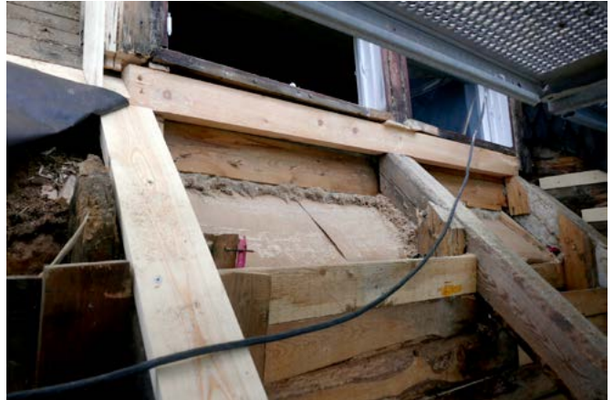
↑ Kattoikkunan ja kattolapteen lahonneet kattovasat uusittiin. Yläpohjan eristys tehtiin selluvilla-eristeellä (Ekovilla levy). amoy 24.6.2020
