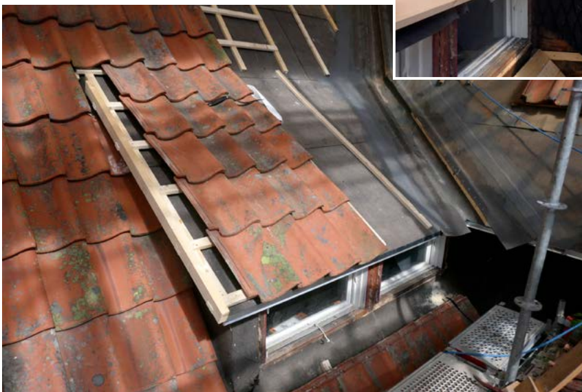
↑ → Kattoikkunan i.215 sivuräystäään lyijypelitys tehtiin mukaillen pohjoislappeen katoikkunaa i.308, jossa tiilijako suhteessa sivuräystääseen oli suunnilleen sama. Kattoikkunan etureunaan lisättiin saman-
