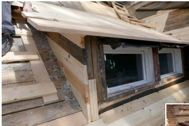
↑ Kattoikkunan i.215 vasemman sivun kantavien rakenteiden lahovaurioituneet kohdat uusittiin puupaikoin. Kattoikkunan keskeltä nykähtänyt rakenne oikaistiin ja ikkunan alle tehtiin uusi pitkitäinen kannatinpalkki, joka tukeutuu ikkunan sivuilla kulkeviin kattovasoihin. amoy 18.6.2020
