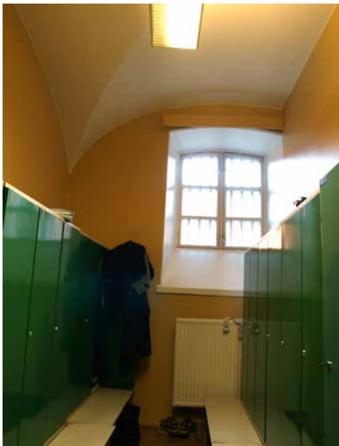
Toinen tilan 036 alkuperäisistä ikkunoista ja osa ristiholvausta, joka todennäköisesti on säilytetty Engelin vankilasta.
