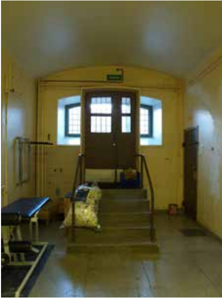
Yllä vasemmalla kellarin käytävän laakea tynnyriholvi.
