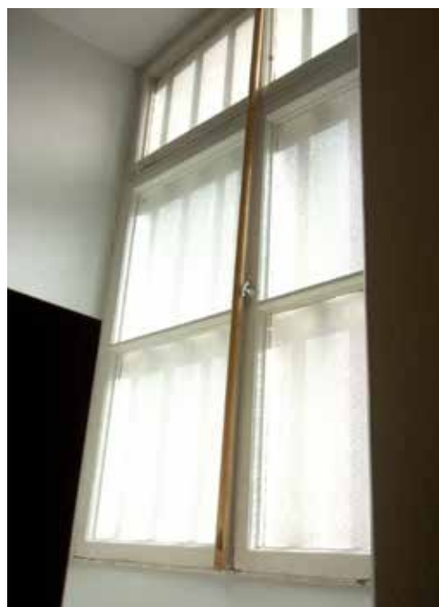
Tilan 030 ikkuna ulko- ja sisäpuolelta. T-ikkunan sisempi yläpuite on saranoitu alalaidastaan ja ulompi ylälaidastaan. Kalterit ovat ikkunan puitevälissä. Ulkopuolelle on myöhemmin lisätty lyöntilista.
