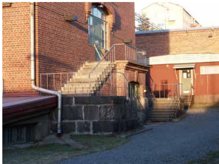
Portaikko itäpäädyssä ja käsityöhuoneen parakki
