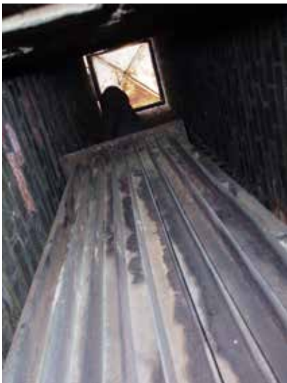
Ripaelementit ovat säilyneet poistopiipuissa.
