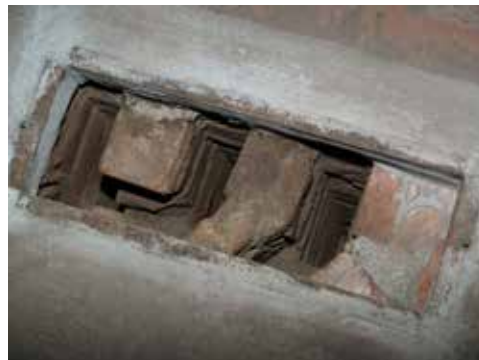
Hormit käytävän seinämuurissa ullakolta nähtyinä.
