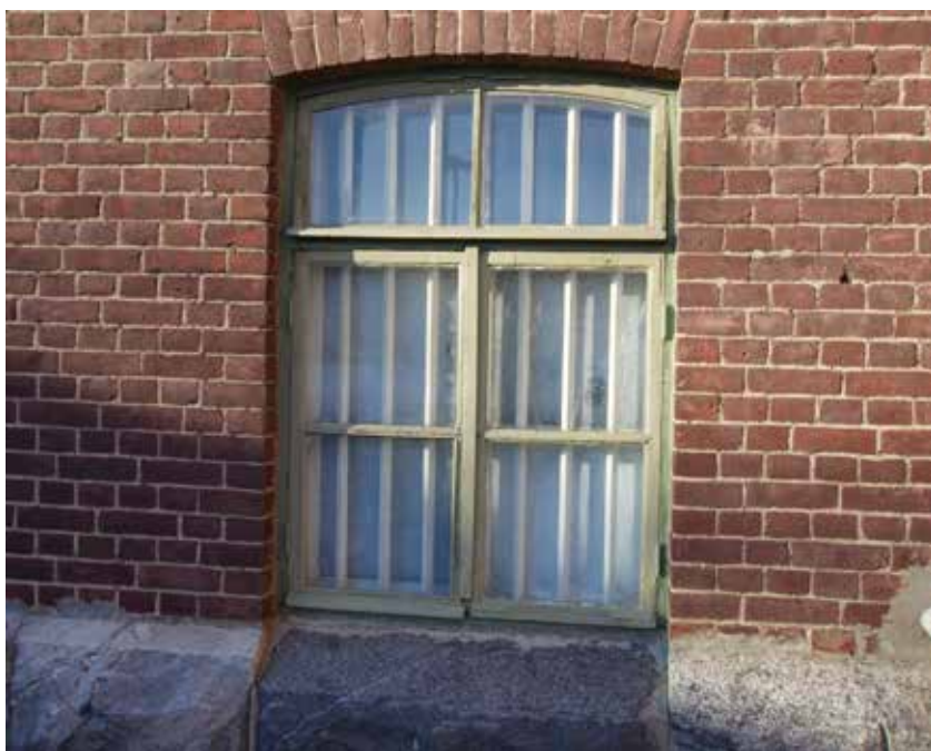
Tilan 030 ikkuna ulko- ja sisäpuolelta. T-ikkunan sisempi yläpuite on saranoitu alalaidastaan ja ulompi ylälaidastaan. Kalterit ovat ikkunan puitevälissä. Ulkopuolelle on myöhemmin lisätty lyöntilista.
