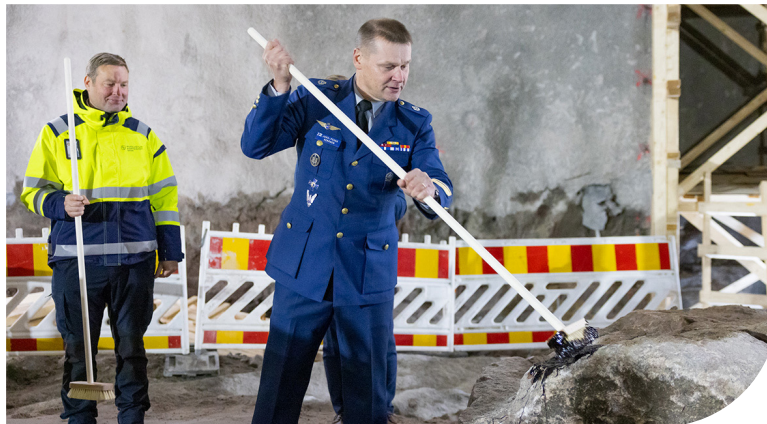
Lapin lennoston infrastruktuurin rakennus- ja muutostyöt ovat edenneet suunnitellussa aikataulussa, ja lennostossa valmistaudutaan ensimmäisten Suomen F-35-hävittäjien vastaanottoon loppuvuodesta 2026. Merkittävä virstanpylväs rakennustöissä saavutettiin 2. lokakuuta, kun rakennushankkeessa vietettiin perinteisiä pohjantervajaisia.
