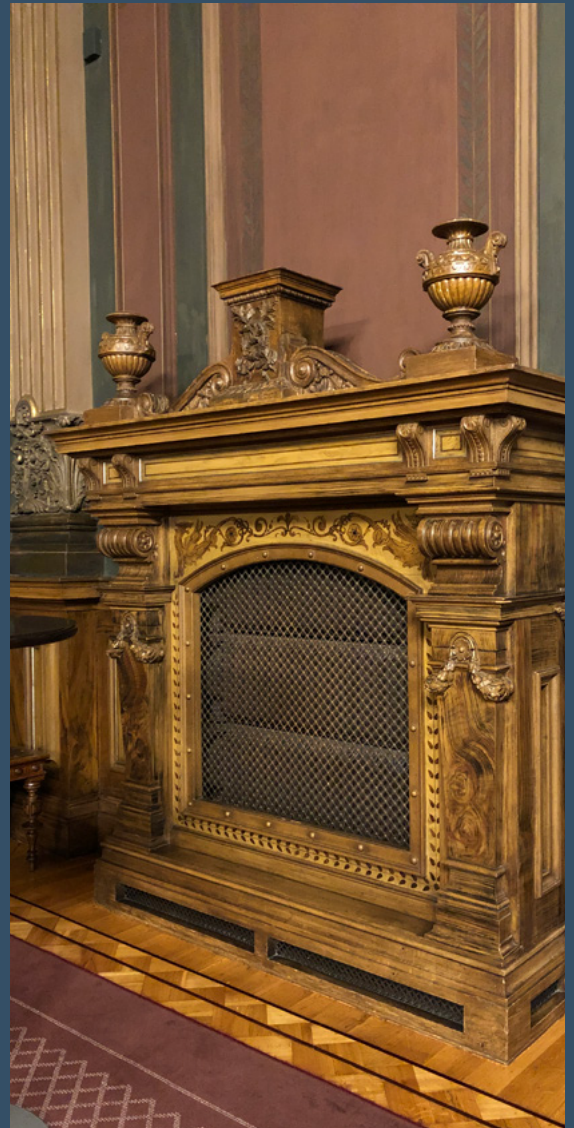
Suurien istuntosalien höyrykiertoiset patterit oli kätetty manttelitakkaa muistuttavan puurakenteisen ja hyvin koristeellisen kalusteen sisään. Peruskorjauksen aikaisessa (1988) kuvassa alkuperäinen patteri on paljastettu kalusteen sisältä, oikealla kuva vuodelta 2017. Kuvat Arkkitehtitoimisto Helander-Leiviskä ja Arkkitehtitoimisto Okulus.
