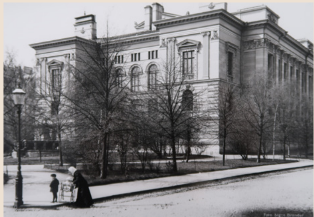
Lehmukset ovat kasvaneet suuriksi ja peittävät Säätytalon rakennuksen Ritarikadun ja Rauhankadun kulmasta katsottuna 1907. Puiston reunaan sijoitetun suoja-aidan tyyppi on ollut erittäin kevyt ja ilmava. Kuva Brander, Helsingin kaupunginmuseo.
