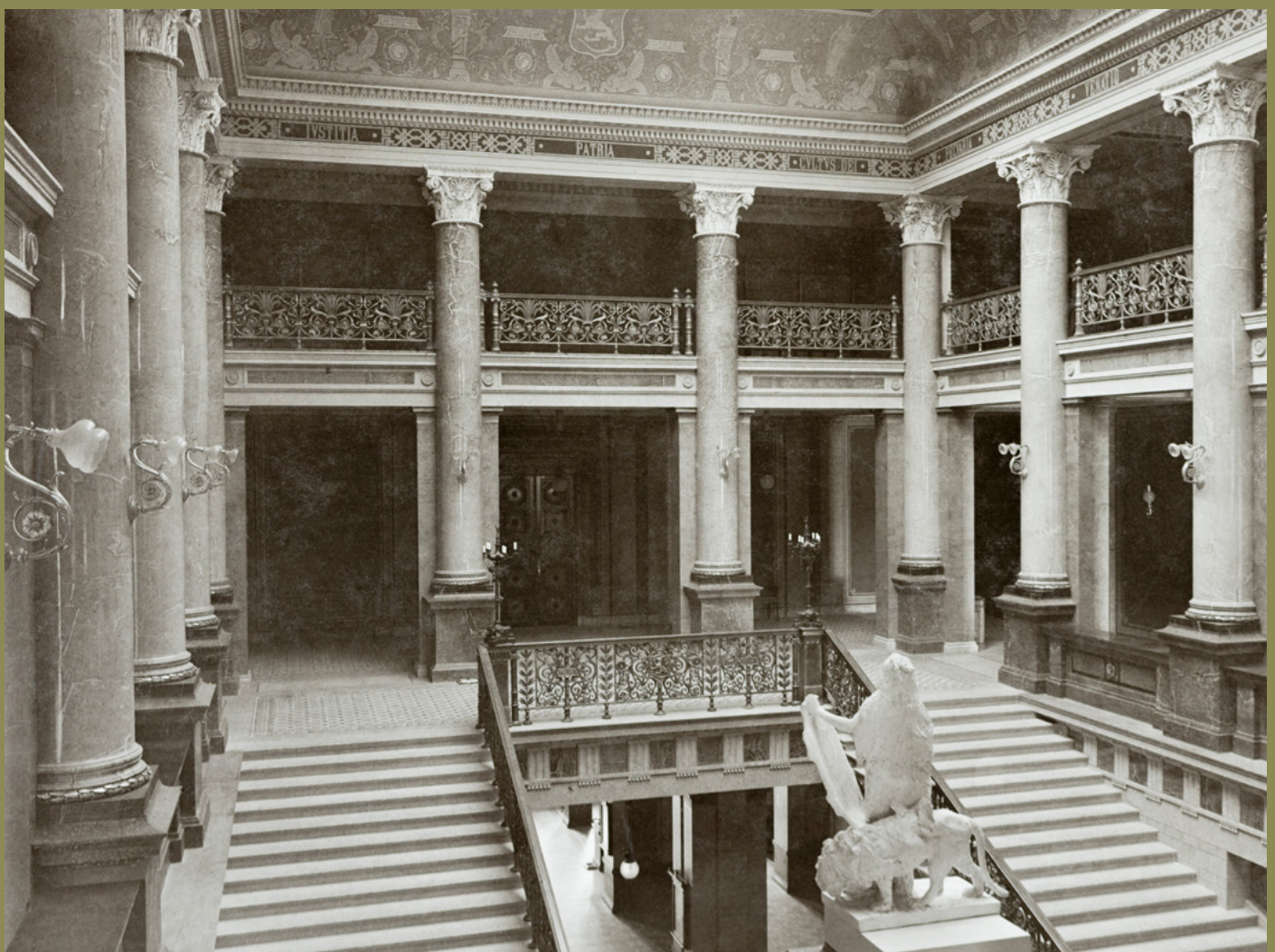
Varhainen sisäkuva pääporrasaulan alkuperäisestä väri- ja koristeasusta. Marmoroidut ja kiiltäväksi lakatut korkeat pylväät ovat tiilirakenteita, porrasaulan välipohjat taas teräskiskoin kannateltuja tiiliholveja. Lattiamateriaaliksi suunniteltiin kalkkikiveä, mutta toteutuksessa päädyttiin suosimaan kotimaista tuotantoa ja varsin uutta materiaalia, mosaiikkibetonia. Koristeelliset käsijohteet ja kaiteet ovat Nyströmin suunnitelmien mukaan Högforsin ruukissa valettuja. Keskellä porrasaulaa on Walter Runebrgin LEX-veistoksen ensimmäinen kipsinen luonnos. 1890-luku, Helsingin kaupungin museo.
