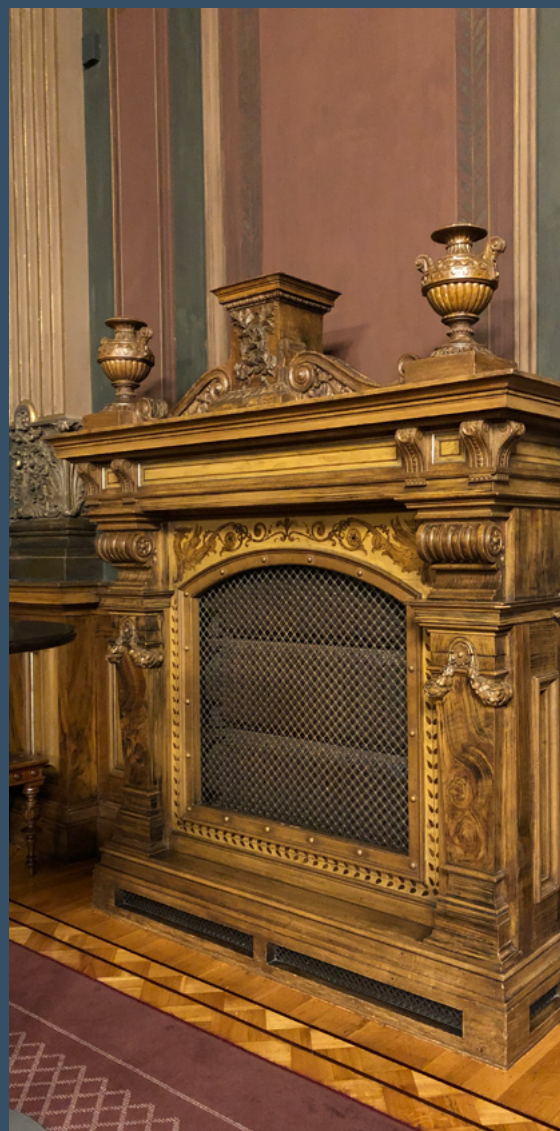
Värmeelement med ångcirkulation i de stora sessionssalarna fanns dolda i en träbyggd och mycket dekorativ möbel som påminde om en mantelspis. I fotot från totalrenoveringen (1988) har det ursprungliga värmeelementet visats på insidan av möbeln, till höger ett foto från 2017. Foton av Arkkitehtitoimisto Helander-Leiviskä och Arkkitehtitoimisto Okulus.
