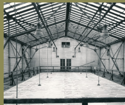
Järnkonstruktionerna i ljusstaket ovanför huvudtrappan är anmärkningsvärt smala och sensitiva. Strukturen har i regel förblivit intakt och vårdas som en särskild egenskap hos byggnaden. Bild 1979, Veikko Laine, Museiverket.
