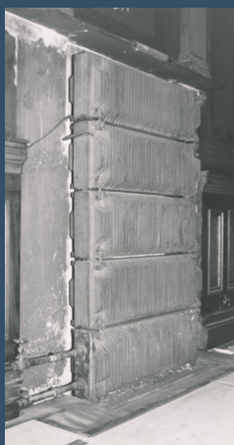
Värmeelement med ångcirkulation i de stora sessionssalarna fanns dolda i en träbyggd och mycket dekorativ möbel som påminde om en mantelspis. I fotot från totalrenoveringen (1988) har det ursprungliga värmeelementet visats på insidan av möbeln, till höger ett foto från 2017. Foton av Arkkitehtitoimisto Helander-Leiviskä och Arkkitehtitoimisto Okulus.
