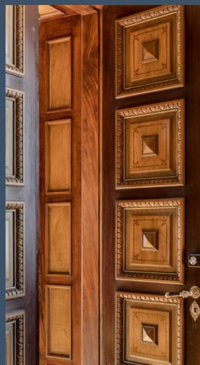
Sessionssalarnas dörrar är byggnadens mest imponerande och hierarkiskt viktigaste. Helheten, som ser ut att vara av ädelträ, består delvis av tonad och lackerad ek, delvis av täckmålade och ådringsmålade furu, gips eller puts.
