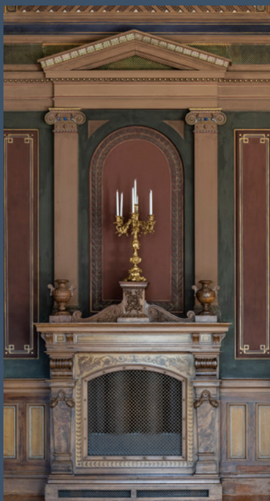
Borgarsalens träkonstruktion med skåp döljer ventilations- och uppvärmningsutrustning. Bilder av Arno de la Chapelle.
