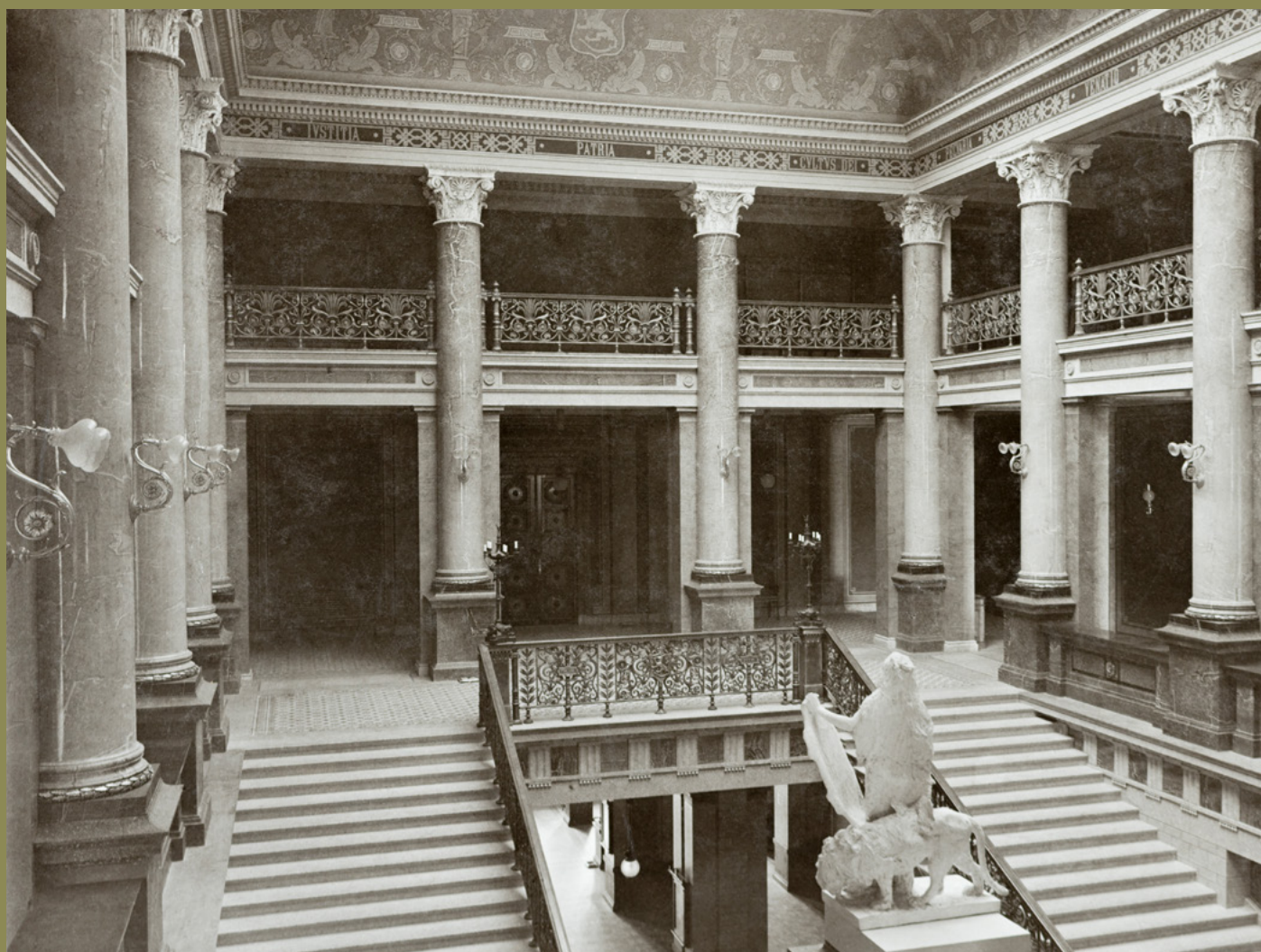
Tidig interiörbild av de ursprungliga färgerna och dekorationerna i huvudtrapphuset. De marmorerade och glanslackade höga pelarna är tegelkonstruktioner, trapphallens mellanbottnar är tegelvalv som bärs upp med stålskenor. Som golvmaterial hade man planerat att använda kalksten, men vid genomförandet valde man att gynna inhemsk produktion och ett relativt nytt material, dvs. mosaikbetong. Enligt Nyströms planer är de dekorativa räcken och ledstängerna gjutna i Högfors bruk. Mitt i trapphallen finns det första gipsutkastet till Walter Runebergs skulptur Lex. 1890-talet, Helsingfors stadsmuseum.
