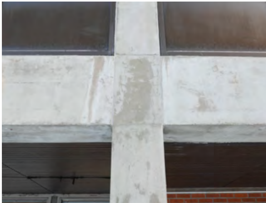
Kajaanin esikuntarakennuksen julkisivun kulma. Slammauksella on kokonaan peitetty julkisivun alkuperäinen lautamuottikuvioitu pintastruktuuri.
