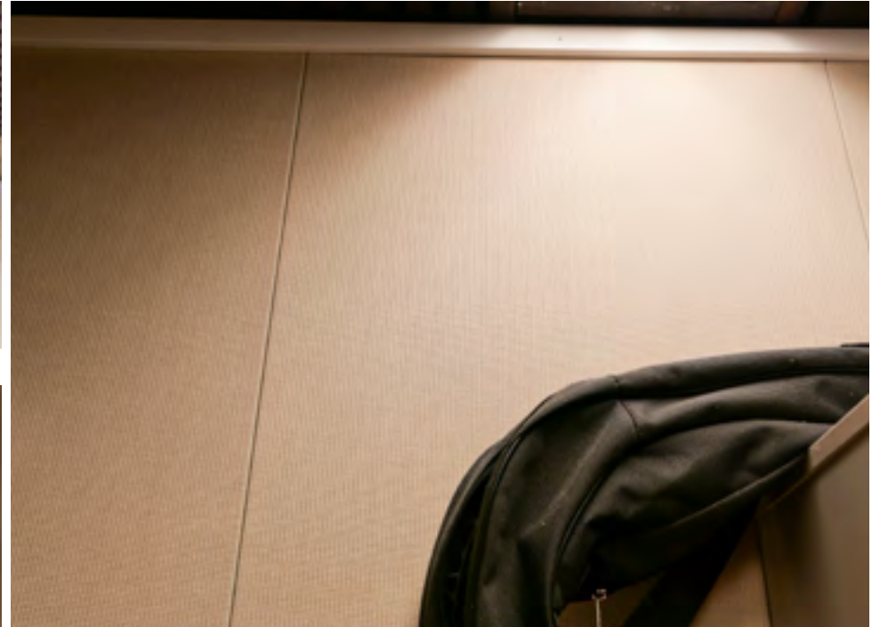
Kuva toimistohuone 5:stä. Osassa uudemmissa väliseinistä on käytetty lasikuitutapettia, osassa ilmoitustaulupohjaa.
