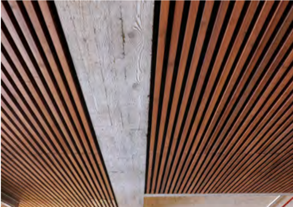
Aulan katon yksityiskohtia.
