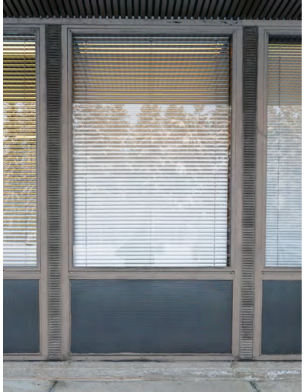
Alkuperäinen ensimmäisen kerroksen ikkuna.
