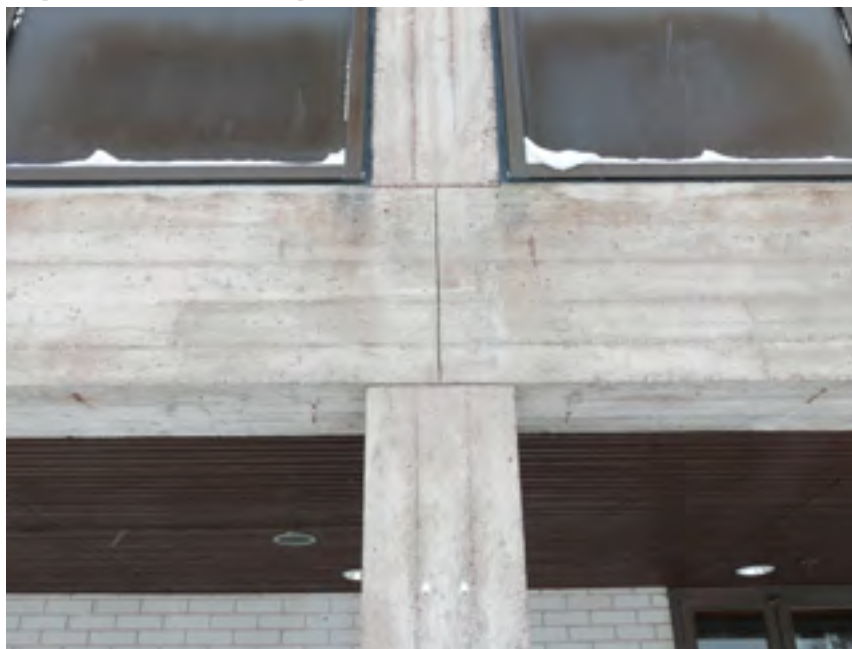
Vertailukuvana Säkylän esikuntarakennuksen julkisivun kulma. Säkylässä rakennuksen identiteettiin kuuluva betonipinnan lautamuottikuvio on säilynyt pieniä paikkakorjauksia lukuun ottamatta.
