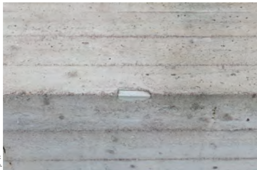
Lautamuottikuvipiintaa ja sisäänvedon laskettua rimakattoa. Raudoitusraudat ovat paikoittain näkyvillä.
