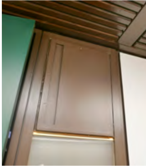
Toimistohuoneiden ovien lasisivupieliin lisätty ääniloukku.
