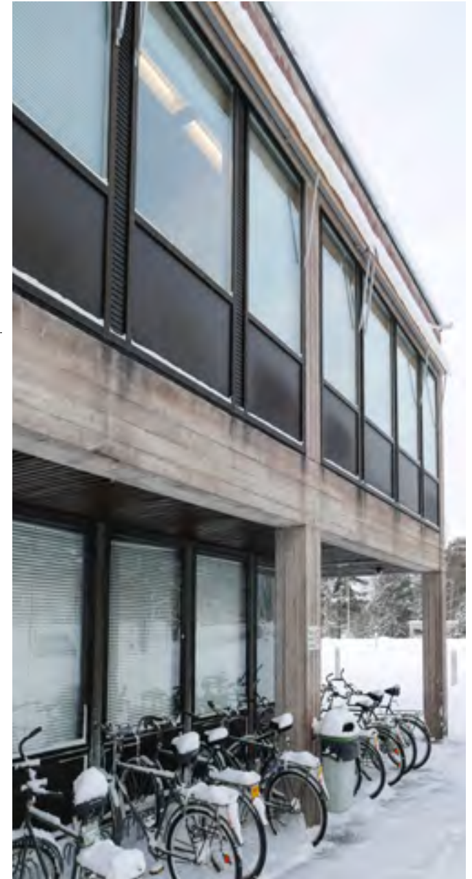
Itäsivulla leväkasvustolla on ollut suurin vaikutus ja betonipinta on julkisivulla punertavin.
