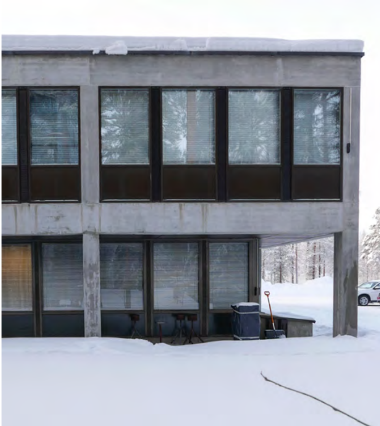
Koillisjulkisivulle on lisätty lauhdutinyksikkö. Osassa koillissivun ikkunoista on punertavat kalvot, osassa ei.
