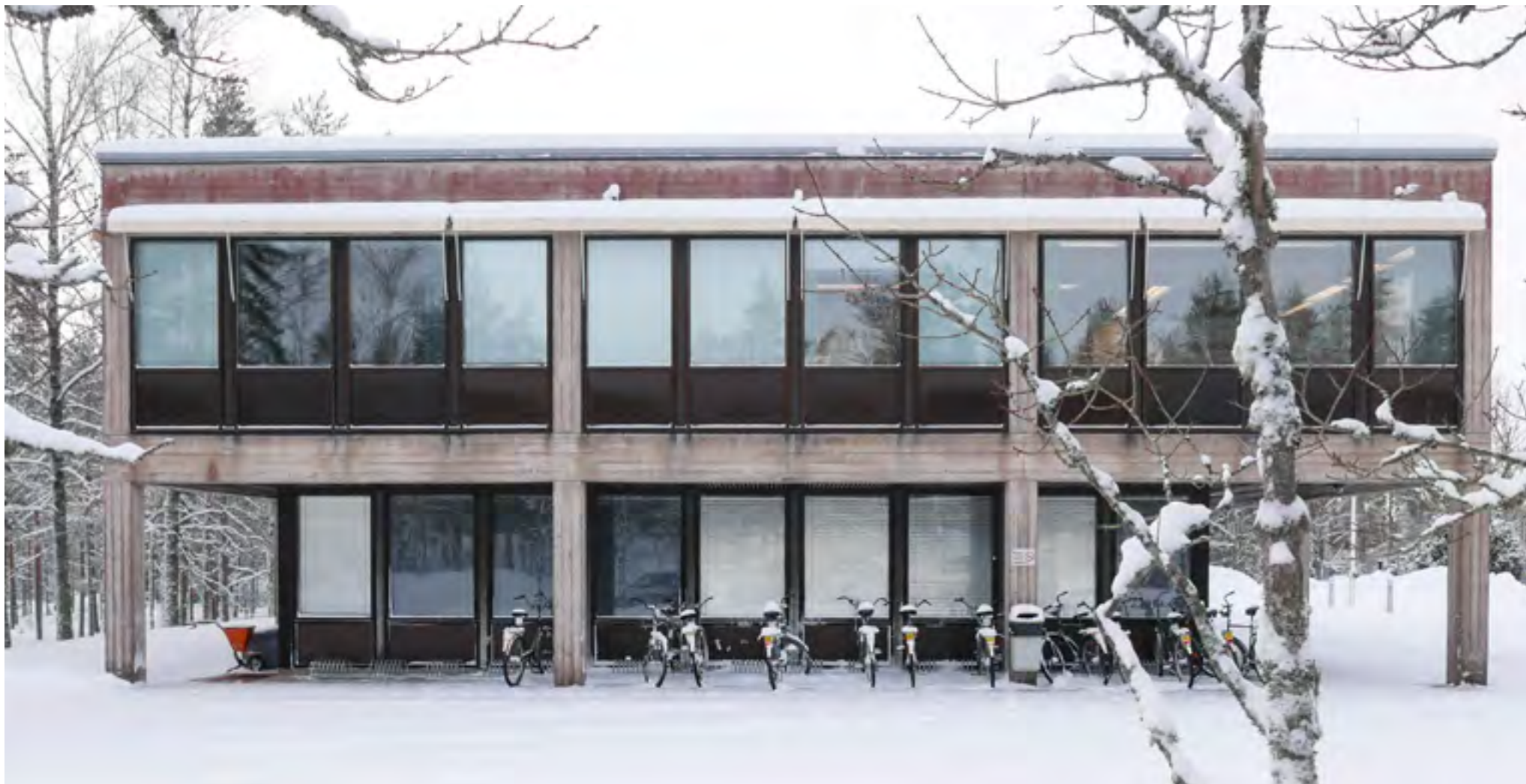
Itäjulkisivu. Julkisivulle on asennettu toisen kerroksen ikkunoiden yläpuolelle moottoroidut markiisit.
