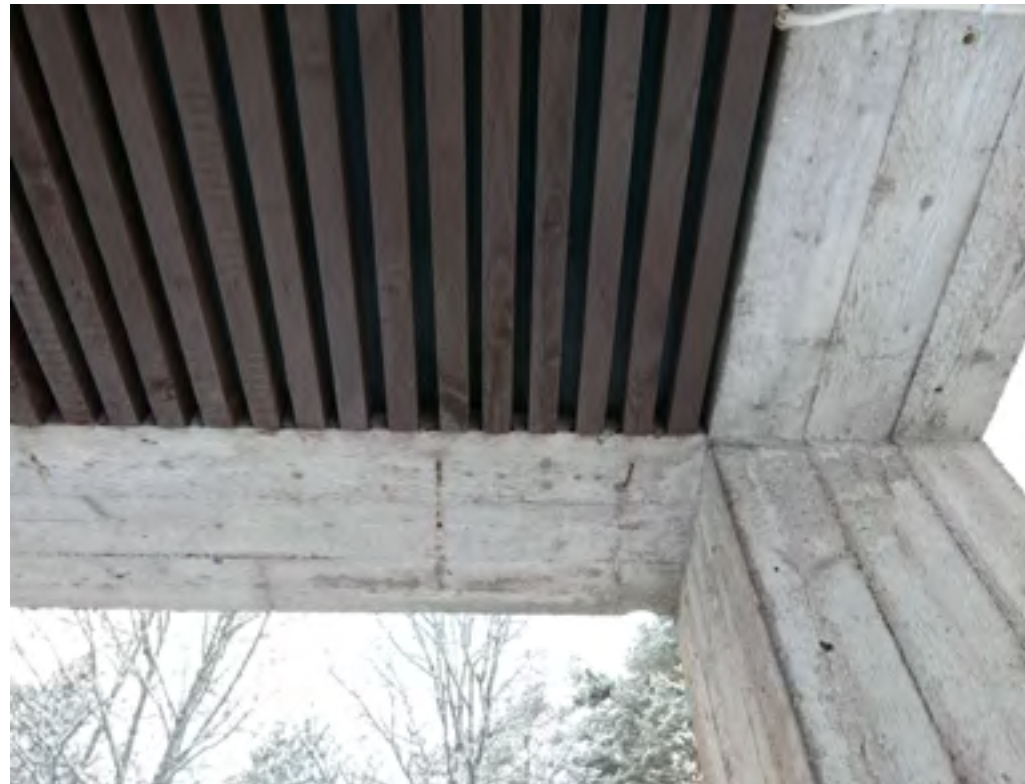
Lautamuottikuvipiintaa ja sisäänvedon laskettua rimakattoa. Raudoitusraudat ovat paikoittain näkyvillä.
