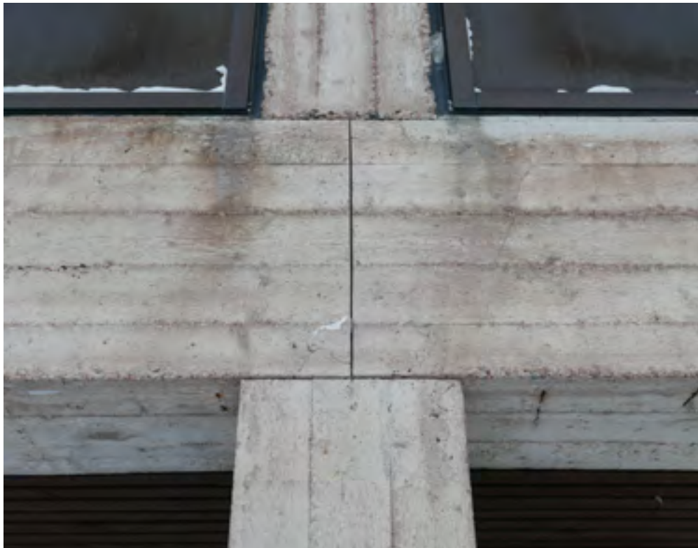
Julkisivun betonipinnan yksityiskohtia. Valussa betoniin on jätetty työsaumojia, jotka imitoivat elementtirakentamista.
