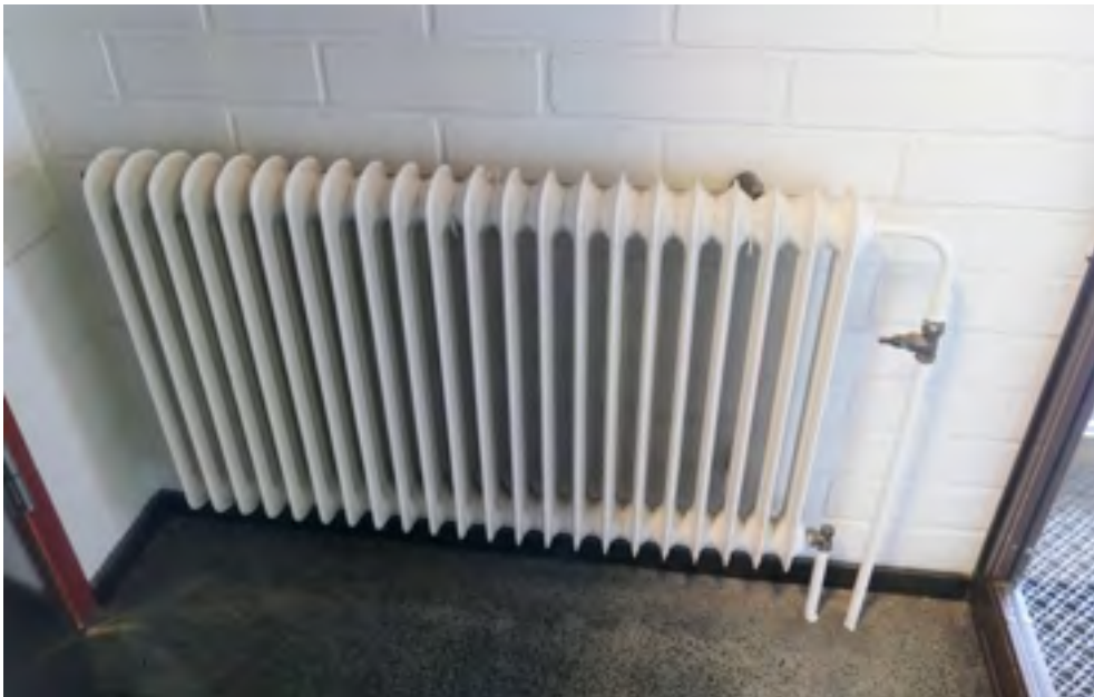
Aulan alkuperäinen lämpöpatteri.
