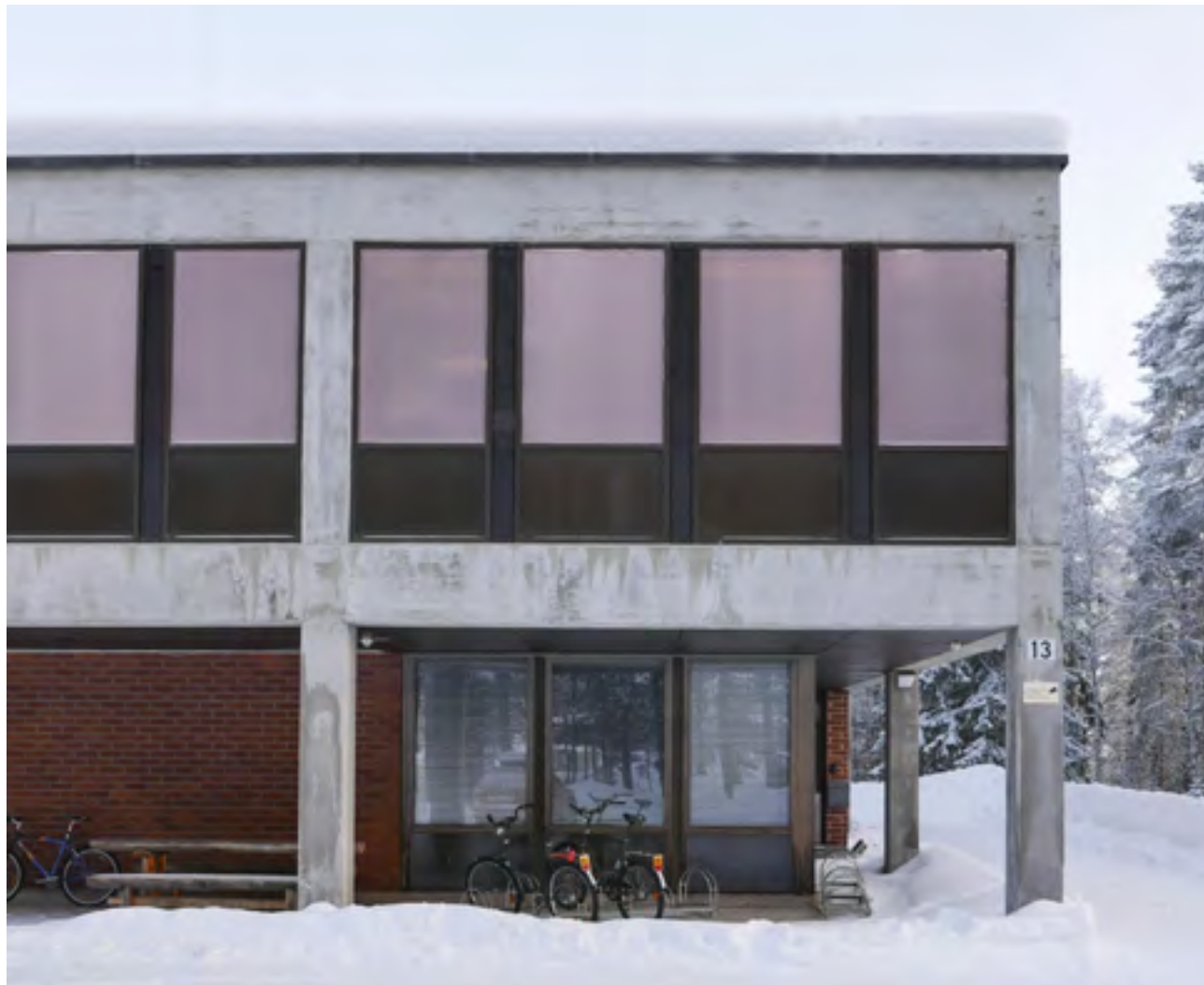
Osaan toisen kerroksen ikkunoista on lisätty näkösuoja- tai peilikalvot.
