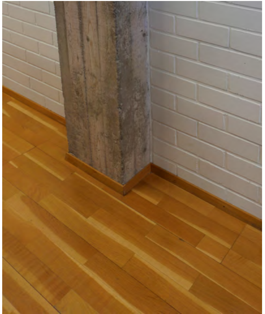
Neuvotteluhuoneen parkettilattia on vaihdettu samaan aikaan, kun tilassa ollut väliseinä purettiin.
