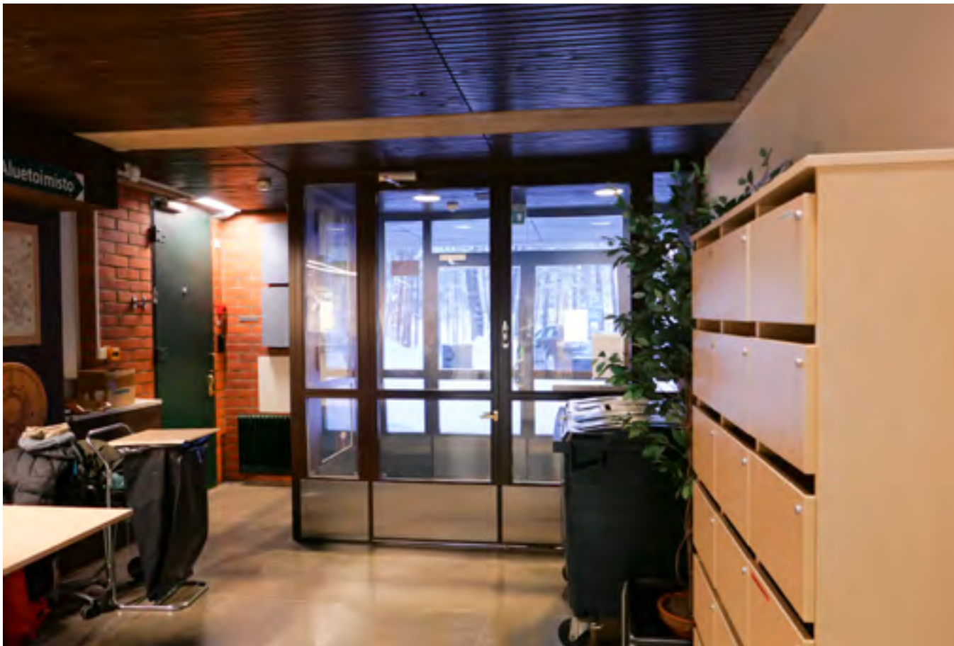
Ala-aula varaston ovelta kuvattuna. Luultavasti 1990-luvulla laajennettu tuulikaappi työntyy pitkälle ja pienentää aulaa. Kellariportaasta vihreän teräsoven vieressä on alkuperäinen lämpöpatteri sekä yläpuolella alkuperäiset valaisimet, joista vain yksi on toiminnassa.
