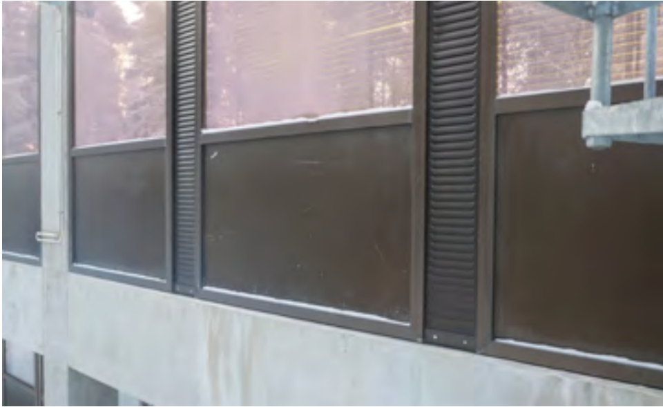
Uudempien ikkunoiden lähikuva. Alumiiniprofileilla, -listoilla ja -peltiosilla toteutetut toisen kerroksen ikkunaseinät on toteutettu samoilla suunnitteluperiaatteilla kuin alkuperäisten, mutta toteutus on merkittävästi yksinkertaistetumpi.
