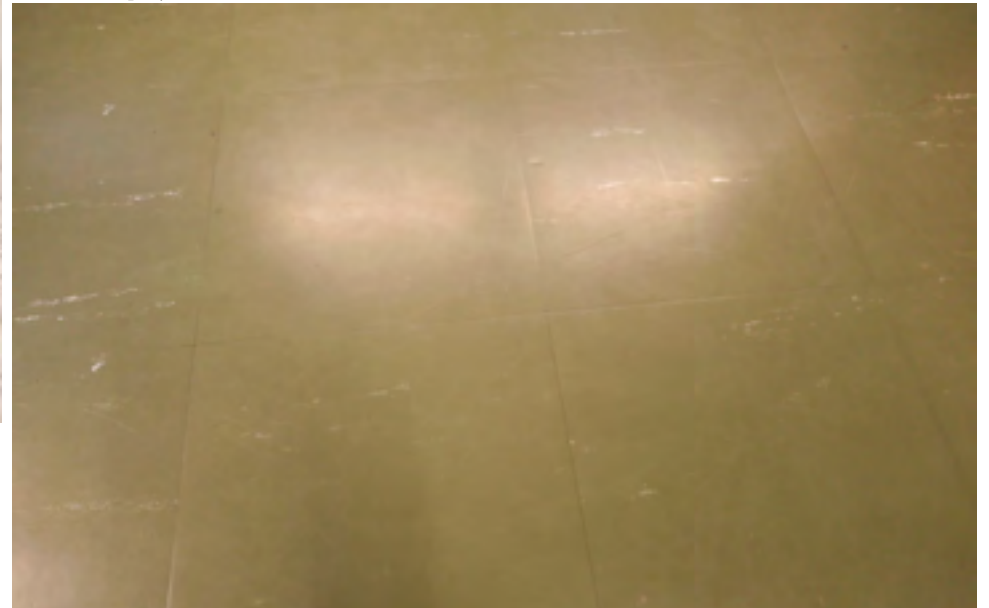
Toimistohuoneiden 6 ja 9–10 lattiapintaa. Suurimmassa osassa tiloja on säilynyt alkuperäinen muovilaattalattia.
