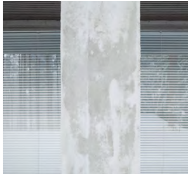
Koillisjulkisivun slammattuja betonirakenteita.
