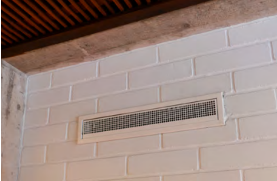
Neuvotteluhuoneen ja ilmanvaihtokonehuoneen väliseen seinään on lisätty ilmaventtiili.
