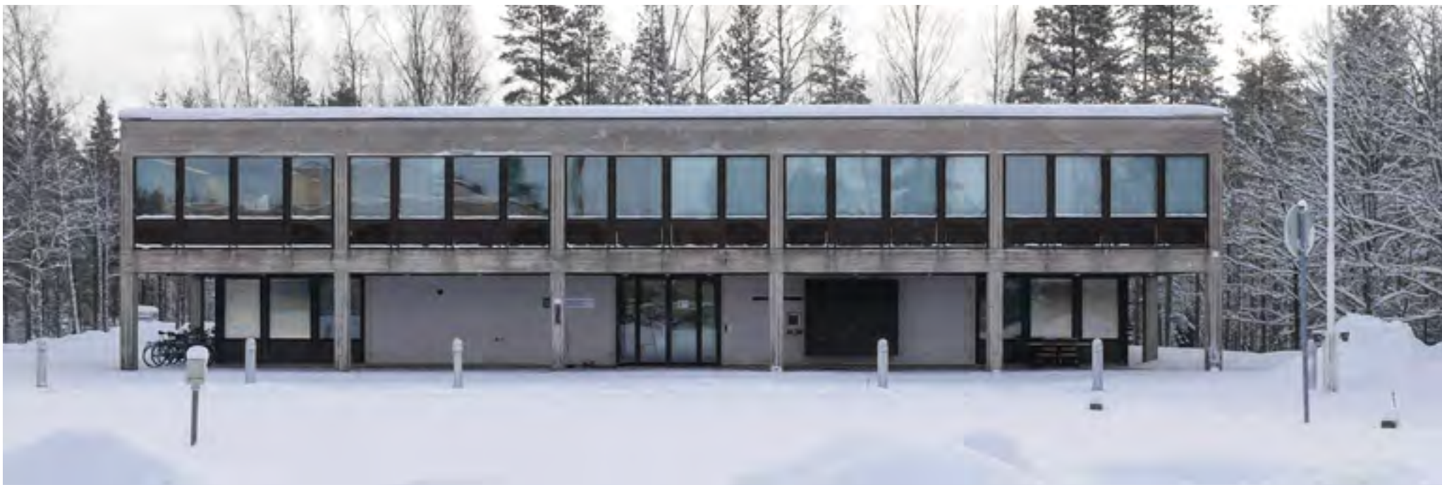
Pohjois- eli pääjulkisivu.
