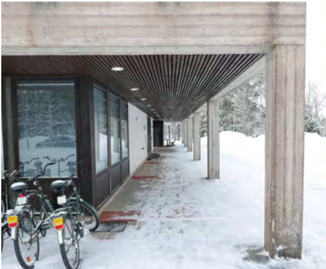
Pääjulkisivun pilarikäytävä. Lumen alta pilkoittaa uusi pihalaatoitus.
