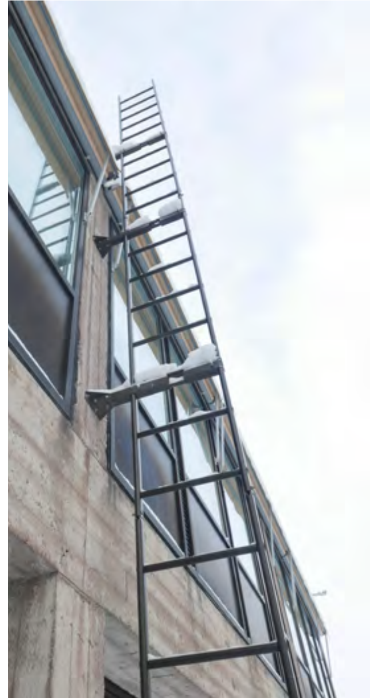
Eteläsivulla on itäisivun tapaan markiisit. Eteläsivulta poistettu alkuperäinen paloporras on korvattu edustalla näkyvällä laukaistavalla poistumistikkaalla. Taustalla näkyy uusi valmistikas.
