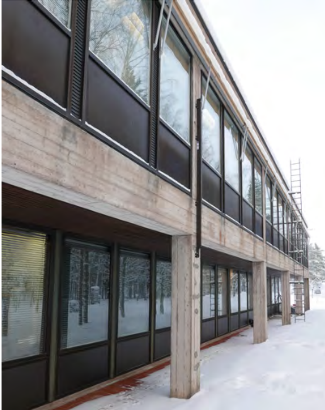
Eteläsivulla on itäisivun tapaan markiisit. Eteläsivulta poistettu alkuperäinen paloporras on korvattu edustalla näkyvällä laukaistavalla poistumistikkaalla. Taustalla näkyy uusi valmistikas.
