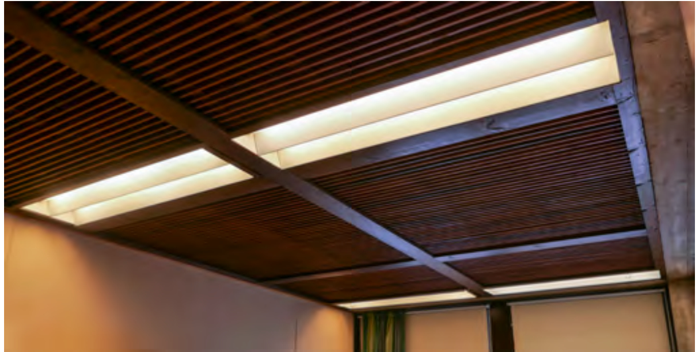
Alkuperäiset loisteputkivalaisimet Säkylän esikuntarakennuksen toimistohuoneessa.
