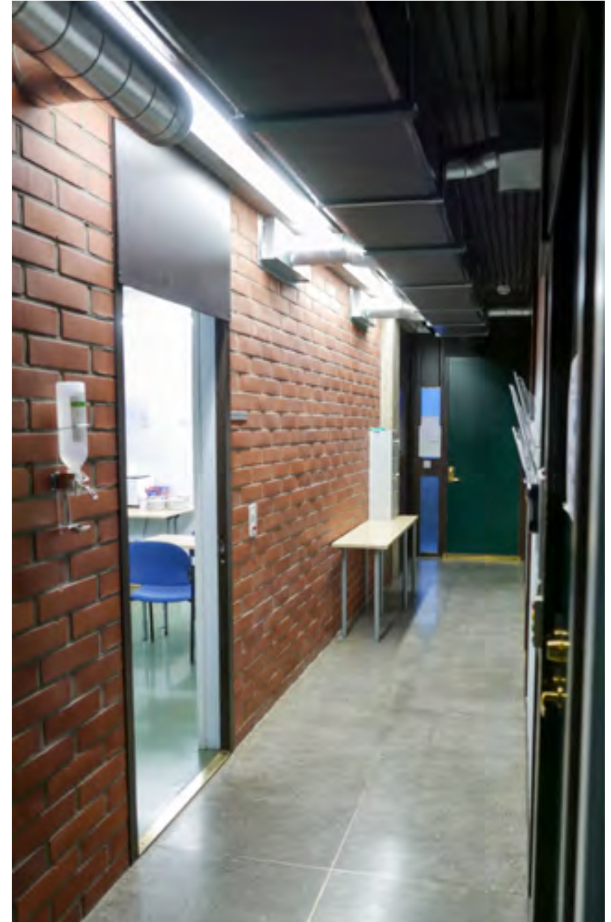
Alkuperäinen lasisivupieli ja toimistohuoneen ovi. Sivupieltä on muokattu ääniloukulla ja ovea jatkettu alareunasta 1980-luvulla. Oviaukon yläreunaan on lisätty vanerilevy.
