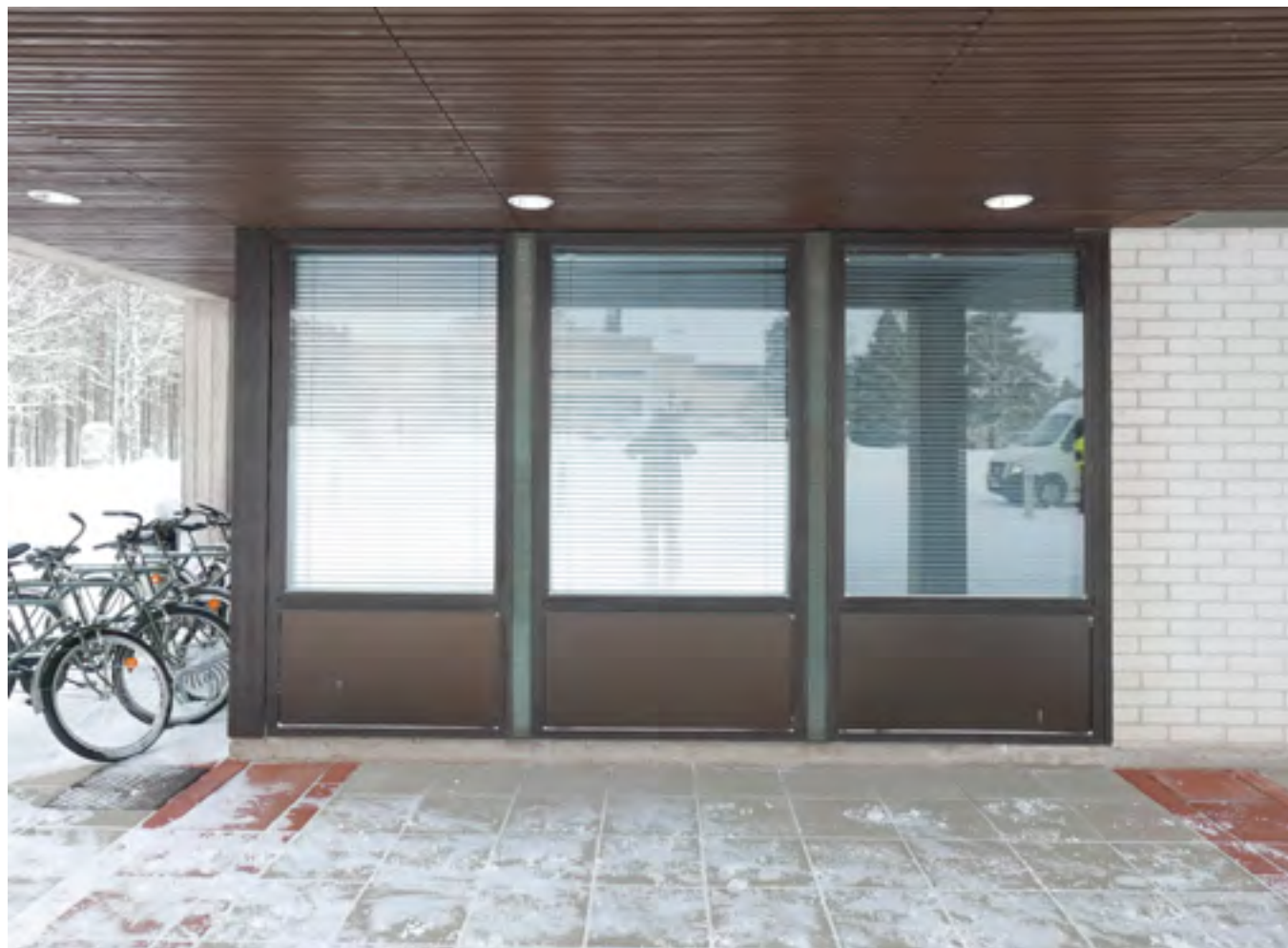
Ensimmäisen kerroksen alkuperäisiä ikkunoita. Kaikkien alkuperäisten ikkunoiden alaosien rautalankalasiset on vaihdettu kuvissa näkyviin alumiinilevyihin.
