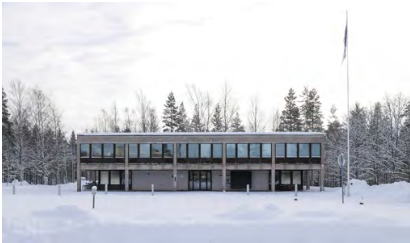
Pohjois- eli pääjulkisivu.
