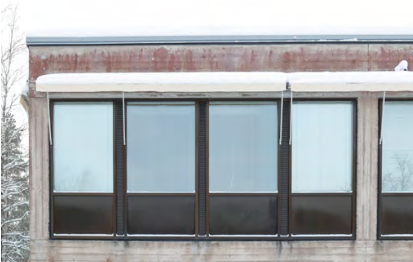
Itäsivulla leväkasvustolla on ollut suurin vaikutus ja betonipinta on julkisivulla punertavin.
