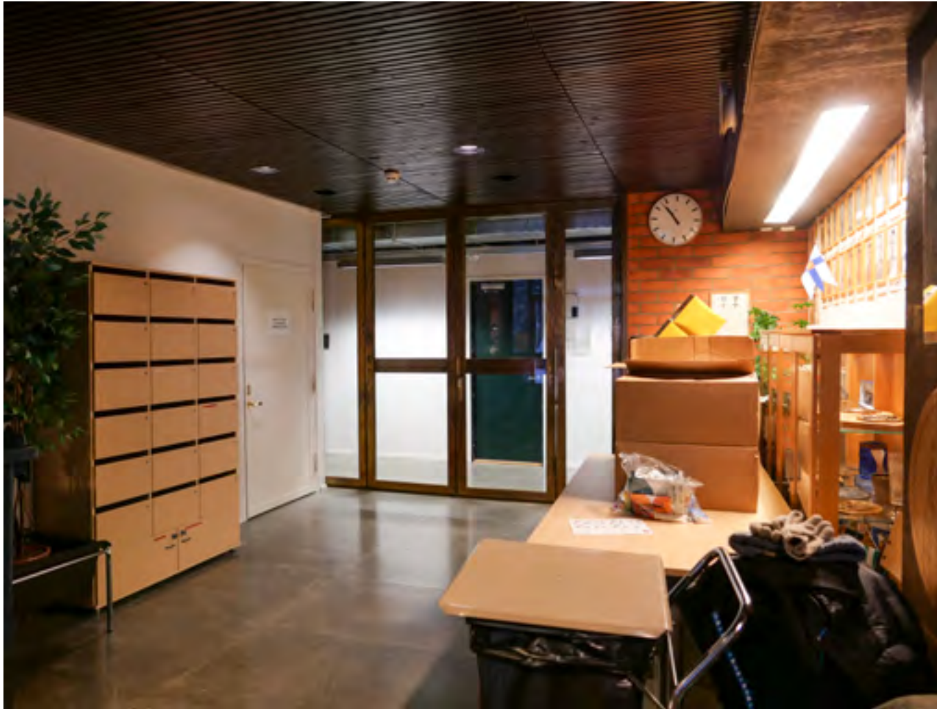
Ala-aula päivästäjän luukulta kuvattuna. Valkoisella seinällä ja ovella on peitetty ennen avonainen porras sekä osa lasiovesta. Taloteknisten asennusten vuoksi tehtyyn vanerikoteloon on asennettu uusi valaisin. Vähäisen valon, pienentyneen tilan, kotelon ja kalusteiden vuoksi aula on erittäin hämärä ja ahdas.
