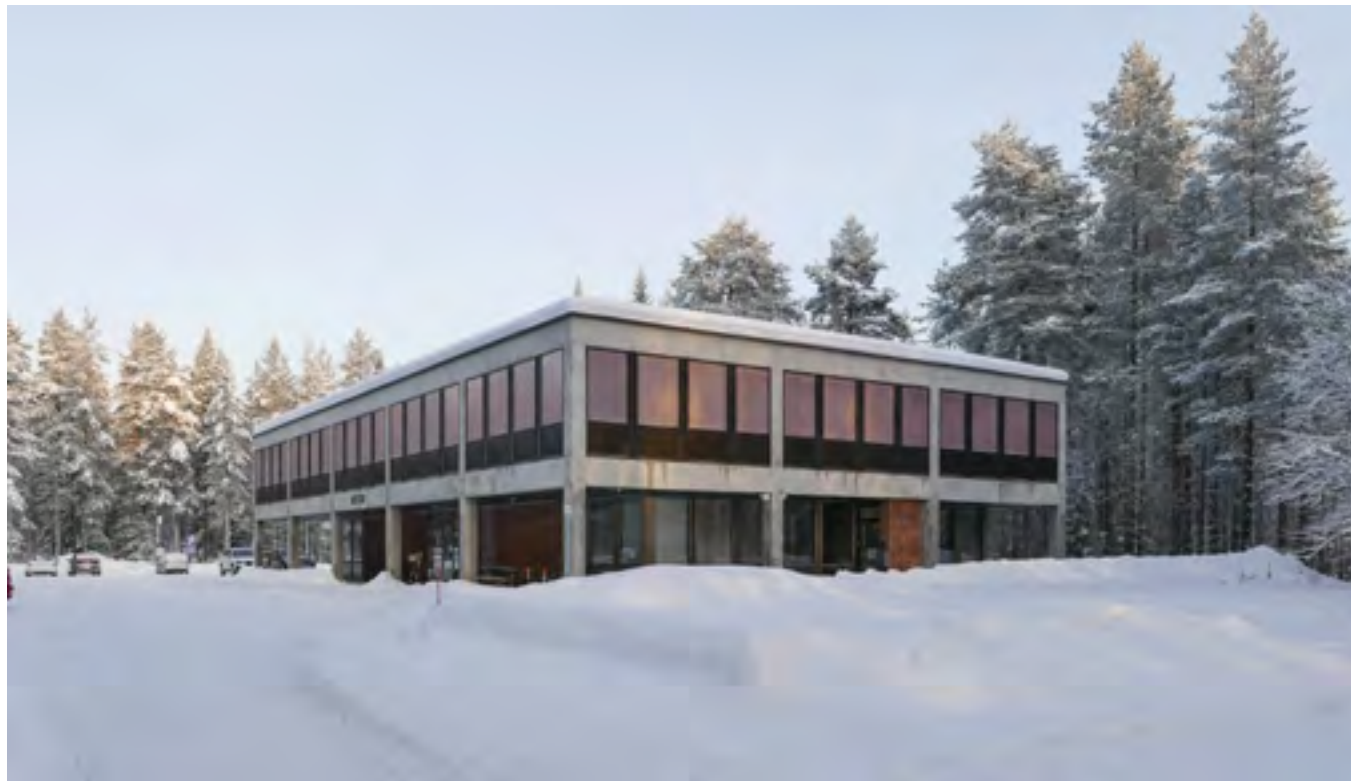
Lounais- eli pääjulkisivun julkisivuote. Rakennuksen julkisivujen ulkokehän päälme muodostuu kuvassa näkyvistä symmetrisistä slammauspinnan rajaamista osista.
