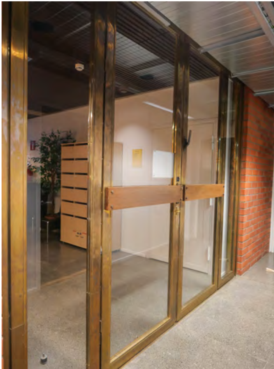
Aulan ja käytävän erottava, arvokkaan näköinen messinkipinnoitettu lasipariovi.
