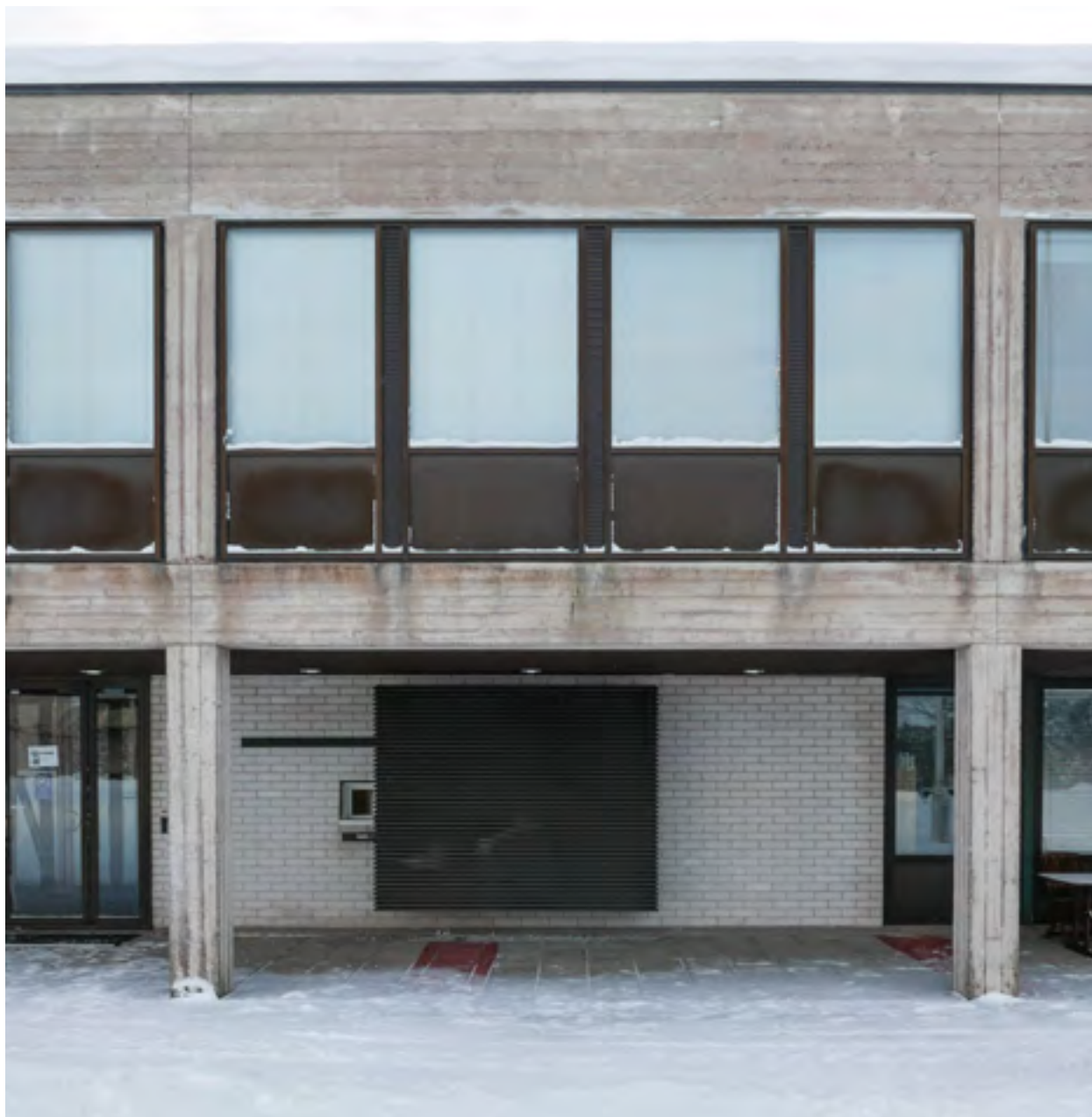
Pääjulkisivulle sijoitettu ilmanvaihdon ulkoyksikköjen ritiläkotelo. Kotelon vasemmalla puolella on kirjeluukku ja sen yläpuolelle myöhemmin lisätty pieni ikkuna.
