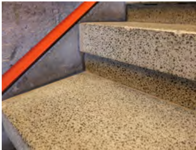
Vasemmallä Säkylä porras, oikealla Kajaanin. Säkylässä askelelementtien koko etupinta on mosaiikkibetonipintainen, toisin kuin Kajaanissa. Kuvissa näkyvät myös Säkylässä käytetty oranssi väri ja Kajaanissa käytetty vihreä väri.
