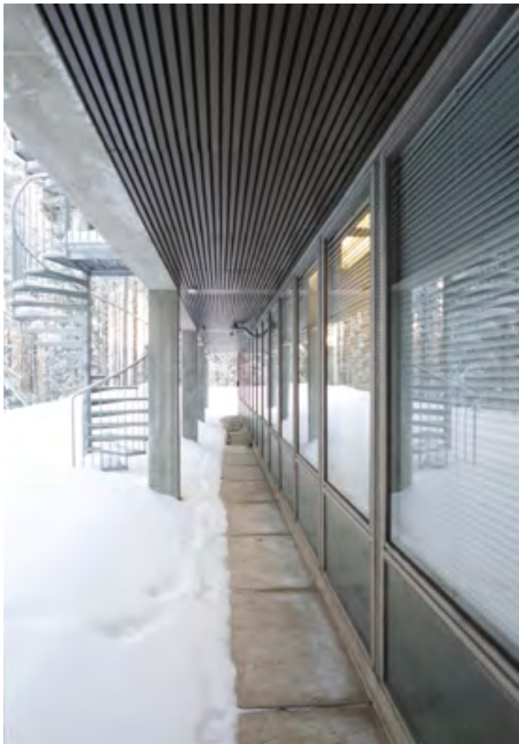
Takasivun pilarikäytävä. Ikkunoiden rautalankalaiset alaosat heijastavat valoa samaan tapaan kuin ikkunalasit, jolloin koko ikkunaseinä vaikuttaa läpinäkyvältä.
