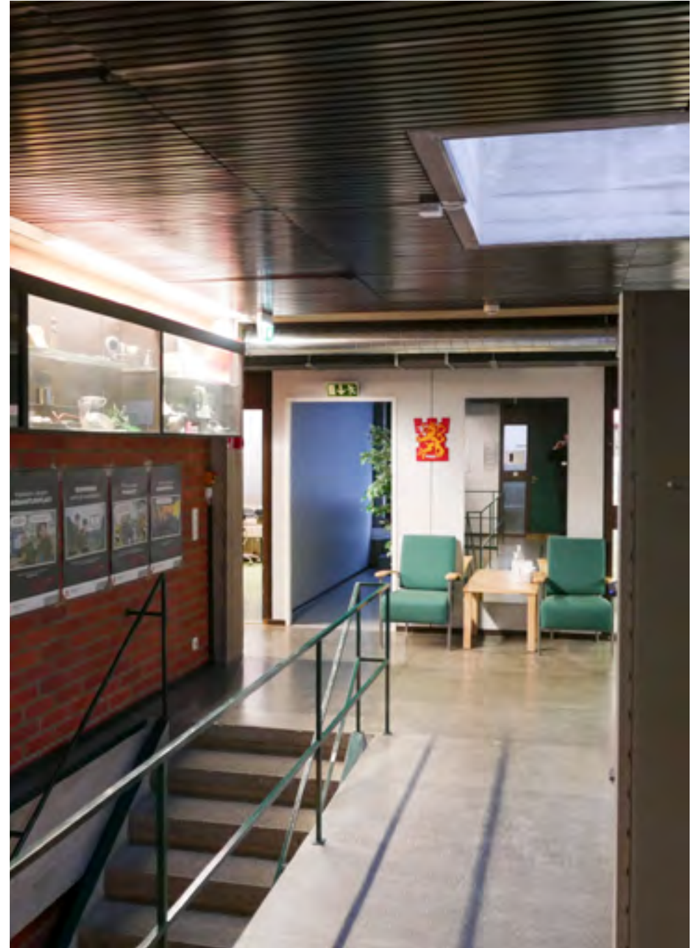
Toisen kerroksen aulatilasan on rakennettu ilmastointikonehuone ja varasto. Lisähuoneet on rajattu aulasta valkoiseksi maalatulla seinällä (yläkuvassa). Alun perin aulan seinät olivat kaikkialta punatiilisiä.
