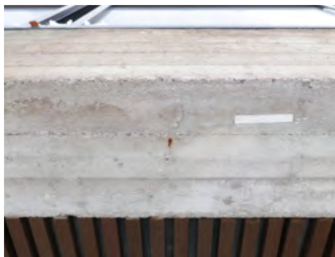
Betonivalun alapintaa länsisivulla.
