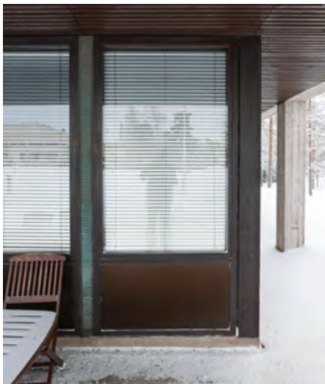
Ensimmäisen kerroksen alkuperäisiä ikkunoita. Kaikkien alkuperäisten ikkunoiden alaosien rautalankalasiset on vaihdettu kuvissa näkyviin alumiinilevyihin.
