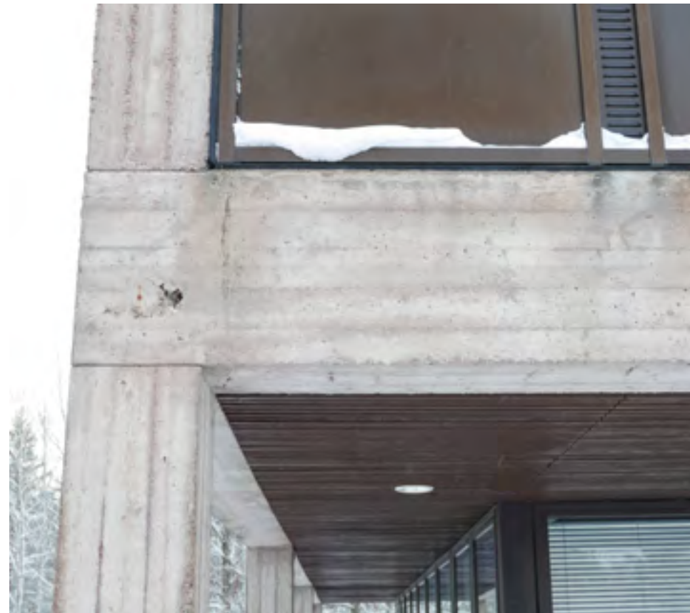
Rakennuksen lautamuottikuvioitua betonipintaa.
