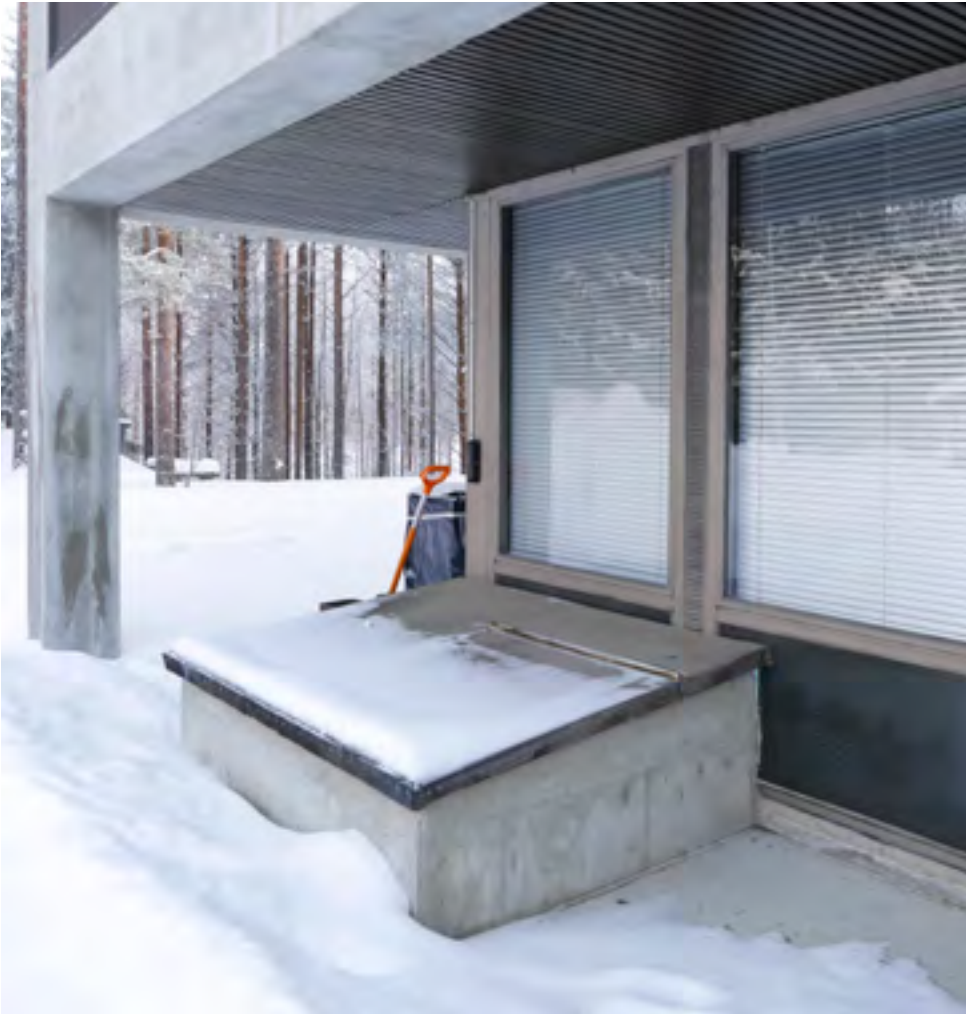
Kellarin varastoistumisluukku. Luukku on saatu istutettua julkisivuun kohtalaisen hyvin, vaikka sininen muovieriste on jäänytkin näkyviin.
