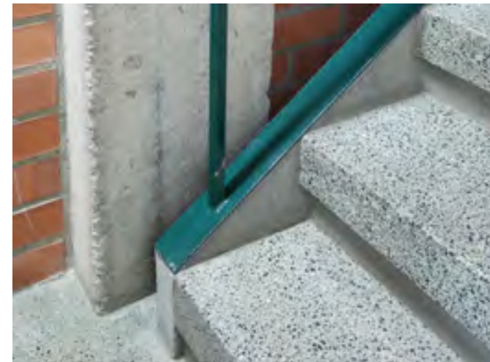
Vasemmallä Säkylä porras, oikealla Kajaanin. Säkylässä askelelementtien koko etupinta on mosaiikkibetonipintainen, toisin kuin Kajaanissa. Kuvissa näkyvät myös Säkylässä käytetty oranssi väri ja Kajaanissa käytetty vihreä väri.
