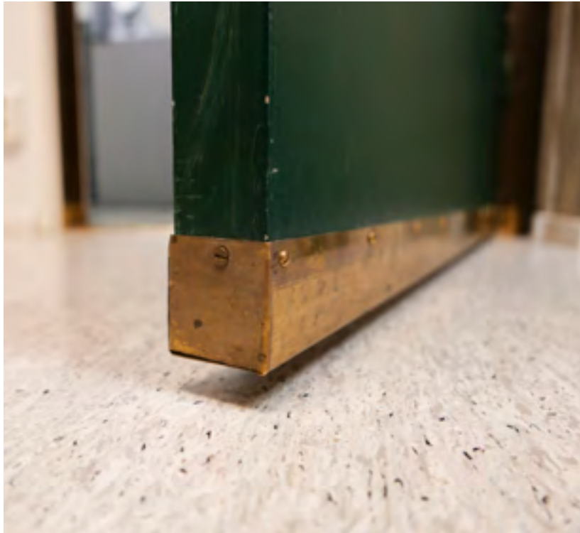
Toimistohuoneen 1 oven alareuna. 1980-luvun muutoksissa ovia jatkettiin kuvan tavalla messinkipinnoituilla puulistoilla. Ratkaisu noudattaa sisätilojen alkuperäistä ilmettä.
