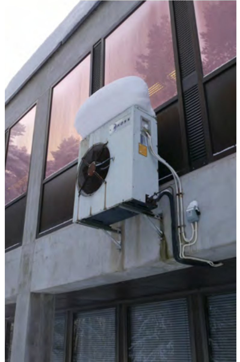
Koillisjulkisivulle on lisätty lauhdutinyksikkö. Osassa koillissivun ikkunoista on punertavat kalvot, osassa ei.
