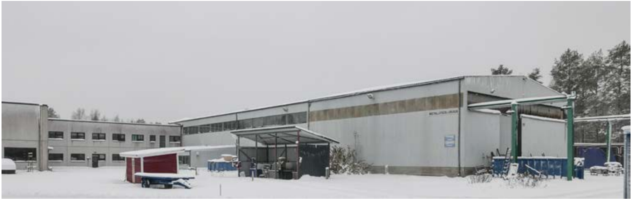
Metallityöhalli. Poimulevyverhotun kehäpalkkihallin kauempi, ikkunallinen osa on valmistunut 1974. Lähempänä sijaitseva ikkunaton loppuosan laajennus on valmistunut 1978. Metallihallin takana on 1982 valmistunut maalaamo-laajennus.
