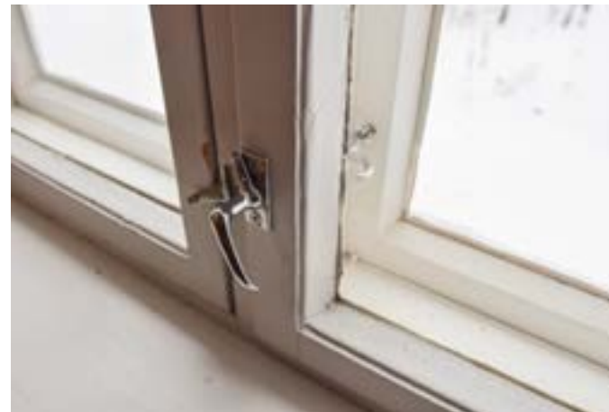
Rantakerhon ikkuna ja ikkunan helat. Tyypin ja helojen perusteella osa rantakerhon ikkunoista saattaa olla alkuperäisiä.
