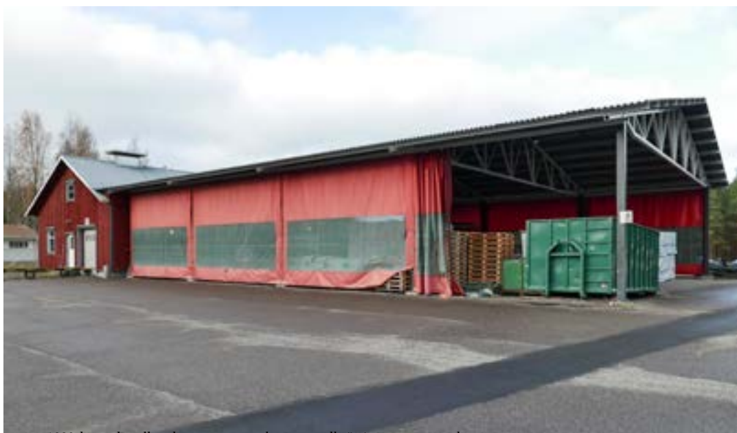
1980-luvun lopulla rakennettu pressukatos on selkeästi erottuva osa rakennusta.
