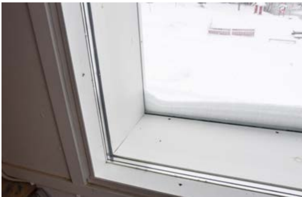
Uusituissa ikkunoissa on kiinteät kolminkertaiset lasitukset.
