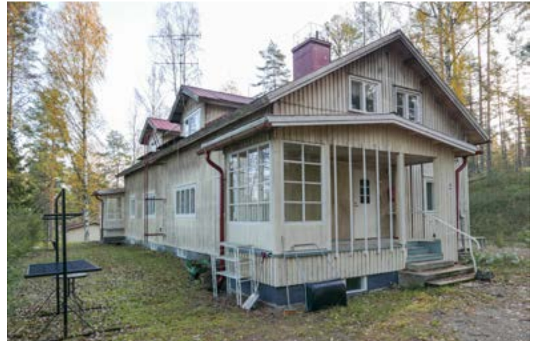
Rakennuksen luoteiskulma. Ulkonevat, alkuperäiset kuistit ovat rakennuksen merkittävin ominaispiirre.
