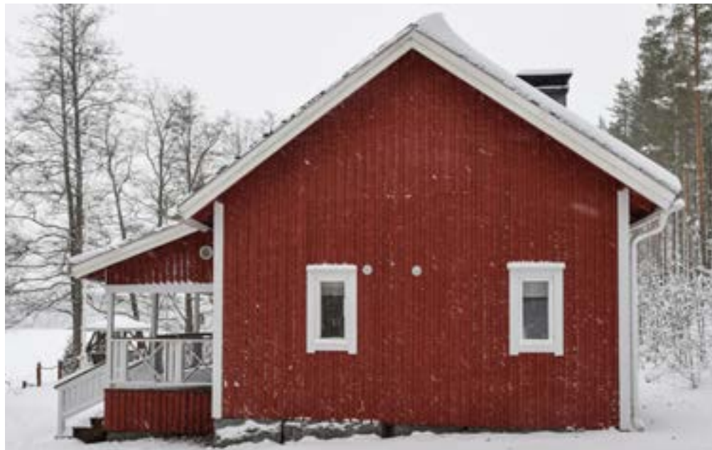
Rantakerhon länsipääty. Vasemmanpuoleista ikkunaa ei ole vuoden 1948 piirustuksessa, joten se on todennäköisesti lisätty 1970-luvun muutoksissa. Ikkuna on lisätty pelkästään sisätilan mukaan, minkä vuoksi se ei ole symmetrisesti julkisivussa. Oikeanpuoleinen ikkuna on ilmeisesti alkuperäinen.
