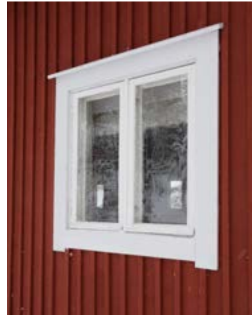
Rakennuksen kaksi- ja kolmeosaiset ikkunat ovat todennäköisesti alkuperäisiä.
