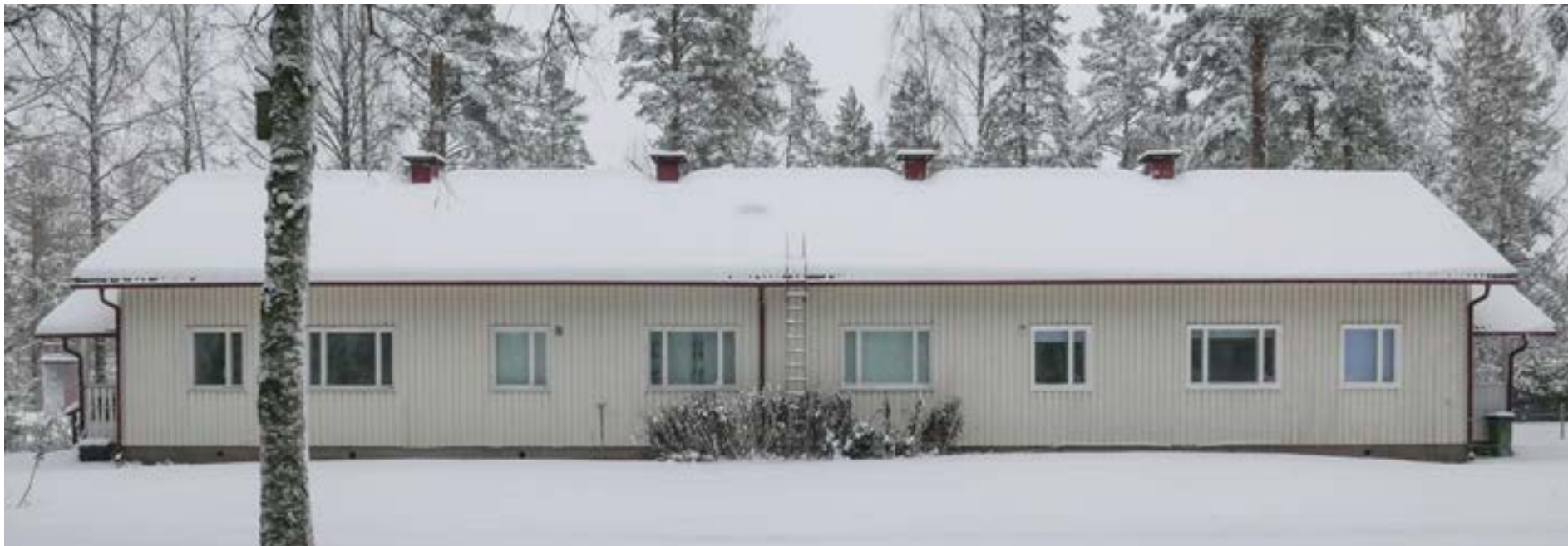
Rakennuksen lounaissivu. Ulkopuolelta rakennus on säilynyt lähes alkuperäisenä.
