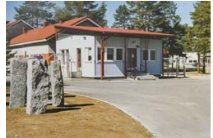
Nykyinen kiinteistönhuollon toimisto (rakennus 30) oli ensin vankilarakennuksen yhteydessä. NJV.
