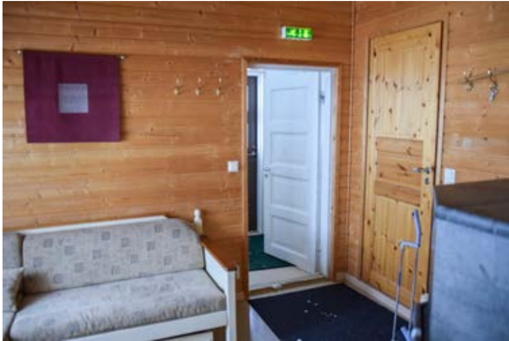
Vilvoitteluhuone. Vilvoittelun lisäksi puku- ja takkahuoneena toimiva tila on 1990-luvulla uusittua takkaa lukuun ottamatta 1970-luvun korjauksen asussa. Valkoinen ovi on muuta tilaa vanhempi ja mahdollisesti alkuperäinen 1940-luvulta. Ovesta kuljetaan tuulikaappiin, jonka vasemmalla puolella on pieni wc ja oikealla tekninen tila. Mäntypintaisesta ovesta kuljetaan suihkuhuoneeseen.
