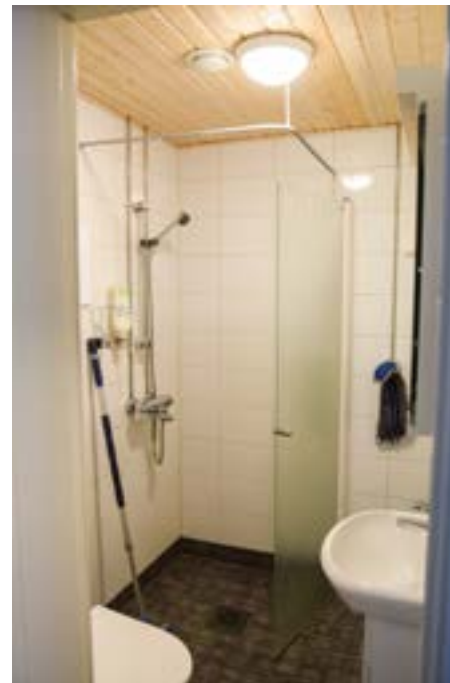
Asunnon A kylpyhuone. Pintamateriaalien perusteella tilaa on remontoitu 2000-luvulla.
