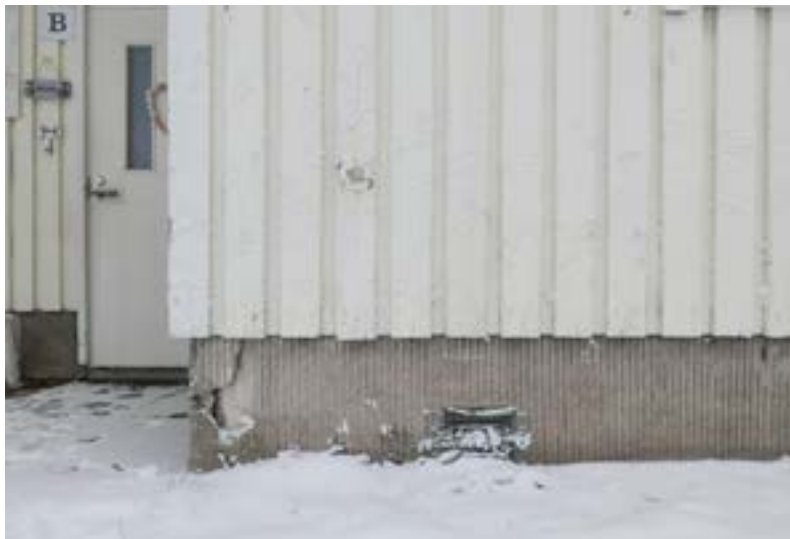
Rakennuksen sokkeli on 1950-luvun arkkitehtuurille tyypillisesti uritettu.
