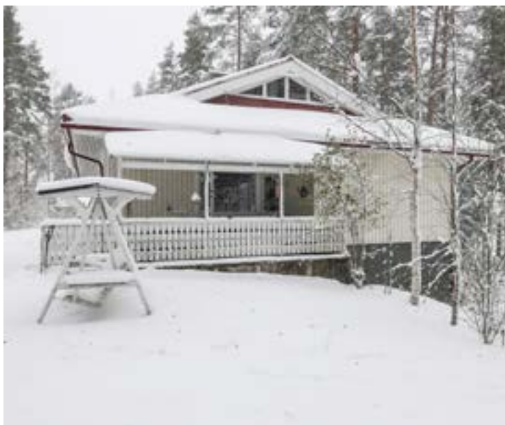
Uusitut kaiteet peittävät terassin eivätkä nikkarimaiselta tyylistään sovi rakennuksen ilmeeseen. Uusi terassikatos parantaa terassin käytettävyyttä, mutta toteutus poikkeaa rakennuksen tyylistä ja varjostaa olohuonetta.
