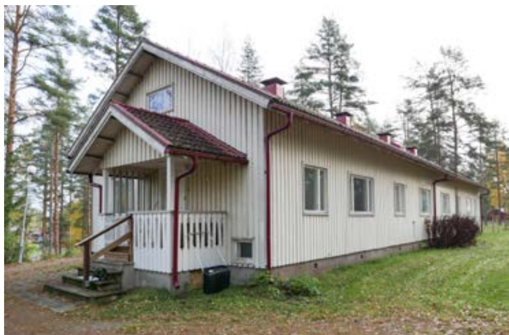
Rakennuksen länsikulma. Luoteispäädyn kuistiin on lisätty kestopuinen käsijohde.
