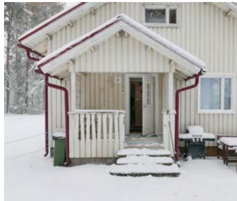
Rakennuksen kaakkoispääty. Ulko-ovet on vaihdettu valkoi- siin tavanomaisiin ulko-oviin.
