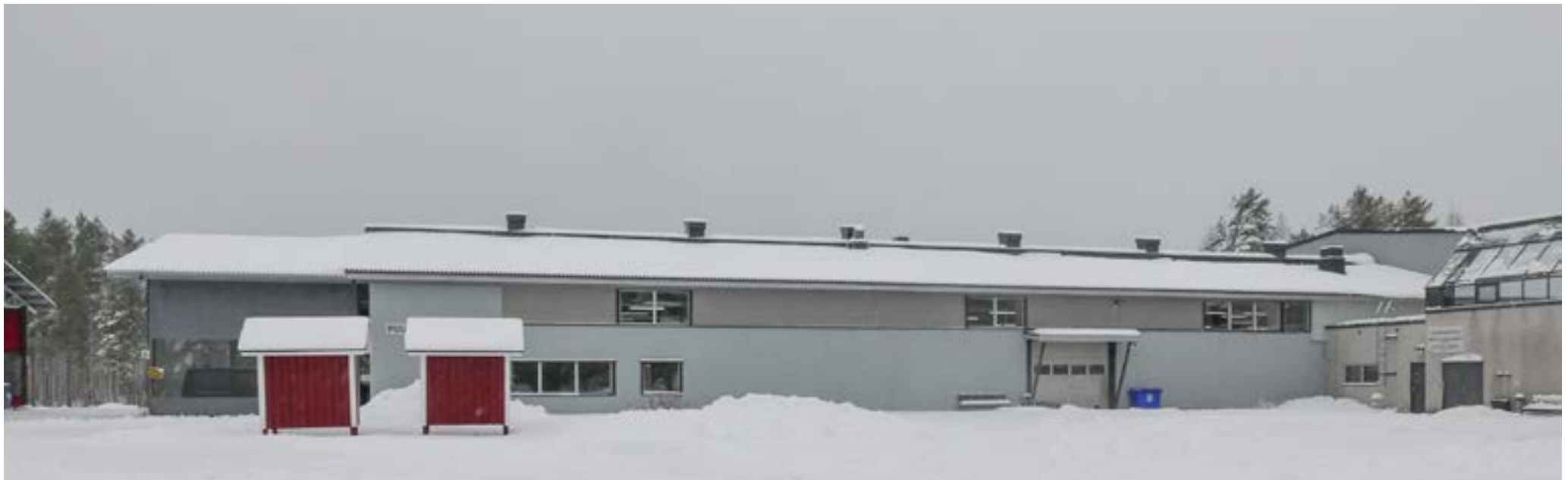
Puutyöhalli. Poimulevyverhottu kehäpalkkihalli on valmistunut 1975.
