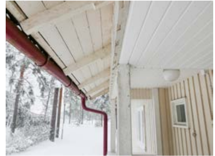
Kattotuolien näkyvät päät on muotoonveistetty/-sahattu räystään ulkonäön keventämiseksi. Kuistien sisäkatot on maalattu valkoiseksi, luultavasti ulko-ovien vaihdon yhteydessä.
