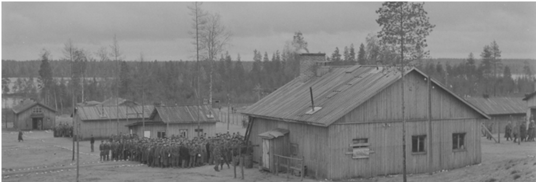
Näkymä Naarajärven sotavankileiriltä. Etualalla oleva rakennus on ilmeisesti “yläkeittiönä” tunnettu. Takana näkyvät aliupseerien asunto ja sotavankien alakeittiö. Harjaltaan toisin päin takana näkyvässä rivissä parakit 85 ja 86. Kuvan oikeassa laidassa näkyy aita ja sen takana parakit 53-61. SA-kuva (alkuperäistä kuvaa rajattu).
