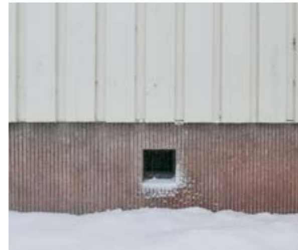
Sokkeli ja alapohjan tuuletusaukko. Sokkelipinta on rakennusaikakaudelle tyypillisesti uritettu.
