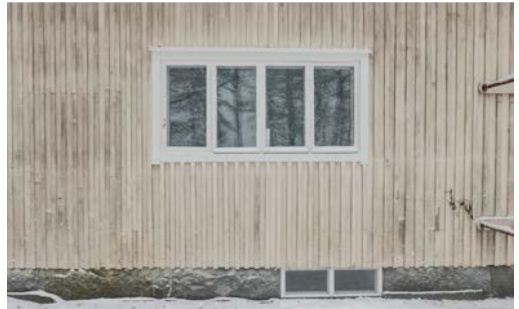
Vanhemman rakennuspuoliskon ulkoseinää ja ikkuna. Kuvassa näkyy vanhempi, luonnonkivistä tehty sokkeli.
