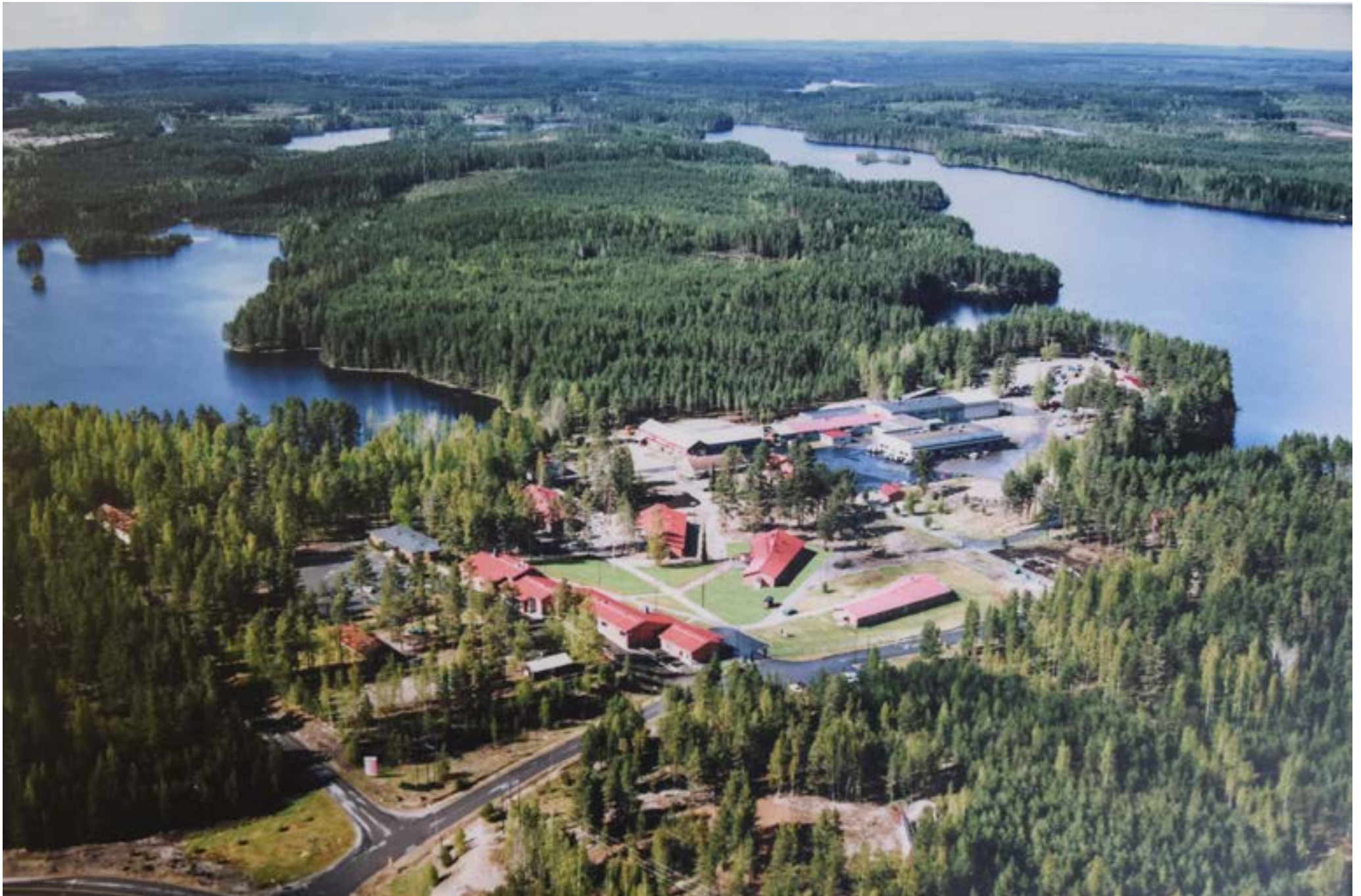
Viistokuva todennäköisesti vuoden 2010 paikkeilta. Kuva on otettu viistokuvasta, joka on kehyksissä vankilan huoltorakennuksessa.
