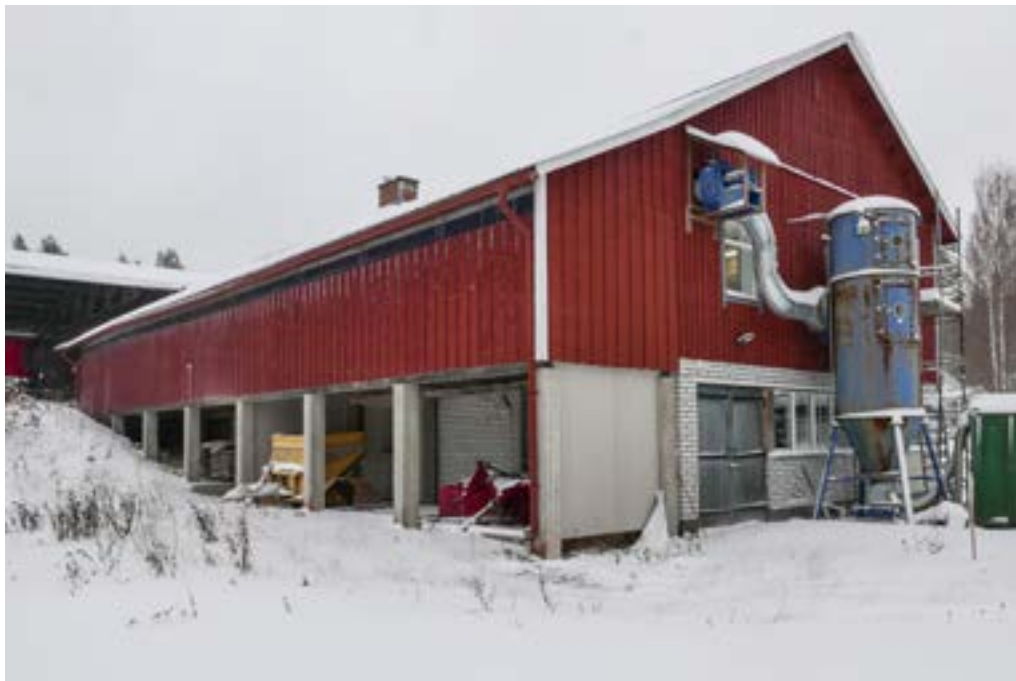
Rakennuksen koillissivun laajennusosa poikkeaa muusta rakennuksesta. Laajennusosa on rakennettu betonipilareiden varaan.
