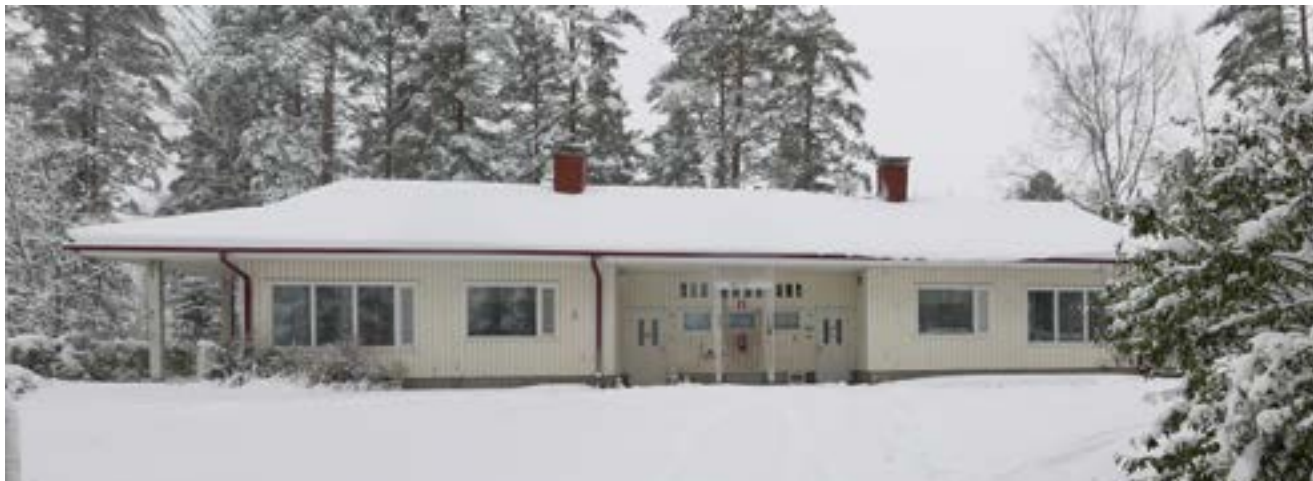
Kaakkoisjulkisivu rakennukselle saavuttaessa. Ilman alkuperäisiä tammiovia sisäänkäyntisyvennys sulautuu julkisivuun.
