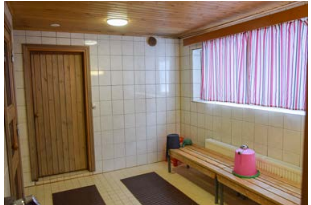
Suihkuhuone. Suihkuhuone ja sauna ovat säilyneet lähes alkuperäisinä. Ovien ja seinien vanhoja panelointeja on sävytetty harmaalla kuultokäsittelyllä.
