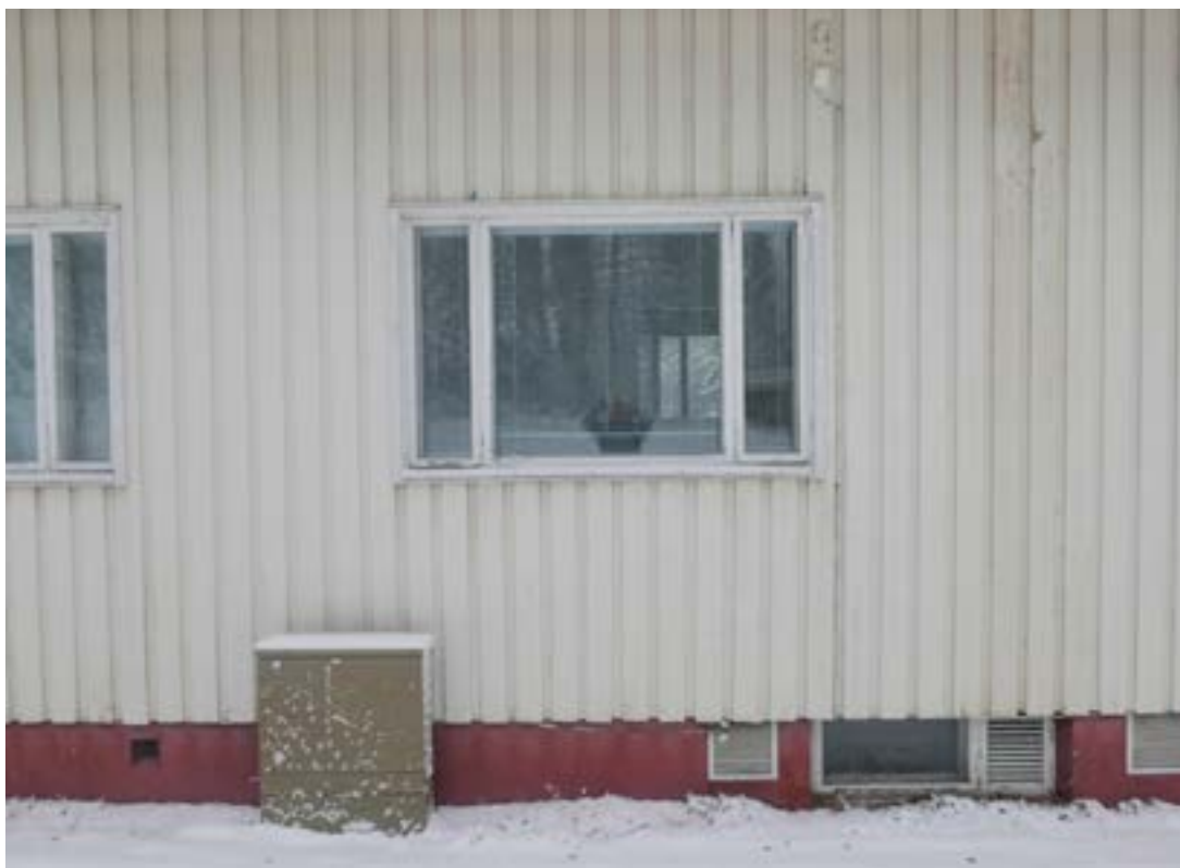
Rakennuksen ikkunat ovat alkuperäiset. Sokkelipinta on aikakaudelle tyypillisesti uritettu.
