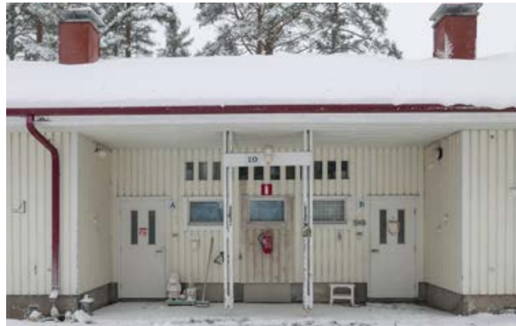
Uusitut ulko-ovat ovat hyvin tavanomaiset. Kaikki sisäänkäyntisynnyksen alkuperäiset ovet olivat tammea ja varustettu kuparisilla potkupuilleillä. Kellarin ja vierasasunnon ovet on ummistettu ja korvattu pienillä ikkunoilla.
