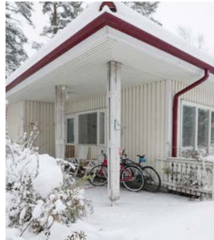
Räystäiden alapintojen näyttävä kulmissa jiirattu rimoitus ja kattoa kannattelevat erikoissuunnitellut puupilarit ovat säilyneet.
