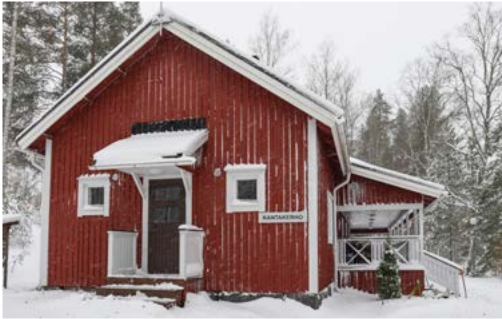
Rantakerhon itäpääty. Pienet neliöikkunat länsi- ja eteläisivulla on lisätty 1970-luvun muutosten yhteydessä, sillä niitä ei ole vuoden 1948 piirustuksessa.
