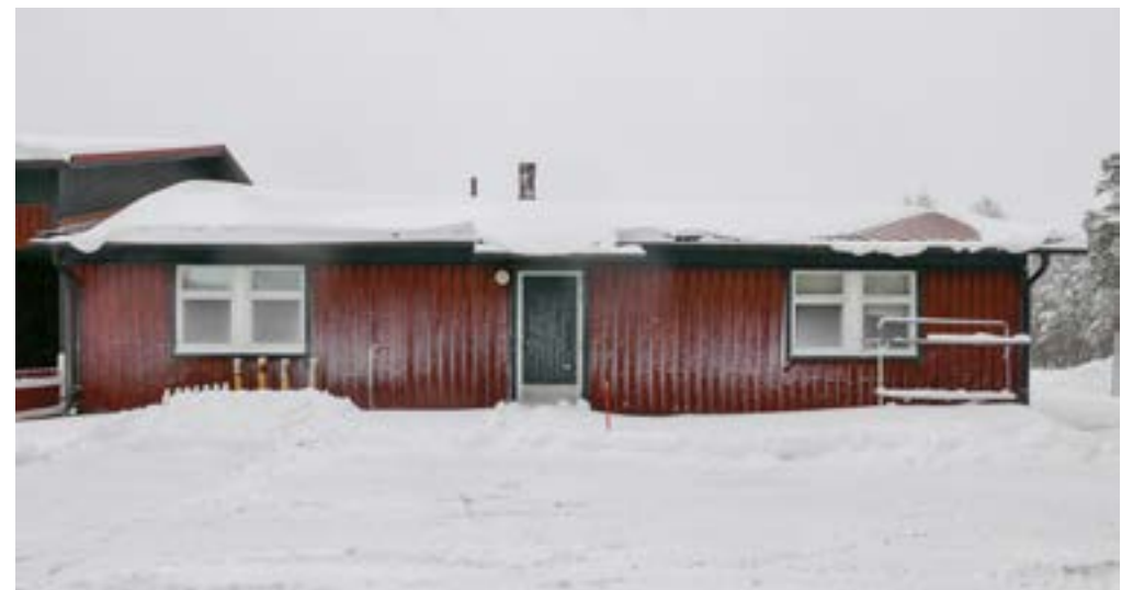
Vapaa-ajantilojen rakennusosa on säilynyt ulkoa alkuperäisenä. Sisätiloissa tilajako on säilynyt samana, mutta pukuhuoneet on kalustettu kirjastoksi ja vapaa-ajantilaksi.
