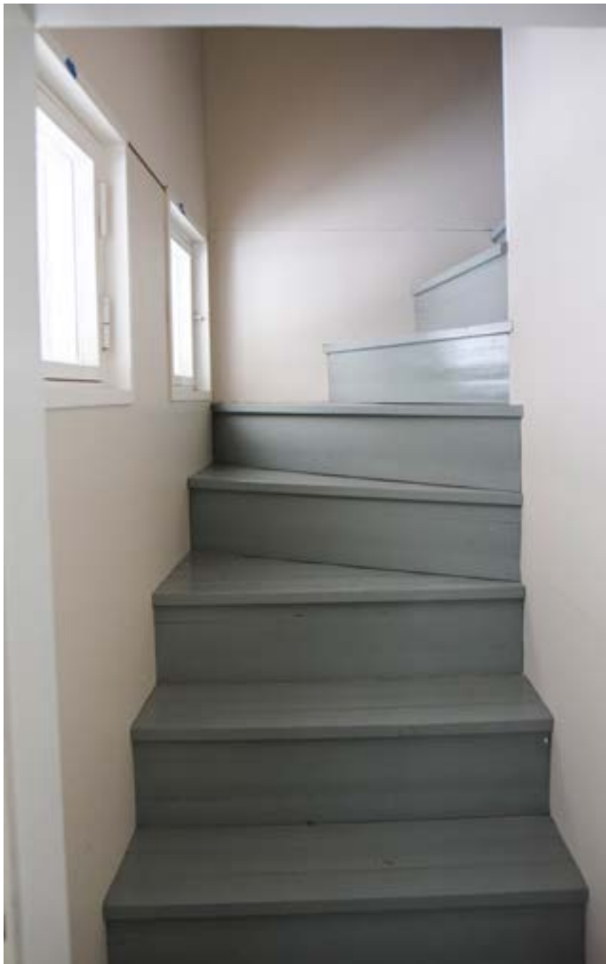
Asunnon B ullakkoporras on säilynyt alkuperäisenä.
