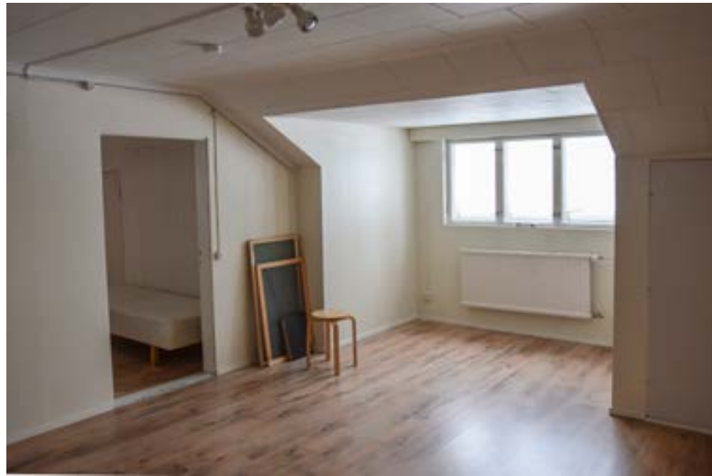
Ullakkokerroksessa on säilynyt 1950-luvulle tyypillinen puukuitulevykatto.
