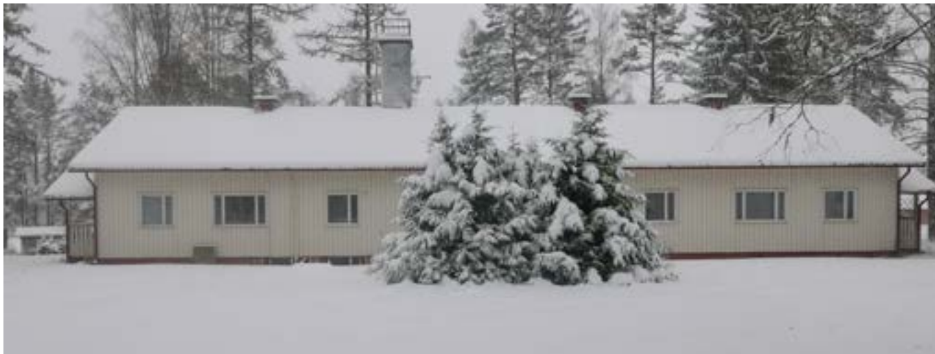
Rakennuksen lounaissivu. Ulkopuolelta rakennus on säilynyt lähes alkuperäisenä.
