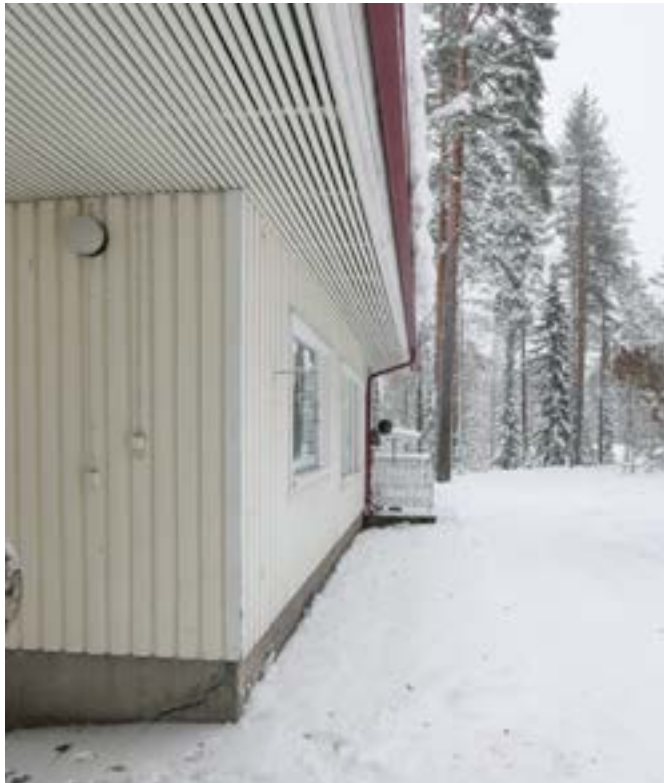
Rakennuksessa on koko sivun pituinen räystäärimoitus, joka näkyy kattopinnassa.
