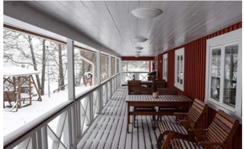
Rantakerhon terrassin ja portaiden kaiteet ja lattia on uusittu ulkonäön perusteella 1990-luvun korjauksessa.
