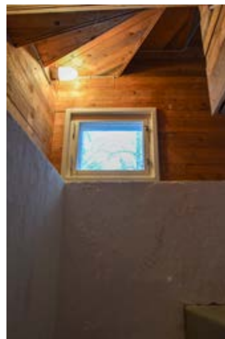
Asunnon A kellariin johtava porras on säilynyt alkuperäisenä. Rakennuksen ullakko on yksi yhtenäinen, kylmä tila.
