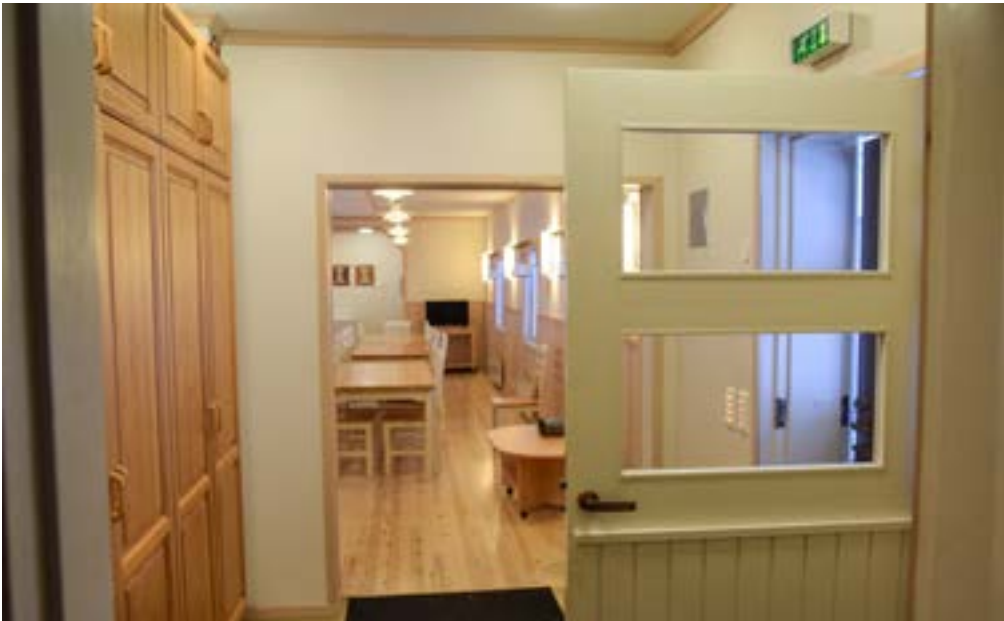
Eteistila saunan suunnasta. Eteisessä ja vilvoitteluhuoneessa on mahdollisesti alkuperäinen, maalattu lautalattia. Ulko-ovet ovat luultavasti alkuperäiset, kuten vilvoitteluhuoneeseen johtava peiliövi.
