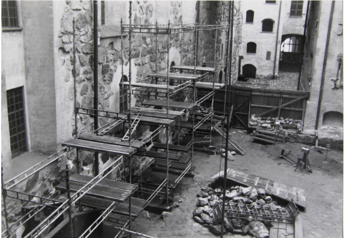
Kuva 16: Päälinnan pohjoissiiven eteläjulkisivun korjaustyöt vuonna 1990 (Ilmo Kajala, 6.8.1990).
