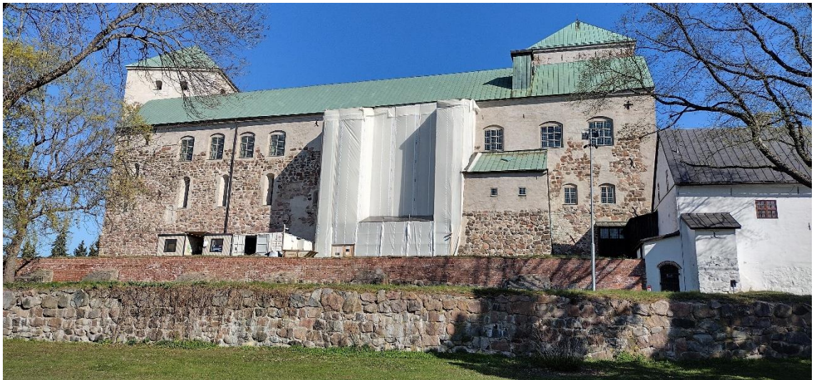
Kuva 18: Päälinnan eteläjulkisivun korjaustyöt keväällä 2023.
