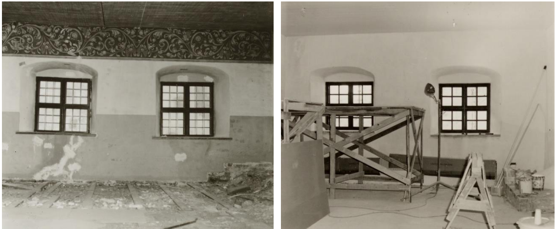
Kuva 13: Vasemmalla Brahen sali ennen korjausta (Ilmo Kajala 1979). Oikealla uusitut rappauspinnat ennen maalausten tekoa (Ilmo Kajala 1983).
