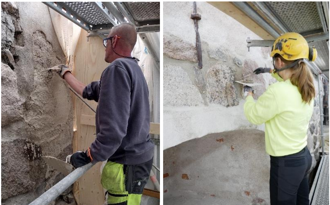
Kuva 21: Vasemmalla Markku Nykänen rappaa tiilipintaa Turun linnalla 4.5.2023. Oikealla kokeilen luonnonkivimuurin saumaamista Erkka Vainio-Ketolan ohjauksessa. (Helena Salo, 12.5.2023)
