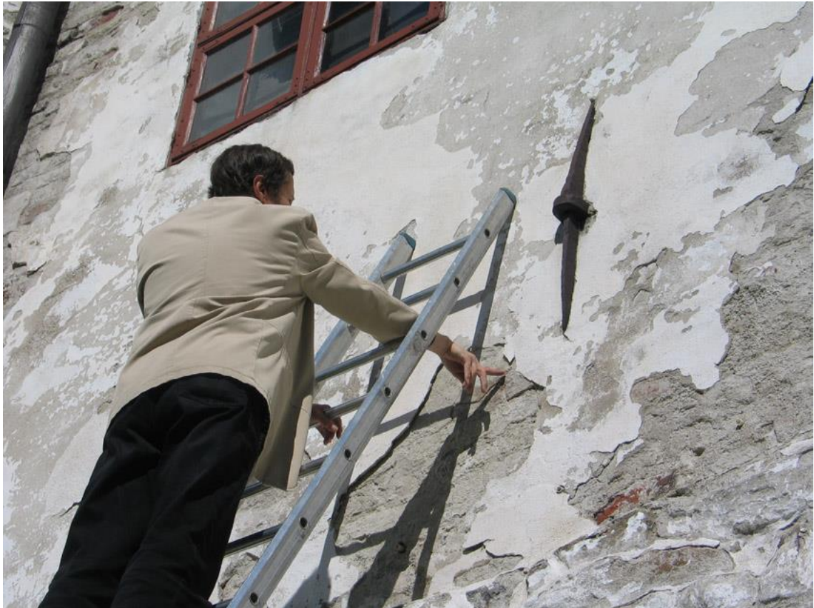
Kuva 20: Turun linnan eteläjulkisivun katselmus (Antti Suna, ei päivämäärää).
