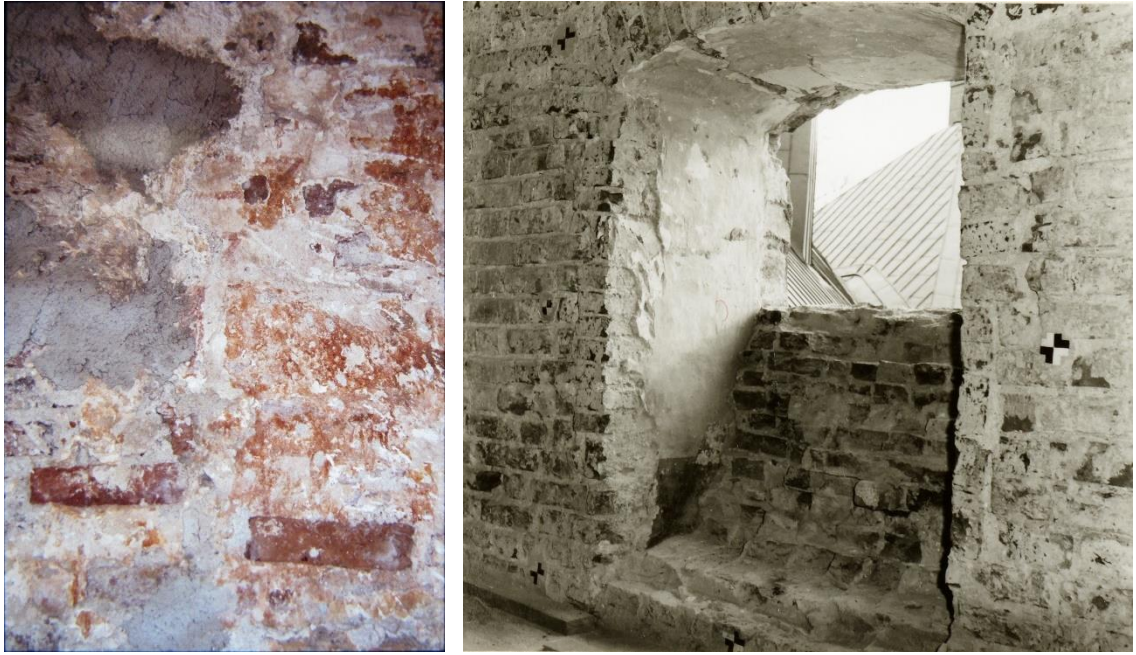
Kuva 12: Vasemmalla esilinnan pohjoissiiven julkisivurappauksessa erottuvat vanhat värit ( Pohjoissiiven eteläjulkisivun rappauskorjauksen värit , tuntematon valokuvaaja 1985). Oikealla eteläsiiven ikkunasyvennys, jossa on vielä jäljellä vanhaa rappauspintaa (Ilmo Kajala 1978).
