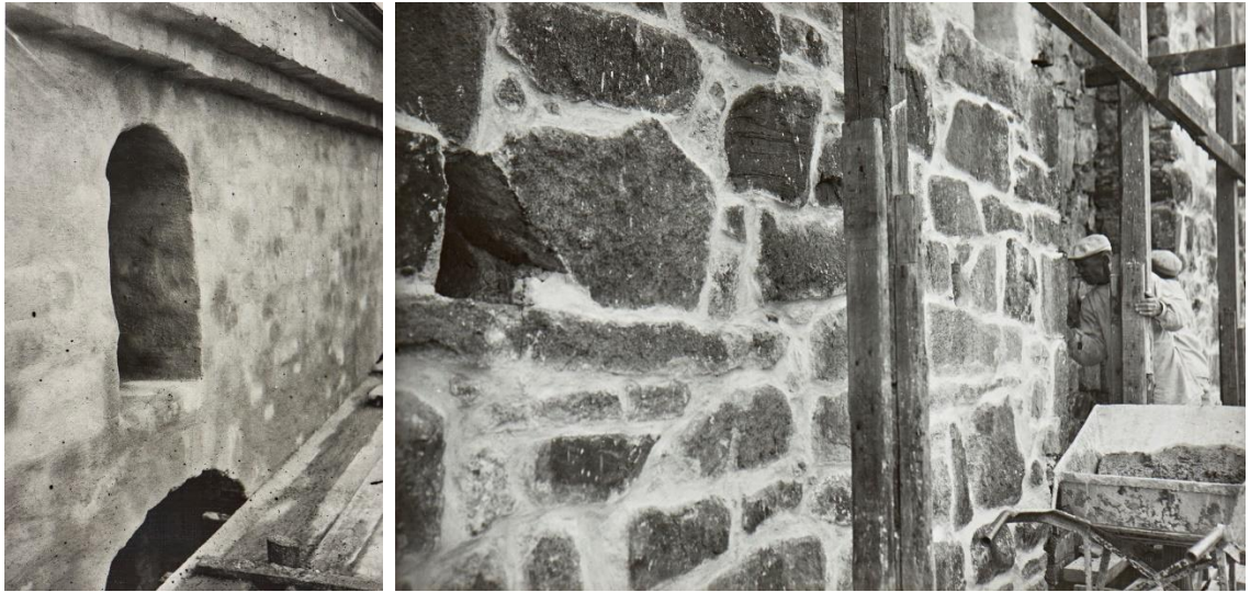
Kuva 9: Vasemmalla tiilipinnan rappaus vuonna 1950 ( Turun linnan länsitornin läntinen julkisivu, ylimmän kerroksen keskimmäisen ikkunan päällä oleva pienempi aukko , tuntematon valokuvaaja 1950). Oikealla luonnonkivimuurin tasasaumaus vuonna 1954 (Per-Olof Welin 1954).
