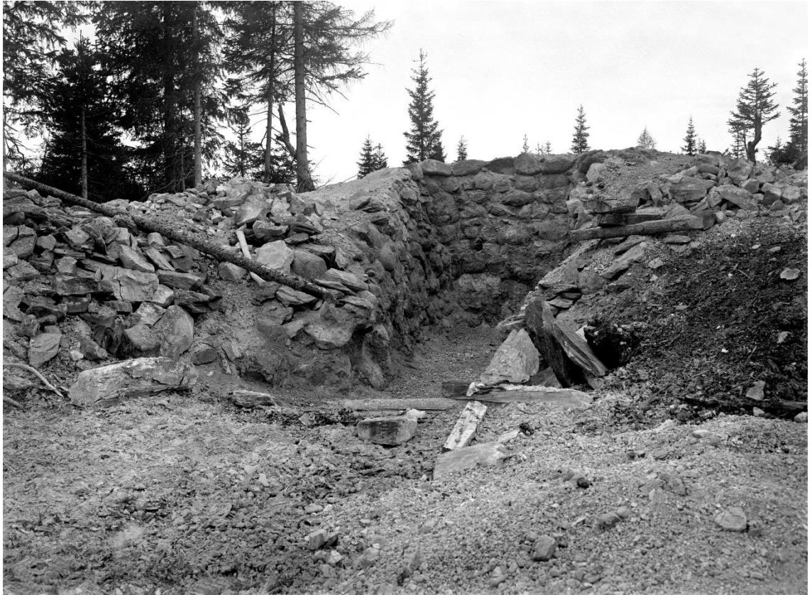
Kuva 4: Mäenrinteeseen kaivettu kalkkiuuni Kainuussa (Frosterus 1904).
