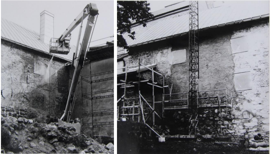
Kuva 14: Vasemmalla eteläsiiven vanha rappaus poistetaan painepesulla (Ilmo Kajala 1982a). Oikealla eteläsiipeen tehdään uutta rappausta (Ilmo Kajala 1982b).
