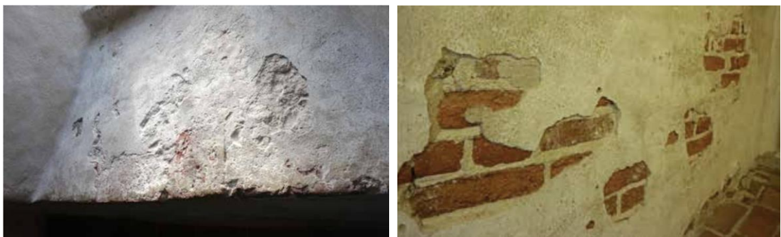
Kuva 19: Vasemmalla Kirjurintuvan ikkunapenkki ja oikealla portaikko M102 (Tiina Sonninen 2017, 7,38).
