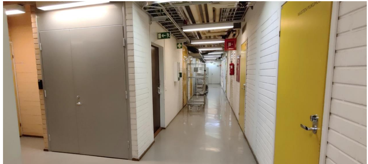
Kuva 226. Laboratoriosiiven käytävä, alkuperäisen osan kellarikerros.
