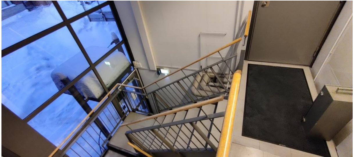
Kuva 229. Portaikko energiahallin toimistotiloihin (2000-luvun alusta).
