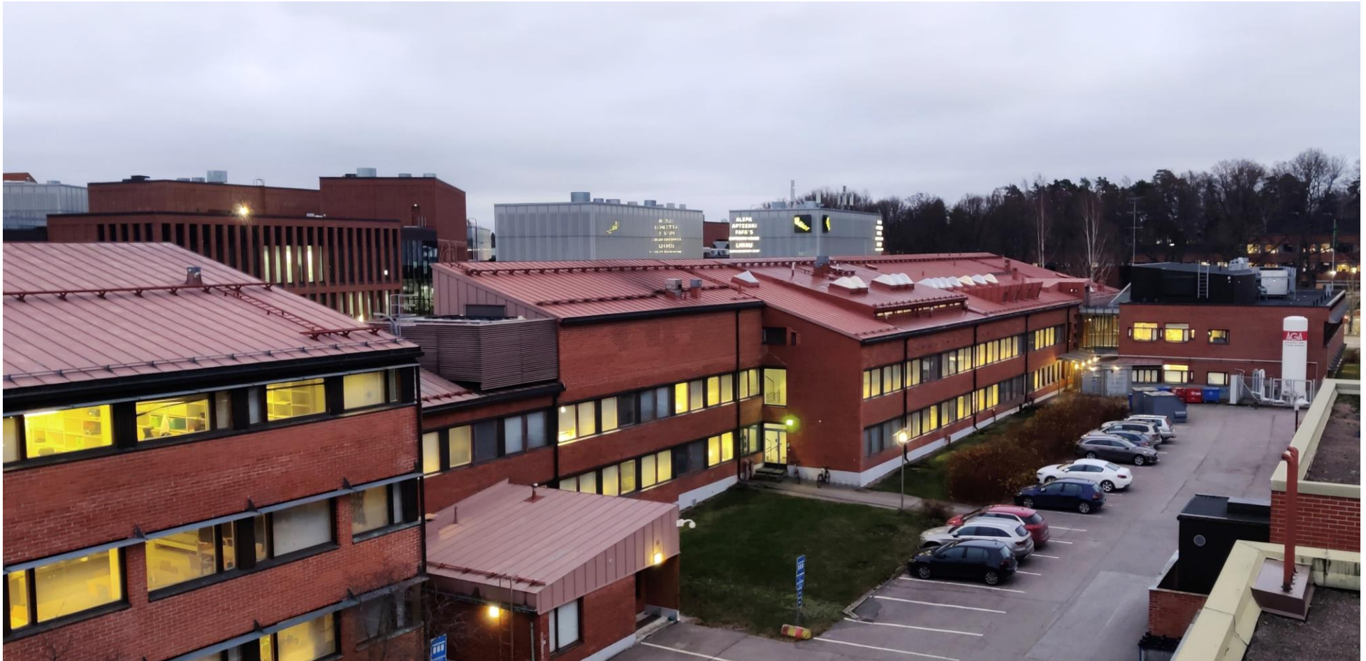
Kuva 156. Näkymä sisäpihalle Biotekniikan katolta. Vasemmalla laajennusosa vuodelta 1999, joka yhdisti Elintarviketeollisuuslaboratorion ja Biotekniikan laboratorion toisiinsa. Keskellä Elintarvikelaboratorion alkuperäinen osa ja sen edessä oleva entinen vahtimestarin asunto. Taus-talla vuonna 1993 rakennettu laajennusosa kaakkoon ja lehmuskuja.
