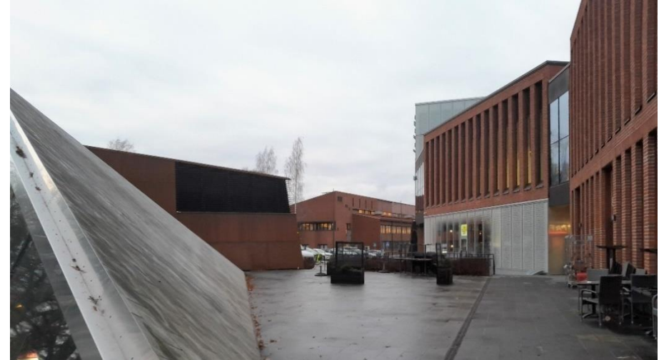
Kuva 93. Väreän ja metron ilmanvaihtorakenteiden väliin jäävä alue.
