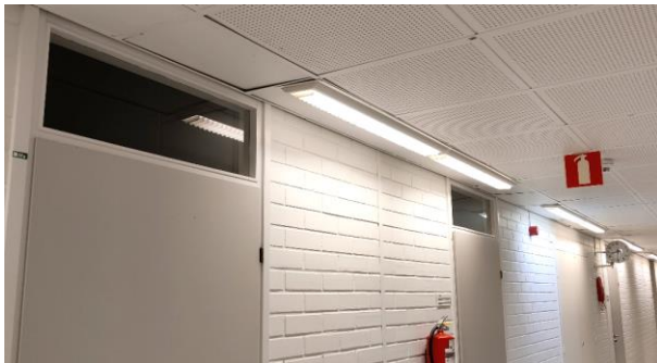
Kuva 190. A-siipi, kellarin käytävä.
