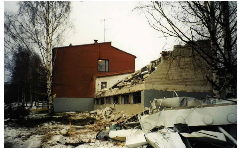
Kuva 47. Tietotie 2 C lisärakennuksen työt alkavat autotallien ja varastojen purkamisella joulukuussa 1997. Lähde: VTTA. Kuvaaja tuntematon.
