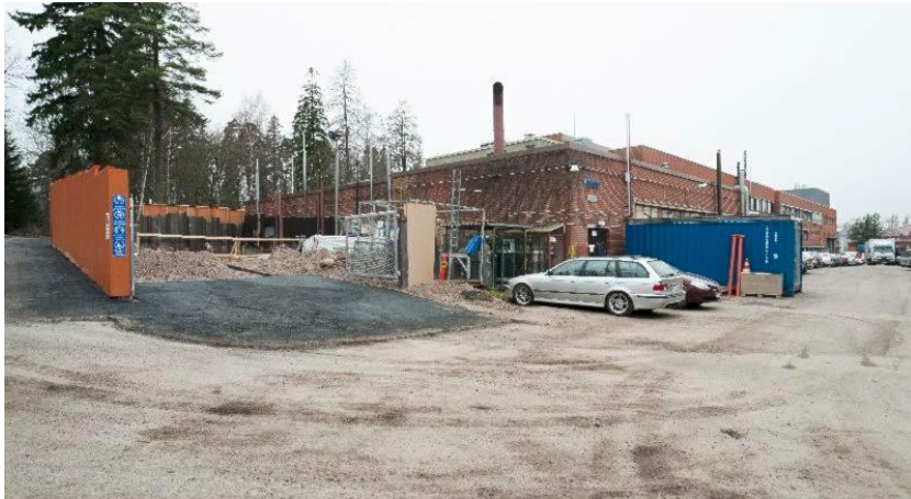
Kuva 51. Aalto-yliopiston metroaseman rakennustyömaa (2011). Kuvaaja Järvinen Ilmari. Lähde: KAMU, Finna -palvelu (5.1.2023).
