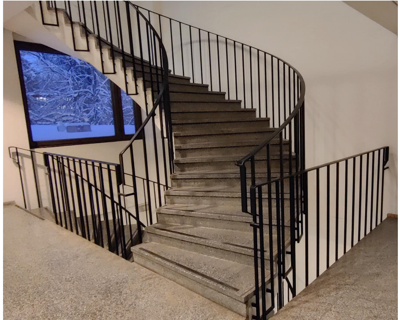
Kuva 193. A-siiven porrashuone. Laboratoriosiiven keskiosan portaat ovat kierreportaita ja siiven kaakkoispuolella on erillinen porraskuilu. Lattiamateriaalit ja kaiteet ovat alkuperäisiä. Käytävillä olevat ikkunapenkit on laatoitettu mustalla laatalla.
