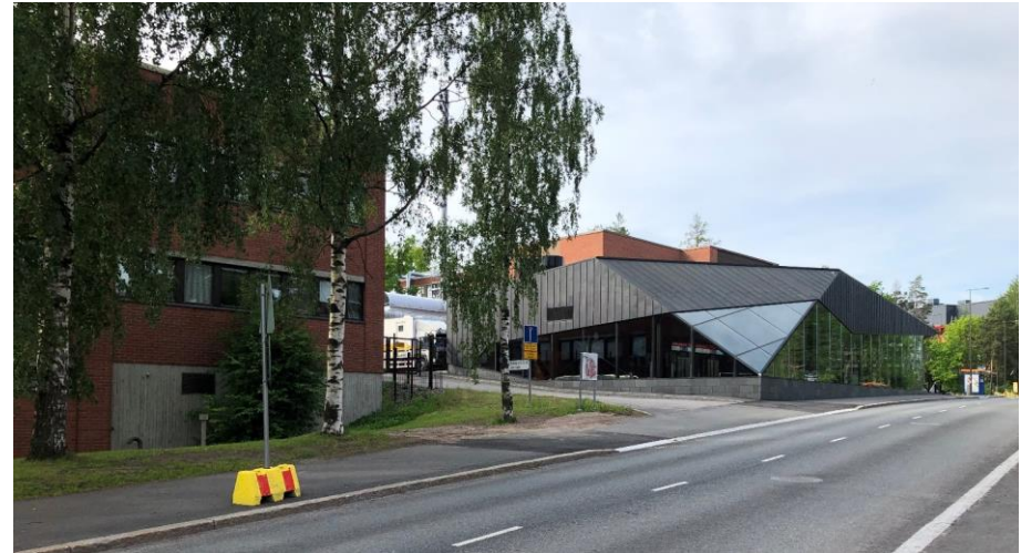
Kuva 86. Metrosisäänkäynti Tietotieltä pohjoisen suunnasta. Kuva SW 2020.
