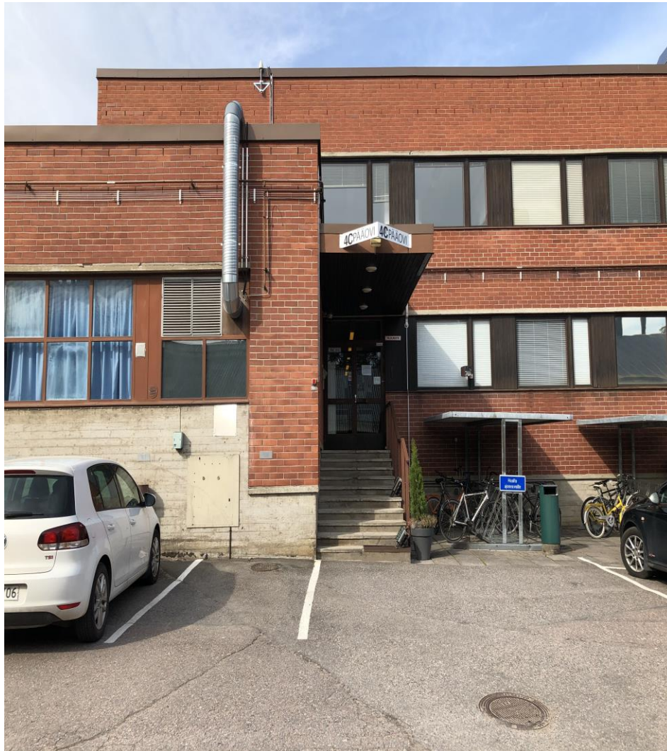
Kuva 214. Tietotie 4 C, pääsisäänkäynti koillisjulkisivulla. Pääoven kohdalla on pitkä katos ja ulkoportaat. Kuva: SW, 8.6.2020.
