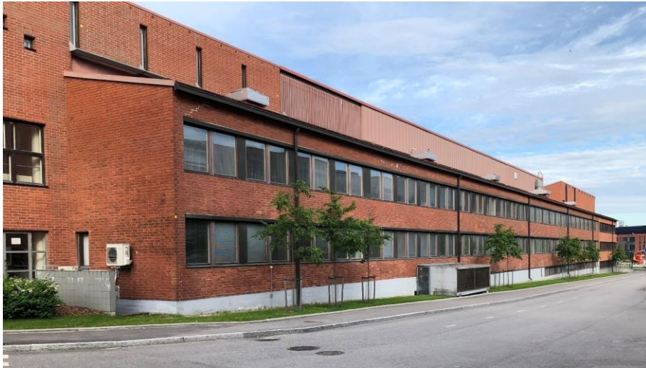
Kuva 152. Elintarviketeollisuuslaboratorion alkuperäinen osa, julkisivu koilliseen. Kuva: SW, 8.6.2020.
