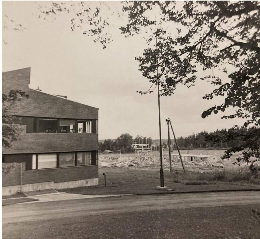
Kuva 34. VTT:n Elintarvikelaboratorio rakenteilla taustalla avoimeen maisemaan 1960-luvun alkuvuosina. Vasemmalla vuonna 1960 valmistunut Alvar Aallon suunnittelema ensimmäinen Öljy- ja turveteknillinen laboratorio. Lähde: Tietotie 4 C tiloissa olevat valokuvat. VTTA.
