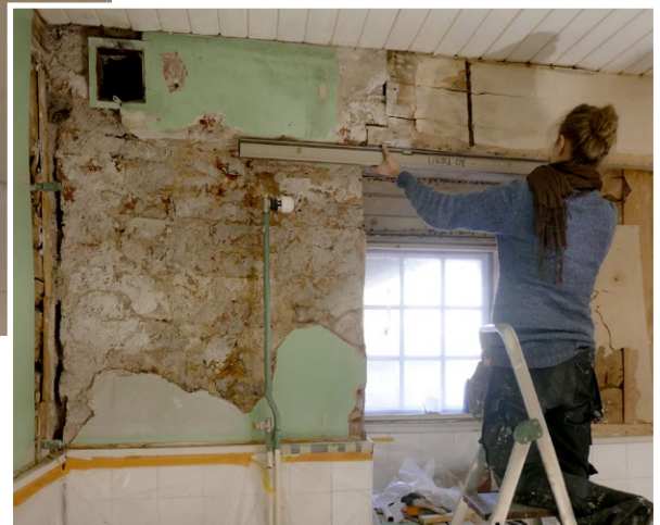
↑ Hormin rappaukset jouduttiin suurimmaksi osaksi uusimaan. amoy 18.11.2020
