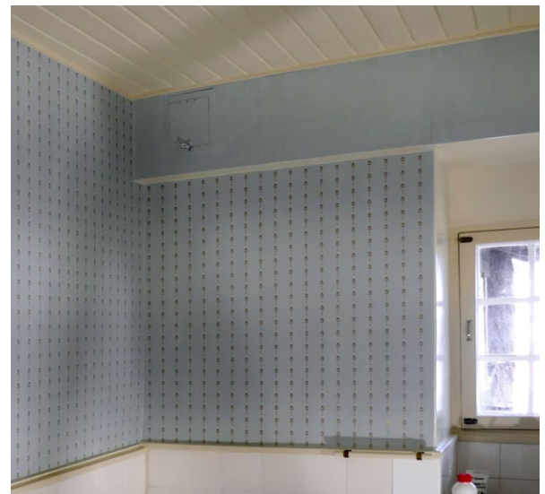
↓ Rapattu hormi maalauksen jälkeen. Hormin kohdalla ikkunoiden yläpuolinen puurakenteinen paperoitu otsapinta muuttuu rapatuksi. Materiaalin vaihtumakohtaan tehtiin matala ura. amoy 3.5.2021
