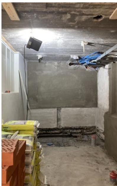
Seinien tasoitus ja sähköasennukset WC:ssä 017; 15.3.2022.
