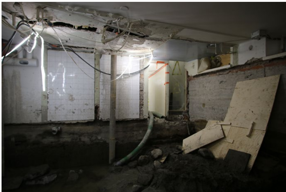
Alapohjan purku sekä maa-aineksen poisto apukeittiössä 07; 7.10.2021.
