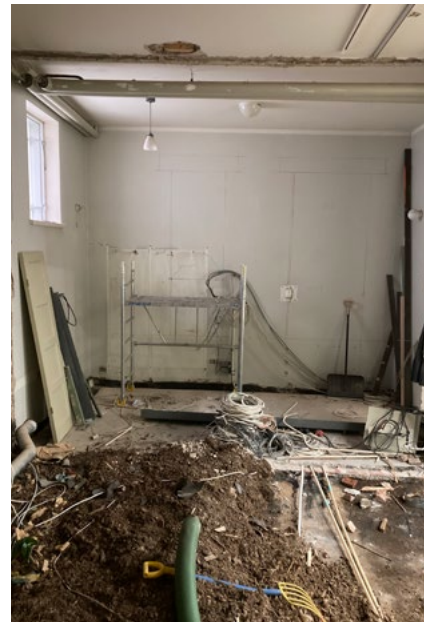
Alapohjan purku tilassa 102; 16.9.2021.
