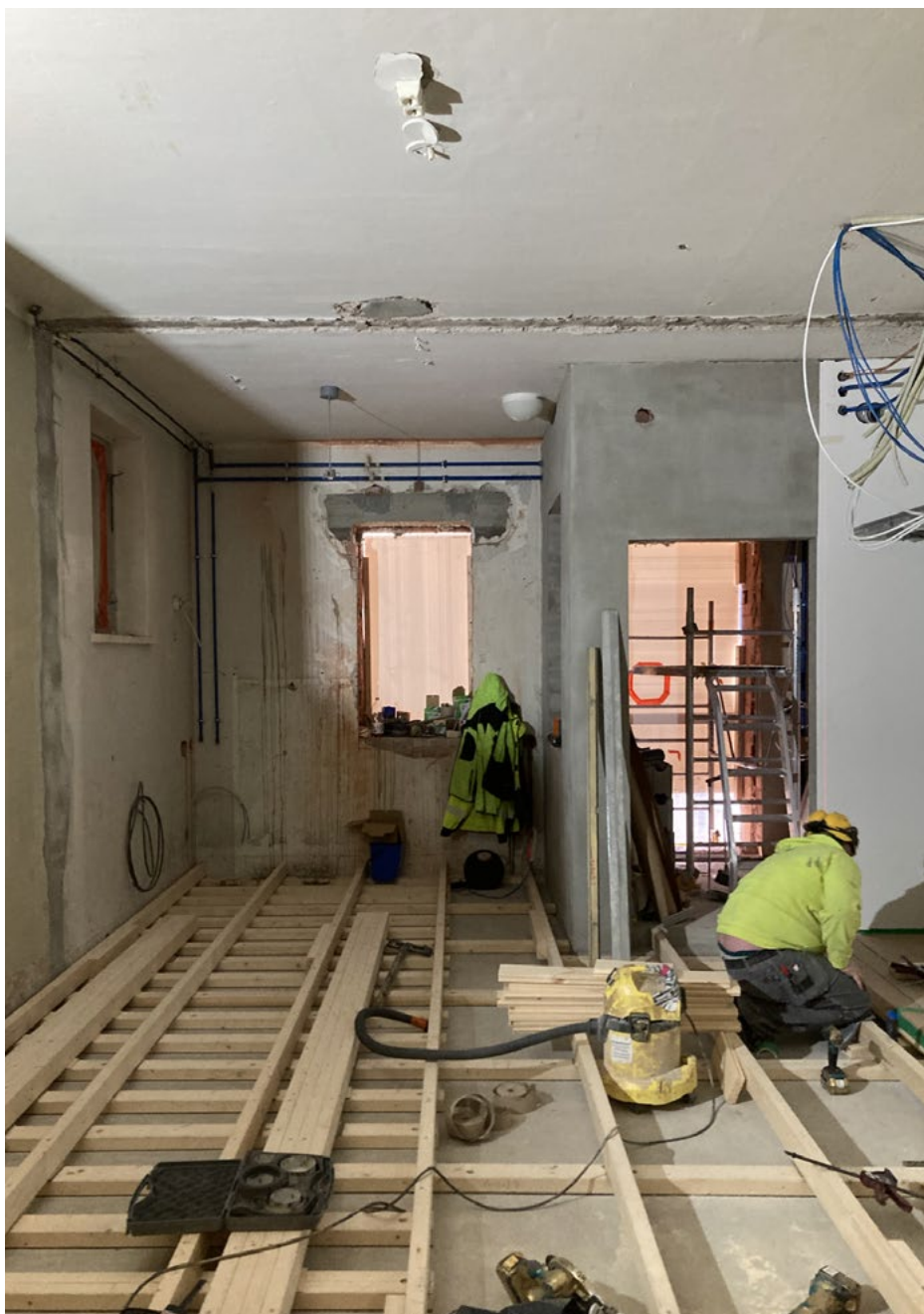
Alapohjan koolaukset toimistossa I02; 31.3.2022.
