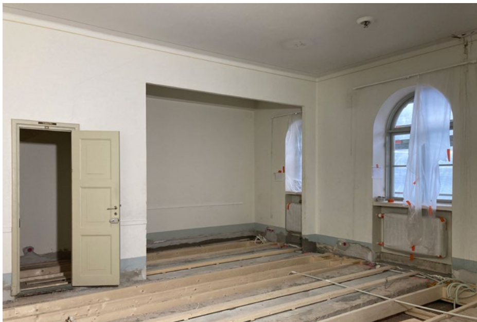
Lattian uudet koolaukset kahvihuoneessa 401; 23.11.2021.
