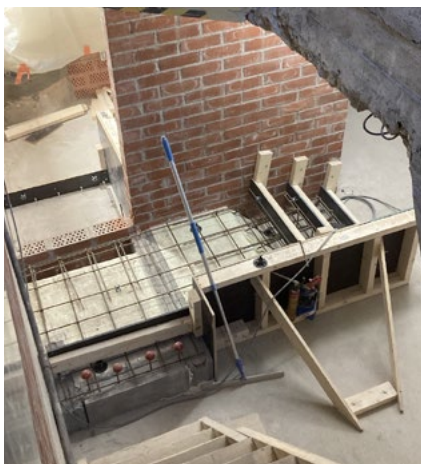
Betoniportaan valumuotti apukeittiössä 07; 15.3.2022.
