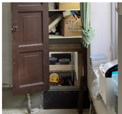
Komeron 113 pohjan korottaminen; 15.3.2022.
