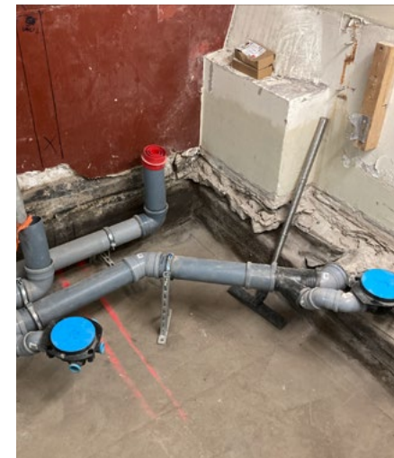
Uudet viemäriputket WC-tilassa 017; 9.2.2022.
