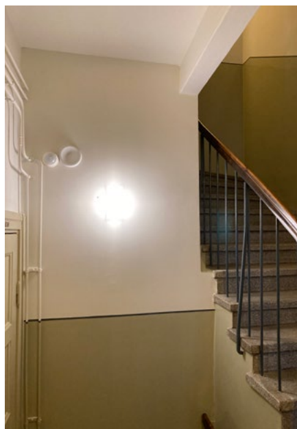
Uusi palkki ja uusi väliseinä; 6.9.2022.
