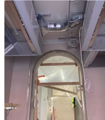
Huuvien asennus keittiössä 112c; 19.5.2022.
