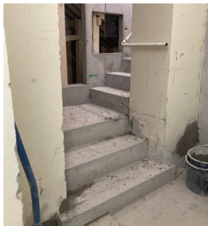
Uudet betoniporrait ennen sementtimosaikkiaskeleiden asentamista; 28.4.2022.
