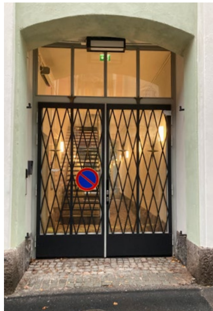
Vanhan teräsportin ja uuden teräs-lasirakenteisen ulko-oven yhdistelmä; 5.10.2022.
