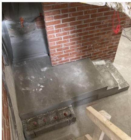
Vastavalettu betoniporras; 24.3.2022.
