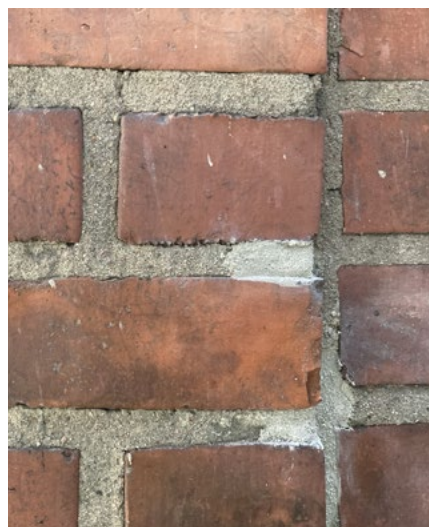
Tiilijulkisivun korjaus, ei vielä patinoitu; 9.12.2021.
