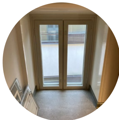
Muutettu ikkuna puretun kierreportaan kohdalla; 6.9.2022.
