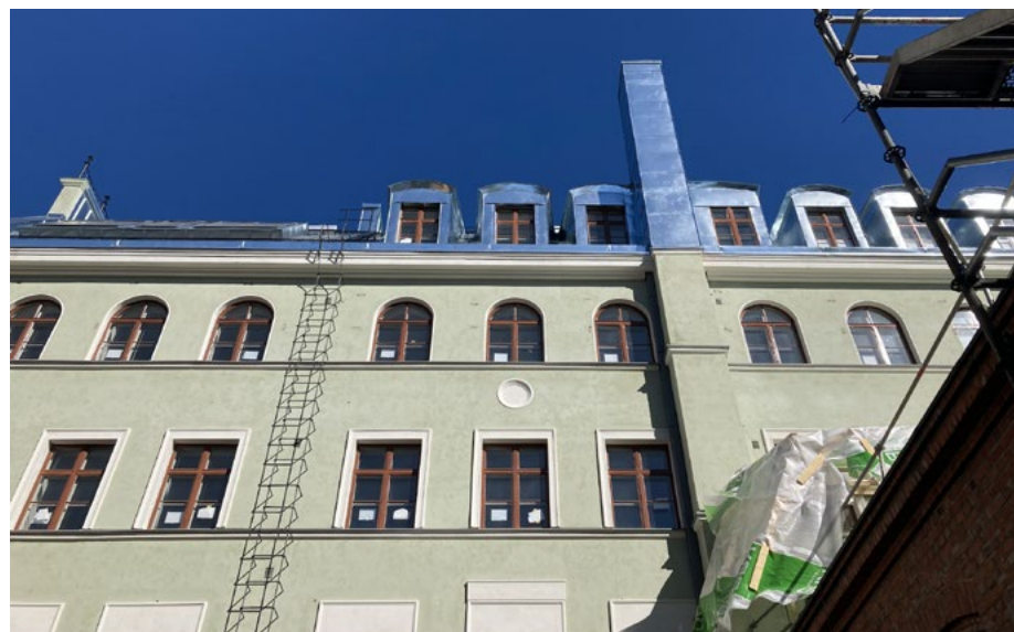
Korjattu julkisivu ja vesikatto; 21.4.2022.
