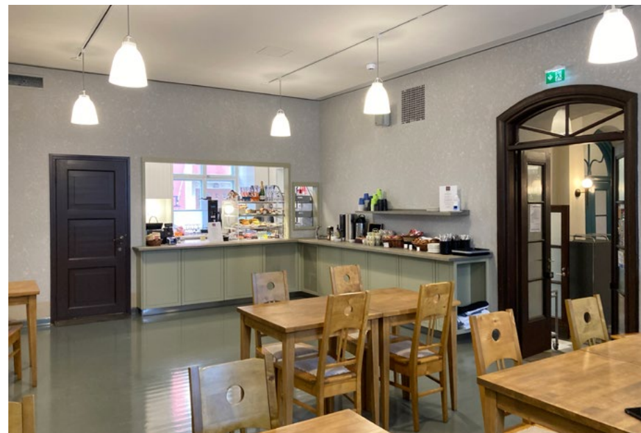
Valmis kahvila I 16, jonka seinillä on jalustavyöhyke ja sienitöppäys; 6.9.2022.
