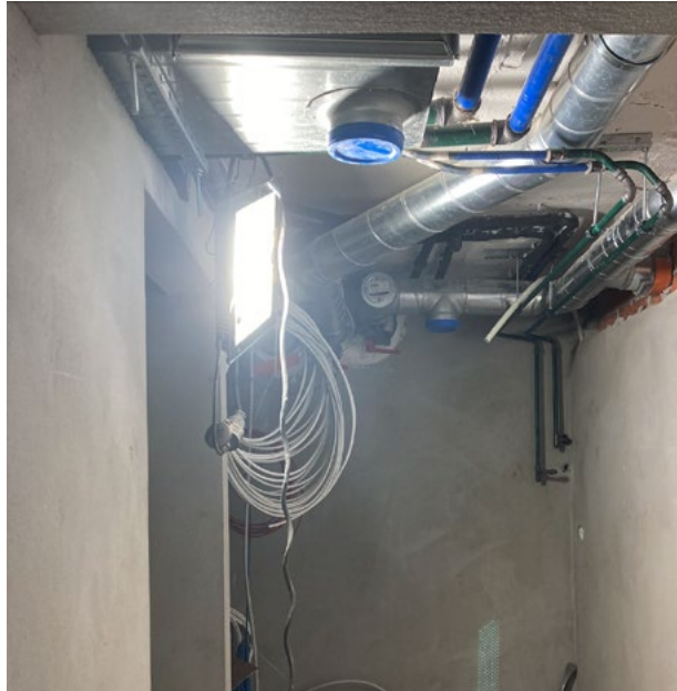
Talotekniikka-asennuksia sos. tilassa 018; 19.5.2022.
