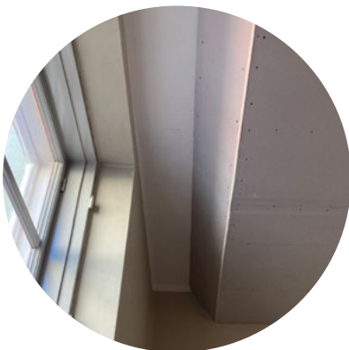
Postitushuoneen 318 uusittua alakattoa; 31.3.2022.
