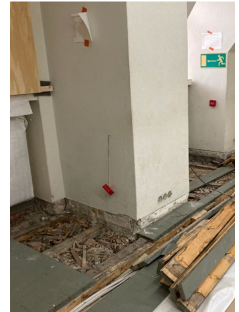
Muottilaudoitusten purku lattiasta toimistossa 404; 23.9.2021. Lattialaudoituksen purku kokoustilassa 504; 16.9.2021.
