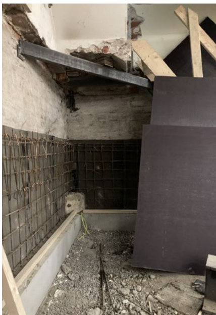
Vedenpaine-eristyksen nosto ja verhomuurauksen betonisokkelin rauditus apukeittiössä 07; 30.12.2021.
