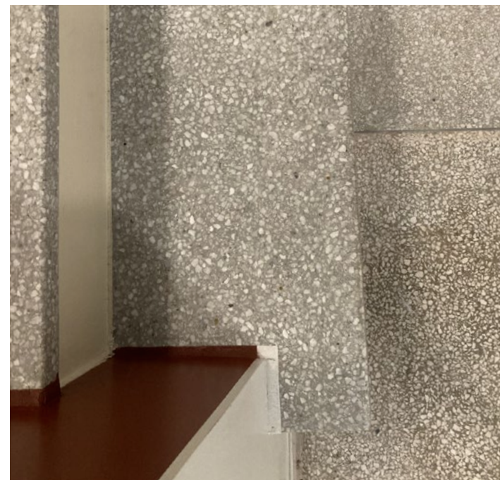
Vanhaa ja uusittua sementtimosaikkilattiaa sekä porraskaskelmia käytävässä 014; 5.10.2022.
