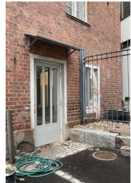
Uusi sisäänkäynti ja ikkuna; 14.6.2022.
