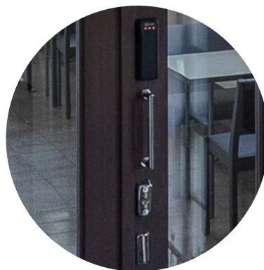
Väliseinäkkeen uuden oven helat; 5.10.2022.
