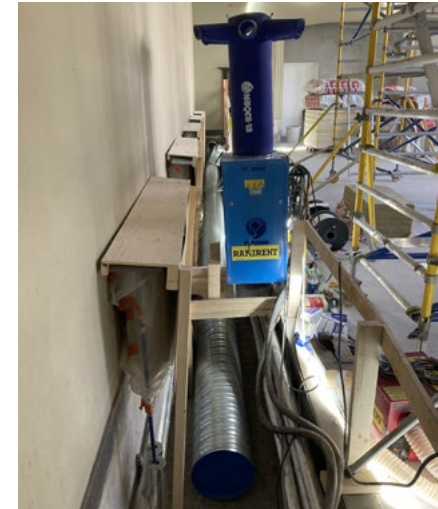
Juhlasalin lattiakanaali ja uusi tuloilmakanaava, seinällä uudet radiaattorit; 31.3.2022.
