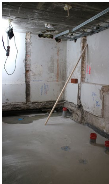
Uusi lattia WC:ssä 017; 2.3.2022.
