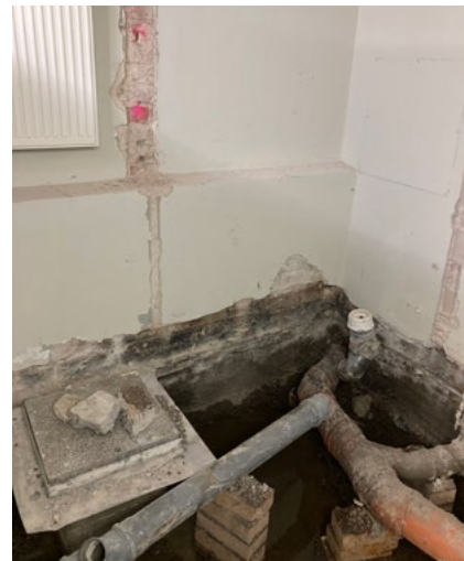
Viemäriputket ennen purkua sosiaali-tilassa 05; 16.9.2021.
