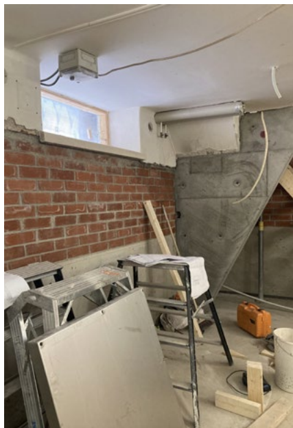
Uusittu verhomuuraus ja uusi vinopalkki apukeittiössä 07; 10.3.2022.
