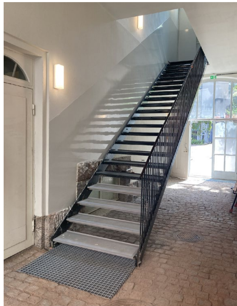
1990-luvun teräsportas alkuperäisessä porttikäytävässä eli porrashuoneessa 117; 22.7.2022. Teräsportaan alimmat askelmat irrotettiin alapohjan avauksen vuoksi. Askelmat kuitenkin katosivat, minkä vuoksi niiden tilalle jouduttiin teettämään uudet 1990-luvun detaljipiirustuksen mukaisesti.
