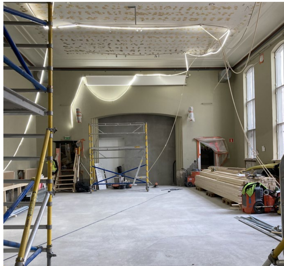
Juhlasali 104, alapohjan uusi teräsbetonilaatta ennen uutta koolausta; 24.3.2022.
