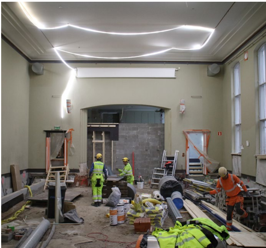
Juhlasali 104, lautolettia ja koolaukset purettu, alapohjan vanha betonilaatta vielä purkamatta; 17.2.2022.
