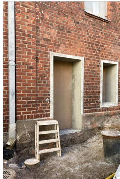
Uusi sisäänkäynti ja ikkuna; 21.4.2022.
