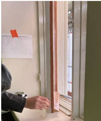
Kunnostetun ikkunan katselmointi 11.11.2021.
