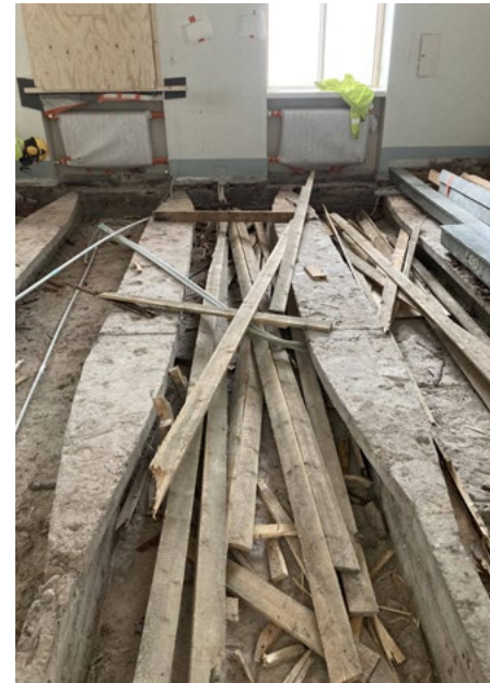
Muottilaudoitusten purku lattiasta toimistossa 404; 23.9.2021. Lattialaudoituksen purku kokoustilassa 504; 16.9.2021.
