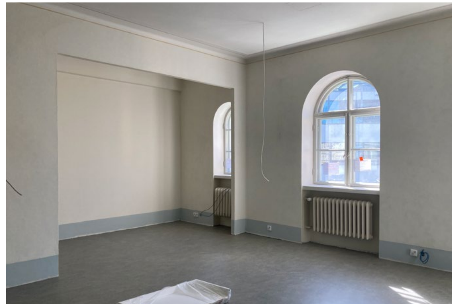
Linoleum-maton asennus, sähköasennukset ja pintojen maalaus kahvihuoneessa 401; 22.4.2022.
