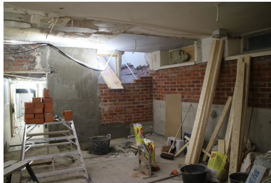
Väliseinien ja verhomuurauksen rakentaminen apukeittiössä 07; 2.3.2022.
