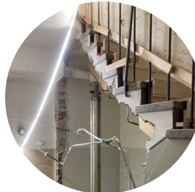
WC:n 106 väliseinän purku; 31.9.2021.
