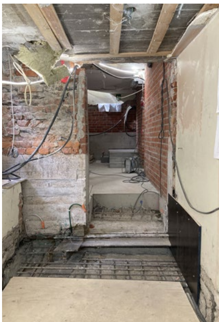
Tarjoiluvaunutilan 014b lattian ja portaan rakentaminen; 24.3.2022.
