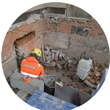
IV-kanavan reitin purku ulkoseinään lattian alle; 5.1.2022.
