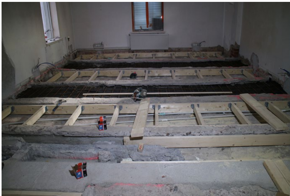
Välipohjan korjaus toimistossa 201; 16.9.2021.
