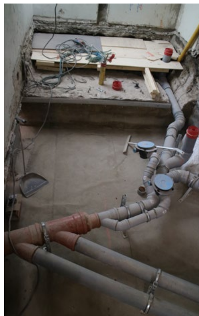
Viemäroinnin asennus WC:ssä 017; 17.2.2022.
