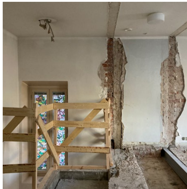
Välipohjan rakentaminen puretun kierreportaan aukkoon toimistossa 301; 14.10.2021, 9.12.2021; 2.3.2022.
