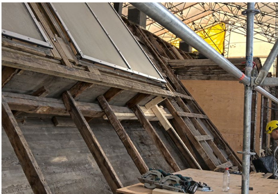
Katon rakenteiden korjaus; 27.7.2021.
