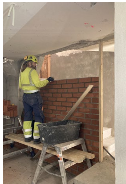
Porrashuoneen 020 väliseinän muuraus apukeittiössä 07; 28.4.2022.
