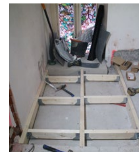
Välipohjan rakentaminen puretun kierreportaan aukkoon toimistossa 301; 14.10.2021, 9.12.2021; 2.3.2022.
