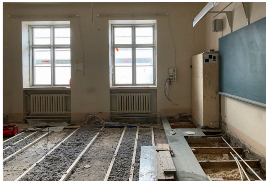
Välipohjan puhallettu puukuitueriste toimistossa 312; 16.12.2021.
