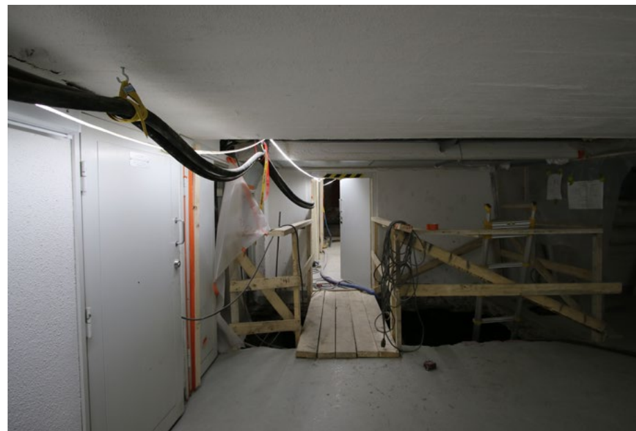
Purettu lattia uuden raitisilmakanavan kohdalla tilassa 013; 16.12.2021.
