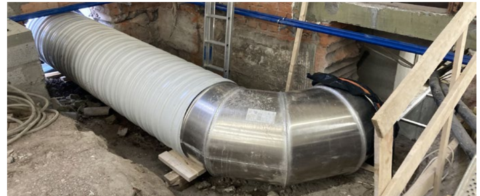
Uusi raitisilmakanava juhlasalin 104 alapohjan alla; 9.2.2022.
