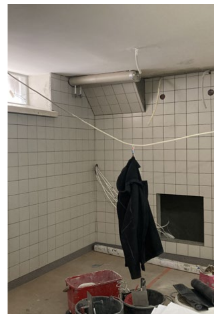
Apukeittiön 07 laatoitus ja tarkastusluuku; 19.5.2022.
