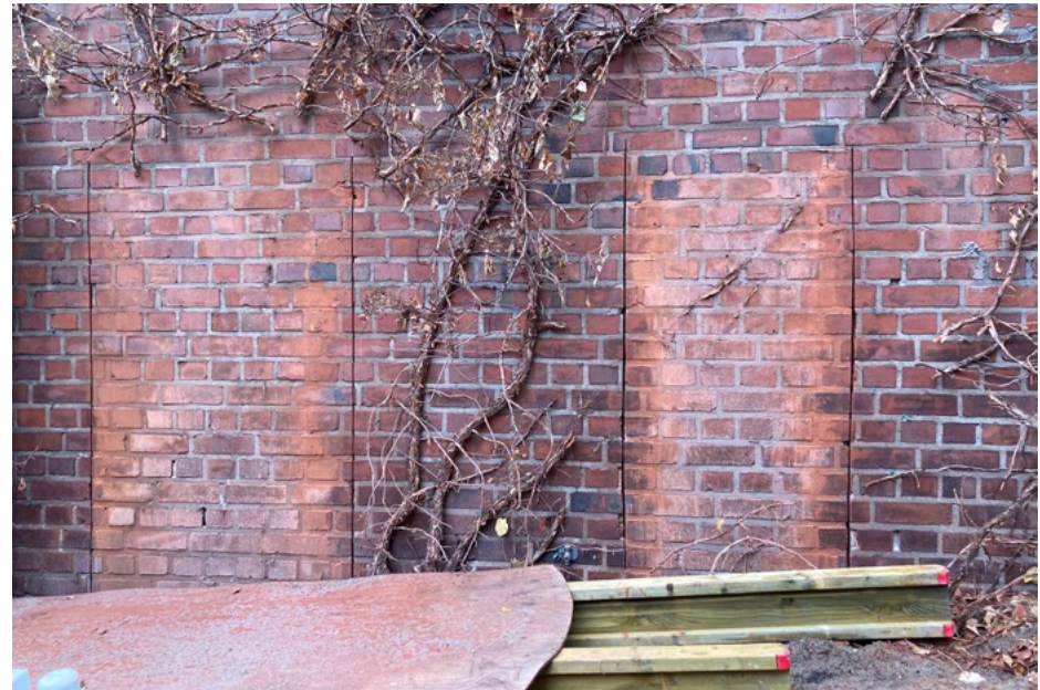
Siipirakennuksen uuden ovi- ja ikkuna-aukon purkaminen vanhaan julkisivuun; 28.10.2021.
