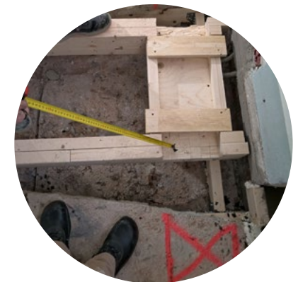
Sähkökouru välipohjassa; 6.10.2021.
