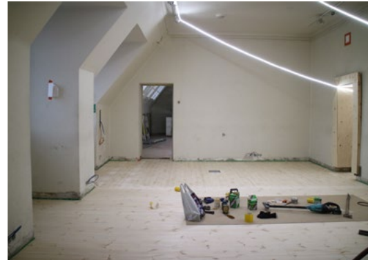
Kokoushuoneen 504 uusittu laualattia; 17.2.2022.
