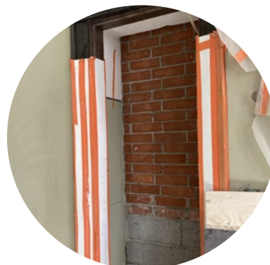
Juhlasalista siipirakennuksen päätyosaan johtavan oviaukon umpeenmuuraus; 21.4.2022.
