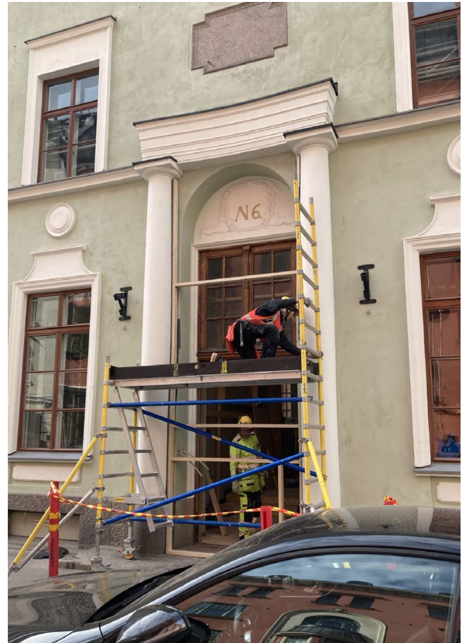
Pääsisäänkäynnin oviautomatiikan asennus; 19.5.2022.
