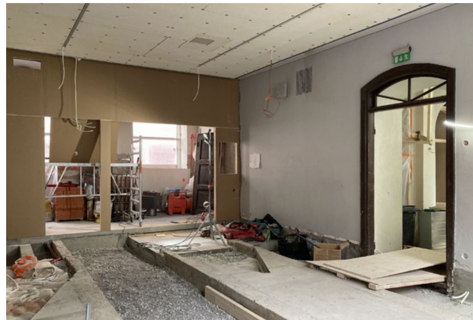
Väli­pohjan korjaus ja sisä­katon akustinen pinnoite kahvilassa I 16 sekä tarjoilutilan I 20 vastainen väliseinä; 24.3.2022.
