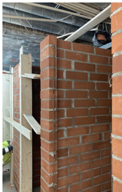
Eriöiden väliseinien muuraus WC:ssä 017; 31.3.2022.
