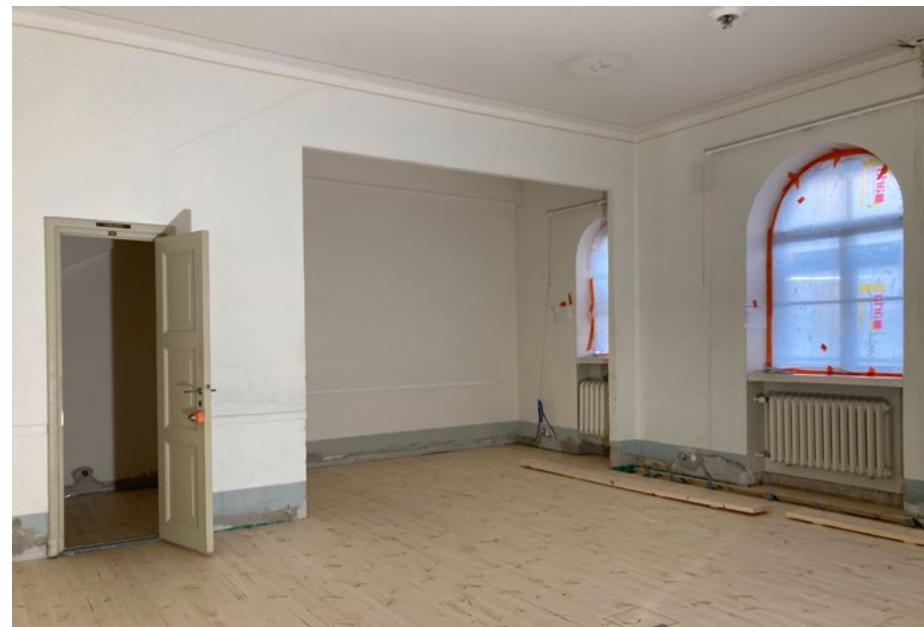
Uusi lattialaudoitus kahvihuoneessa 401; 16.12.2021.
