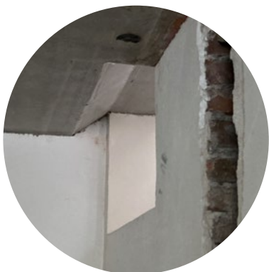
Umpeen valettu kierreportaan aukko toimistoissa 201; 9.2.2022.
