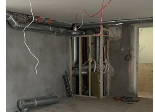
Uusia ilmanvaihtokanavia siipirakennuksen päätyosan toimistossa 301; 21.4.2022.
