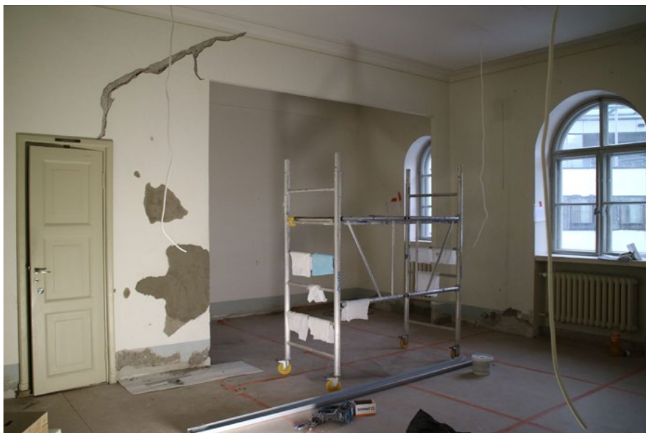
Väliseinien rappauskorjaukset ja sisäkaton akustinen pinnoite kahvihuoneessa 401; 17.2.2022.
