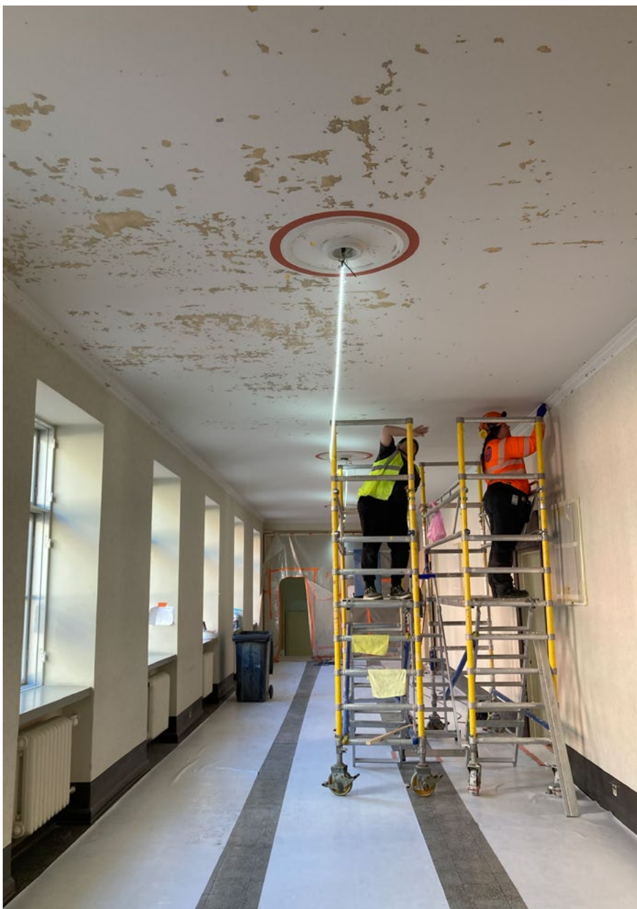
Hallin 315 sisäkaton pohjatöitä ylimaalausta varten; 31.3.2022.
