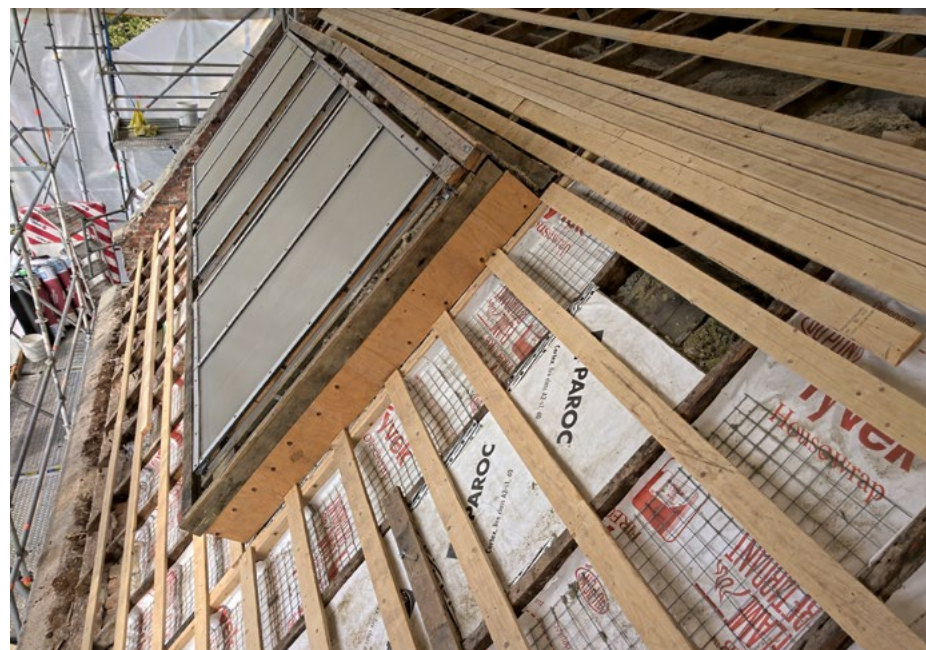
Katon korjaus ja eristys; 12.8.2021.
