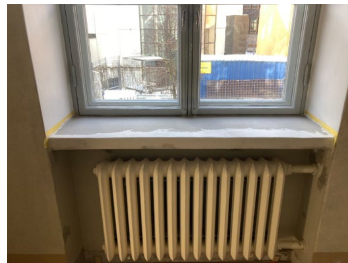
Ikkunapenkin kunnostus luokkatilassa; 10.3.2022.
