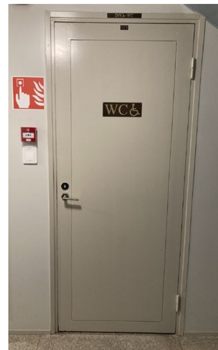
Kunnostettu 1990-luvun väliovi päärakennuksen kellarin käytävällä 014; 5.10.2022.
