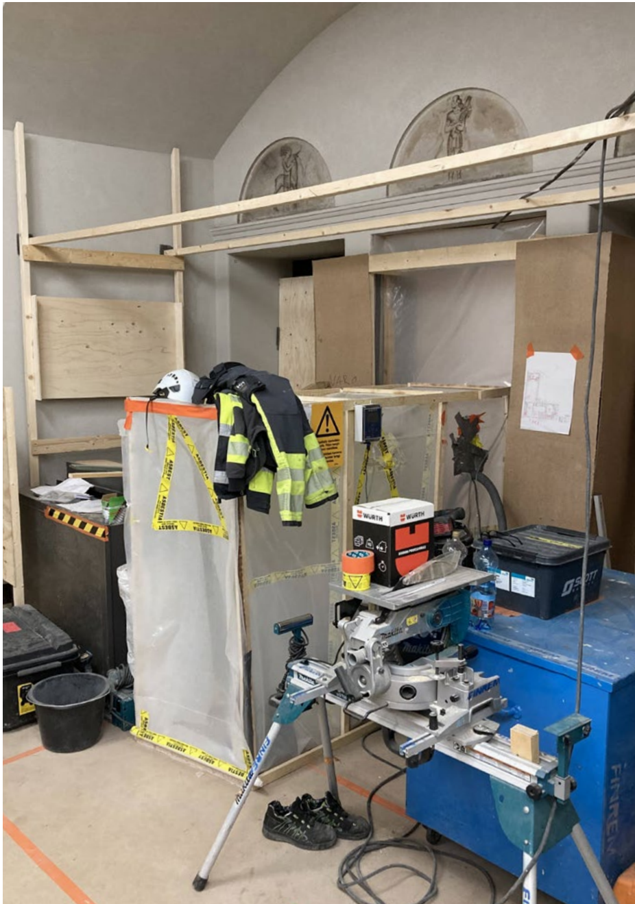
Juhlasalin sisäänkäynti aulasta 112; 23.9.2021.
