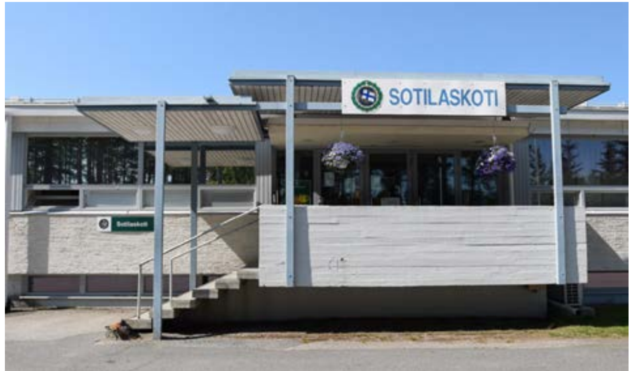
Pääsisäänkäyntien uudet lipat ovat kaksiosaisia. Lipan ylempi levennysosa on tuettu vanhan lipan päälle. Ulkoportaatt kattava osa on samassa linjassa vanhan lipan alareunan kanssa. Teräsosat on maalattu suunnitelmien mukaan vaalean sinisiksi. Lippojen alapintojen panelointi suunniteltiin kuultokäsittelyksi.
