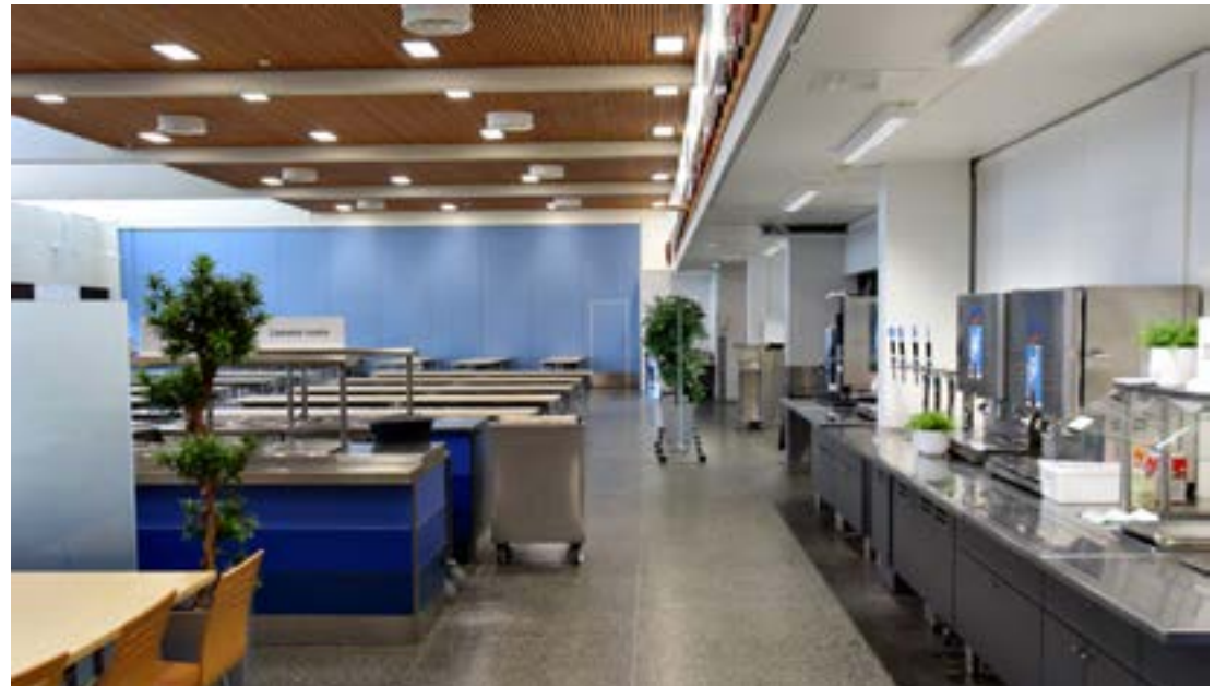
1990-luvun alun peruskorjauksessa keskusrakennuksen ilmastointia lisättiin. Ruokasalissa ilmastoinnin putket koteloiitiin keittiön seinälle. Kuvassa näkyvät loisteputkivalaisimet ovat siinä kohdassa, josta kotelo alkaa. Rimoitettuun kattoon lisättiin tällöin ilmanvaihtoventtiilit.
