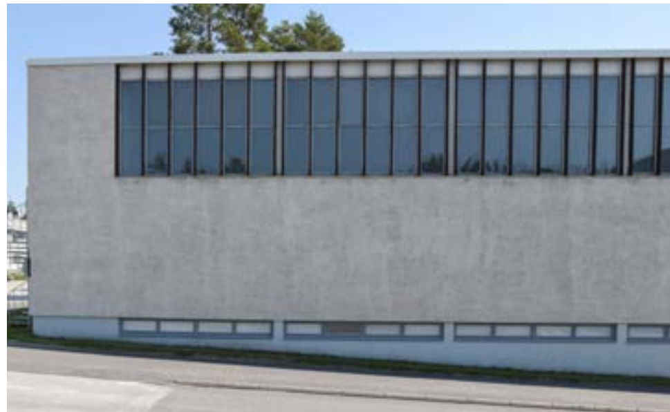
Yläikkunat antavat miellyttävää epäsuoraa valoa tiloihin. Betonipintojen lautamuottipinnat tuovat vaikuttavaa materiaalituntua. Korkeat kattopalkistot olivat tyypillistä Osmo Lapon luomaa arkkitehtuuria.
