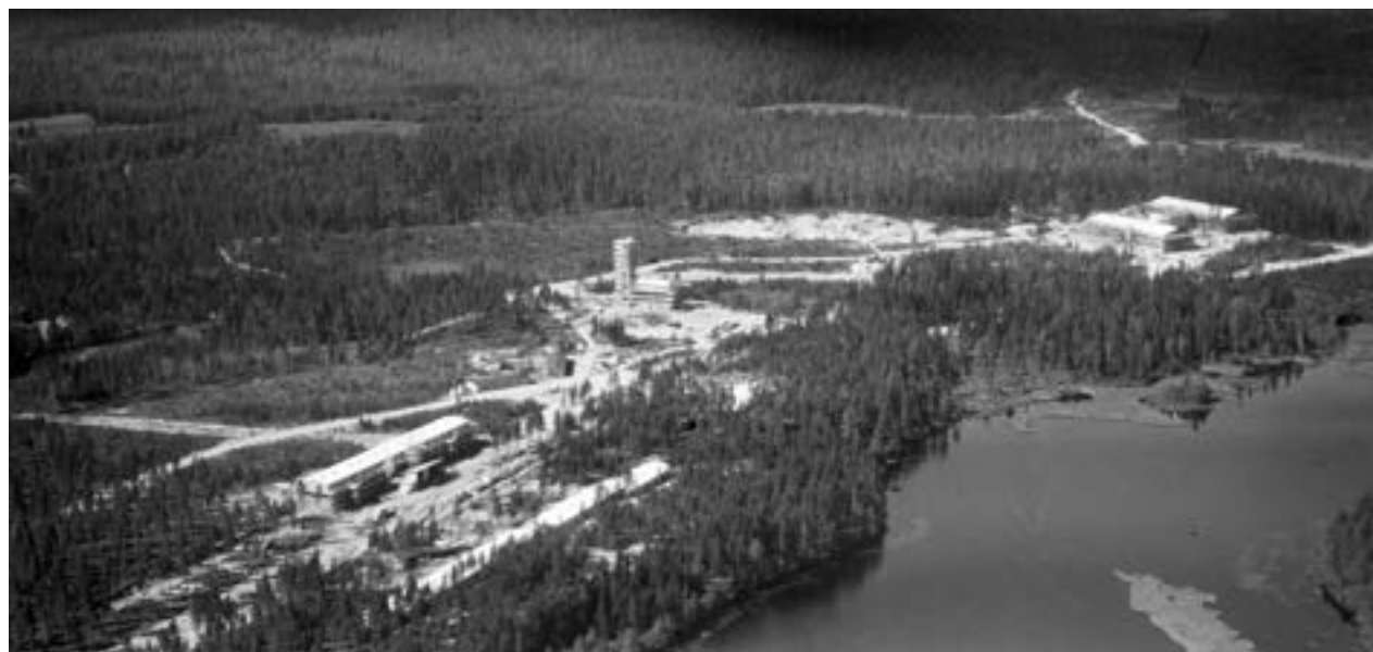
Ilmakuva Luonetjärven länsirannalta elokuussa 1960. Alueella oli rakenteilla ainakin lämpökeskus, kaksi kasarmirakennusta ja asuinrakennuksia. Keskusrakennuksen rakentamista ei ole vielä aloitettu. Suomen Ilmavoimamuseo.
