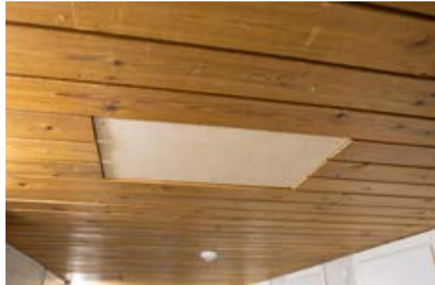
Kellarin käytävän ja pääsisäänkäyntien alakatot ovat höylätystä laudasta tehtyjä.
