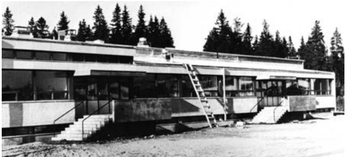
Vuonna 1964 otetussa ilmakuvassa (yllä) näkyy valkoinen rakennusmassa alkuperäisessä tilassaan. Pääsisäänkäyntejä kattoivat alun perin pienet betonilipat. Sisäänkäyntitasot ja portaat oli maasta irrallaan. Kuvat: Suomen Ilmavoimamuseo.
