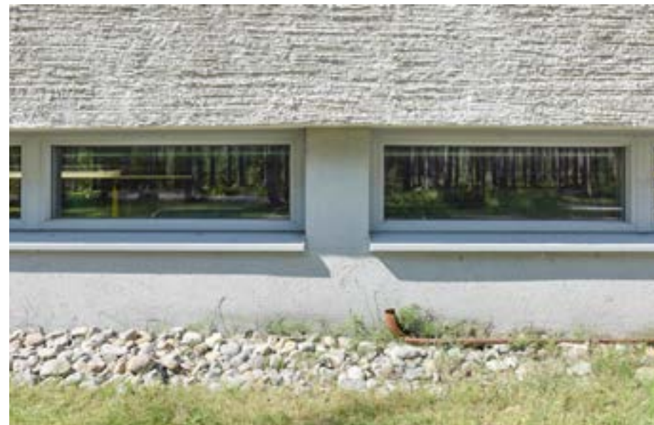
Ikkunat olivat sisäänaukeavia 2-puitteisia ja 2-lasisia puuikkunoita. PKA.
