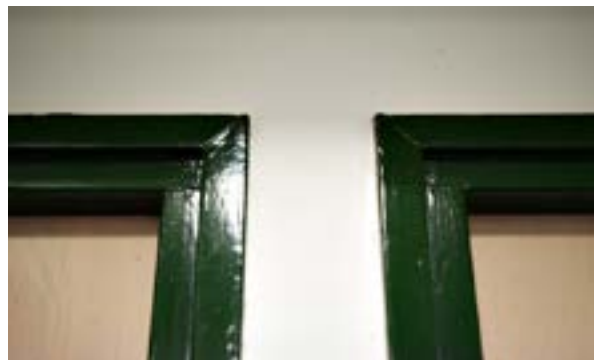
Kaiteet on toteutettu yksikertaisina ja minimalistisina tukeutuen rakennuksen kokonaisarkkitehtuuriin. Tummanvihreä väri toistuu kaiteissa ja ovien pielilaudoissa.
