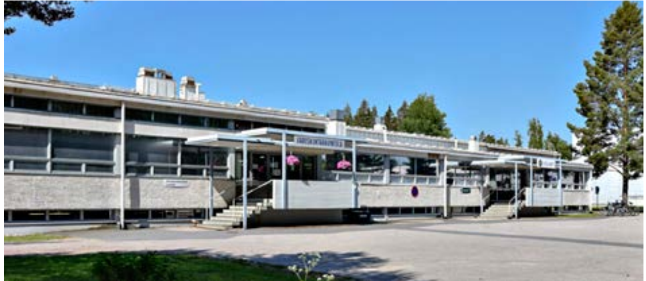
Huoltorakennus kuvattuna itäjulkisivultaan kesäkuussa 2022.
