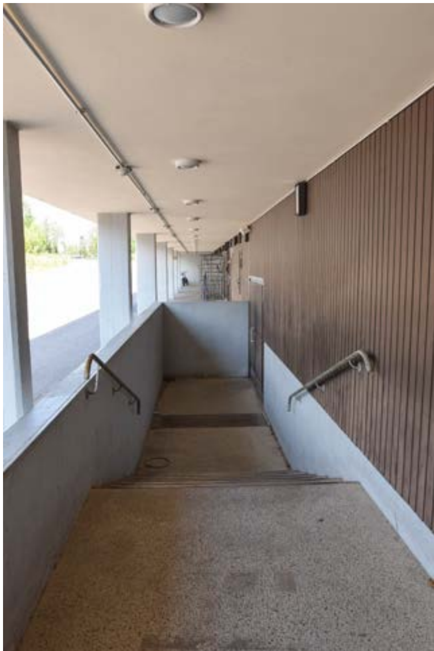
Betonisissa porrasaskelmissa ja kaiteessa on kulmarautavahvikkeet. Teräskäsijohteissa on kaarevia muotoja.
