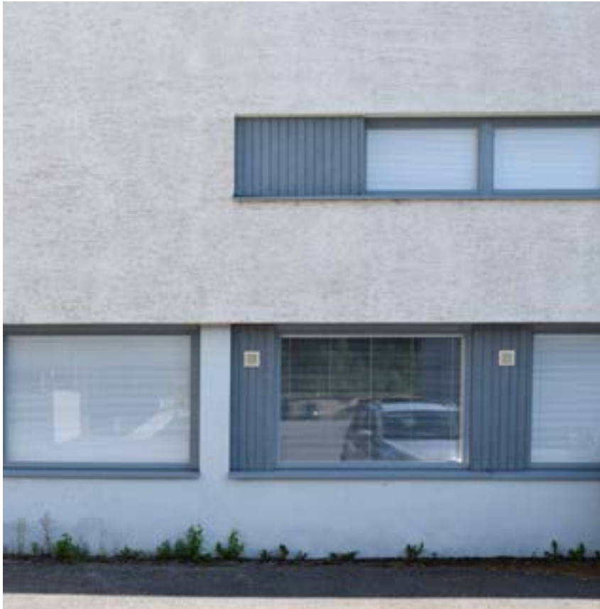
Ikkunat olivat sisäänaukeavia 2-puitteisia ja 2-lasisia puuikkunoita. PKA.
