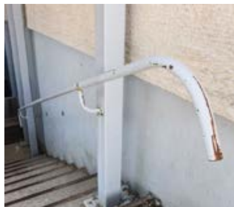
Betonisissa porrasaskelmissa ja kaiteessa on kulmarautavahvikkeet. Teräskäsijohteissa on kaarevia muotoja.
