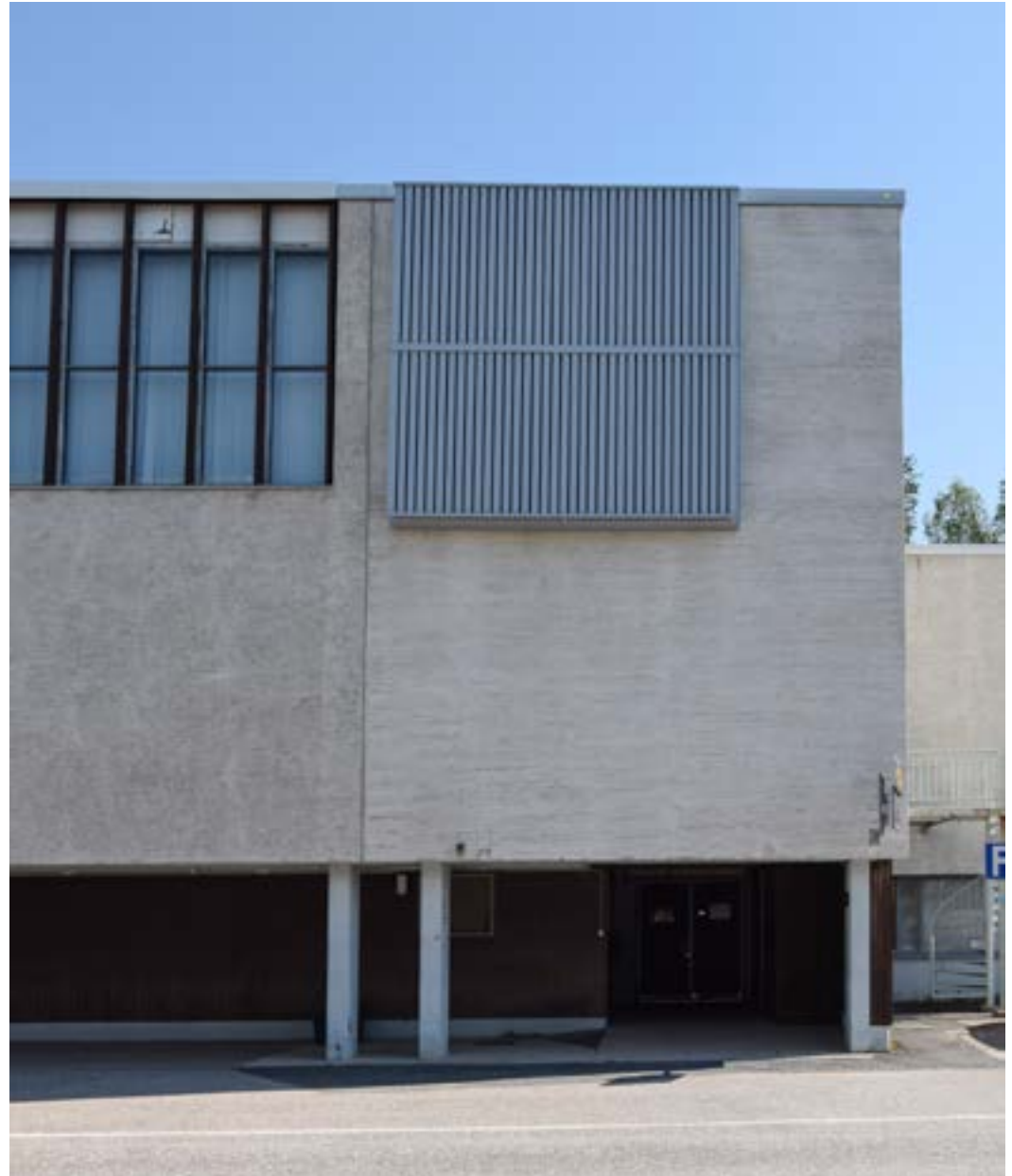
1990-luvun alun peruskorjauksessa lisätty ilmastoinnin konehuone sijoitettiin rakennuksen korkeimman päämassan jatkeeksi.
