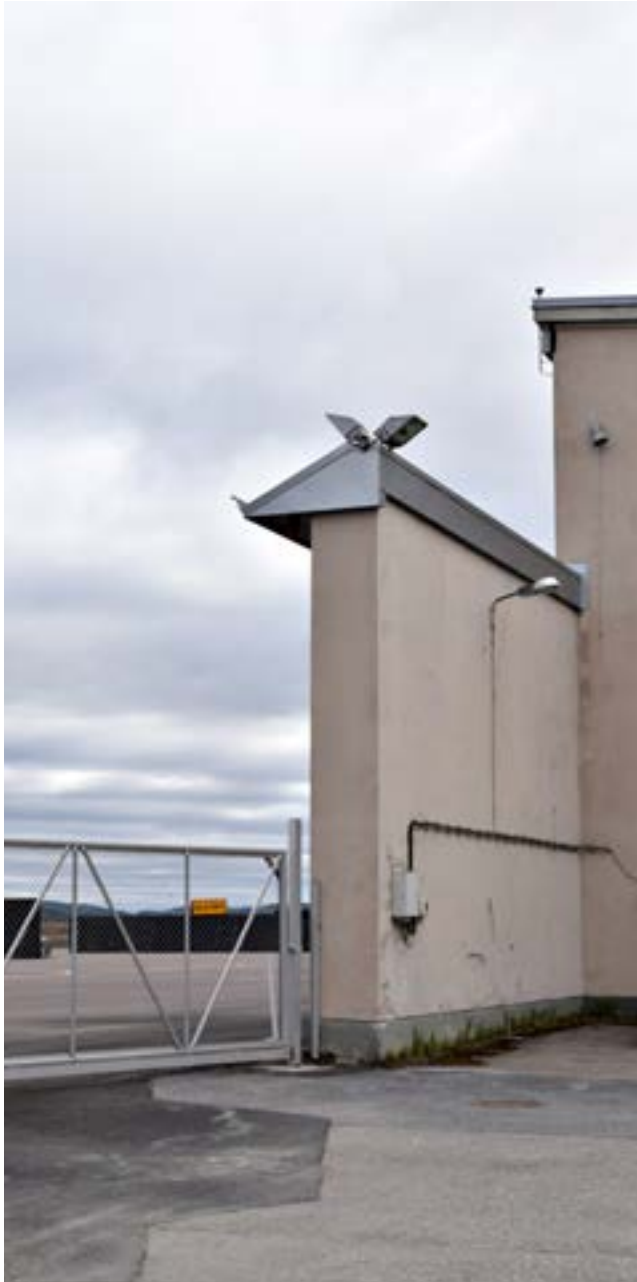
Lentokonehallin pohjoispääty on suurilta osin alkuperäinen. Oven yläpuolella oleva katos on lisätty 1980-luvun ja 2000-luvun alun välisenä aikana. Päädyssä on myös laatta, jossa kerrotaan, että ”Helikopteritoiminta Suomessa alkoi täällä 1953”.
