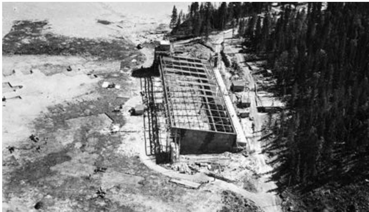
2-hallin rakennustyömaa kesäkuun 20. päivä vuonna 1939. Suomen ilmavoimamuseo.
