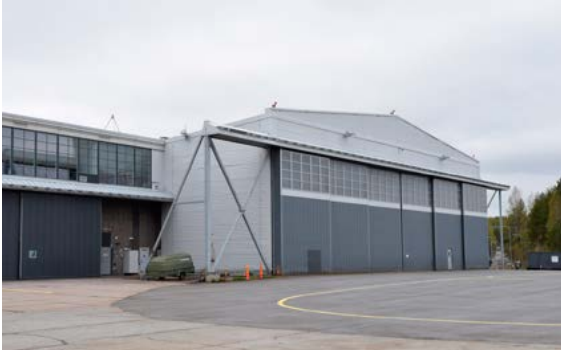
1990-luvun taitteessa valmistuneen laajennuksen katolla on harjapääty. Toisin kuin alkuperäisenä säilyneessä osassa, hallin ikkunat on sijoitettu liukuovien yläosaan.
