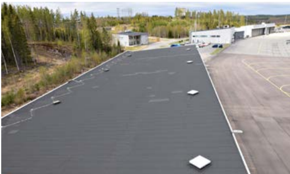
2-hallin katto lennonjohtotornista nähtynä. Kermikate on uusittu vuonna 2000.
