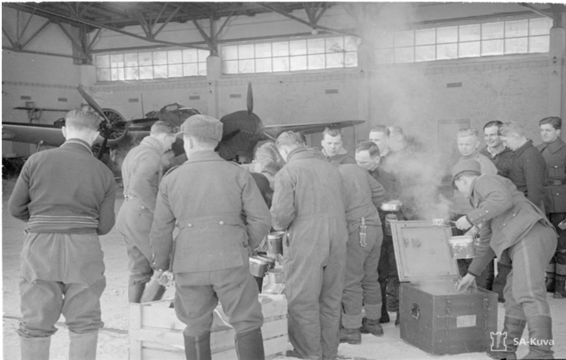
Ruokailua lentokonehallissa maaliskuussa 1940. Pintavetoina tehdyt sähköjohdot näkyvät ikkunoiden alla ja päätyseinällä. Sähkövetojen alapuolella on matalan osan katon tuuletussäleiköt. SA-kuva.
