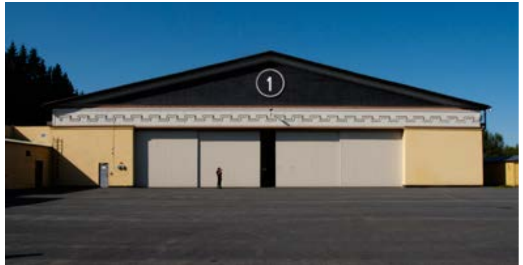
Kauhavan lentosotakoululle vuonna 1928 valmistunut lentokonehalli kuuluu vanhan mallisiin harjakattoisiin lentokonehalleihin, joiden kattorakenteet tehtiin puusta. Kuva: Hannu Puurunen.
