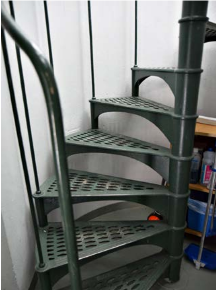
Ylimpään kerrokseen pääsee rautaista kierreporrasta pitkin. Porras lienee alkuperäinen 1960-luvun alusta. Tilassa on tällä hetkellä kuntosalilaitteita.
