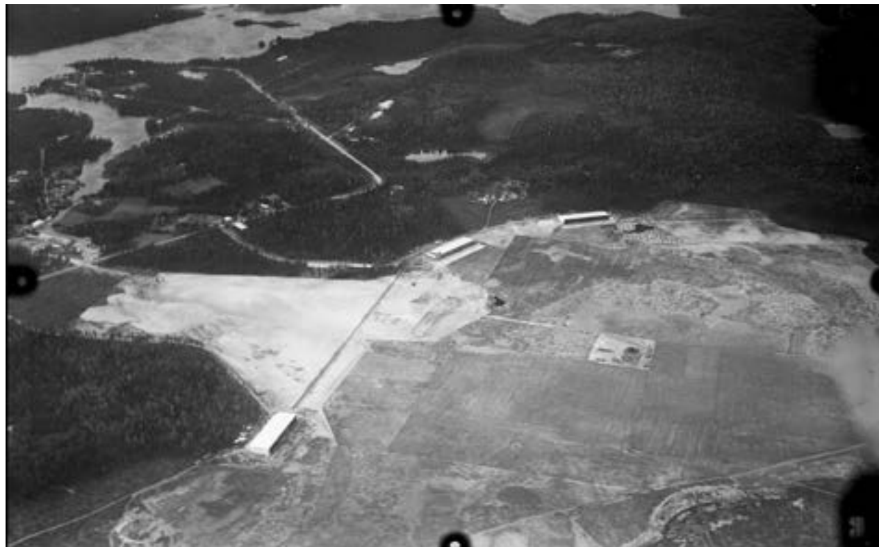
Syyskuun 20. päivä vuonna 1939 otettu kuva rakenteilla olevista Lentoesama 6:n kentästä ja lentokonehalleista. Suomen Ilmavoimamuseo.
