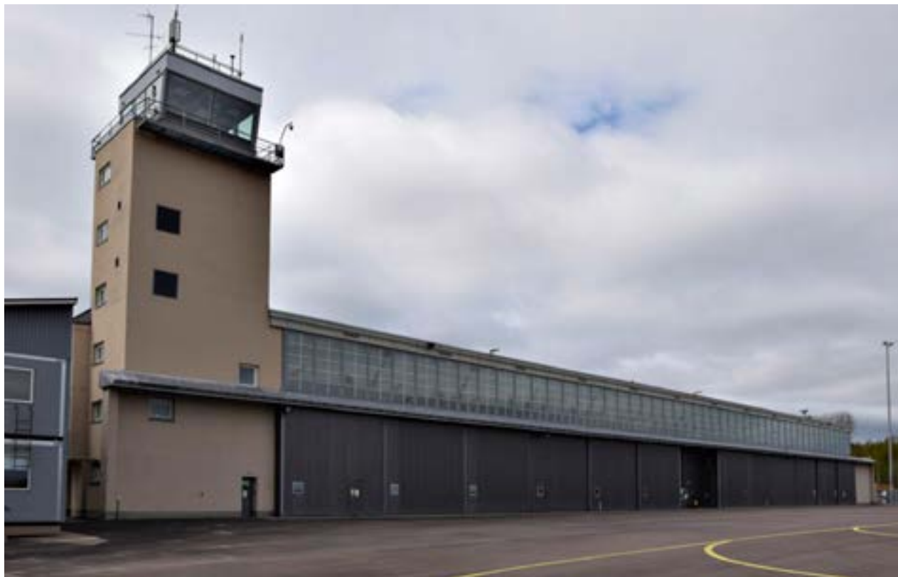
2-hallin ikkunat on uusittu 2000-luvulla.
