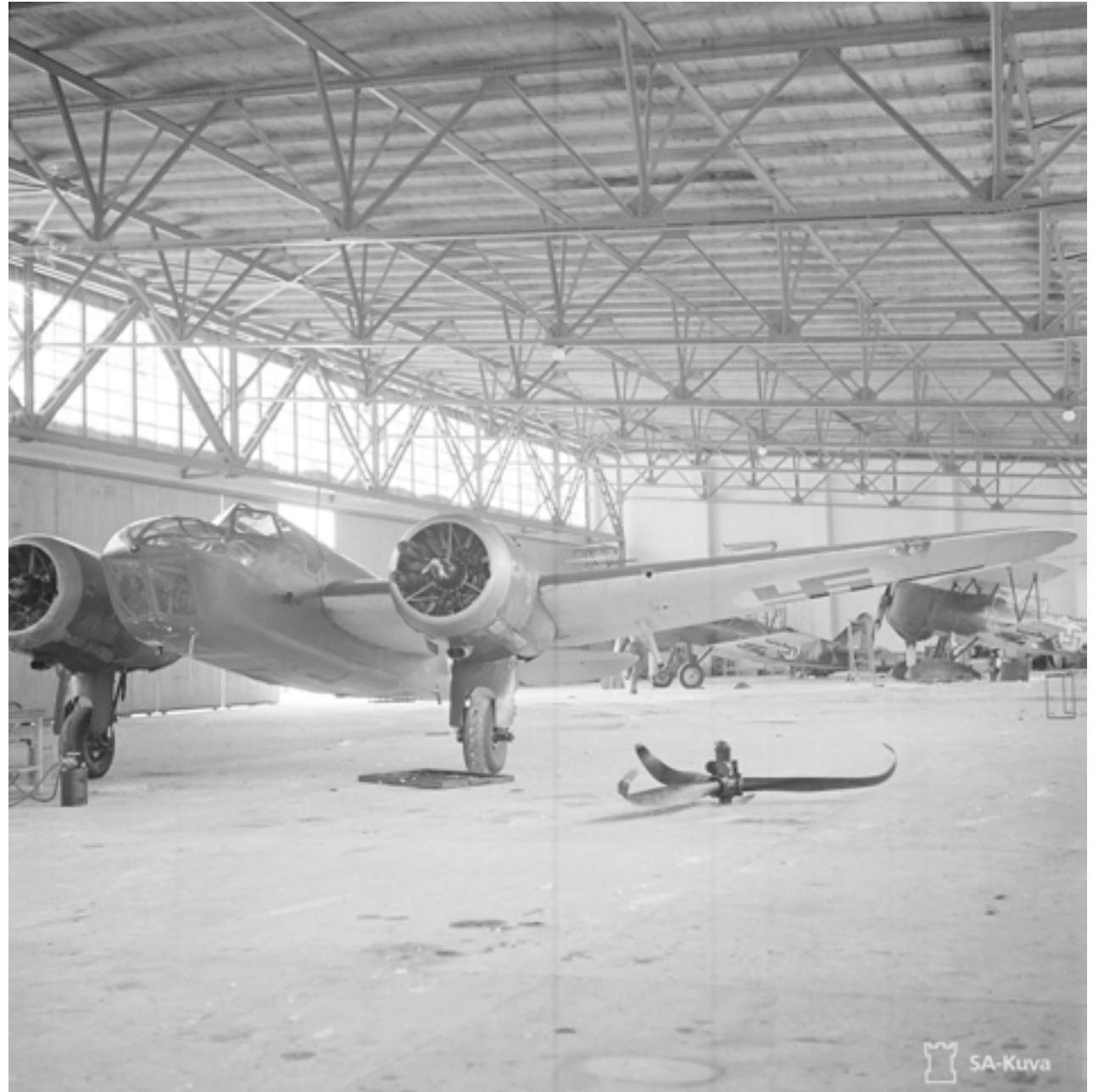
Lattian valupinnassa erottuu selvästi ruutujako. SA-kuva.
