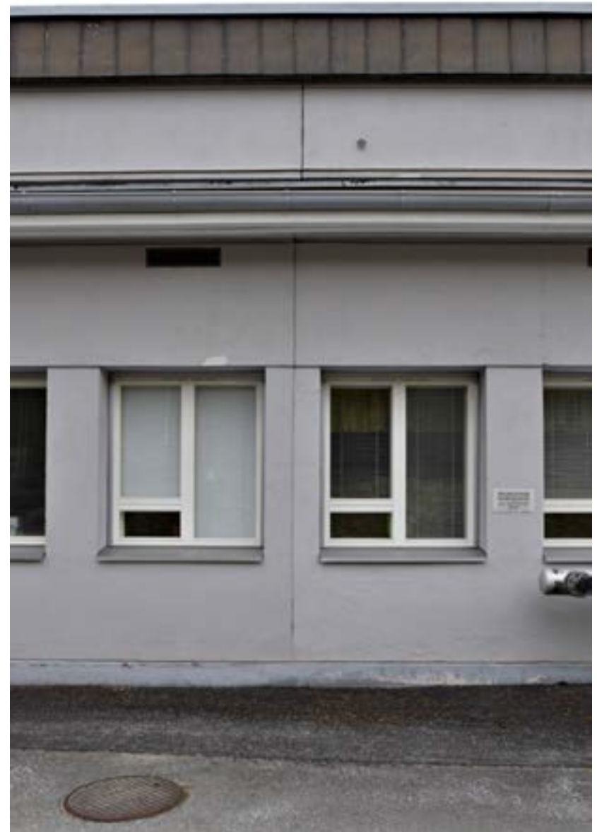
Matalan toimisto-osan huoneiden ikkunat on uusittu ilmeisesti vuosien 1996-97 peruskorjauksessa. Ikkunat tehtiin vanhan mallin mukaisiksi. Matalan osan katolle on lisätty katon tuuletuksen vuoksi hormit.
