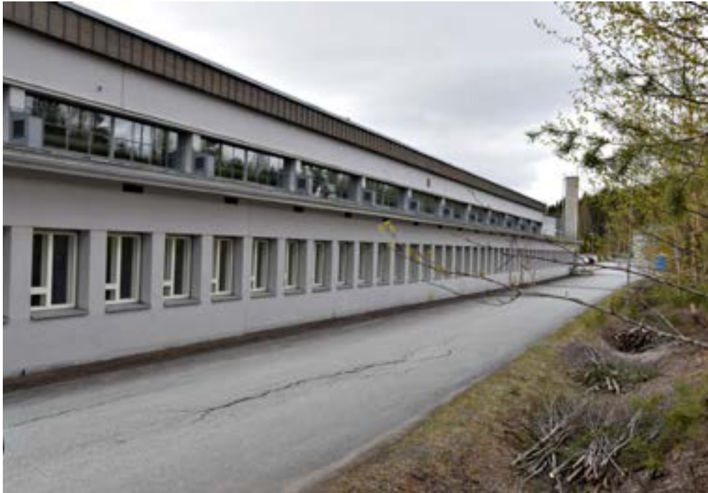
Matalan toimisto-osan huoneiden ikkunat on uusittu ilmeisesti vuosien 1996-97 peruskorjauksessa. Ikkunat tehtiin vanhan mallin mukaisiksi. Matalan osan katolle on lisätty katon tuuletuksen vuoksi hormit.
