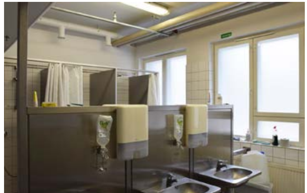
Matalan osan huoneiden nimet on lisätty vuosien 1996-97 peruskorjauksessa. Pukuhuoneen kuvassa näkyvä alakatto on lisätty myöhemmin ilmanvaihtoputkien ja sähkövetojen kotelointiseksi.
