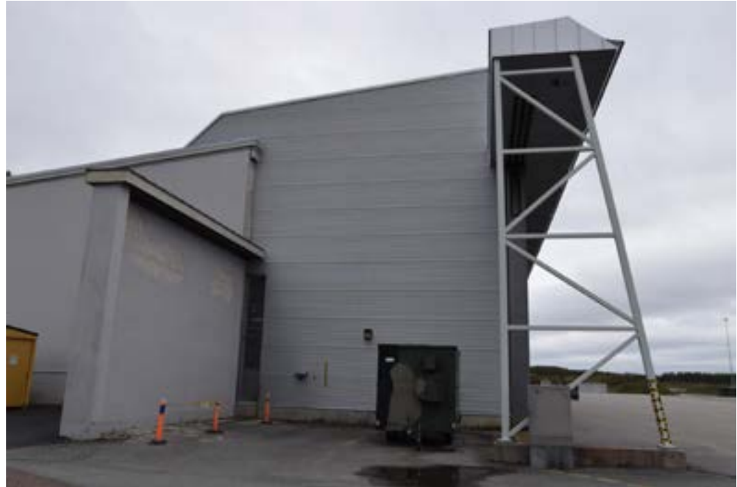
Alkuperäiset liukuovien tukiseinät on säilytetty, vaikka ne jäivät laajennuksen myötä tarpeettomiksi. Laajennusosan liukuovien tukirakenne on teräksinen.
