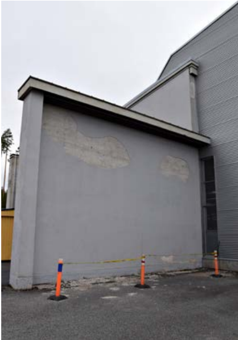
Alkuperäiset liukuovien tukiseinät on säilytetty, vaikka ne jäivät laajennuksen myötä tarpeettomiksi. Laajennusosan liukuovien tukirakenne on teräksinen.
