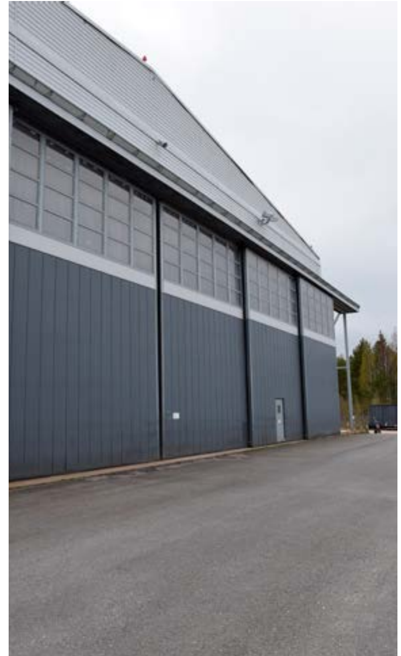
1990-luvun taitteessa valmistuneen laajennuksen katolla on harjapääty. Toisin kuin alkuperäisenä säilyneessä osassa, hallin ikkunat on sijoitettu liukuovien yläosaan.
