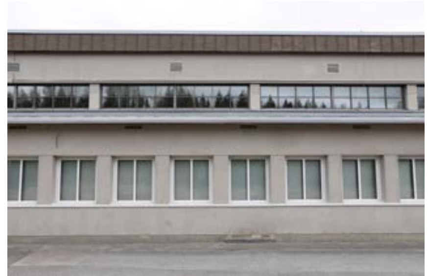
Matalan osan toimistohuoneiden ikkunat on uusittu mahdollisesti vuonna 2014. Osan yläpuolella näkyvät halliin avautuvat ikkunat on uusittu todennäköisesti samaan aikaan kuin 1- ja 2-hallien vastaavat ikkunat eli 2005-2006.
