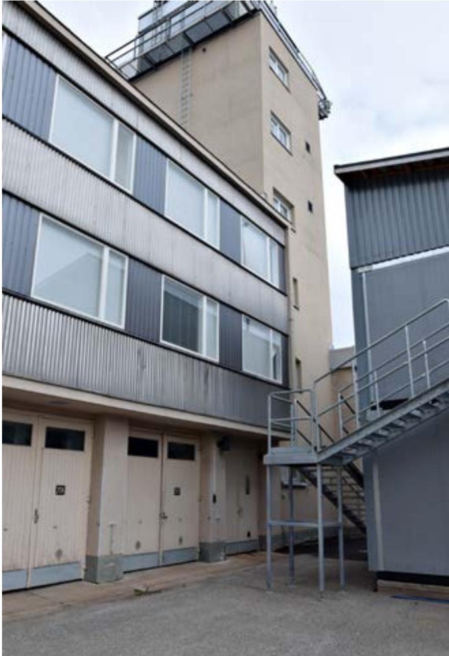
Todennäköisesti tallien ovet on kokonaan uusittu 1960-luvun lisäosan korotuksen yhteydessä. Alun perin ovissa oli vaakapanelointi ja ikkunat olivat pykälää alempana.
