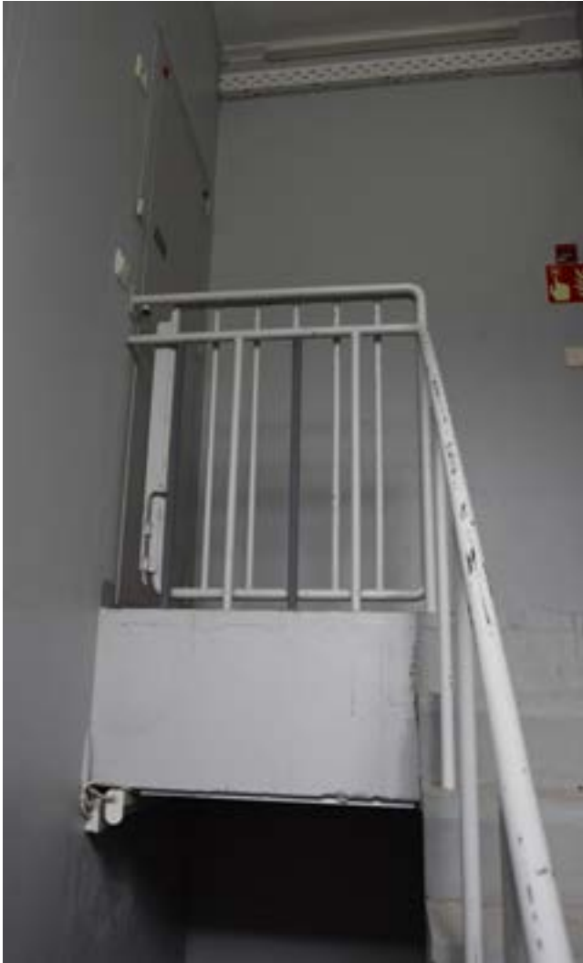
Kellarin porrashuoneessa on alkuperäisiä rakennusosia jäljellä, esimerkiksi porrasaskelmat, käsijohde ja komeron ovi.
