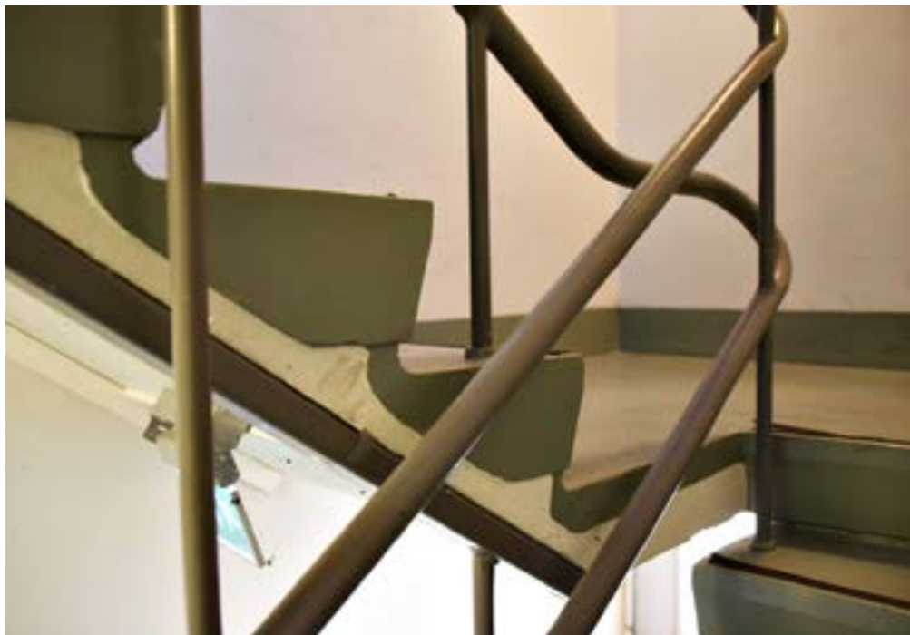
Porrasaskelman sivuprofiilin muotoilu on erityinen.
