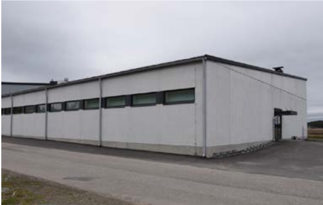
Laajennusosa on elementtirakenteinen ja julkisivupinnat ovat kuviobetonia.
