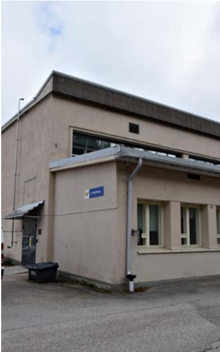
Toimistohuoneiden ikkunat on uusittu vuonna 2015. Toimisto-osan yläpuolella kulkeva lentokonehalliin avautuva nauhaikkuna on uusittu vuonna 2005 vanhan mallin mukaisesti.
