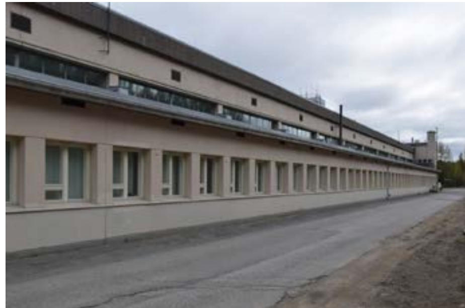
Toimistohuoneiden ikkunat on uusittu vuonna 2015. Toimisto-osan yläpuolella kulkeva lentokonehalliin avautuva nauhaikkuna on uusittu vuonna 2005 vanhan mallin mukaisesti.
