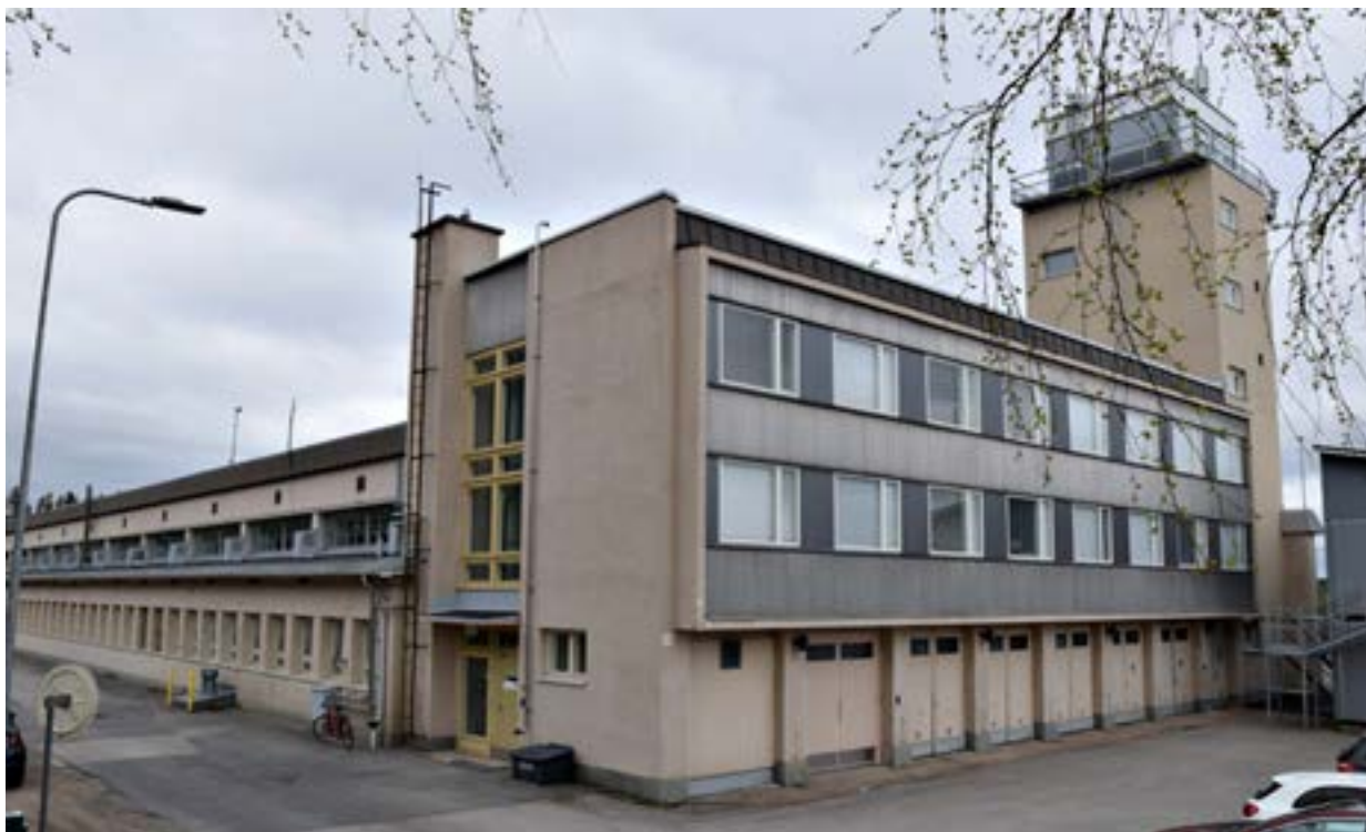
2-hallin eteläpääty on pitkälti siinä asussa, jonka se sai 1960-luvun laajennuksessa.
