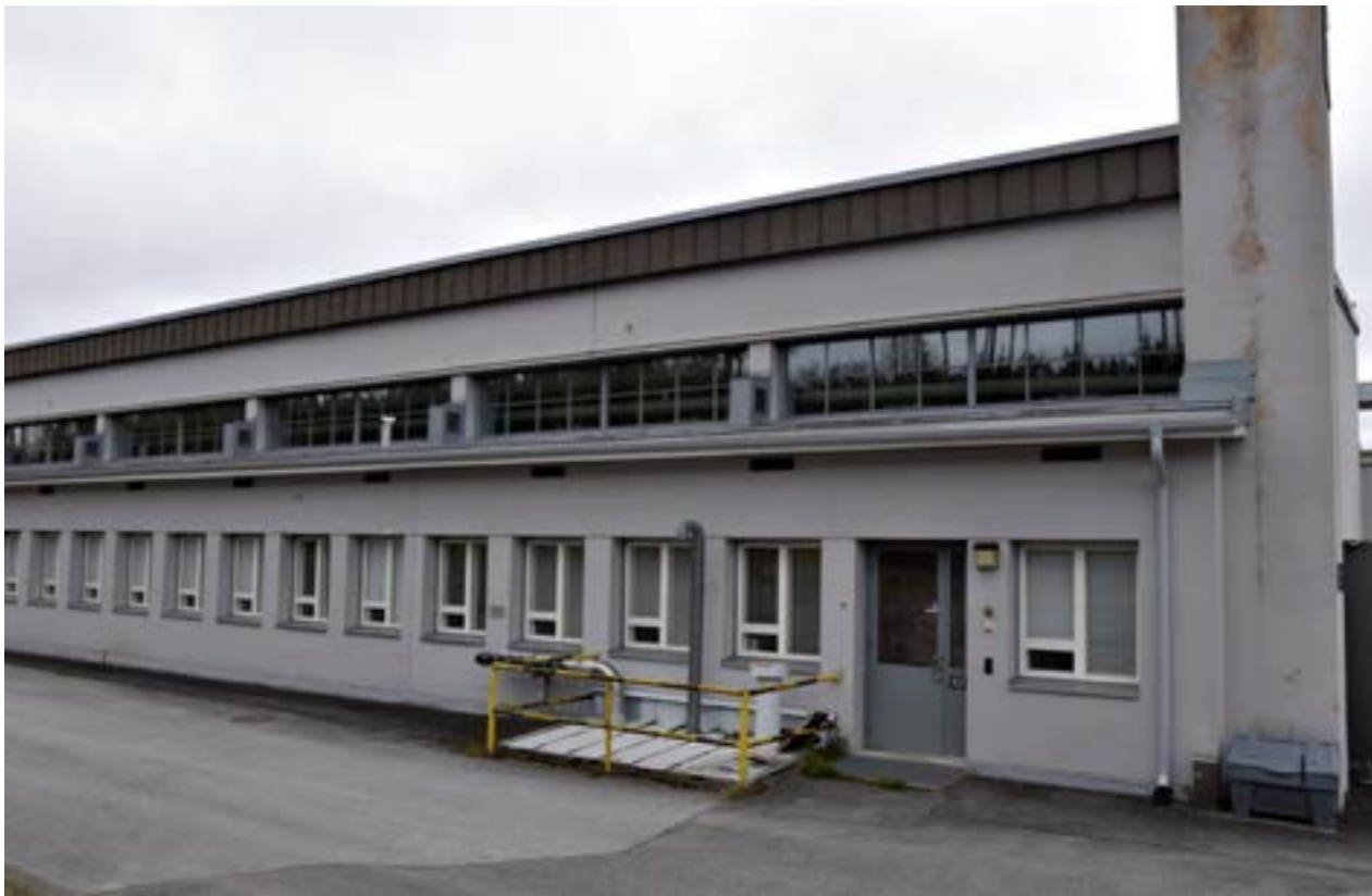
Lentokonehalliin avautuvat ikkunat uusittiin vanhan mallin mukaan vuonna 2005. Toimisto-osan eteläpään huoneeseen lisättiin ulko-ovi 1996-97 peruskorjauksessa. Alkuperäinen piippu on vielä olemassa.
