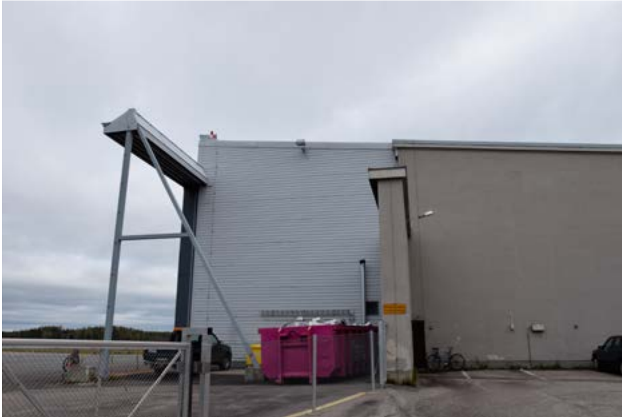
Alkuperäisten liukuovien tukirakenne hallin luoteispäädyssä on säilytetty, vaikka se on jäänyt laajennuosan myötä tarpeettomaksi.
