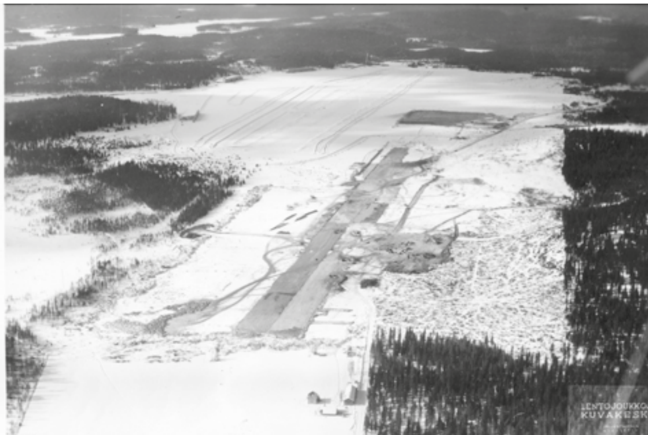
Ilmakuva vuodelta 1955. Kuvassa näkyy uuden kiitotien rakennustyömaa. Kuva: Suomen Ilmavoimamuseo.
