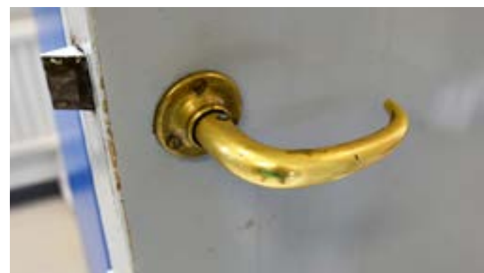
Pukinsarvipainike yleistyi 1950–60-luvuilla. Painike voi kuitenkin olla alkuperäinen, niin kuin myös ovi.
