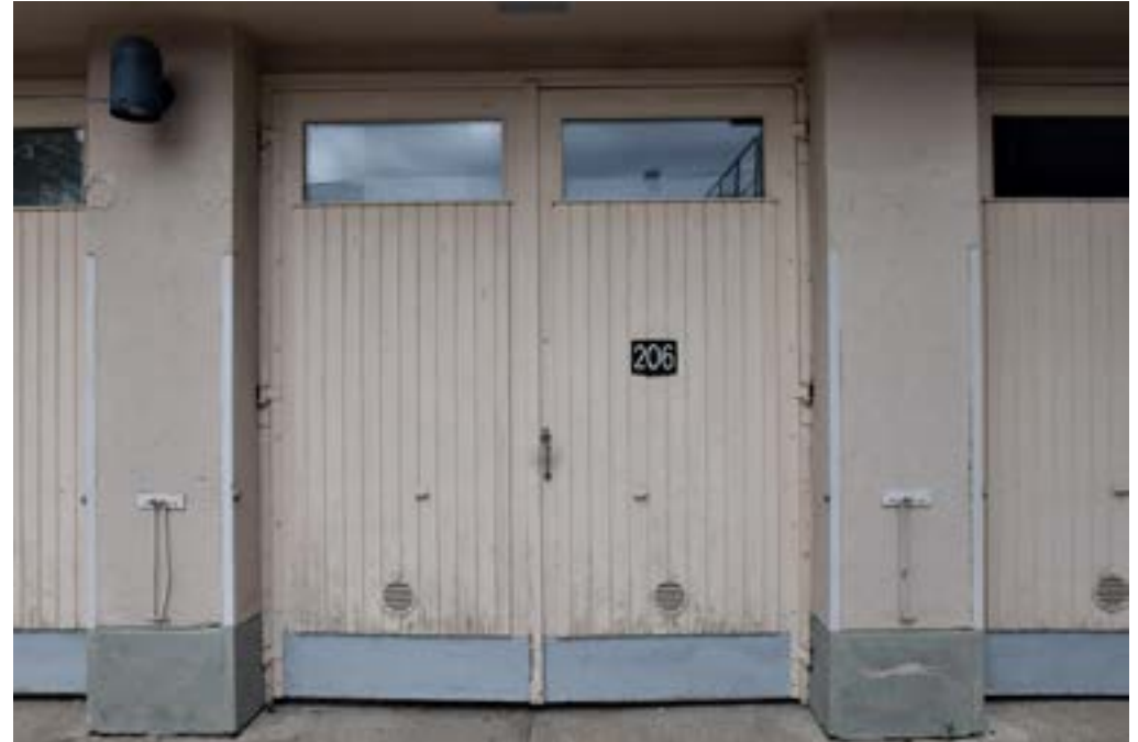
Todennäköisesti tallien ovet on kokonaan uusittu 1960-luvun lisäosan korotuksen yhteydessä. Alun perin ovissa oli vaakapanelointi ja ikkunat olivat pykälää alempana.
