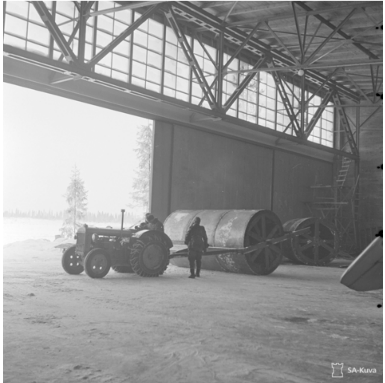
Maaliskuussa 1940 lähdössä lumijyrällä tasoittamaan kenttää. Alun perin eritämättömänä olleessa lentokonehallissa oli katon kantava rakenne näkyvissä. SA-kuva.
