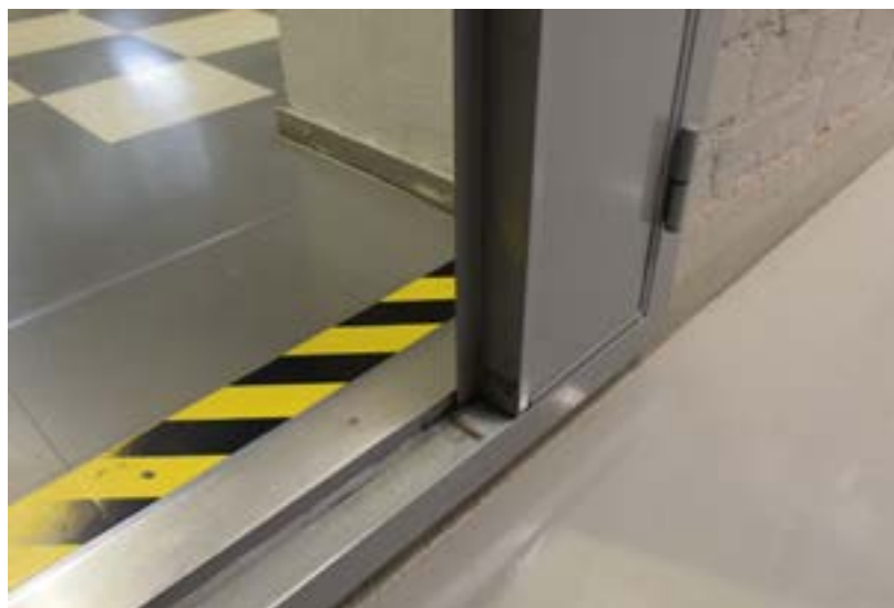
Tiiliseinän paksuus on nähtävissä oviaukoissa. Matalan osan huoneissa on alkuperäisiä ikkunapenkkejä. Toimistohuoneiden lattiarakenteet on uusittu ja lämmöneristystä on lisätty. Uusi lattiakorko on hallitilan lattiaa ylempänä.
