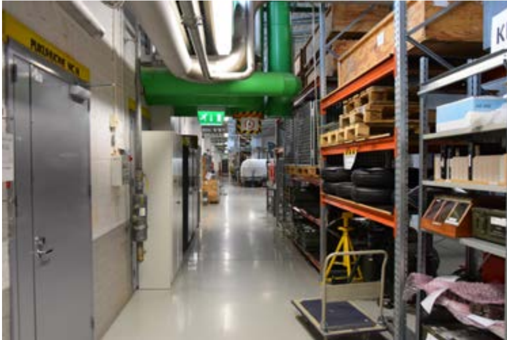
Hallitilan matalaan päähän on rakennettu hyllyjä tavaroiden varastointia varten. Matalassa osassa on myös paljon talotekniikkaa, jota alun perin eristämättömässä lentokonehallissa ei ollut ollenkaan.
