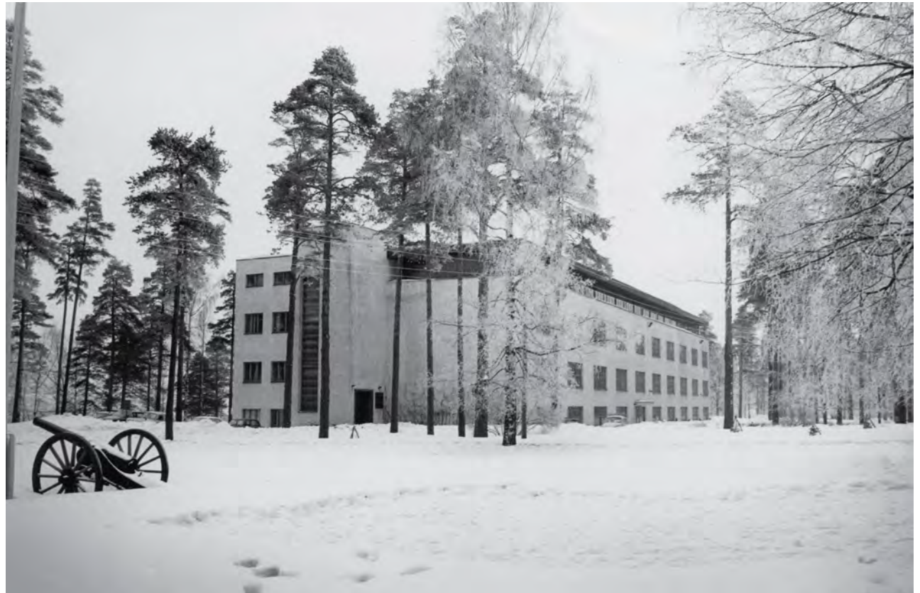
Kasarmi valokuvattuna 1960-luvun asussaan ennen 1980-luvulla lisättyjä porrastornien korotuksia, ilmastointikonehuoneita ja ikkunamuutoksia. SM.
