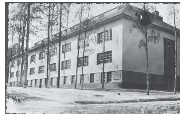
Huuhanmäen kasarmin ulkoasussa on nähtävissä klassisiin viittaavia julkisivuaiheita, kuten pohjakerroksen kasetoitointi. Pohjaratkaisu muistutti Lappeenrannan Vääpeliä. MV.
