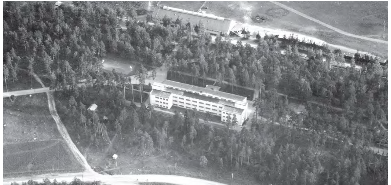
Väapeli-rakennus alkuperäisessä asussaan 1950-luvun ilmakuvasa. SM.
