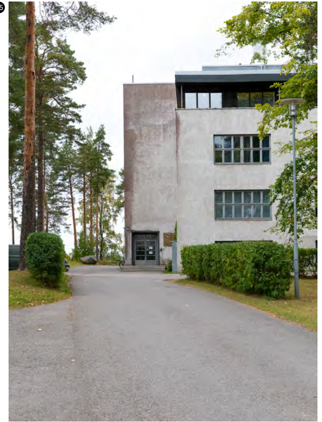
↑ Pääsisäänkäyntejä korostava korkea umpinainen seinäpinta rappauspinta on julkisivuaiheena veistoksellinen.
