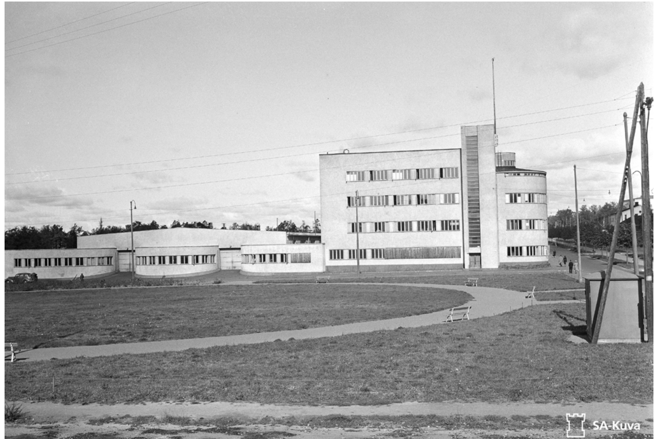
Taivallahden autokasarmi oli sijainniltaan Helsingin keskustan kupeessa poikkeuksellisen näkyvä kasarmirakennus. Myös sen suuri mittakaava ja uudenaikainen autoihin liittyvä toiminta toivat kasarmille mediahuomiota. SA-kuva.
