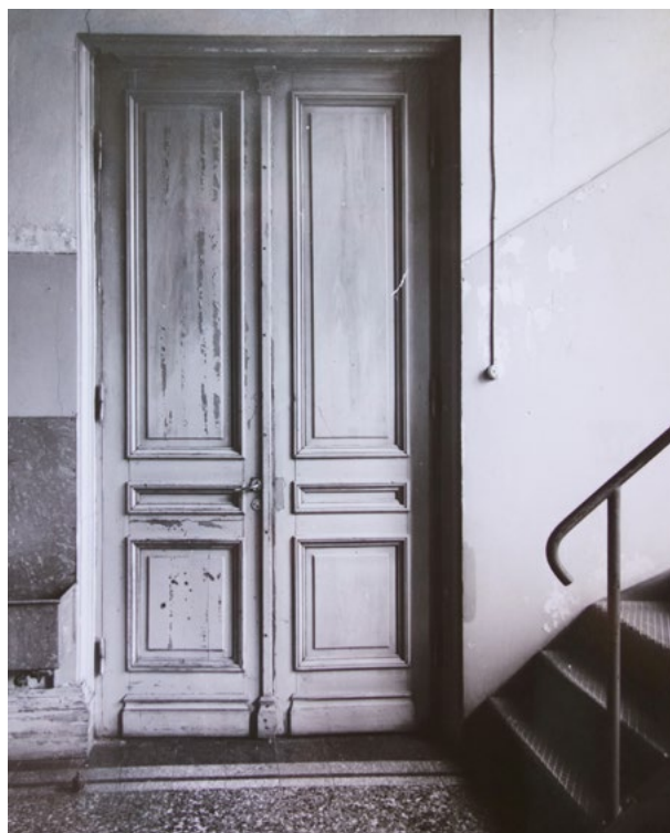
↑↑ 1980-luvulla alkuperäisen oven mukaisena tehty uusi palo-ovi. amoy 2022
