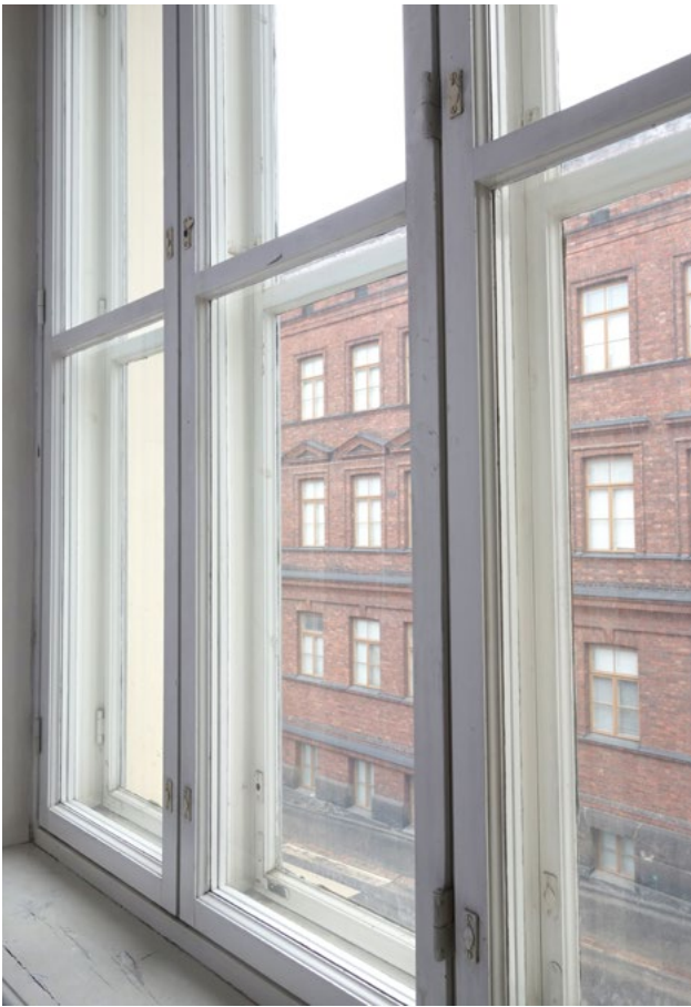
↑ 1980-luvulla uusitut ikkunat on tehty männystä ja peittomaalattu valkeiksi. Detaljointi perustuu alkuperäisiin ikkunoihin, mutta ikkunoiden avautuminen on muutettu sisään-ulos-aukeavista sisään-sisään-aukeaviksi. amoy 2022
