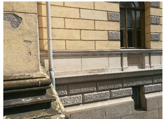
Kuva 34 Julkisivurappauksessa on pieniä vaurioita.
