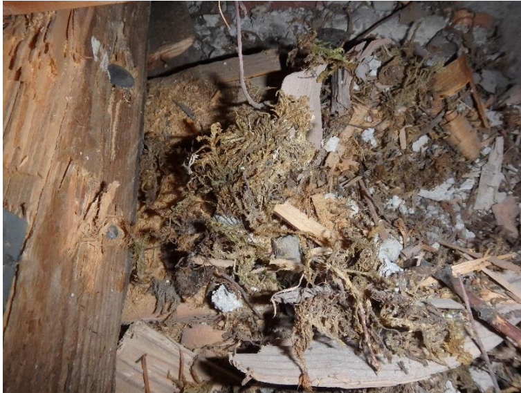
Kuva 29 Välipohjatäytteenä on käytetty monipuolisesti saattavilla olevaa materiaalia (Mehto 2021 b)
