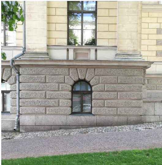
Kuva 39 Uusi esteetön sisäänkäynti on suunnitteilla 0. kerroksen ikkunan kohtaan, jossa maantaso ja lattiantaso ovat lähellä toisiaan.
