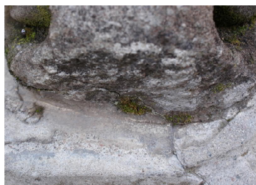
KUVA 8. Veistoksen ER-C1 ja altaan ER-A liitoskohta.
