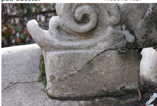
KUVA 6. Halkeama veistoksen IR-C2 jalustassa .
