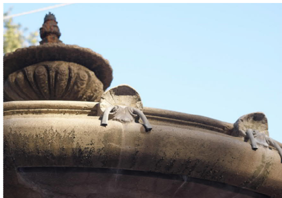
KUVA 1. Yläosan altaan AY reunan koriste.
