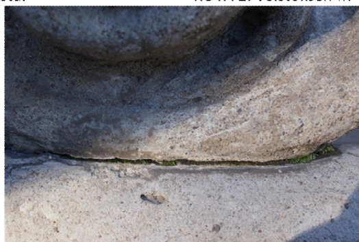
KUVA 4. Veistoksen IR-C2 ja sivualtaan IR-A liitoskohta.
