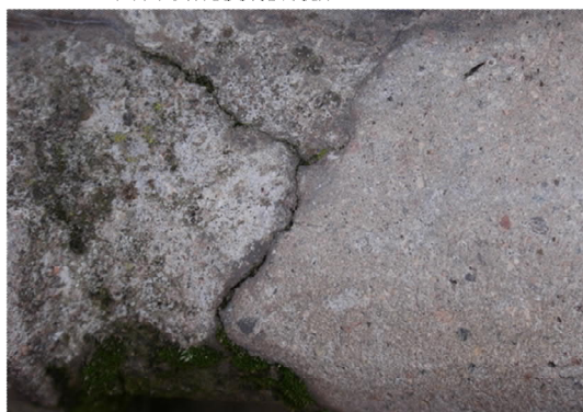
KUVA 6 ja KUVA 7. Veistoksen PR-C2 uuden pään valusauma.
