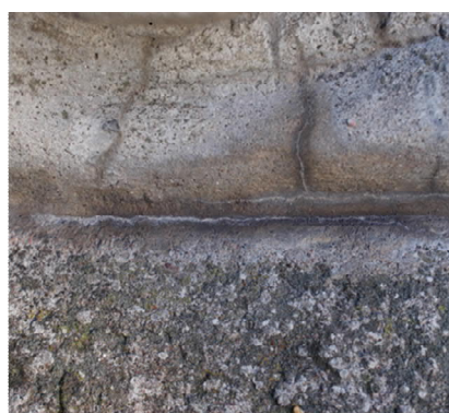
KUVA 7. Veistoksen ER-C2 ja altaan ER-A liitoskohta.
