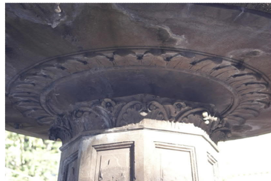
KUVA 2. Valumajäljet yläosan jalassa J.
