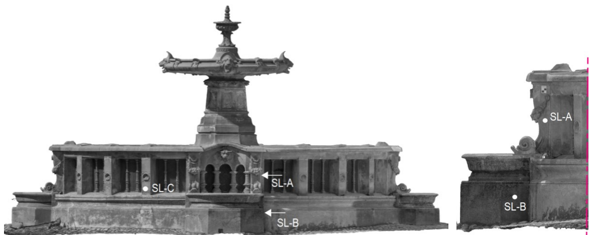
Kuva 40. Säätytalon suihkulähteen näytteenottopaikat. Itäjulkisivuprojektio ja itäpuolisen koristeryhmän oikeanpuolen projektio.
