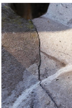
KUVA 6. Veistoksen ER-C2 liitoskohta.
