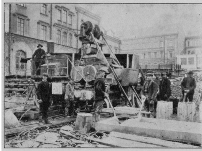
Kuva 13. 1900-luvun alussa uusia teknologioita käytettiin isoilla työmailla. Kuvassa esitetty betonin sekoituskonetta Helsingin päärautatieaseman työmaalla vuonna 1914 (Teknillinen aikakausilehti 1914/5-6, 112).
