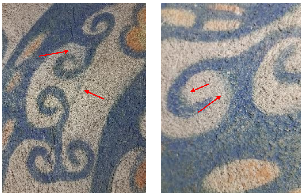
Kuva 54. Alkuperäistä sinistä kulunutta maalia näkyy 70-luvulla maalattujen koristekuvioiden ulkopuolella (Määttä 2022).
