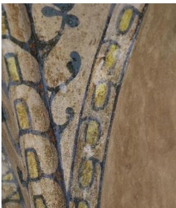
Kuva 63. Paksumpia valkoisia kalkkihärmäkertymiä sekä kalkkihärmää ohuena kerroksena ruoteissa (Määttä 2022)
