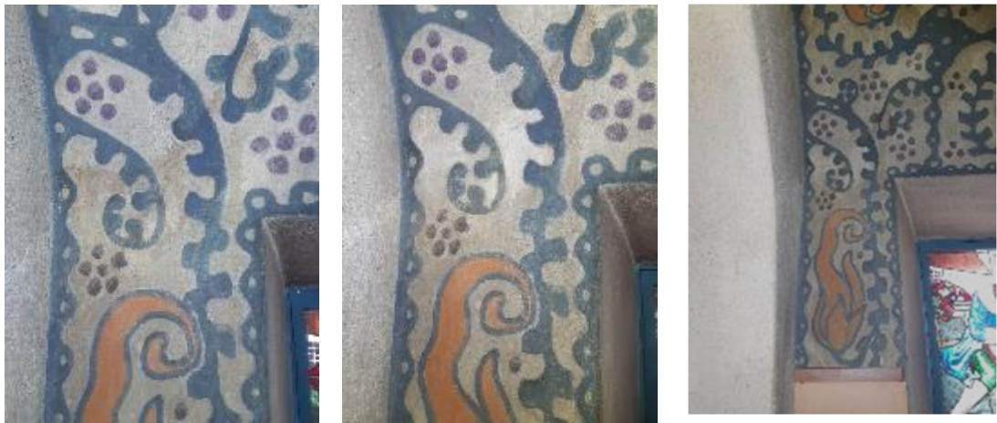
Kuva 73. Halkeaman päällä oleva tummentunut beigenharmaa retusointi liukeni ionivaihdettuun veteen ja paljasti altaan vaalean harmaan rappauspinnan. Kauempaa katsoen puhdistettu alue erottuu vaaleampana puhdistamattomasta ympäristöstä. (Määttä 2022.)
