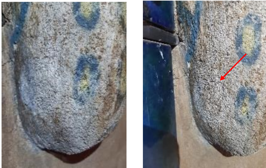
Kuva 72. Nuolen alapuolelle sijoitettu etikkahappohauhe liuotti kalkkihärmää sekä savea pois paljastaen alkuperäistä beigenharmaata maalipintaa (Määttä 2022).
