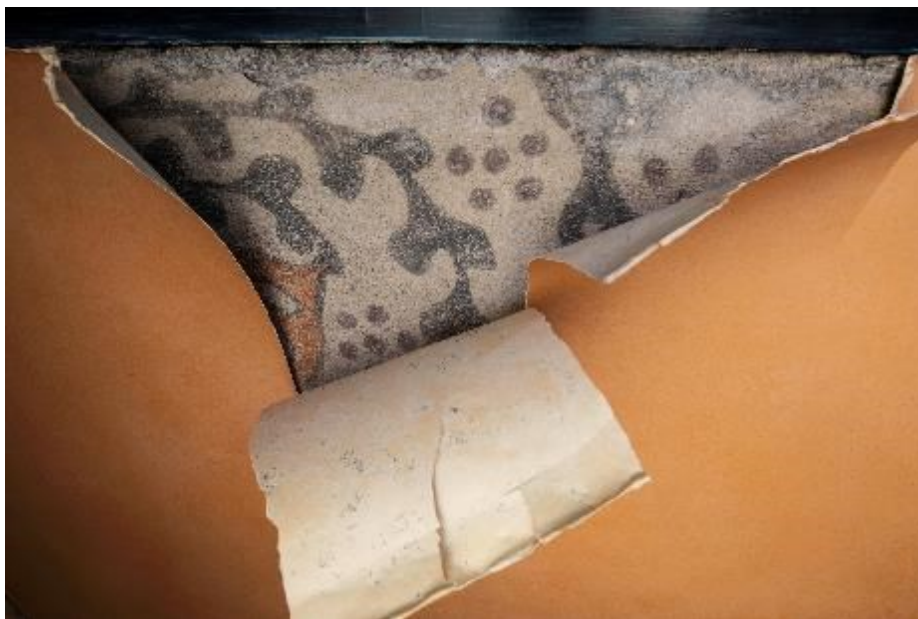
Kuva 53. Repeämästä näkyy, että 70-luvulla pienennetyn ikkunan alapuolelle maalatut koriste- tekuviot ovat tummempia kuin muualla olevat 70-luvun siniset värisävyt (de la Chapelle 2022).
