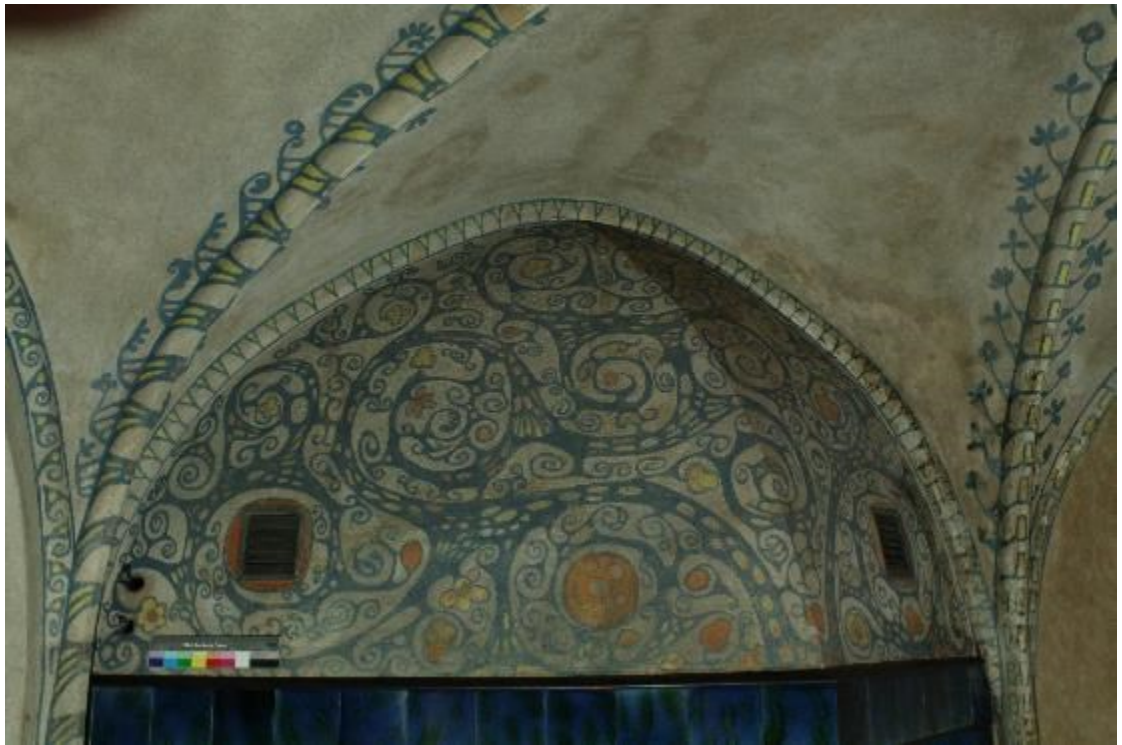
Kuva 35. Takan kuvun ja ruoteiden koristekuvioita 70-luvun restaurointimaalauksen jälkeen (Määttä 2022)
