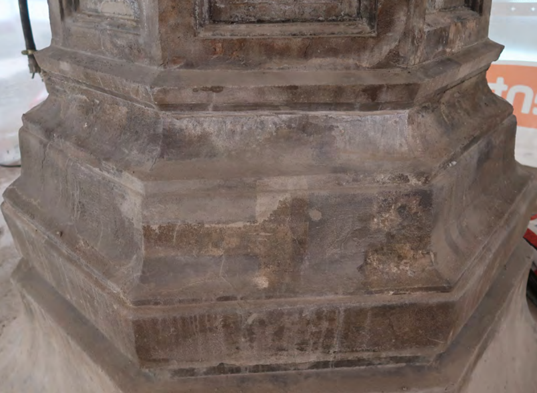
Yllä keskipylvään jalustan puhdistamisen ja paikkakorjauksen koalueita. Korjaustyön aikana kuivuvan rakenteen pintaan nousi monessa vaiheessa valkoista härmettä, joka oli lähinnä suolakiteitä. Kalkkisuotumaa poistettiin laajalti. Kuvat Okulus, KW.
