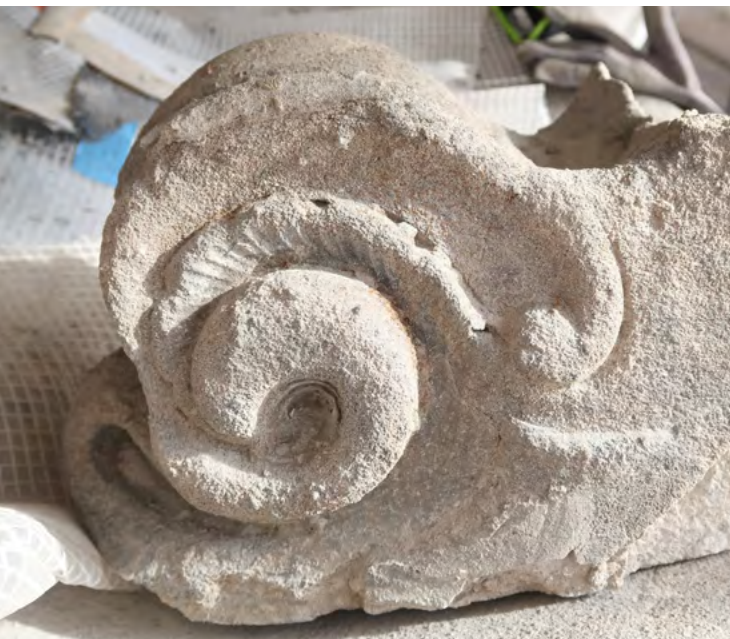
Yllä keskipylvään jalustan puhdistamisen ja paikkakorjauksen koalueita. Korjaustyön aikana kuivuvan rakenteen pintaan nousi monessa vaiheessa valkoista härmettä, joka oli lähinnä suolakiteitä. Kalkkisuotumaa poistettiin laajalti. Kuvat Okulus, KW.
