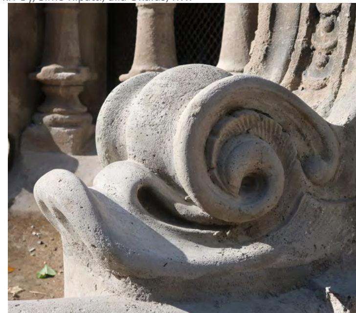
Kaikista koristeaiheita tehtiin muototutkielma, jotta säälellä alttiina oleva alkuperäinen muoto säilyisi mahdollisimman hyvin. Yllä yläleijonan karkea kipsivalos ja sen täydennetty rekonstruktio. Alla delfiinin pään alkuperäinen betonikappale, keskellä täydennetty kipsivalos ja oikealla uusi paikalleen sijoitettu betonivalos.
