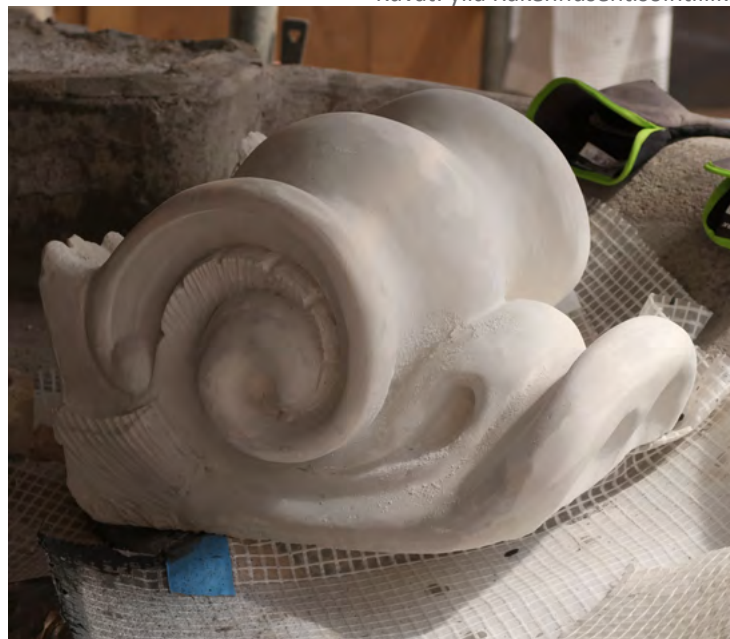
Yllä keskipylvään jalustan puhdistamisen ja paikkakorjauksen koalueita. Korjaustyön aikana kuivuvan rakenteen pintaan nousi monessa vaiheessa valkoista härmettä, joka oli lähinnä suolakiteitä. Kalkkisuotumaa poistettiin laajalti. Kuvat Okulus, KW.
