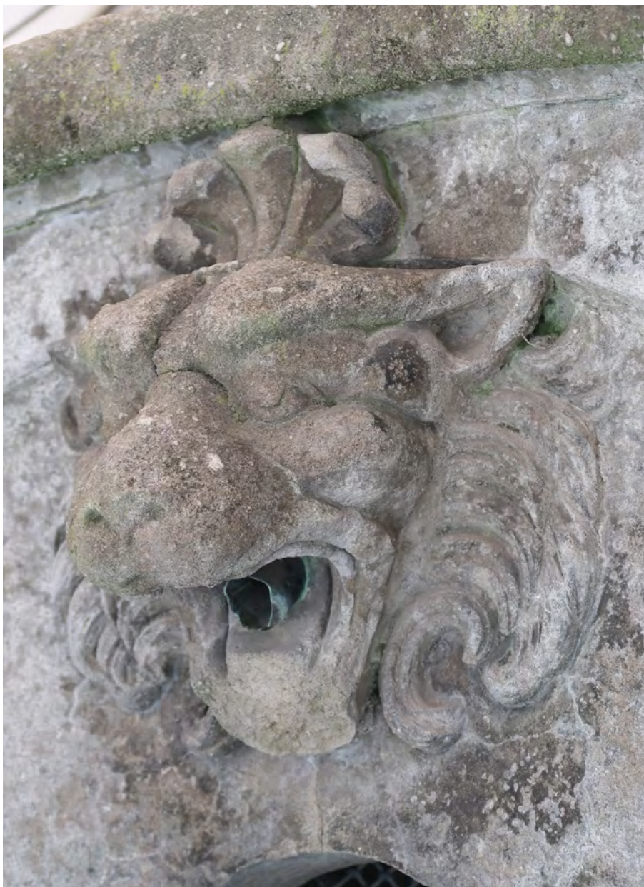
Alkuperäinen leijonanpäävalos. Virtaavan veden ja pakkasen yhteistyönä kaikki suuret leijonat olivat menettäneet alaleukansa. Kuva ennen vuonna 2020 käynnistyneitä korjaustöitä. Kuva Okulus, KW.
