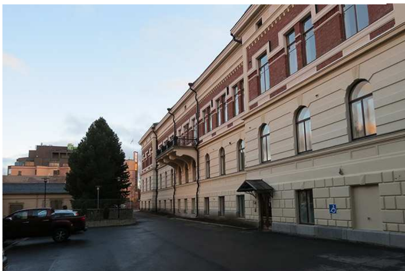
Kuva 126. Päärakennuksen pihajulkisivu 2013 julkisivukunnostuksen jälkeen.
