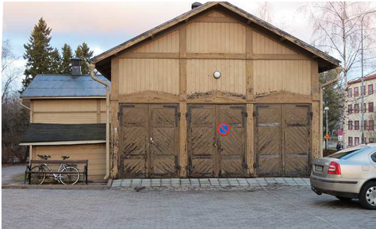
Kuva 190. Piharakennus, julkisivu Linnankadulle.
