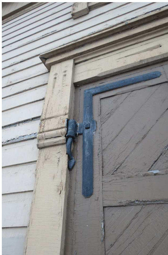
Kuva 192. Piharakennus, julkisivudetalji Oven alkuperäistä detaljointia.
