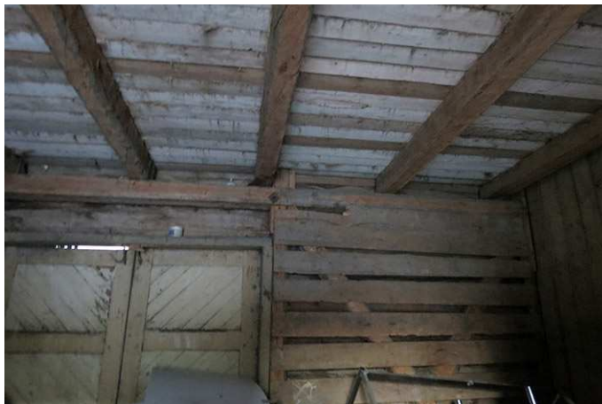
Kuva 195. Ulkoseinien vinoristikkoinen runkorakenne näkyy harvan laudoituksen takana.
