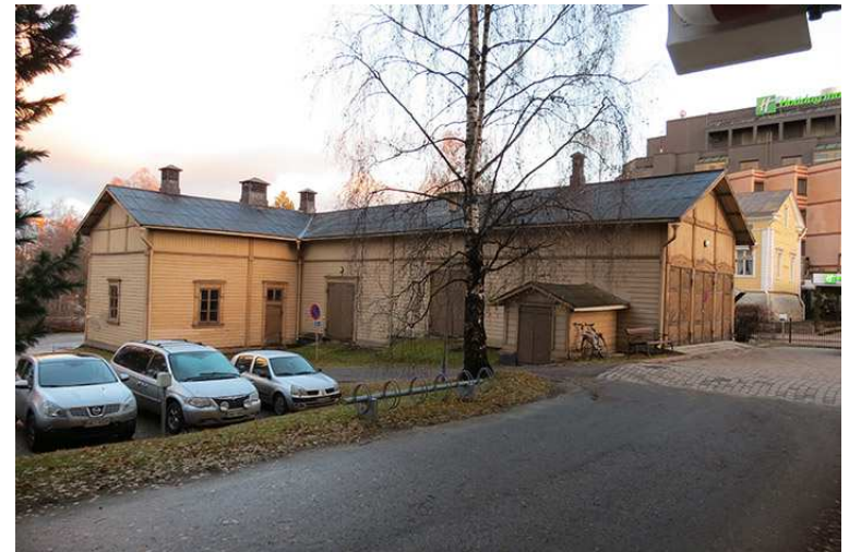
Kuva 184. Piharakennus, julkisivut sisäpihalle 2013.
