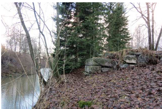
Kuva 165. Vanhan sillan perustuksia Plaatansaaren rantatörmällä. Lääninhallituksen tontin ja Plaatansaaren väliä on purettu vanha kulkuyhteys maaherran puutarhaan.
