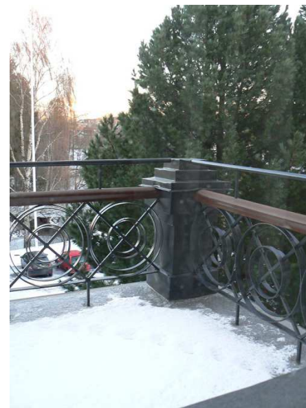
Kuva 127. Parvekkeen lisäkaide asennettiin 2006.
