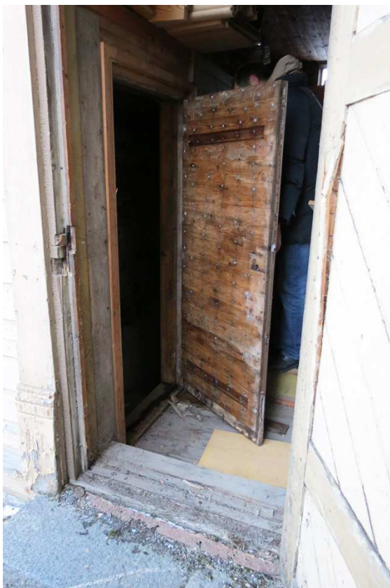
Kuva 194. Toinen kellarisisäänkäynti. Alkuperäispiirustuksista poiketen piharakennuksen alla on kellaritiloja.
