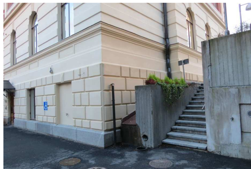
Kuva 128. Päärakennuksen ja lisärakennuksen liittymäpintoja.
