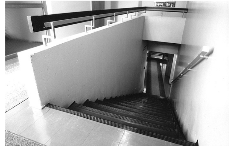
Kuva 67. Uusi avoporras kellarikerrokseen tehtiin 1970-71.
