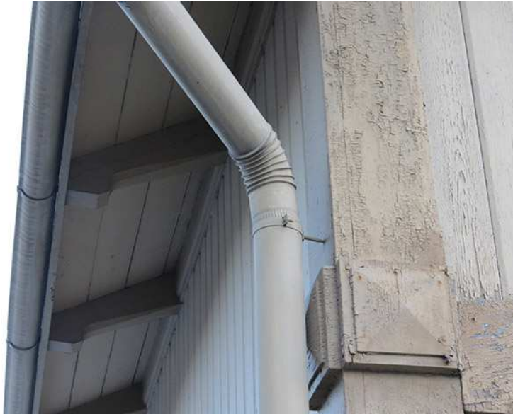
Kuva 188. Piharakennus, räystäskannattajien detailjointiarakennuksen vesikatossa.
