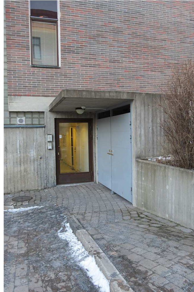
Kuva 170. Lisärakennuksen 2000 lisätty huoltosisäänkäyntiovi.
