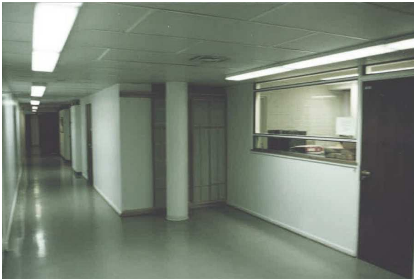
Kuva 148. Lisärakennuksen käytävätiloja ennen vuoden 2000 peruskorjausta.
