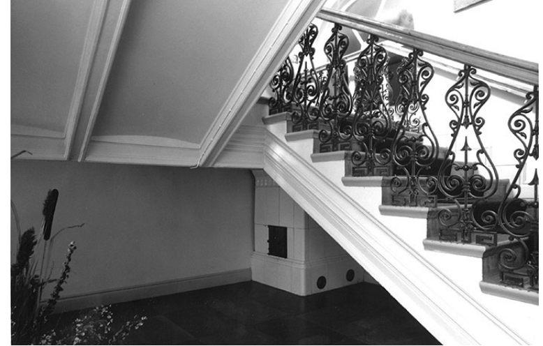
Kuva. 45. Lääninhallituksen pääportaikon alla on ns. Gurneyn rimauuni.
