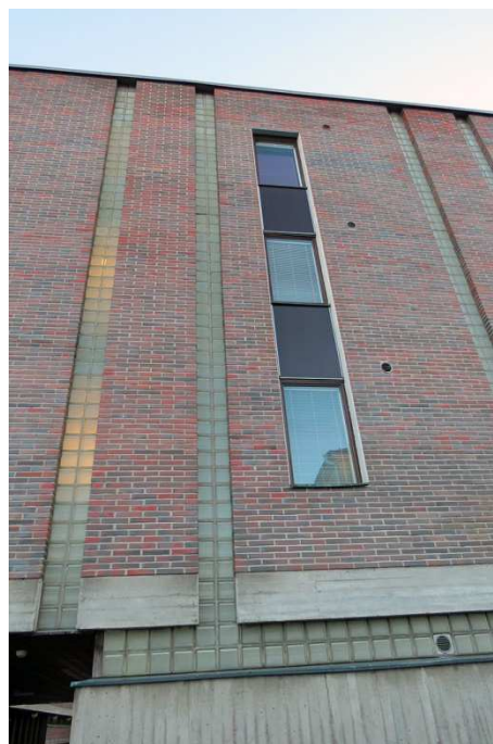
Kuva 163. Lisärakennuksen v. 2000 muutettua julkisivua.
