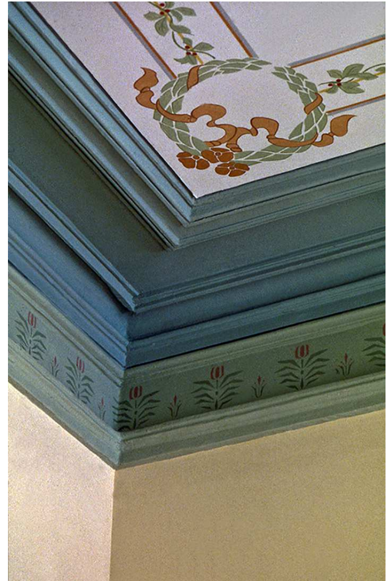
Kuva 105. Maaherran 1. kerroksen työhuoneen boordi- ja kattomaalaus rekonstruoituina 1900-luvun alun Jugend-vaiheeseen 1995.
