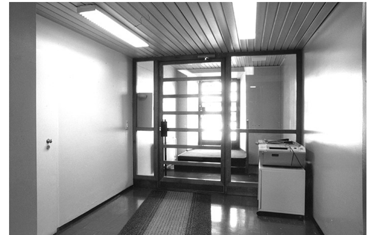
Kuva 66. Kellarikerroksen uusi tuulikaappi.
