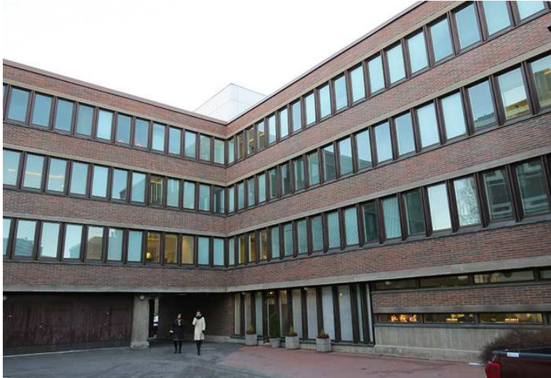
Kuva 168. Lisärakennuksen julkisivut sisäpihalla.
