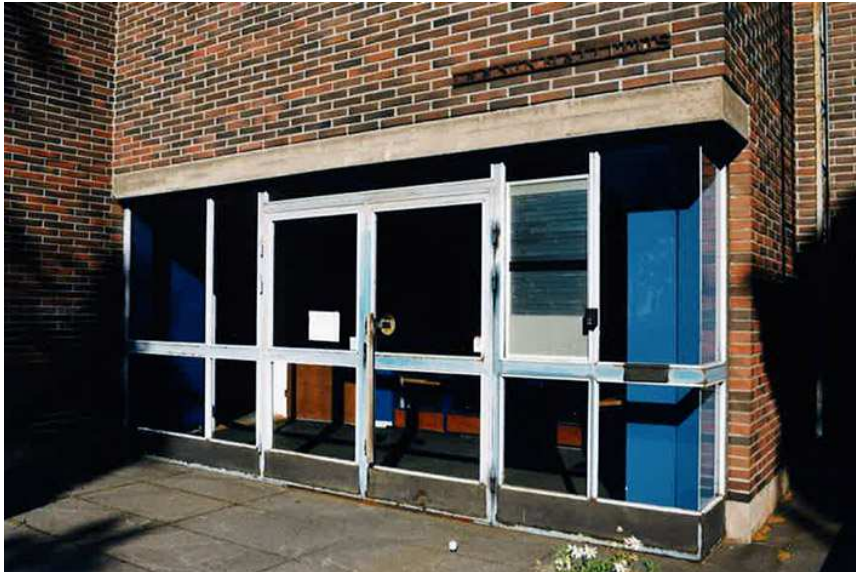
Kuva 146. Lisärakennuksen pääovi ennen vuoden 2000 peruskorjausta ja hissin rakentamista.
