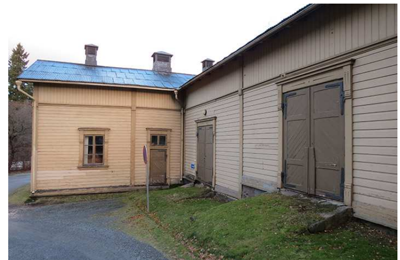
Kuva 185. Piharakennus, vaunutallin luiskatut kulkuyhteydet pihalle 2013.
