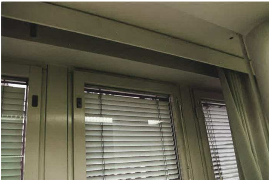
Kuva 151. Lisärakennuksen ikkunat ja kappalistat ennen vuoden 2000 peruskorjaustöitä.
