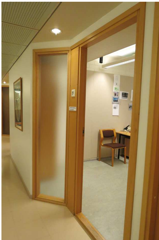
Kuva 175. Vuonna 2000 tehdyt käytävätilojen laajennukset ja uudet väliseinäikkunat.
