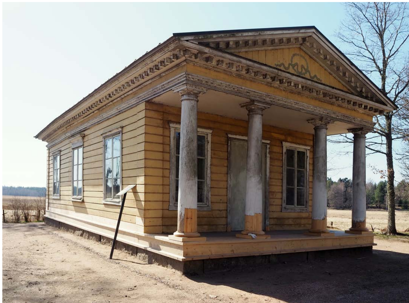
Läget i april 2021 när pelarnas, verandans och stommens rötskador hade åtgärdats.
