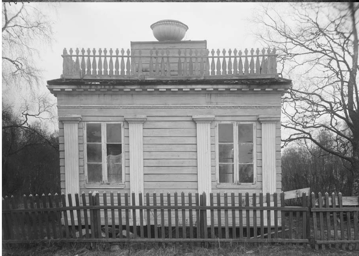
Elimä lusthus. Lusthuset flyttades till Fölisöns museum år 1919, innan dess stod den vid Moisio herrgård. Lusthuset torde ha byggts på 1830-talet efter ritningar av C. L. Engel. Utsmyckningen av dörren, fönstren, pelarna och pilasterna liknar utsmyckningarna på Granstedts ritning av Strandpaviljongen, vilka aldrig förverkligades i enlighet med planerna. MVHK.
