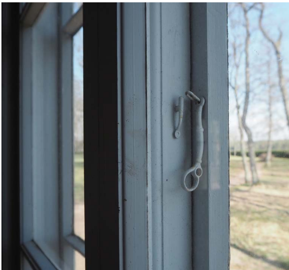
Fönster F3. Karmarna är av äldre ursprung än fönsterbågarna och beslagen.
