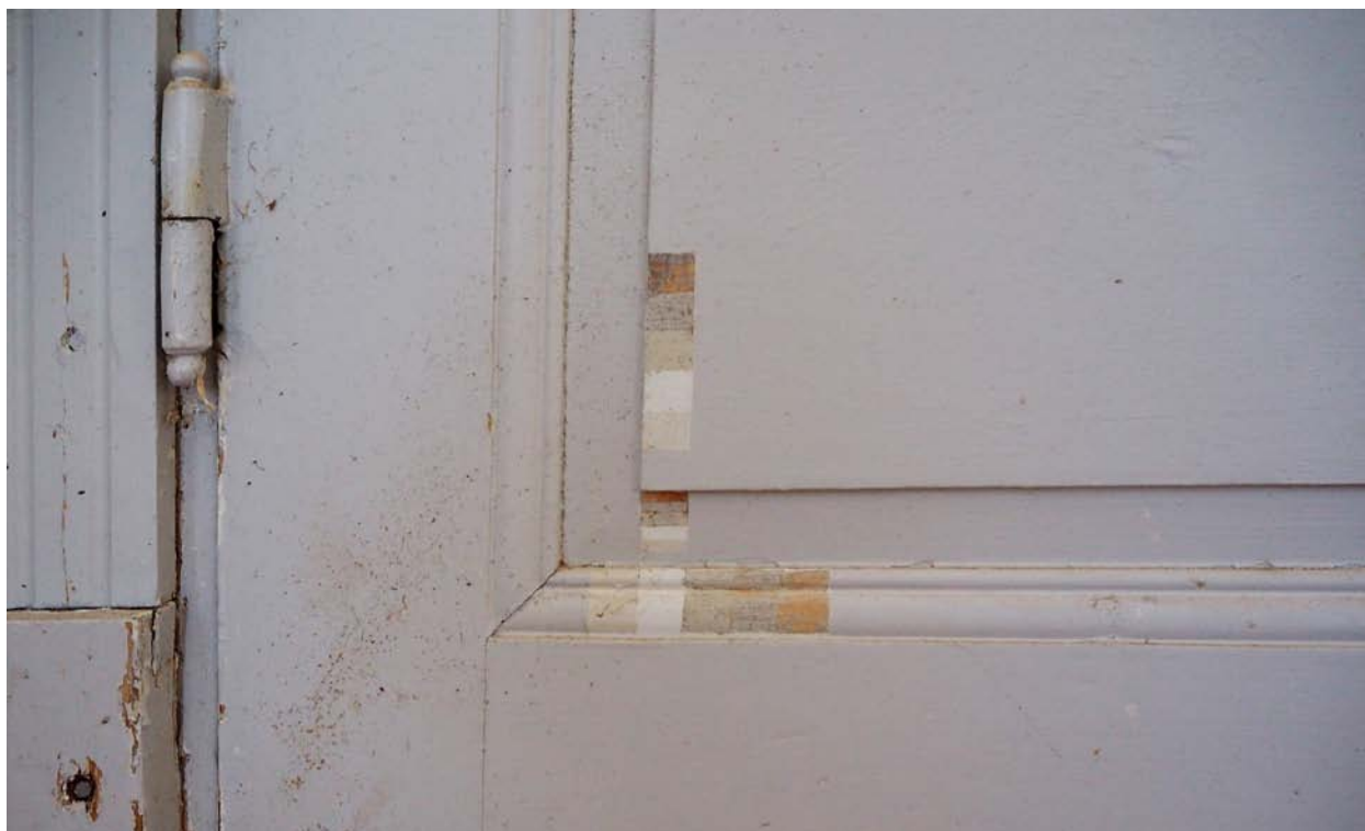
Dörr D2:s färglager har tagits fram. Dörren har gångjärn med kulformade knoppar.
