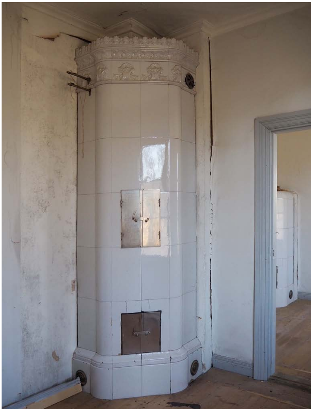
Åbo Kakelfabriks kakelugn nr. 58 har i kammaren R3 en så kallad punschlucka som saknas på ugnen i kammaren R5.
