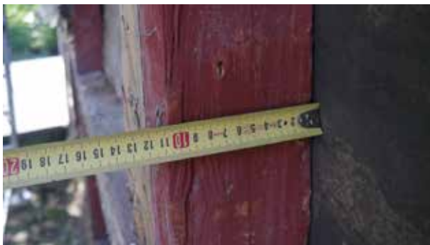
↓ Avokatoksen takaseinän alkuperäisrakenteita ulkopuolisen pystyrimalauituksen purkamisen jälkeen. amoy 2015
