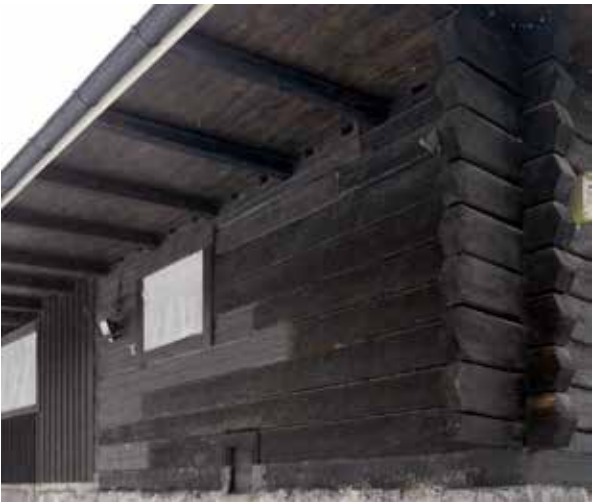
↘ Tallin takajulkisivu. Entisen lantaluukun kehys näkyy alhaalla, hirsiseinän keskellä. Käymälä sijaitsi hirsiseinän jälkeisen pystyrimalauitettun seinäosuuden kohdalla. Vuosina 2012–13 uusitut hirret erottuvat vaaleampina. amoy 2015
