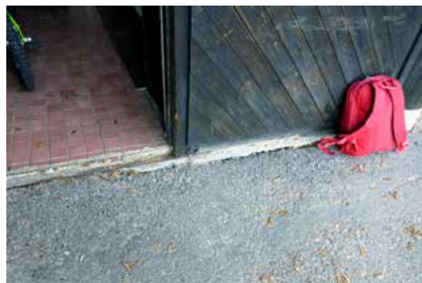
↓ Tilan lattiapinta on lähes maanpinnan tasossa. Entisen autotallin oven oikeanpuoleinen ovilehti on osa seinärakennetta.
