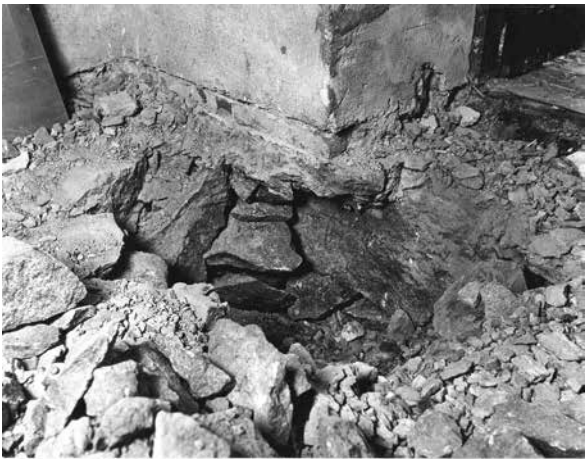
Piste 5. Kuva otettu tallin oven kohdalta. Kuvassa näkyy kuinka luonnonkivi seinä jätetty tukemaan kallioon saakka. Verhomuuraus lähtee vasta louheen pinnasta.
