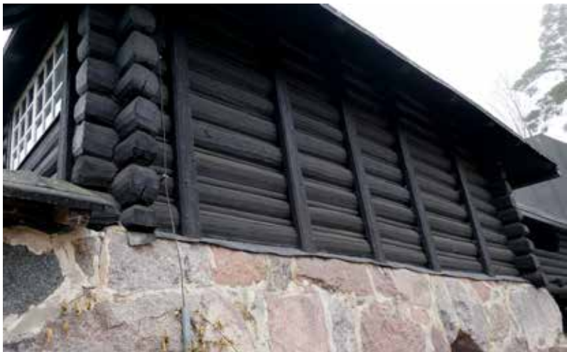
← "Följärimäiset" ulkopuoliset pystytuet pohjoispäässä nurkan molemmin puolin ovat 1980-luvun puolivälin hirsikorjauksesta. Hirsiiä vaihdettiin nurkan molemmin puolin. Jatkokset vanhaan hirteen on tehty vinoon sahaten. Länsijulkisivulla uusitut kolme alinta hirttä erottuvat silmä määräisesti ylemmistä. Hirsien väliset raot on ilmeisesti tässä vaiheessa peitetty pyöristetyin puurimoin. amoy 2018
