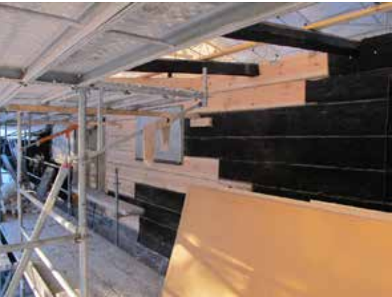
Entisen Tallin hirs- ja kattorakenteiden korjaus v. 2012–13. Restaurointi-S Oy ↗ Tallin vesikatto. ↗ Tallin itäjulkisivun hirsikorjauksia.
