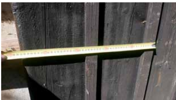
↑ Taloussiiven itäjulkisivun alkuperäistä pystyrimaloitusta. Alkuperäinen laudan leveys on ollut yli 200 mm. amoy 2015
