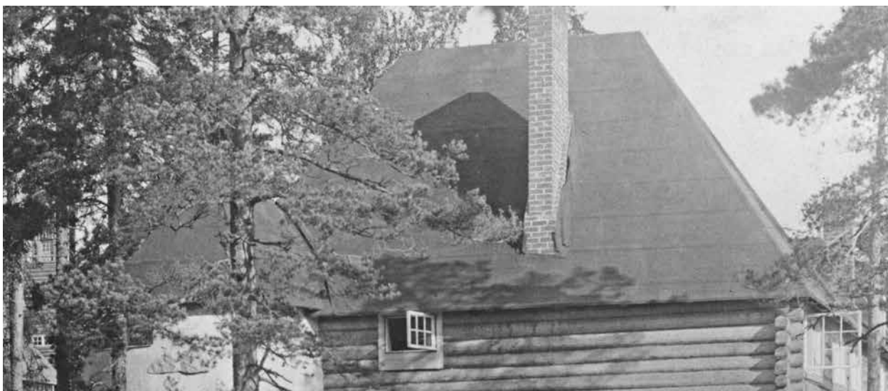
↑ 1900-luvun alkuvuosien valokuvassa Piharakennuksen katteena on vaakasuuntainen huopakate (osakuva). MFA
